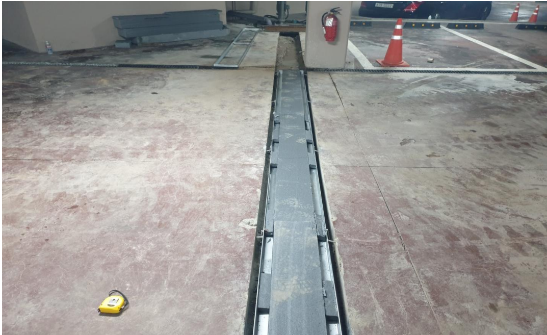
공사 중 : 배수로 신설
