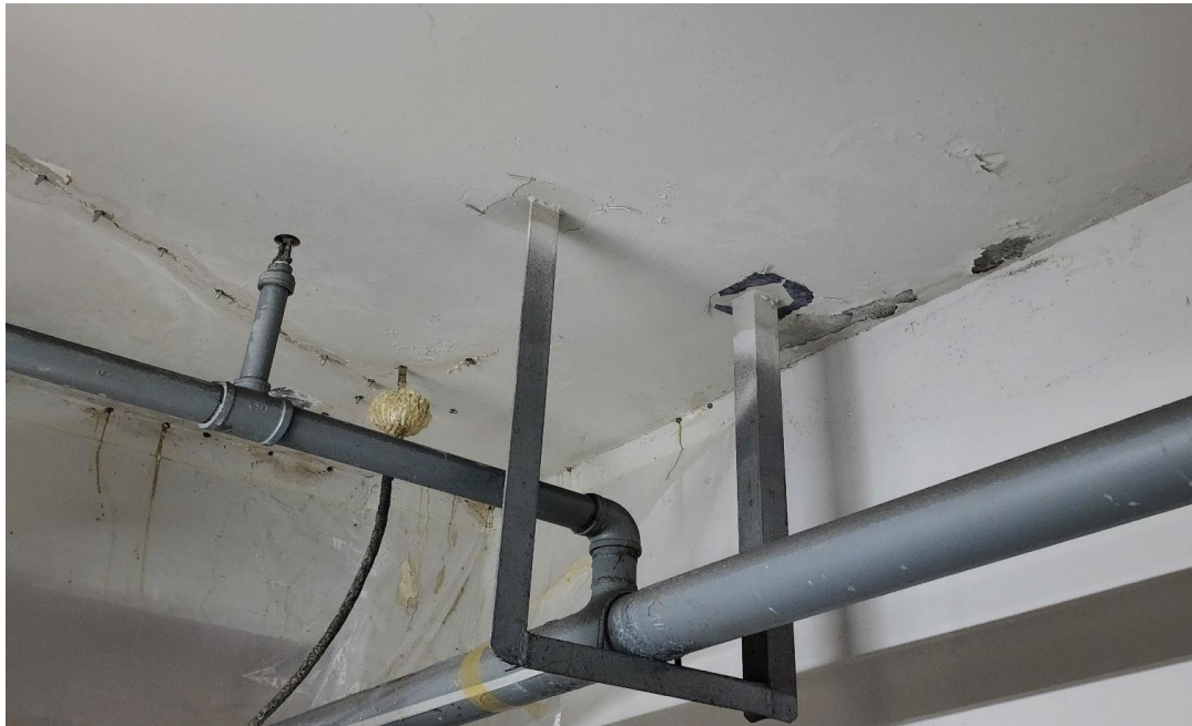
공사 중 : 천장 주입방수
