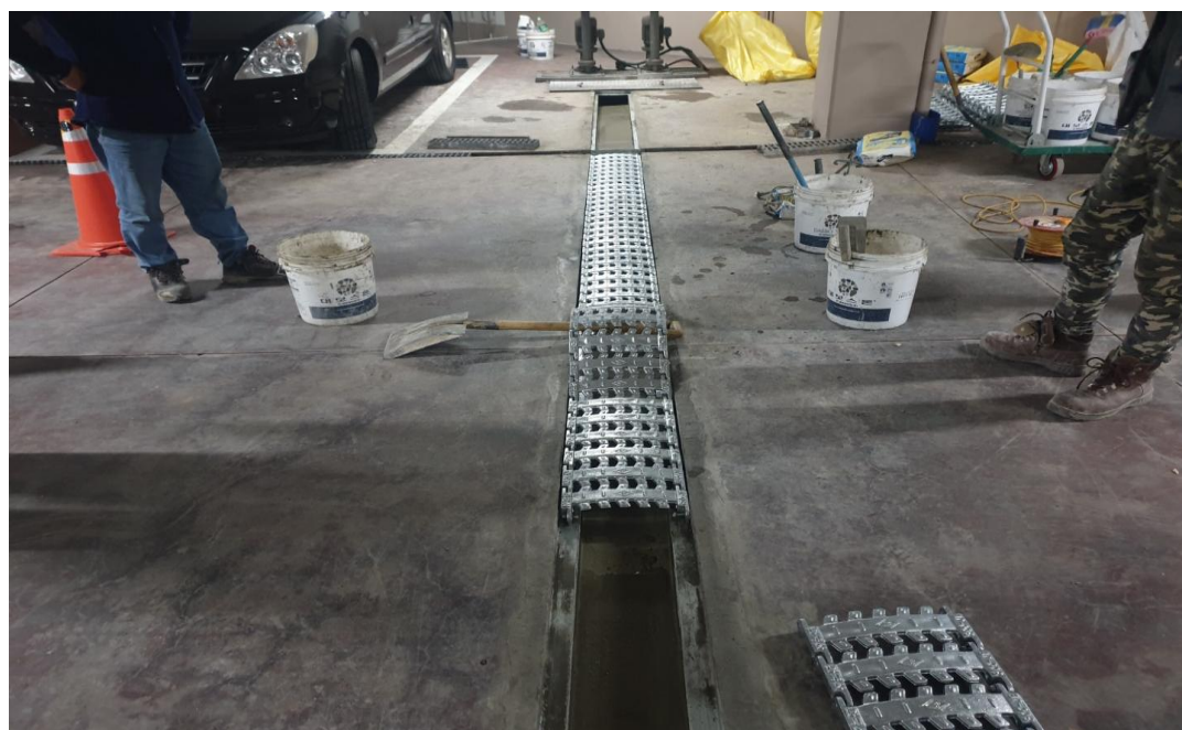
공사 중 : 배수로 신설
