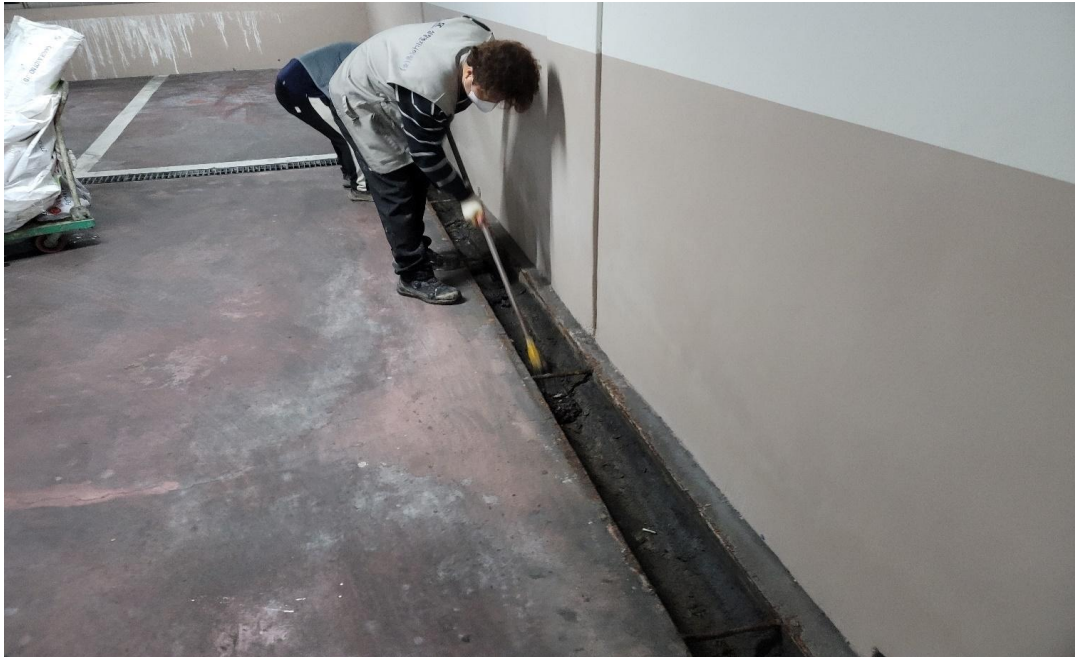
공사 중 : 배수로 청소
