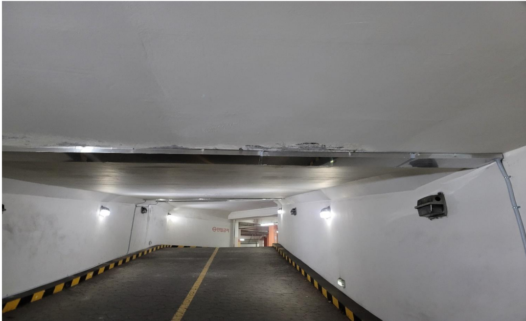
공사 후 : 유도배수 작업
