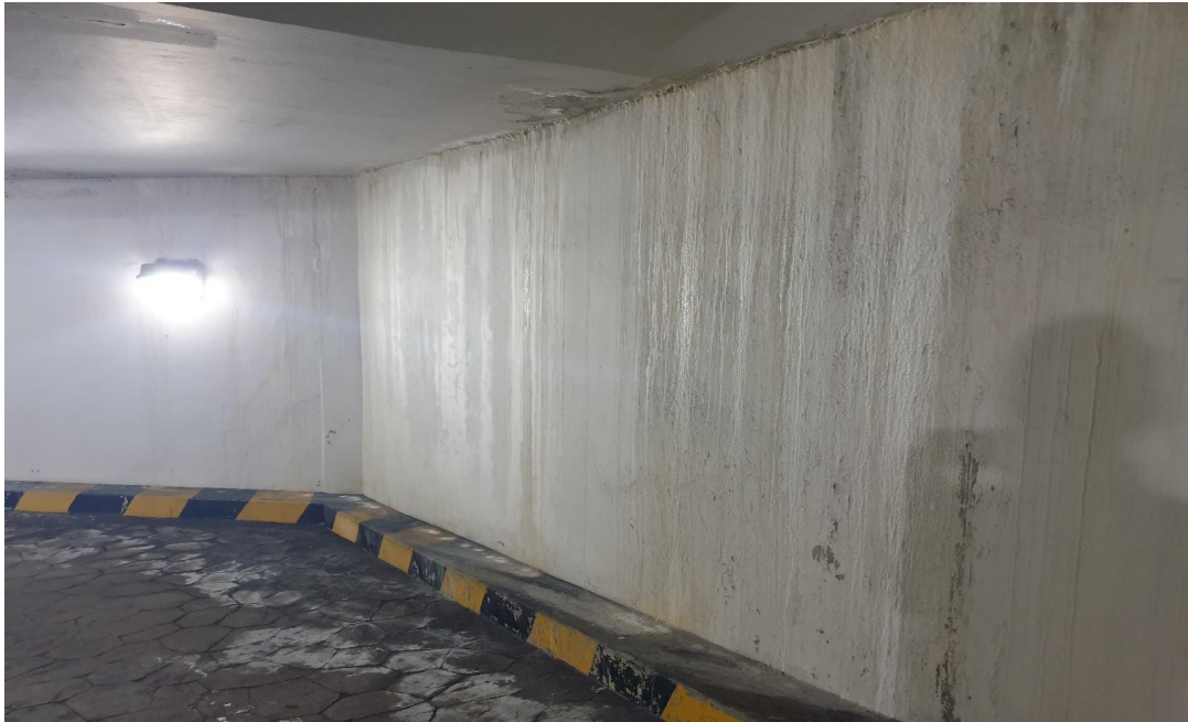
공사 전(주차장 천장)
