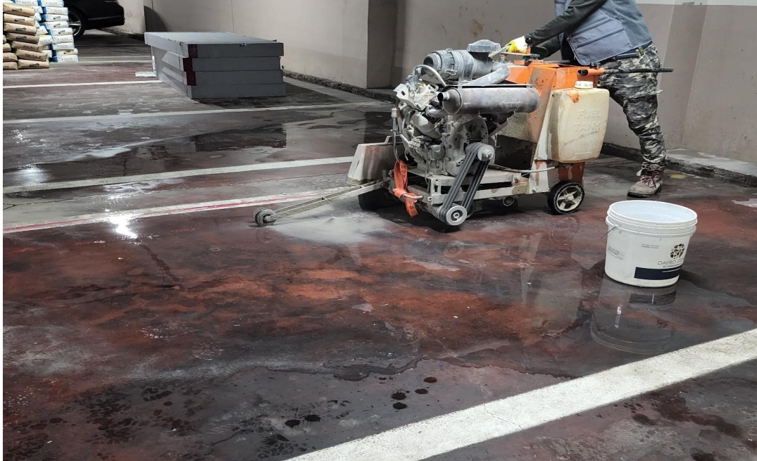
공사 중 : 배수로 신설
