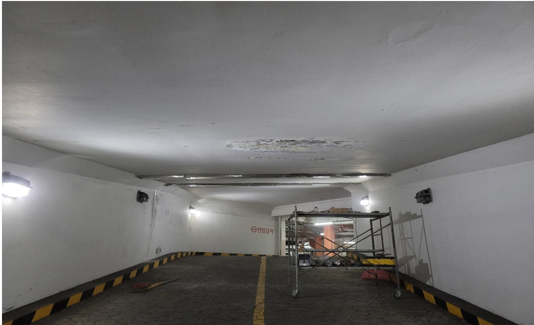
공사 중 : 유도배수 작업
