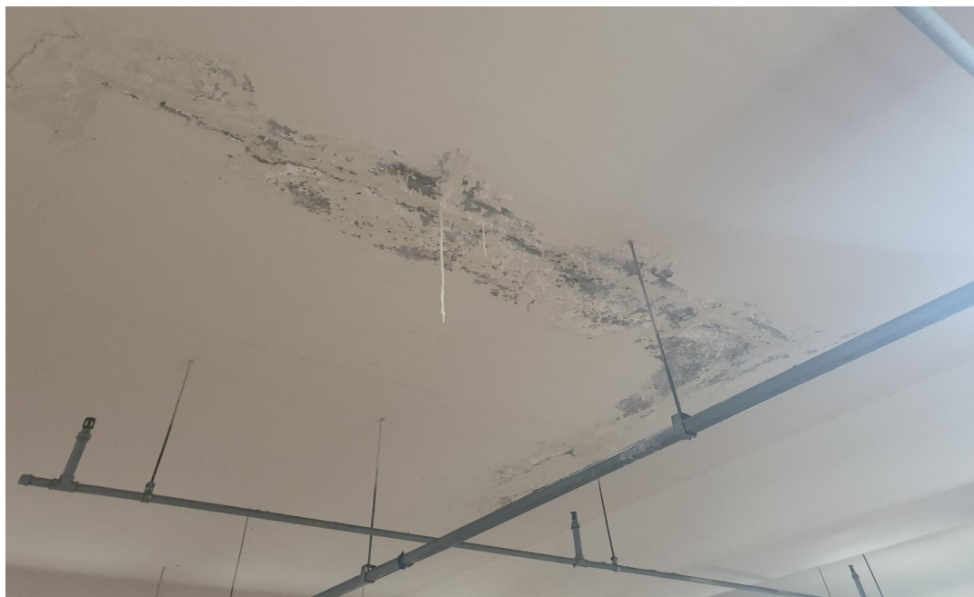
공사 전(주차장 천장)
