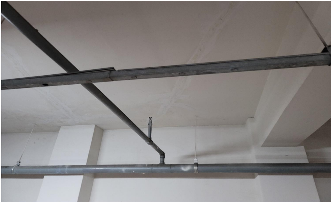
공사 후 : 천장 주입방수
