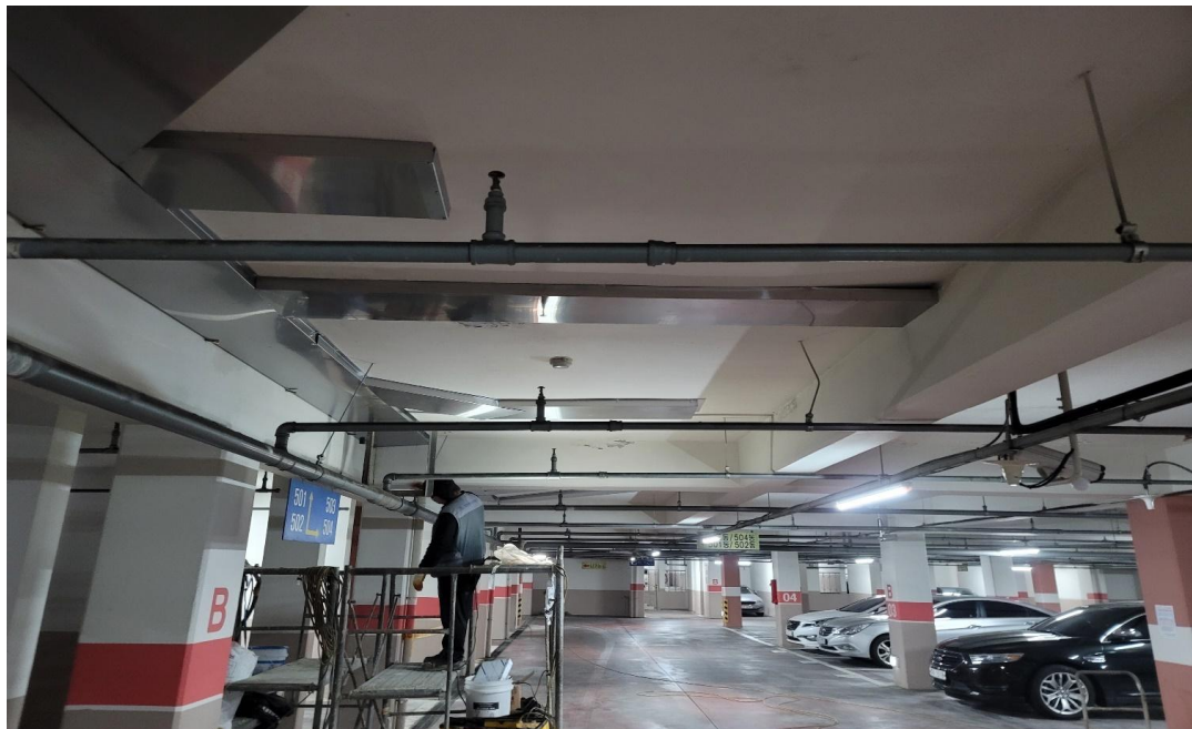
공사 중 : 유도배수 작업
