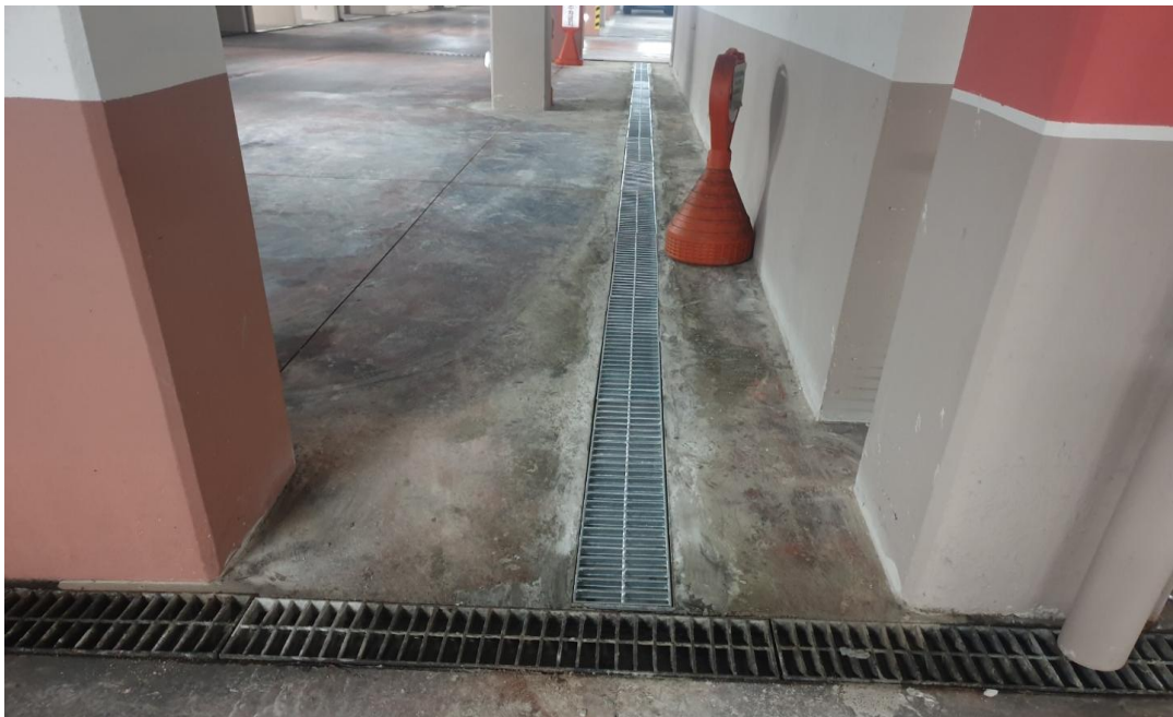
공사 후 : 배수로 신설
