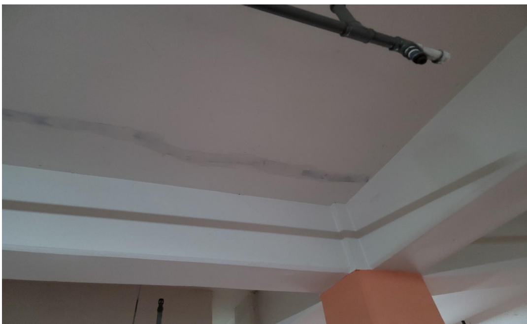
공사 후 : T포트 공법 균열보수
