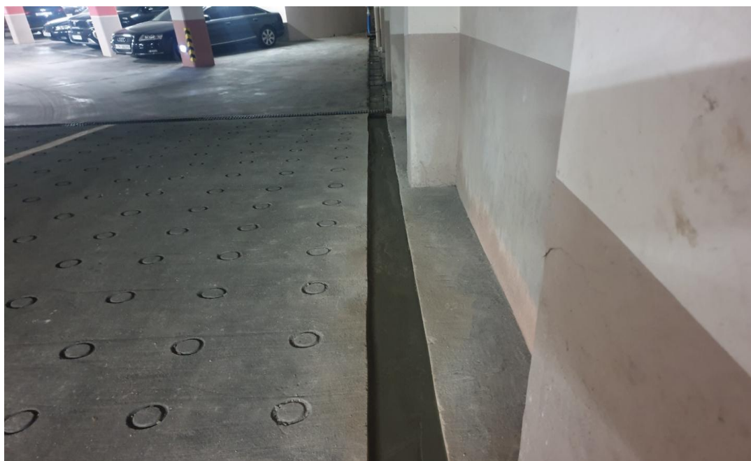
공사 후 : 배수로 구배조정
