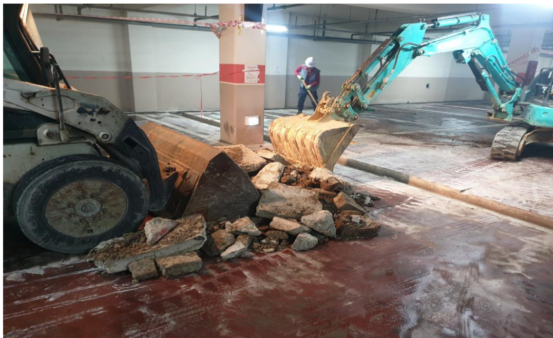
공사 중 : 배수로 신설
