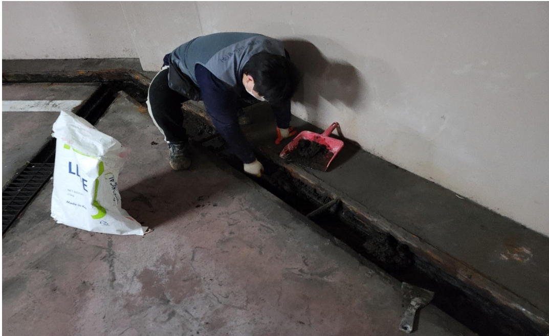
공사 중 : 배수로 청소
