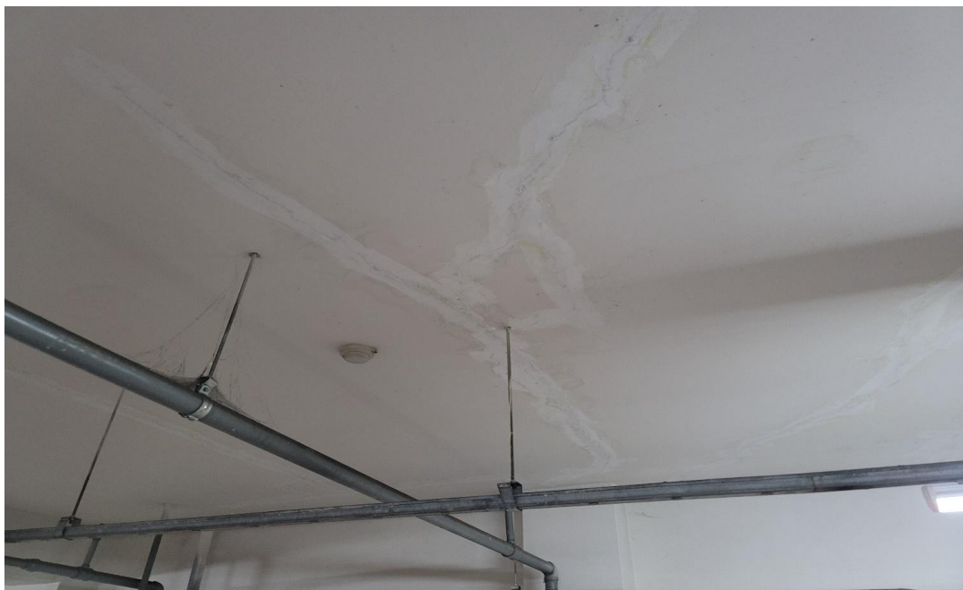
공사 후 : 천장 주입방수
