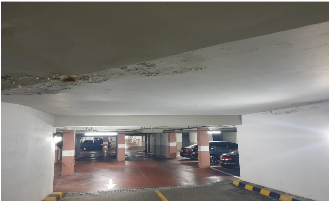
공사 전(주차장 천장)
