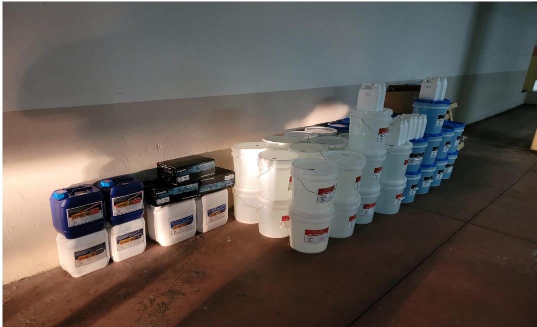
공사 중 : 자재입고
