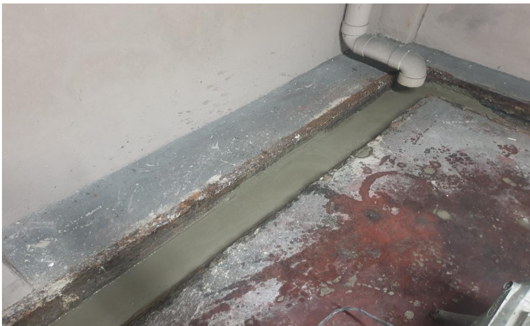
공사 중 : 배수로 구배조정
