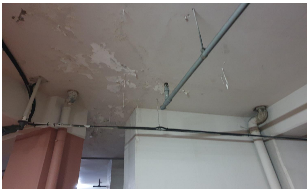
공사 전(주차장 천장)
