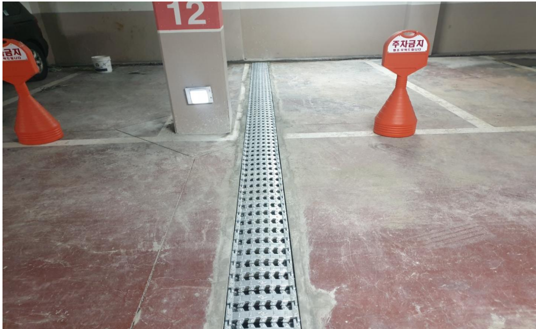
공사 후 : 배수로 신설
