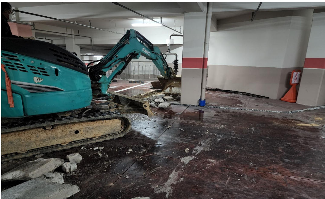
공사 중 : 배수로 신설
