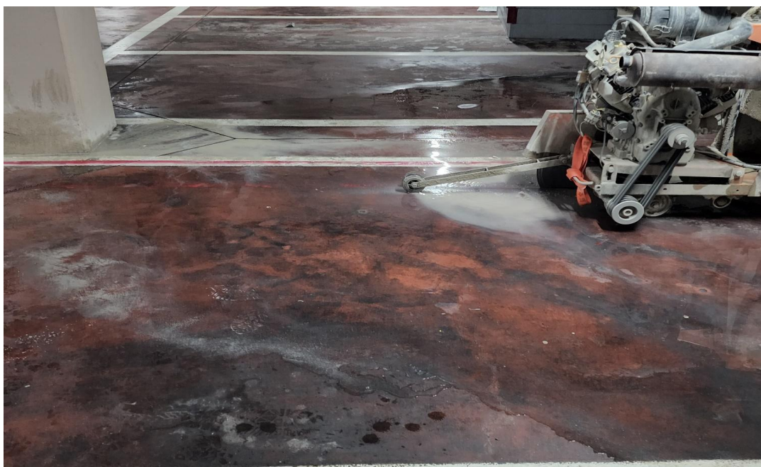
공사 중 : 배수로 신설
