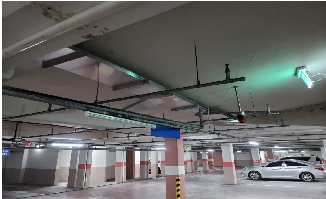
공사 후 : 유도배수 작업
