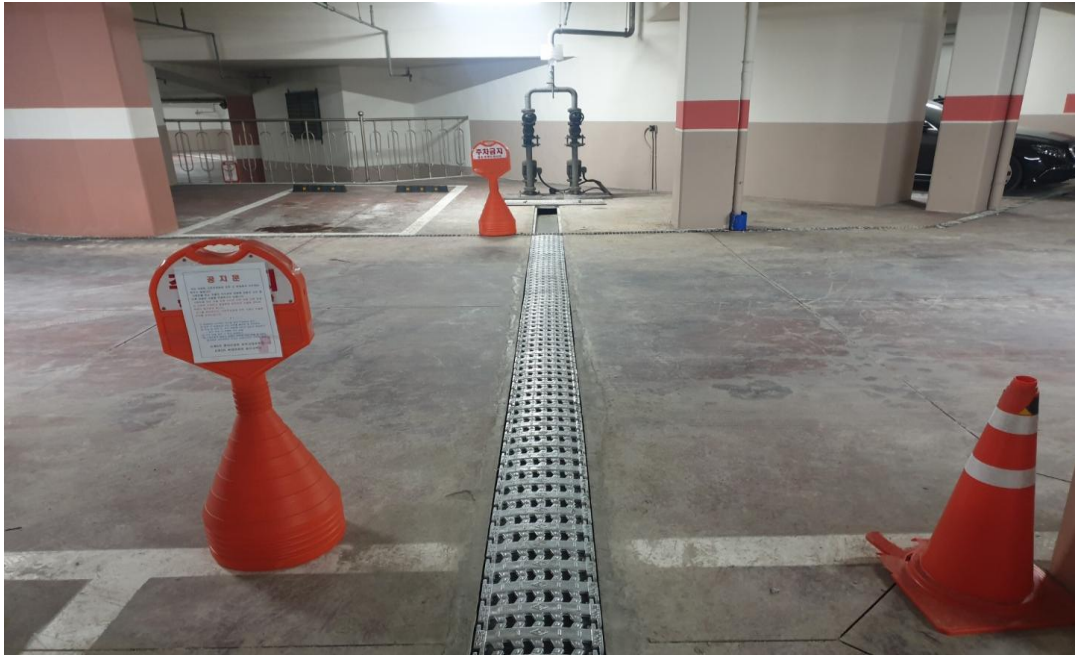
공사 후 : 배수로 신설
