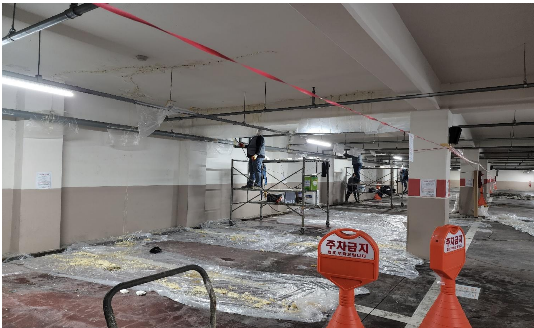
공사 중 : 천장 주입방수
