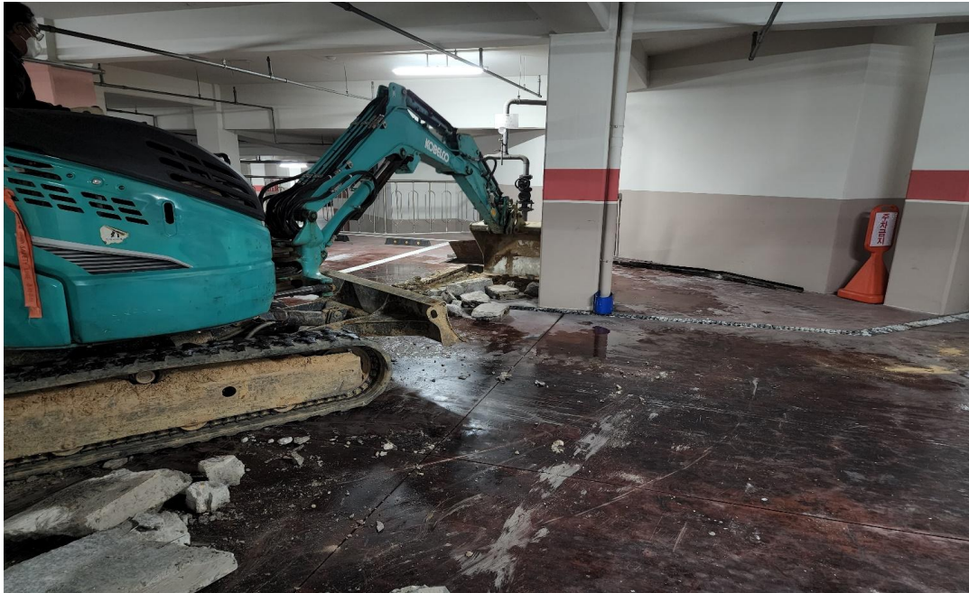
공사 중 : 배수로 신설
