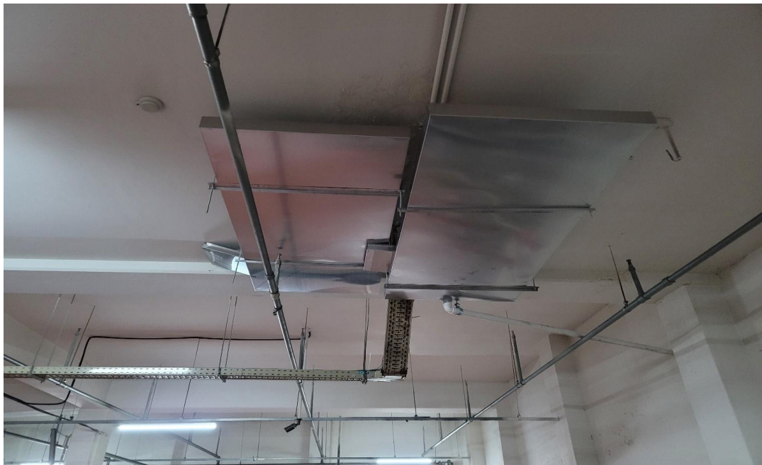
공사 후 : 유도배수 작업
