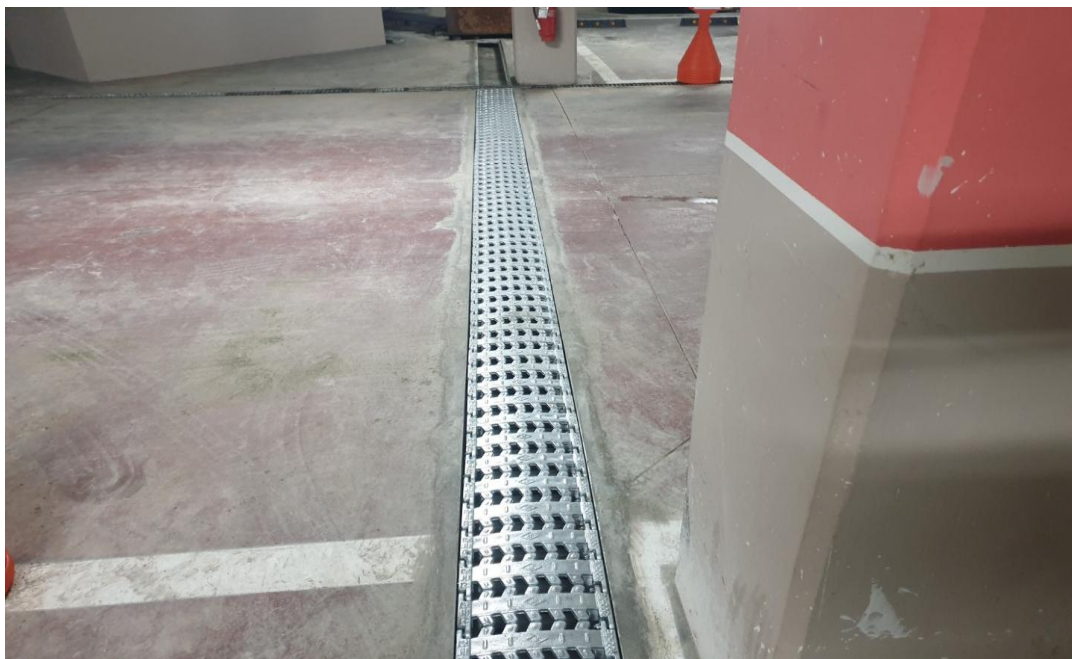
공사 후 : 배수로 신설
