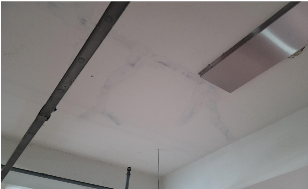
공사 후 : T포트 공법 균열보수
