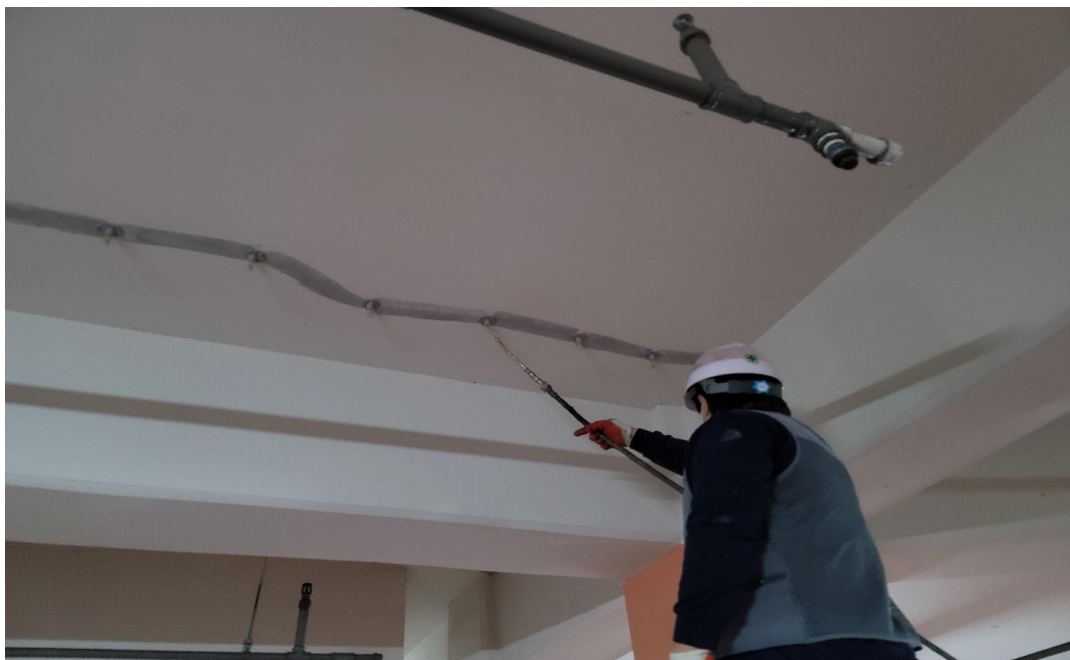
공사 중 : T포트 공법 균열보수
