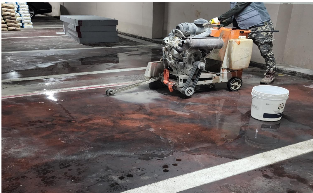
공사 중 : 배수로 신설
