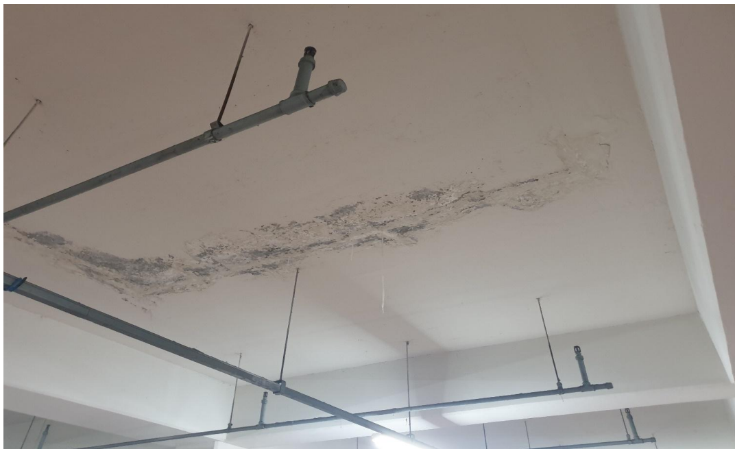
공사 전(주차장 천장)
