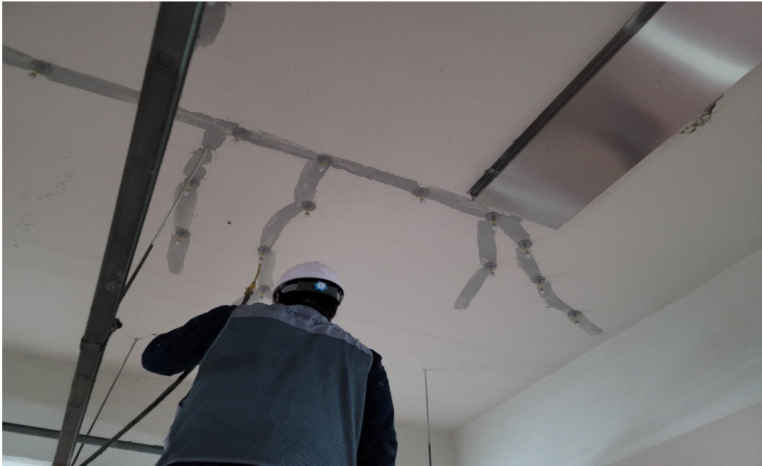
공사 중 : T포트 공법 균열보수
