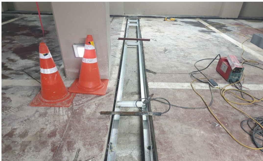
공사 중 : 배수로 신설
