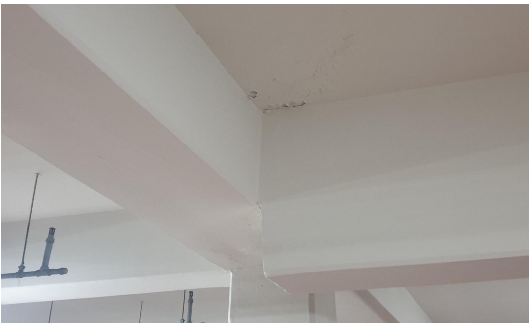
공사 전(주차장 천장)
