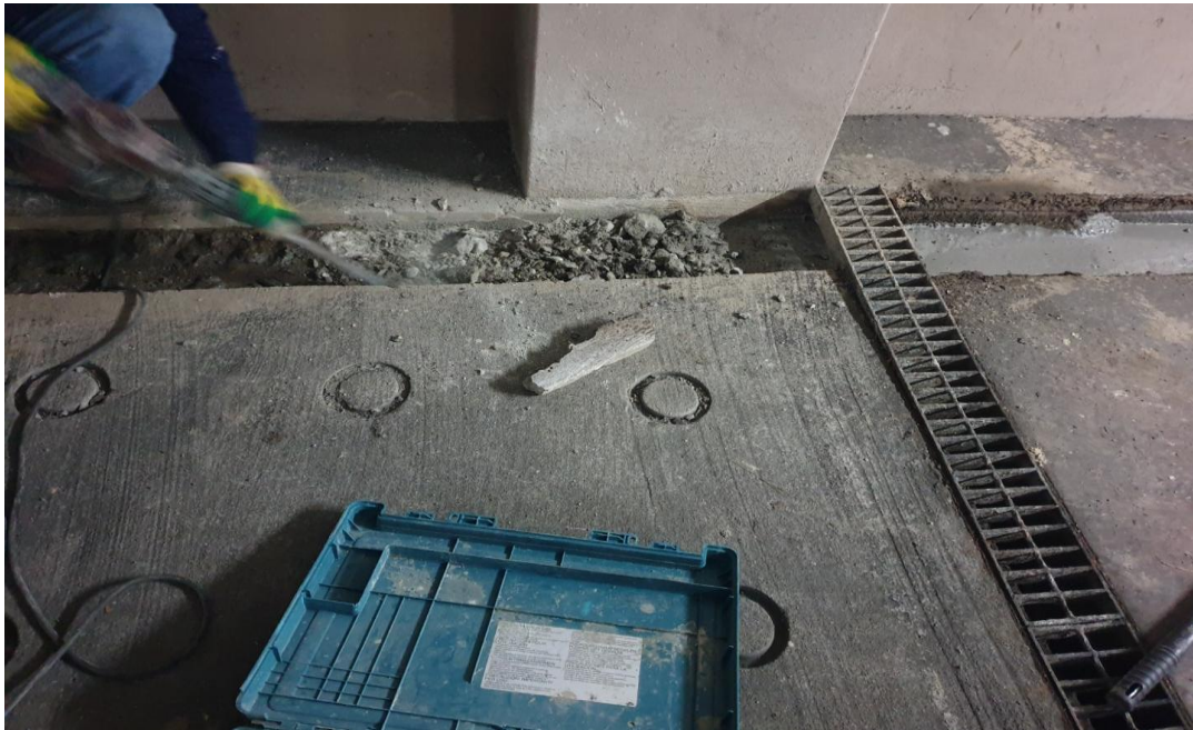
공사 중 : 배수로 구배조정
