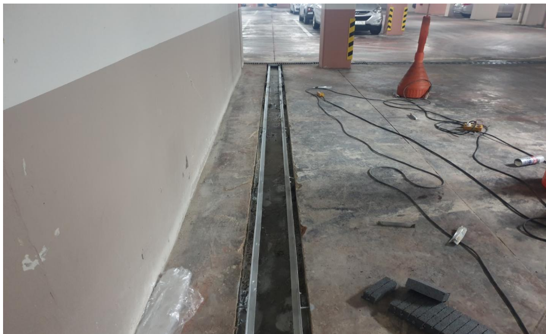
공사 중 : 배수로 신설
