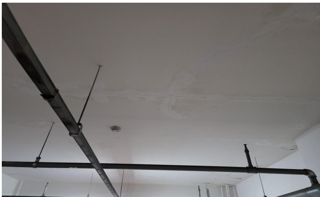
공사 후 : 천장 주입방수
