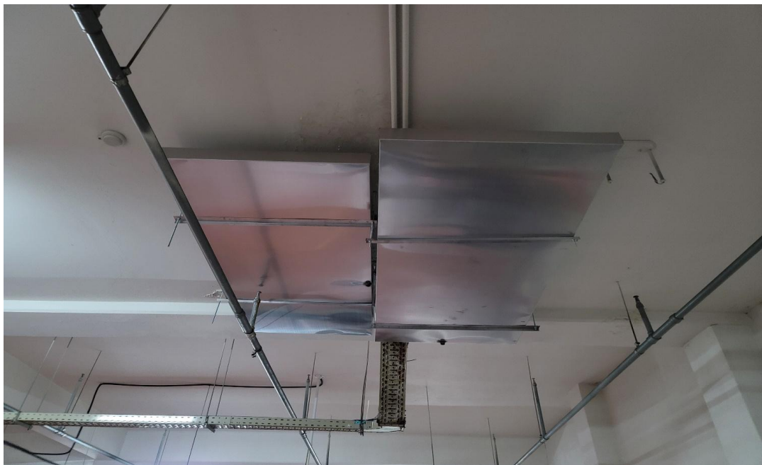
공사 중 : 유도배수 작업
