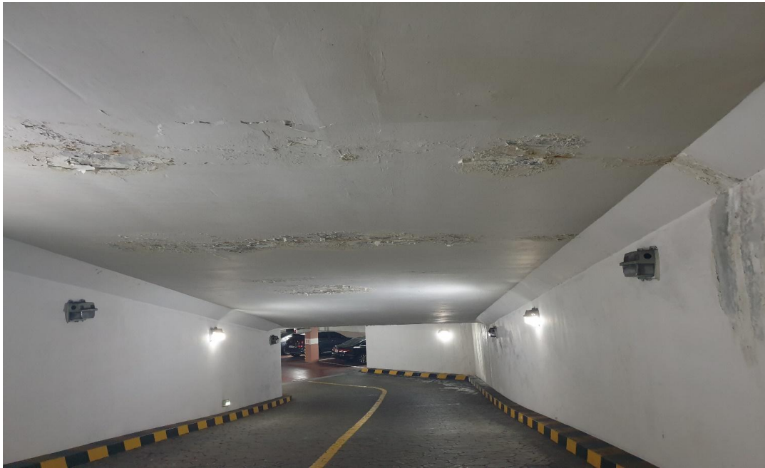
공사 전(주차장 천장)
