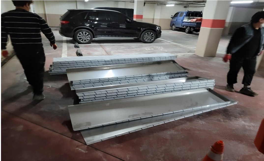
공사 중 : 유도배수 자재입고
