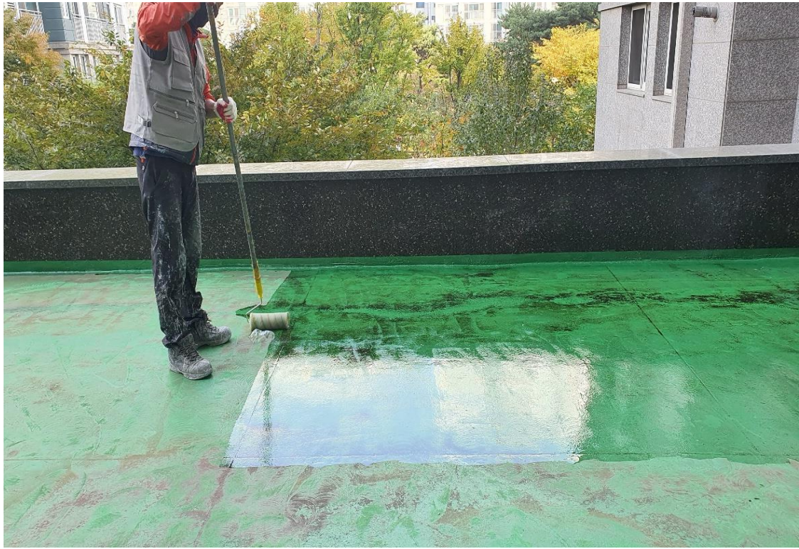
우레탄 하도(프라이머) 도포 작업
