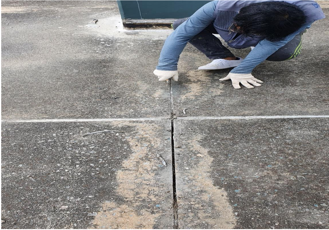
옥상 바닥 면 처리 작업
