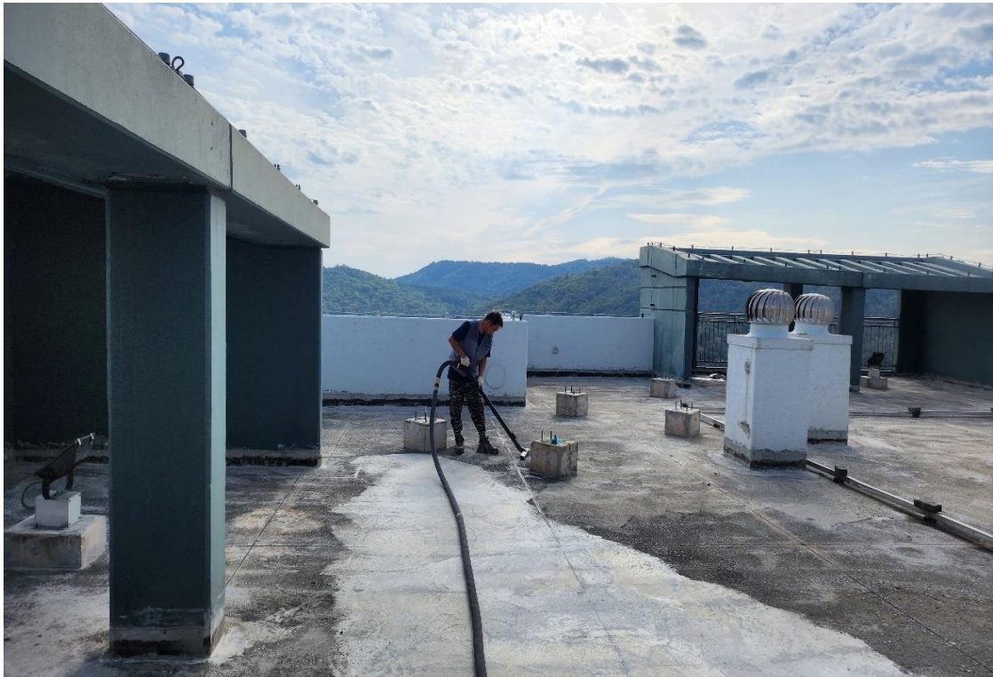
옥상 바닥 면 처리 작업
