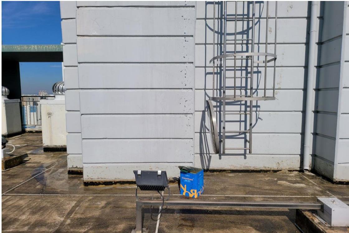
우레탄 하도(프라이머) 도포 작업
