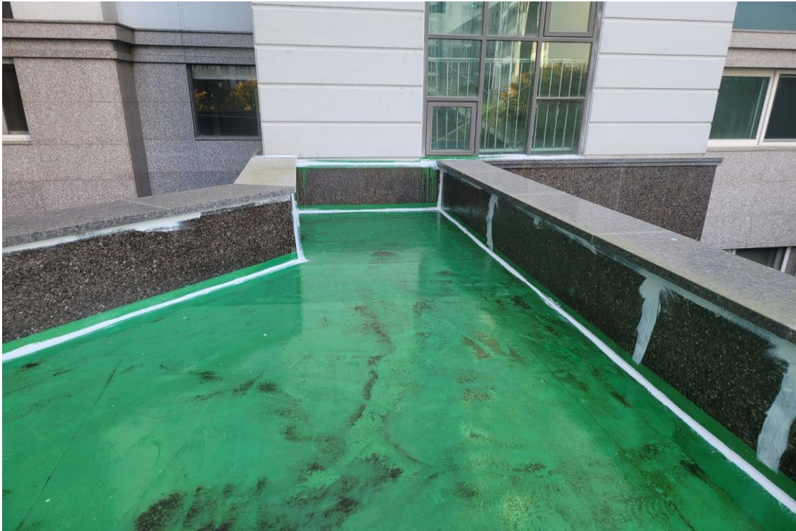
바닥 및 수직 접합부위 우레탄 실란트 작업
