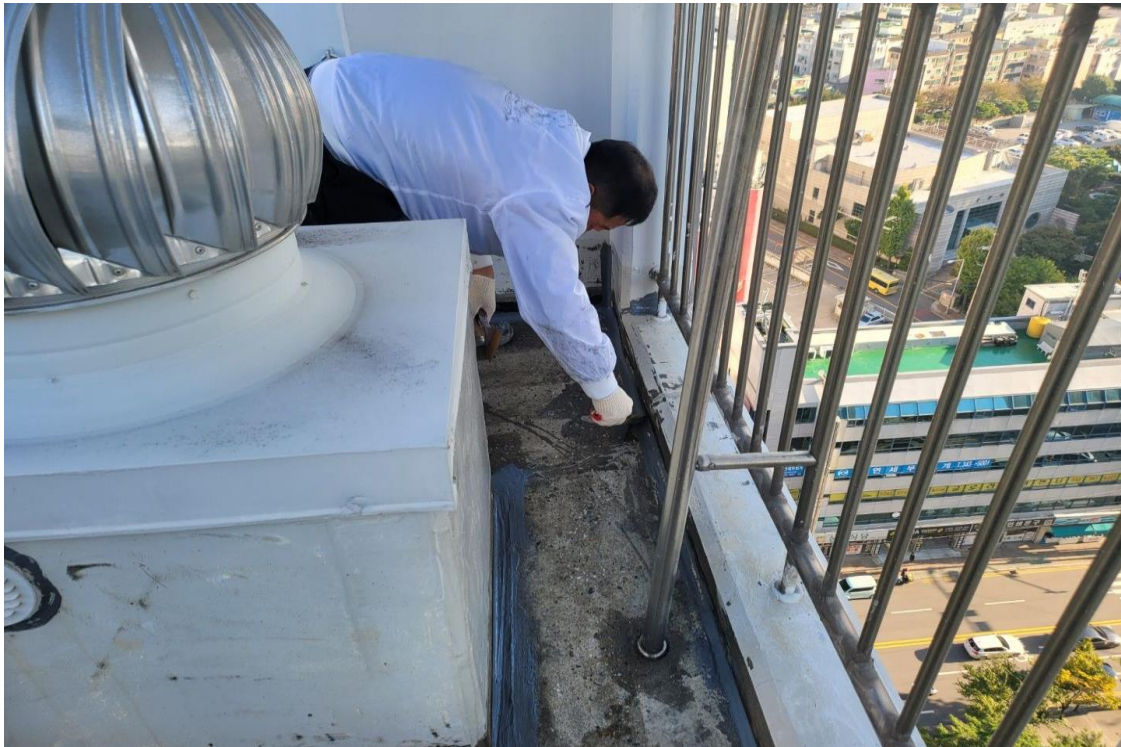
바닥 및 수직 접합부위 우레탄 실란트 작업
