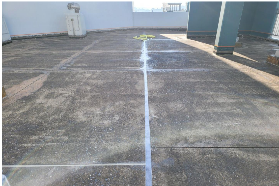
바닥 및 수직 접합부위 우레탄 실란트 작업
