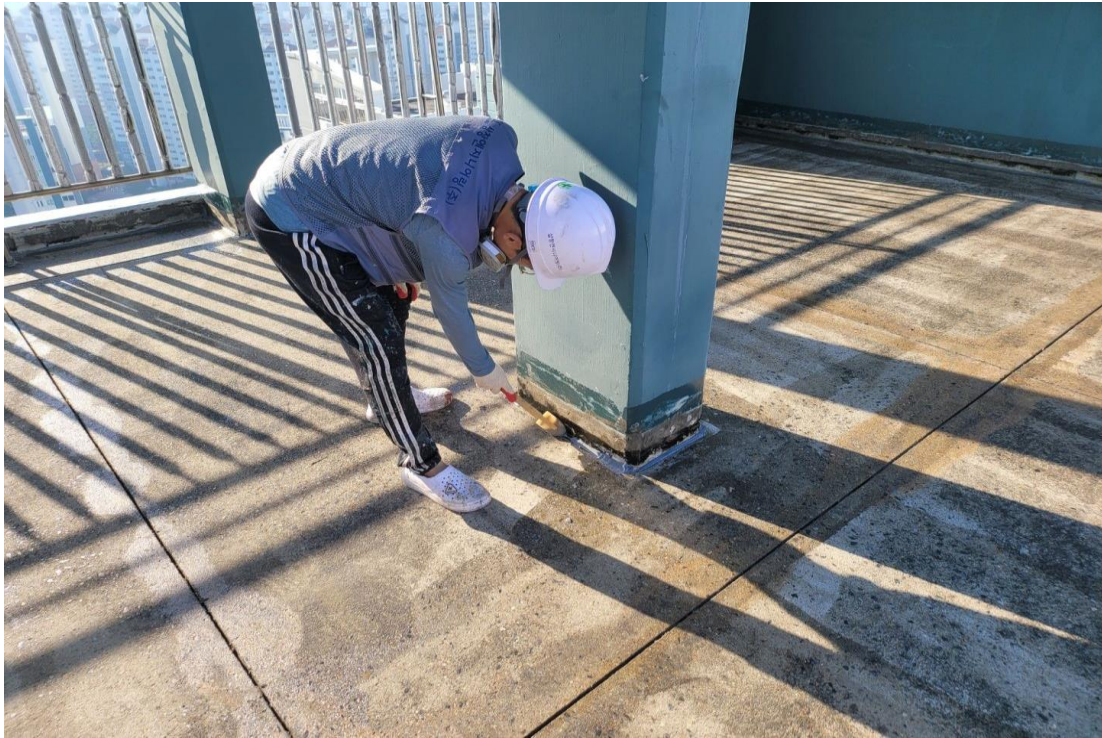
바닥 및 수직 접합부위 우레탄 실란트 작업
