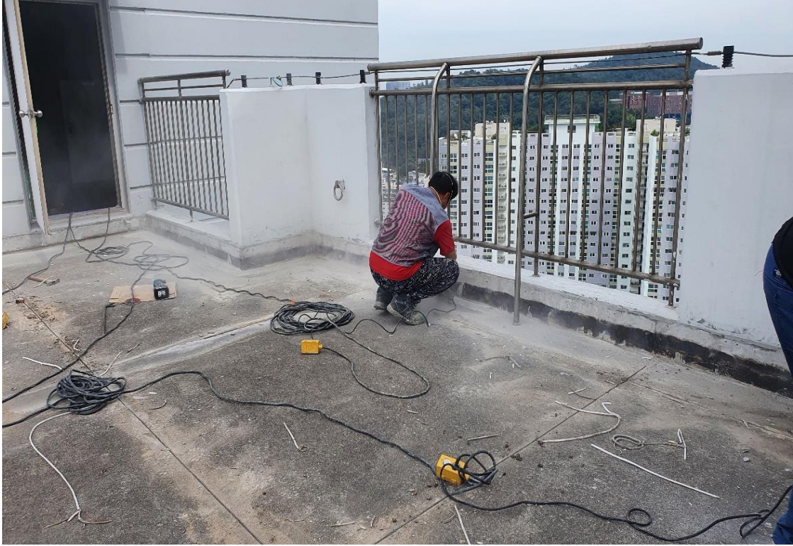
옥상 바닥 면 처리 작업
