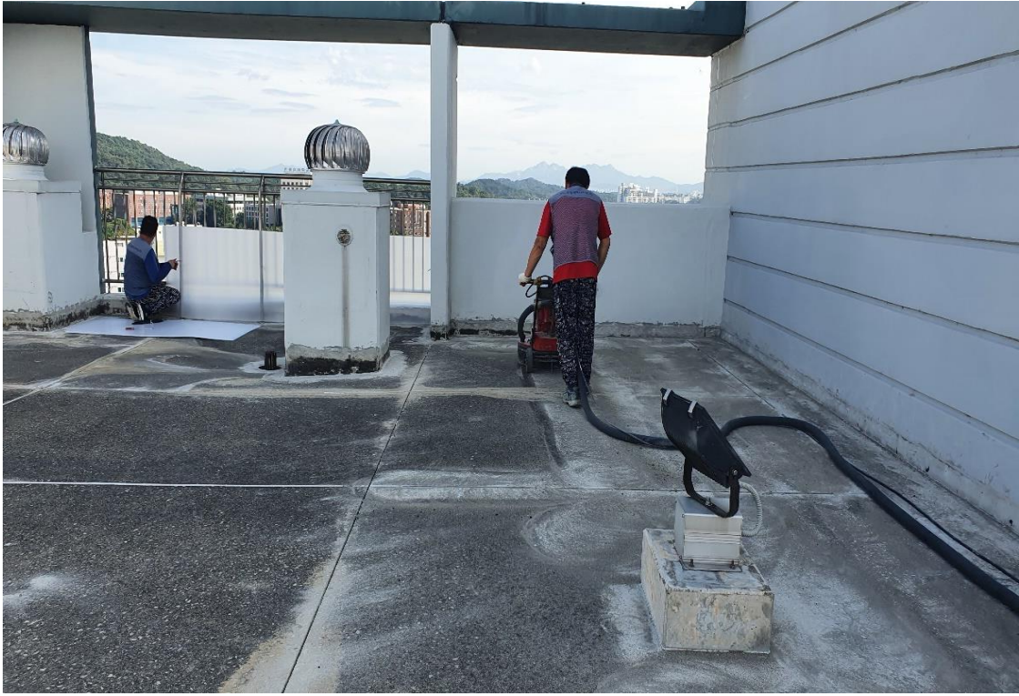
옥상 바닥 면 처리 작업
