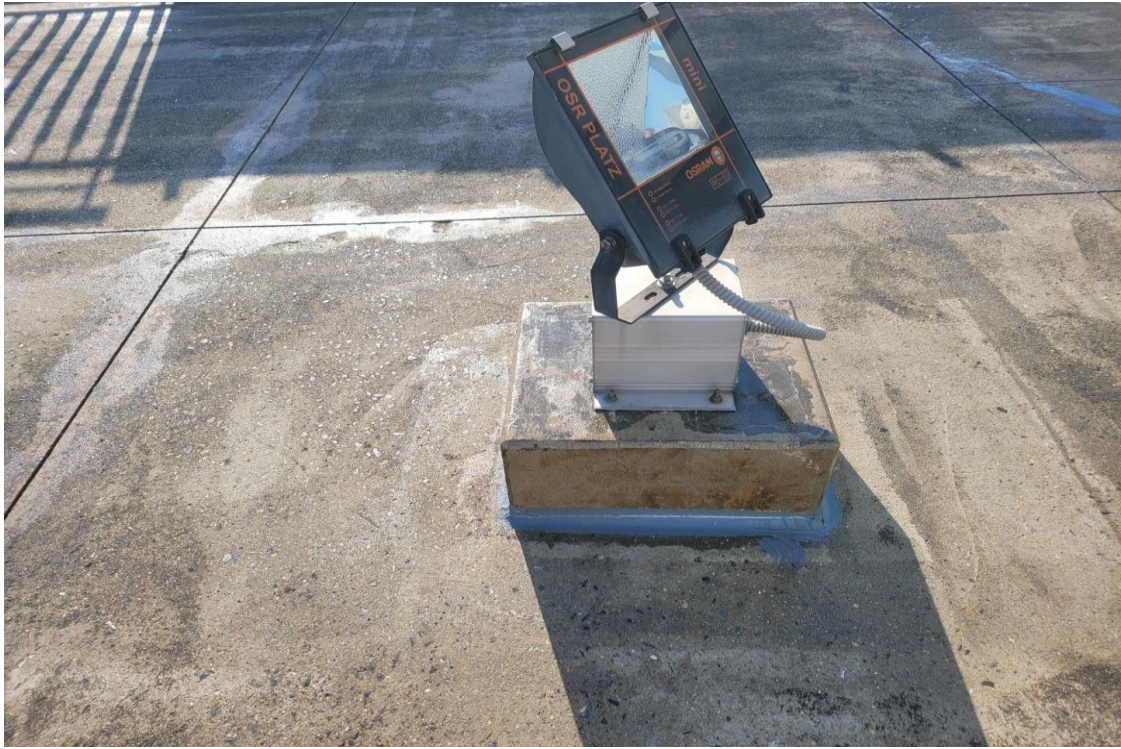
바닥 및 수직 접합부위 우레탄 실란트 작업
