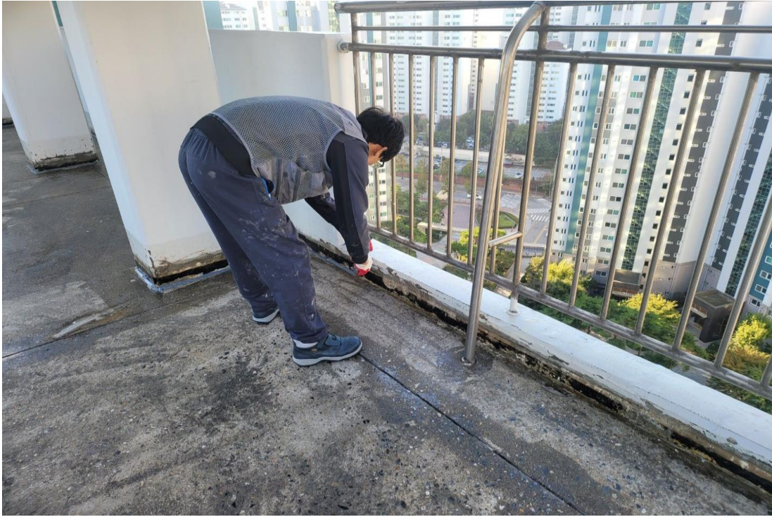
바닥 및 수직 접합부위 우레탄 실란트 작업
