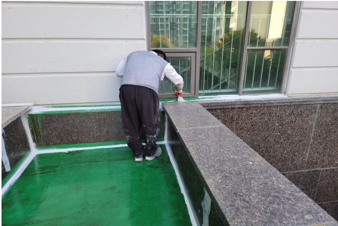
바닥 및 수직 접합부위 우레탄 실란트 작업
