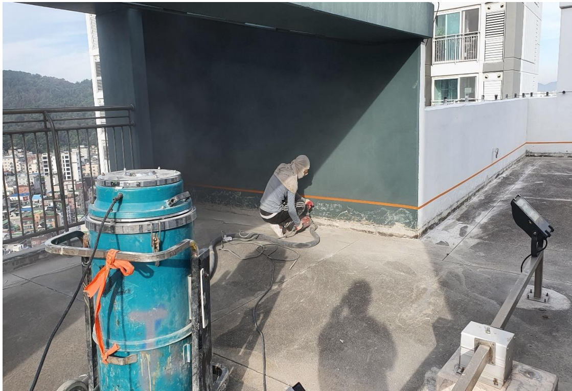
옥상 바닥 면 처리 작업
