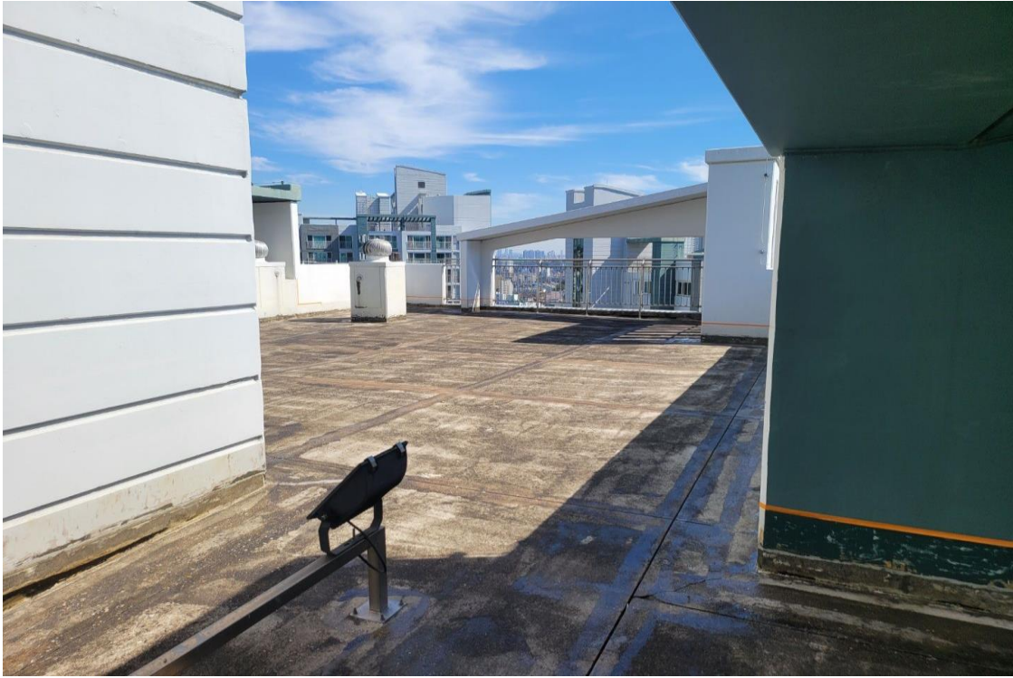
우레탄 하도(프라이머) 도포 작업
