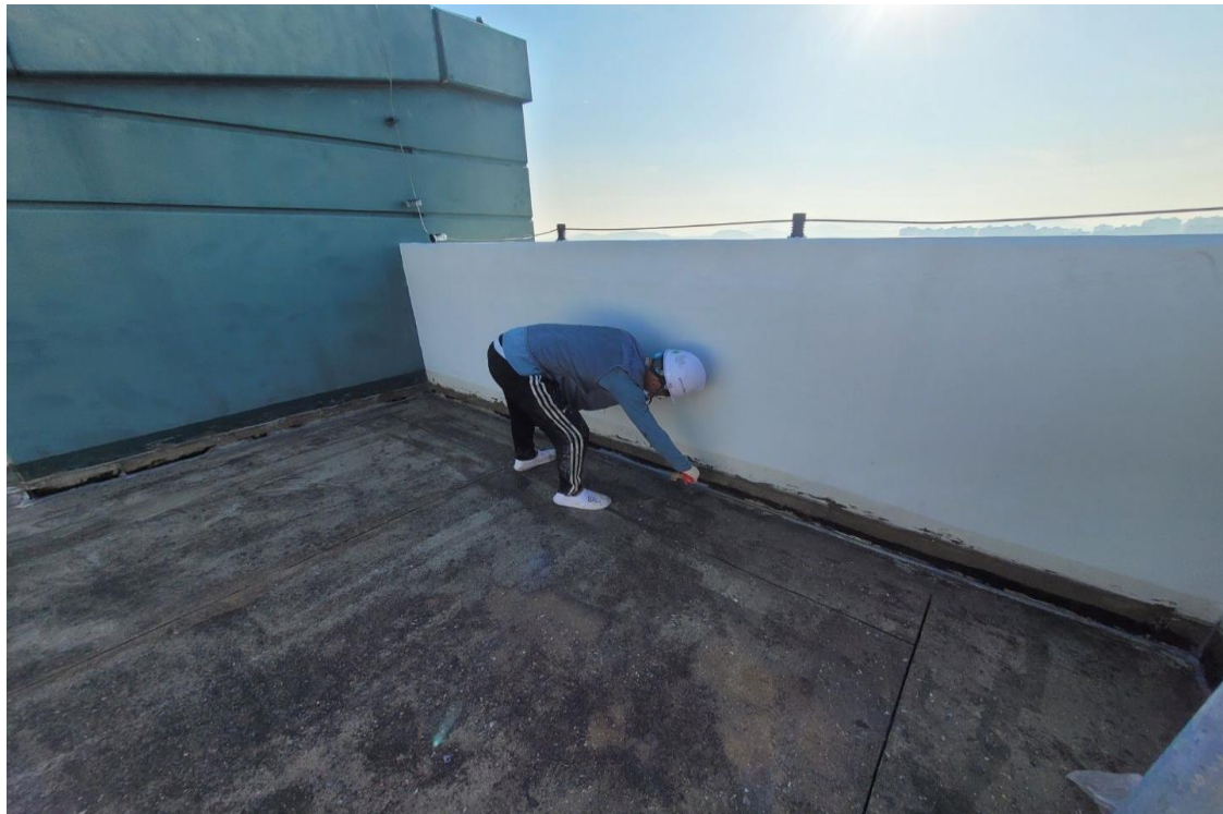
우레탄 하도(프라이머) 도포 작업
