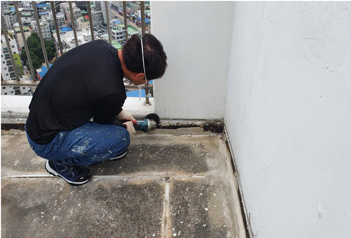
옥상 바닥 면 처리 작업
