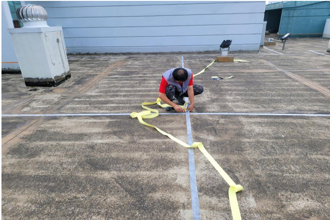
바닥 및 수직 접합부위 우레탄 실란트 작업
