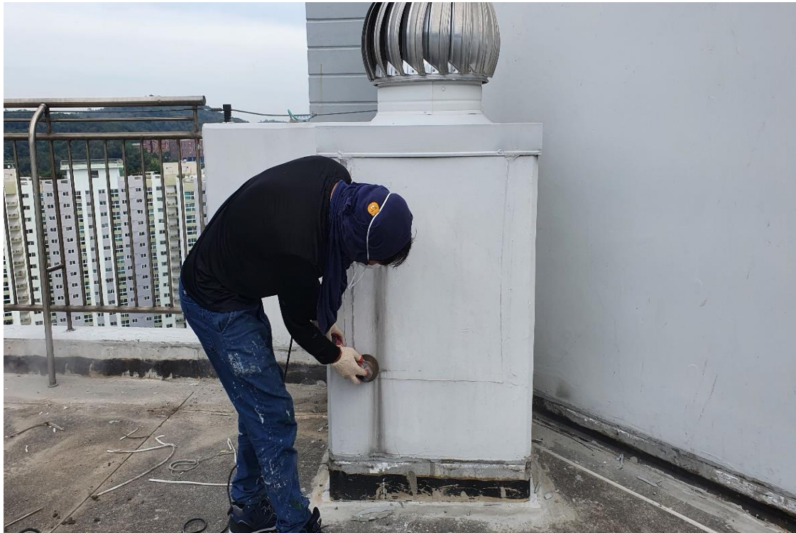
옥상 바닥 면 처리 작업
