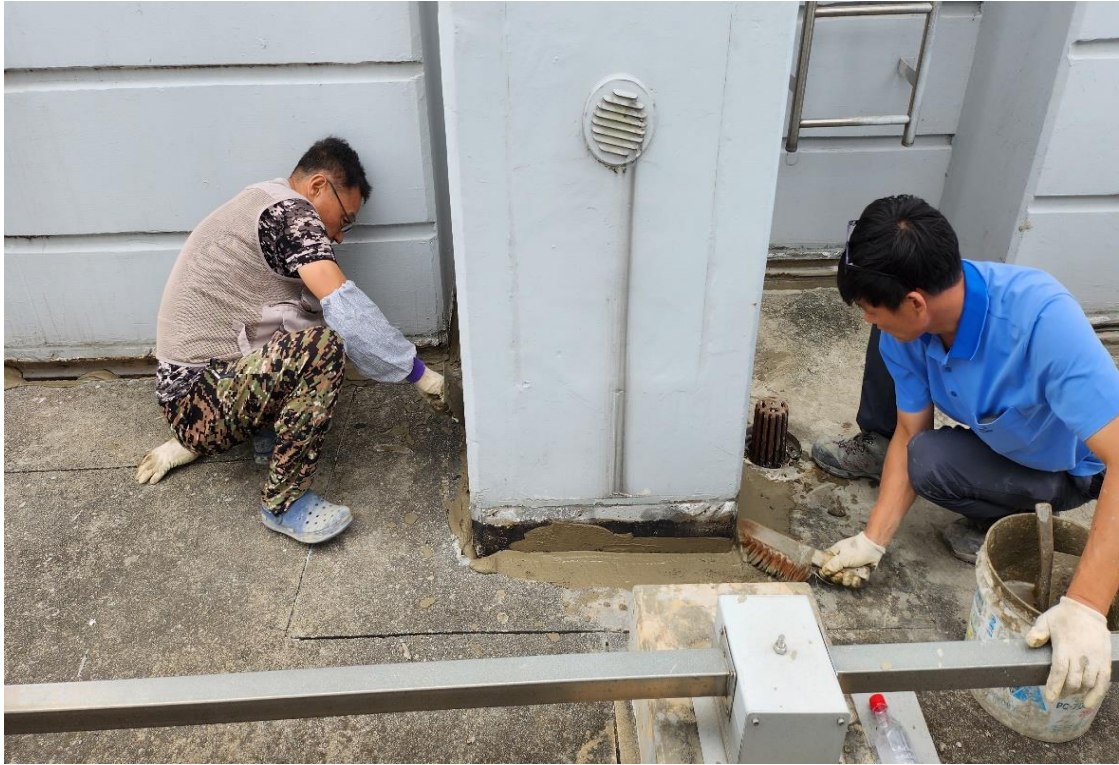
벽체 배수판 고강도 몰탈 미장 작업
