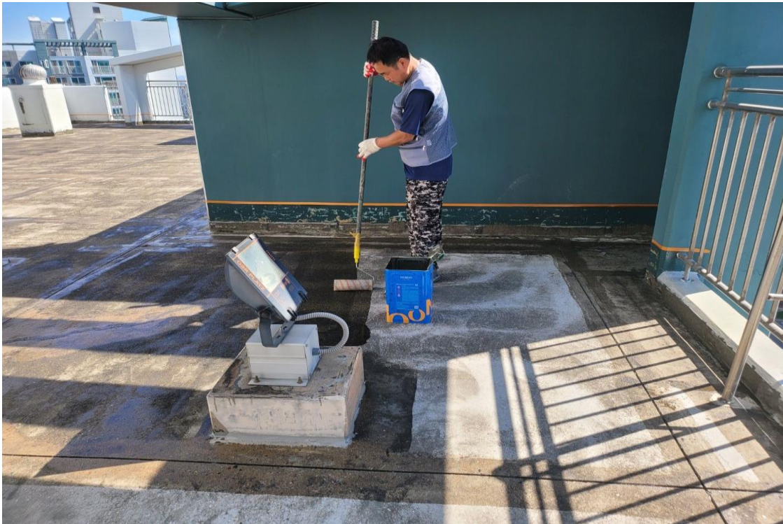
우레탄 하도(프라이머) 도포 작업
