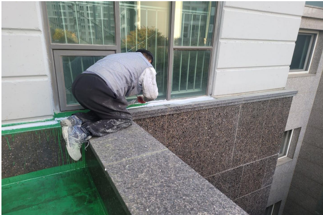
바닥 및 수직 접합부위 우레탄 실란트 작업
