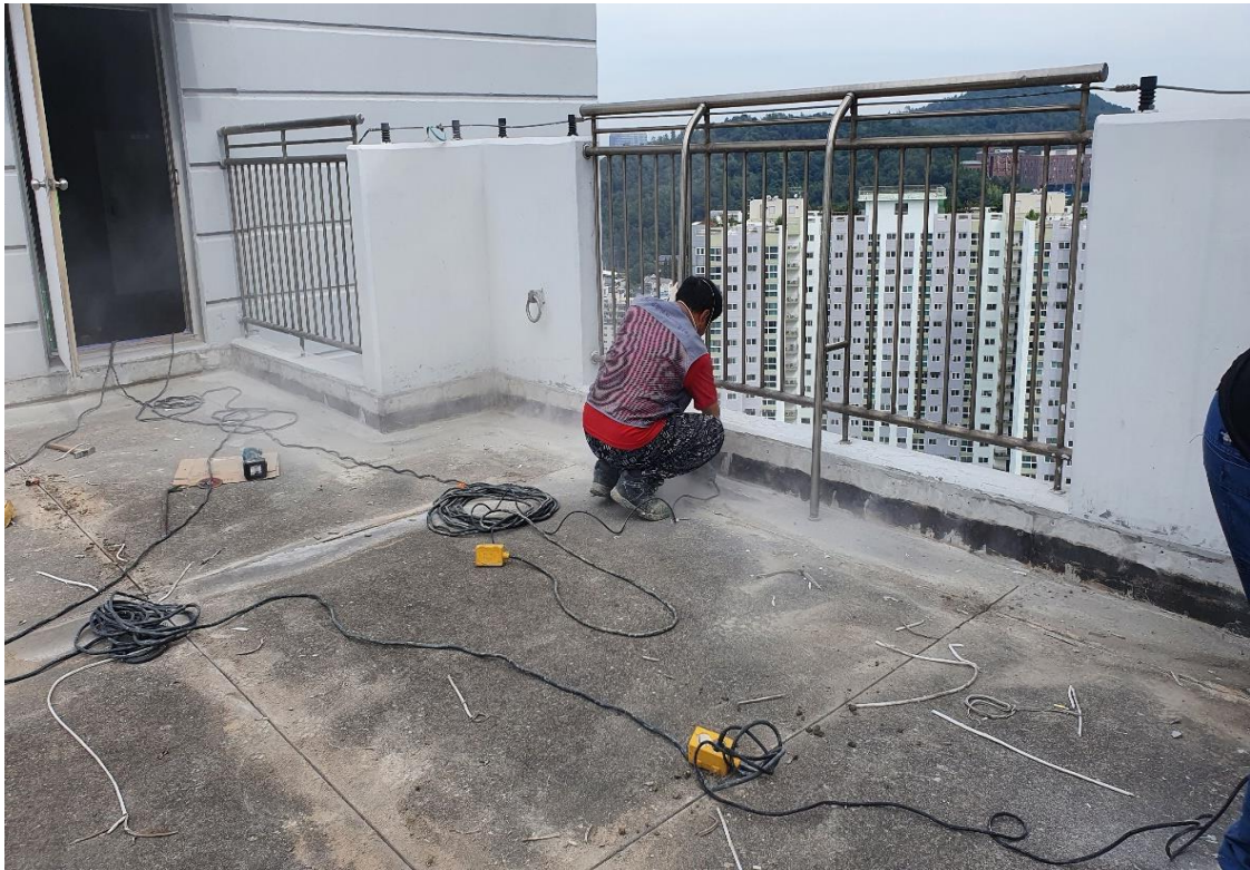
옥상 바닥 면 처리 작업
