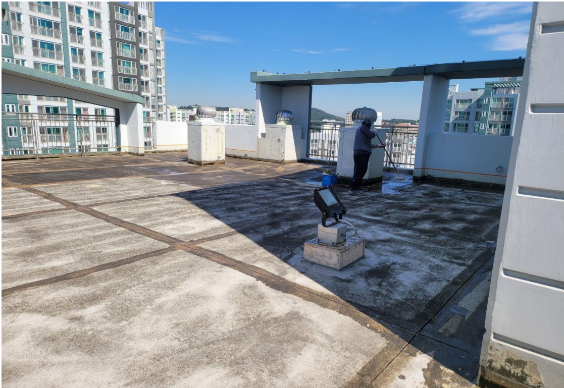
우레탄 하도(프라이머) 도포 작업
