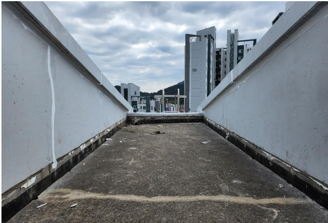
기계실 옥탑 실리콘 보수작업
