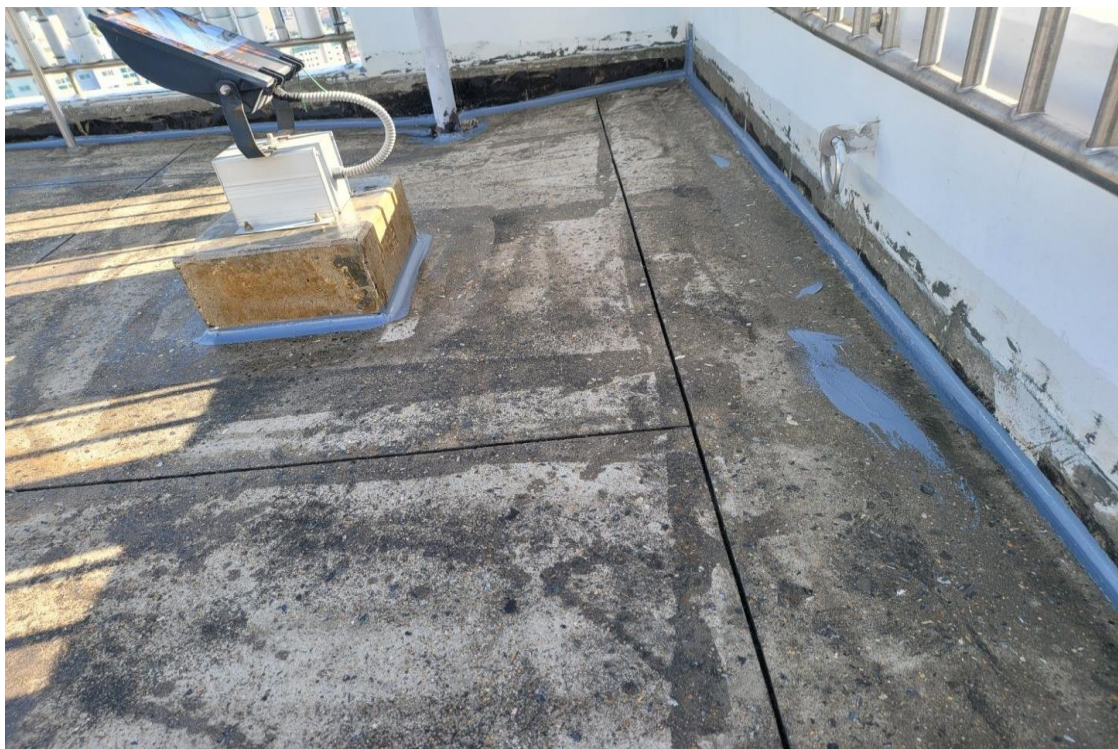
바닥 및 수직 접합부위 우레탄 실란트 작업
