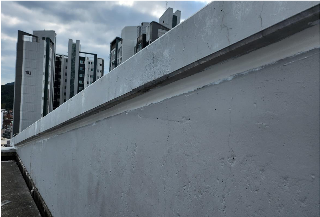
기계실 옥탑 실리콘 보수작업
