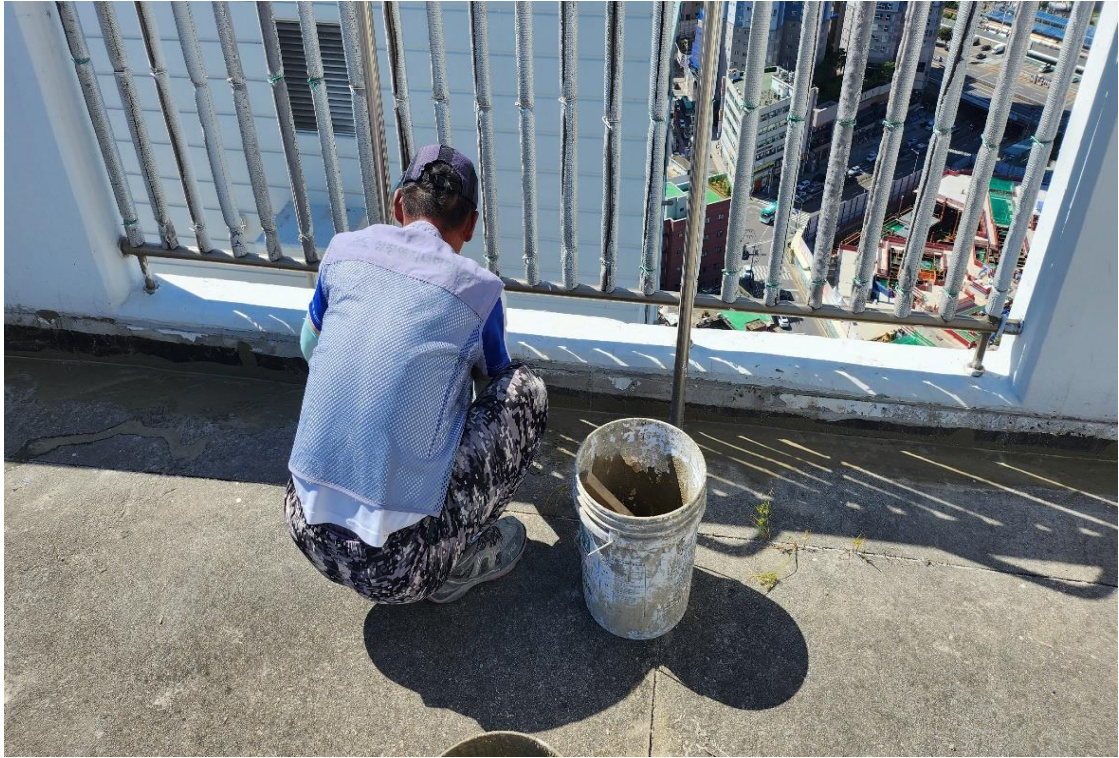
벽체 배수판 고강도 몰탈 미장 작업
