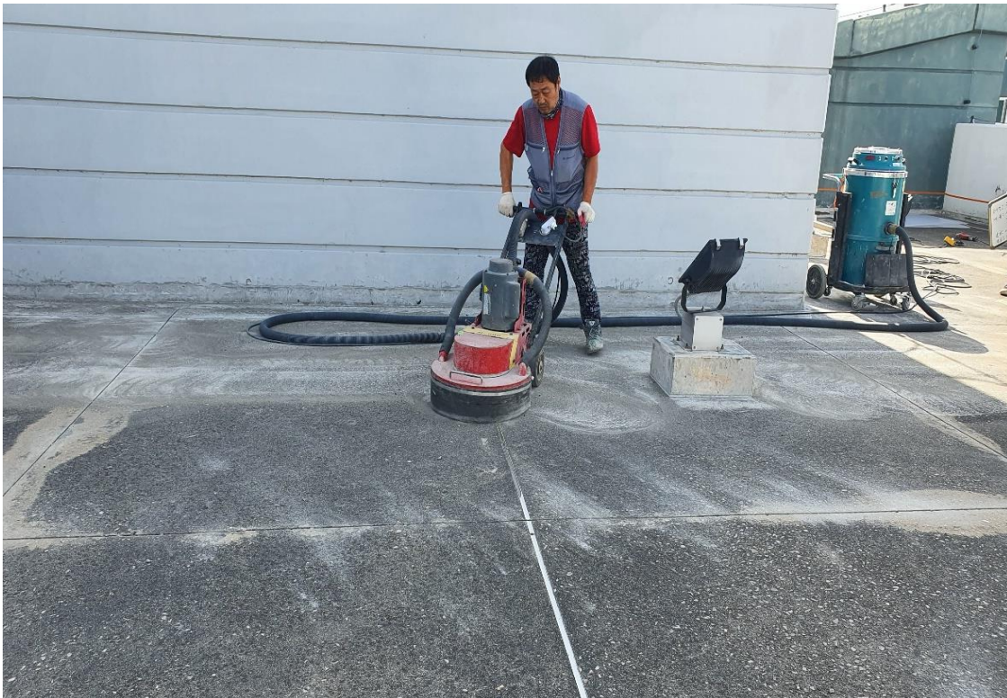
옥상 바닥 면 처리 작업
