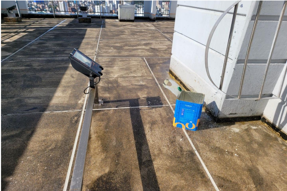
우레탄 하도(프라이머) 도포 작업
