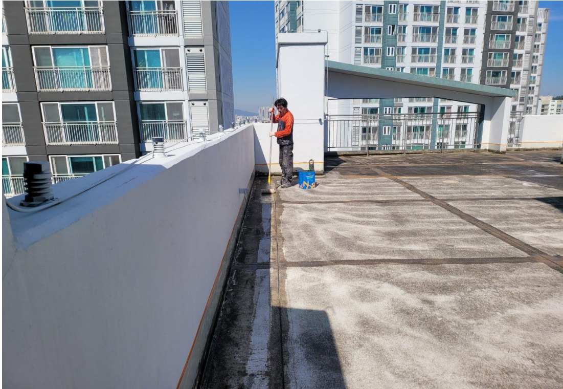
우레탄 하도(프라이머) 도포 작업
