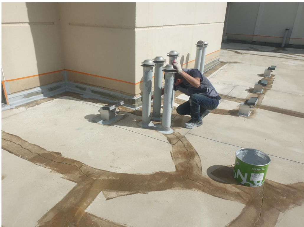
바닥 균열 및 조인트 부위 우레탄 프라이머 도포
