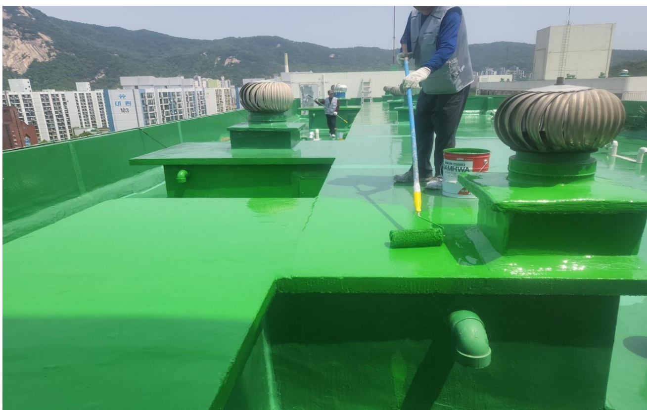
공사 중 (우레탄 중도 1차 도포)
