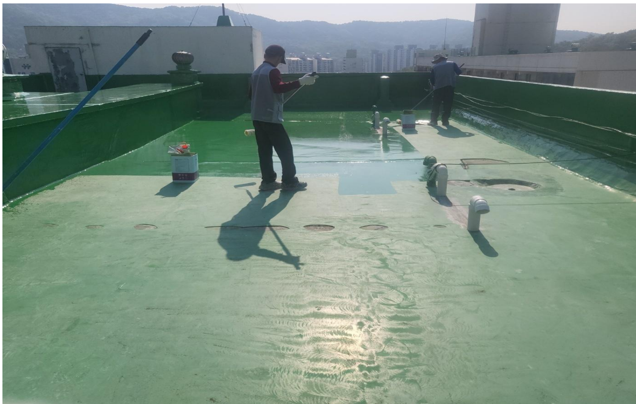
공사 중 (우레탄 하도 도포)
