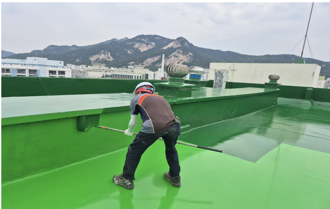
공사 중 (우레탄 상도 도포)
