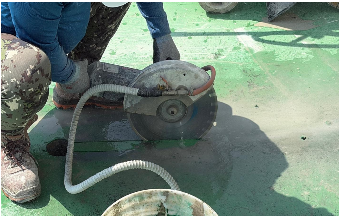
공사 중 (수분제거시스템 : 바닥면 커팅)
