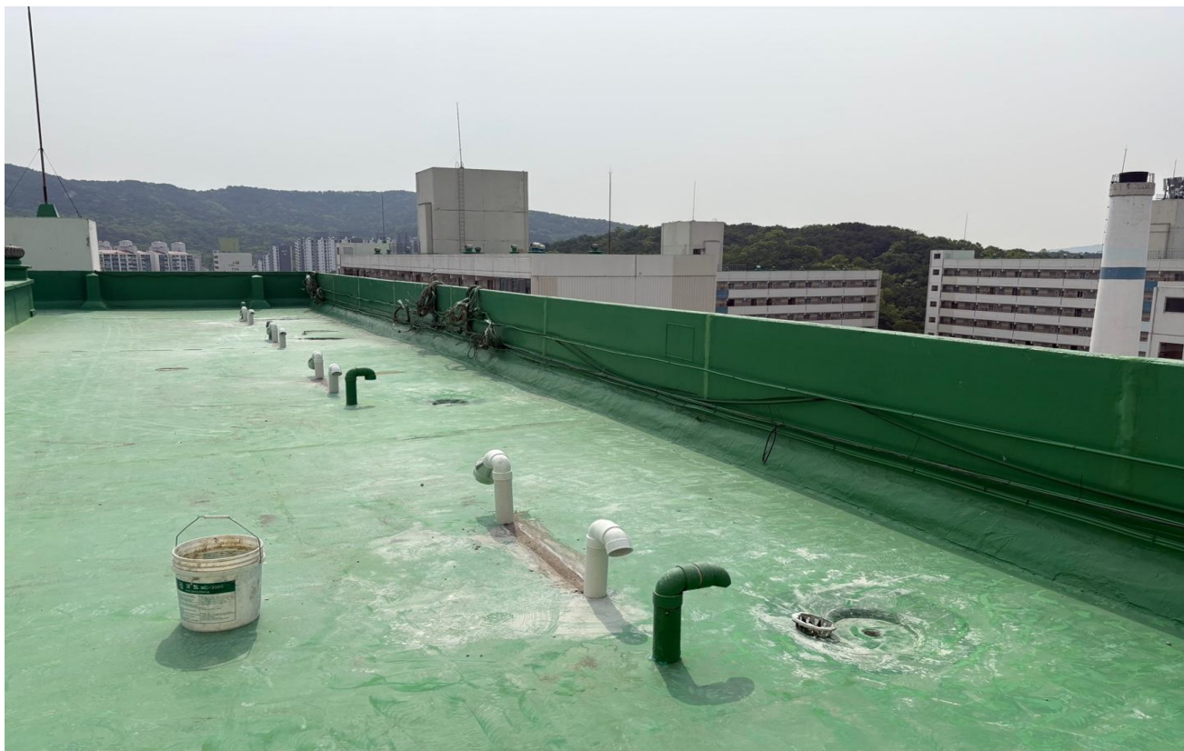
공사 중 (수분제거시스템 : 웬 설치, 미장 작업 후)
