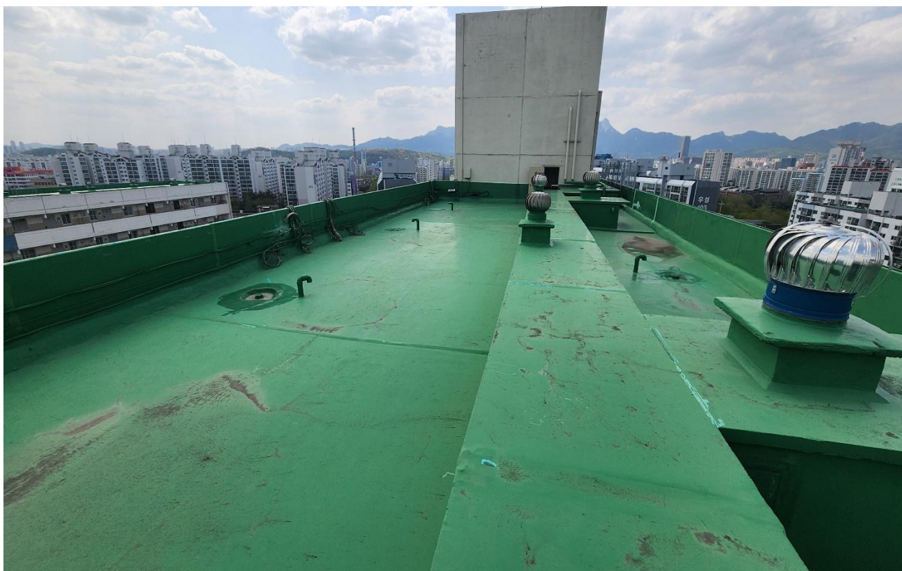
공사 전 (전경)
