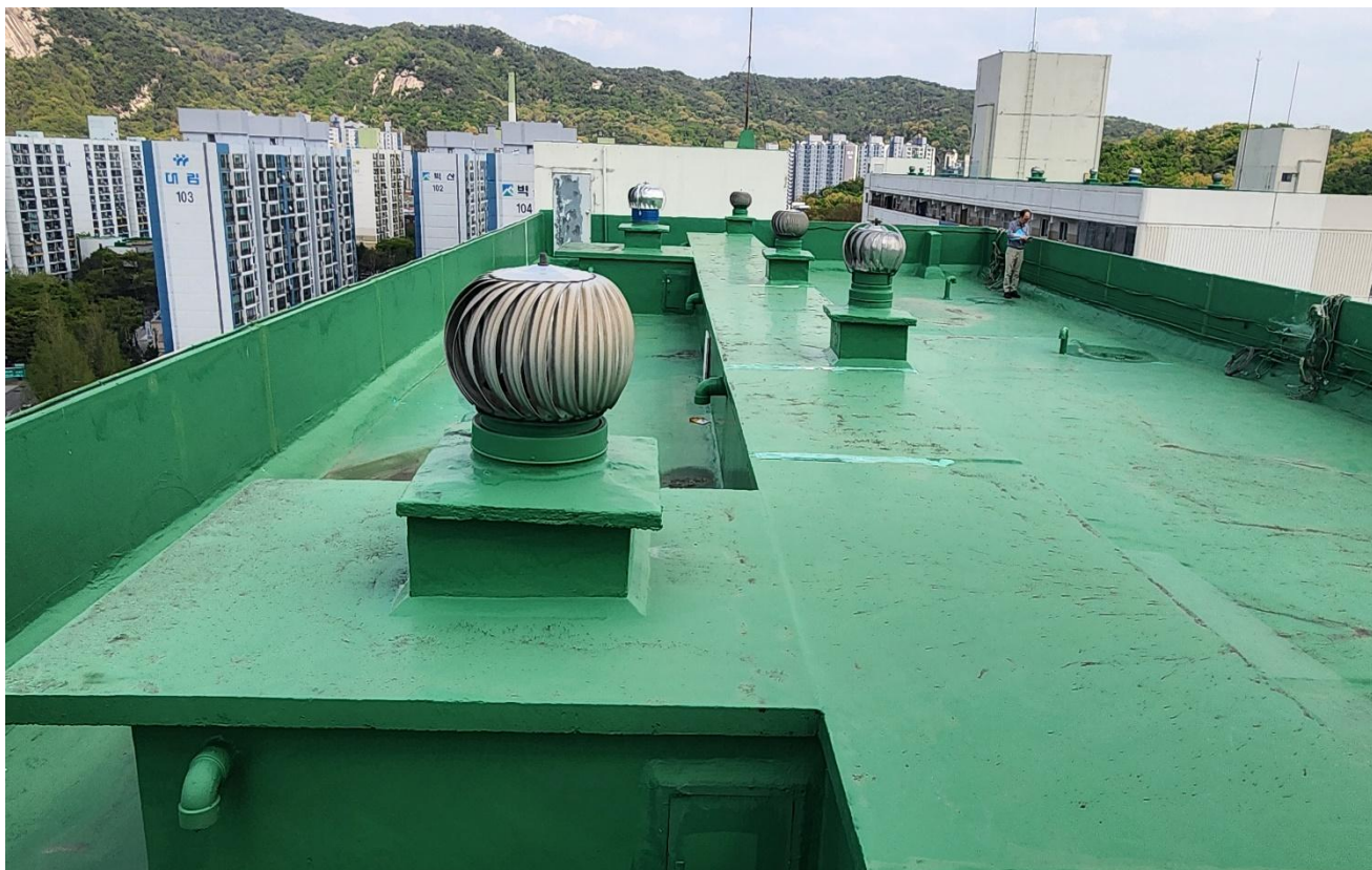
공사 전 (전경)
