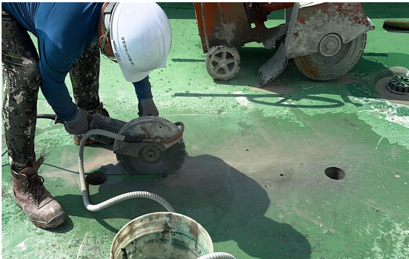
공사 중 (수분제거시스템 : 바닥면 커팅)
