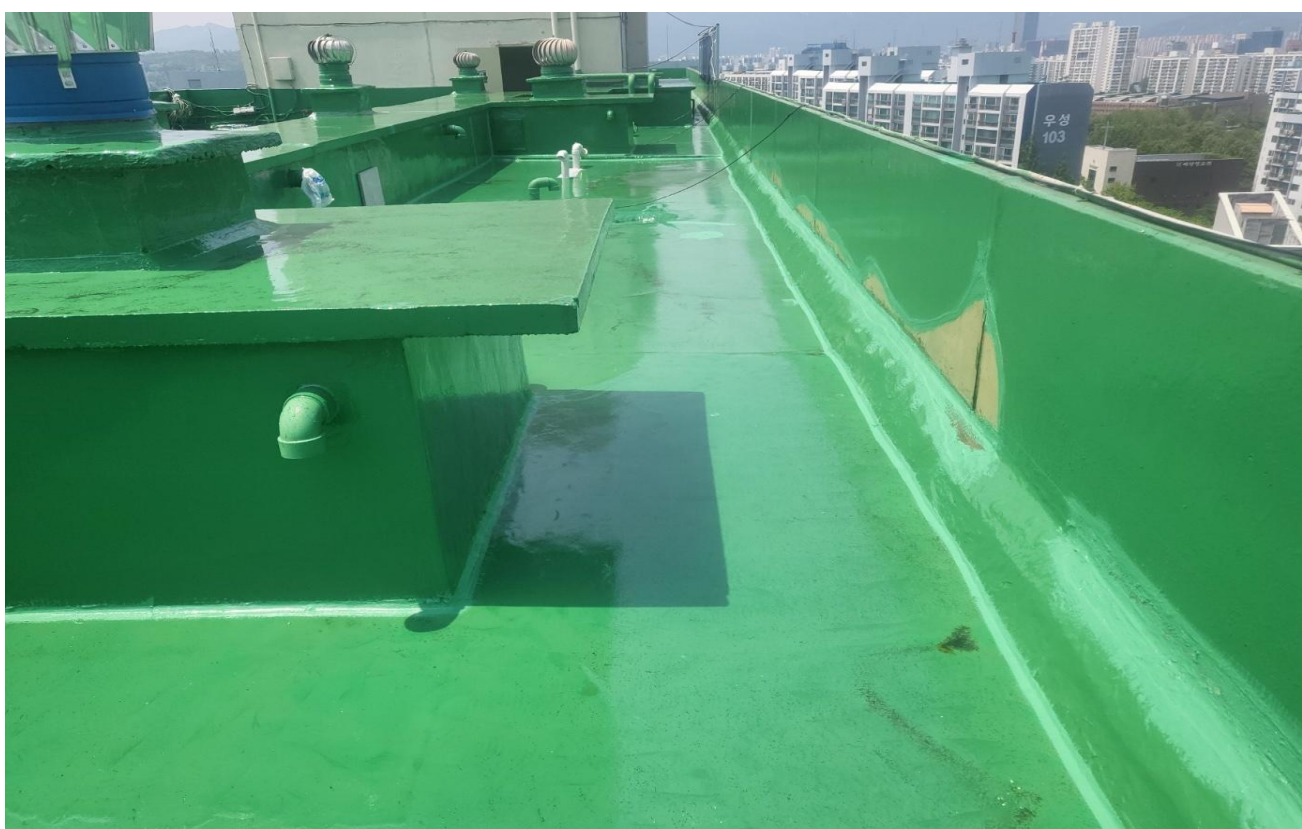
공사 중 (우레탄 실란트 도포 후)
