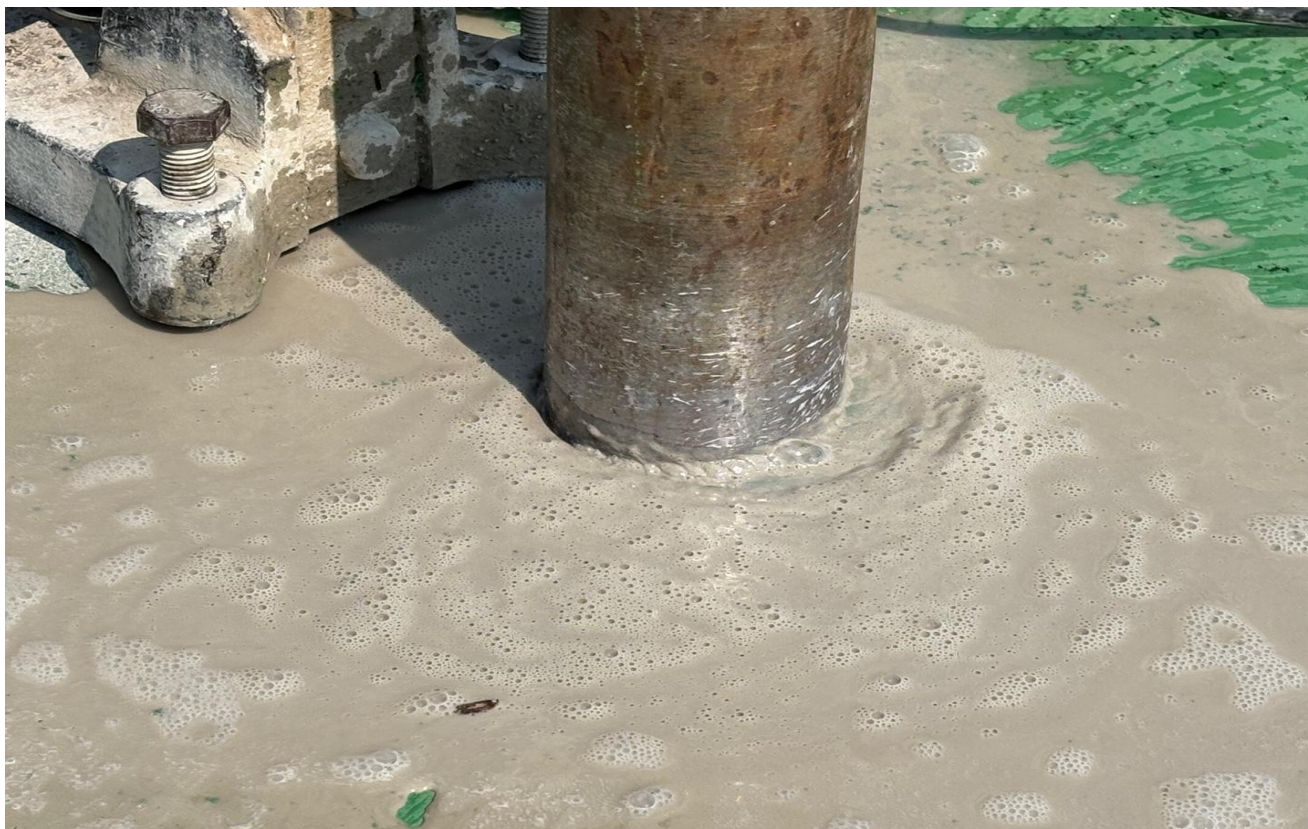
공사 중 (수분제거시스템 : 코어드릴 작업)
