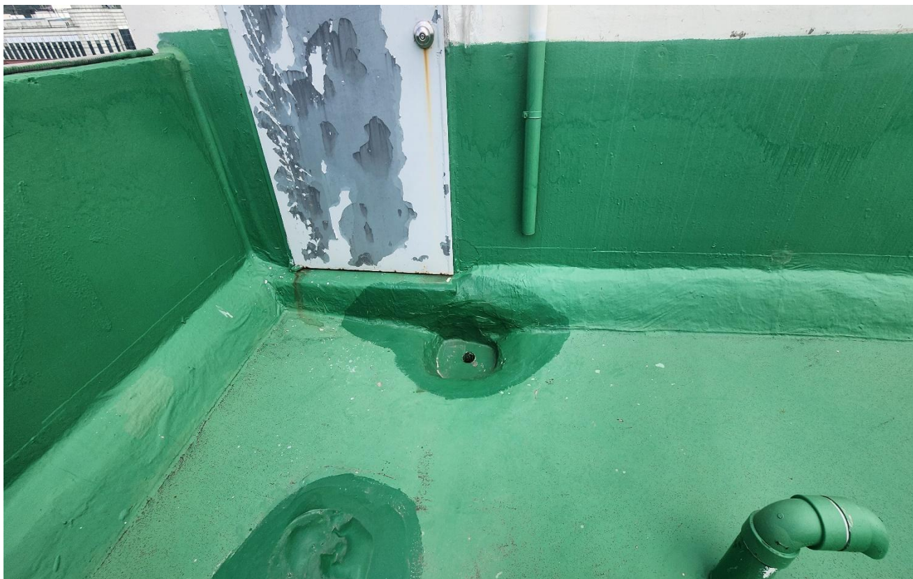
공사 전 (드레인)
