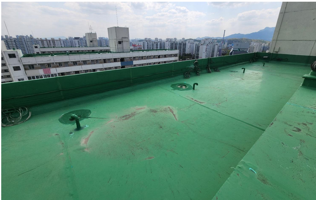
공사 전 (전경)
