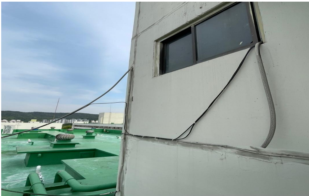
공사 중 (수분제거시스템 : 전선 연결)
