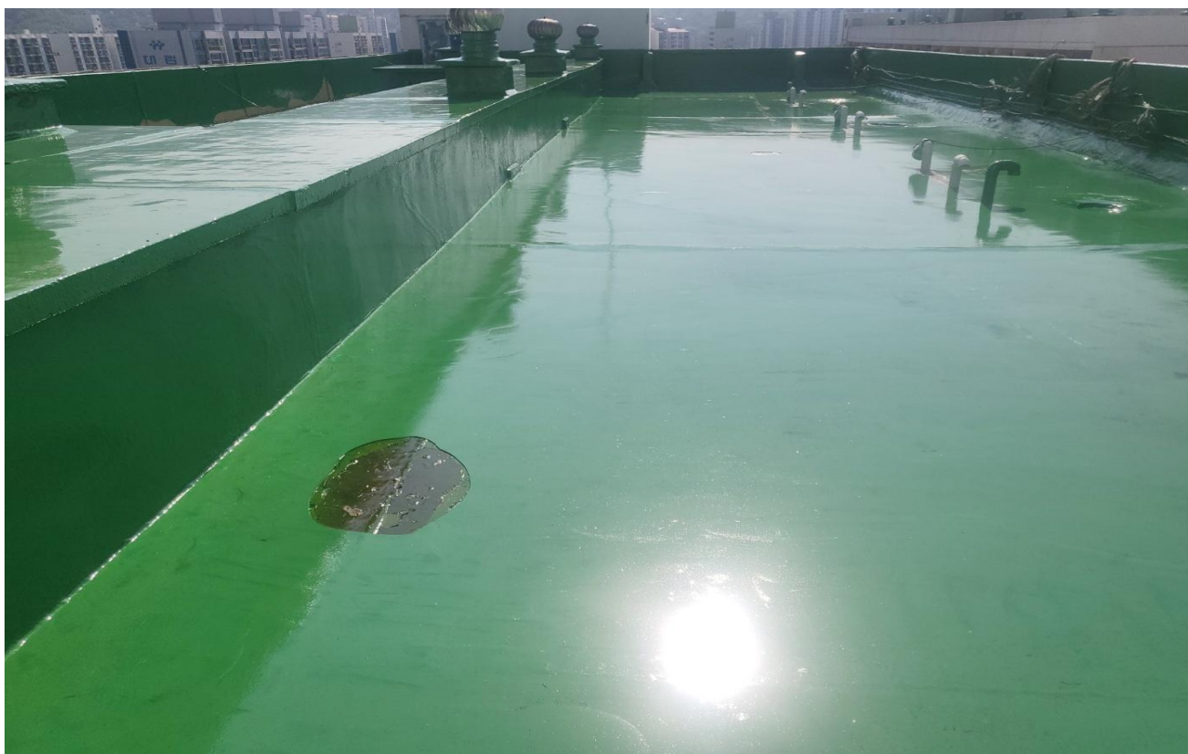
공사 중 (우레탄 하도 도포)
