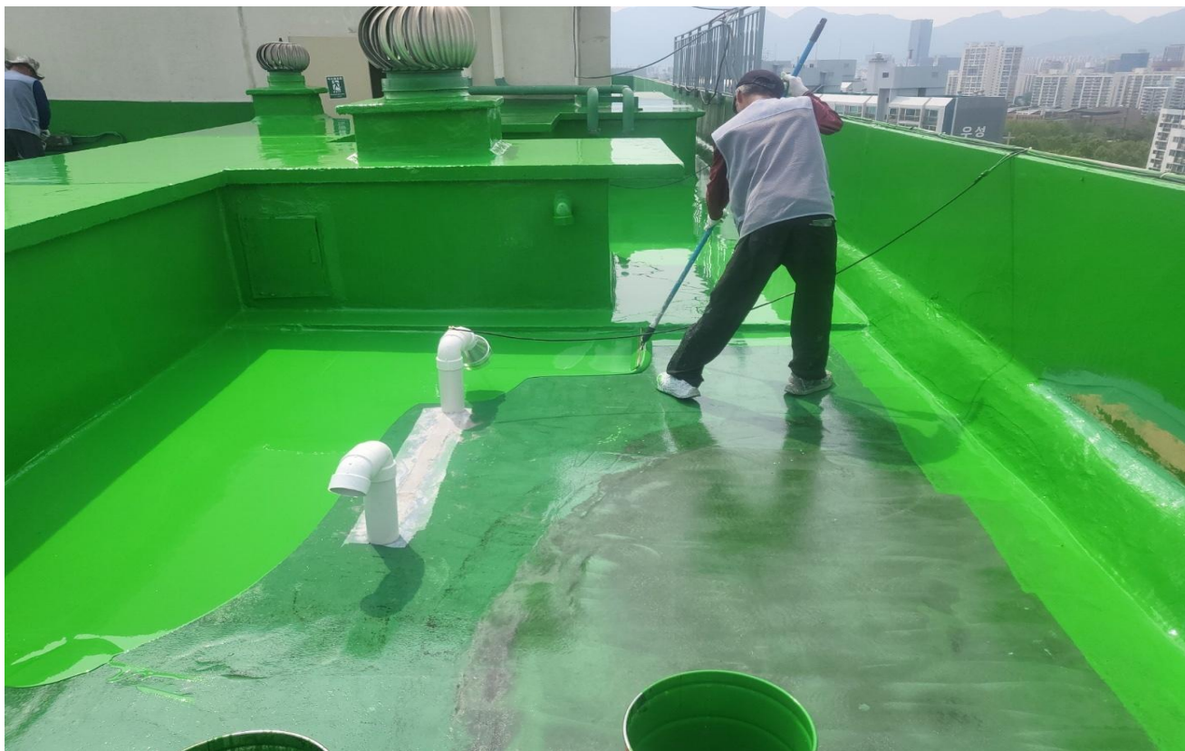
공사 중 (우레탄 중도 1차 도포)
