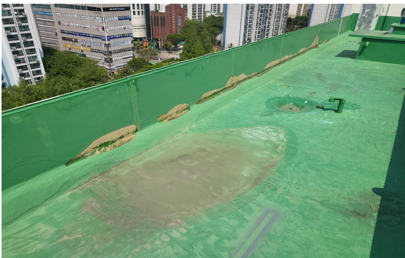
공사 중 (바탕면 정리)
