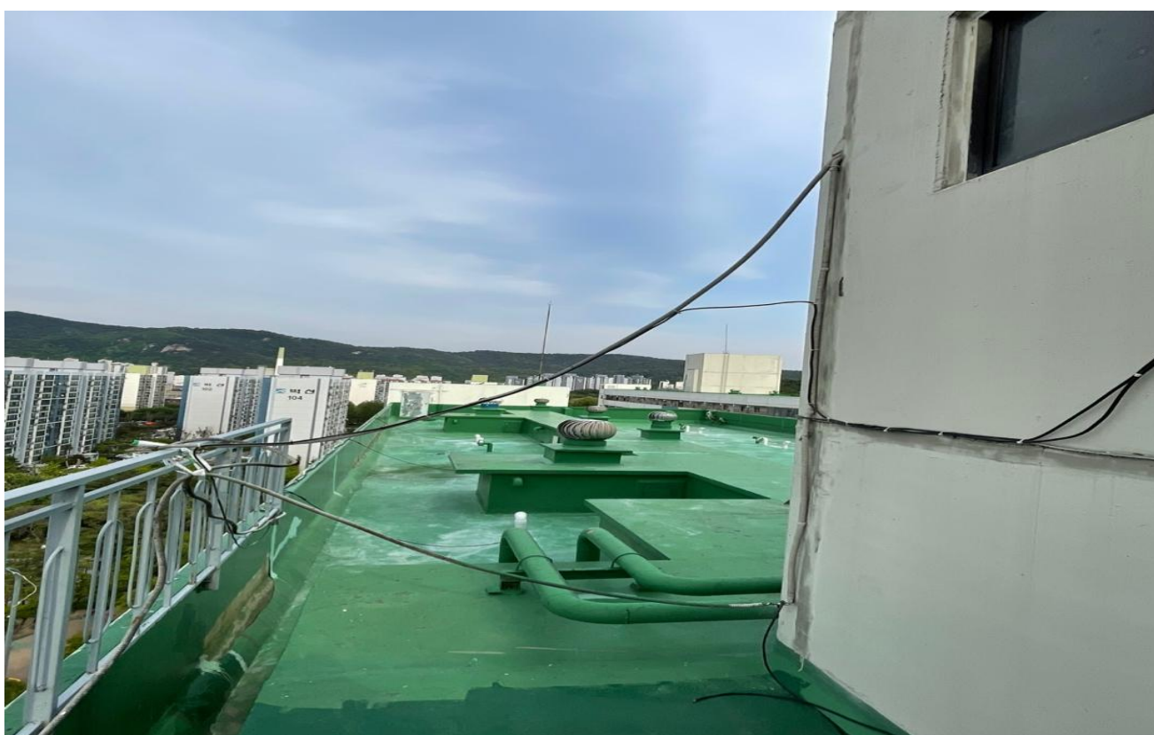
공사 중 (수분제거시스템 : 전선 연결)
