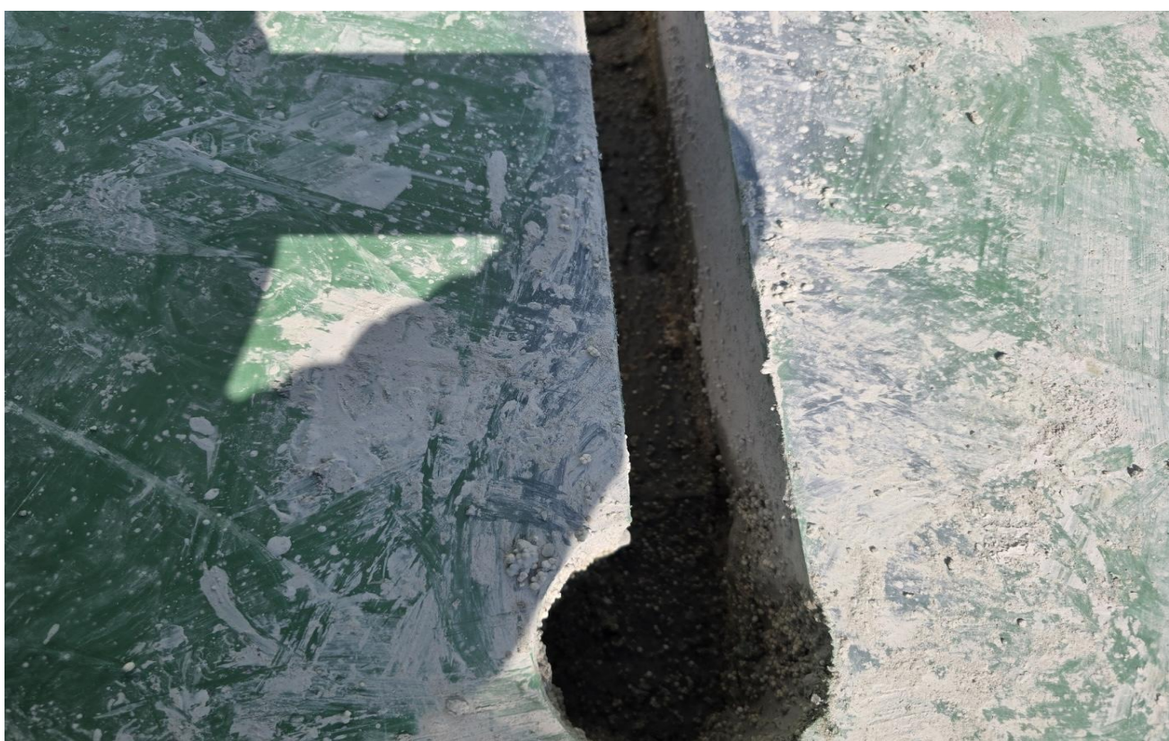
공사 중 (수분제거시스템 : 바닥면 커팅 후)
