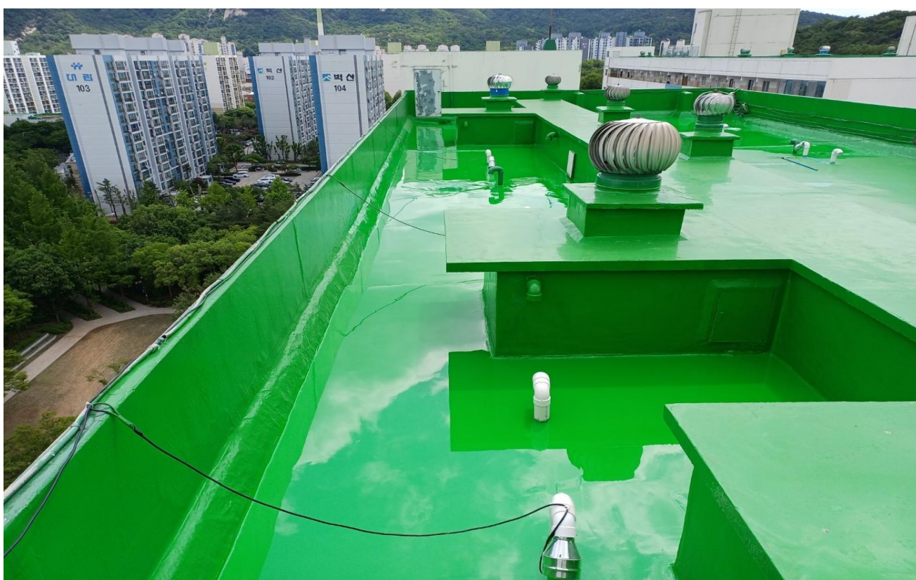
공사 중 (우레탄 중도 2차 도포 후)
