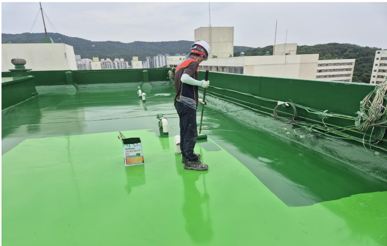
공사 중 (우레탄 상도 도포)
