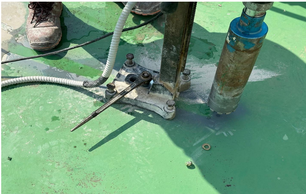
공사 중 (수분제거시스템 : 코어드릴 작업)
