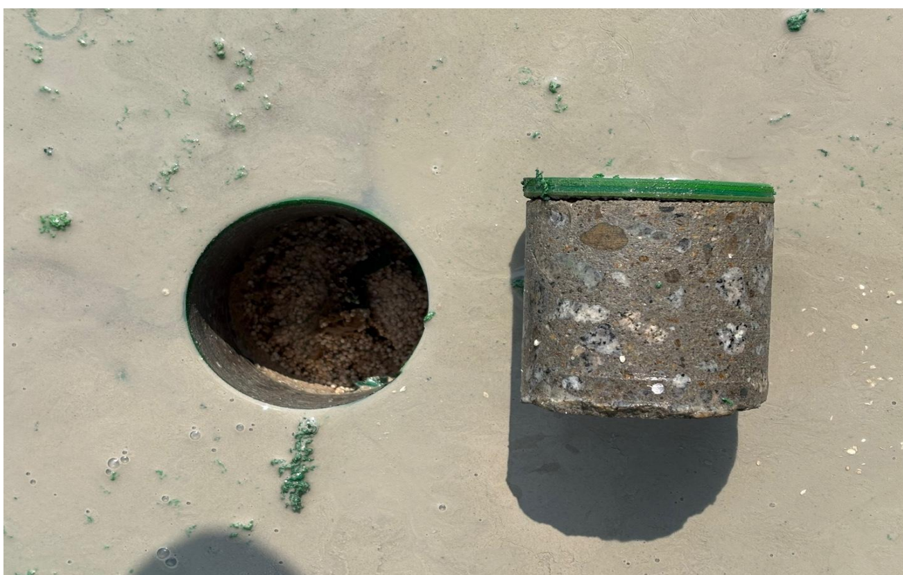
공사 중 (수분제거시스템 : 코어드릴 작업 후)
