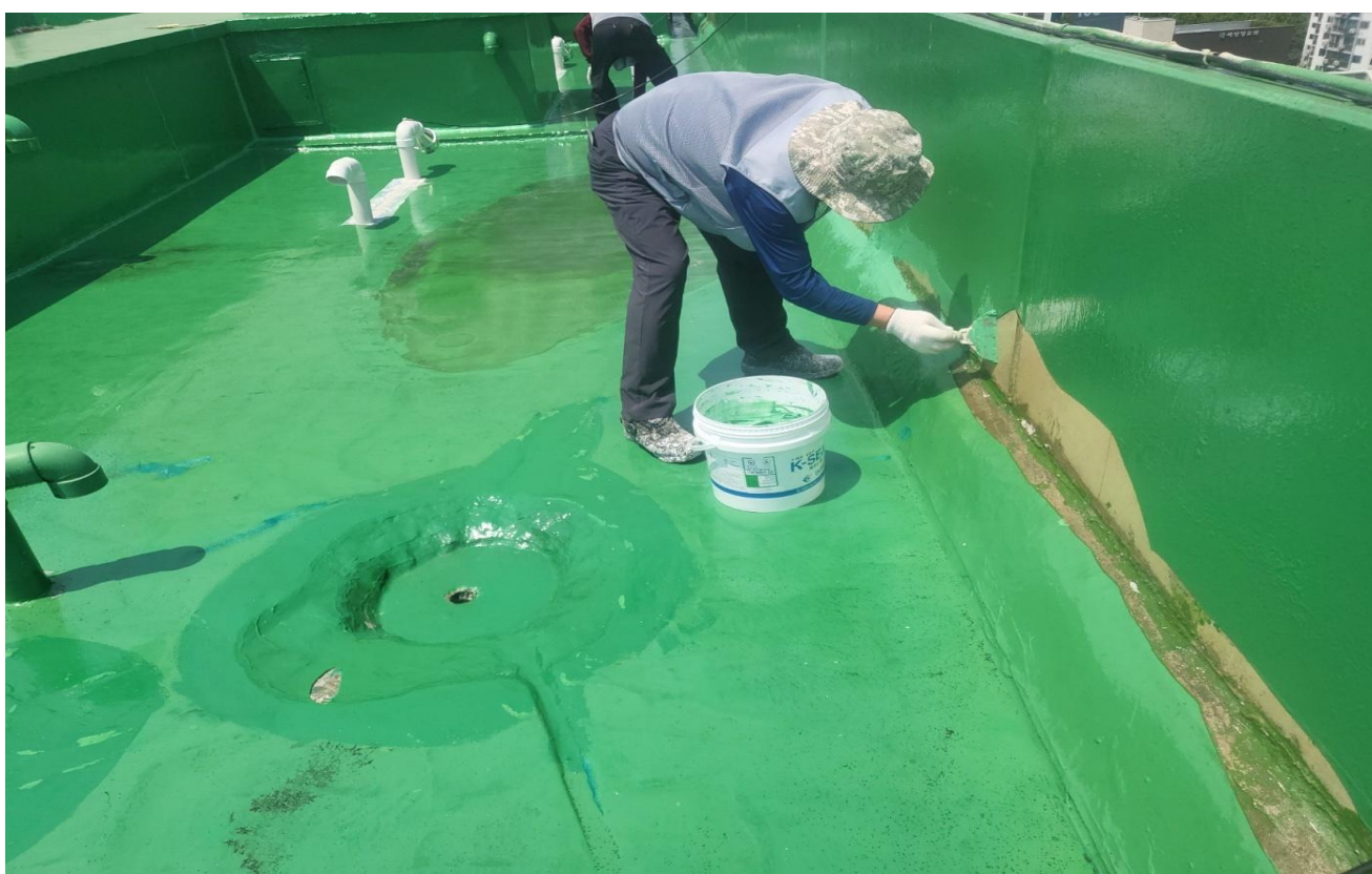
공사 중 (우레탄 실란트 도포)
