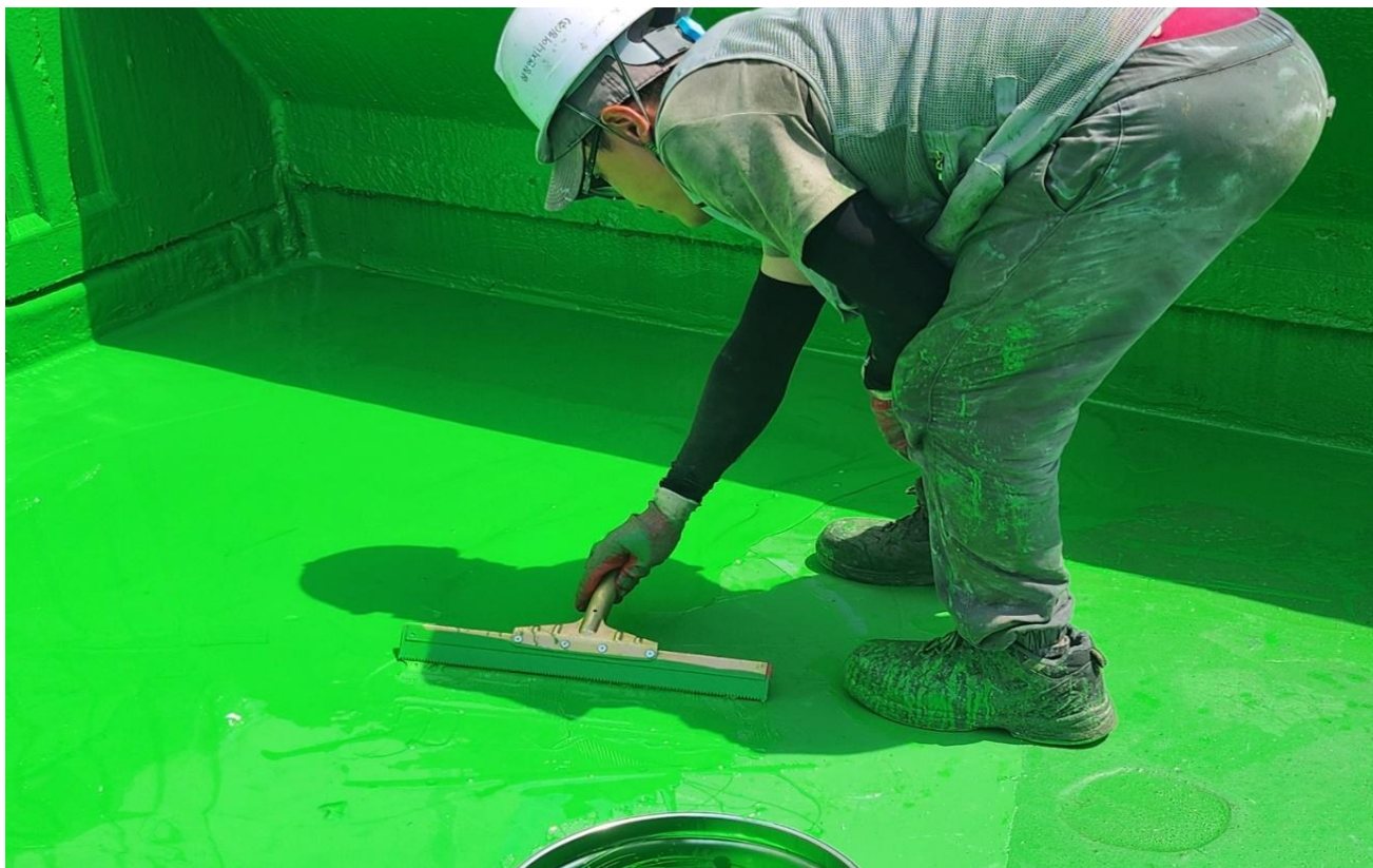
공사 중 (우레탄 중도 2차 도포)
