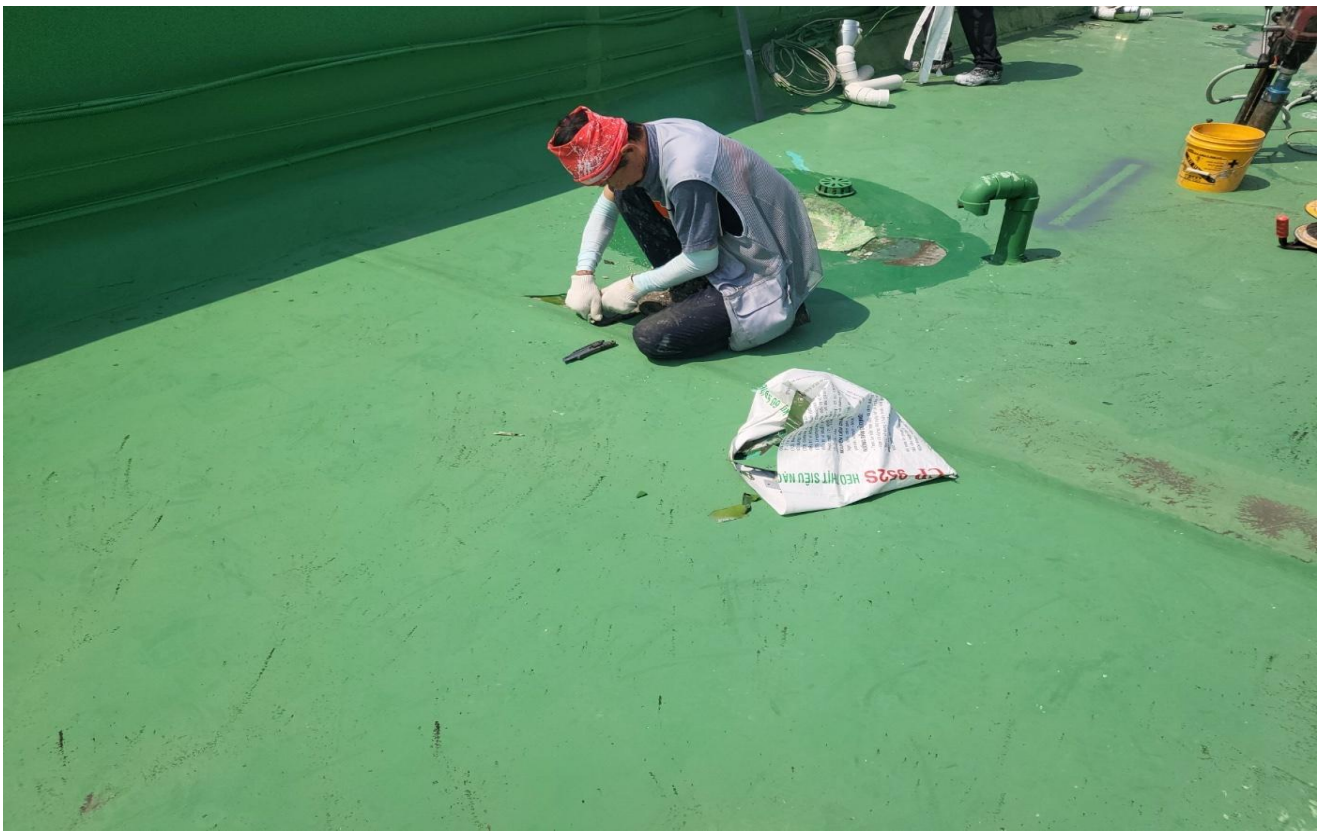
공사 중 (바탕면 정리)
