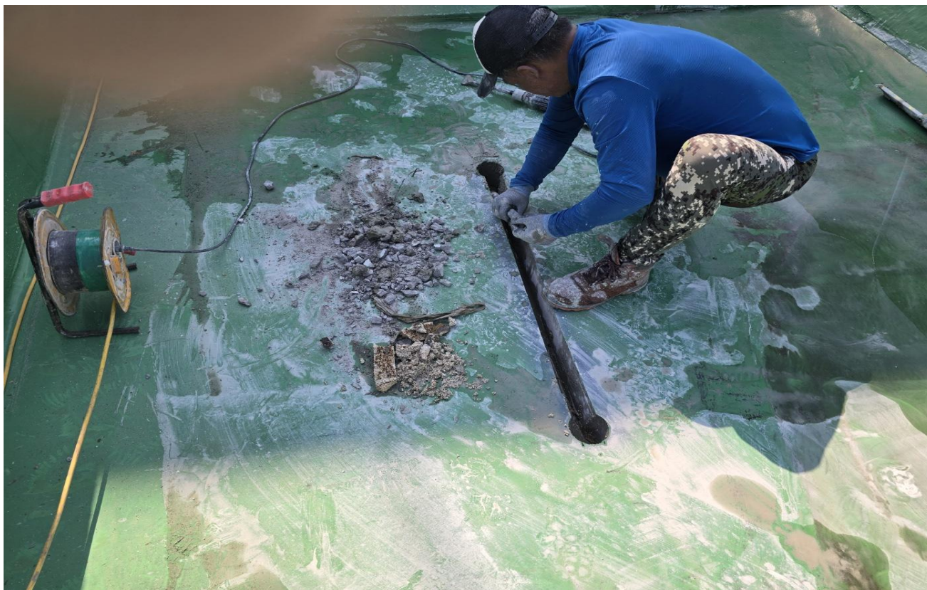
공사 중 (수분제거시스템 : 슬러지 제거)
