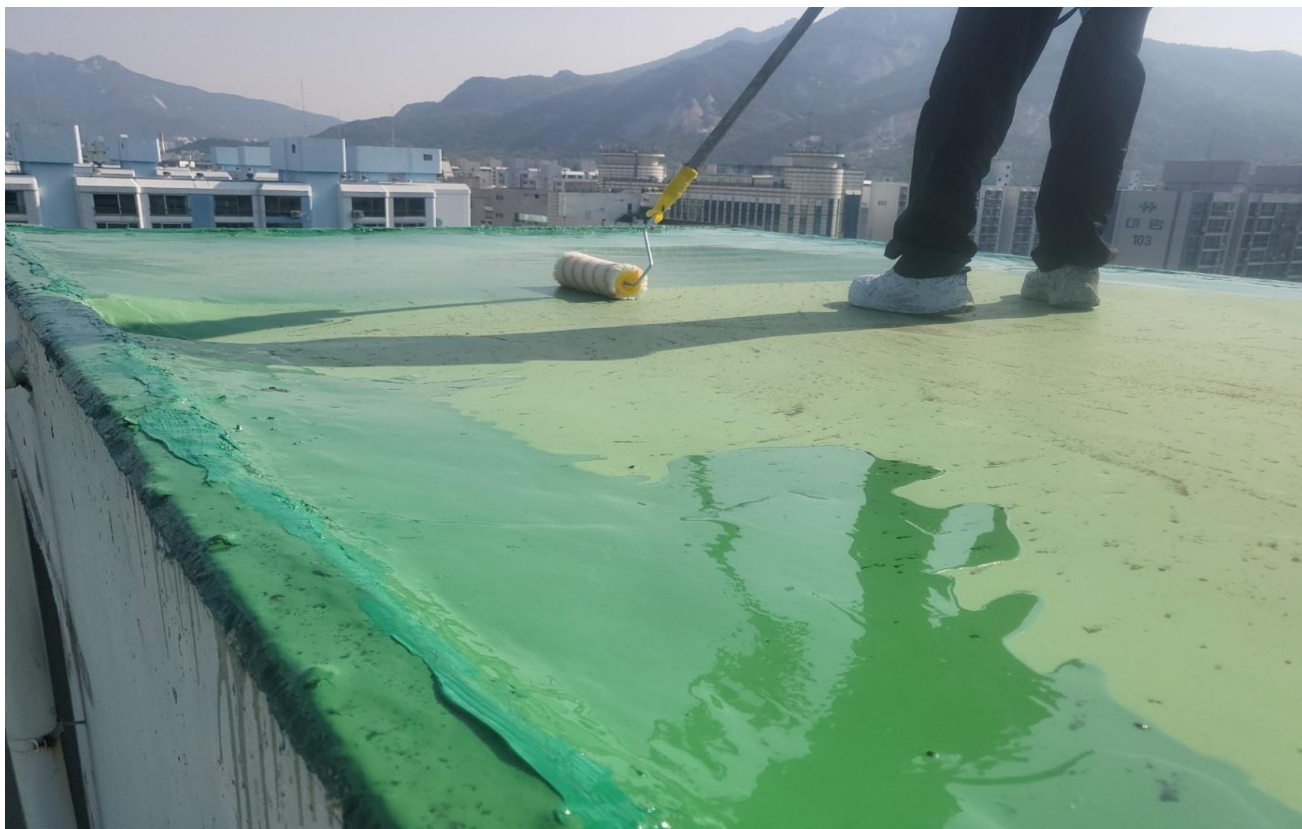
공사 중 (우레탄 하도 도포)
