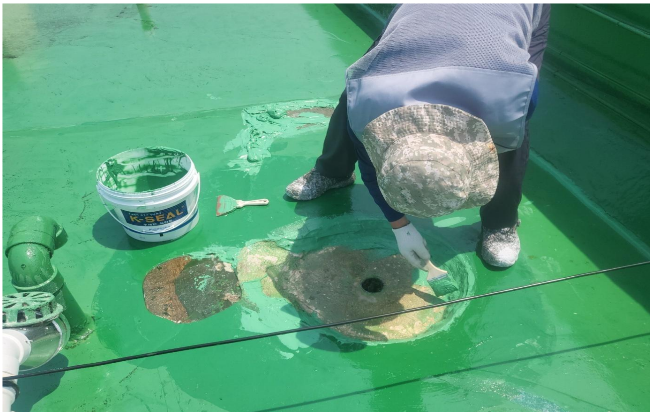
공사 중 (우레탄 실란트 도포)
