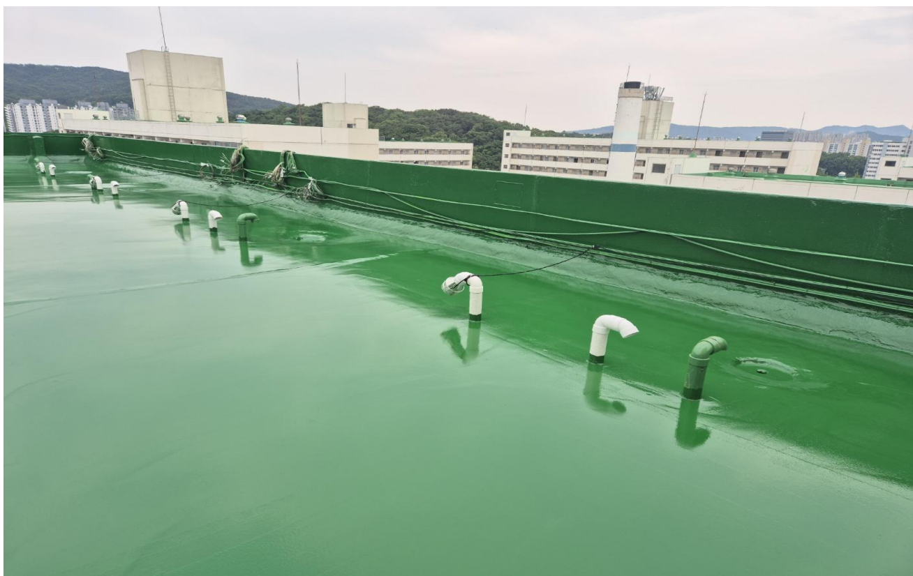
공사 중 (우레탄 상도 도포 후)
