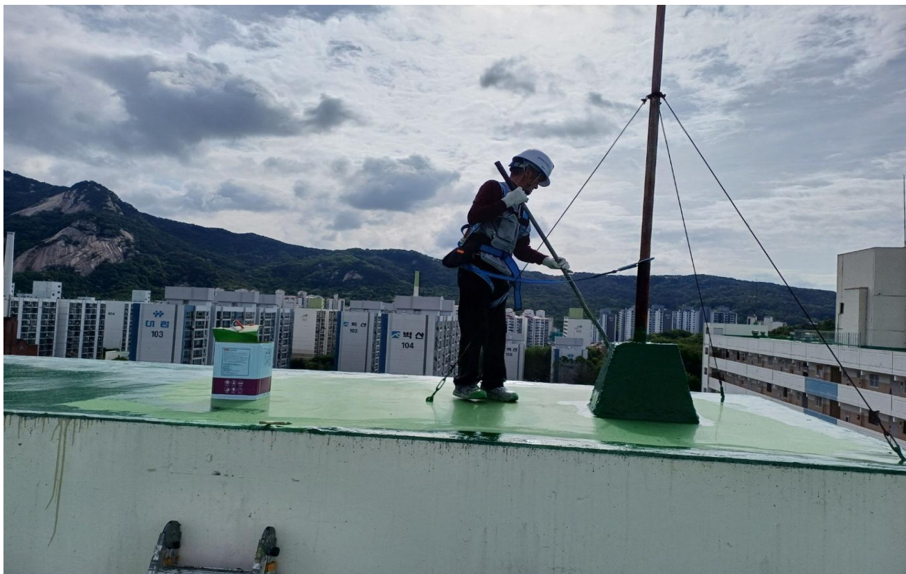
공사 중 (우레탄 상도 도포)
