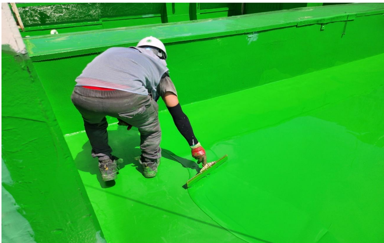
공사 중 (우레탄 중도 2차 도포)
