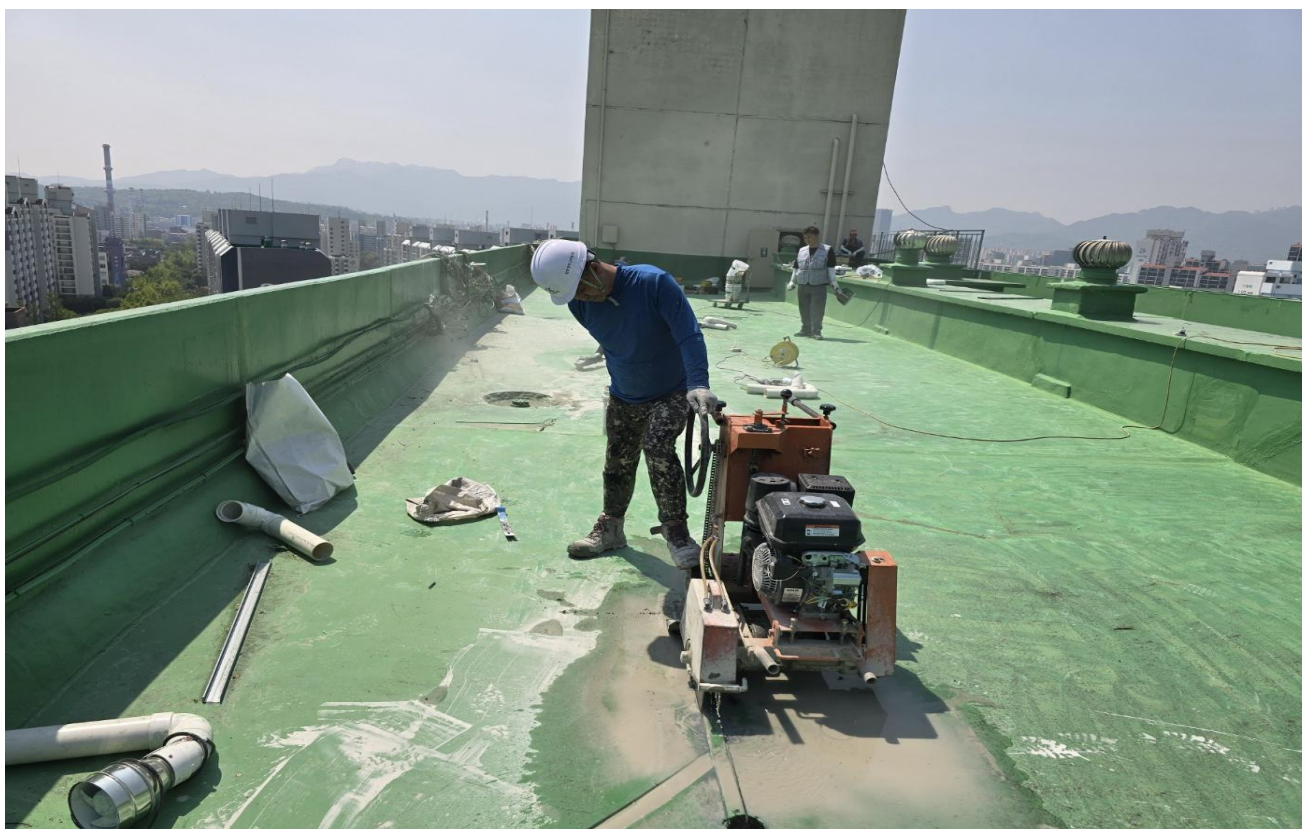
공사 중 (수분제거시스템 : 바닥면 커팅)
