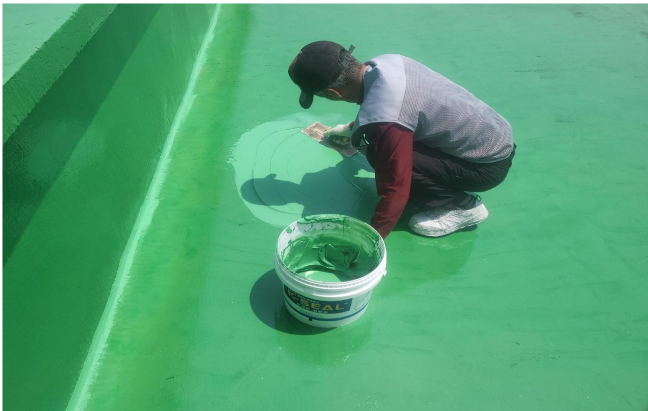
공사 중 (우레탄 실란트 도포)
