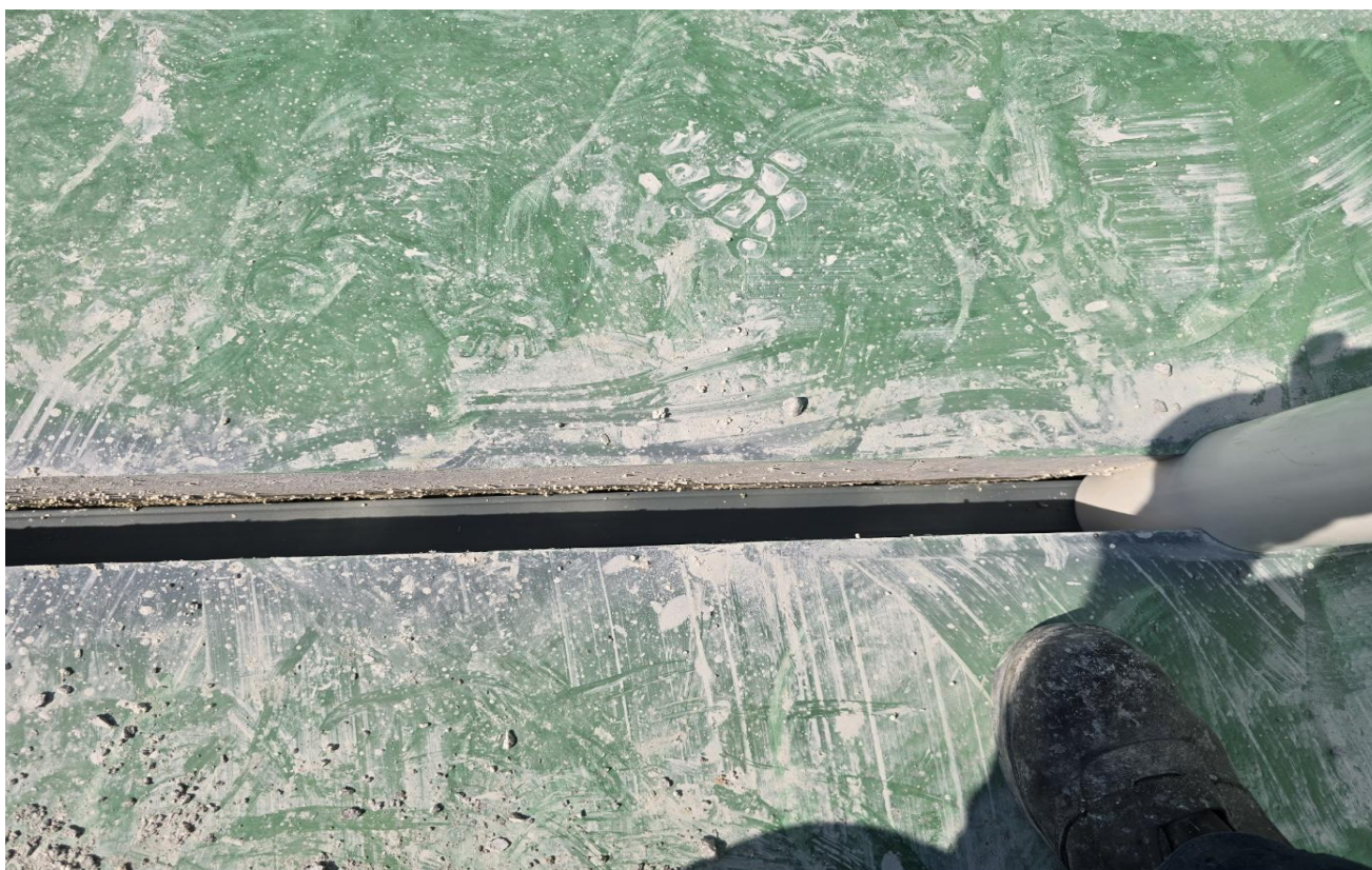
공사 중 (수분제거시스템 : 유바관 매립 및 파이프 설치)
