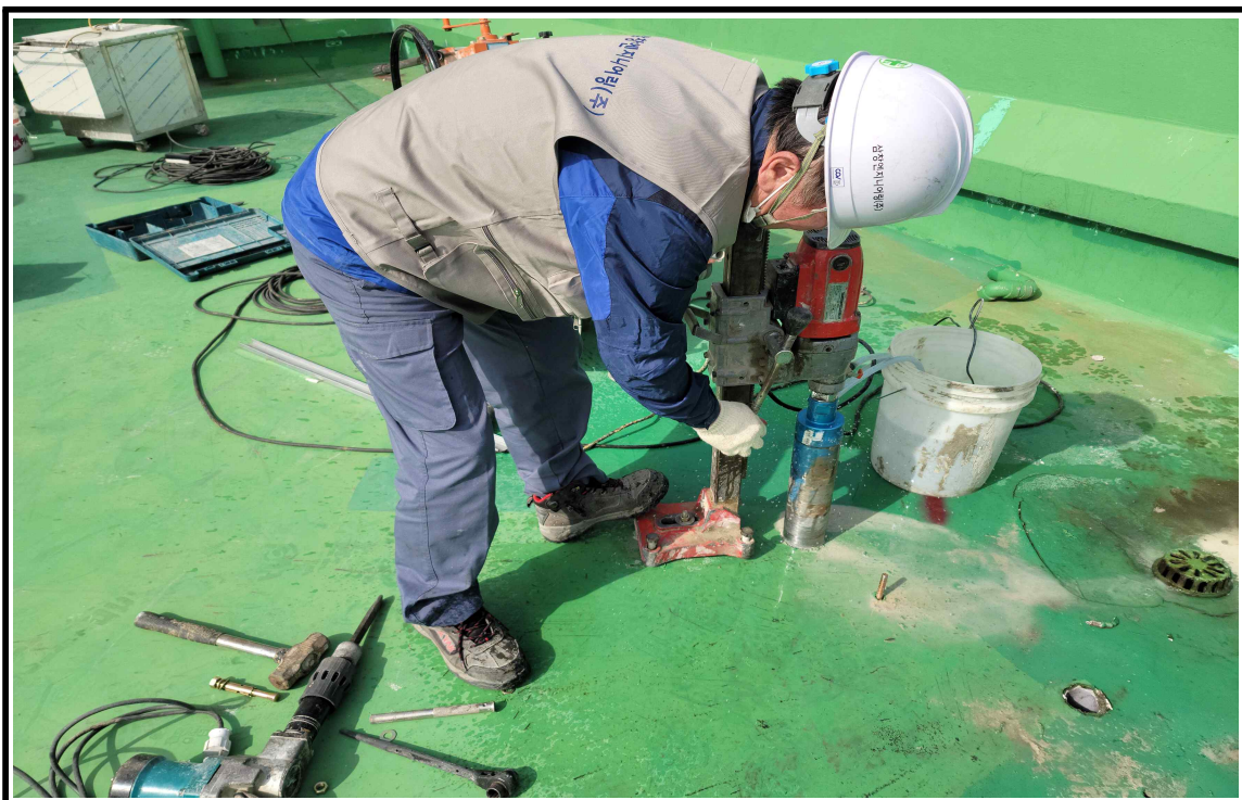
◎ 시공 중(통기관 작업 중)
