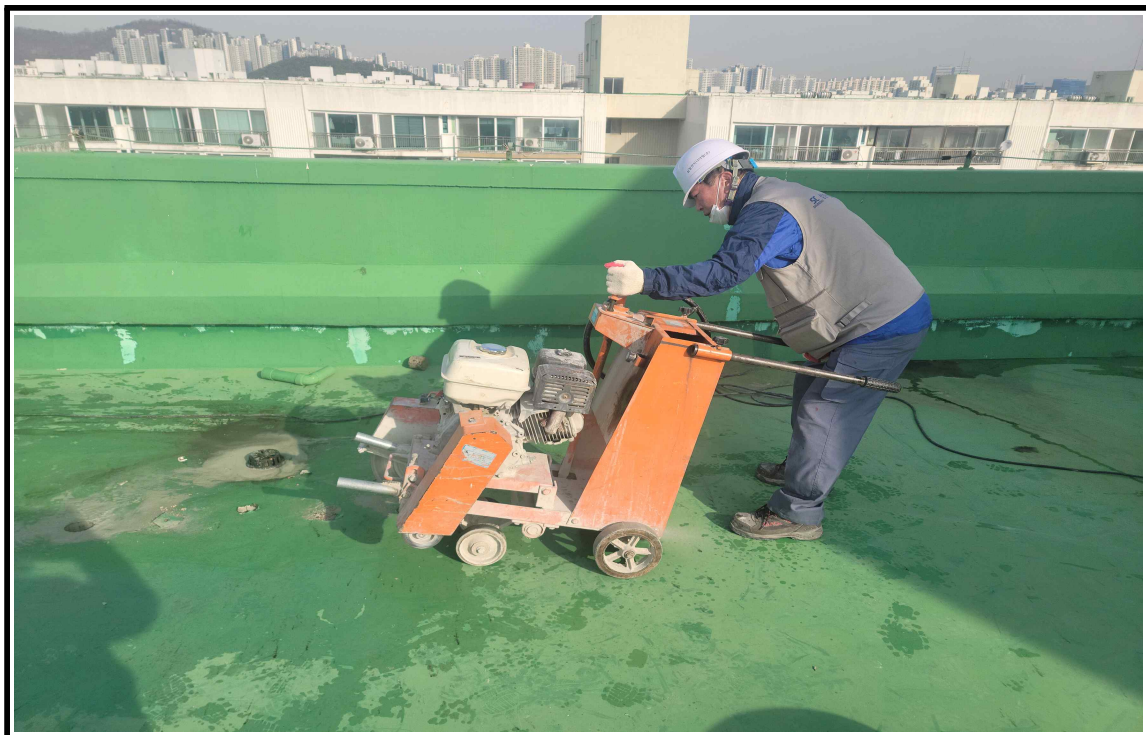
◎ 시공 중(통기관 작업 중)
