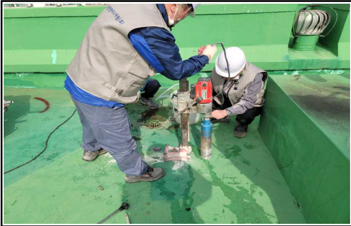
◎ 시공 중(통기관 작업 중)
