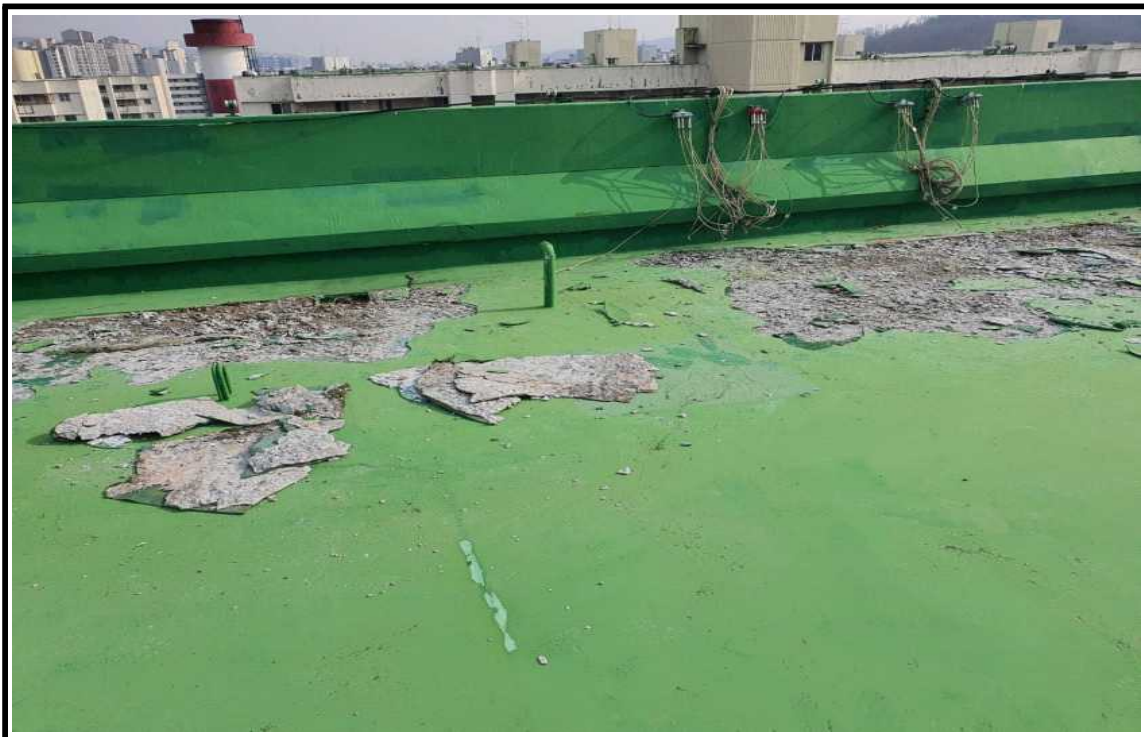
◎ 공사 중(불량우레탄 제거작업)
