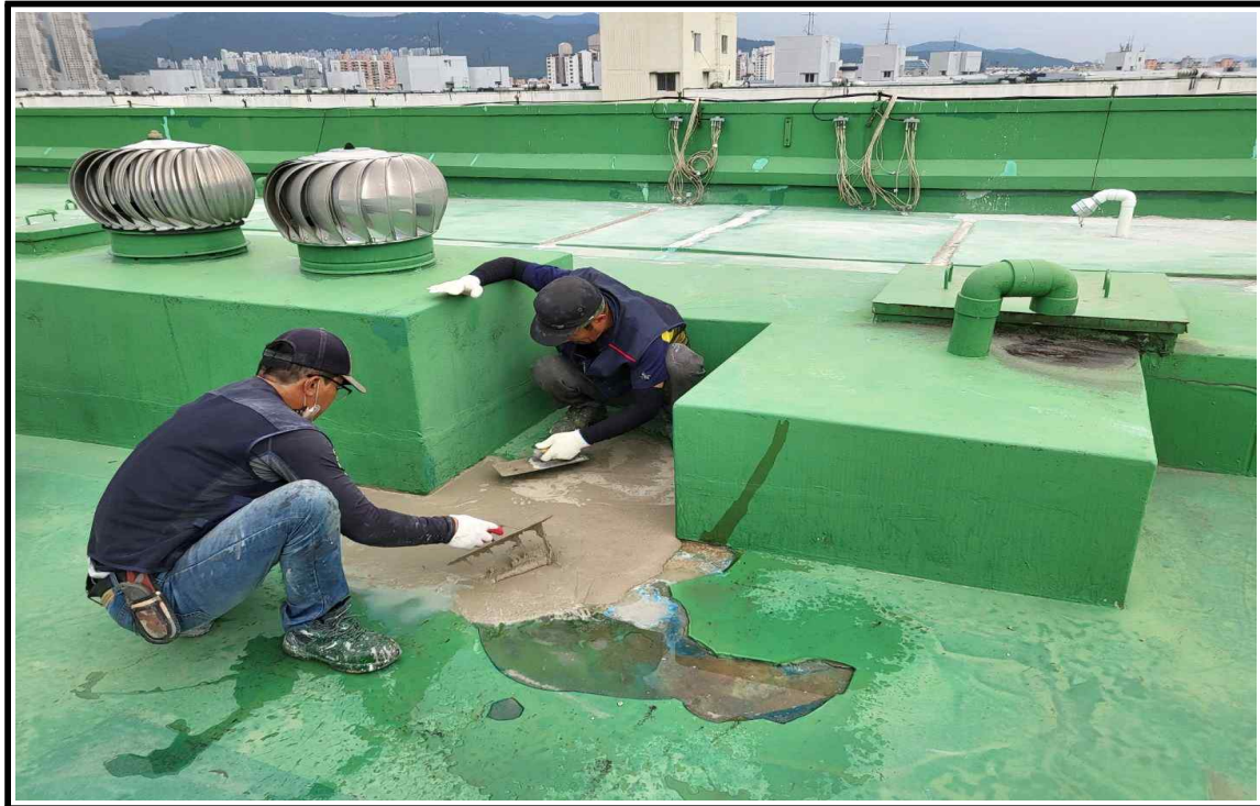
◎ 시공 중(미장 작업중)
