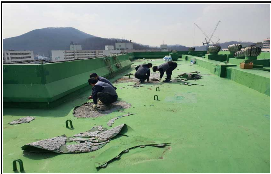
◎ 공사 중(불량우레탄 제거작업)
