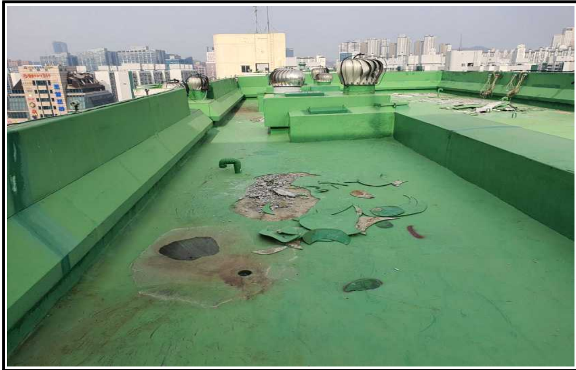
◎ 공사 중(불량우레탄 제거작업)
