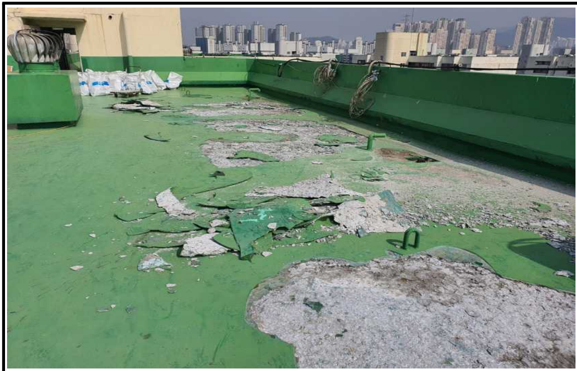
◎ 공사 중(불량우레탄 제거작업)
