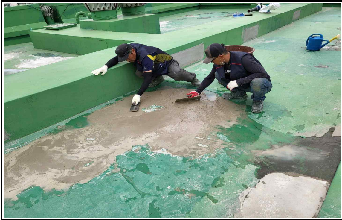
◎ 시공 중(미장 작업중)
