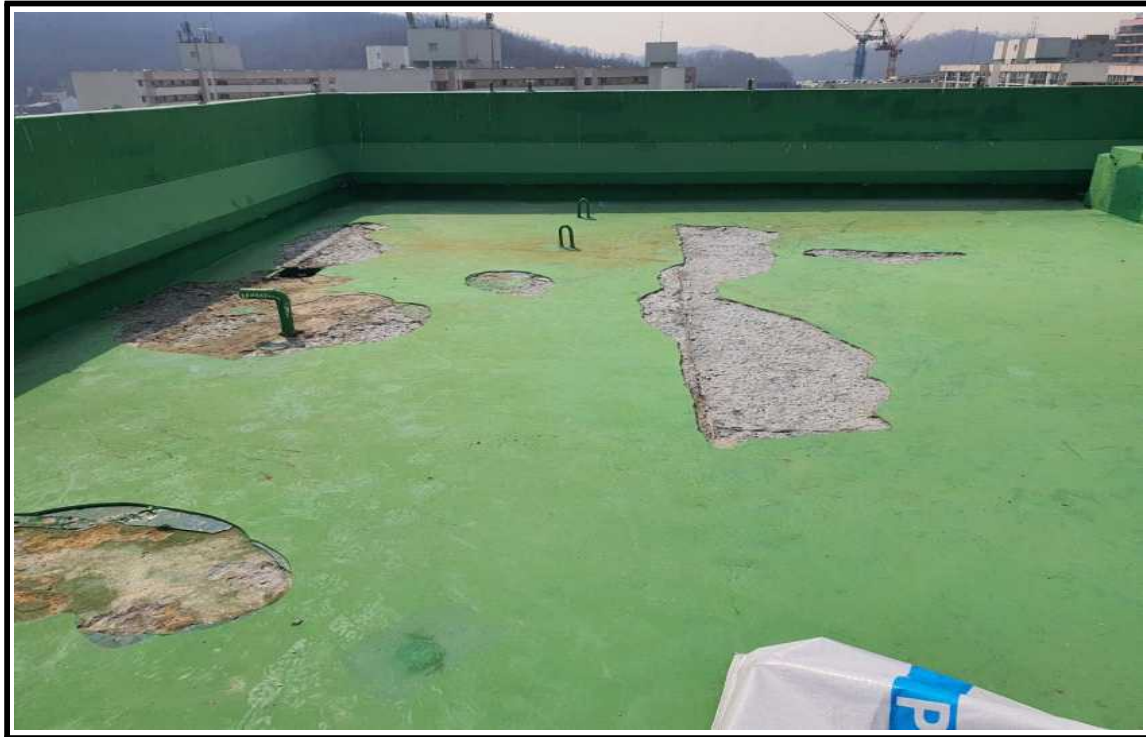
◎ 공사 중(불량우레탄 제거작업)
