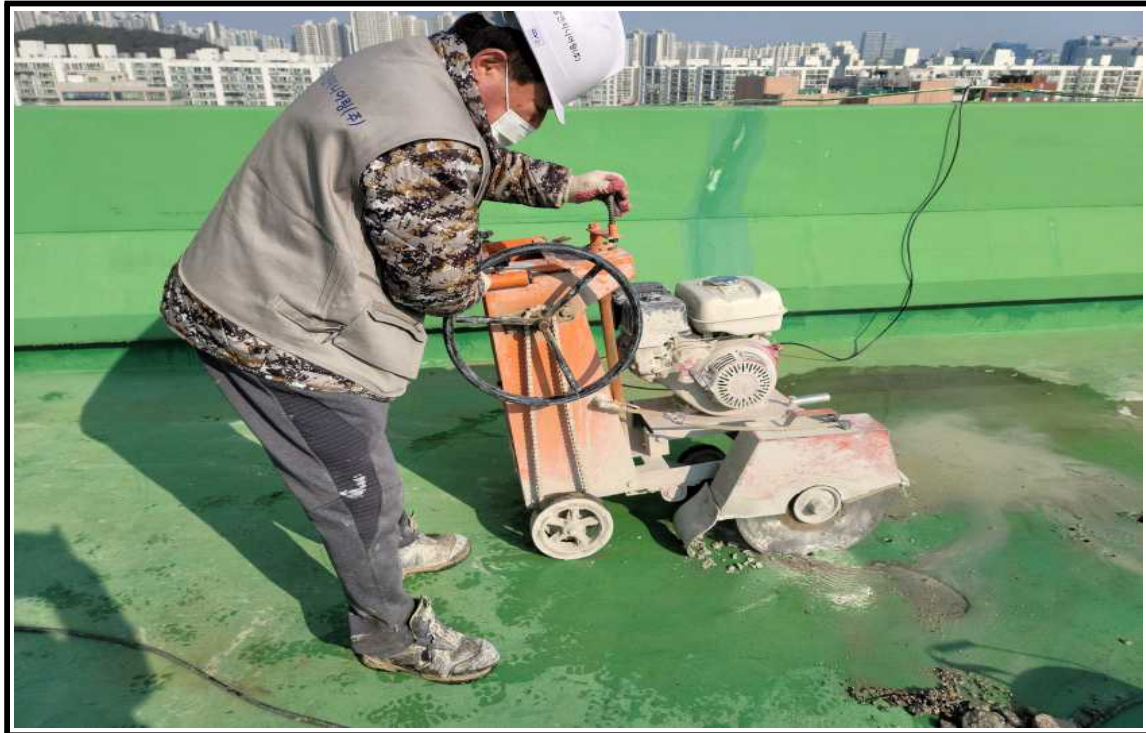
◎ 시공 중(통기관 작업 중)
