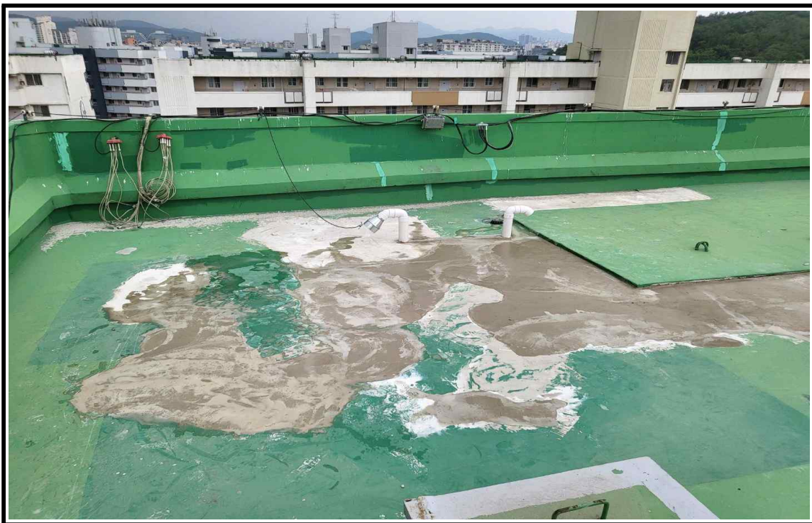
◎ 시공 중(미장 작업중)
