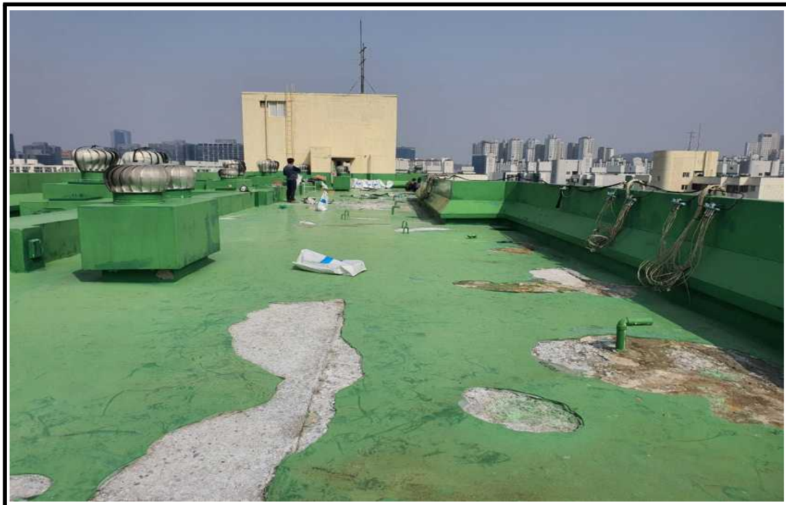
◎ 공사 중(불량우레탄 제거작업)
