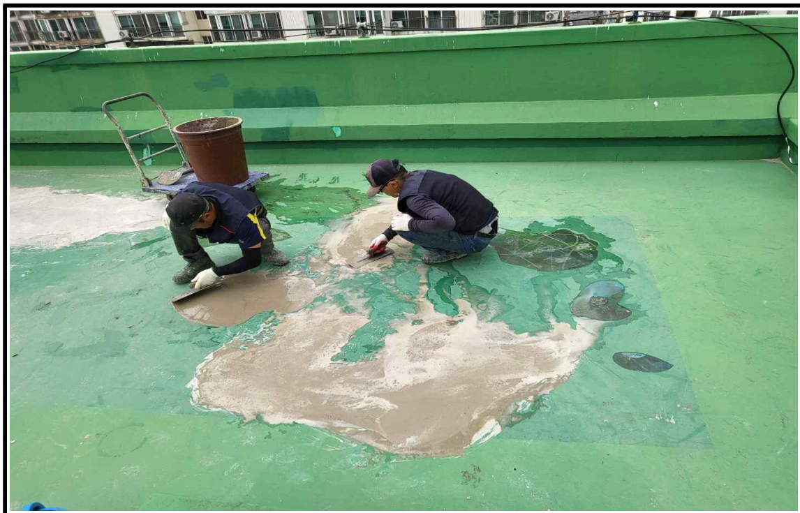
◎ 시공 중(미장 작업중)
