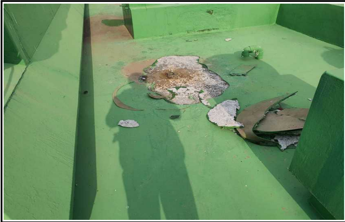
◎ 공사 중(불량우레탄 제거작업)
