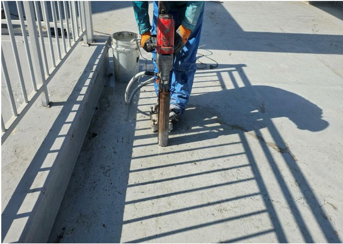
수분제거 작업 : 코어 드릴
