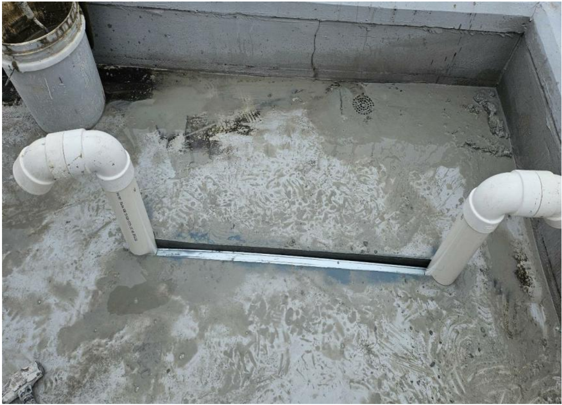
수분제거 작업 : PVC파이프 및 유바관 설치
