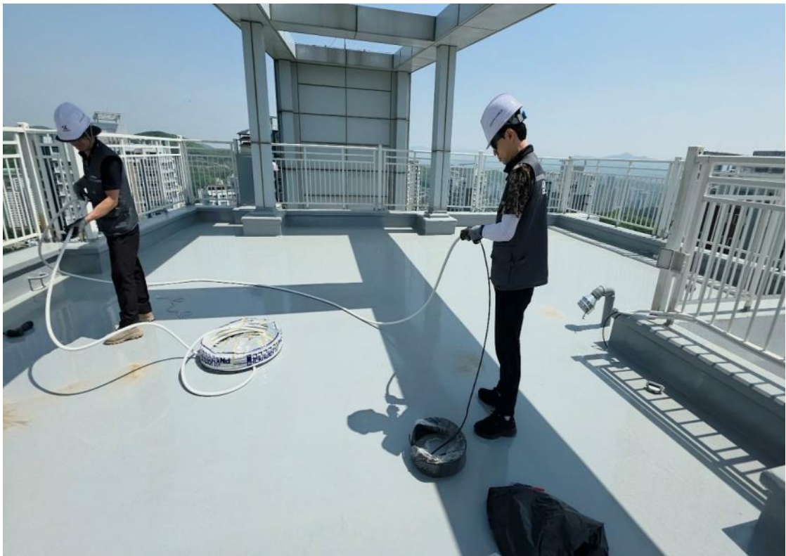
수분제거 작업 : CD관에 케이블 포설
