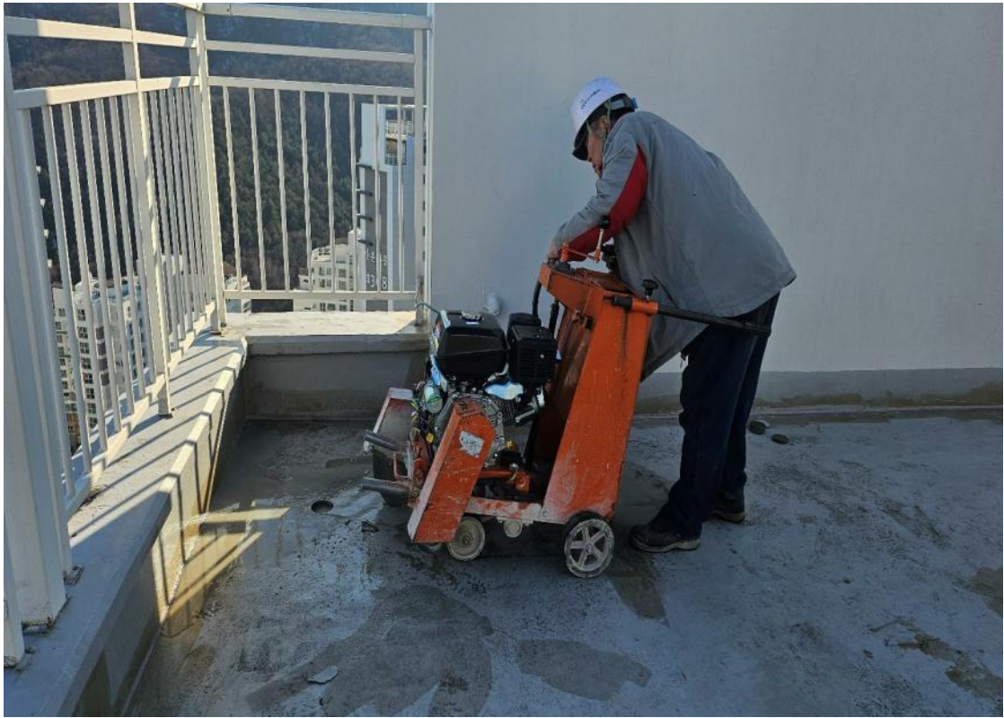
수분제거 작업 : 컷팅 작업
