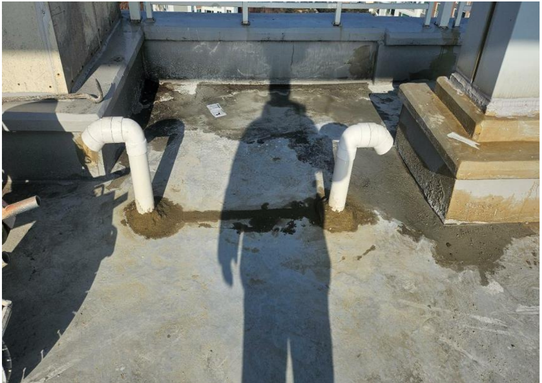
수분제거 작업 : PVC파이프 및 유바관 설치
