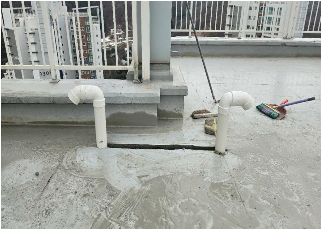
수분제거 작업 : PVC파이프 설치
