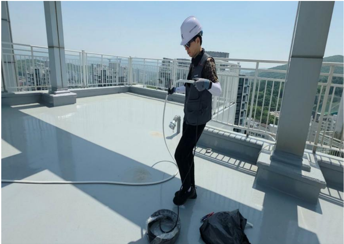
수분제거 작업 : CD관에 케이블 포설
