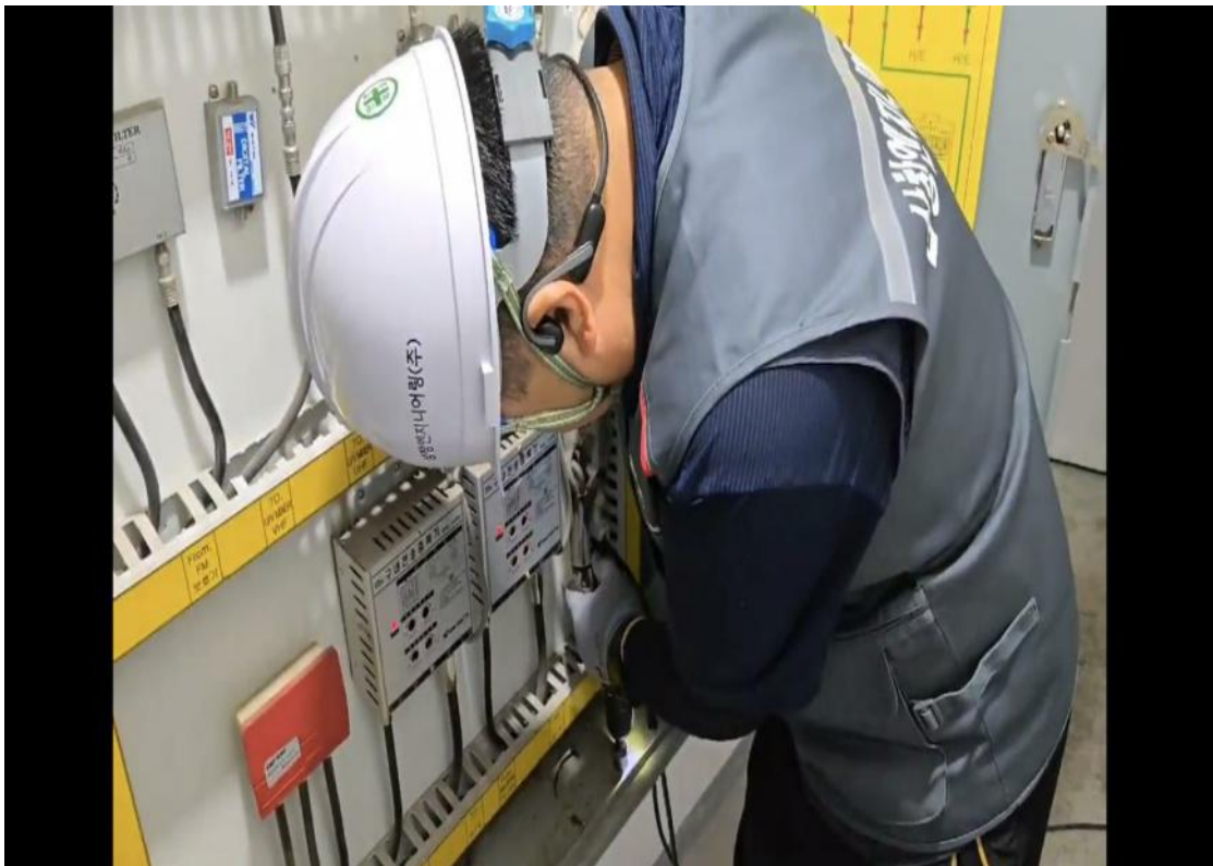
수분제거 작업 : 분전함 타공
