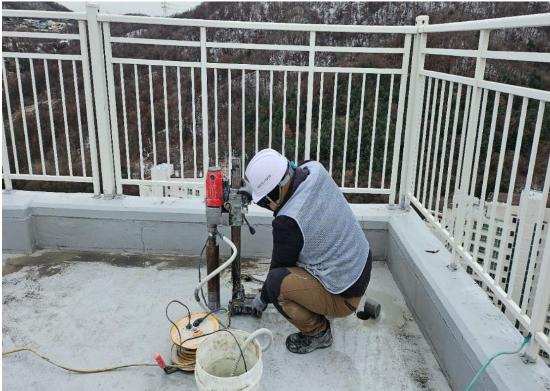
수분제거 작업 : 코어 드릴
