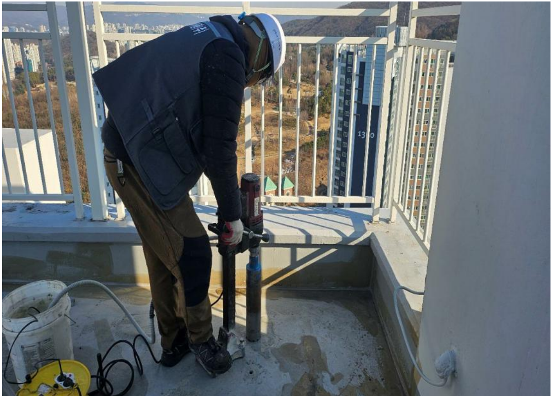
수분제거 작업 : 코어 드릴
