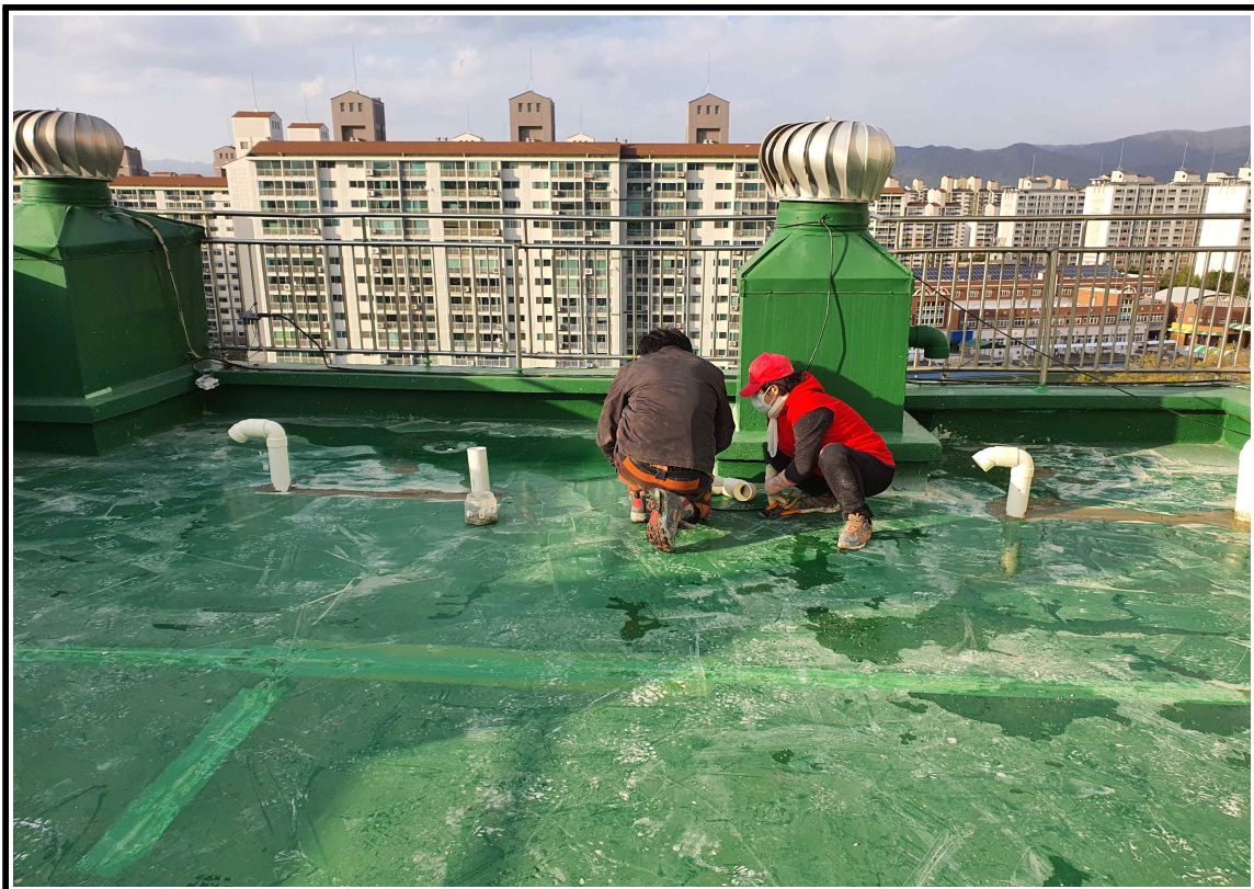
◎ 통기관 설치 작업 중
