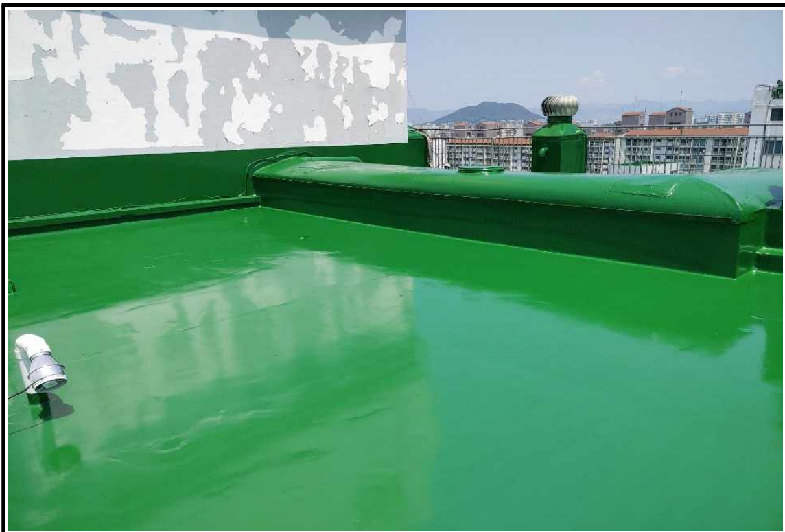
◎ 우레탄 상도 작업 완료
