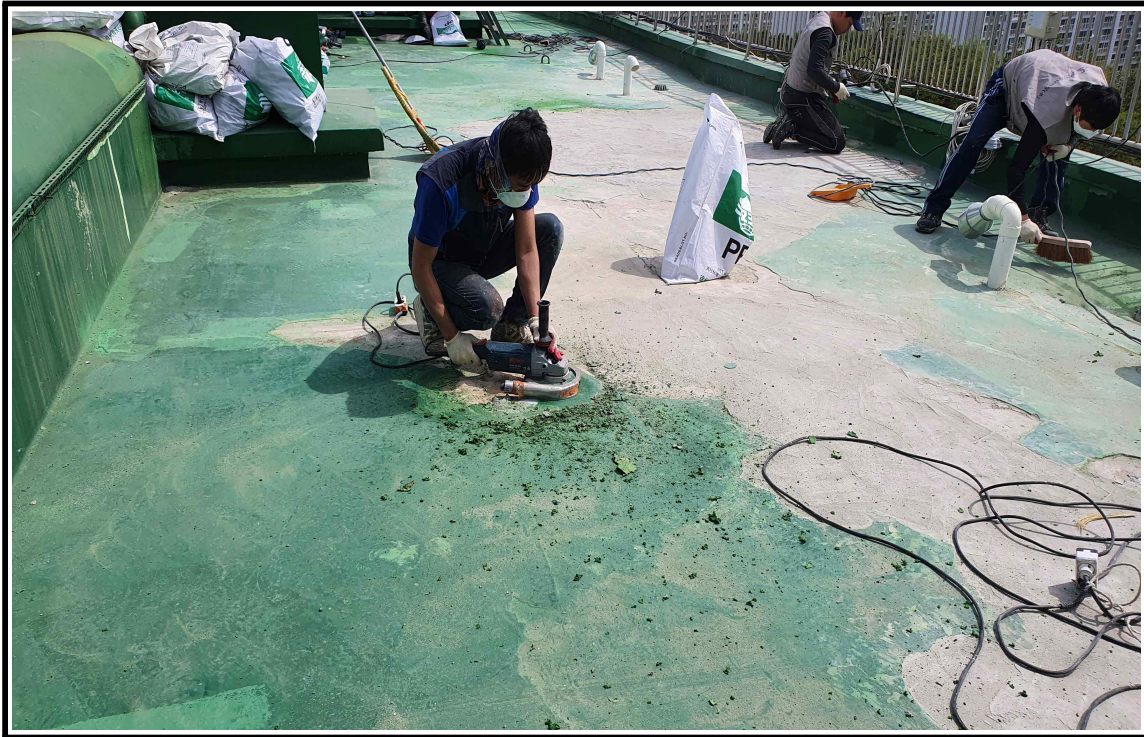
◎ 바탕면 작업 중
