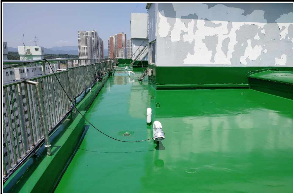
◎ 우레탄 상도 작업 완료
