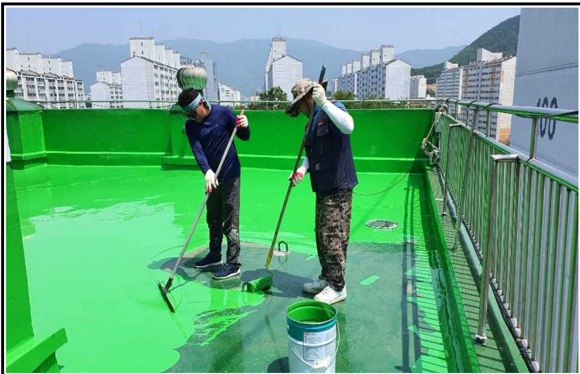
◎ 우레탄 중도 작업 중
