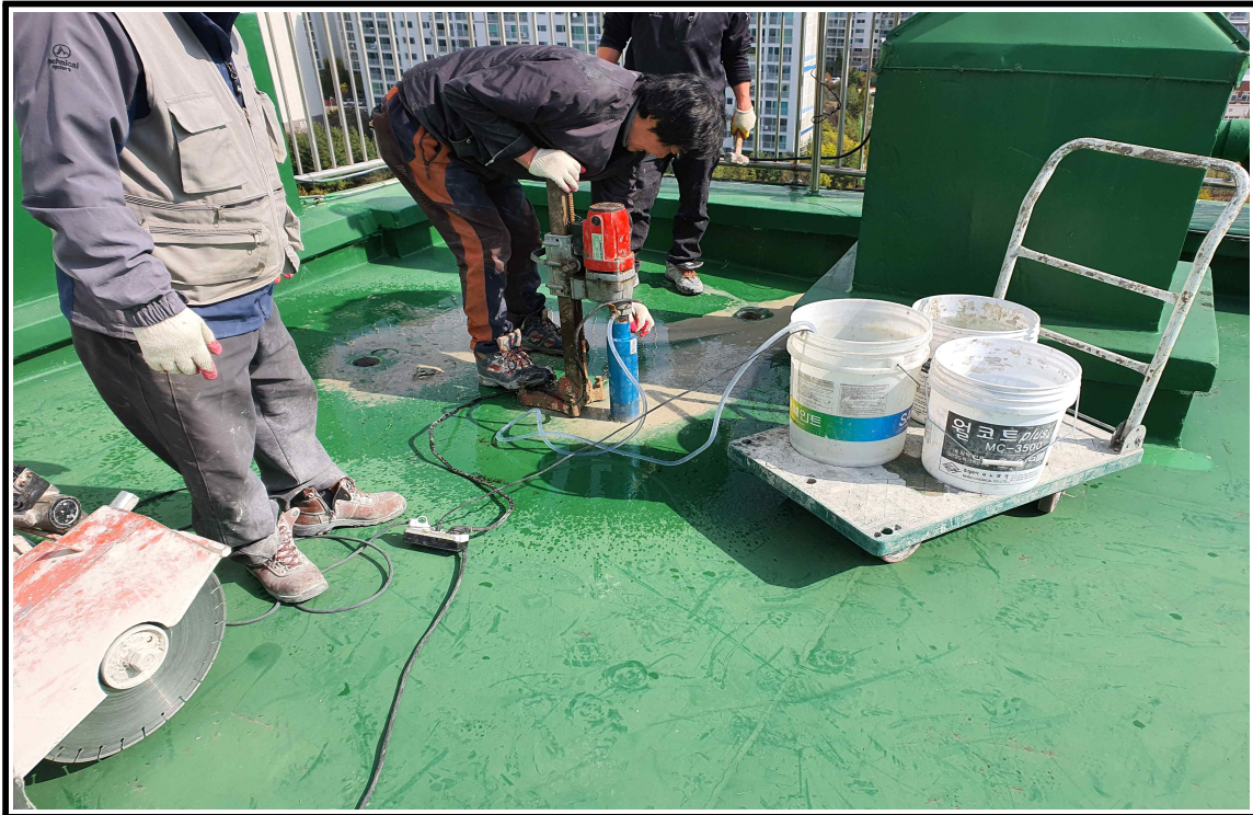
◎ 통기관 설치 작업 중
