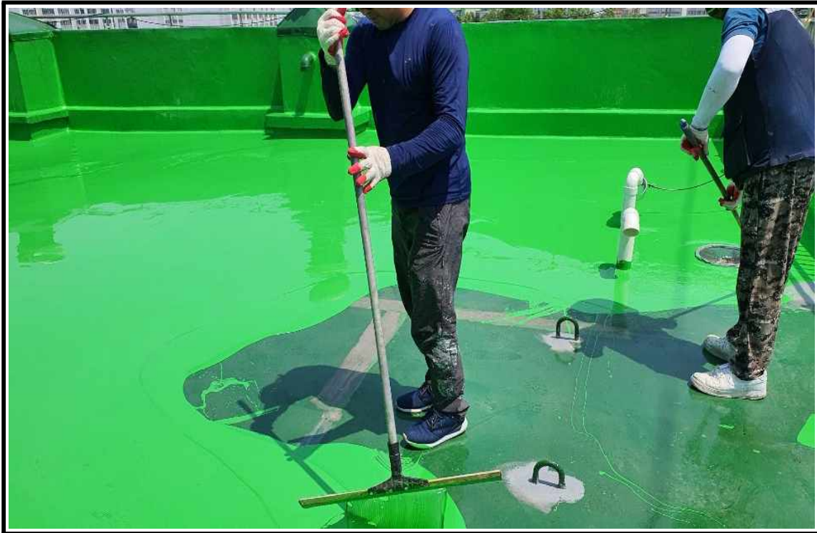
◎ 우레탄 중도 작업 중
