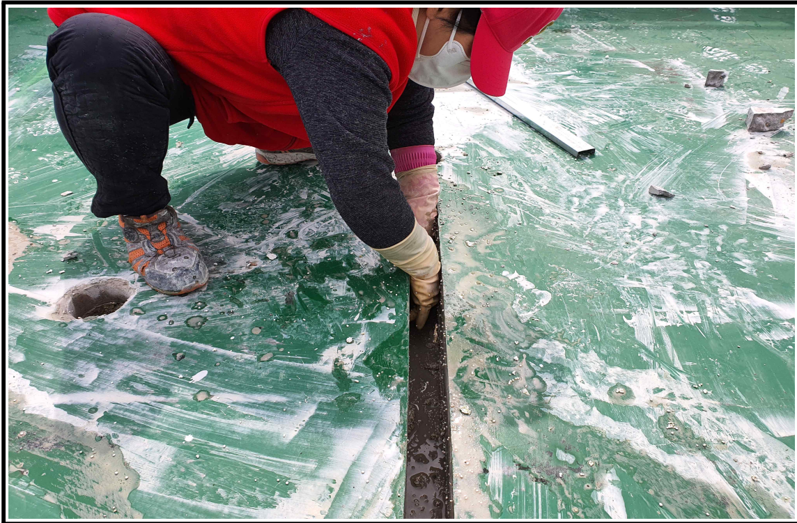
◎ 통기관 설치 작업 중
