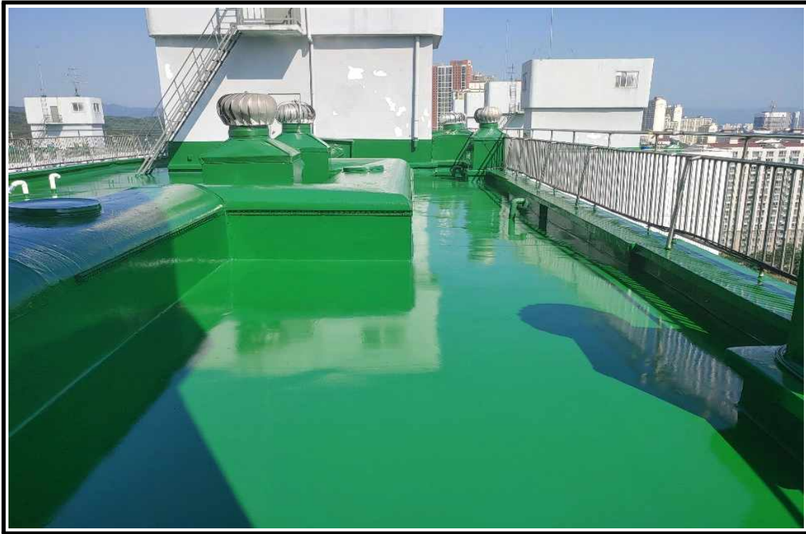
◎ 우레탄 상도 작업 완료
