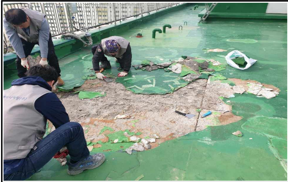
◎ 바탕면 작업 중
