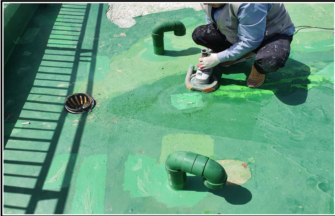
◎ 바탕면 작업 중
