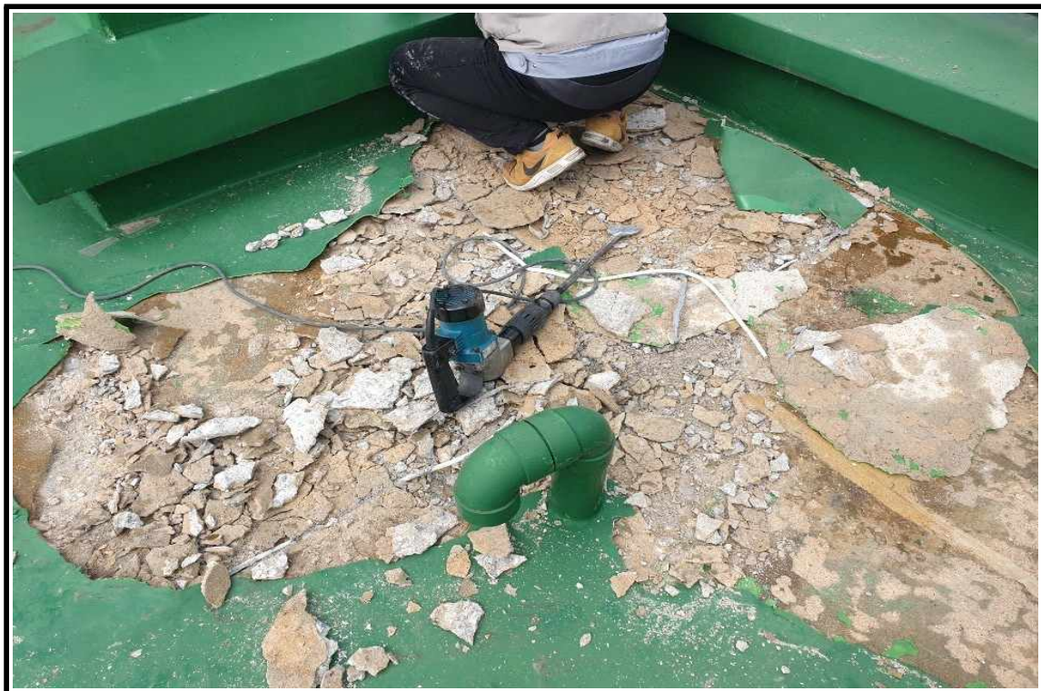
◎ 바탕면 작업 중
