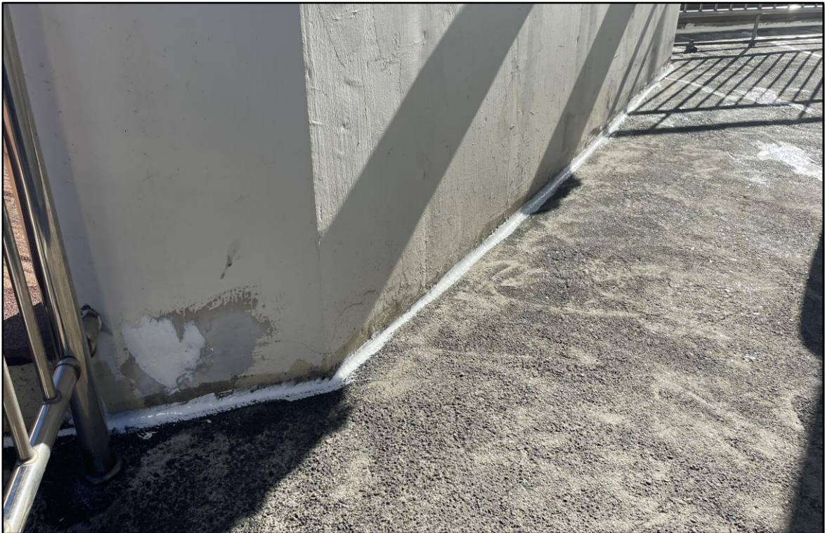
우레탄 실란트 시공
