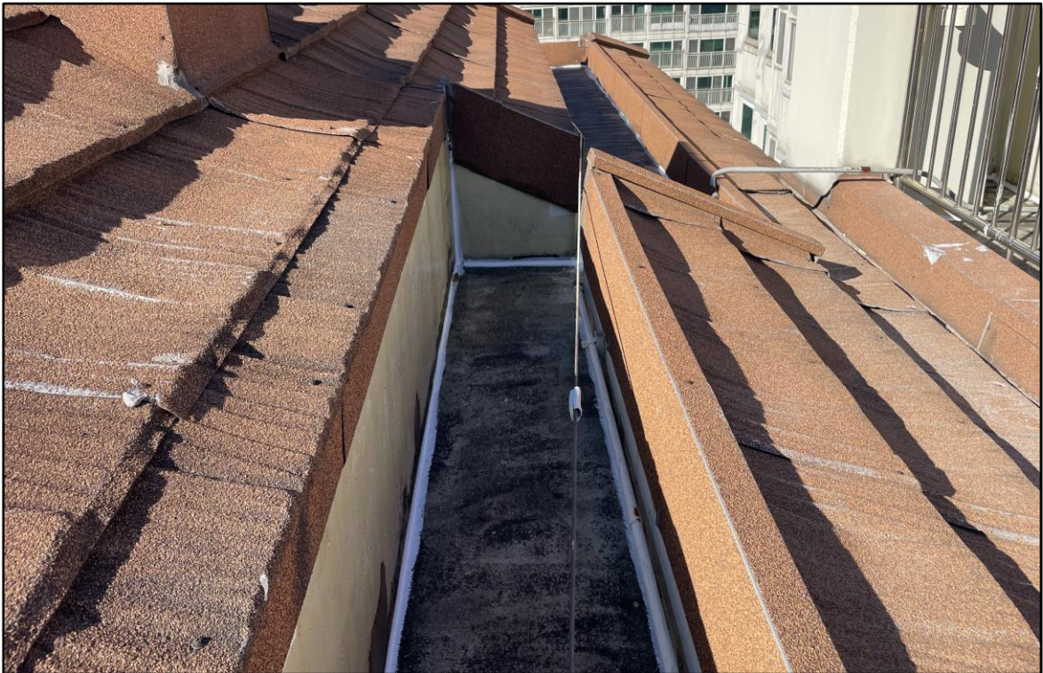
우레탄 실란트 시공
