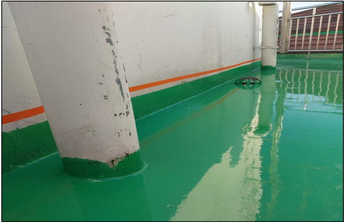
우레탄 상도 도포 마감(마스킹 테이핑 작업)
