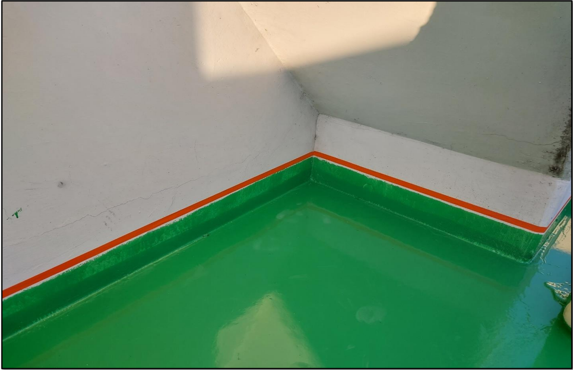
우레탄 상도 도포 마감(마스킹 테이핑 작업)
