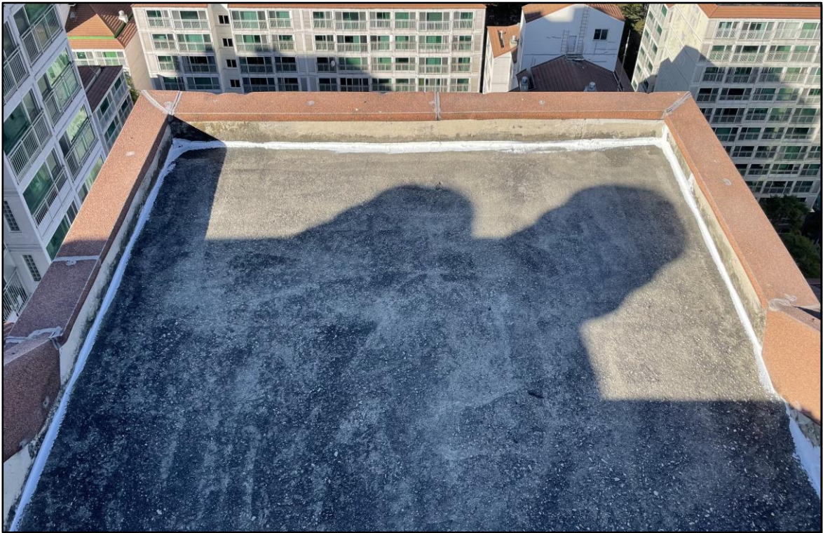
우레탄 실란트 시공
