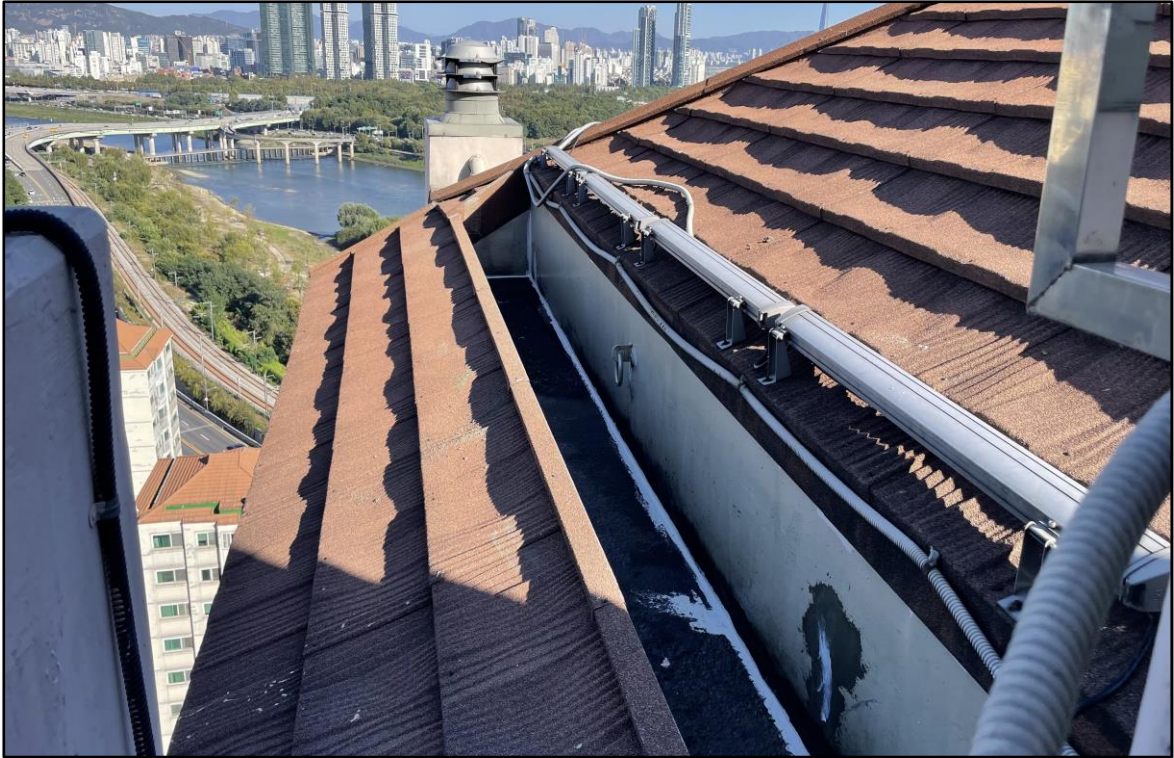
우레탄 실란트 시공
