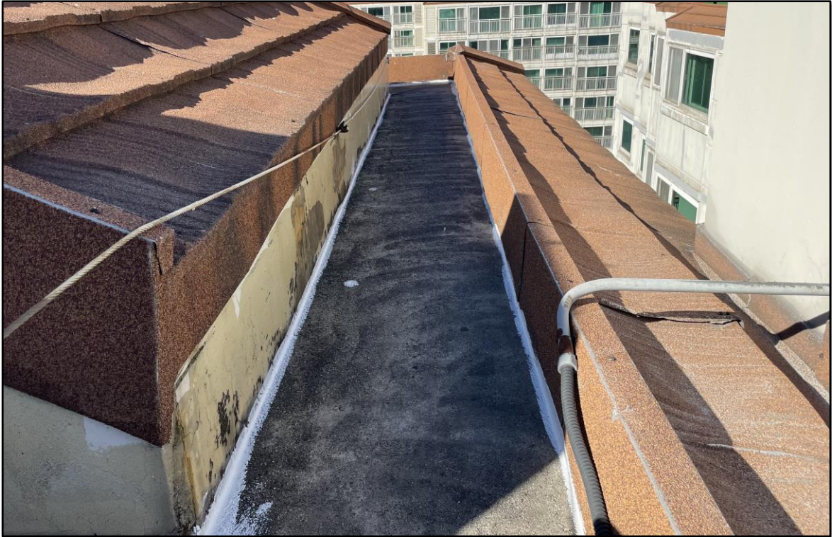
우레탄 실란트 시공
