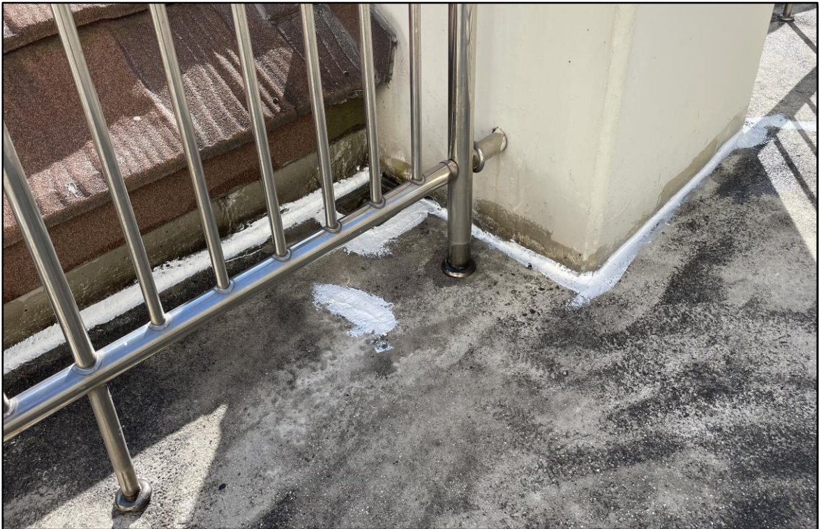
우레탄 실란트 시공
