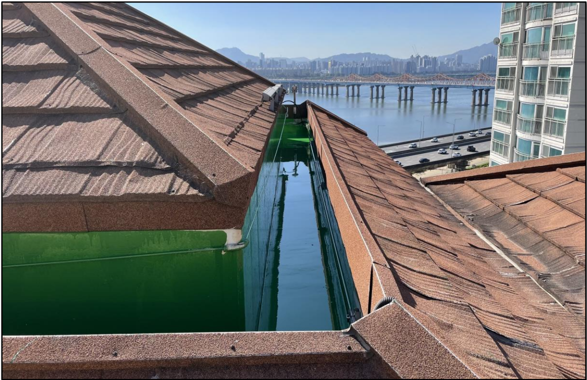
우레탄 중도 1차 시공
