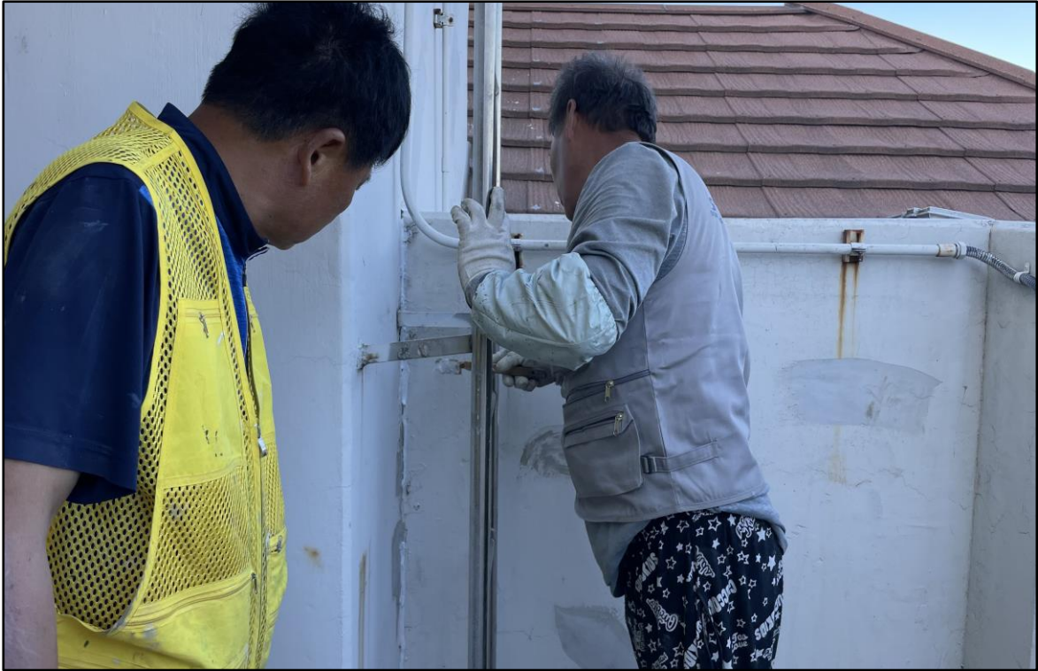
우레탄 실란트 시공
