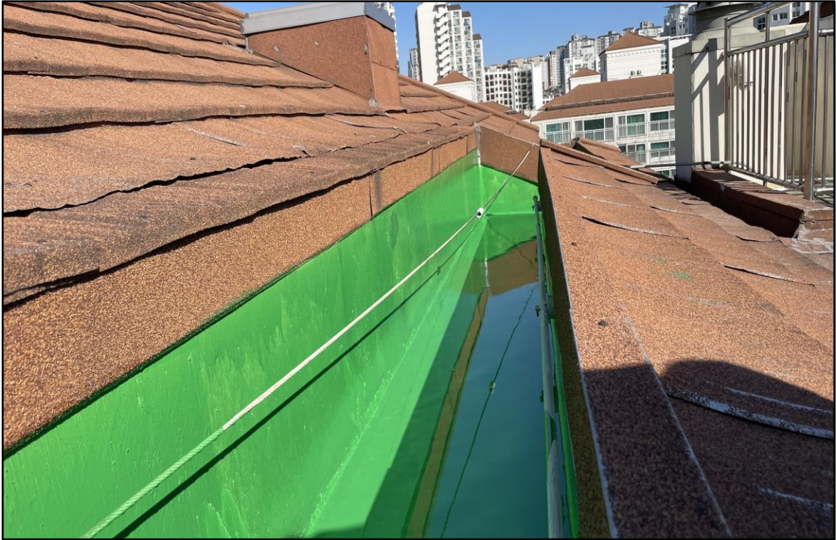
우레탄 중도 1차 시공
