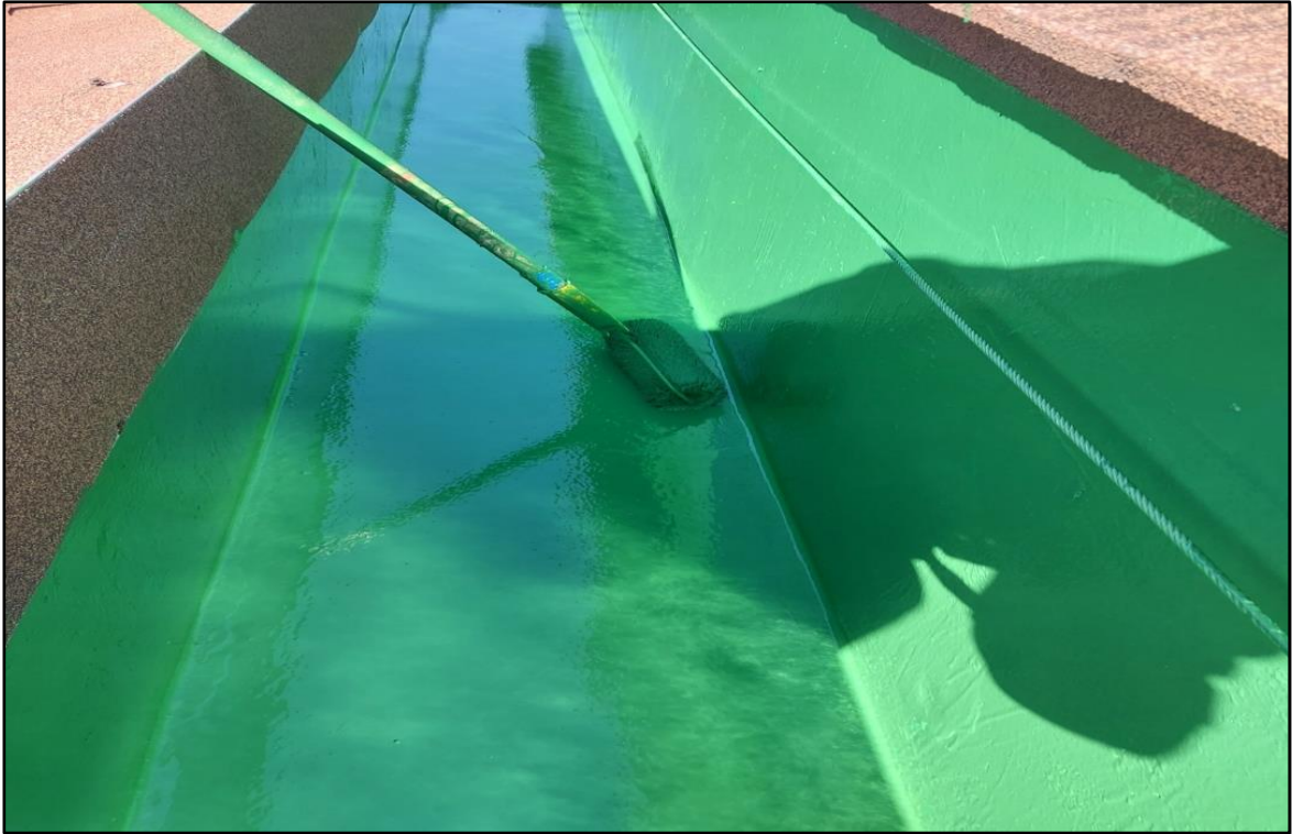
우레탄 중도 2차 시공
