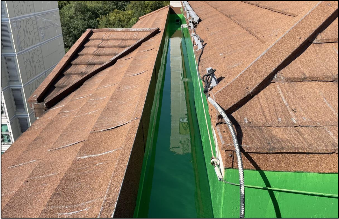
우레탄 중도 1차 시공
