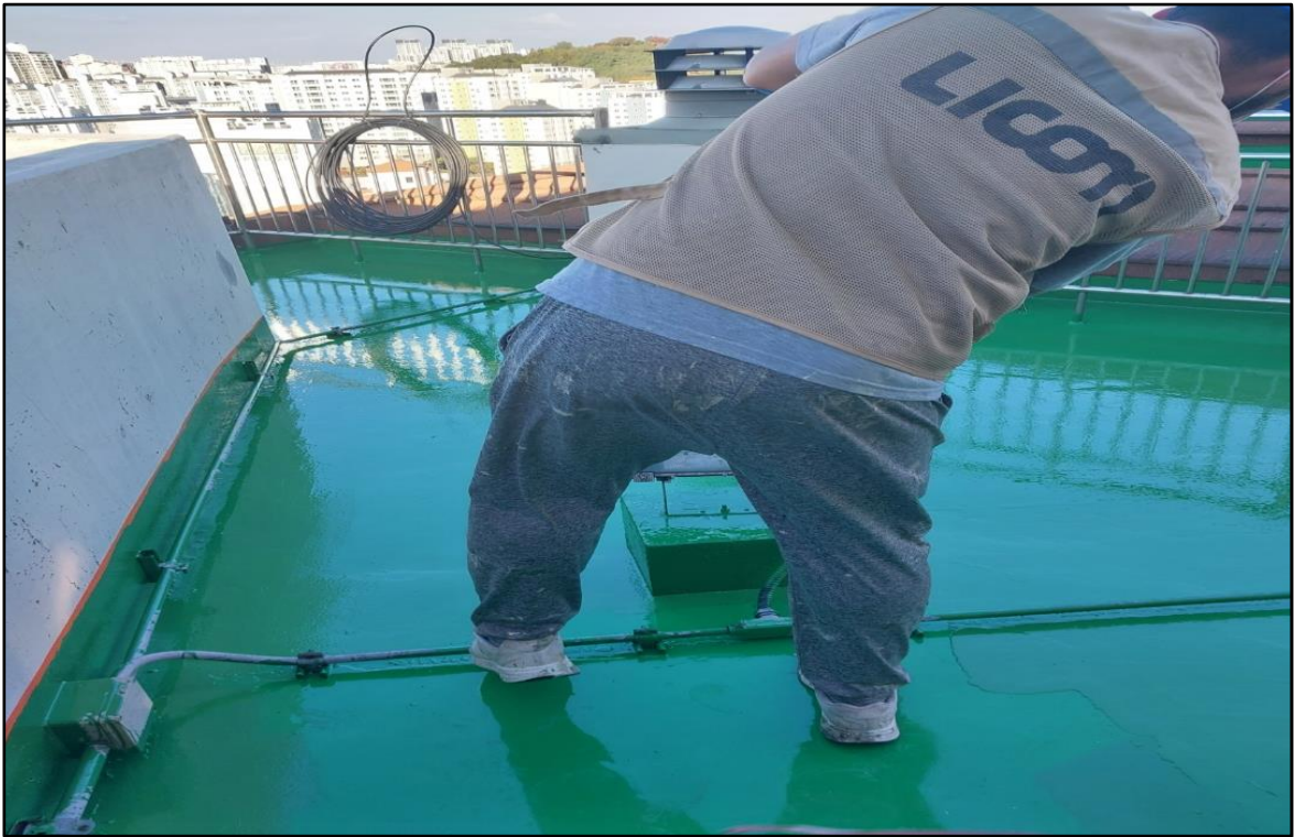
우레탄 중도 2차 시공
