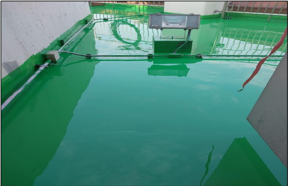
우레탄 중도 2차 시공
