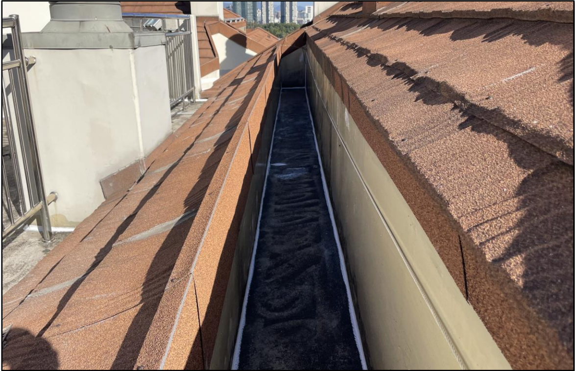
우레탄 실란트 시공
