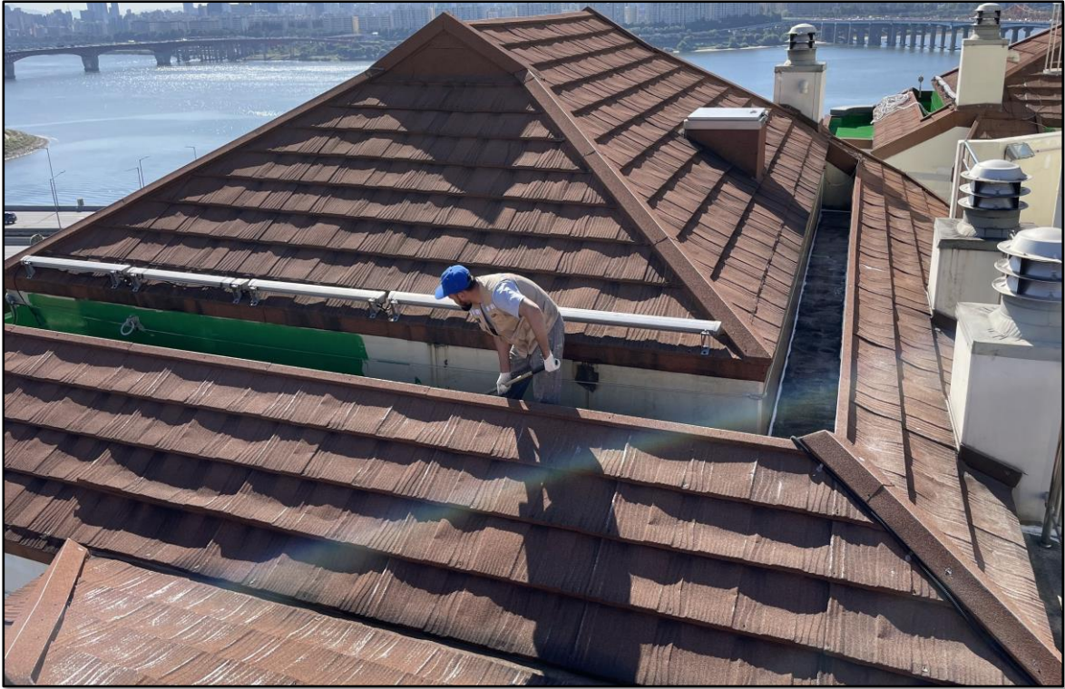
우레탄 중도 1차 시공
