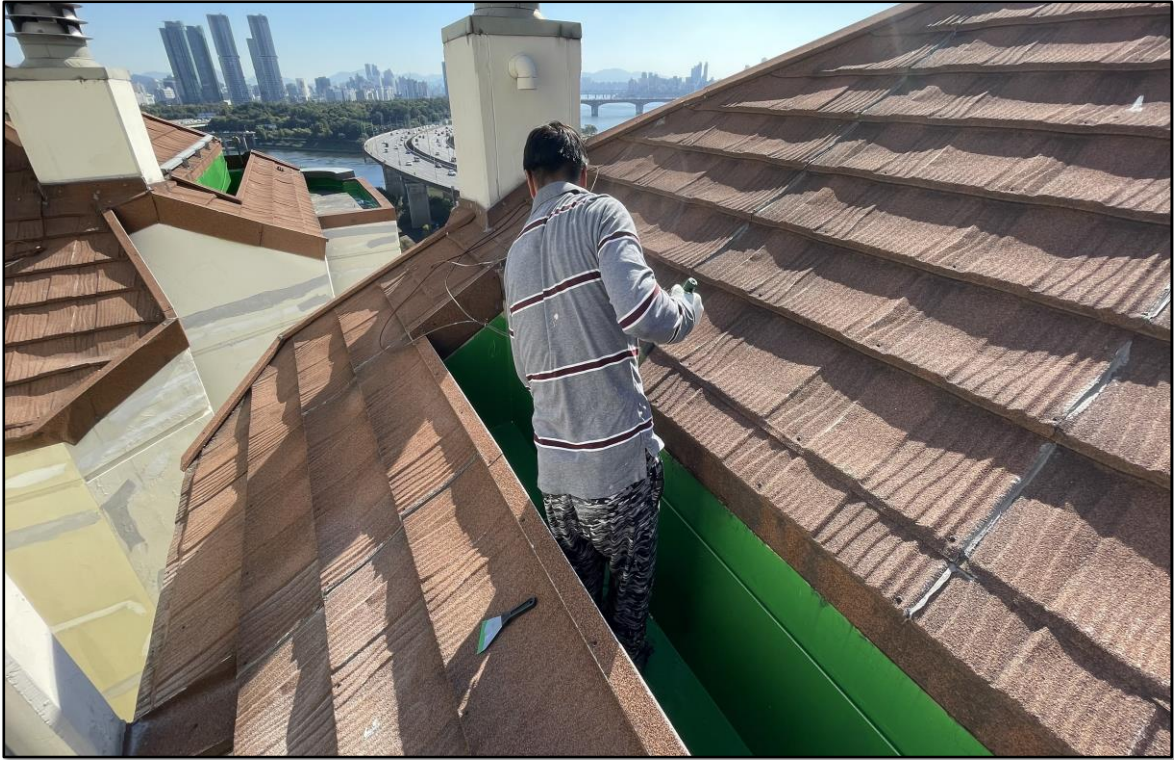
우레탄 중도 1차 시공
