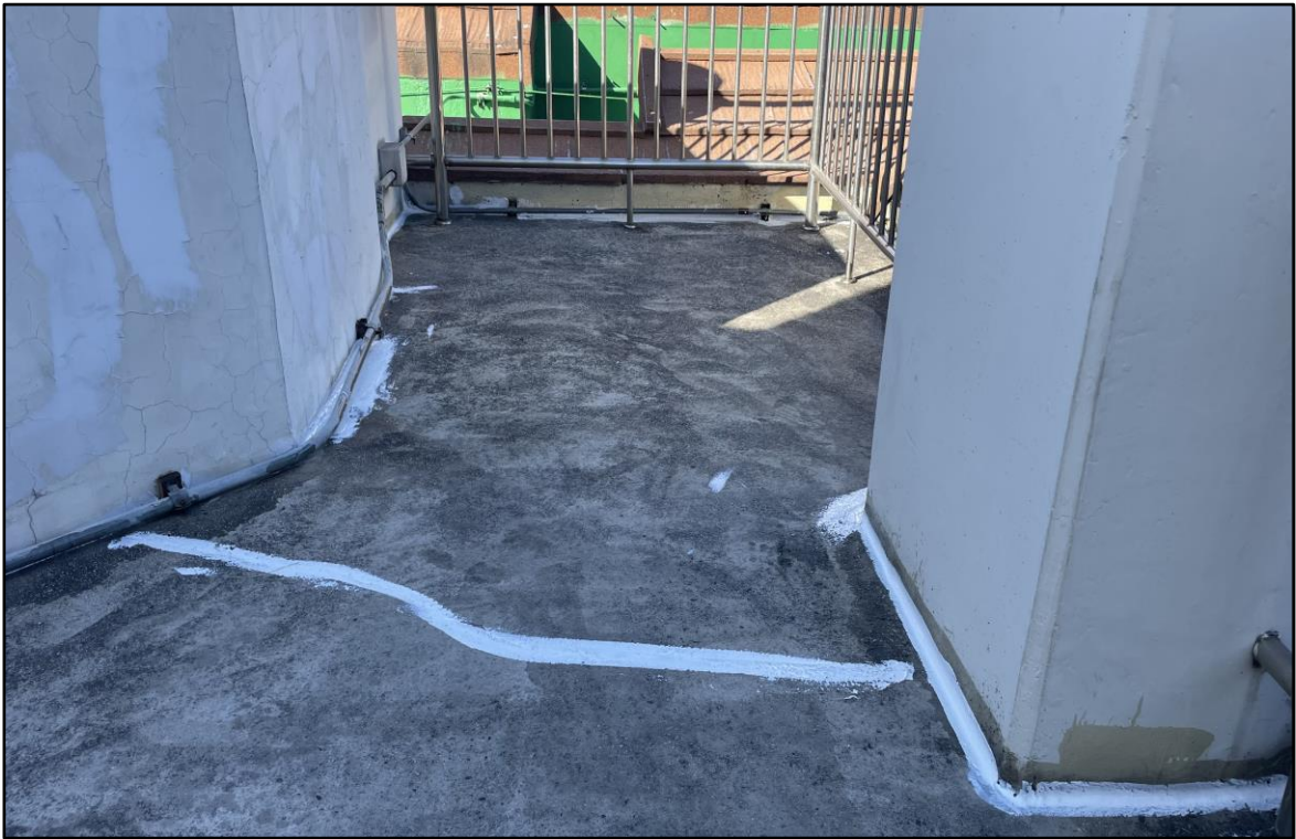
우레탄 실란트 시공
