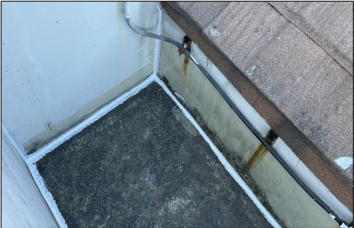
우레탄 실란트 시공
