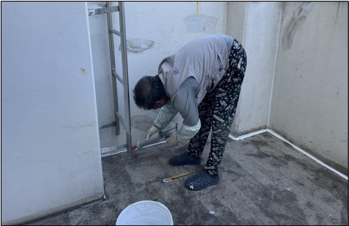
우레탄 실란트 시공
