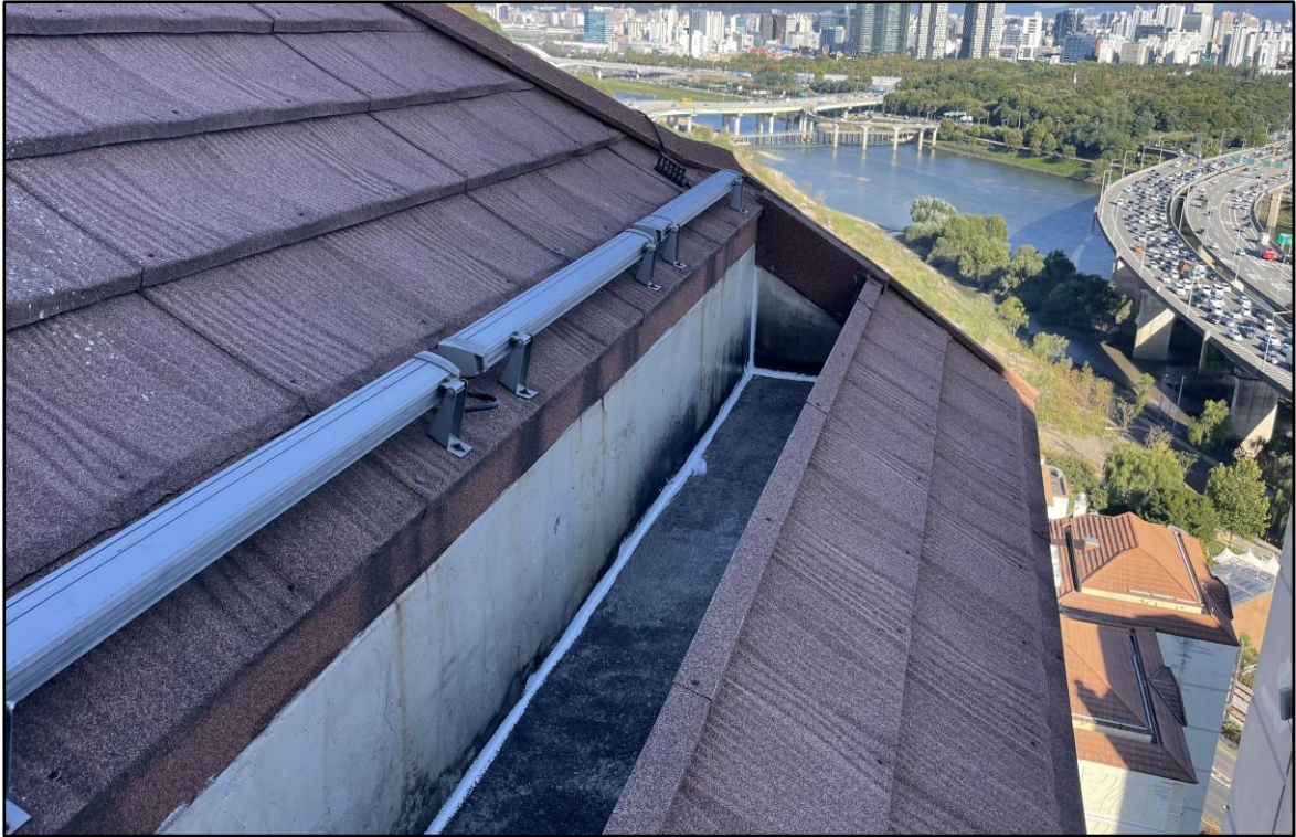
우레탄 실란트 시공
