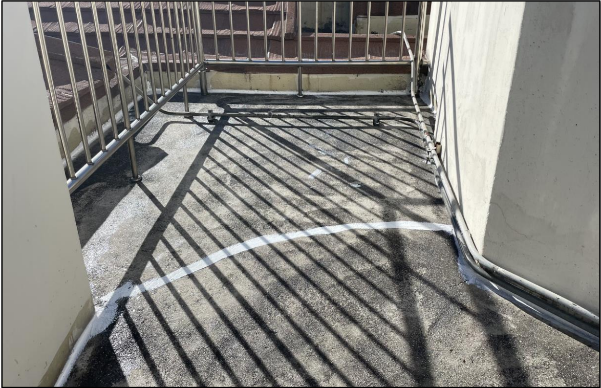
우레탄 실란트 시공
