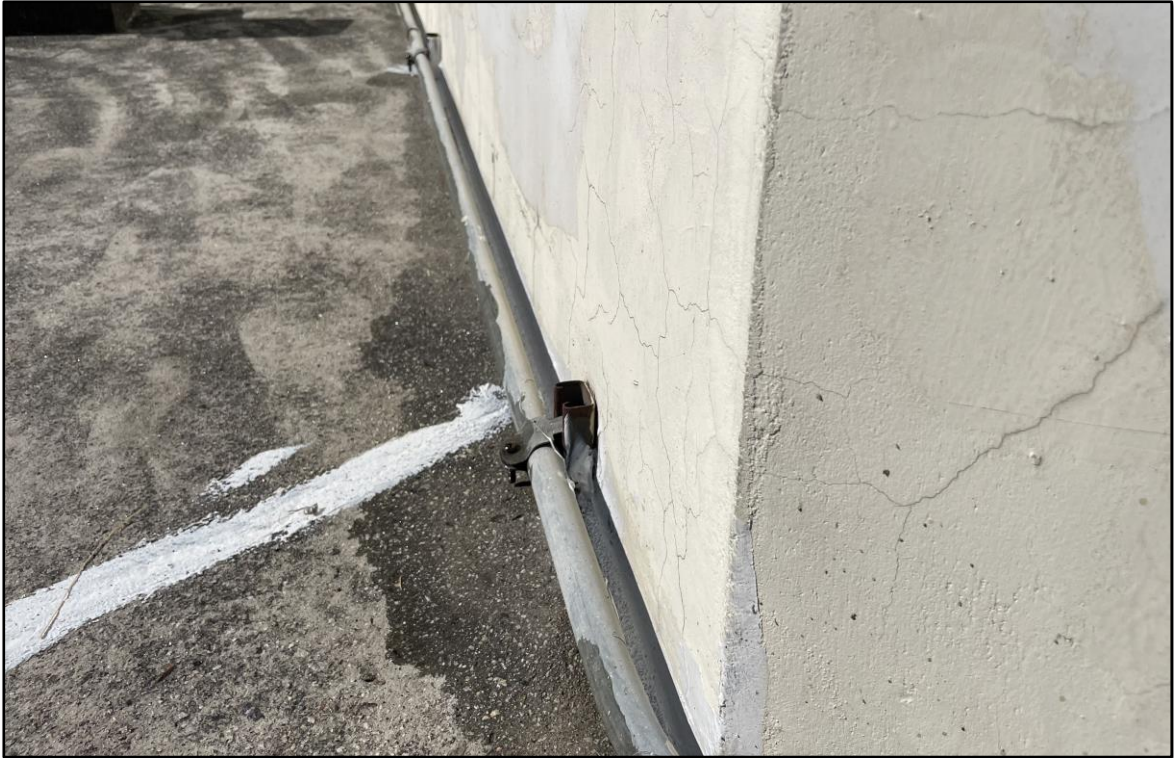
우레탄 실란트 시공
