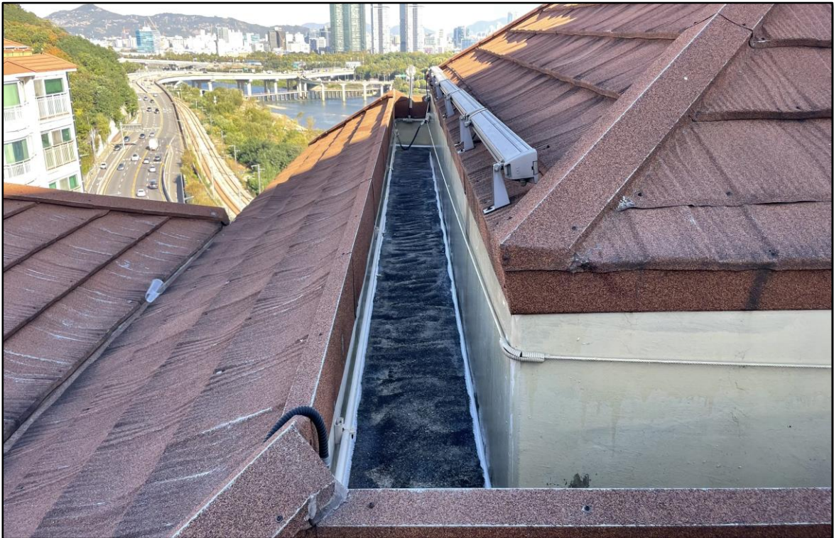
우레탄 실란트 시공
