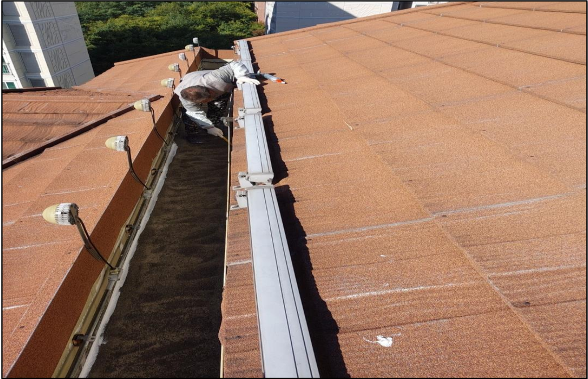
우레탄 실란트 시공
