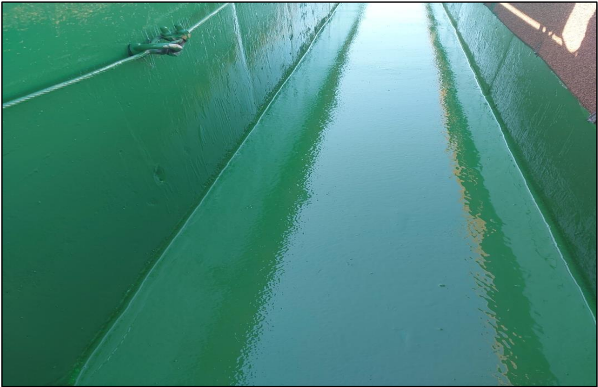
우레탄 중도 2차 시공
