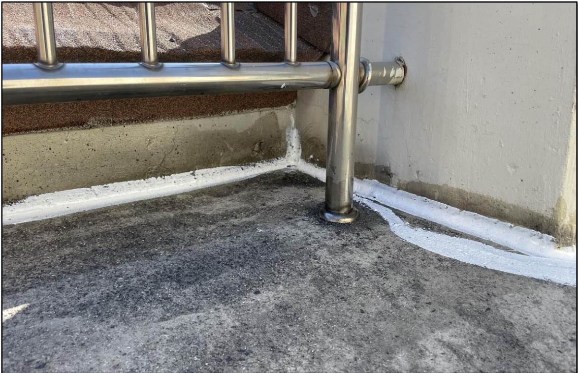
우레탄 실란트 시공
