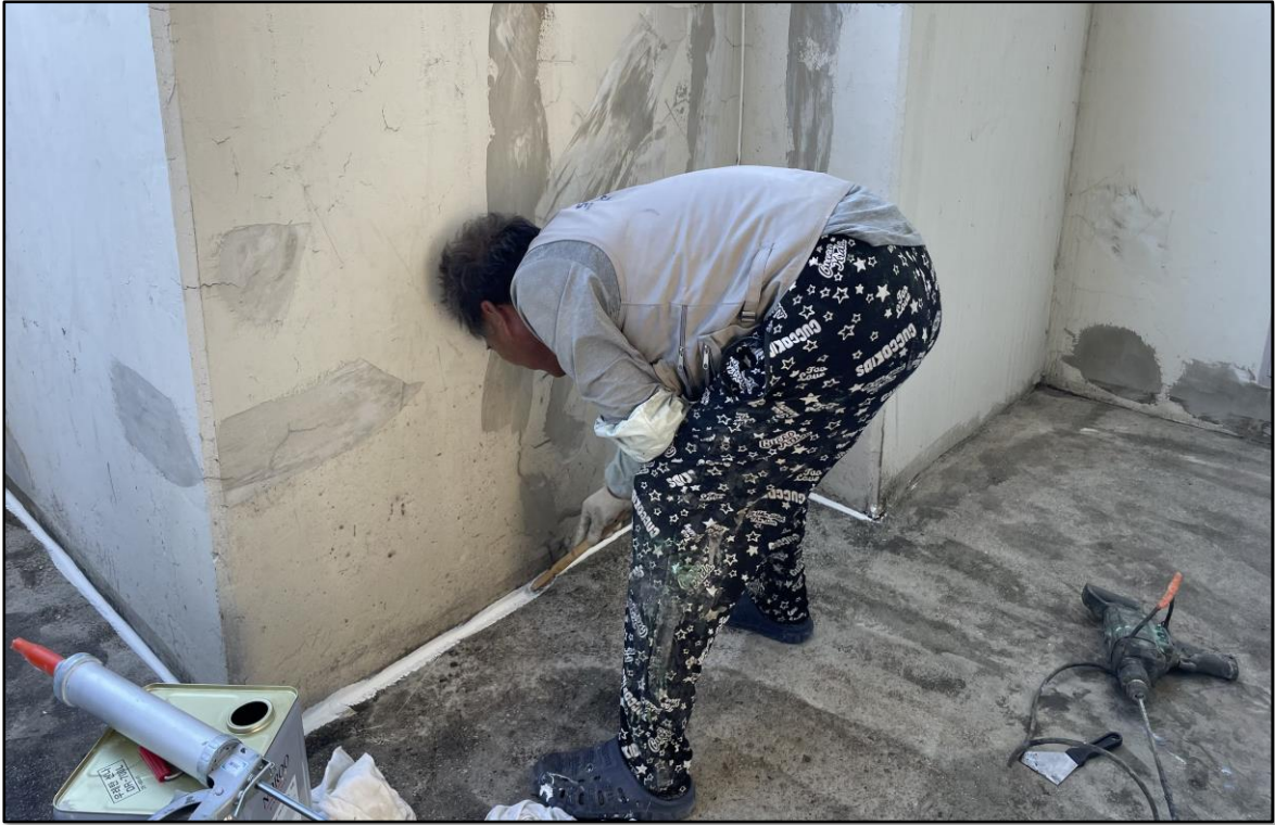
우레탄 실란트 시공
