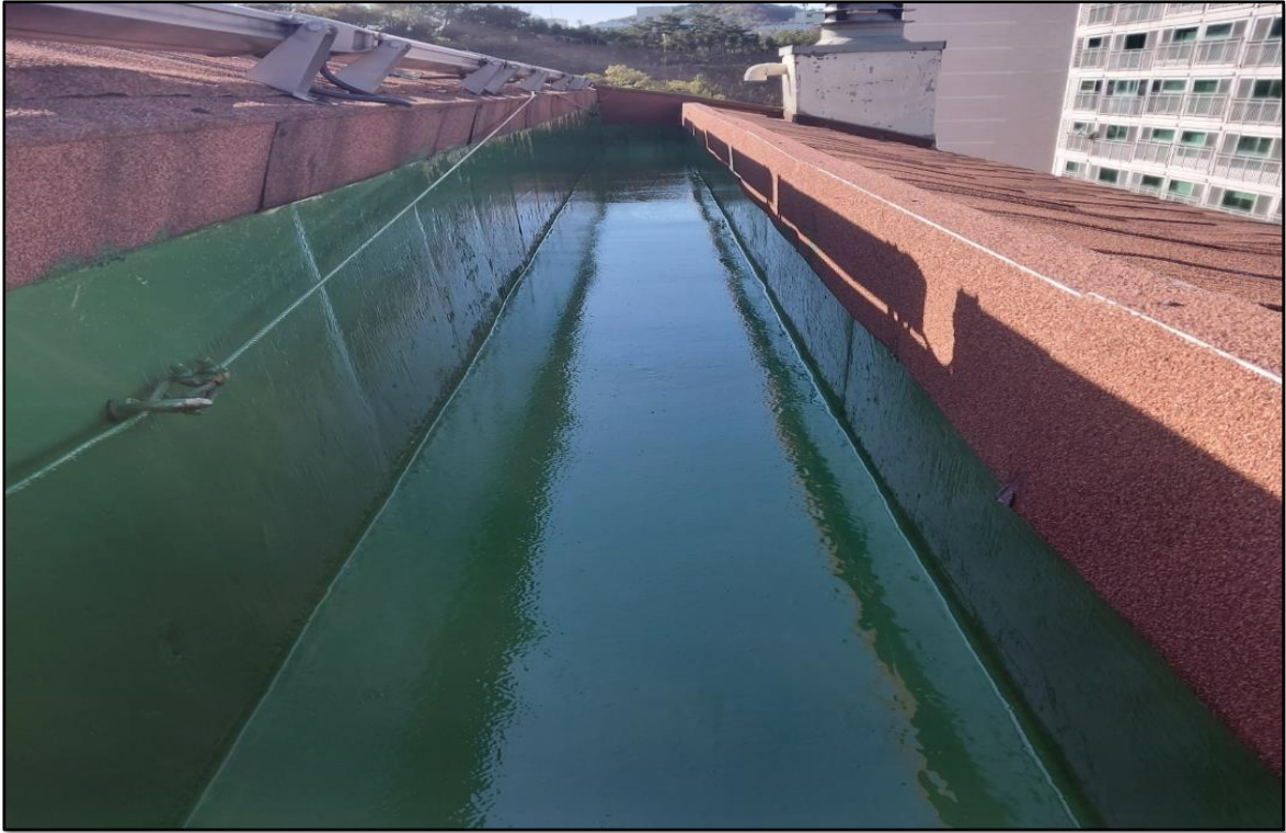
우레탄 중도 2차 시공
