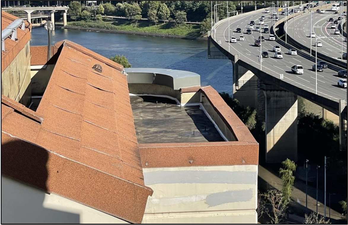
우레탄 실란트 시공
