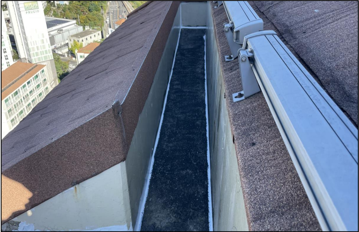
우레탄 실란트 시공
