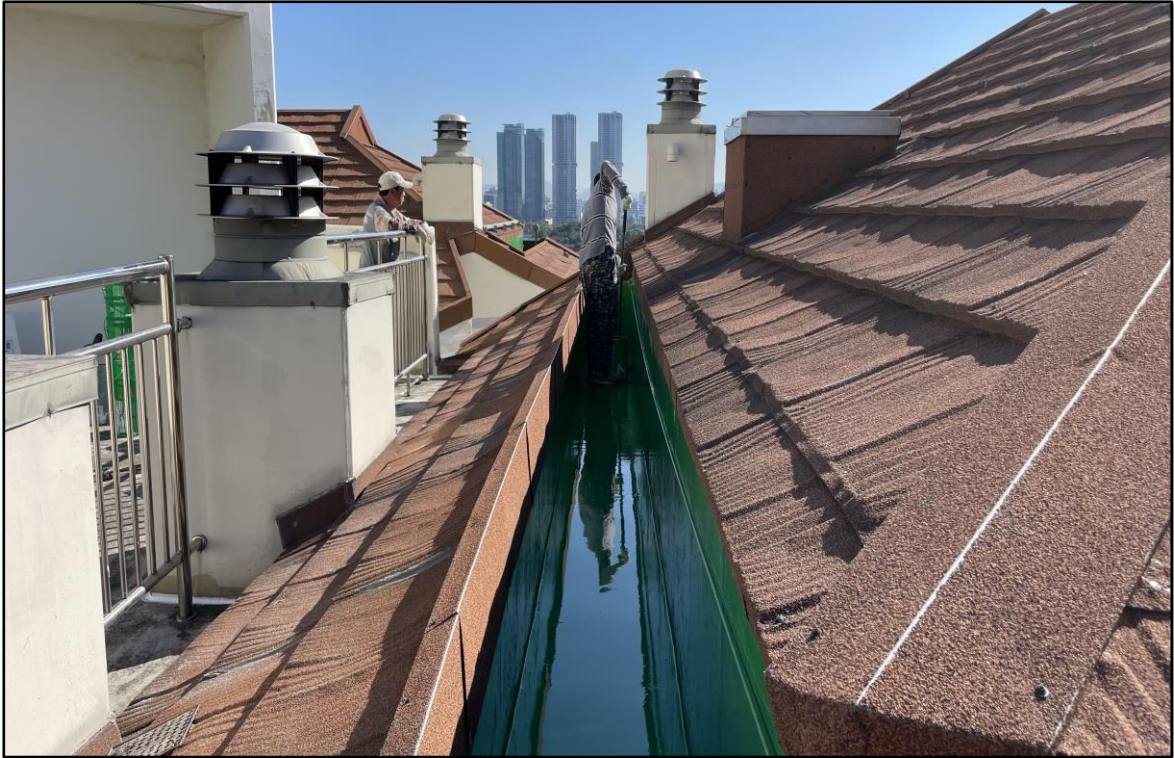
우레탄 중도 1차 시공
