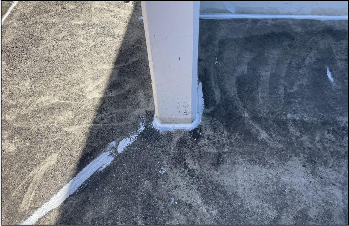
우레탄 실란트 시공
