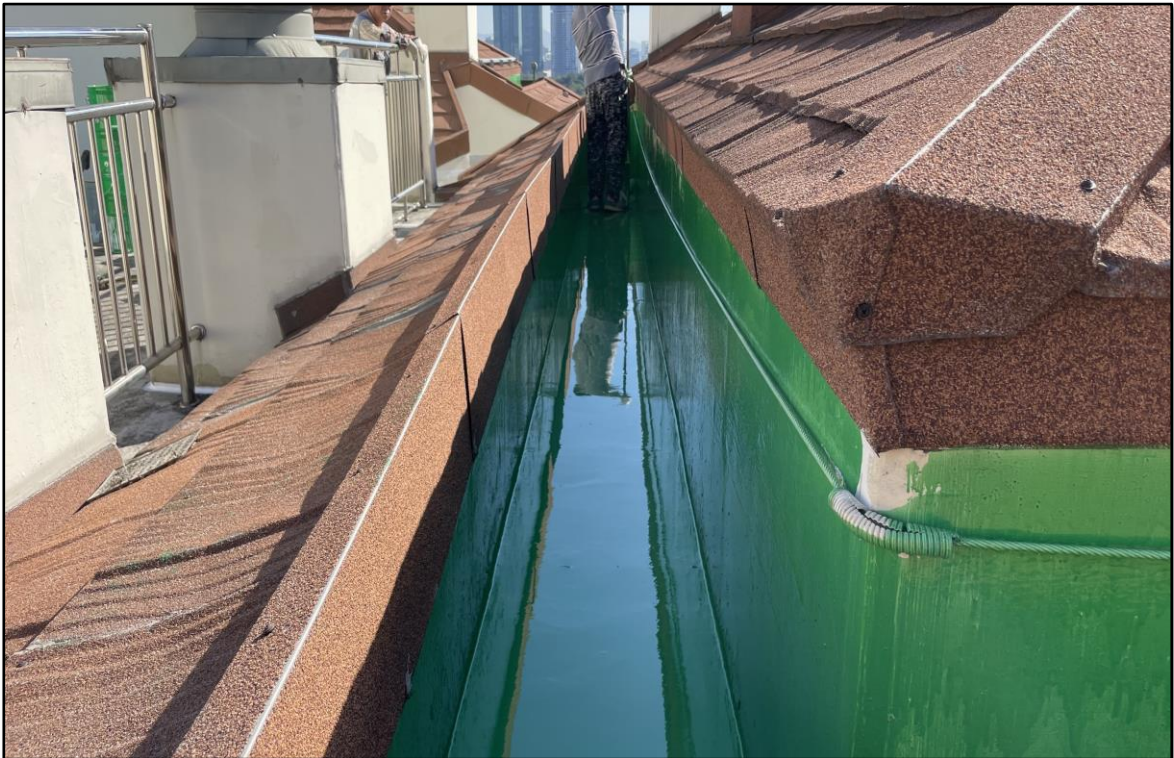
우레탄 중도 1차 시공
