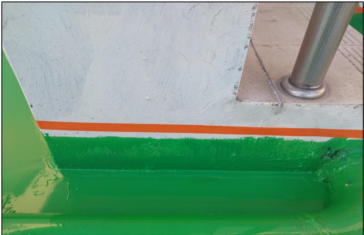
우레탄 상도 도포 마감(마스킹 테이핑 작업)
