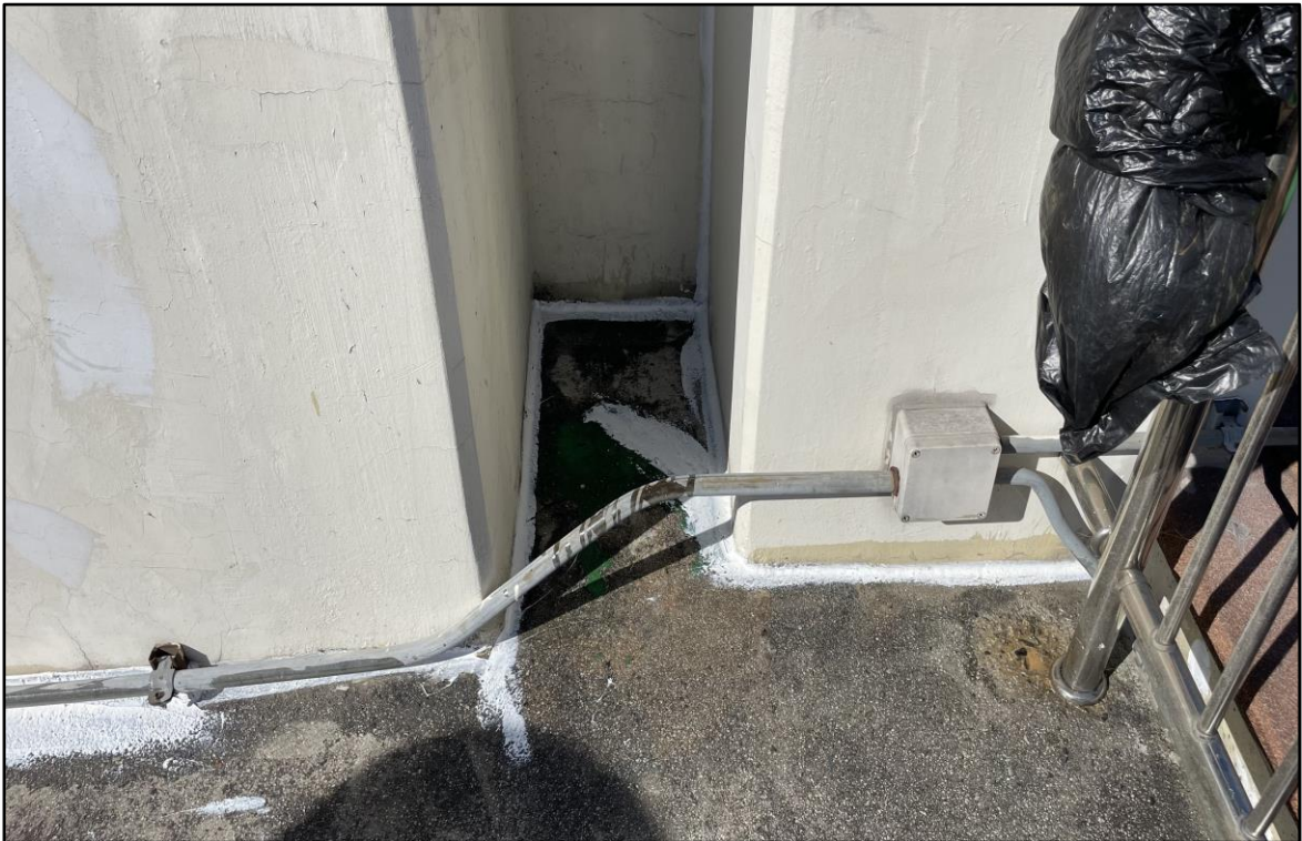
우레탄 실란트 시공
