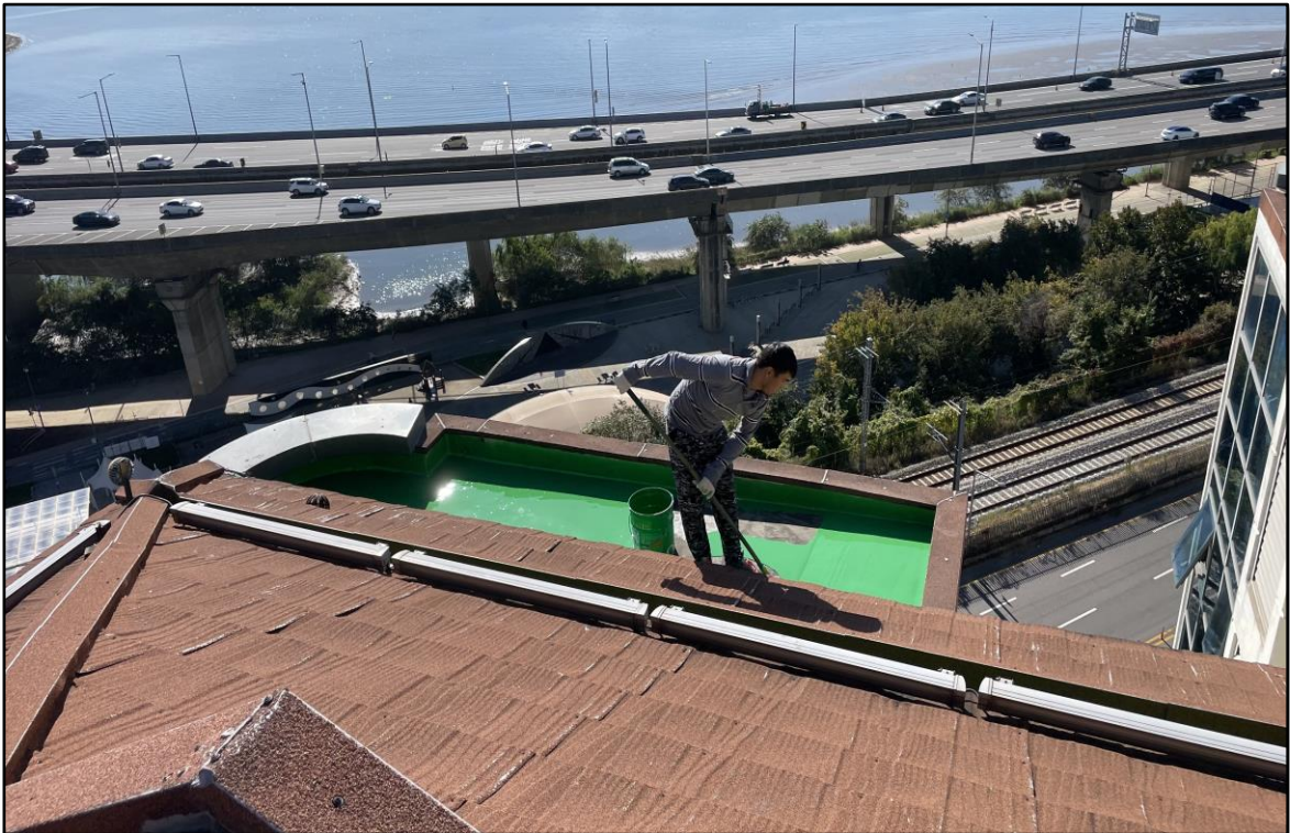
우레탄 중도 1차 시공
