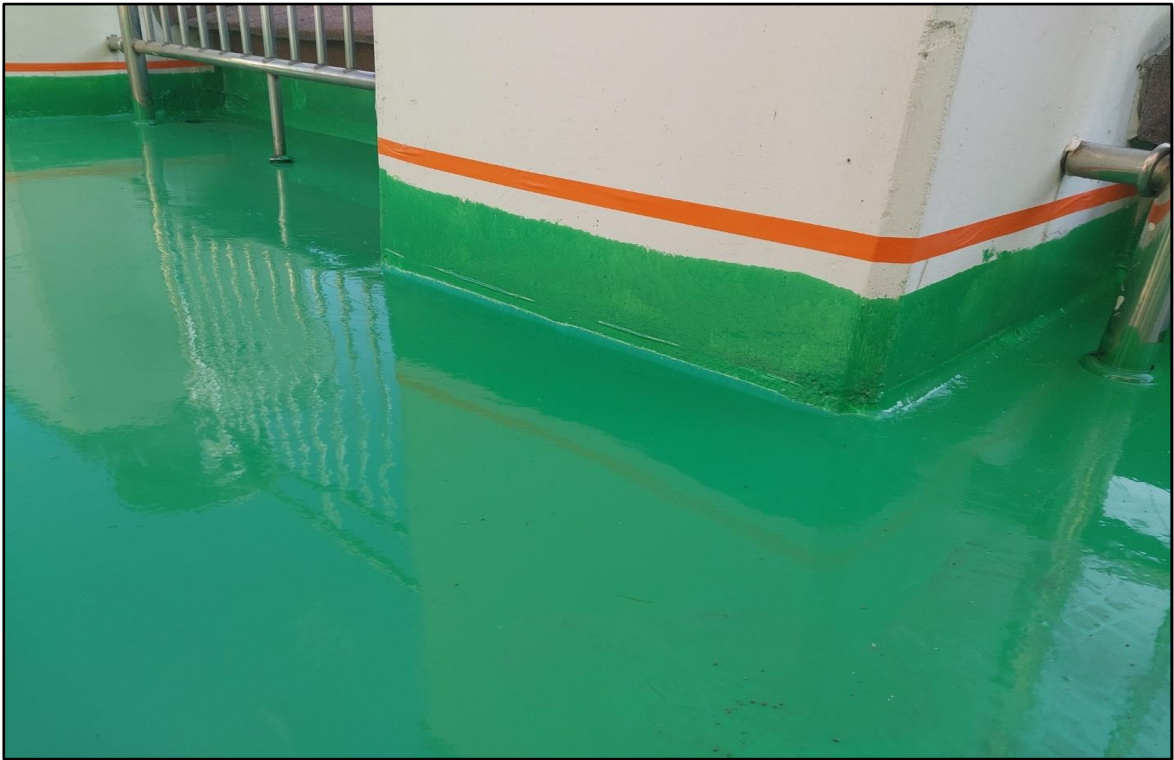
우레탄 상도 도포 마감(마스킹 테이핑 작업)
