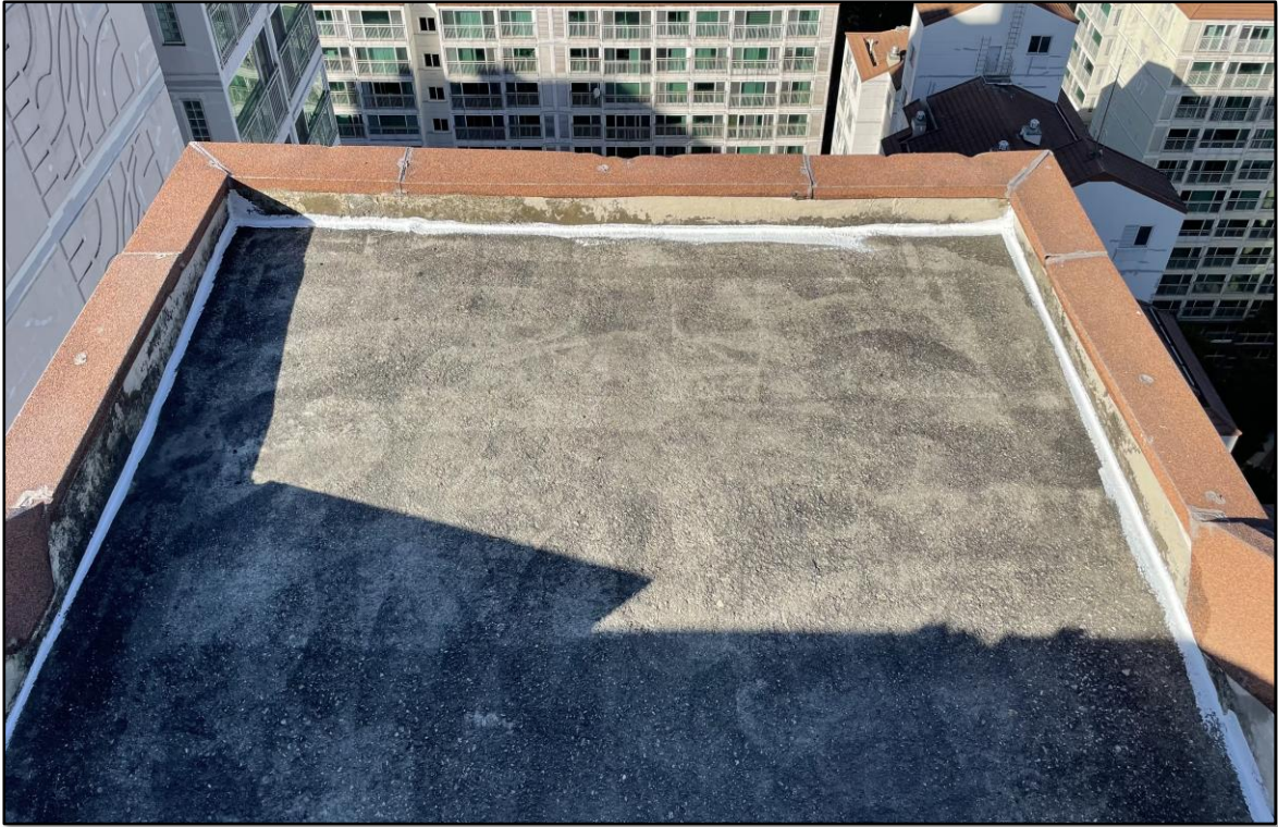
우레탄 실란트 시공
