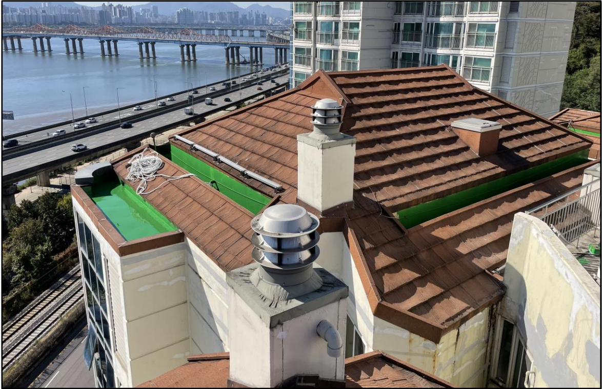
우레탄 중도 1차 시공
