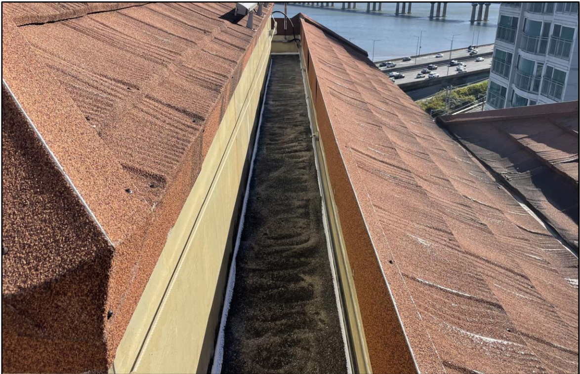
우레탄 실란트 시공
