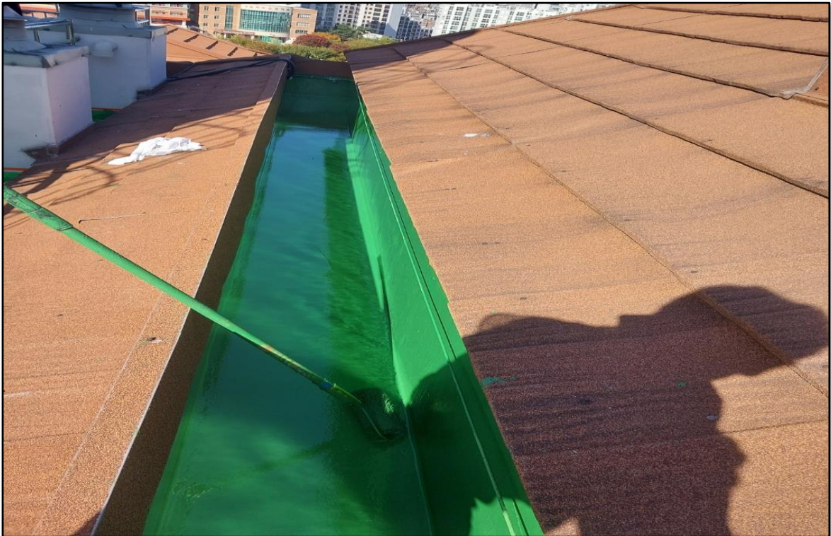
우레탄 중도 2차 시공
