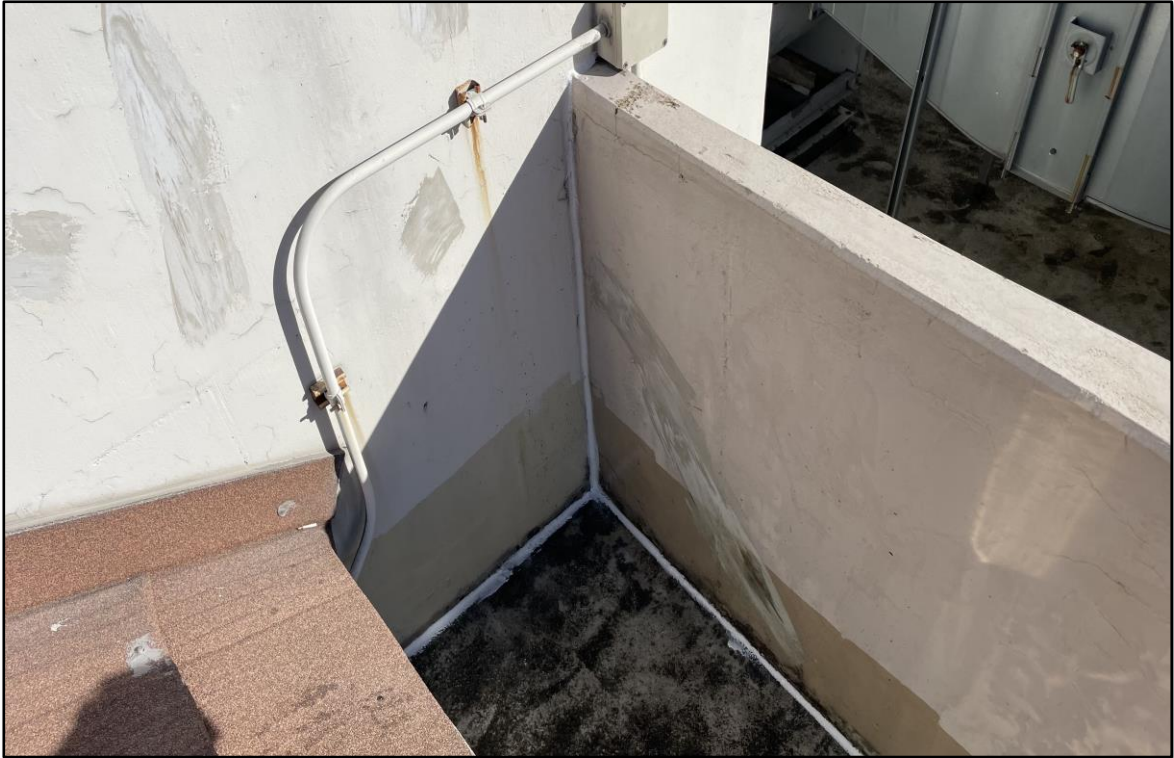
우레탄 실란트 시공
