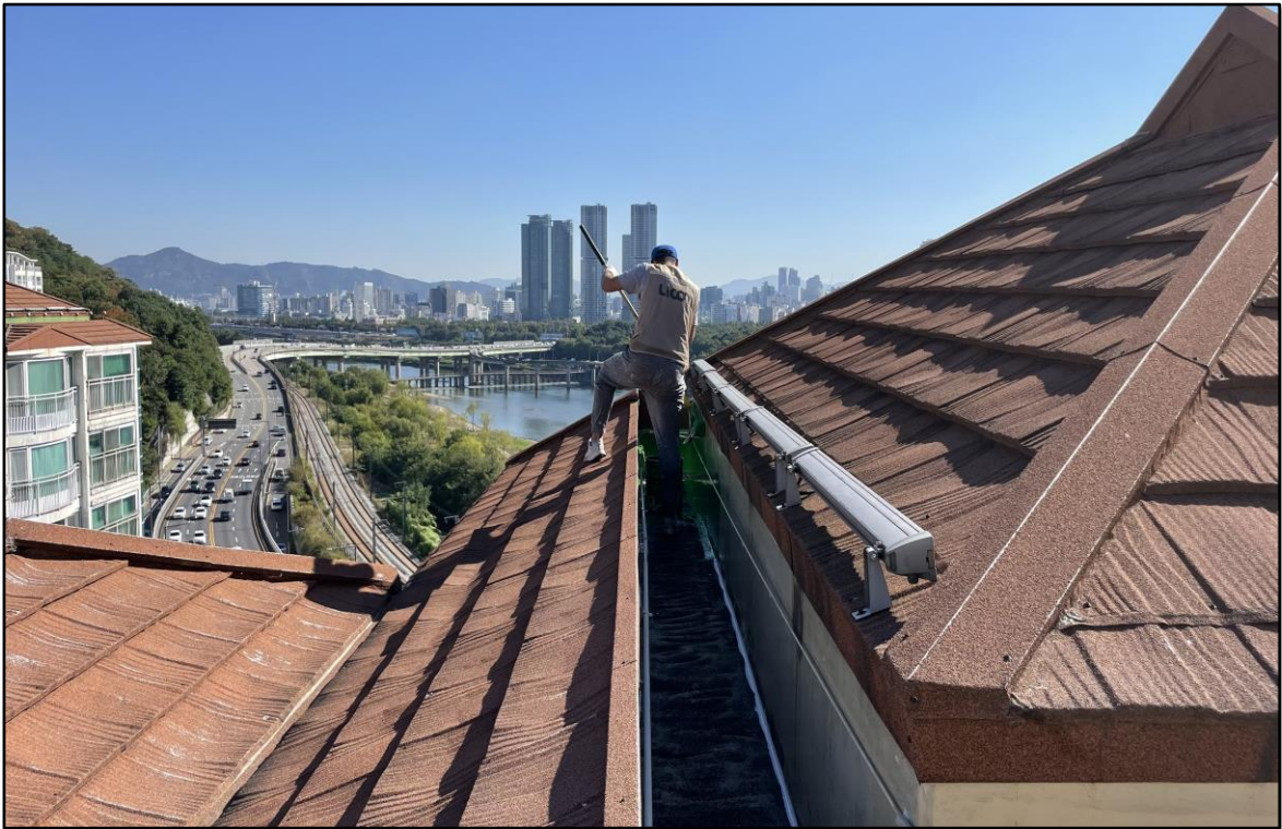
우레탄 중도 1차 시공
