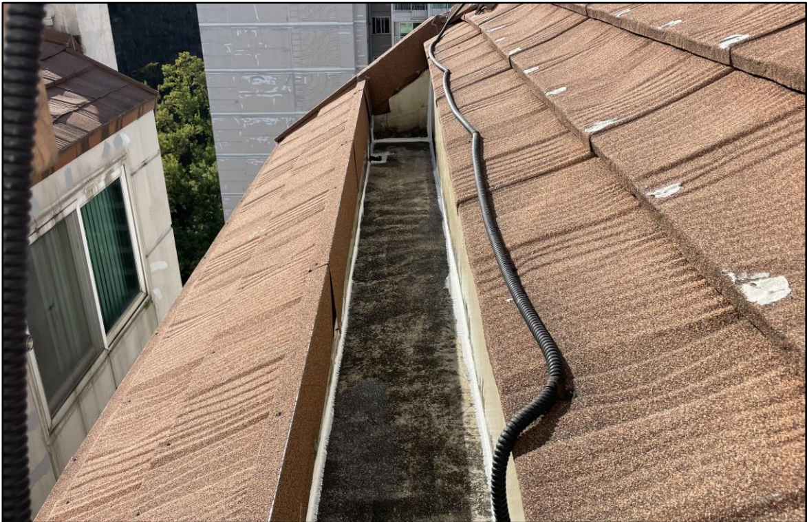
우레탄 실란트 시공
