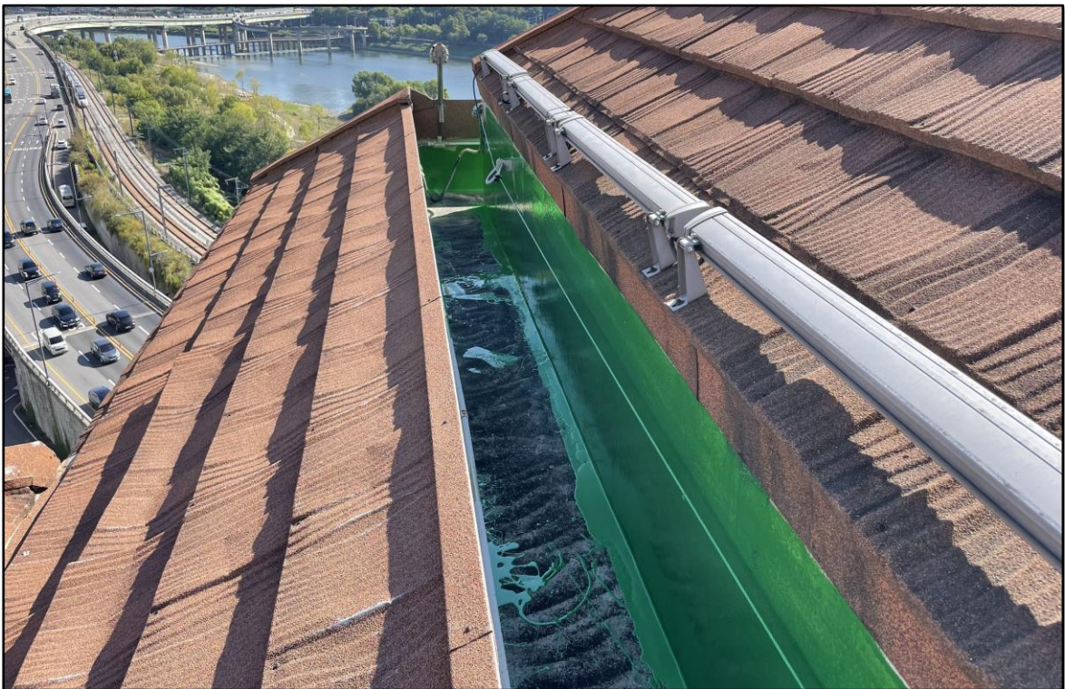
우레탄 중도 1차 시공
