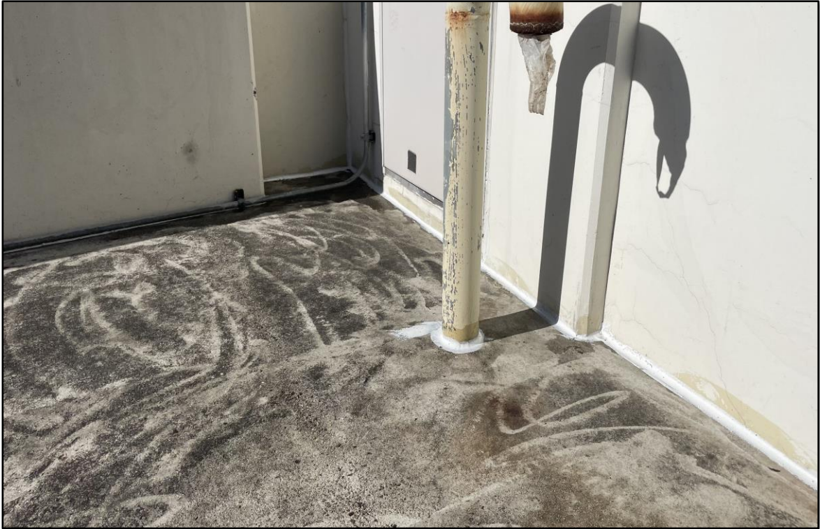
우레탄 실란트 시공
