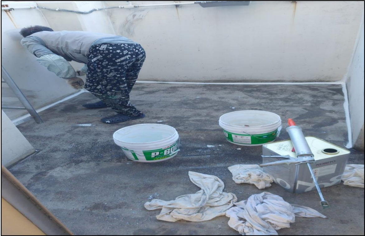
우레탄 실란트 시공
