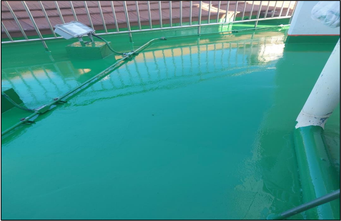
우레탄 중도 2차 시공
