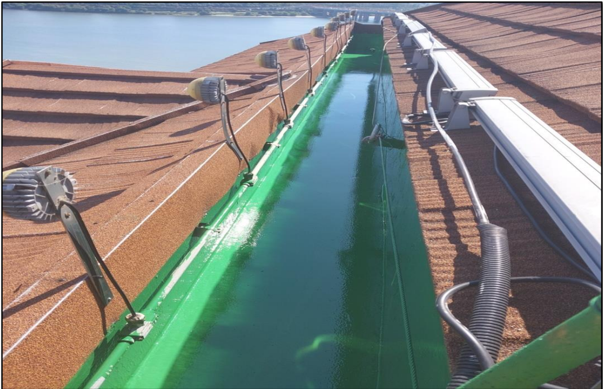
우레탄 중도 2차 시공
