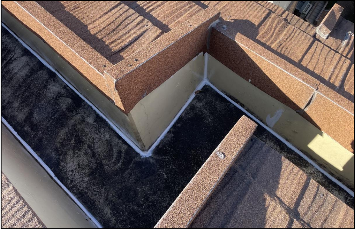
우레탄 실란트 시공
