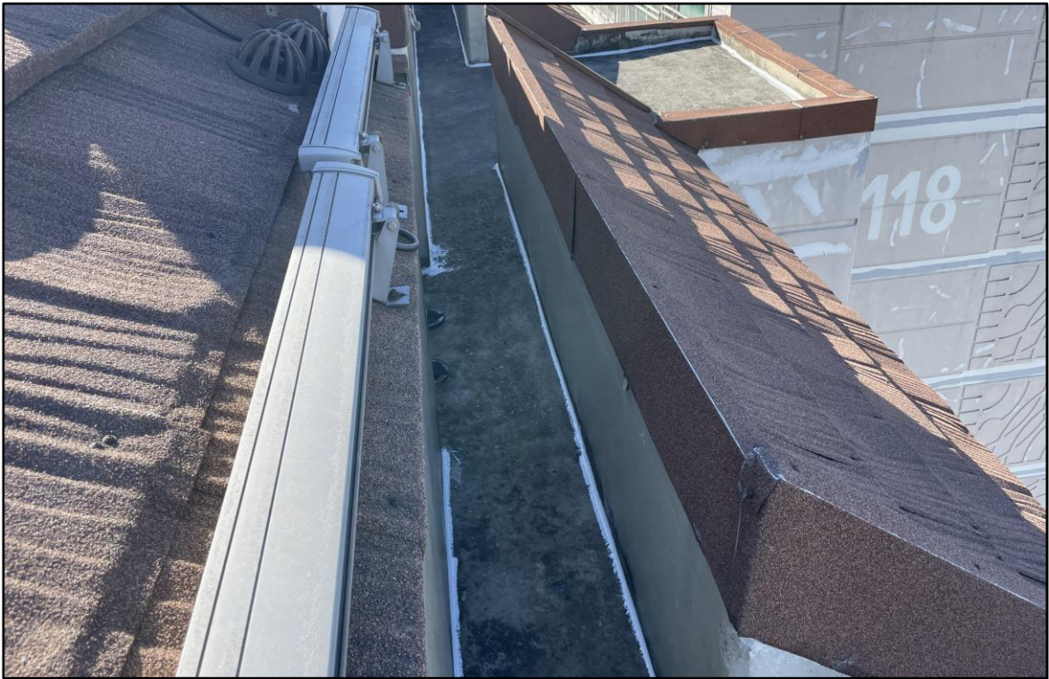
우레탄 실란트 시공
