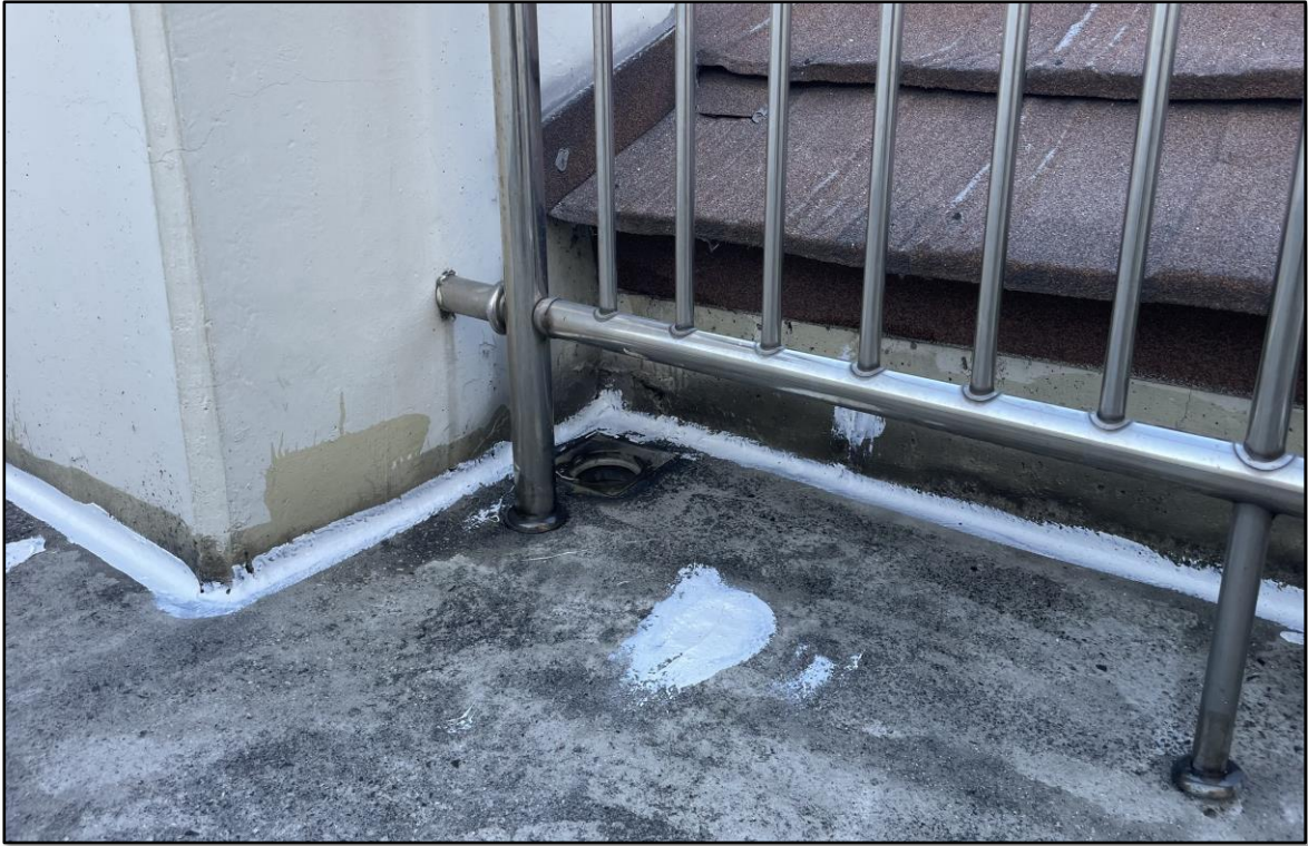
우레탄 실란트 시공
