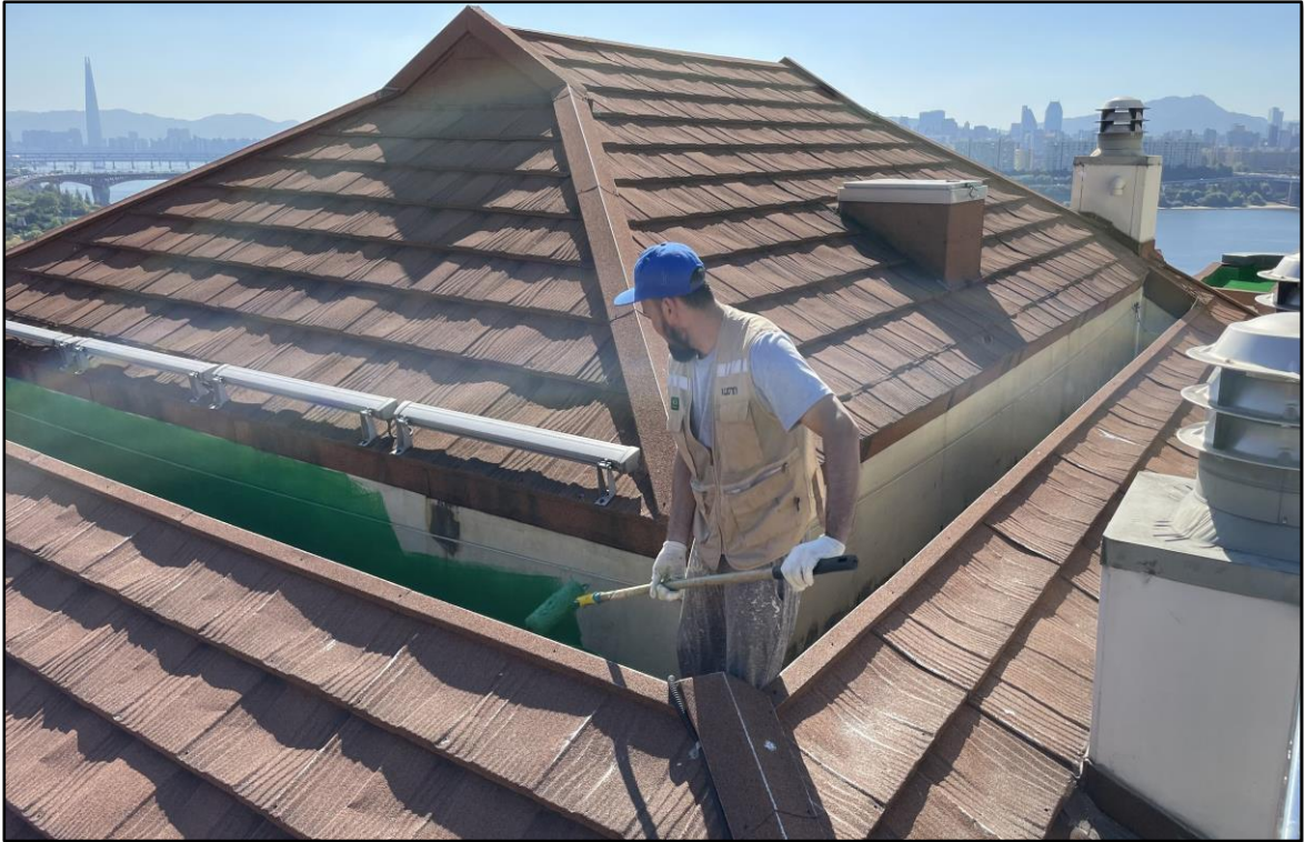
우레탄 중도 1차 시공
