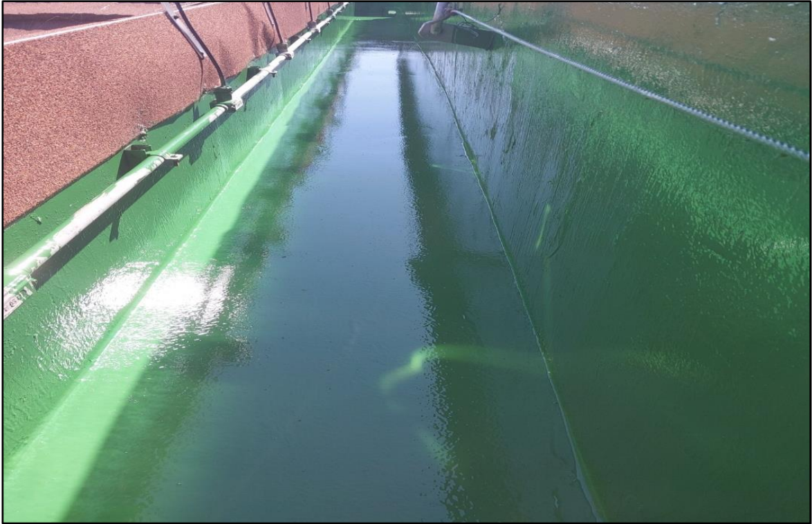
우레탄 중도 2차 시공
