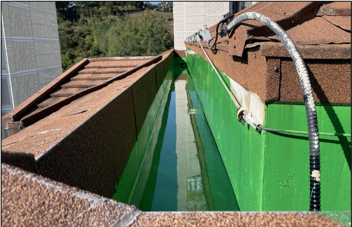
우레탄 중도 1차 시공
