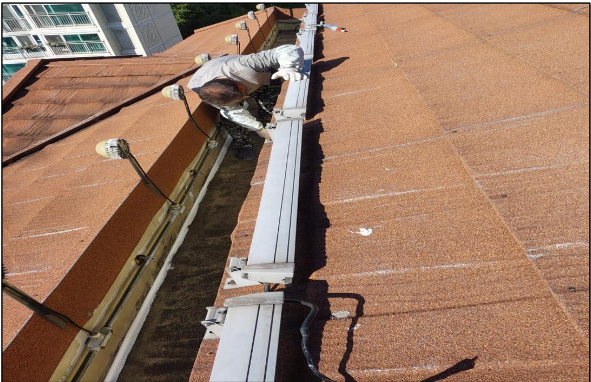
우레탄 실란트 시공
