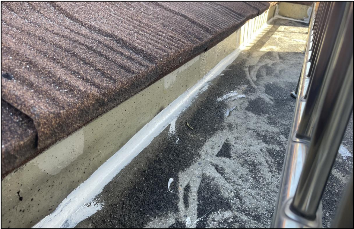
우레탄 실란트 시공
