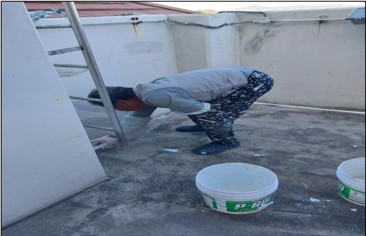
우레탄 실란트 시공
