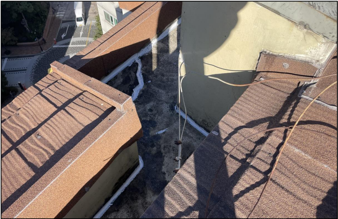
우레탄 실란트 시공
