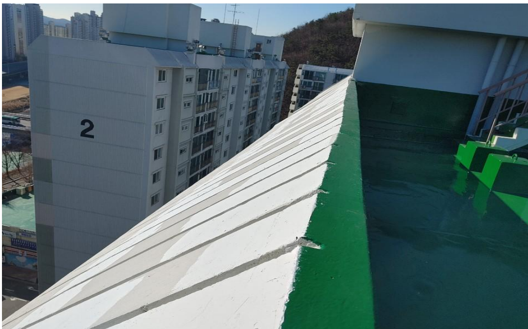
외벽 파라펫 균열보수 후 도장마감(부분도장)
