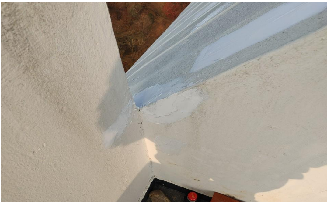
외벽 파라펫 균열보수
