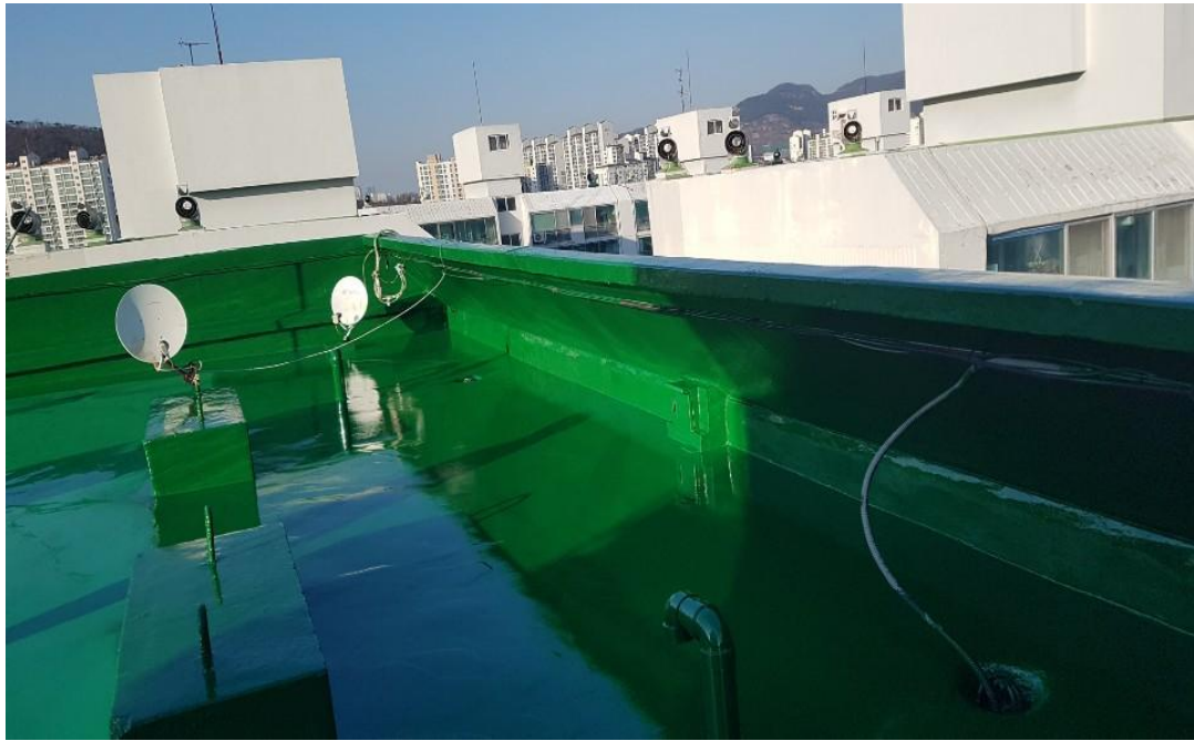
옥상층 우레탄 방수공사 완료 후(전경사진)
