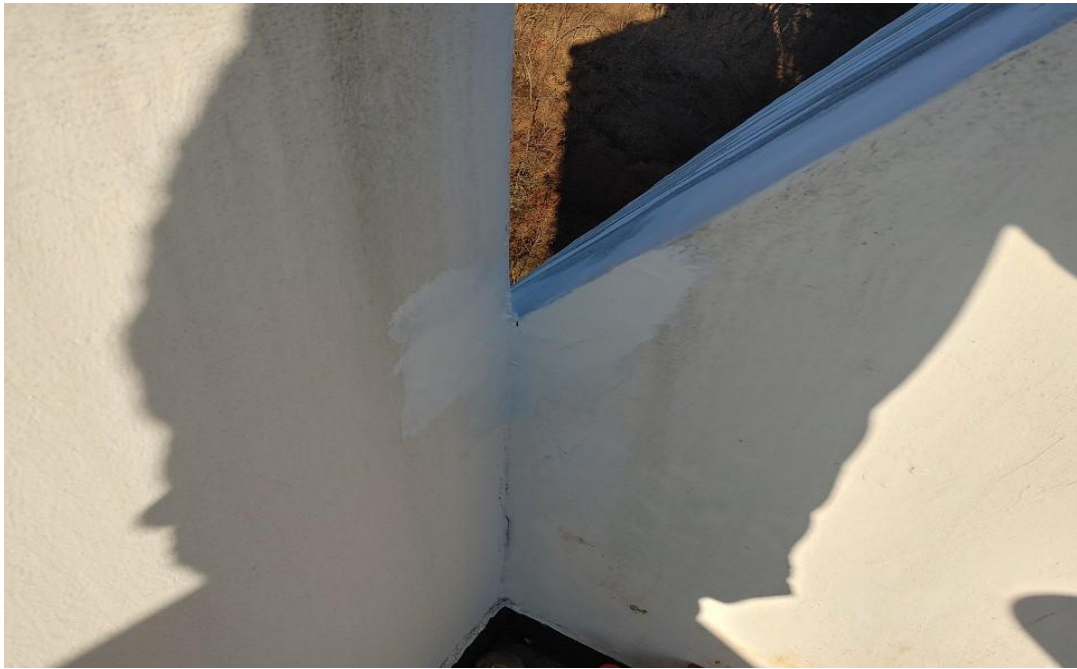
외벽 파라펫 균열보수 후 도장마감(부분도장)
