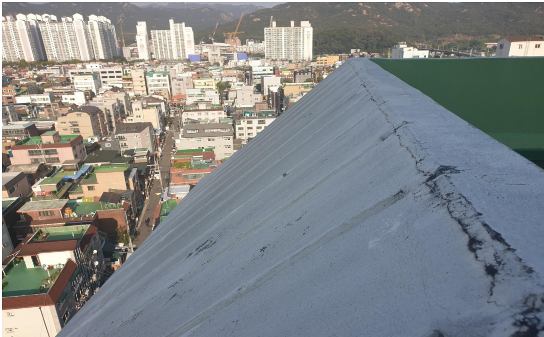
공사전 외벽 파라펫
