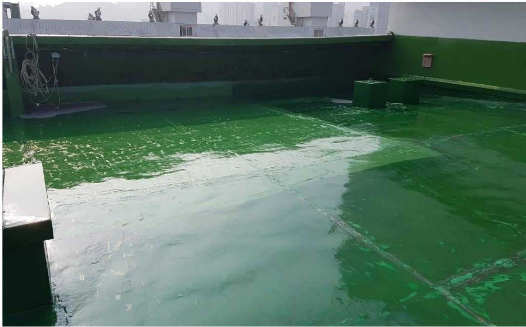
바닥 들뜸부위 보수 후 우레탄 프라이마 도포
