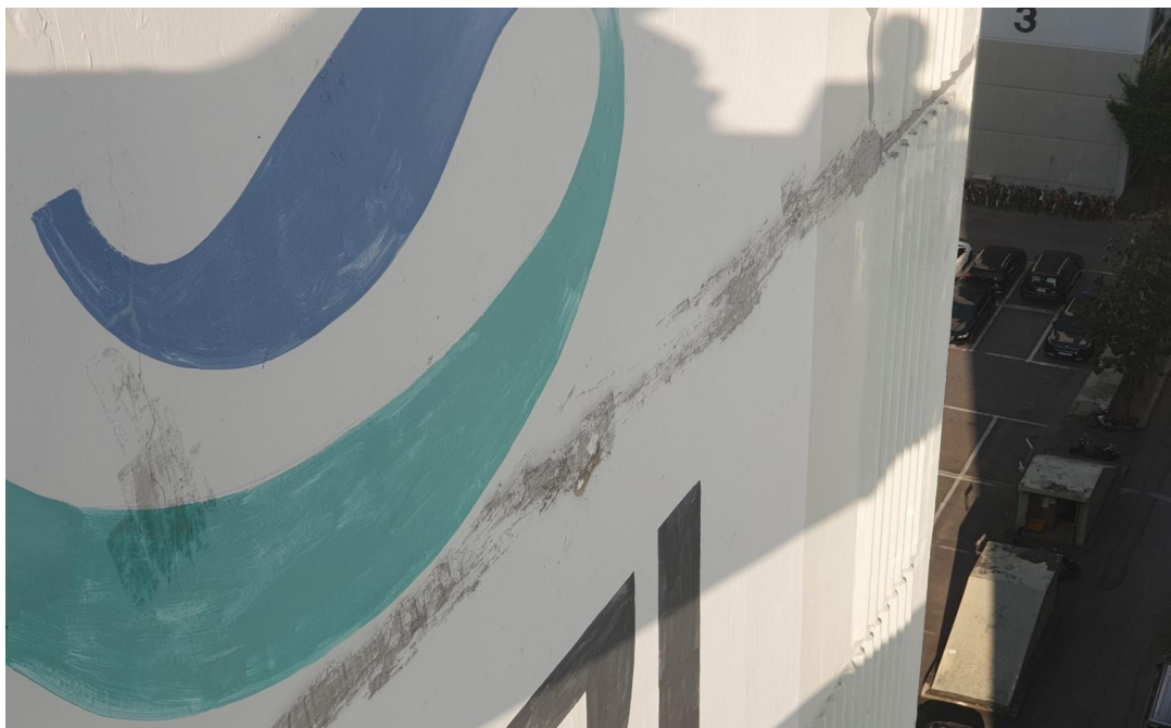
공사전 외벽 측벽
