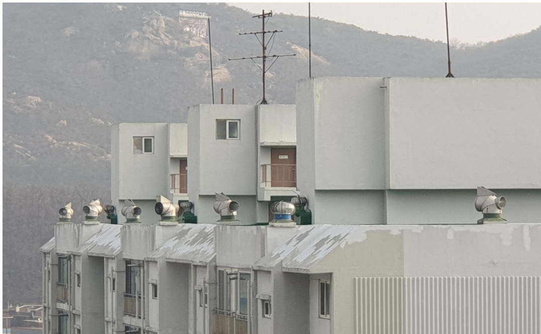
외벽 파라펫 균열보수 및 도장마감 후(3동)
