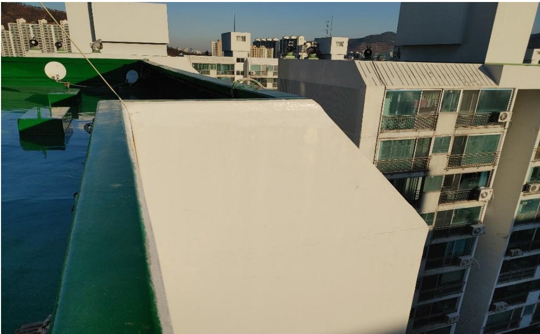
외벽 파라펫 균열보수 후 도장마감(부분도장)
