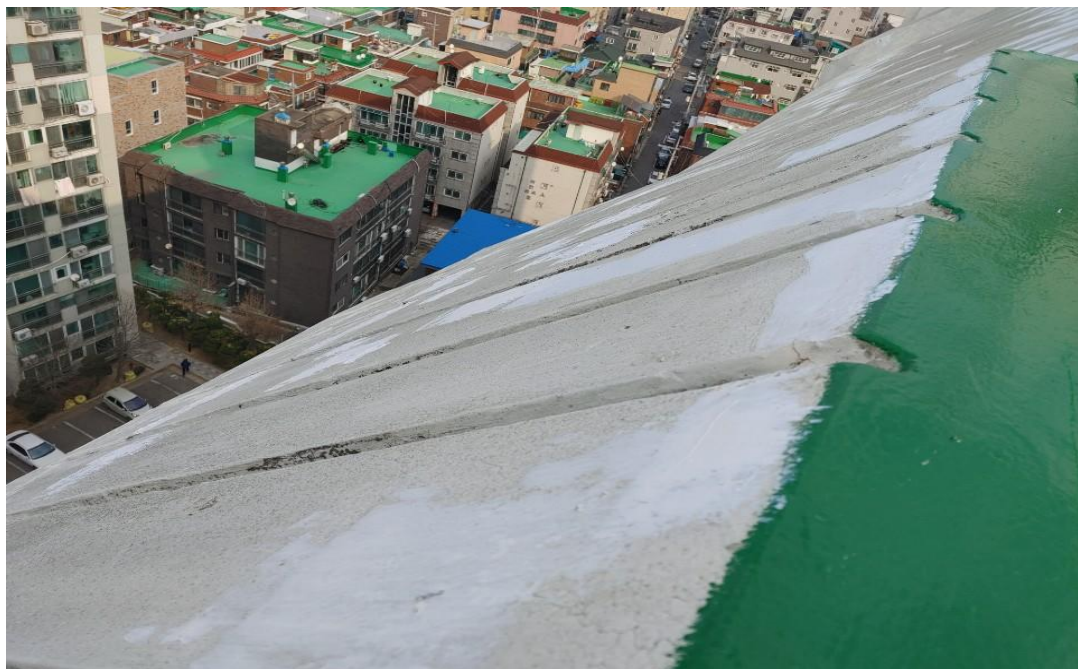
외벽 파라펫 균열보수
