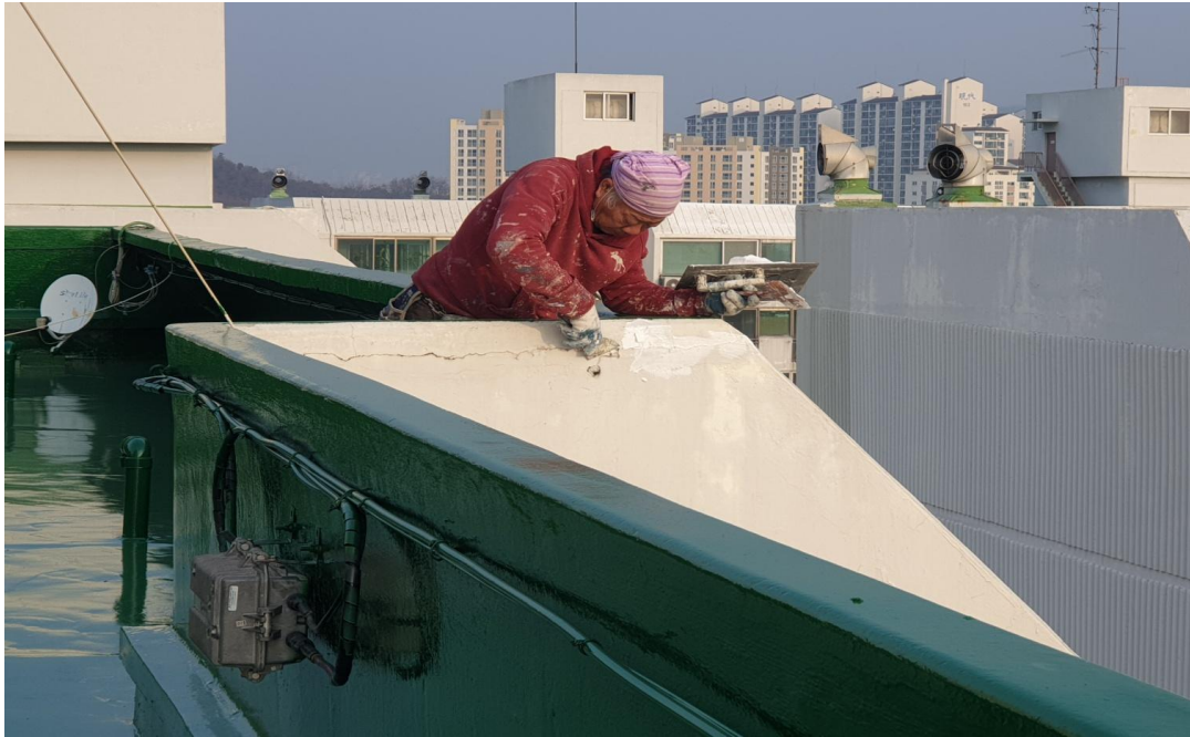
외벽 파라펫 균열보수
