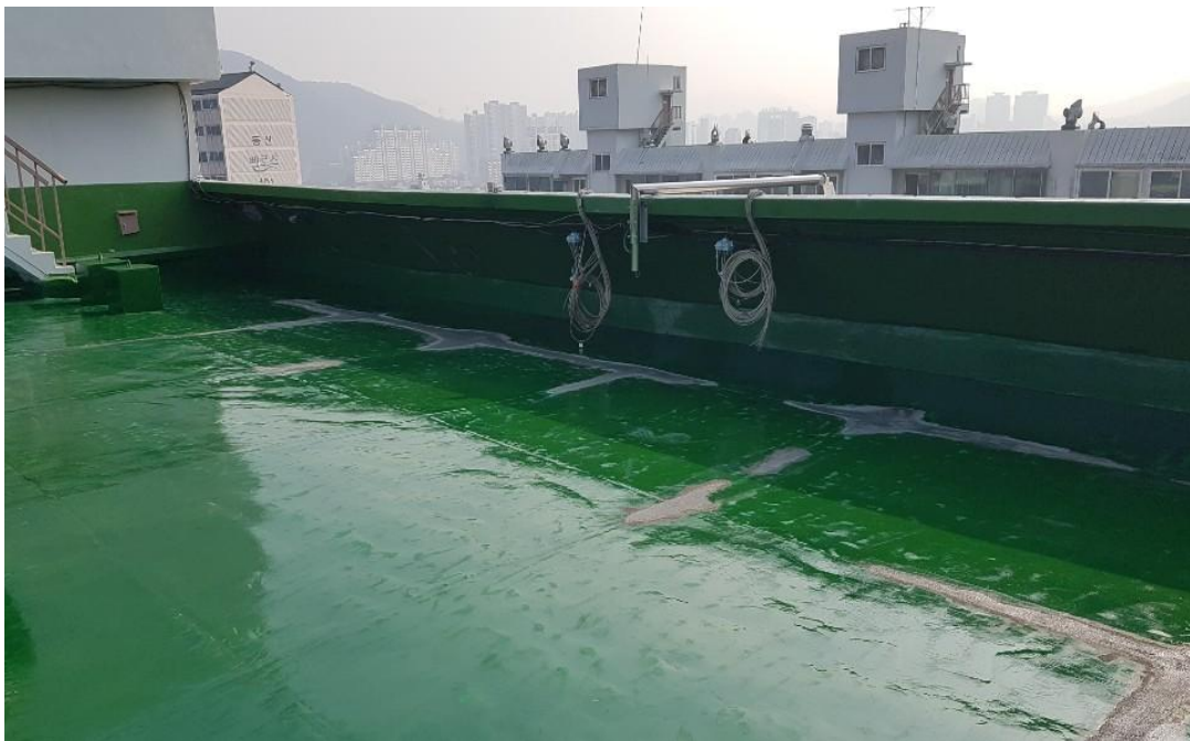
바닥 들뜸부위 보수 후 우레탄 프라이마 도포
