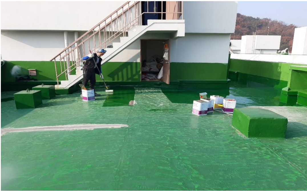
바닥 들뜸부위 보수 후 우레탄 프라이마 도포
