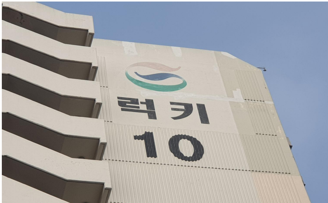
측벽 균열보수 후 도장마감 후(10동)
