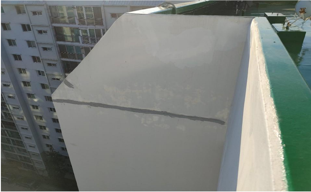
외벽 파라펫 균열보수 후 도장마감(부분도장)
