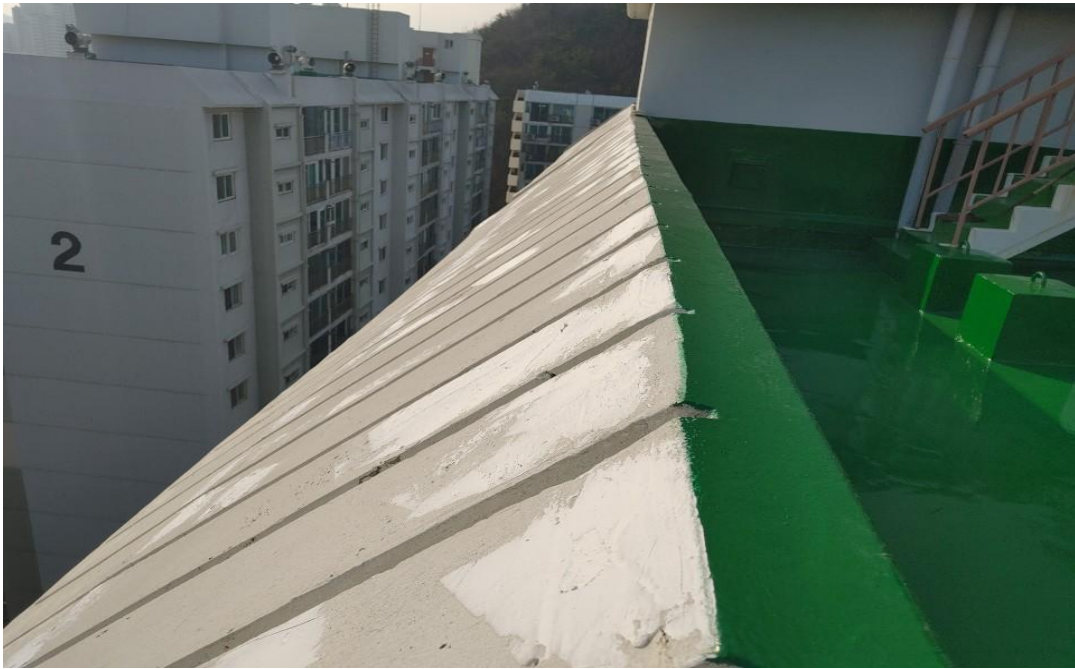
외벽 파라펫 균열보수
