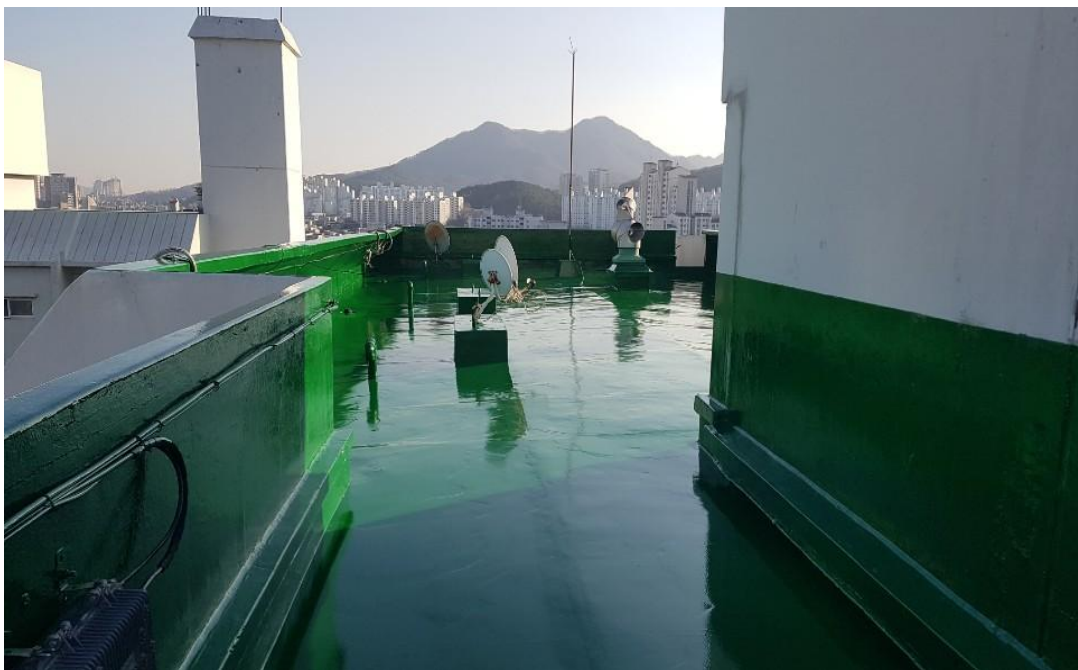
옥상층 우레탄 방수공사 완료 후(전경사진)
