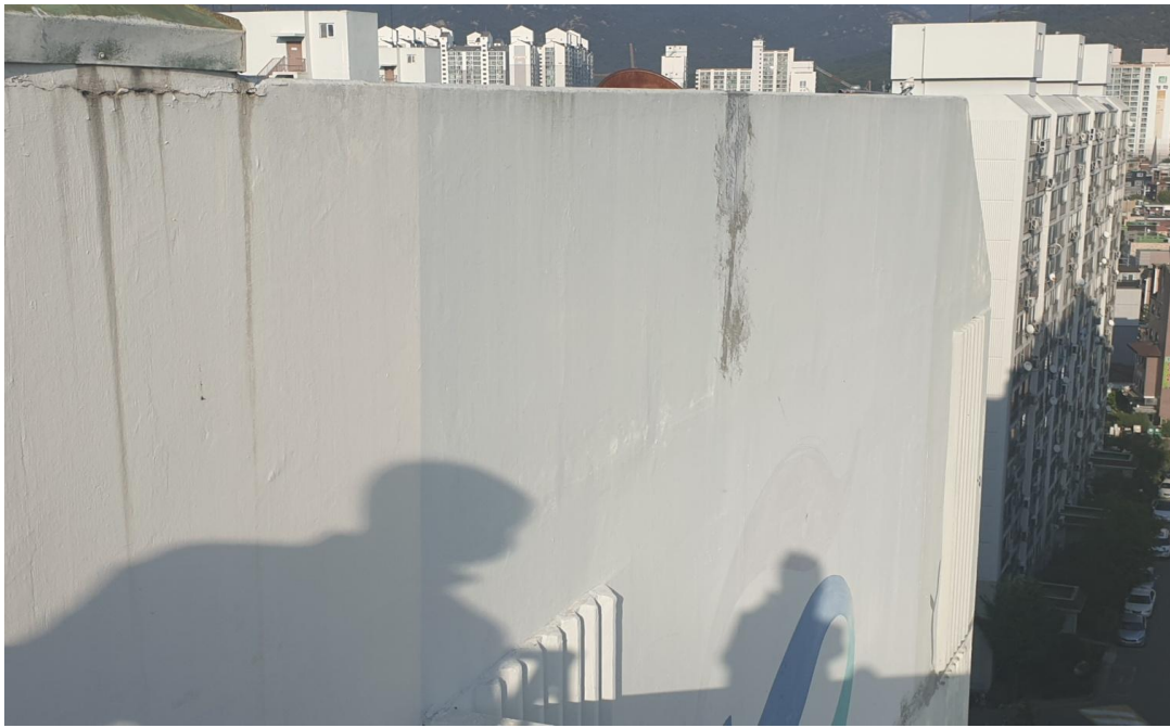
공사전 외벽 측벽
