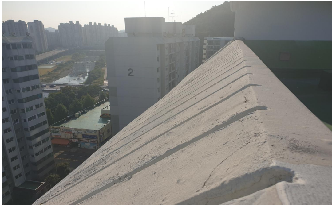
공사전 외벽 파라펫
