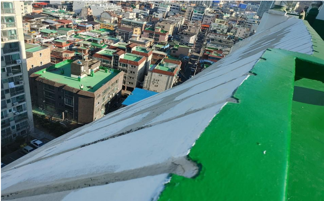
외벽 파라펫 균열보수 후 도장마감(부분도장)
