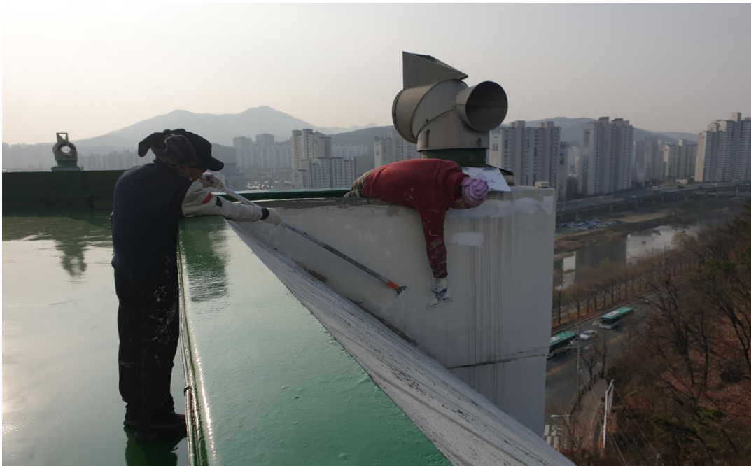
외벽 파라펫 균열보수
