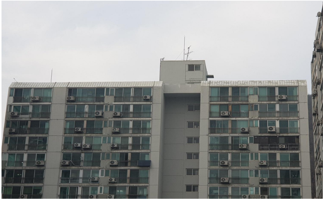
외벽 파라펫 균열보수 및 도장마감 후(10동)
