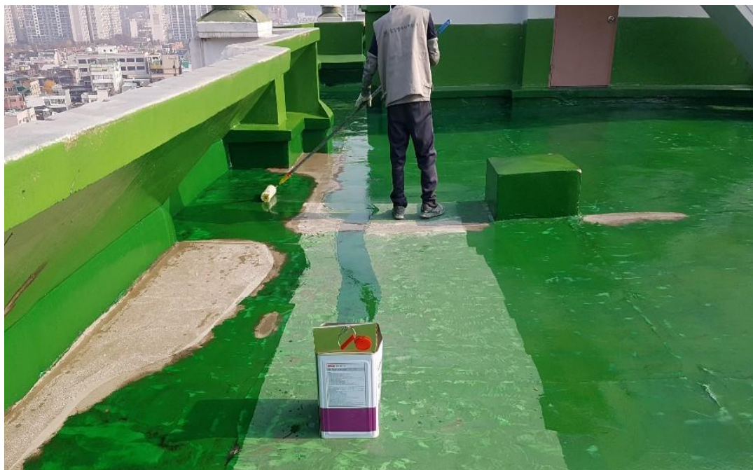
바닥 들뜸부위 보수 후 우레탄 프라이마 도포
