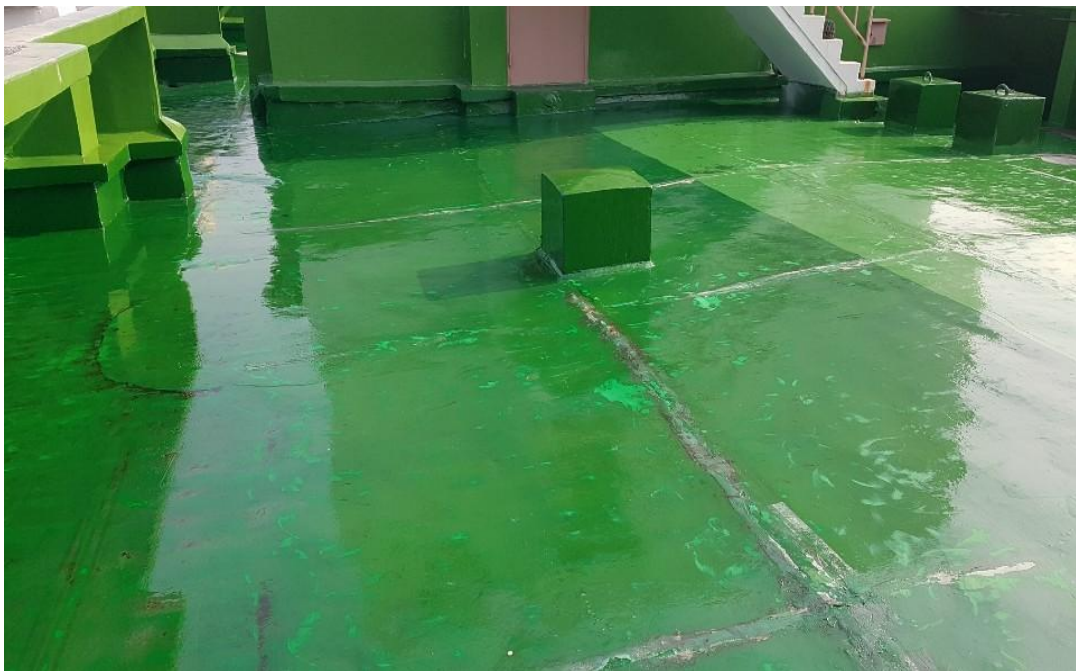
바닥 들뜸부위 보수 후 우레탄 프라이마 도포
