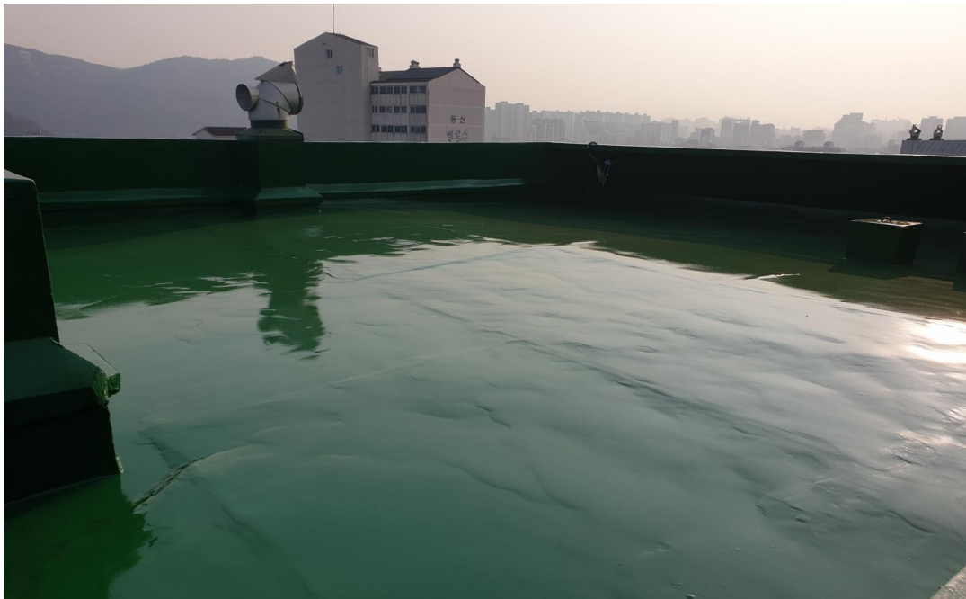
옥상층 우레탄 방수공사 완료 후(전경사진)
