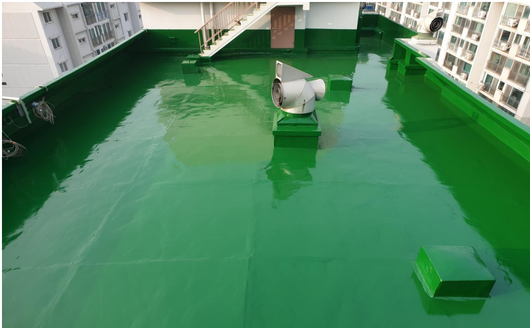
옥상층 우레탄 방수공사 완료 후(전경사진)
