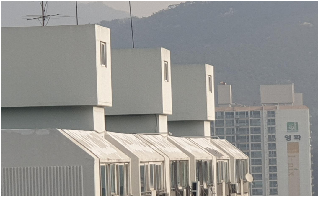
외벽 파라펫 균열보수 및 도장마감 후(3동)
