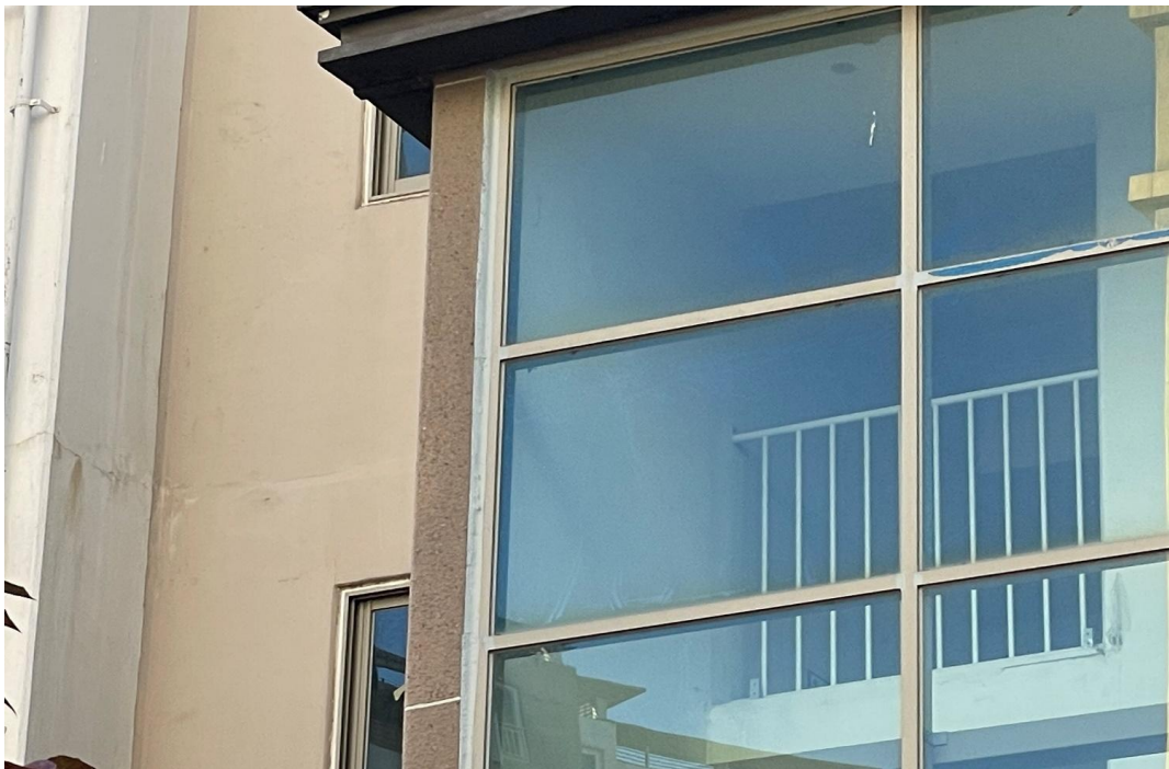
공용계단실 외부 코킹공사 완료
