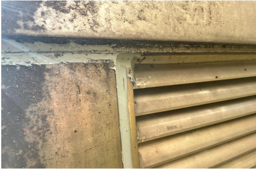
지하주차장 채광창 코킹 공사 완료
