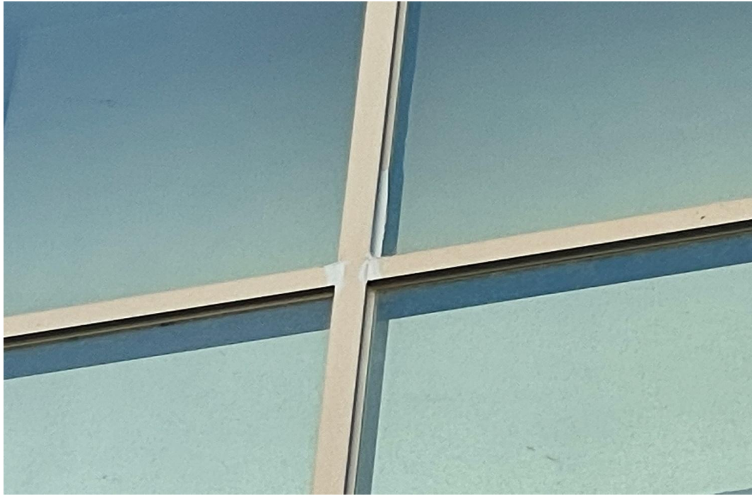
공용계단실 외부 코킹공사 완료
