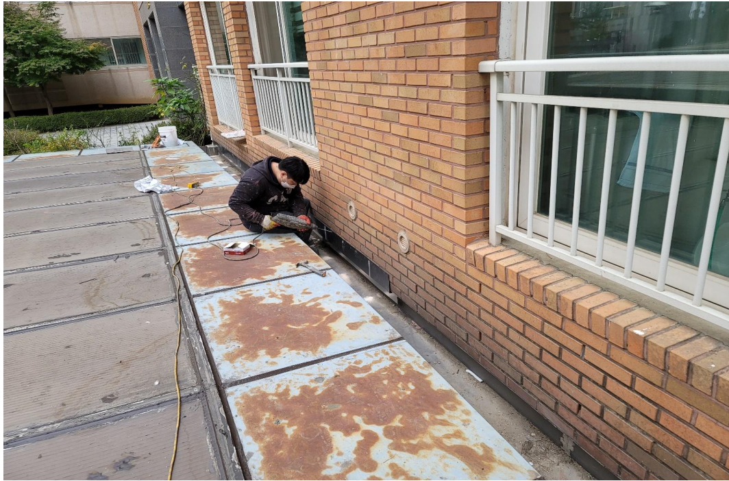
지하주차장 진입램프 렉산 천장 누수부위 보수 공사 중
