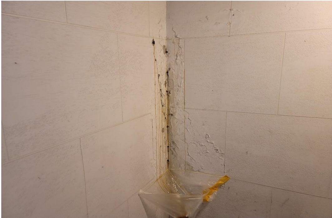
공용계단실 지하층 누수부위 주입 방수 중
