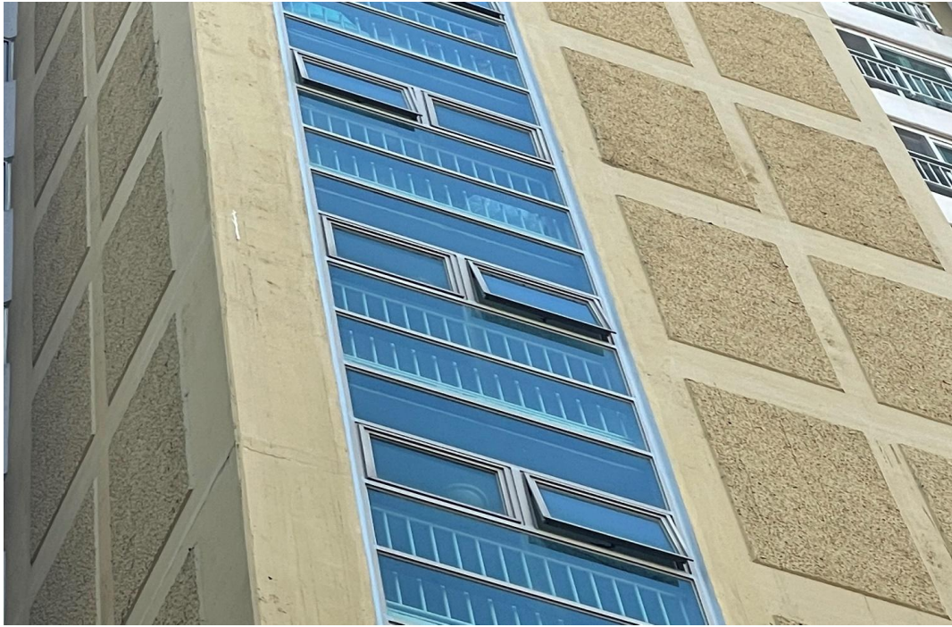
공용계단실 외부 코킹공사 완료
