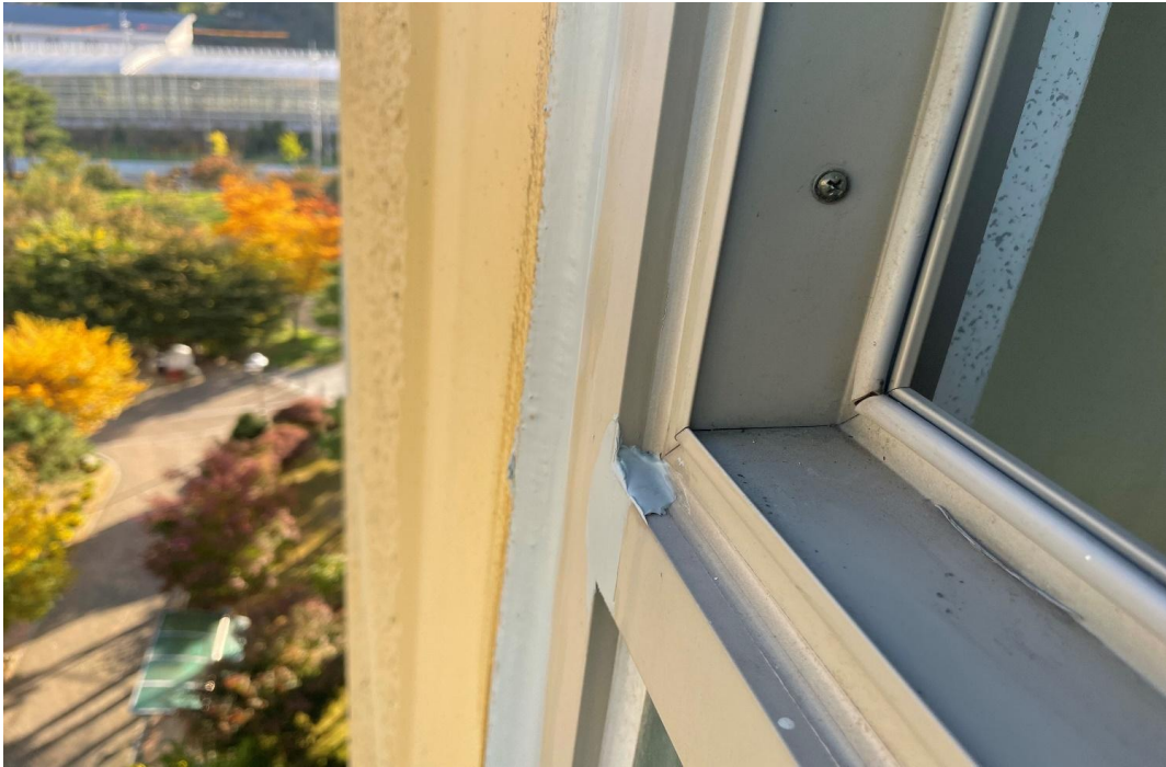
공용계단실 외부 코킹공사 완료
