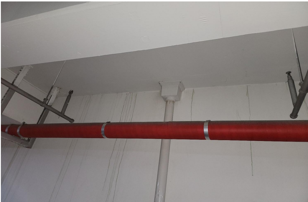
PVC관 유도배수 공사 완료
