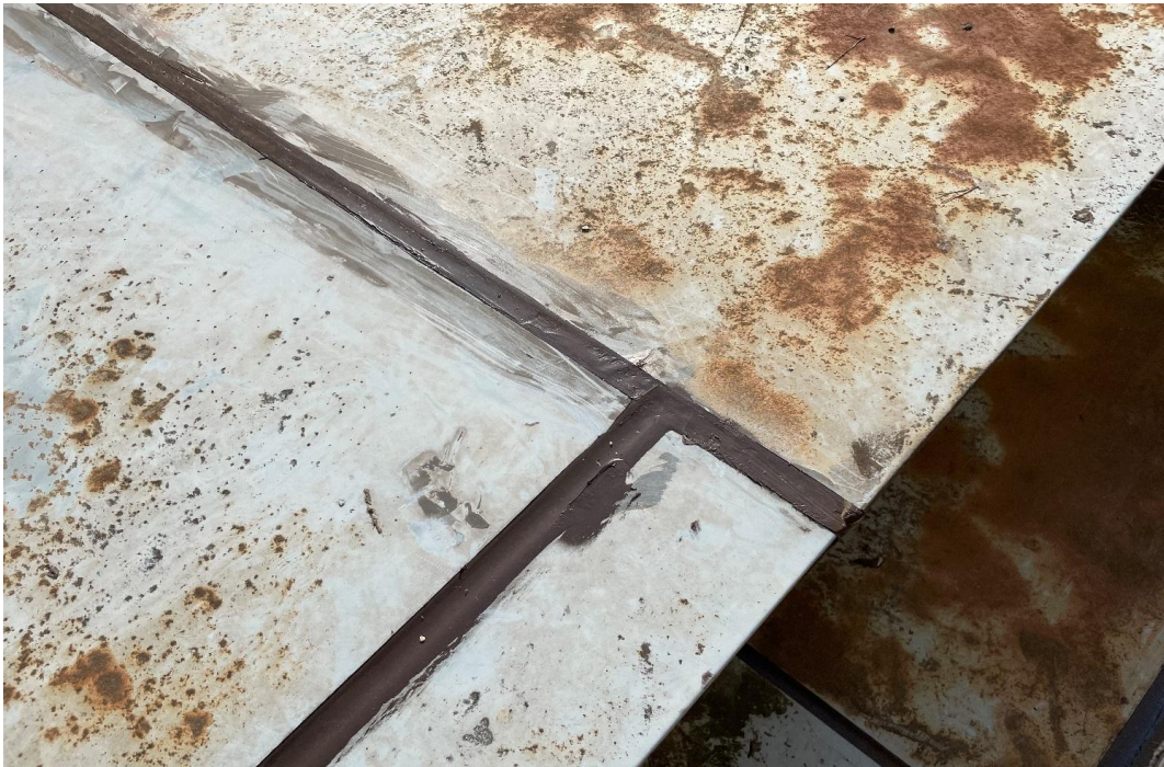
지하주차장 램프 렉산 코킹 공사 완료
