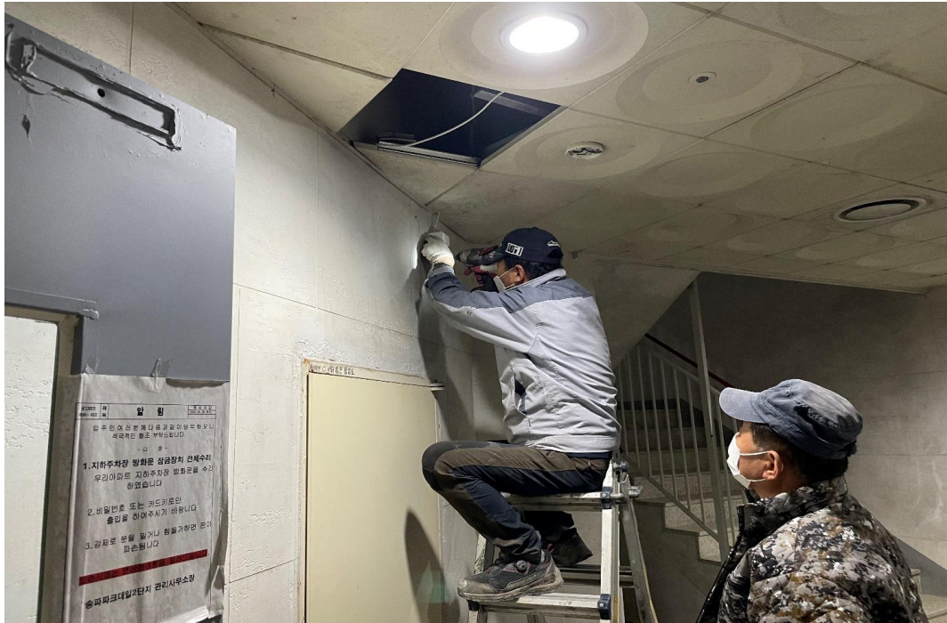
제습기 설치 공사 중
