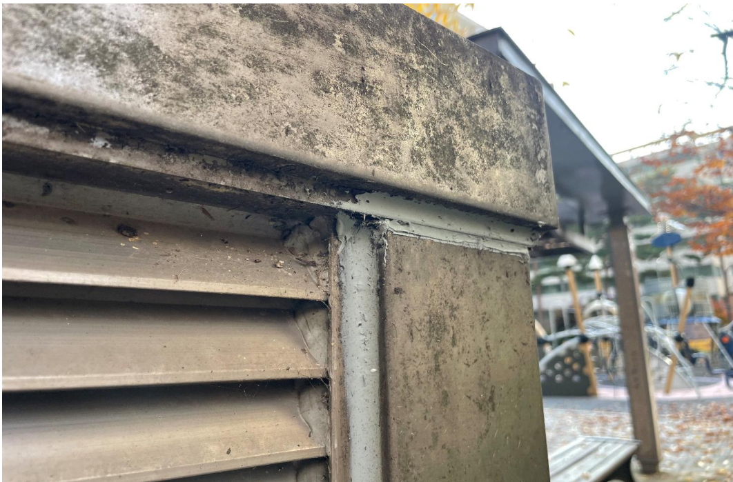
지하주차장 채광창 코킹 공사 완료
