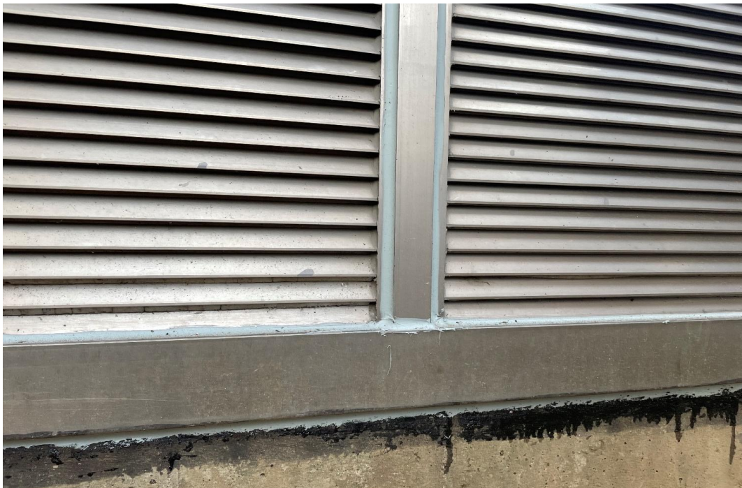
지하주차장 채광창 코킹 공사 완료
