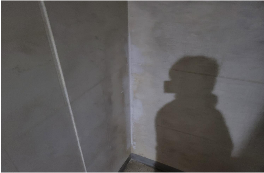
공용계단실 내부 누수부위 보수 완료
