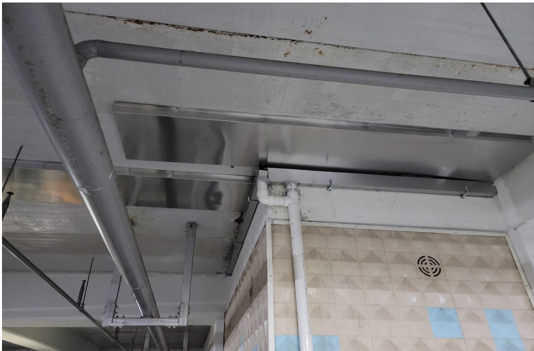
지하주차장 천장 누수부위 유도보수 완료
