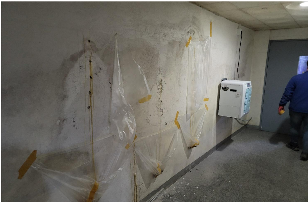
공용계단실 지하층 누수부위 주입 방수 중
