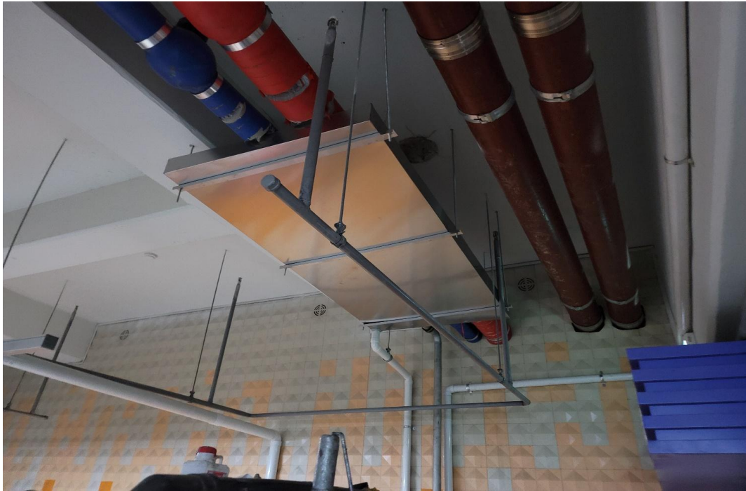
지하주차장 천장 누수부위 유도보수 완료
