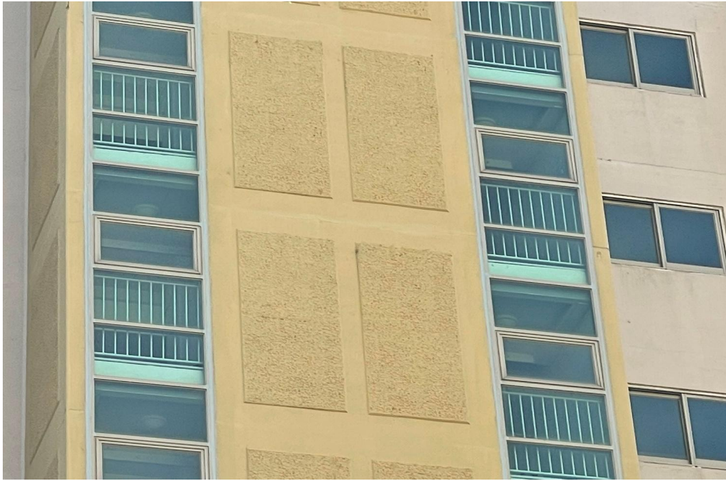
공용계단실 외부 코킹공사 완료
