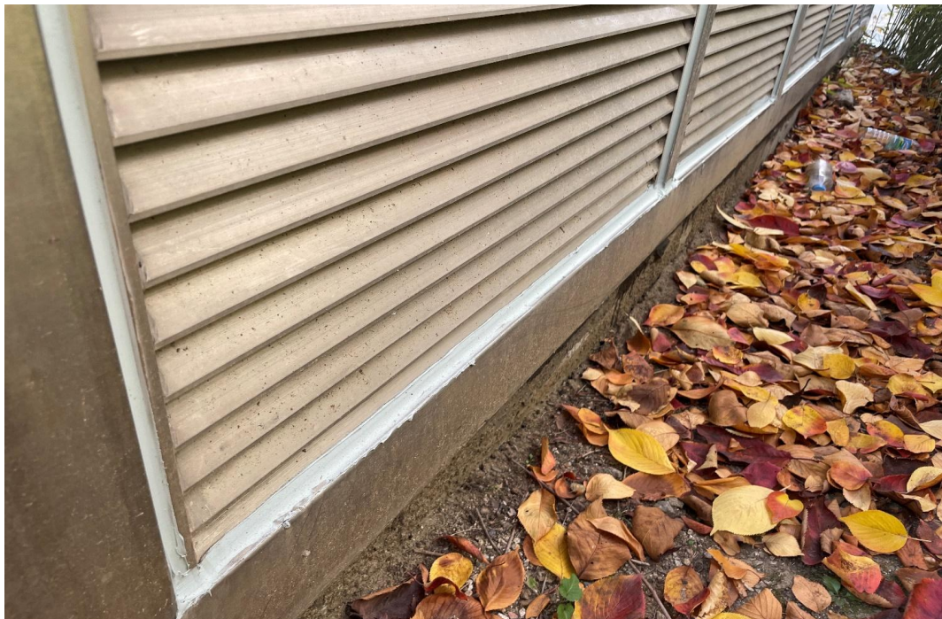
지하주차장 채광창 코킹 공사 완료
