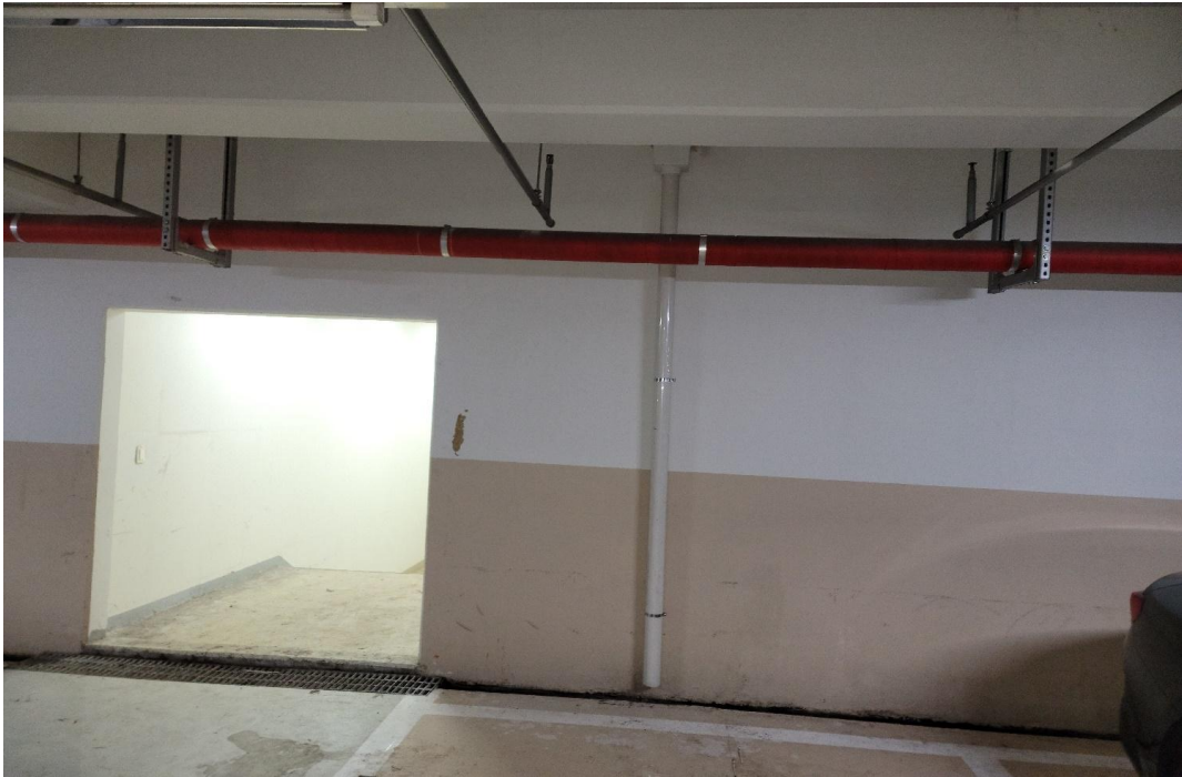
PVC관 유도배수 공사 완료
