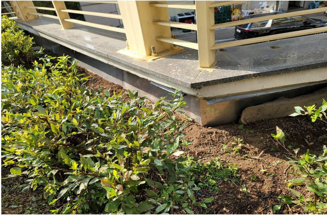
203동 앞 화단 누수보수 완료
