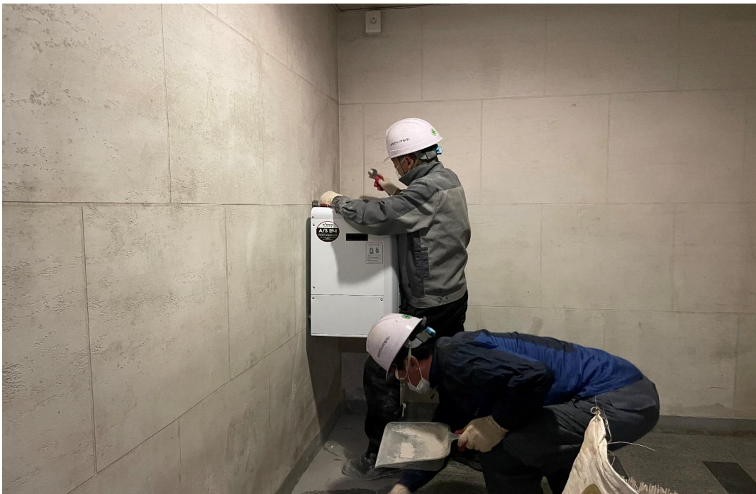
제습기 설치 공사 중
