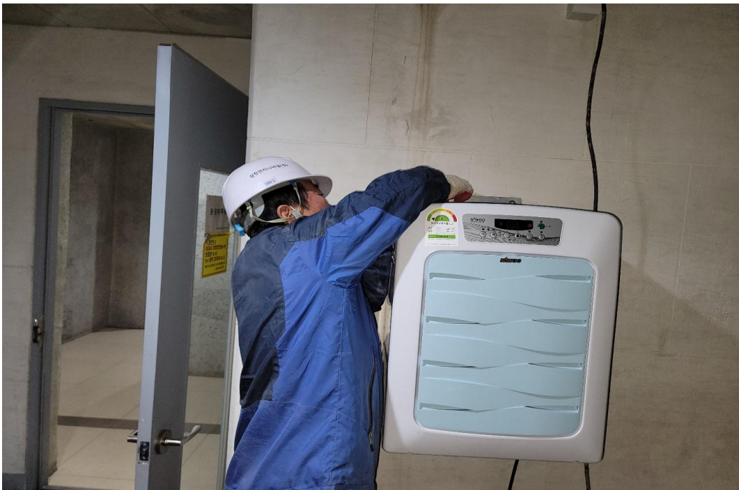
제습기 설치 공사 중
