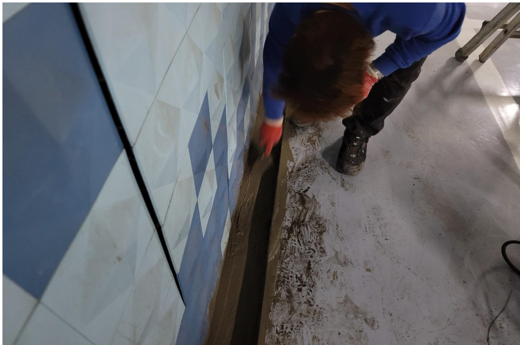
지하주차장 배수로 누수부위 액체방수 중
