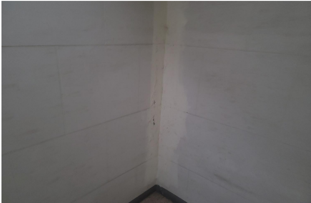
공용계단실 내부 누수부위 보수 완료
