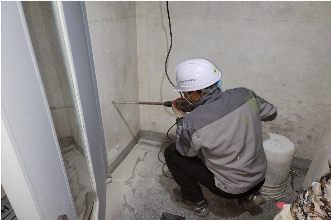
제습기 설치 공사 중
