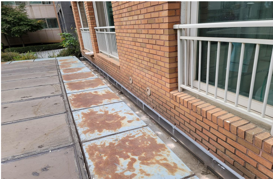
지하주차장 램프 렉산 천장 누수부위 보수 완료
