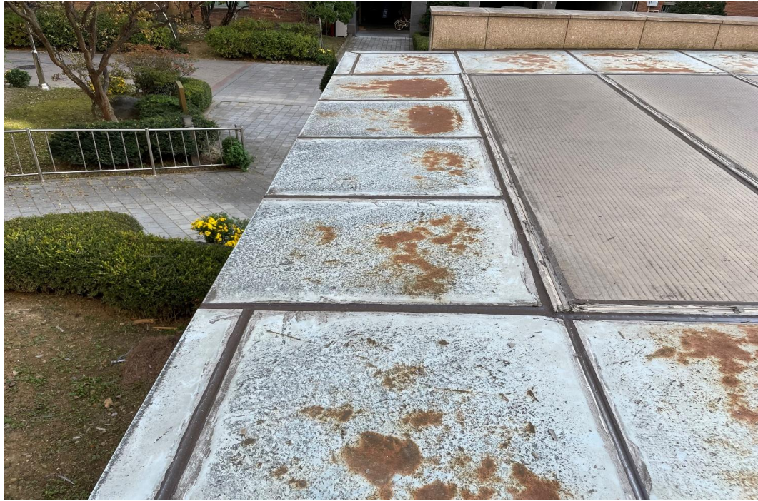
지하주차장 램프 렉산 코킹 공사 완료
