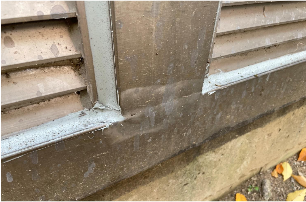
지하주차장 채광창 코킹 공사 완료
