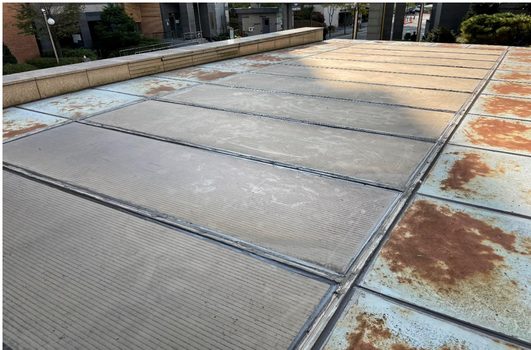
지하주차장 램프 렉산 코킹 공사 완료
