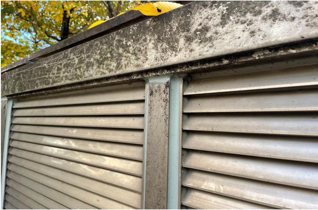
지하주차장 채광창 코킹 공사 완료
