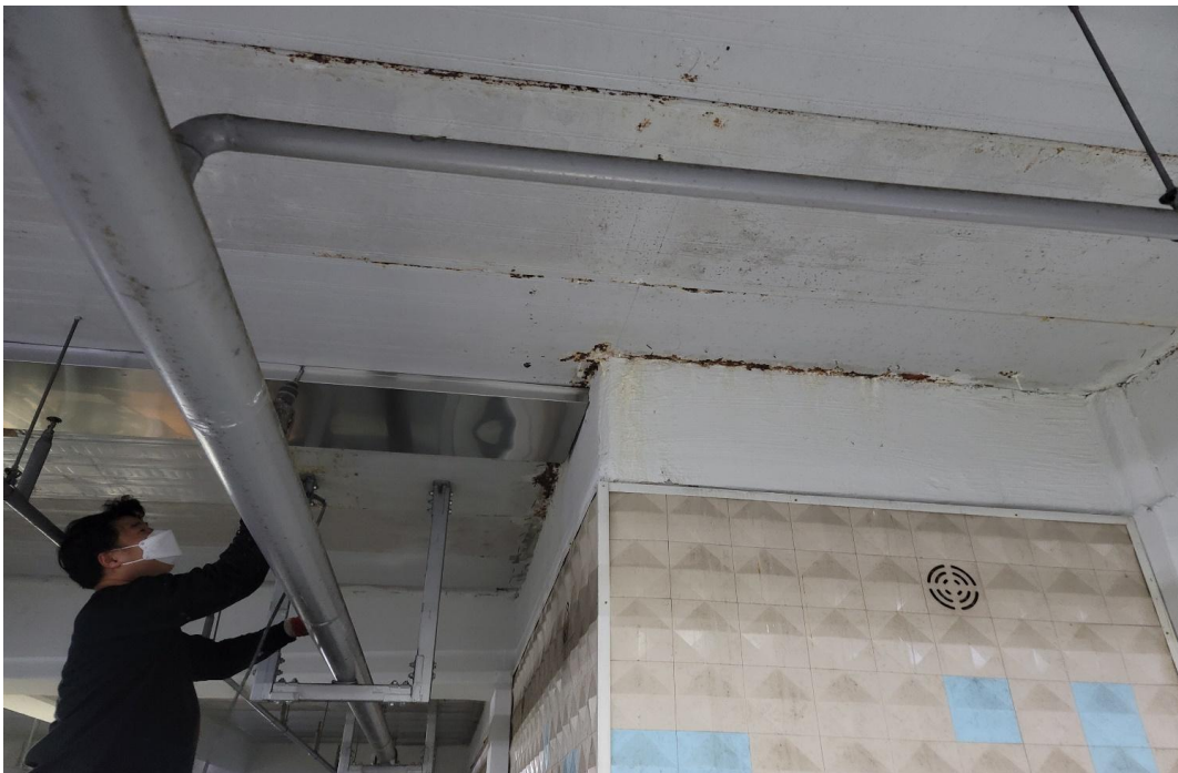
지하주차장 천장 누수부위 유도보수 공사 중
