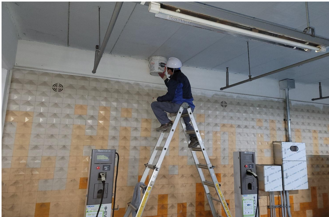
배수로 코어천공 및 PVC 배관 유도배수 공사 중
