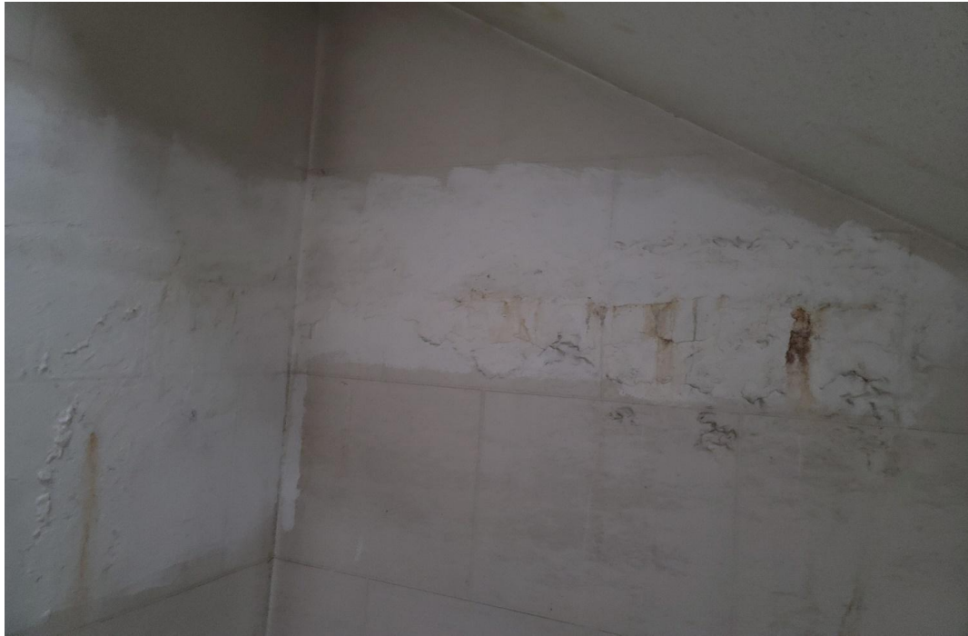
공용계단실 내부 누수부위 보수 완료
