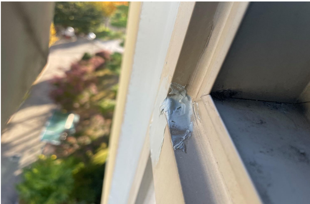
공용계단실 외부 코킹공사 완료
