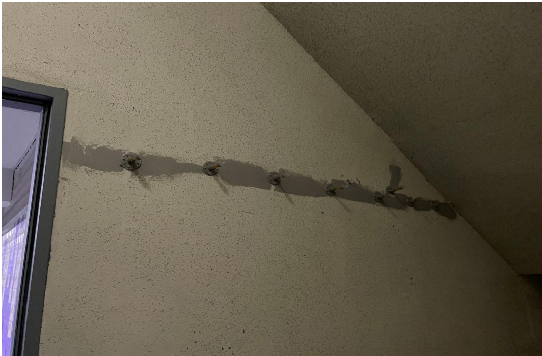
공용계단실 대균열 T-PORT 주사기 주입 시공 중
