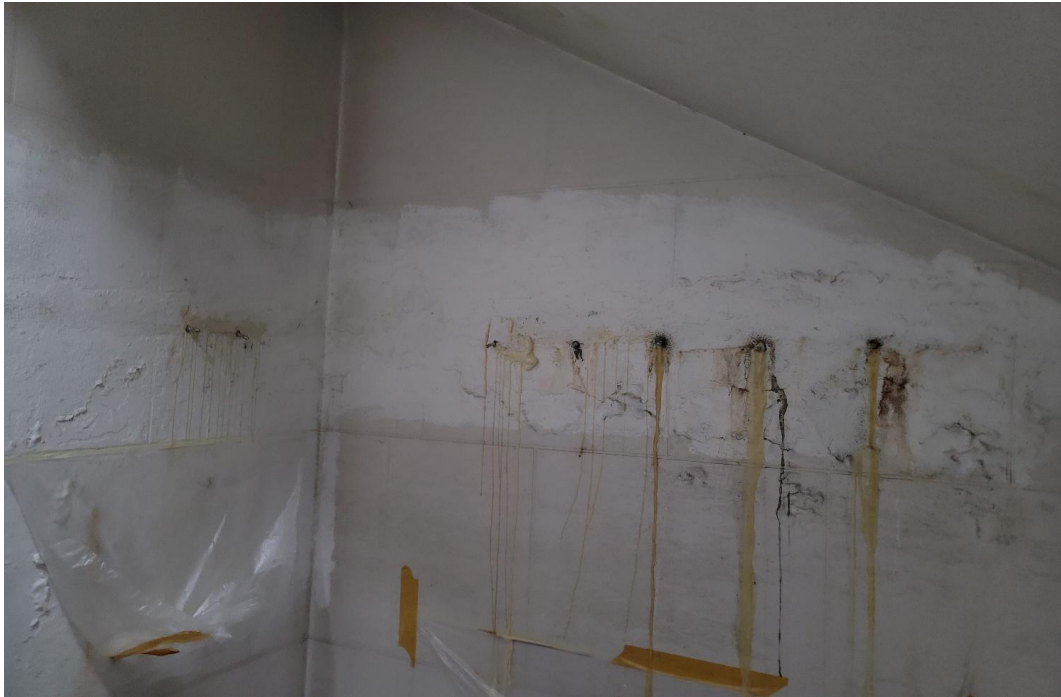
공용계단실 지하층 누수부위 주입 방수 중
