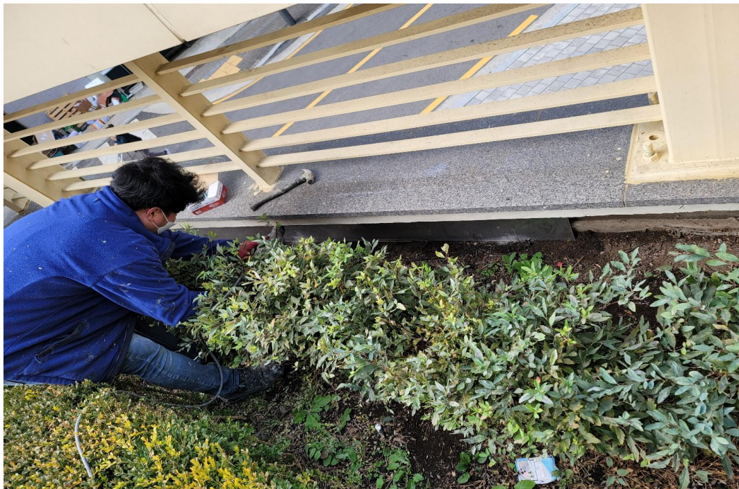
203동 앞 화단 방수 공사 중
