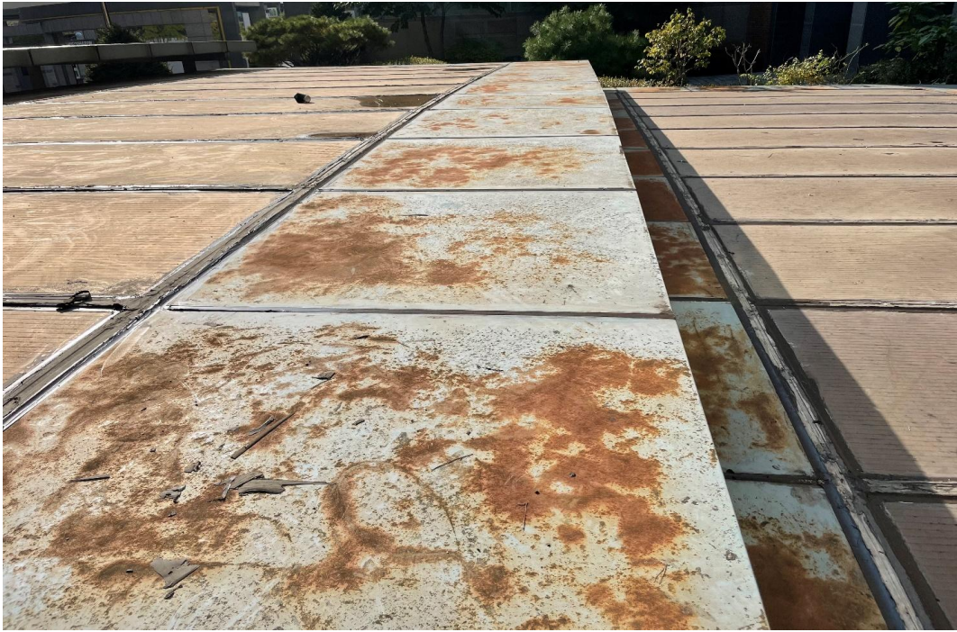
지하주차장 램프 렉산 코킹 공사 완료
