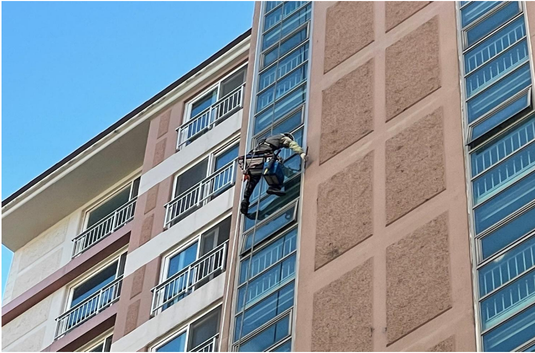
공용계단실 창틀 코킹 공사 중
