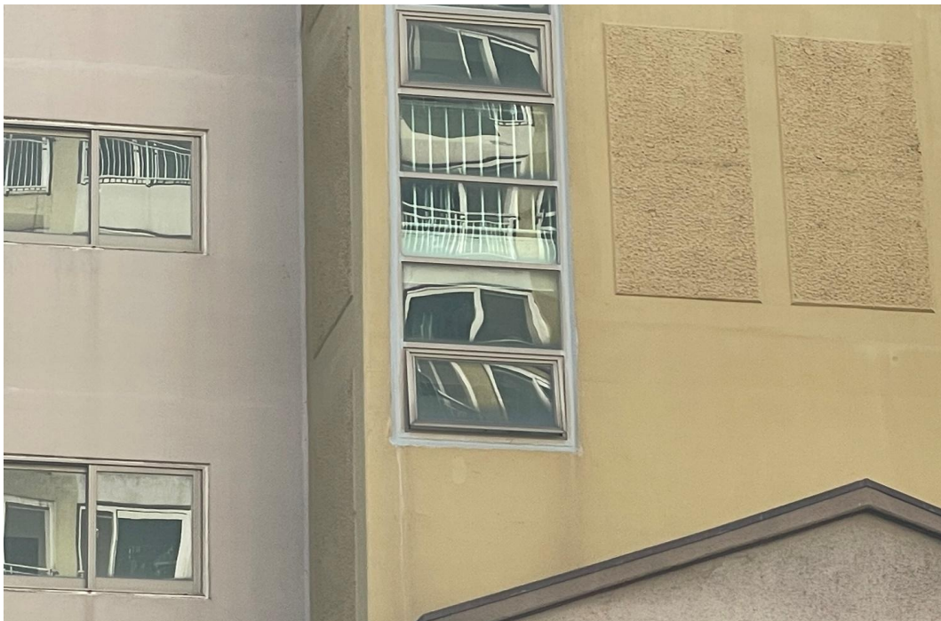
공용계단실 외부 코킹공사 완료
