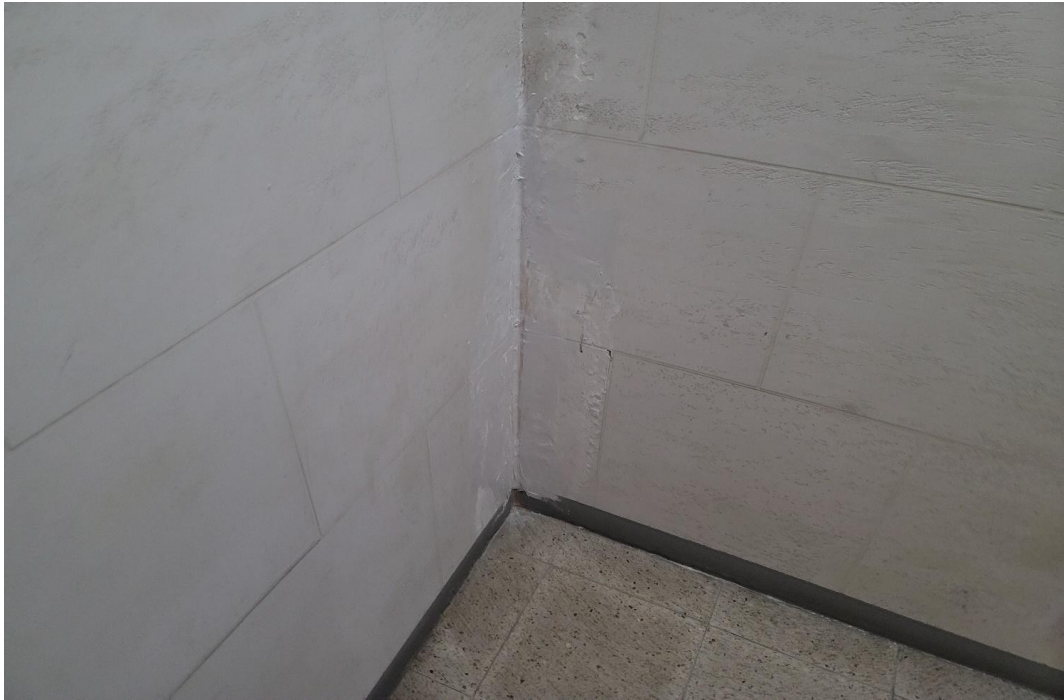
공용계단실 내부 누수부위 보수 완료
