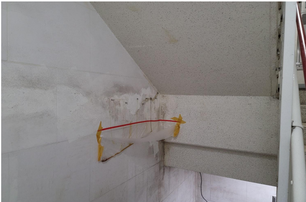
공용계단실 지하층 누수부위 주입 방수 중
