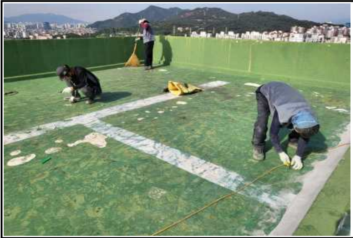
◎ 공사 중(바탕면 정리 및 통기관 작업)
