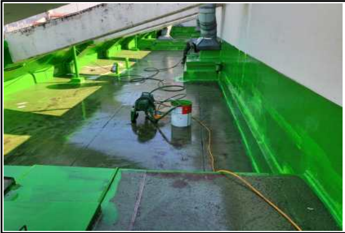
● 공사 중(하도 및 실란트 작업)
