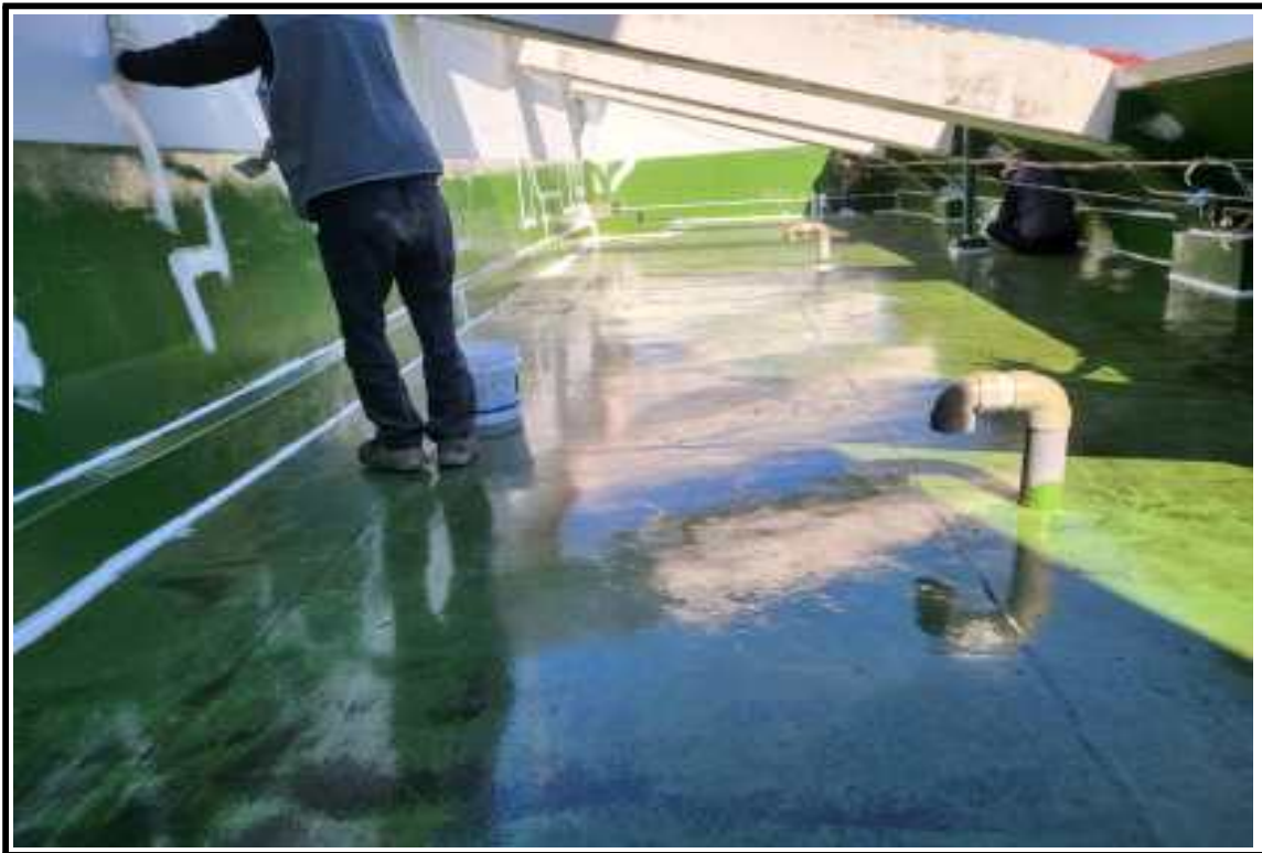
◎ 공사 중(하도 및 실란트 작업)
