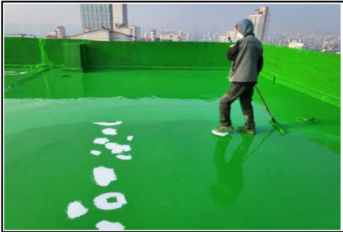
● 공사 중(중도 작업)
