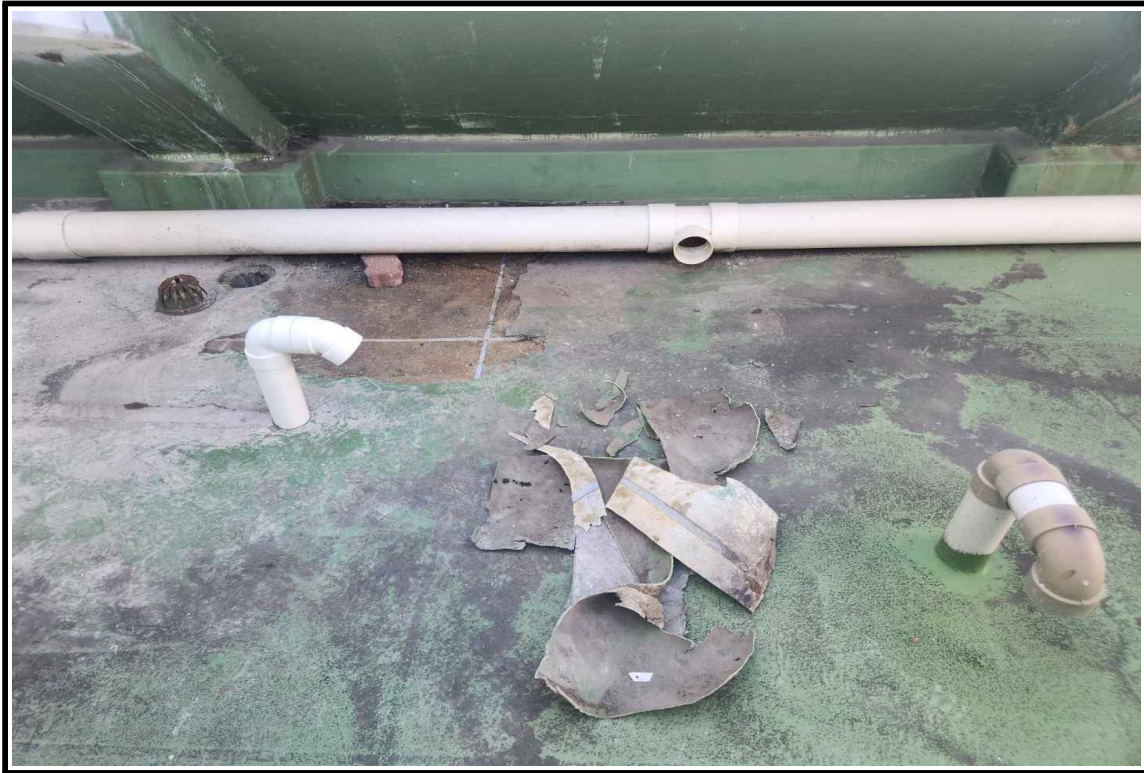
◎ 공사 중(바탕면 정리 및 통기관 작업)
