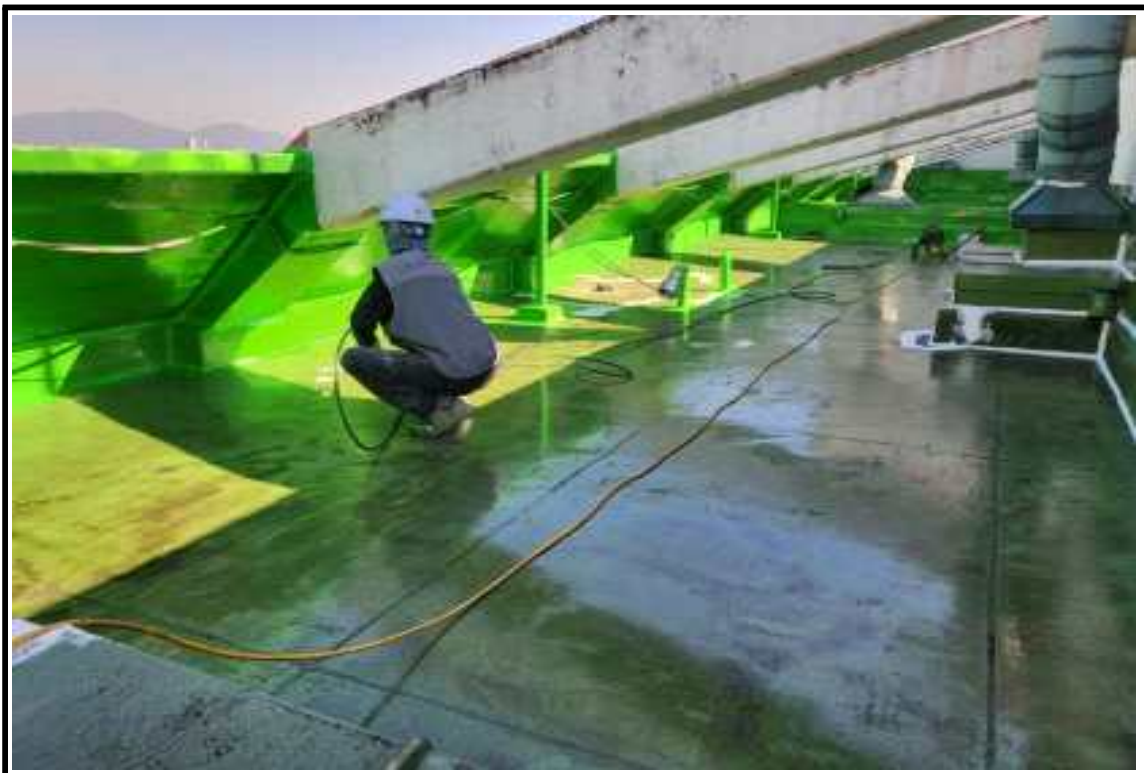
● 공사 중(하도 및 실란트 작업)
