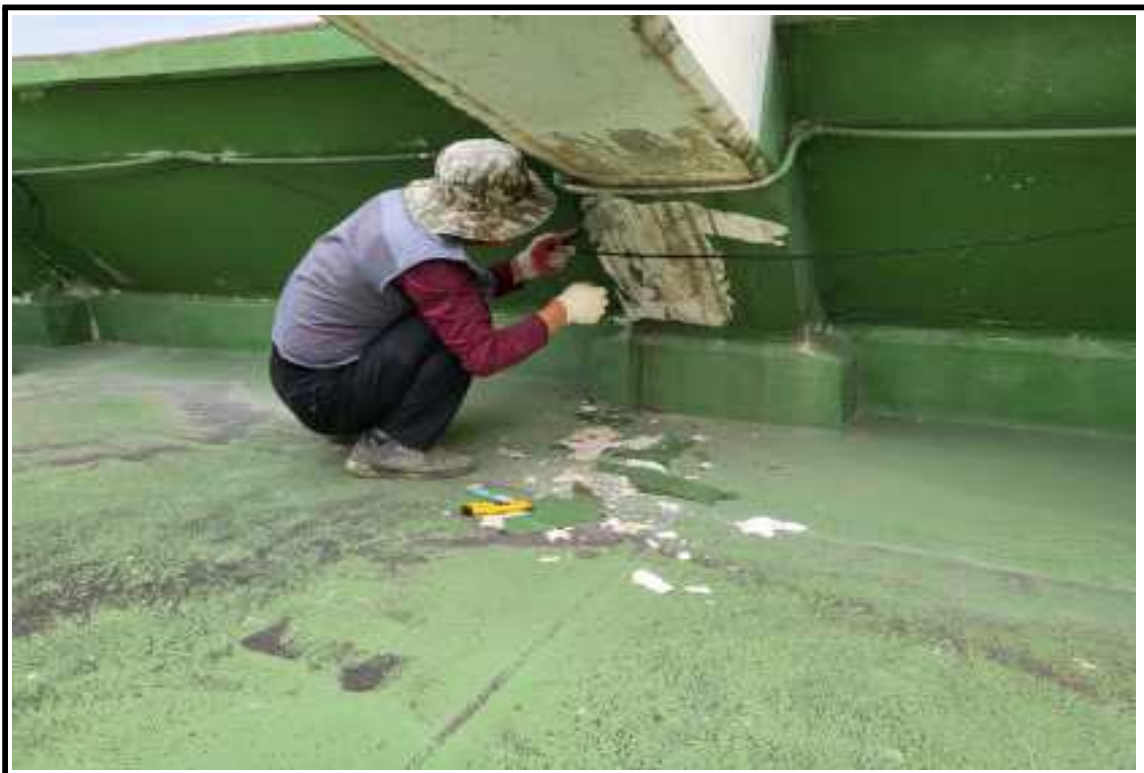
◎ 공사 중(바탕면 정리 및 통기관 작업)
