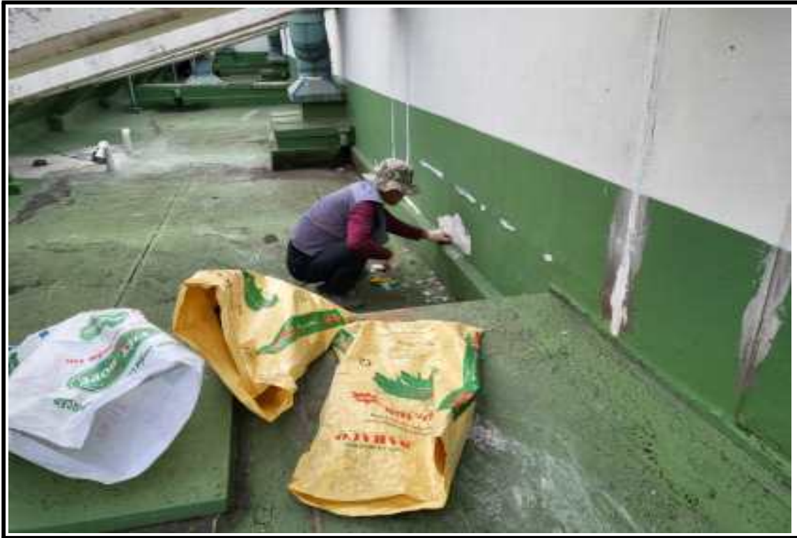
◎ 공사 중(바탕면 정리 및 통기관 작업)
