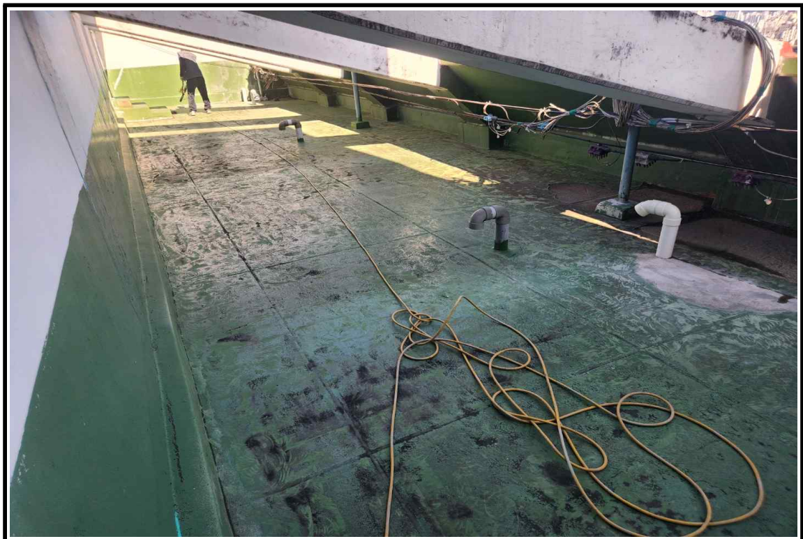
◎ 공사 중(바탕면 정리 및 통기관 작업)
