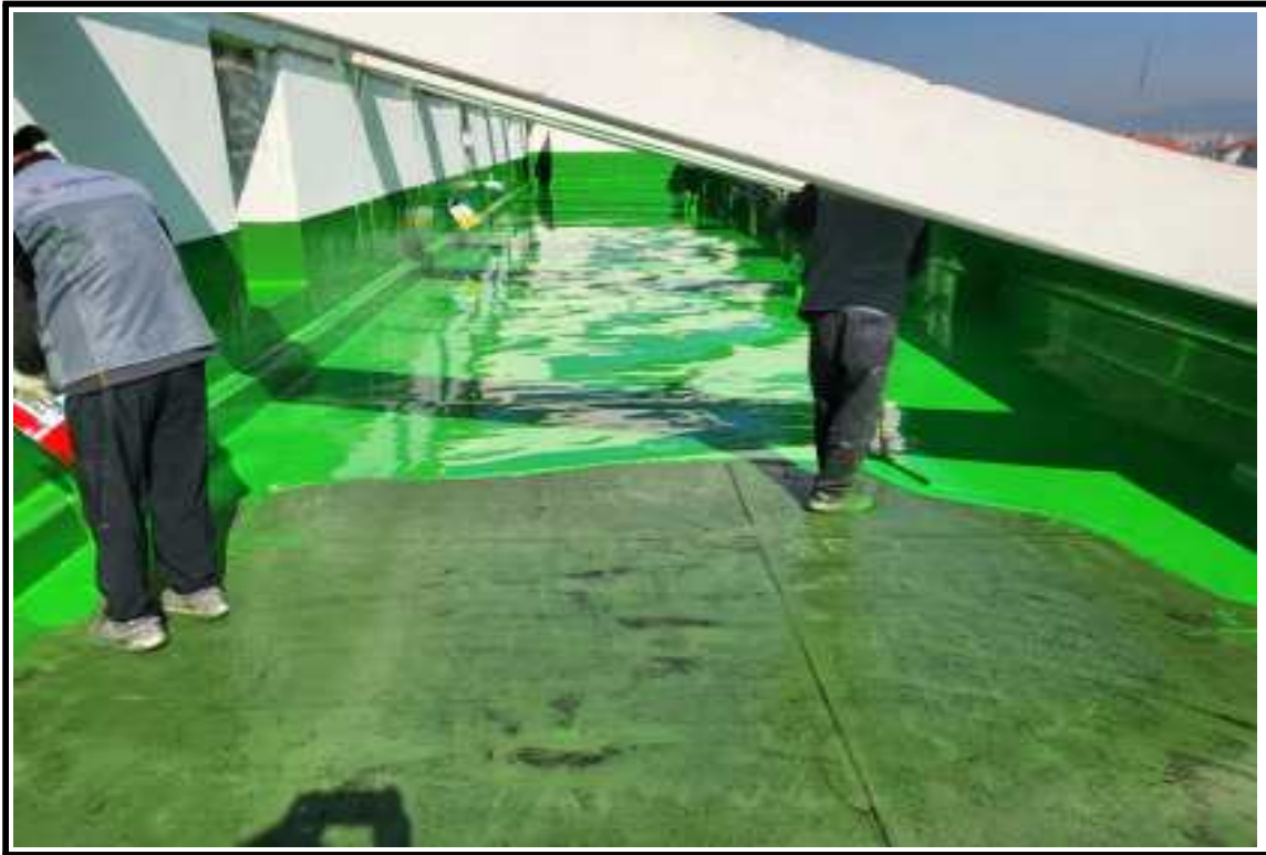
◎ 공사 중(중도 작업)
