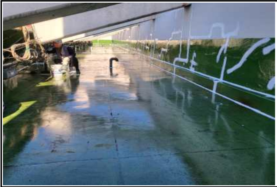
◎ 공사 중(하도 및 실란트 작업)
