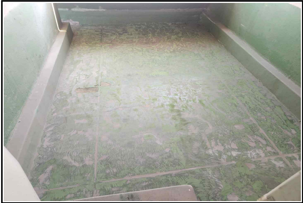
◎ 공사 중(바탕면 정리 및 통기관 작업)
