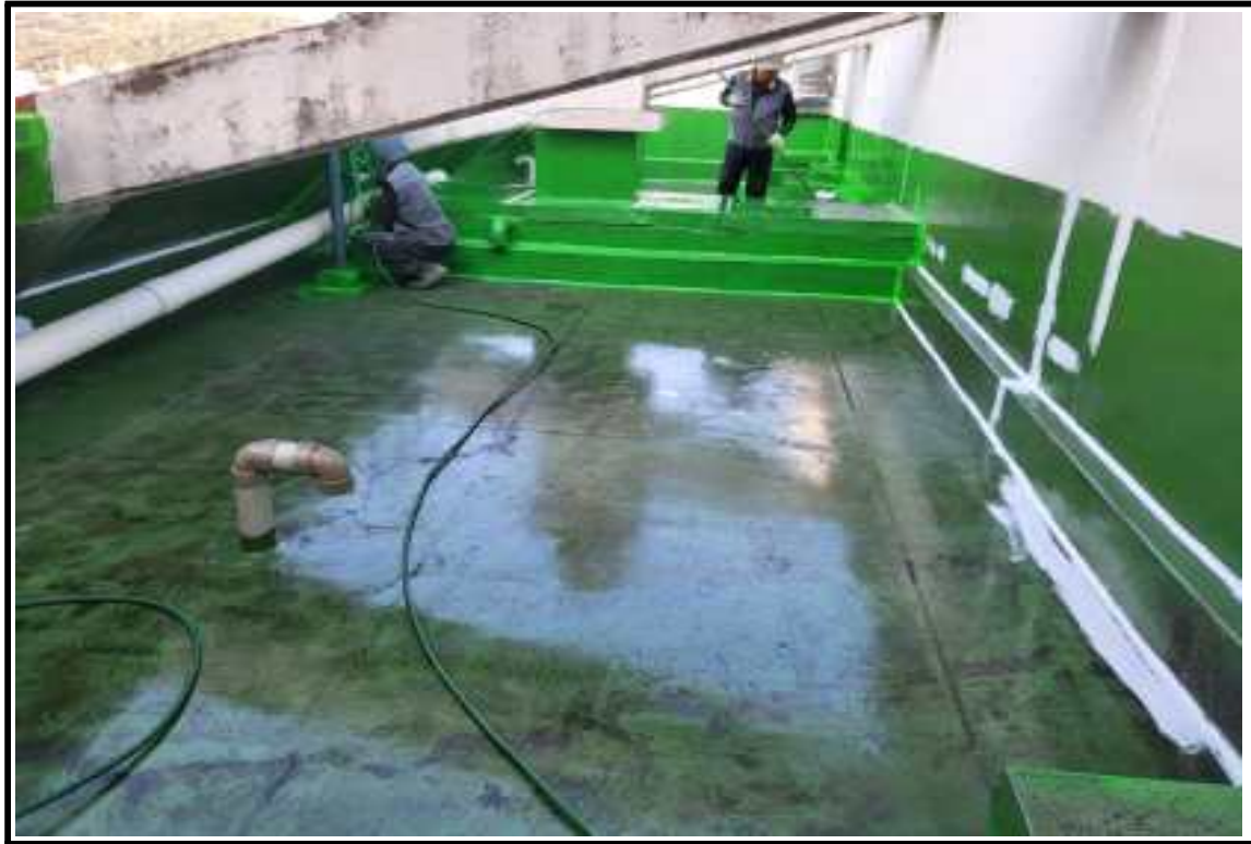
◎ 공사 중(하도 및 실란트 작업)
