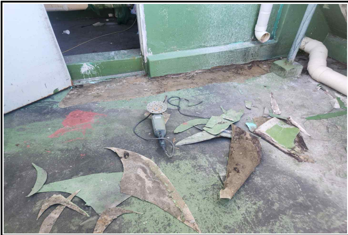
◎ 공사 중(바탕면 정리 및 통기관 작업)
