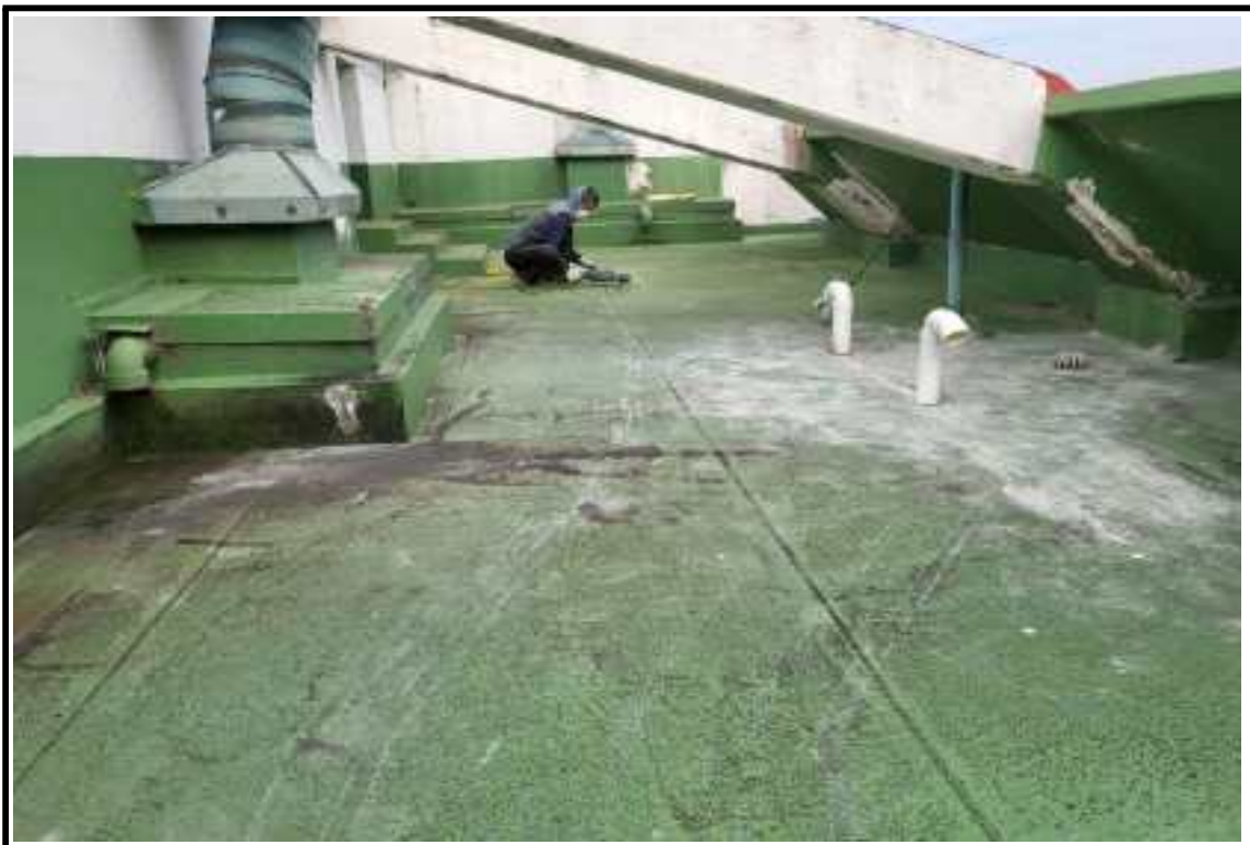
◎ 공사 중(바탕면 정리 및 통기관 작업)
