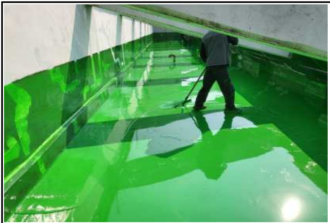
● 공사 중(중도 작업)
