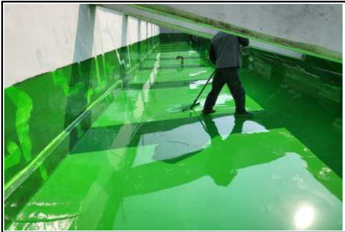
● 공사 중(중도 작업)
