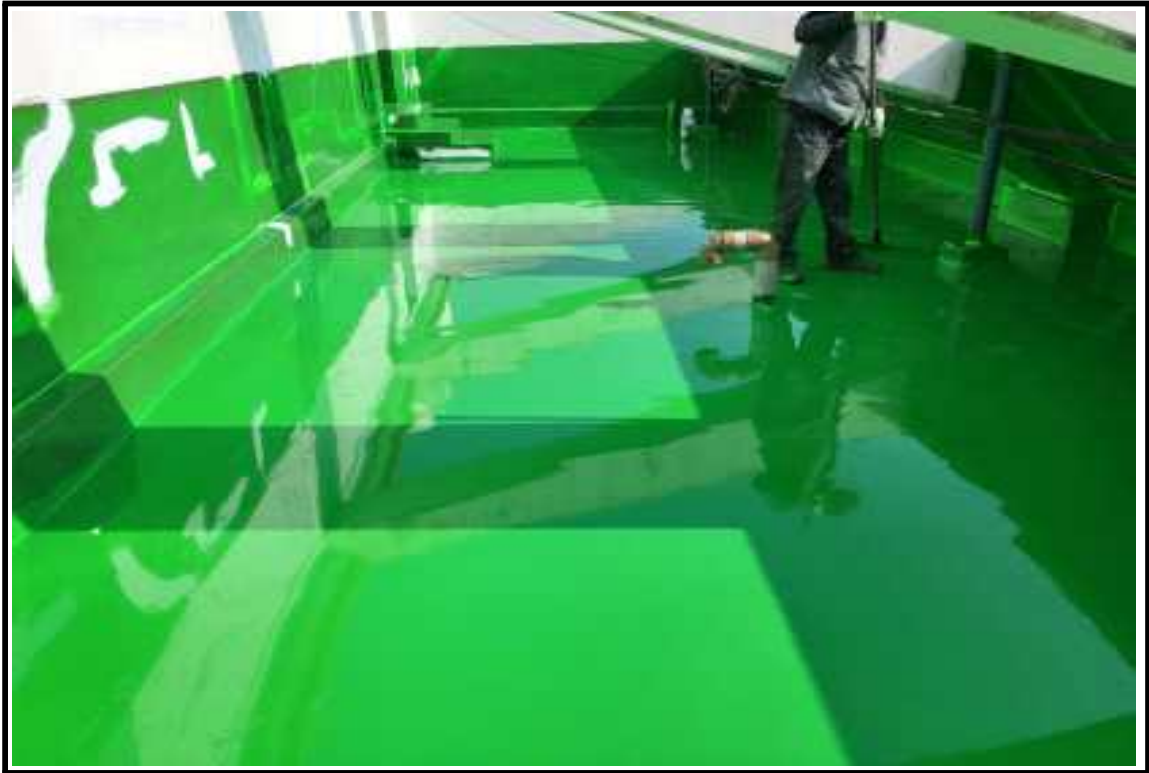
● 공사 중(중도 작업)
