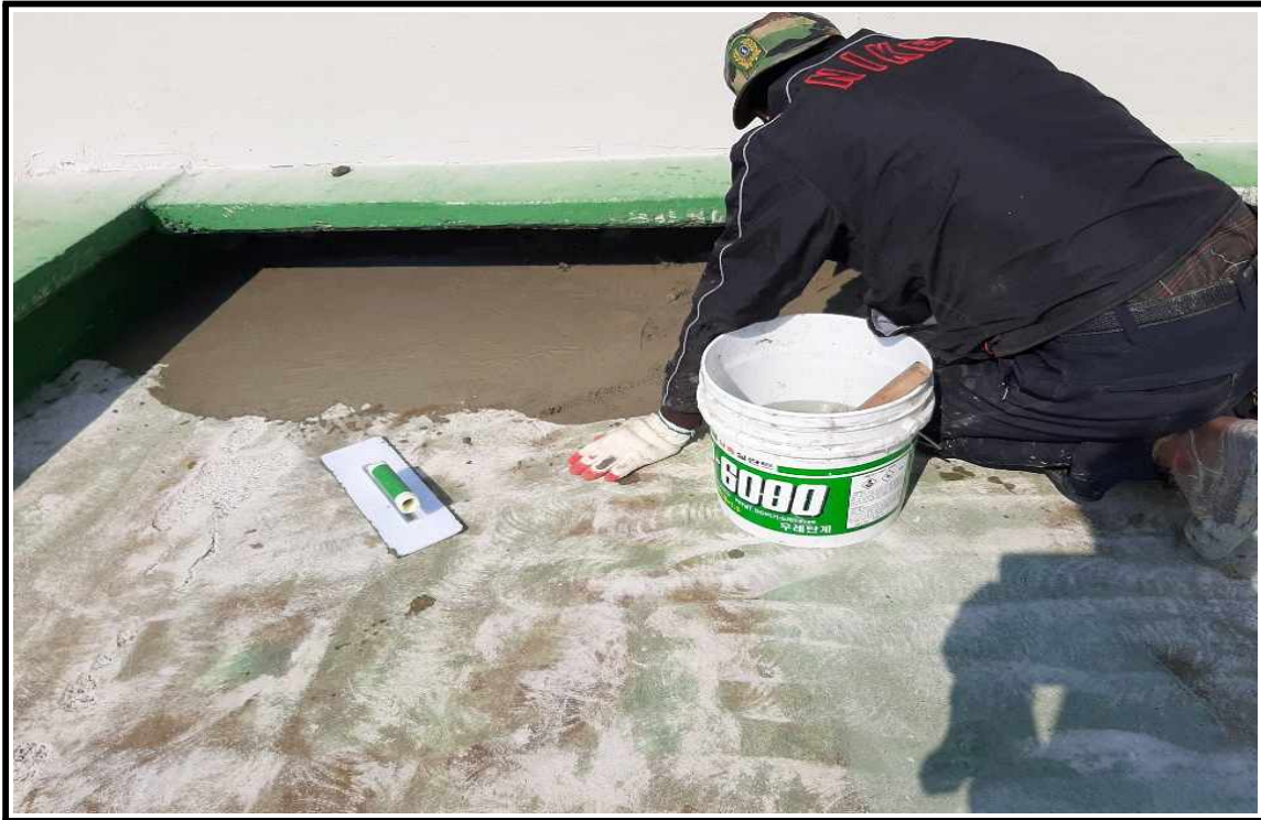
◎ 바탕면 콘크리트 미장 작업 중
