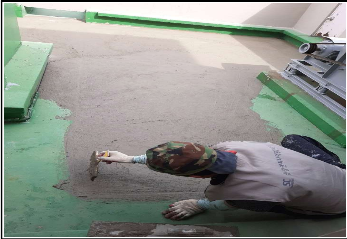
◎ 바탕면 콘크리트 미장 작업 중
