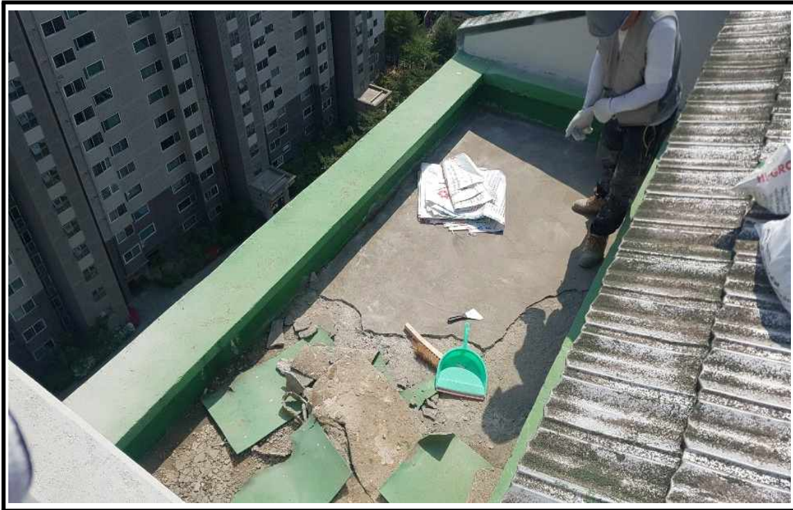
◎ 불량부위 제거 작업 중
