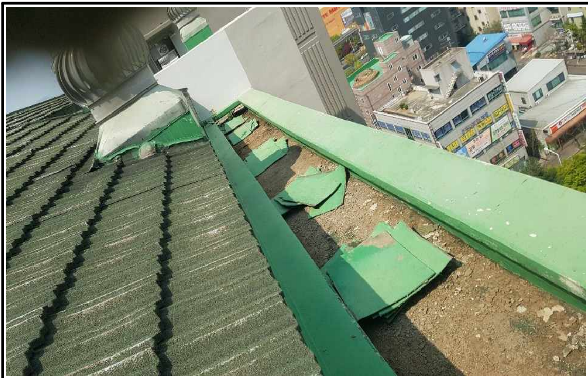
◎ 불량부위 제거 작업 중
