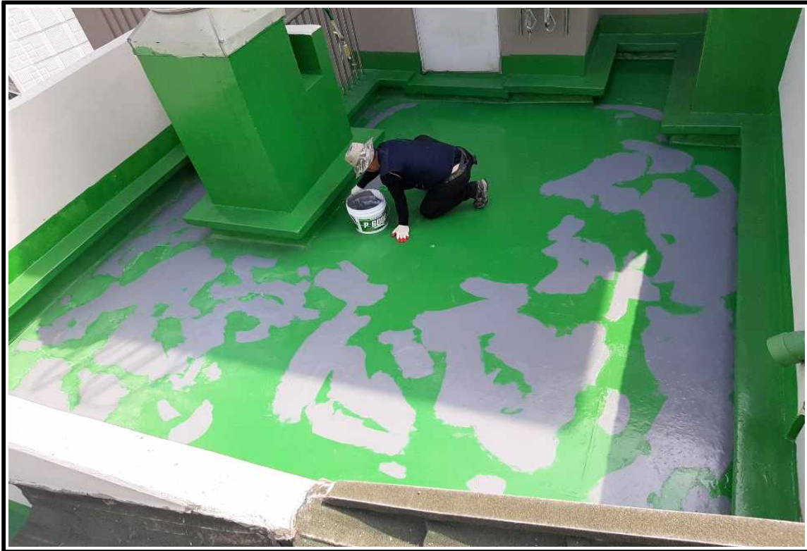
◎ 우레탄 실란트 보강 작업 중
