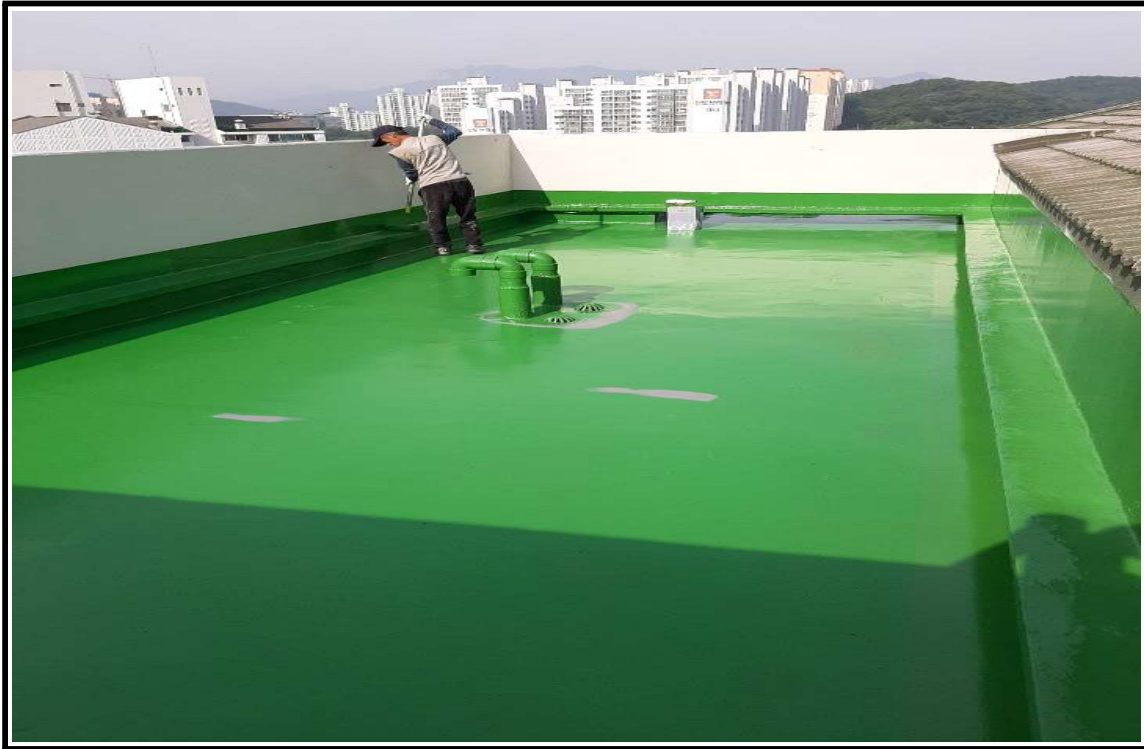
◎ 우레탄 상도 작업 중
