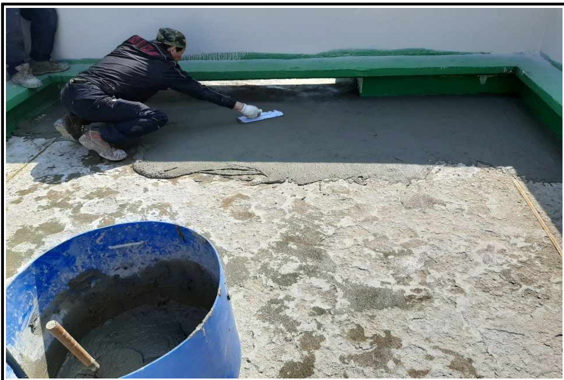
◎ 바탕면 콘크리트 미장 작업 중
