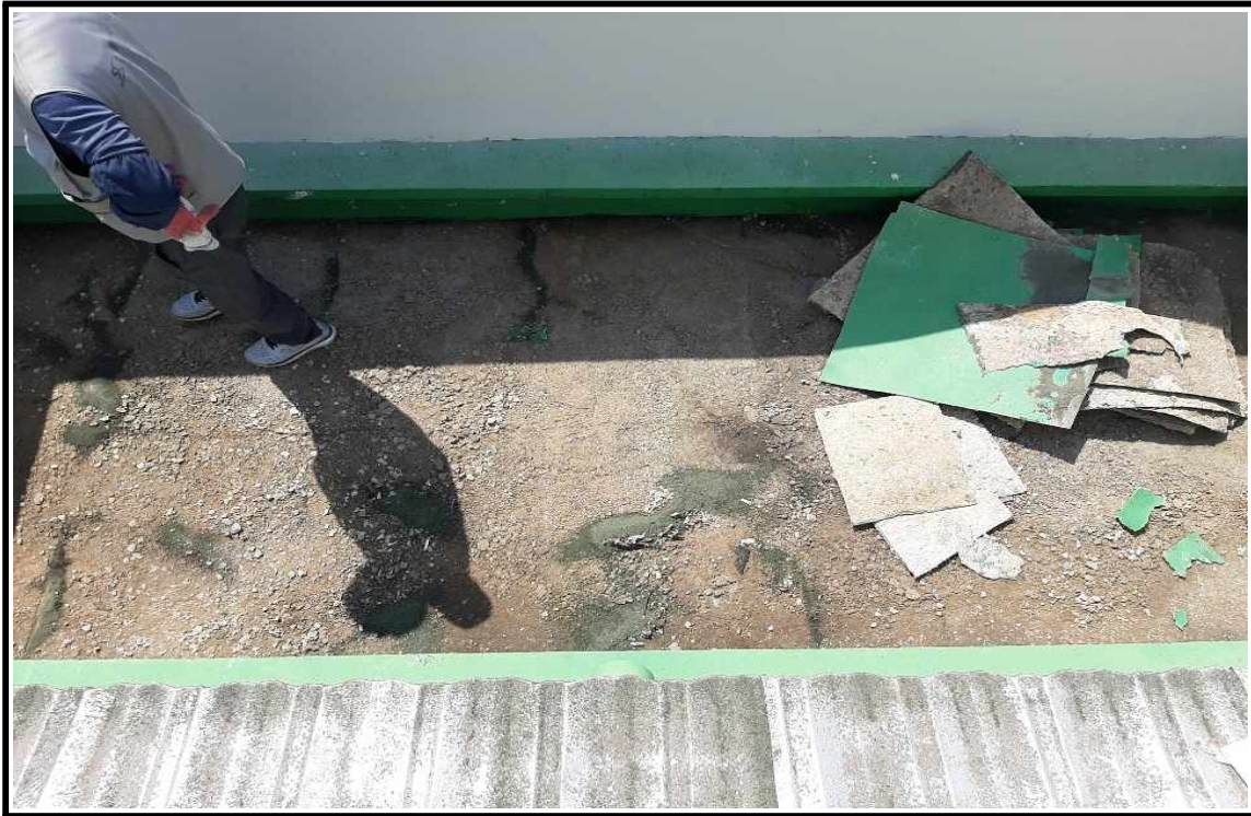
◎ 불량부위 제거 작업 중
