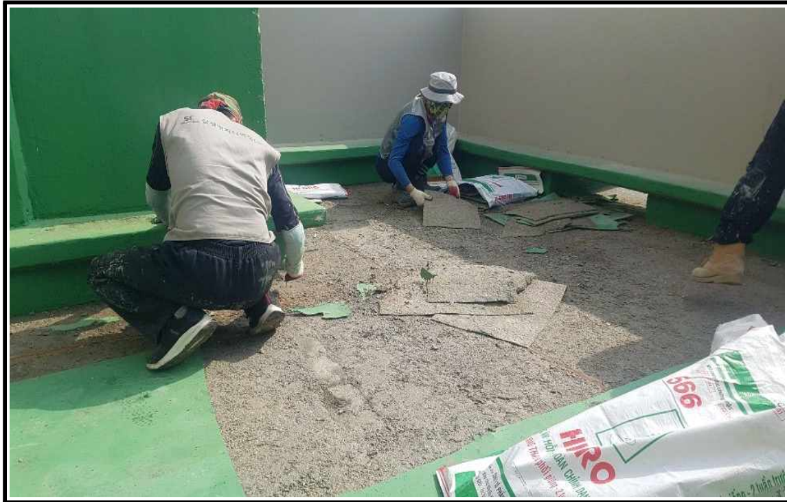
◎ 불량부위 제거 작업 중
