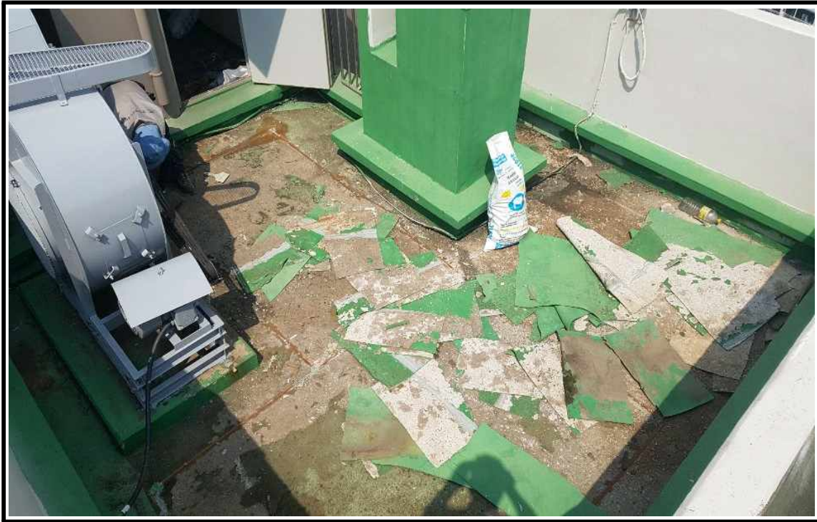
◎ 불량부위 제거 작업 중
