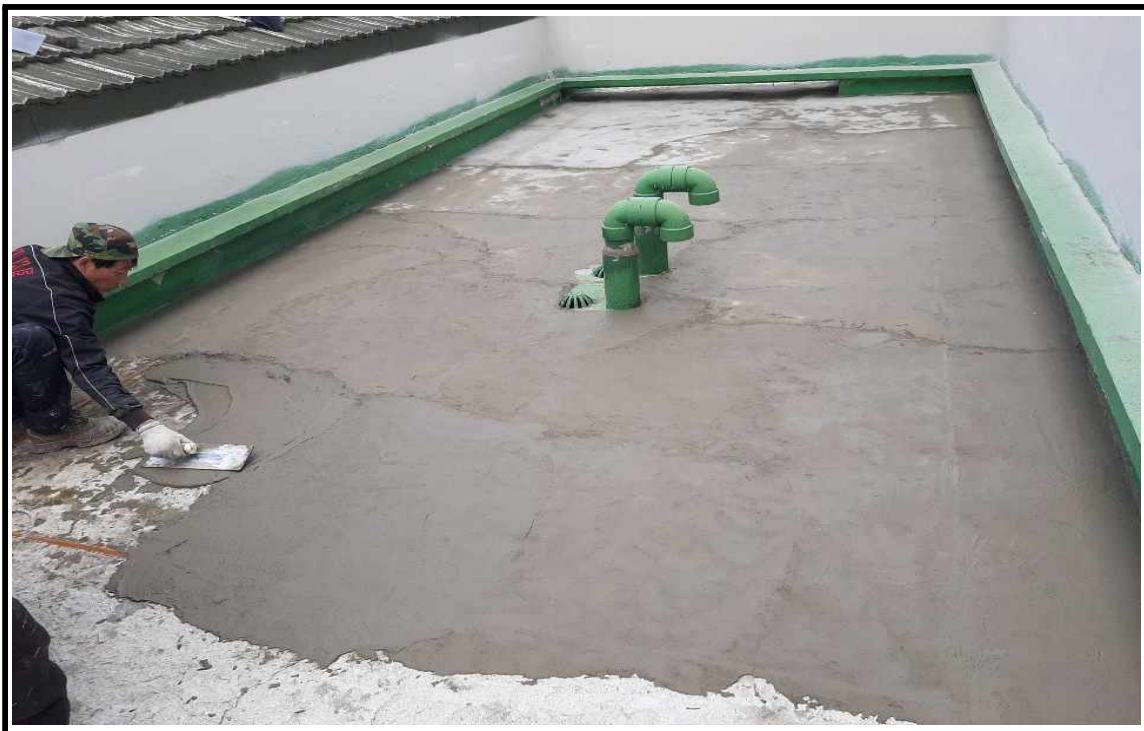
◎ 바탕면 콘크리트 미장 작업 중
