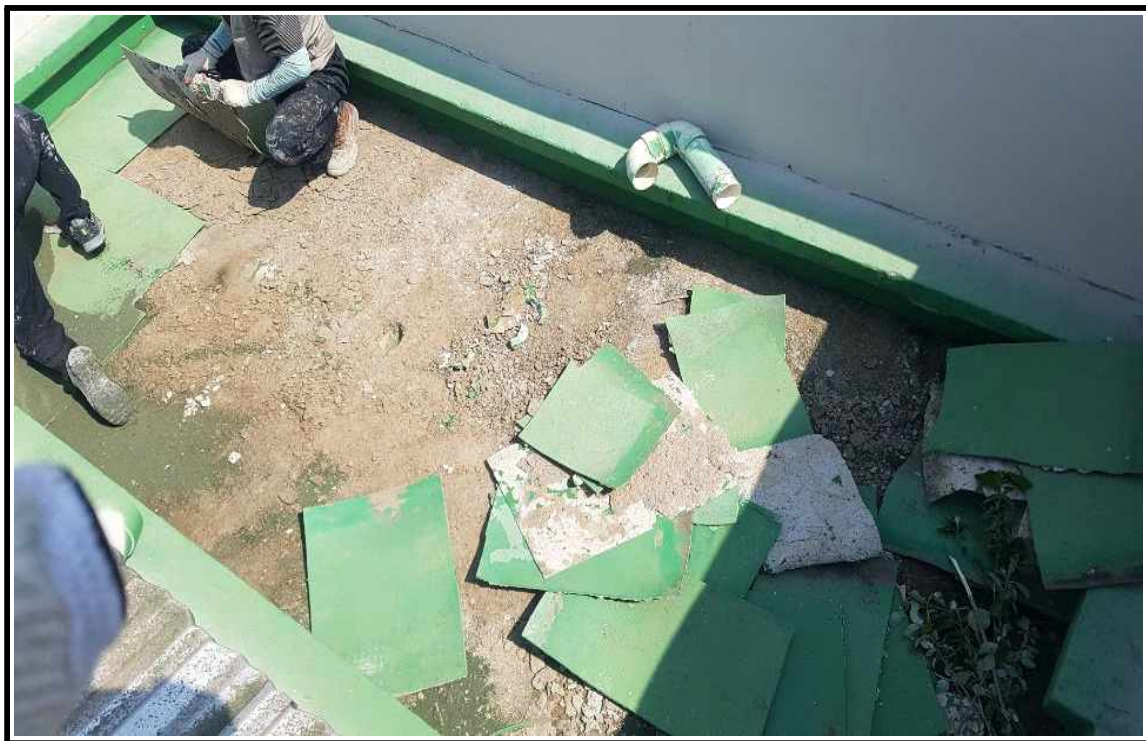
◎ 불량부위 제거 작업 중
