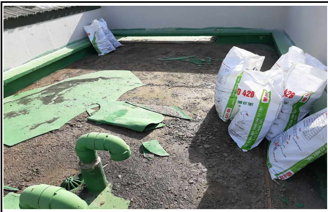
◎ 불량부위 제거 작업 중
