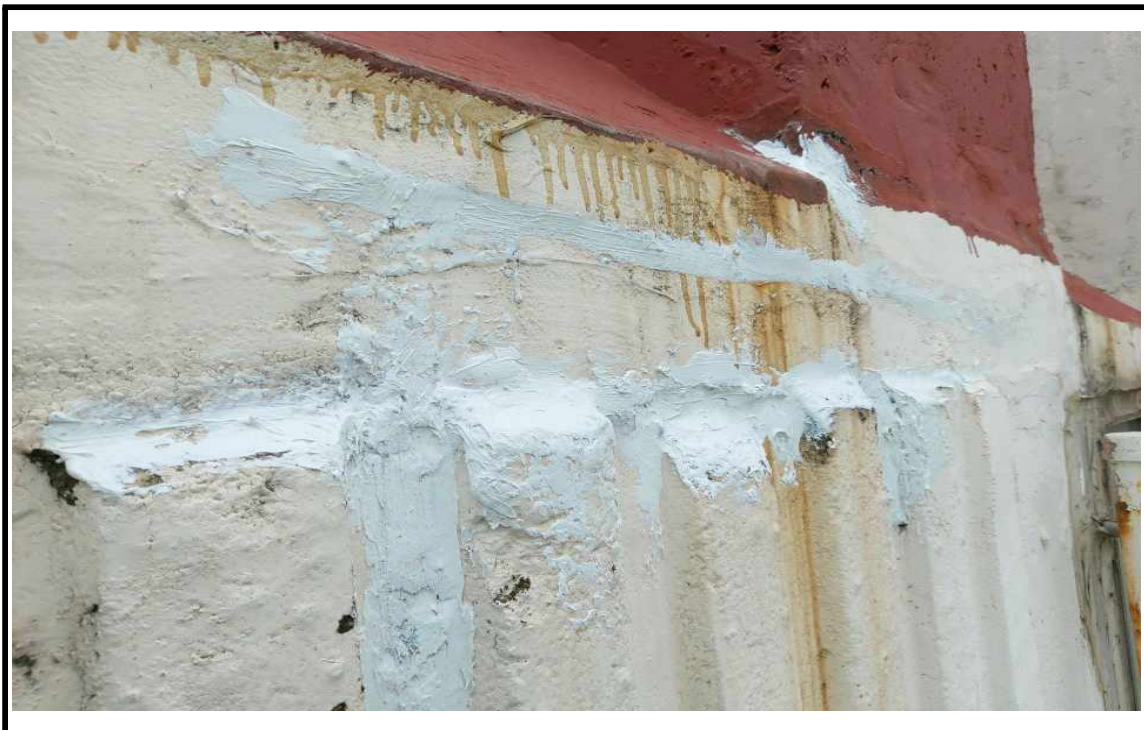
◎ 옥상 파라펫 균열보수(시공 중)
