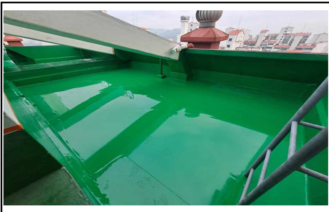
◎ 공사 중(우레탄 방수)
