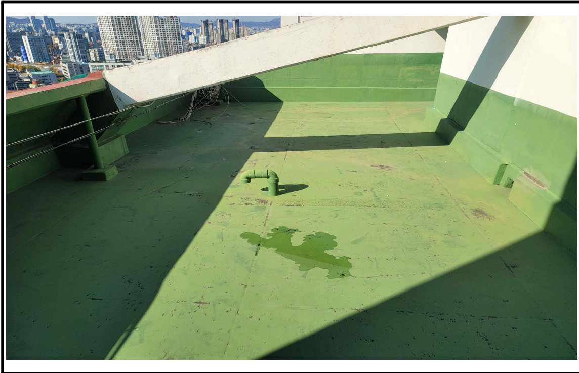
◎ 공사 전(우레탄 방수)
