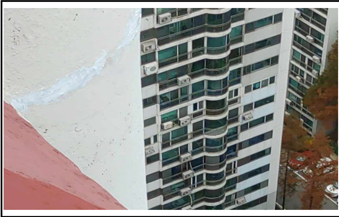
◎ 옥상 파라펫 균열보수(시공 중)
