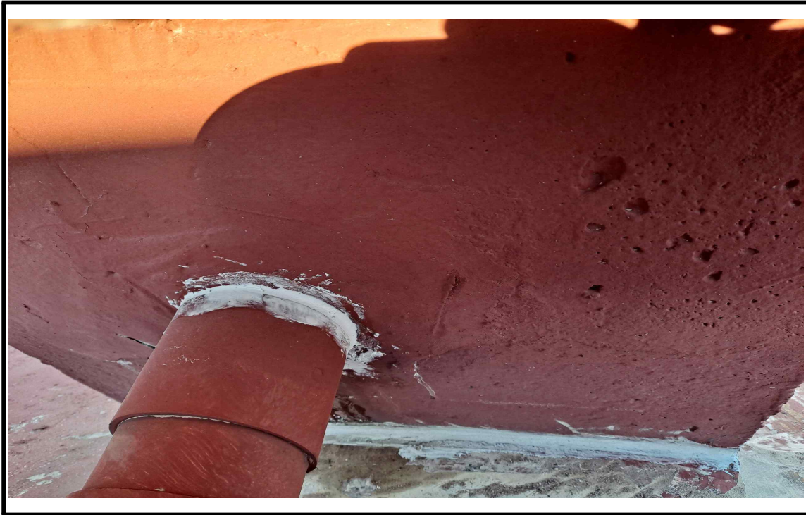
◎ 옥상 파라펫 균열보수(시공 중)
