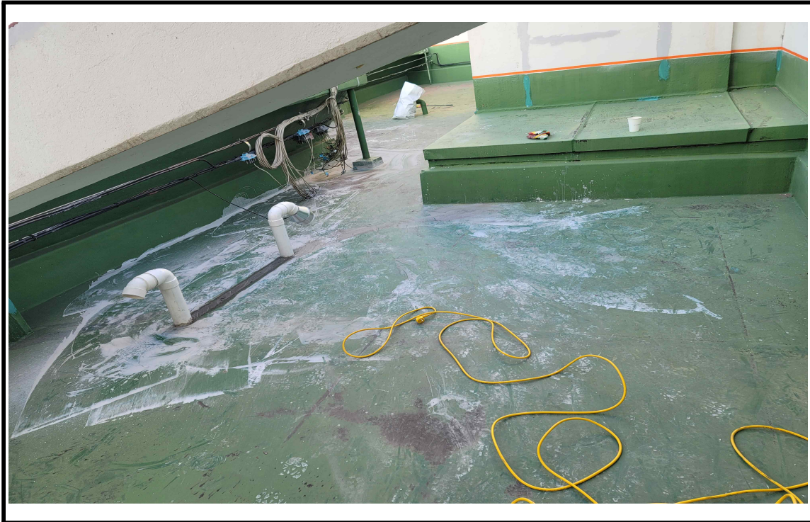
◎ 공사 중(우레탄 방수)
