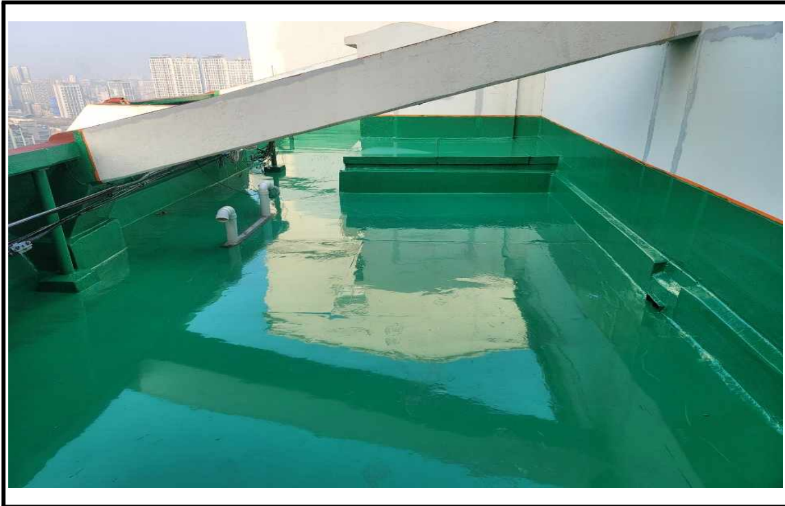
◎ 공사 중(우레탄 방수)
