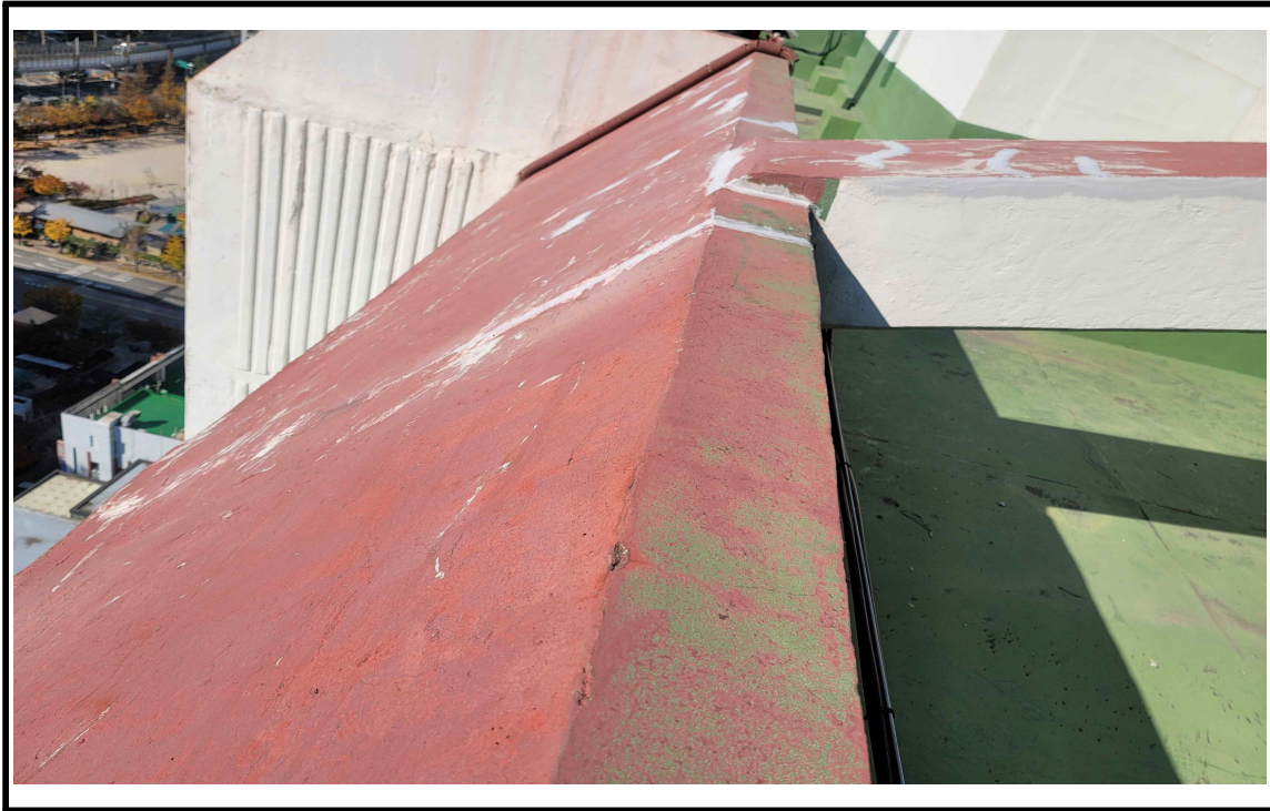
◎ 옥상 파라펫 균열보수(시공 중)
