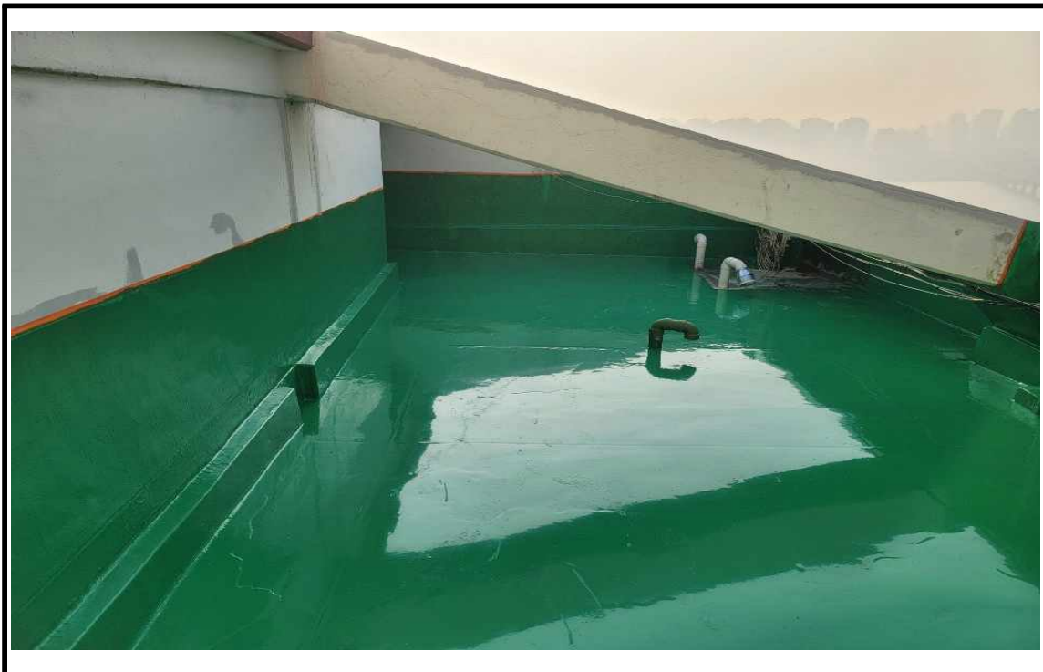
◎ 공사 중(우레탄 방수)
