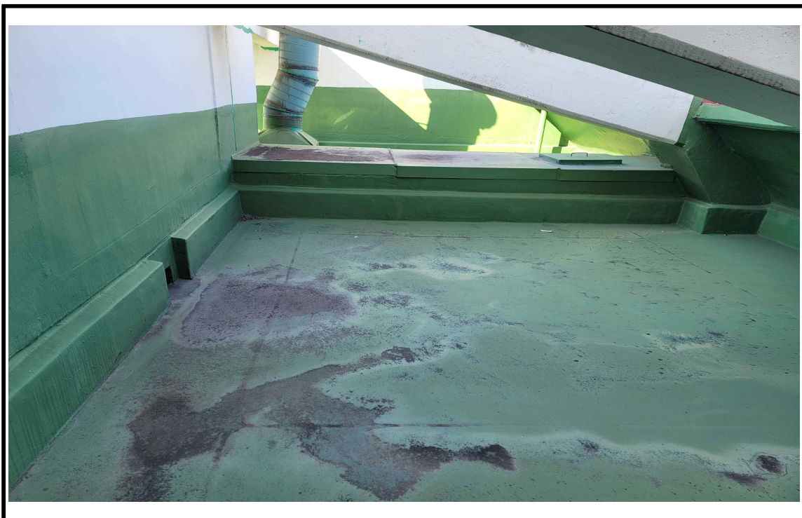
◎ 공사 전(우레탄 방수)
