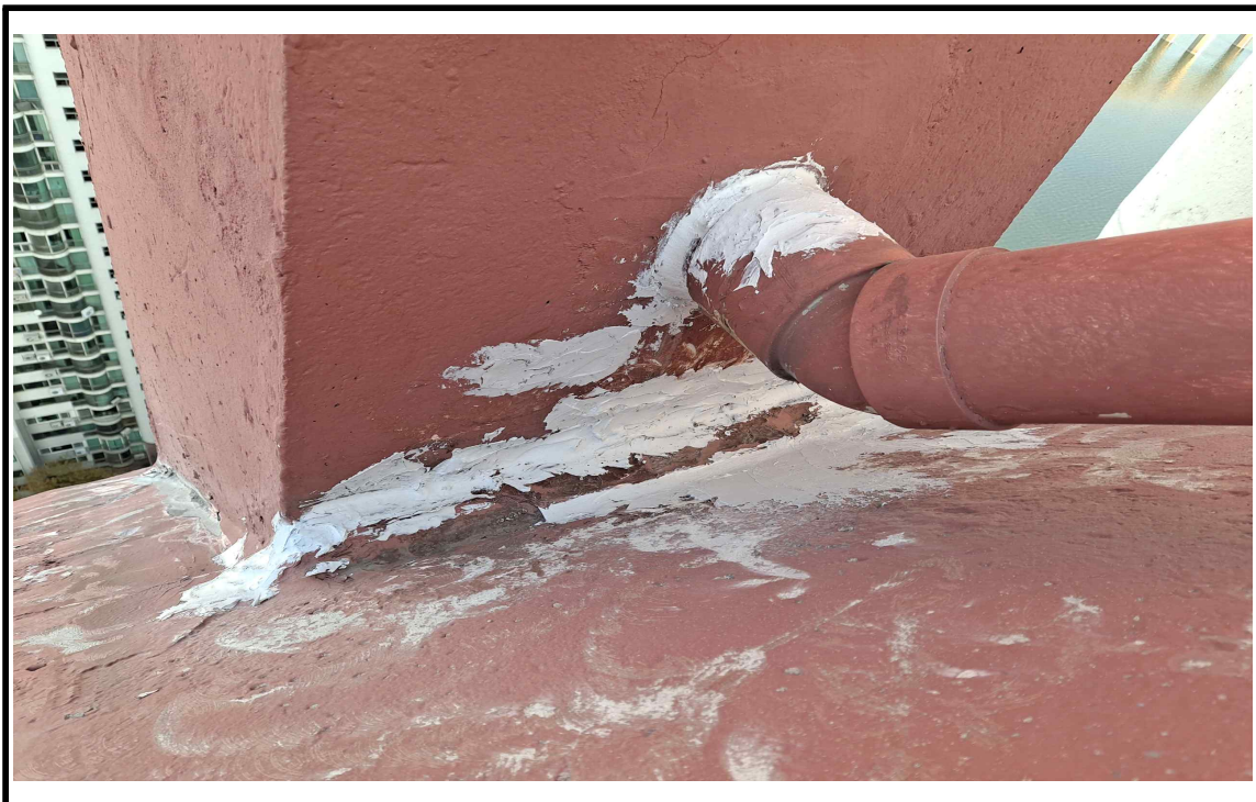
◎ 옥상 파라펫 균열보수(시공 중)
