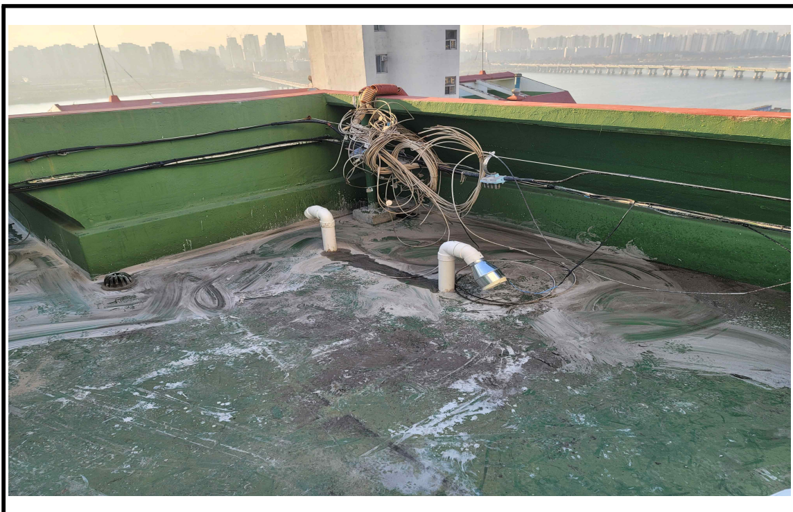
◎ 공사 중(우레탄 방수)
