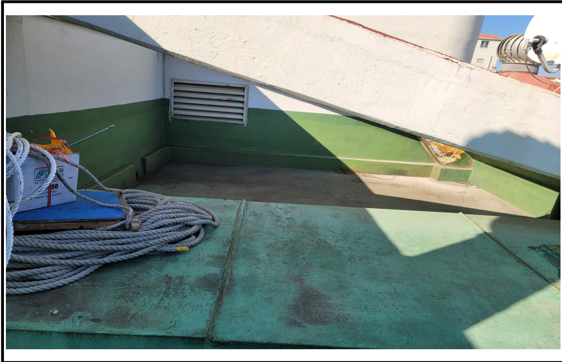
◎ 공사 전(우레탄 방수)
