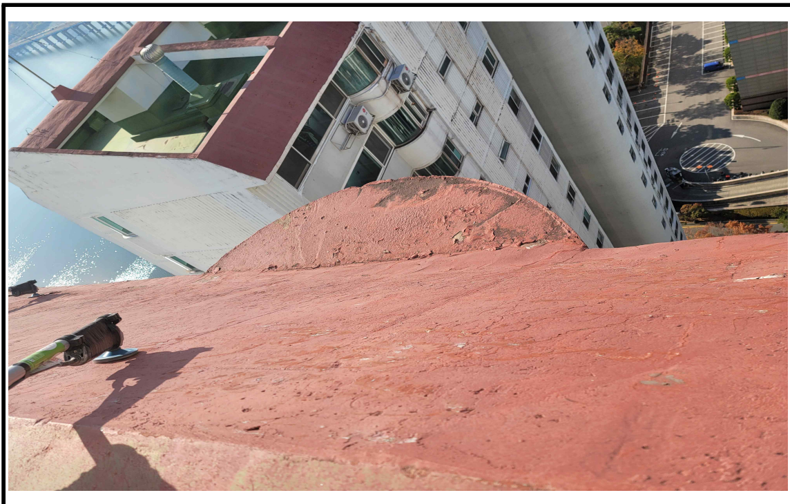
◎ 옥상 파라펫 균열보수(시공 중)
