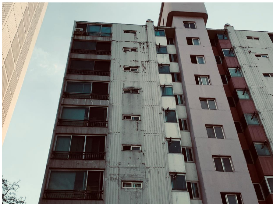
공사 전 외벽 전경
