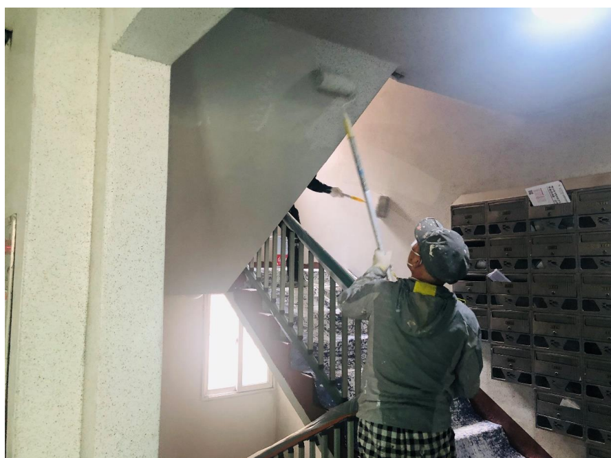
내부 수성페인트 도장
