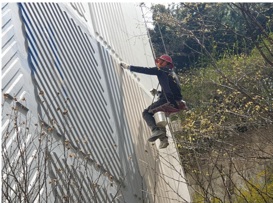
외벽 수성페인트 도장
