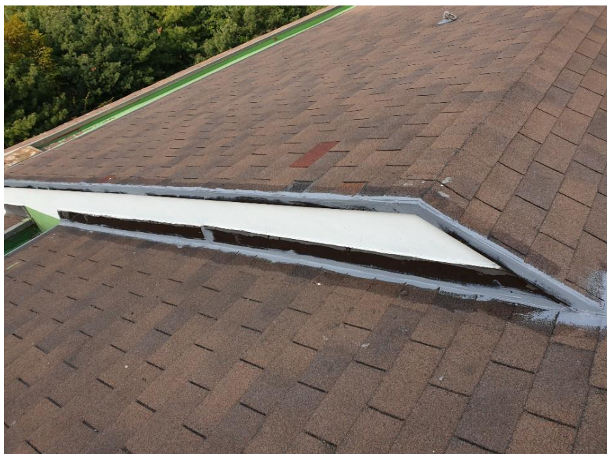
옥상 싱글 방수재 도포 전 실란트 시공
