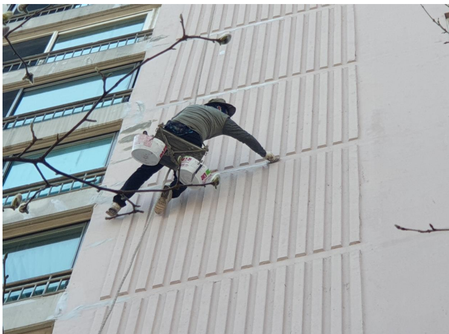
외벽 균열보수 공사
