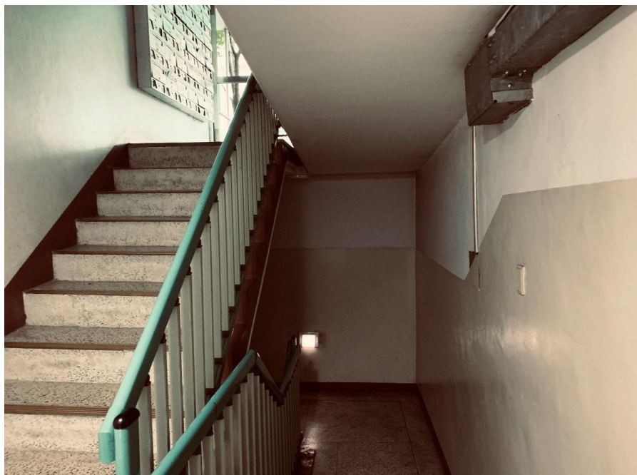
공사 전 내부 전경
