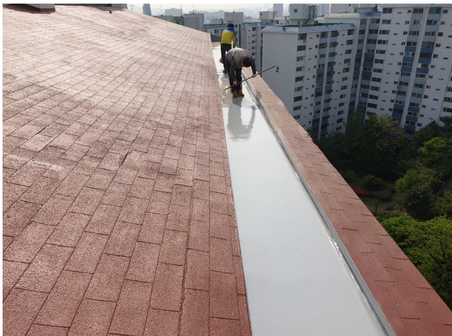
옥상 배수로 우레탄 중도 2차 도포
