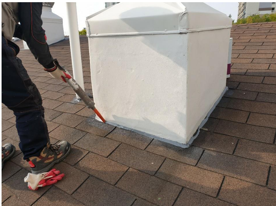
옥상 싱글 방수재 도포 전 실란트 시공
