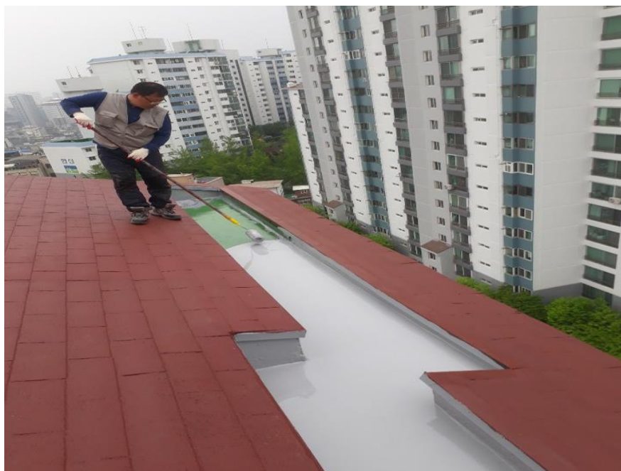
옥상 배수로 우레탄 중도 1차 도포
