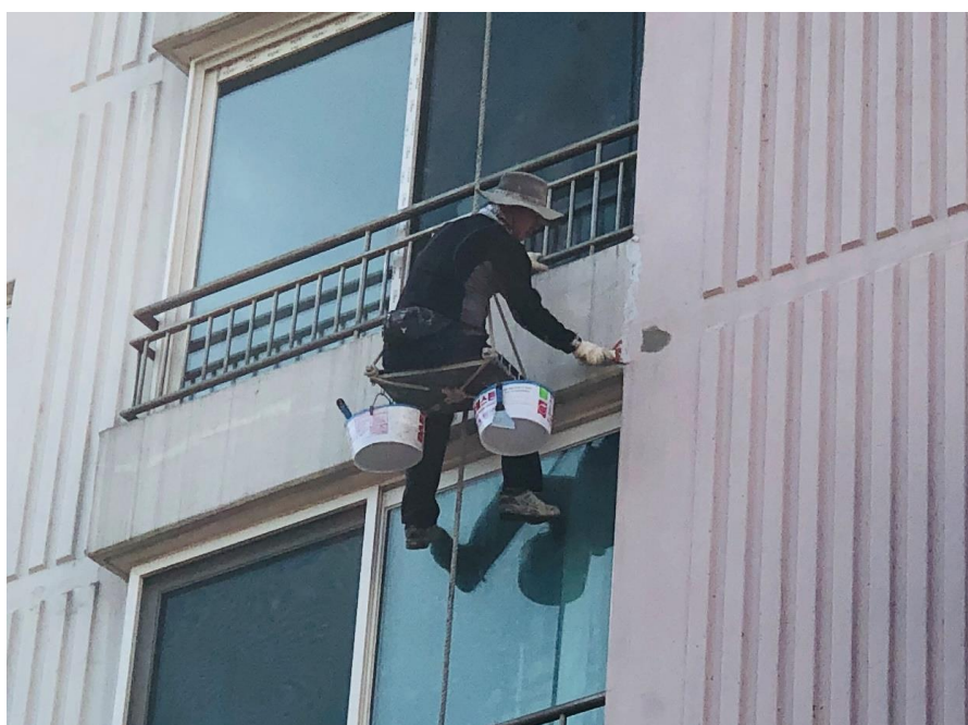
외벽 균열보수 공사
