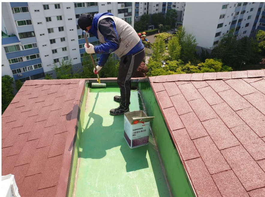
옥상 배수로 우레탄 프라이머 도포
