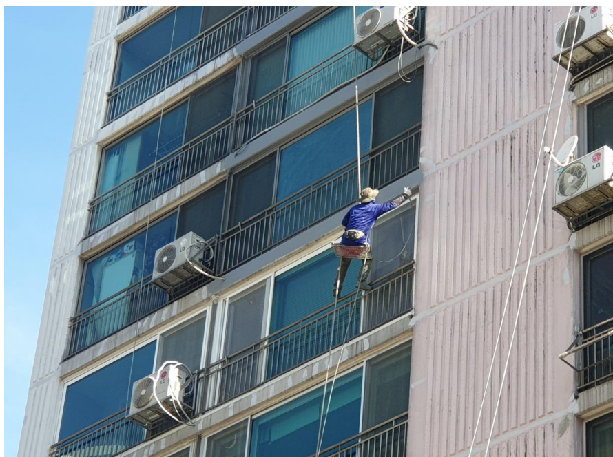
외벽 수성페인트 도장
