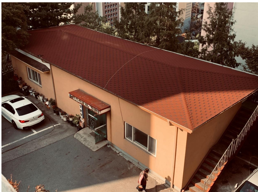
공사 전 부대시설 전경
