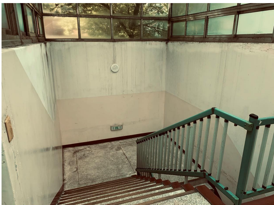
공사 전 부대시설 전경
