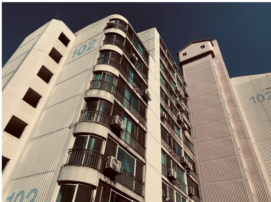
공사 전 외벽 전경
