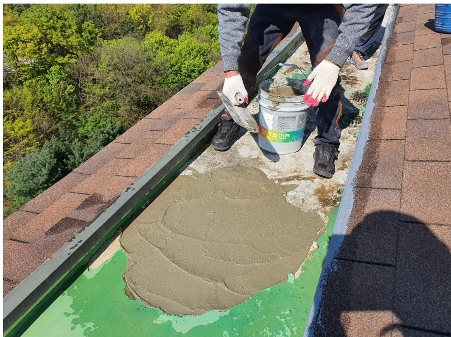
옥상 배수로 우레탄 철거 부분 미장
