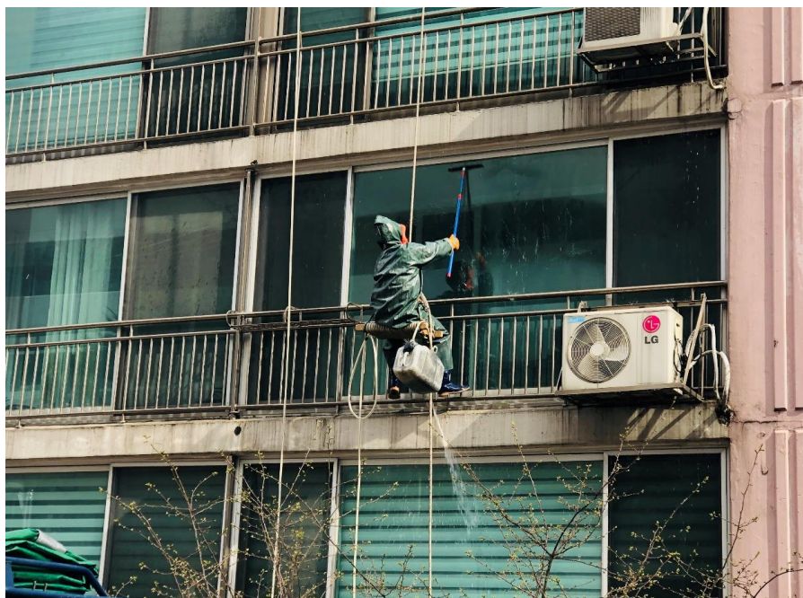
유리창 물청소 공사
