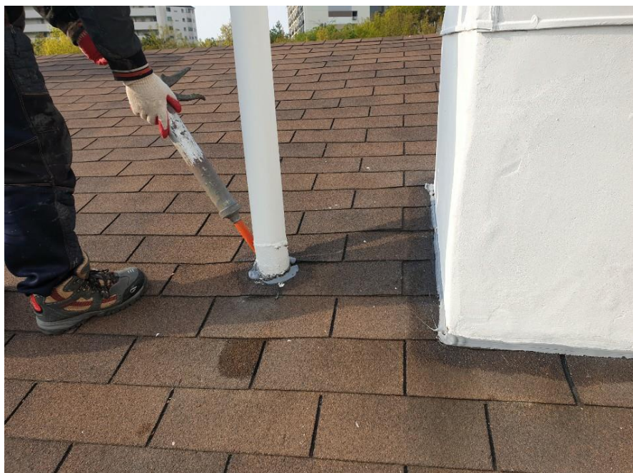
옥상 싱글 방수재 도포 전 실란트 시공
