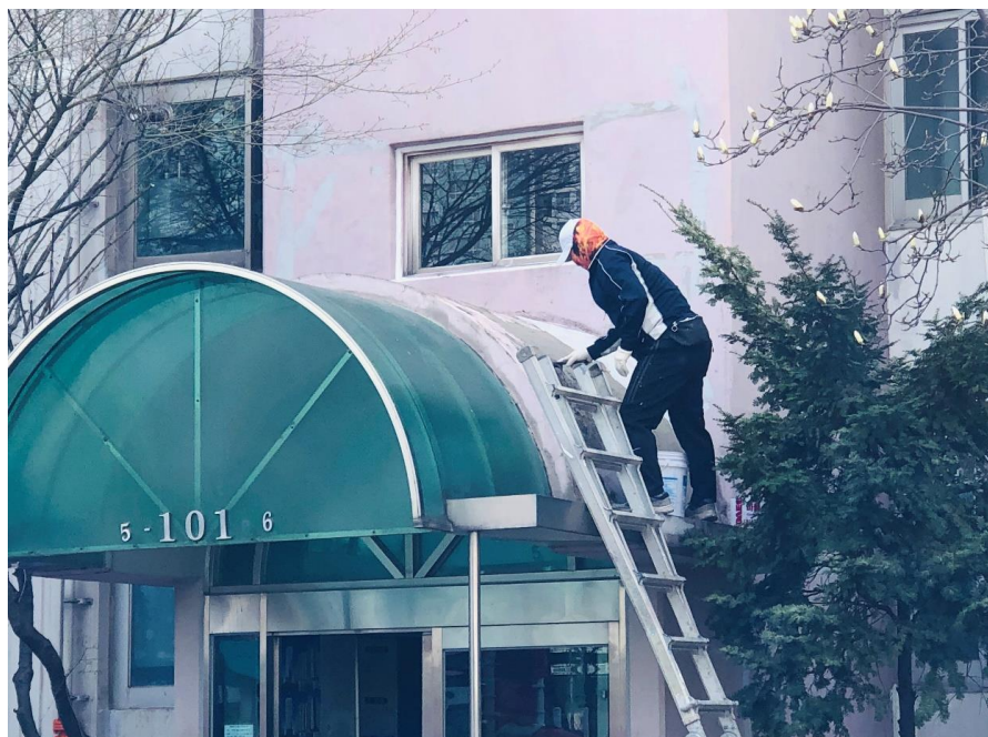
외벽 균열보수 공사
