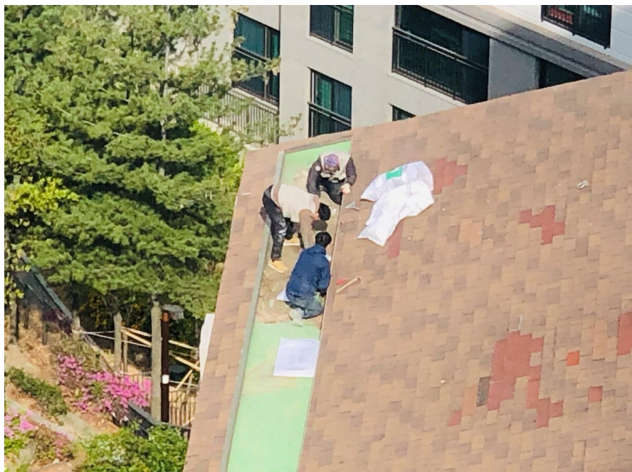
옥상 배수로 우레탄 부실부위 철거
