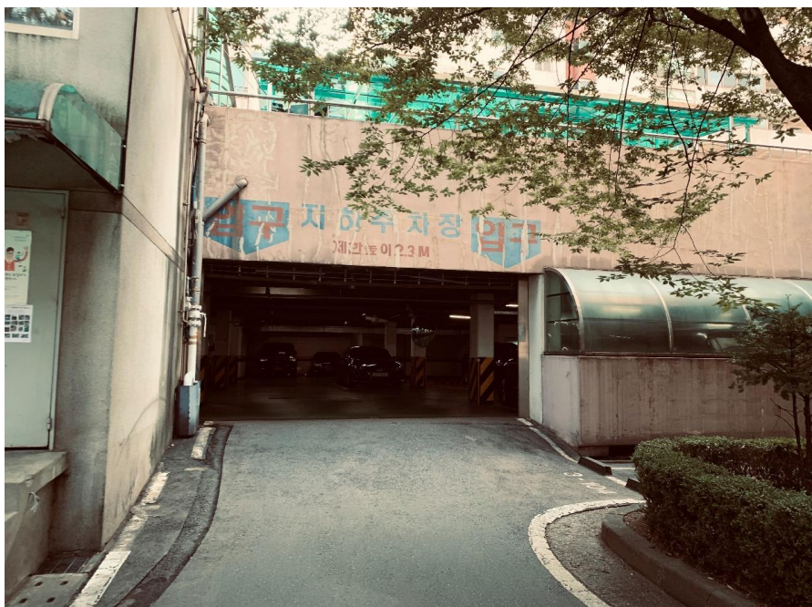
공사 전 부대시설 전경
