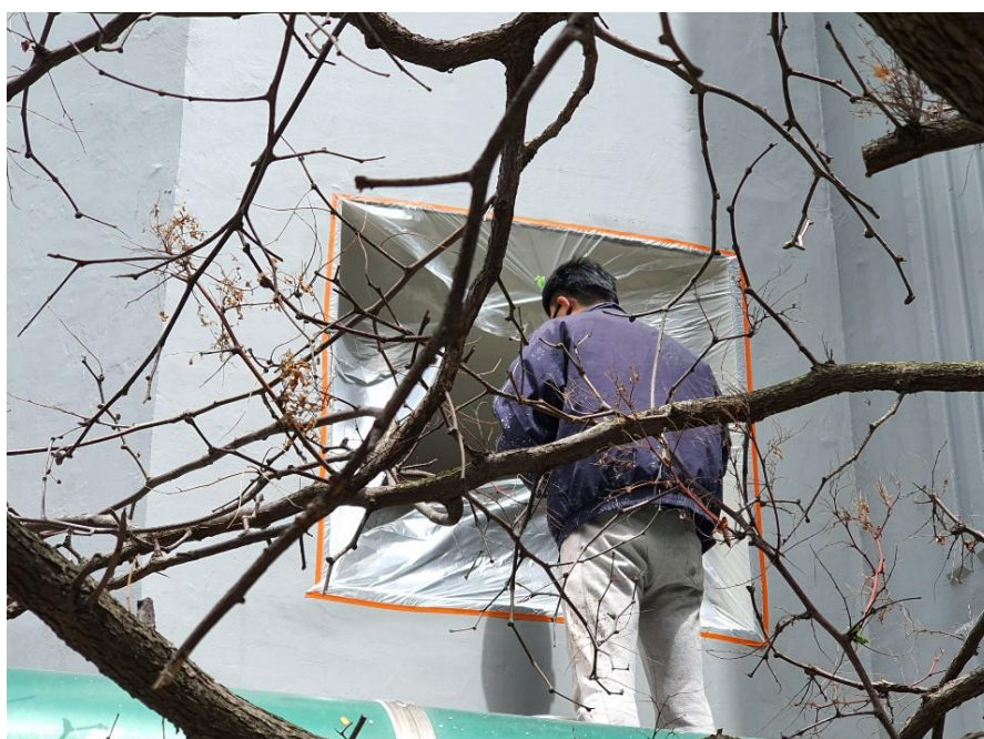
무늬코트 도포 전 보양작업
