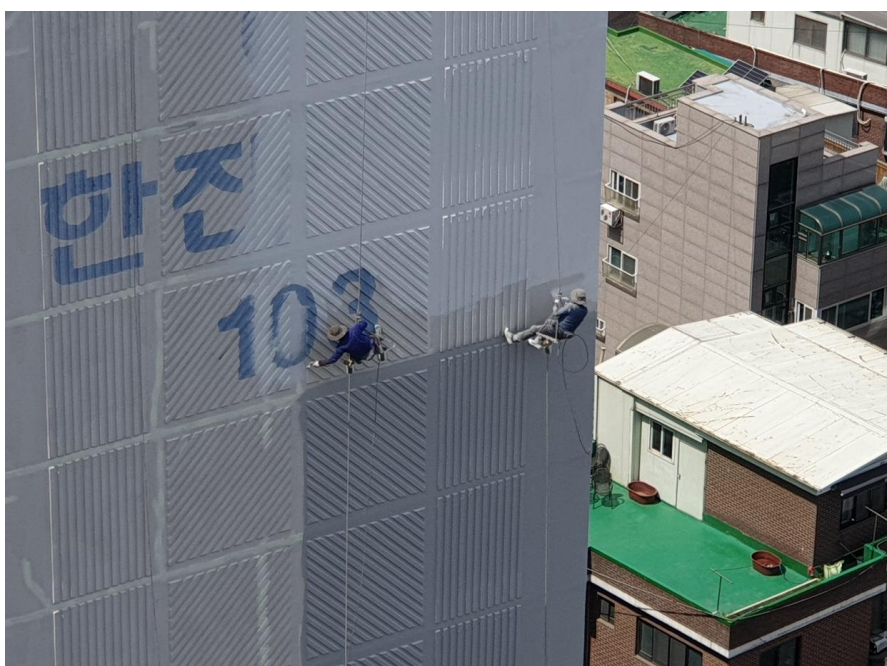
외벽 수성페인트 도장
