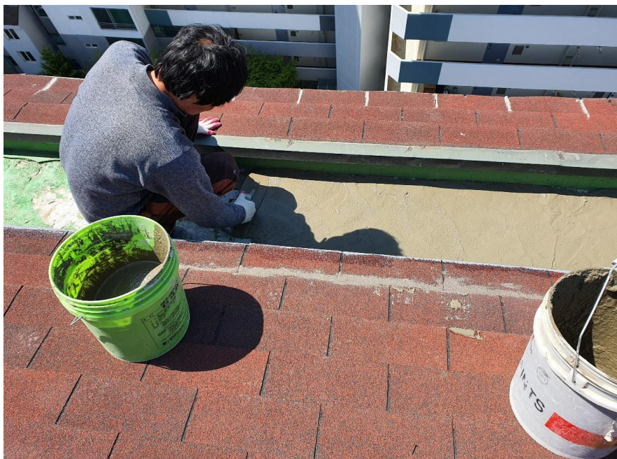
옥상 배수로 우레탄 철거 부분 미장
