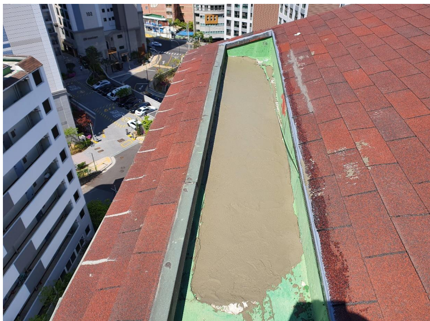
옥상 배수로 우레탄 철거 부분 미장
