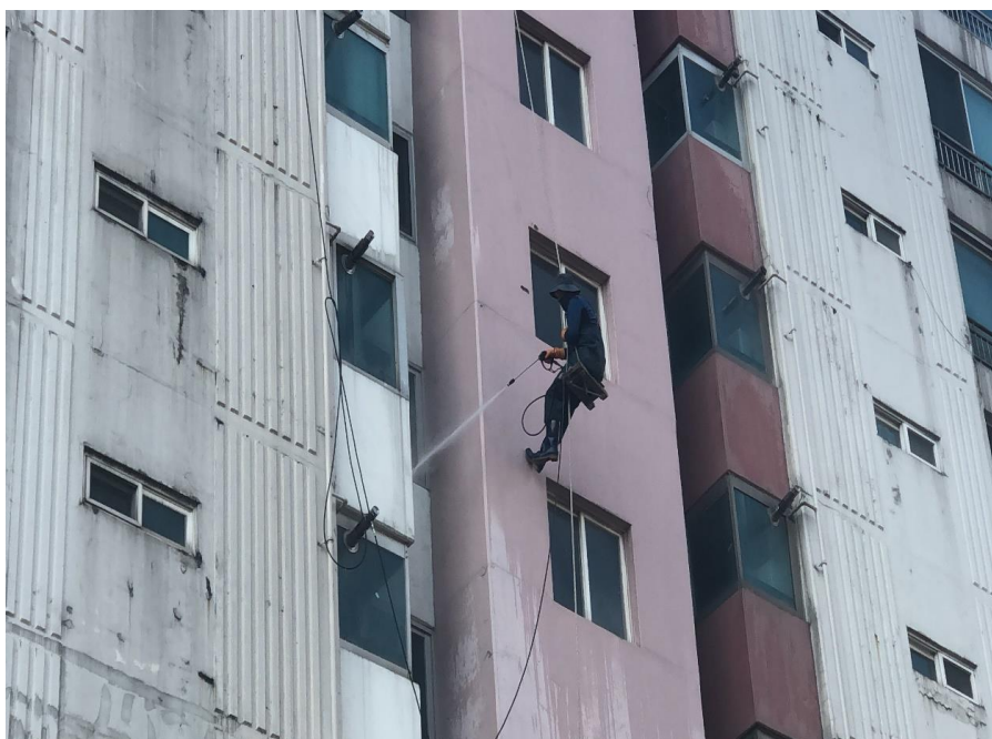
외벽 고압세척 공사
