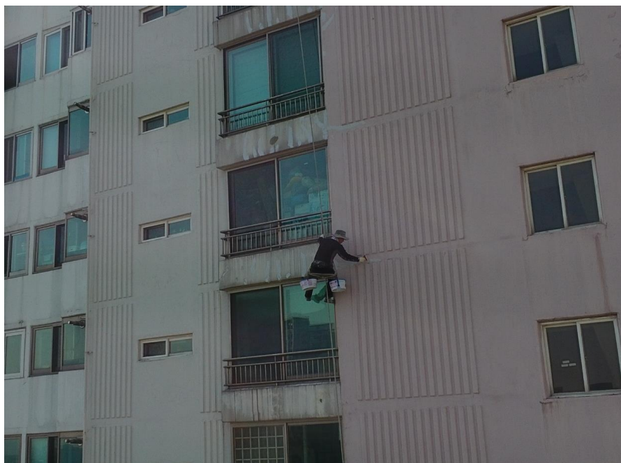
외벽 균열보수 공사
