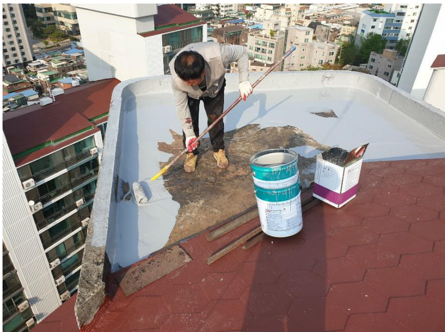
옥상 배수로 우레탄 중도 1차 도포
