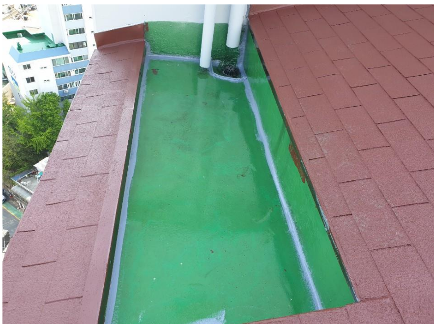
옥상 배수로 우레탄 실란트 도포
