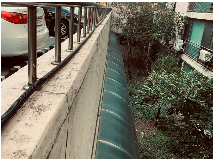
공사 전 부대시설 전경
