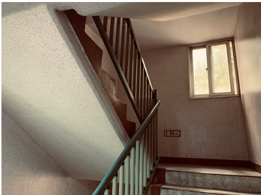
공사 전 내부 전경
