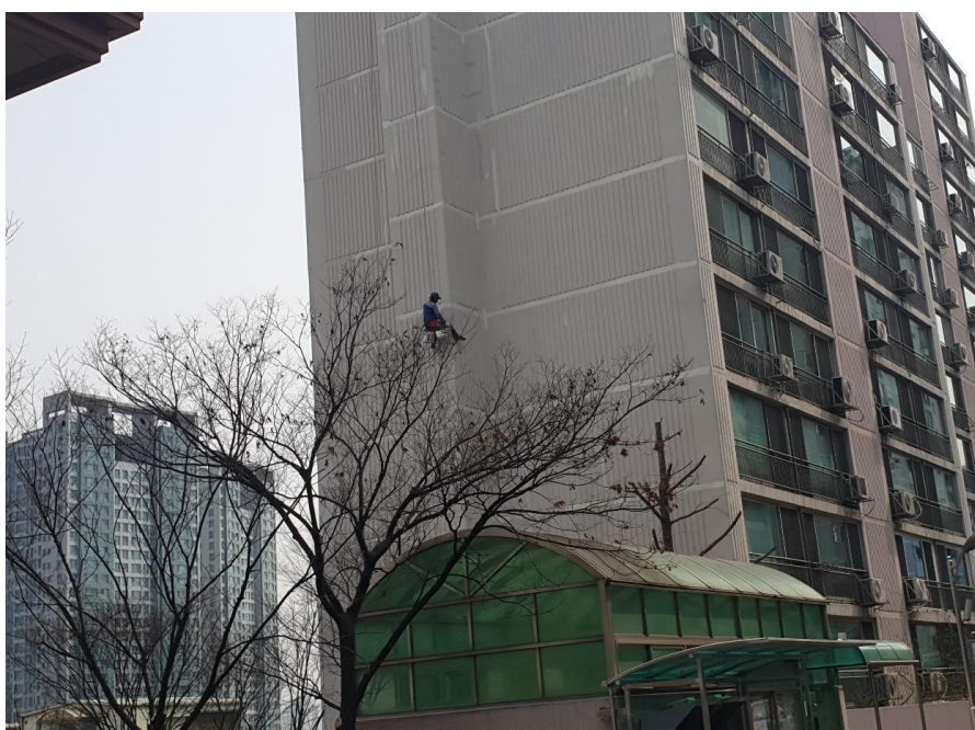
외벽 균열보수 공사(아트월PLUS 작업)
