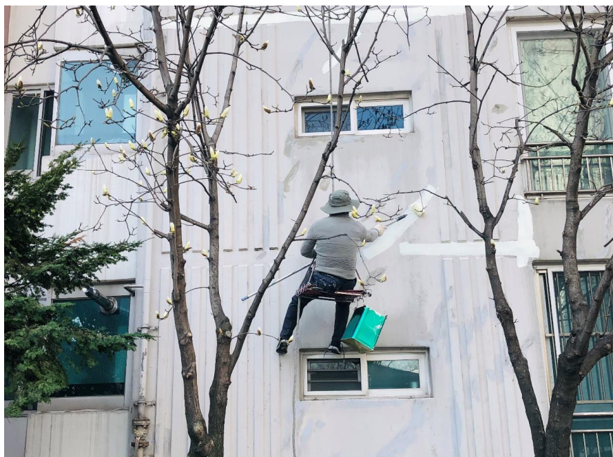
외벽 균열보수 공사(아트월PLUS 작업)
