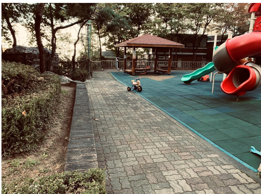
공사 전 부대시설 전경
