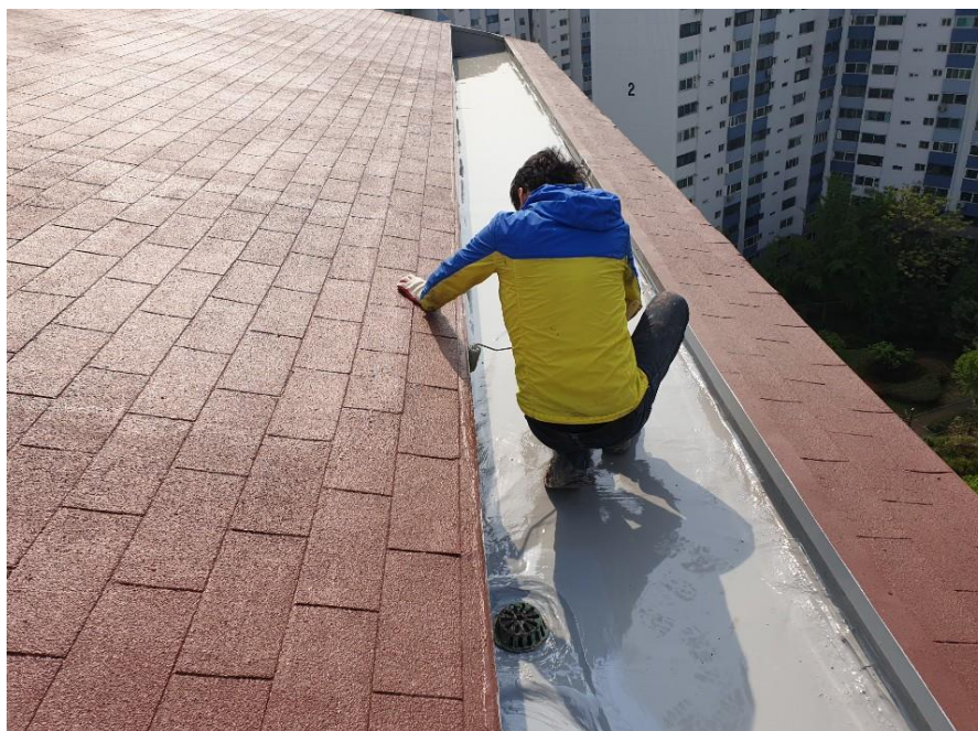
옥상 배수로 우레탄 중도 2차 도포
