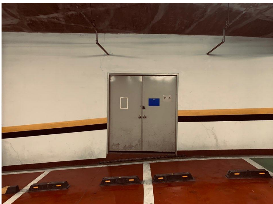
공사 전 부대시설 전경
