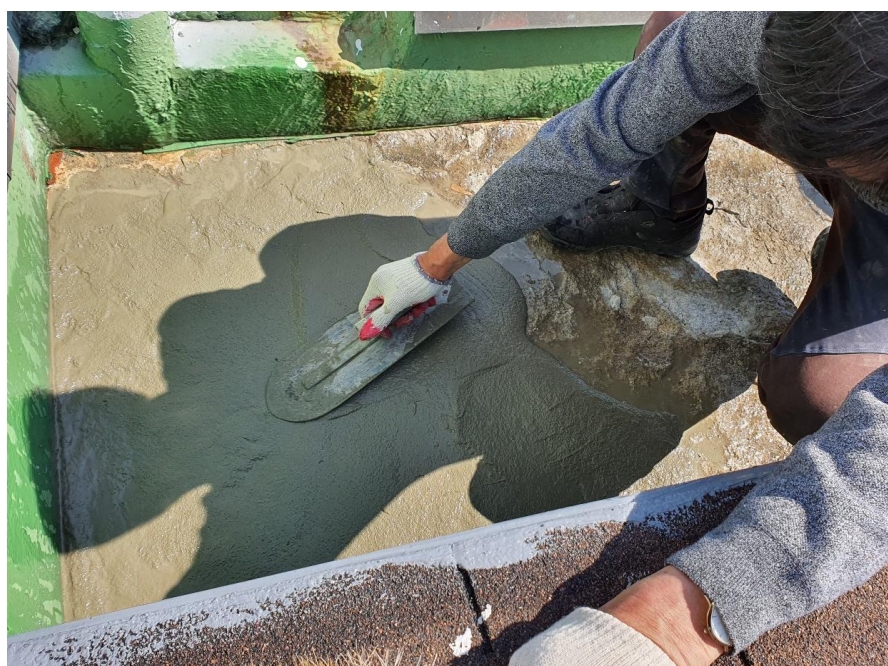
옥상 배수로 우레탄 철거 부분 미장
