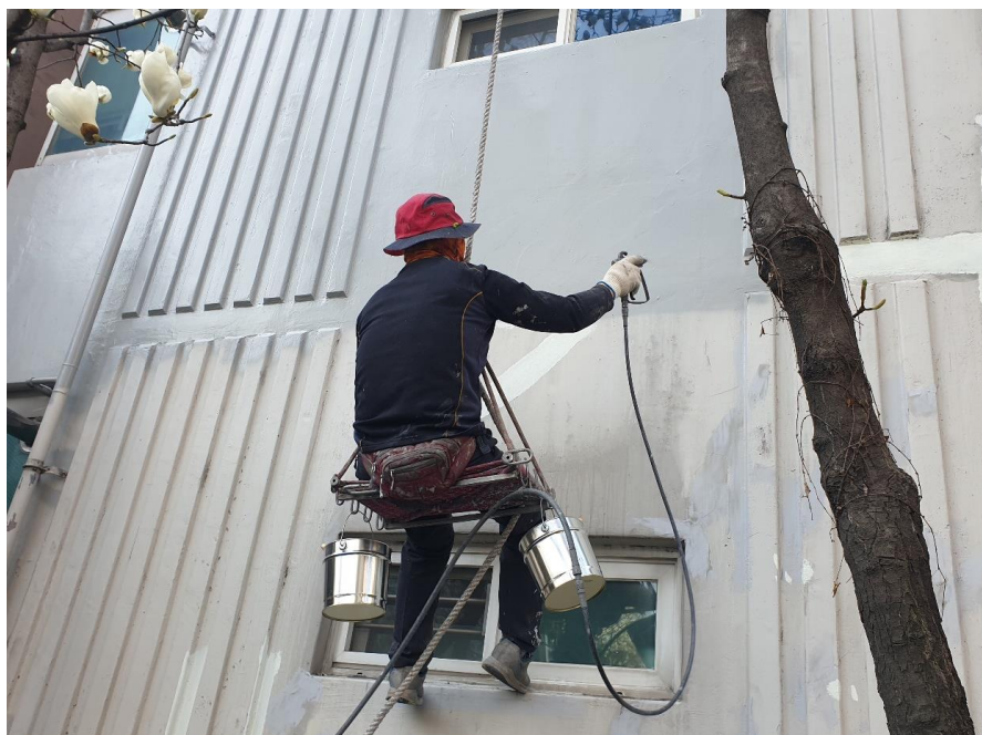
외벽 수성페인트 도장
