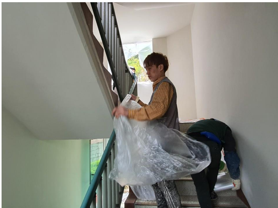
무늬코트 도포 전 보양작업
