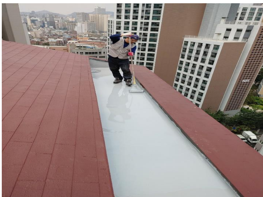
옥상 배수로 우레탄 상도 도포
