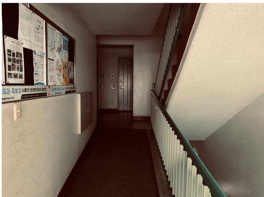
공사 전 내부 전경
