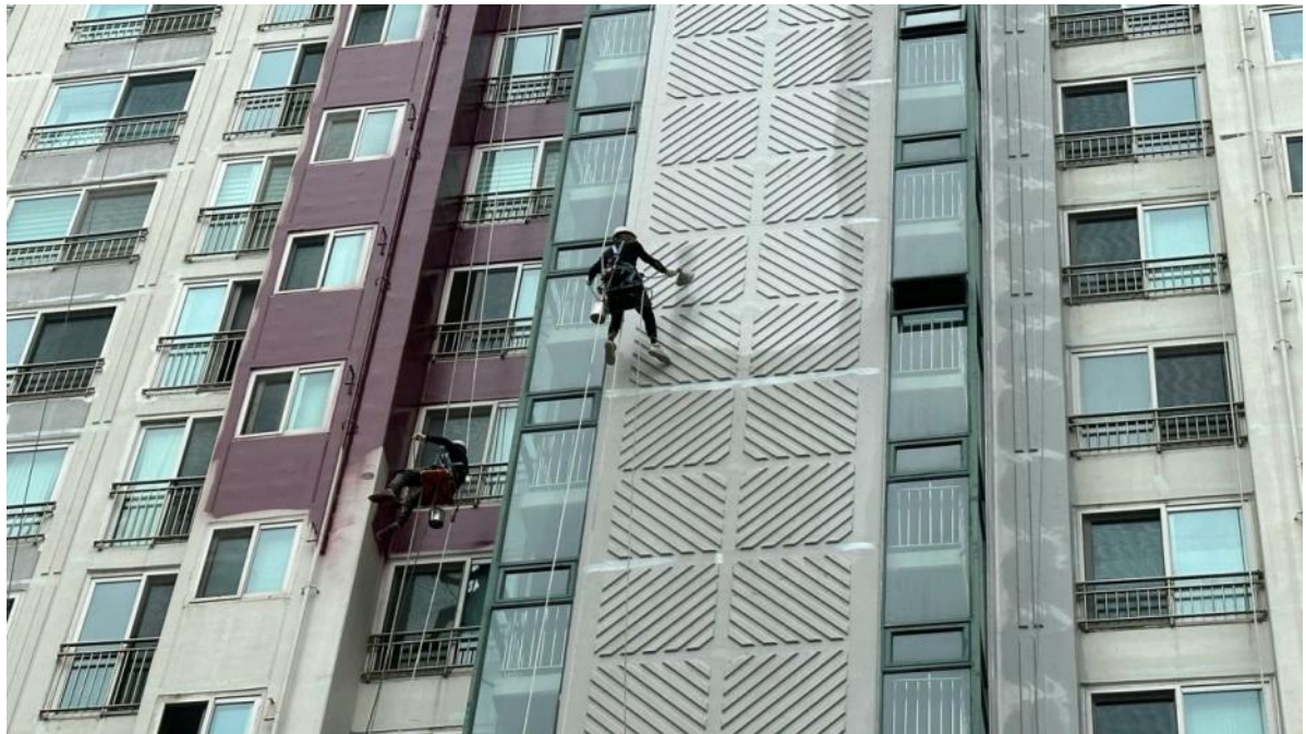
외벽 수성페인트 도장작업
