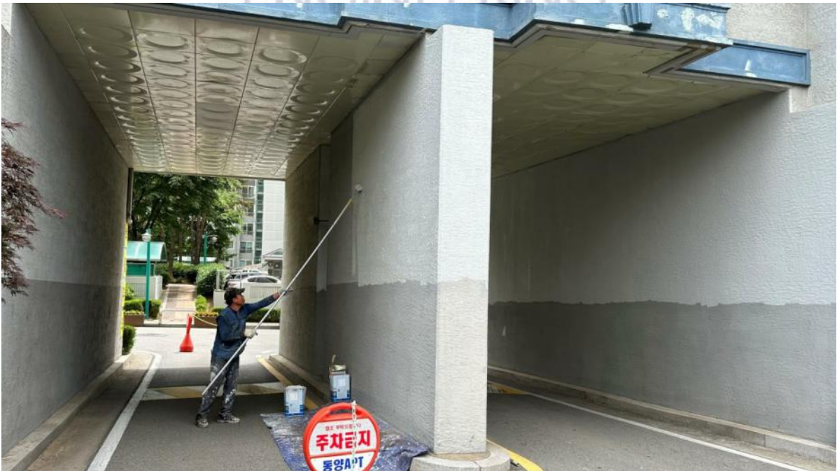
외벽 수성페인트 도장작업
