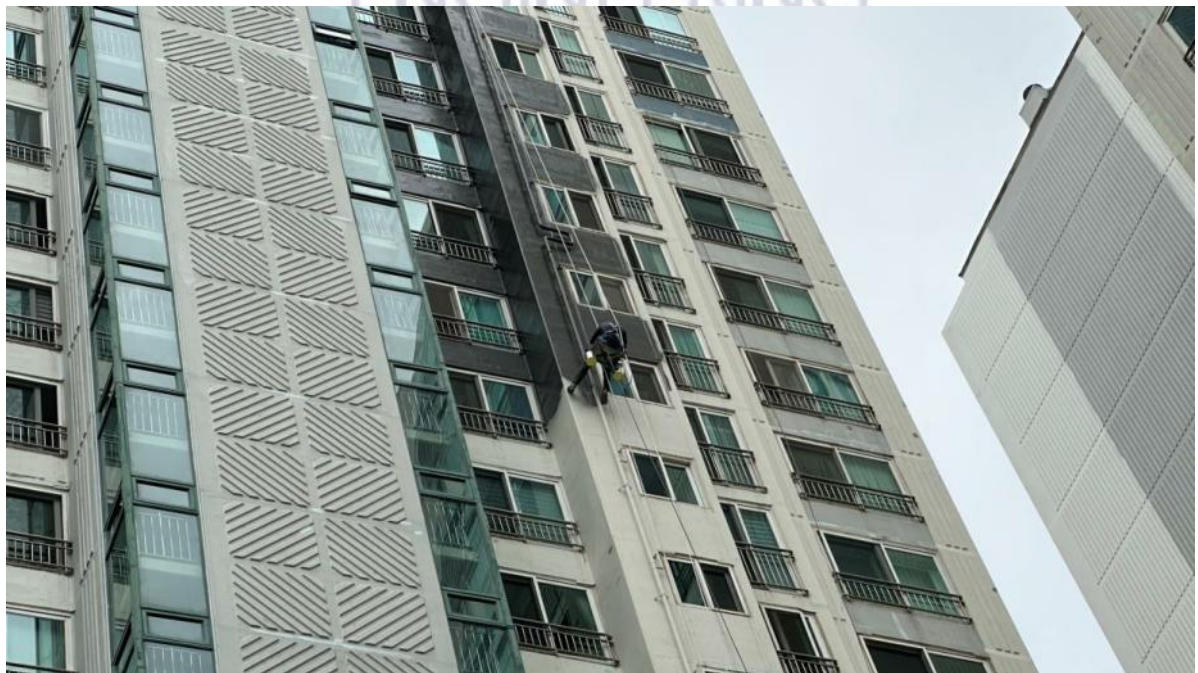
외벽 수성페인트 도장작업
