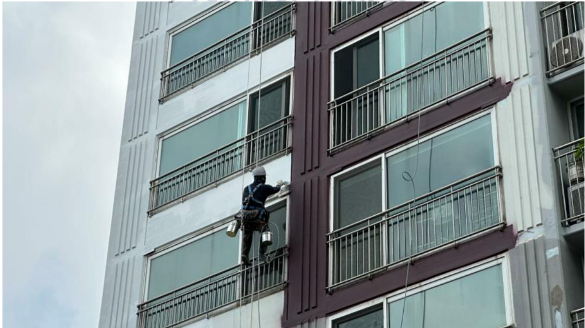
외벽 수성페인트 도장작업
