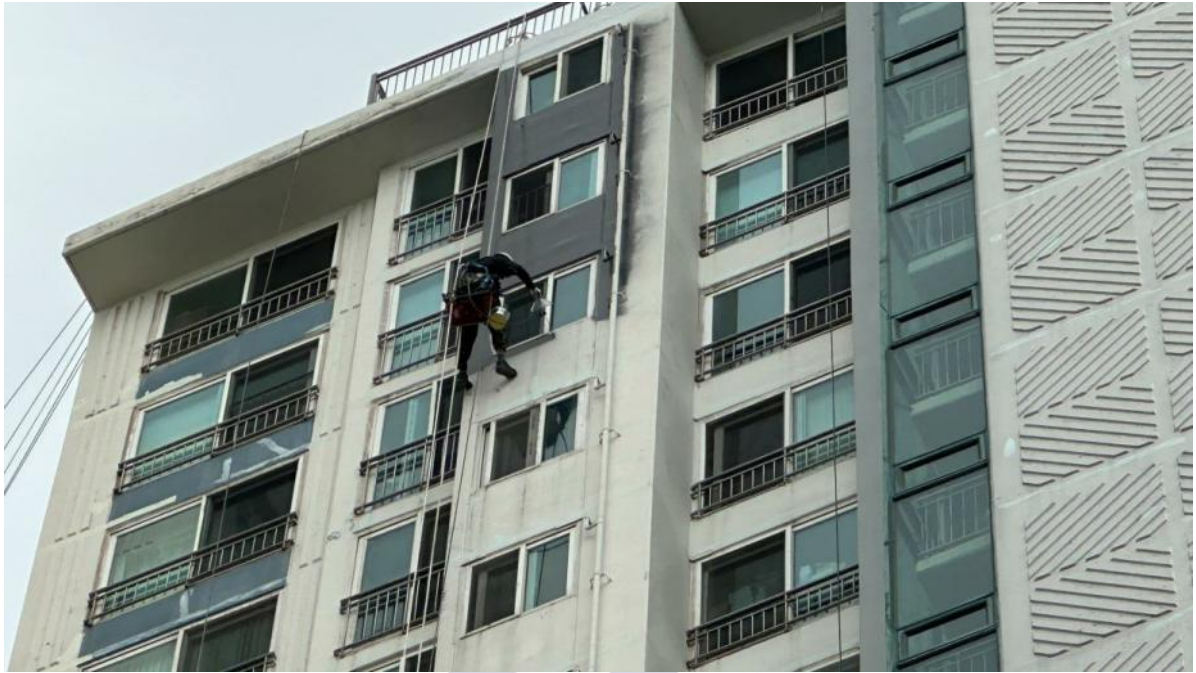
외벽 수성페인트 도장작업
