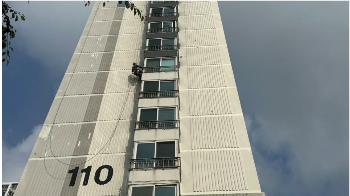
외벽 수성페인트 도장작업
