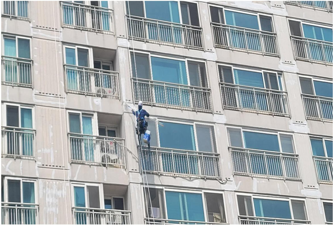
외벽 균열 보수 1차
