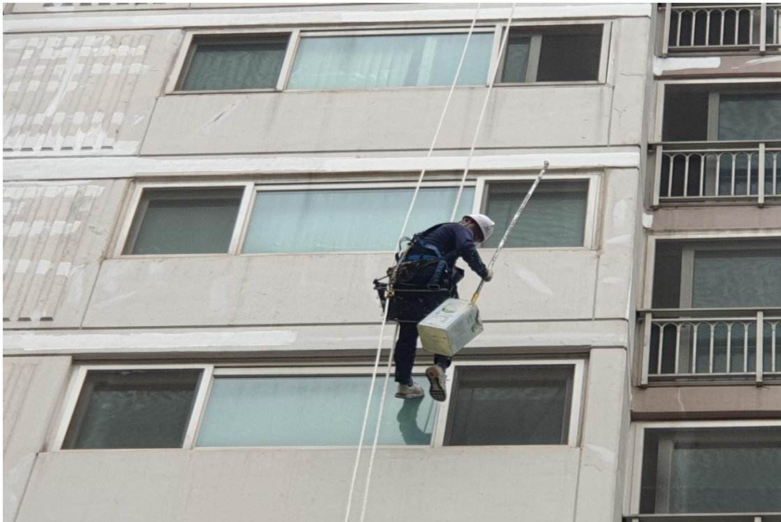
외벽 균열 보수 2차
