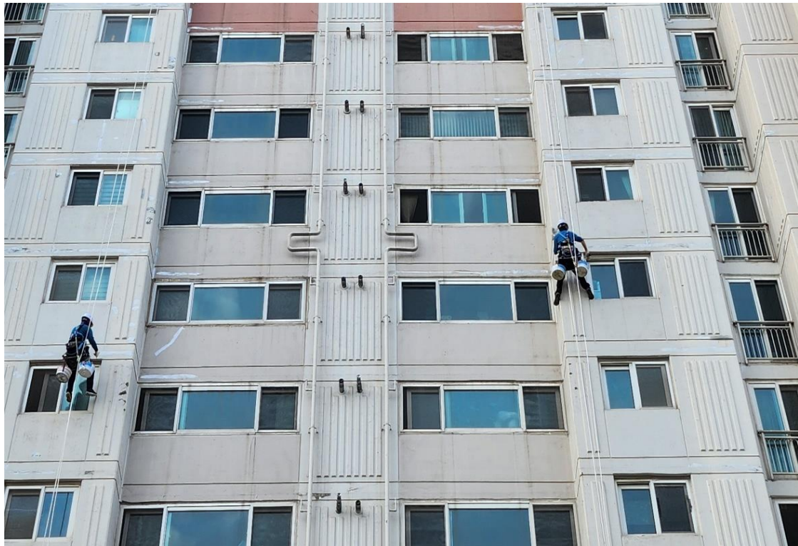
외벽 균열 보수 1차
