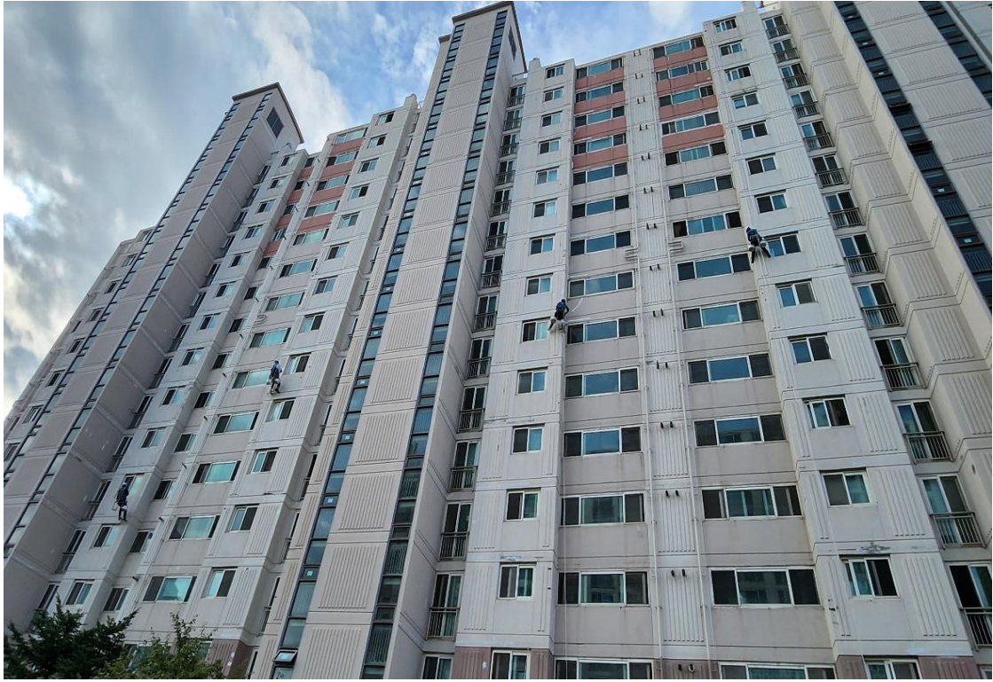
외벽 균열 보수 1차
