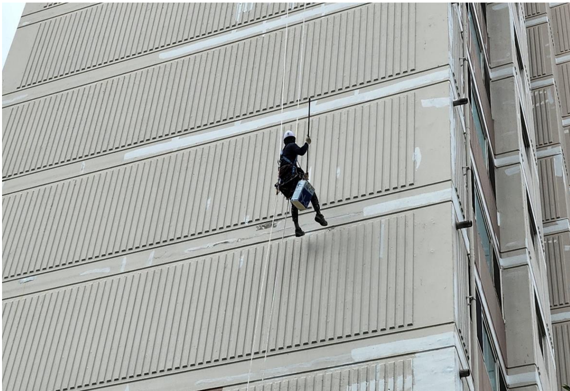
외벽 균열 보수 2차
