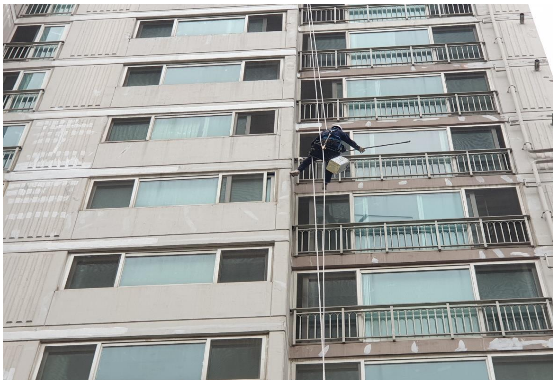
외벽 균열 보수 2차
