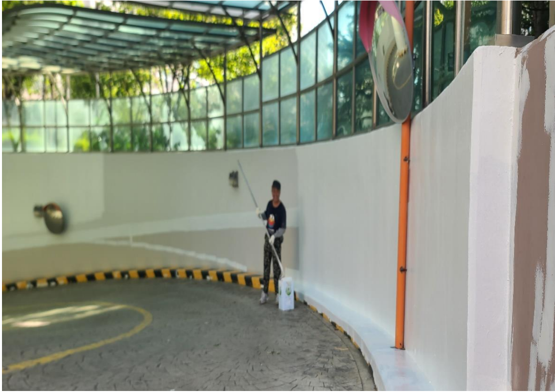
지하 주차장 도장
