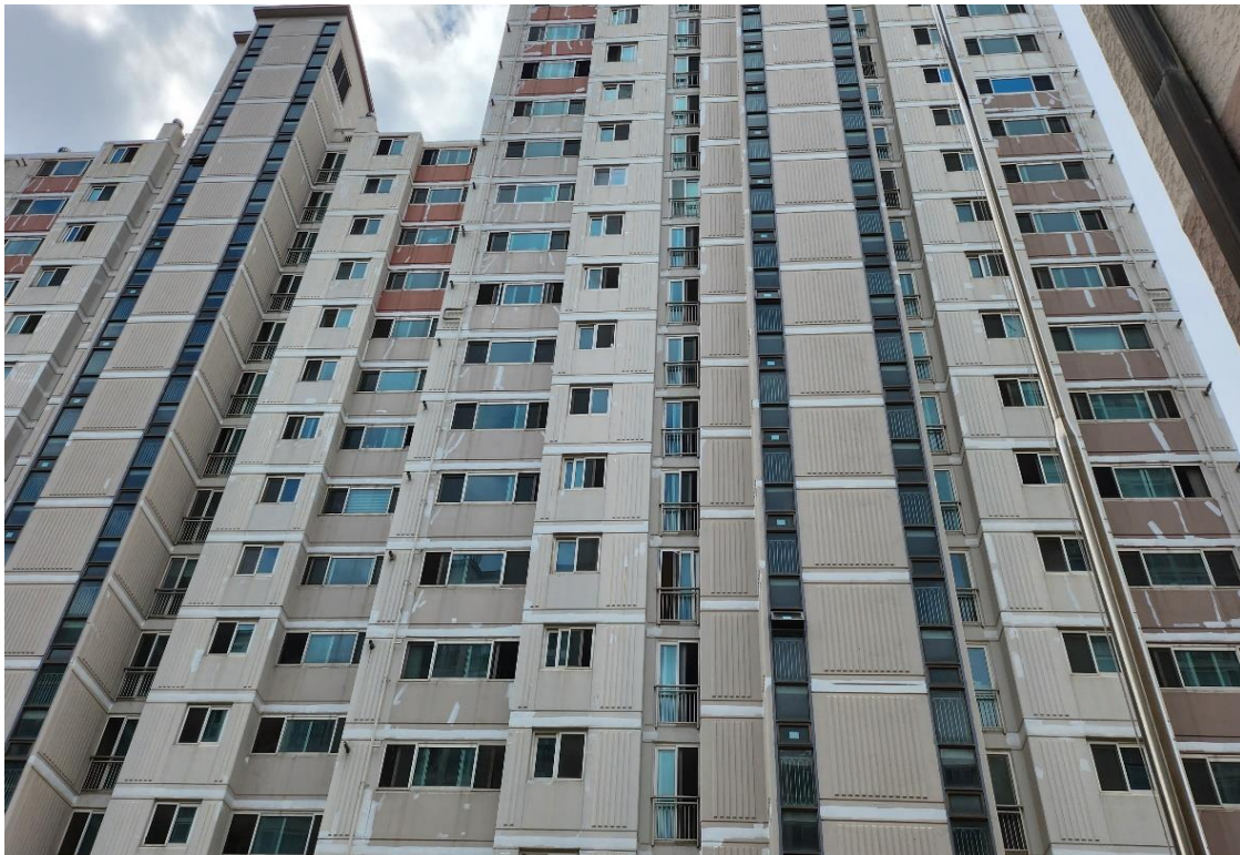
외벽 균열 보수 2차
