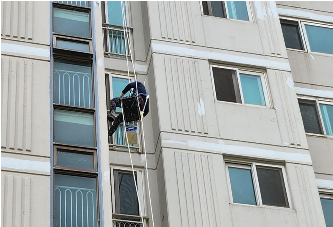
외벽 균열 보수 1차
