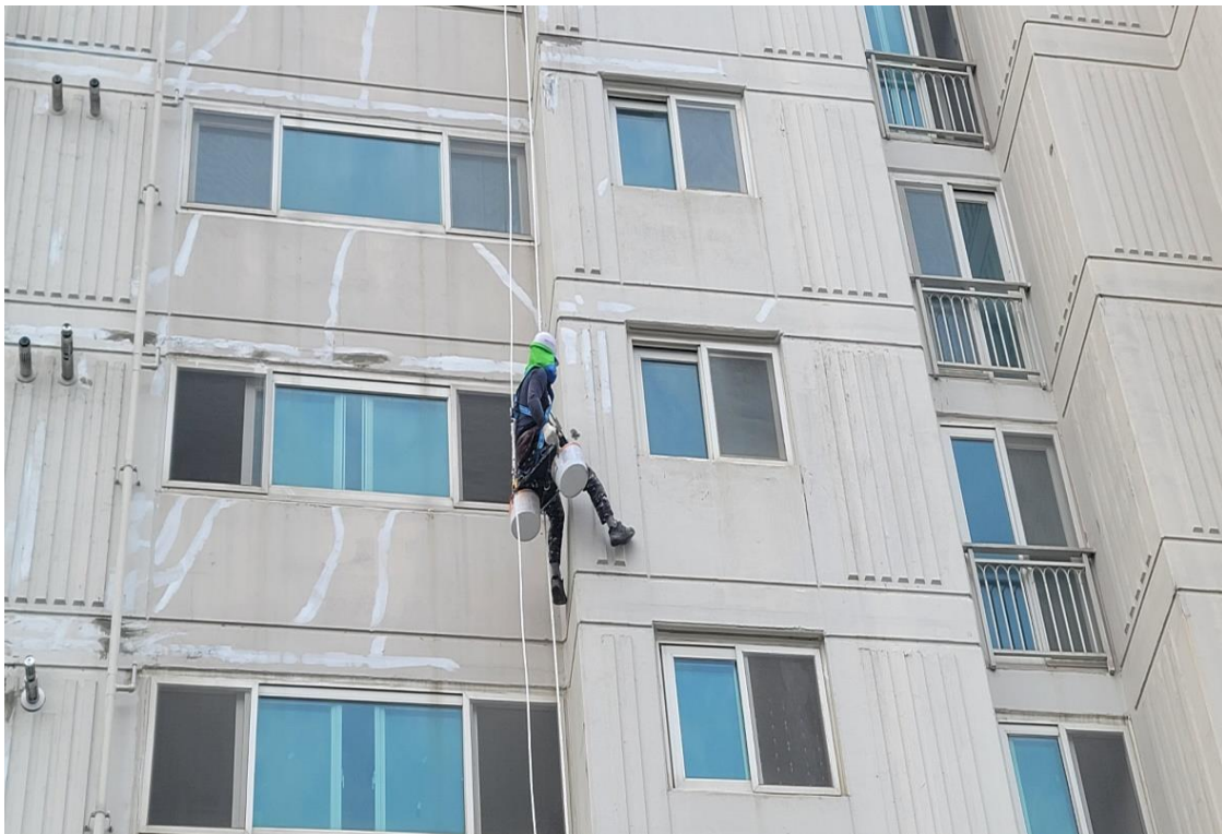
외벽 균열 보수 1차
