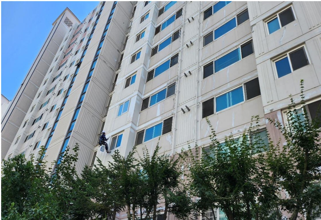
외벽 균열 보수 2차
