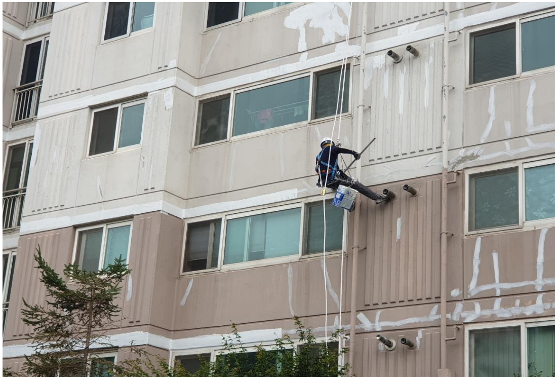
외벽 균열 보수 2차
