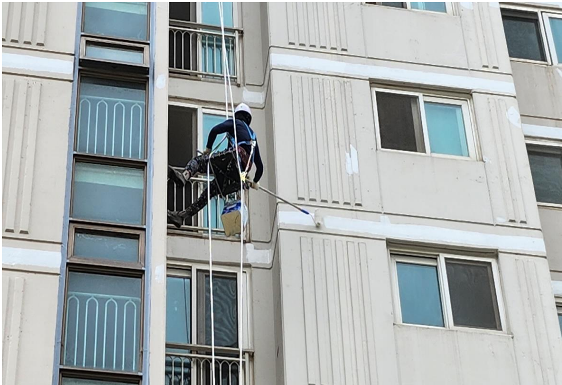
외벽 균열 보수 2차
