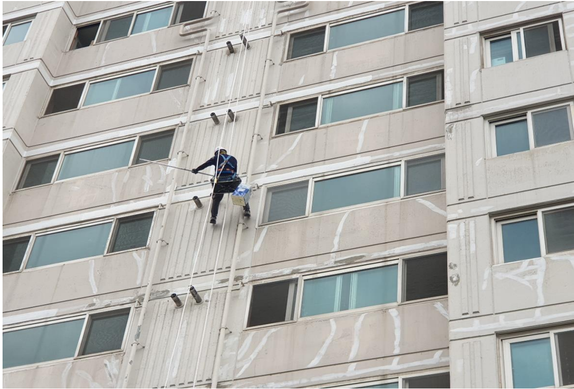
외벽 균열 보수 2차
