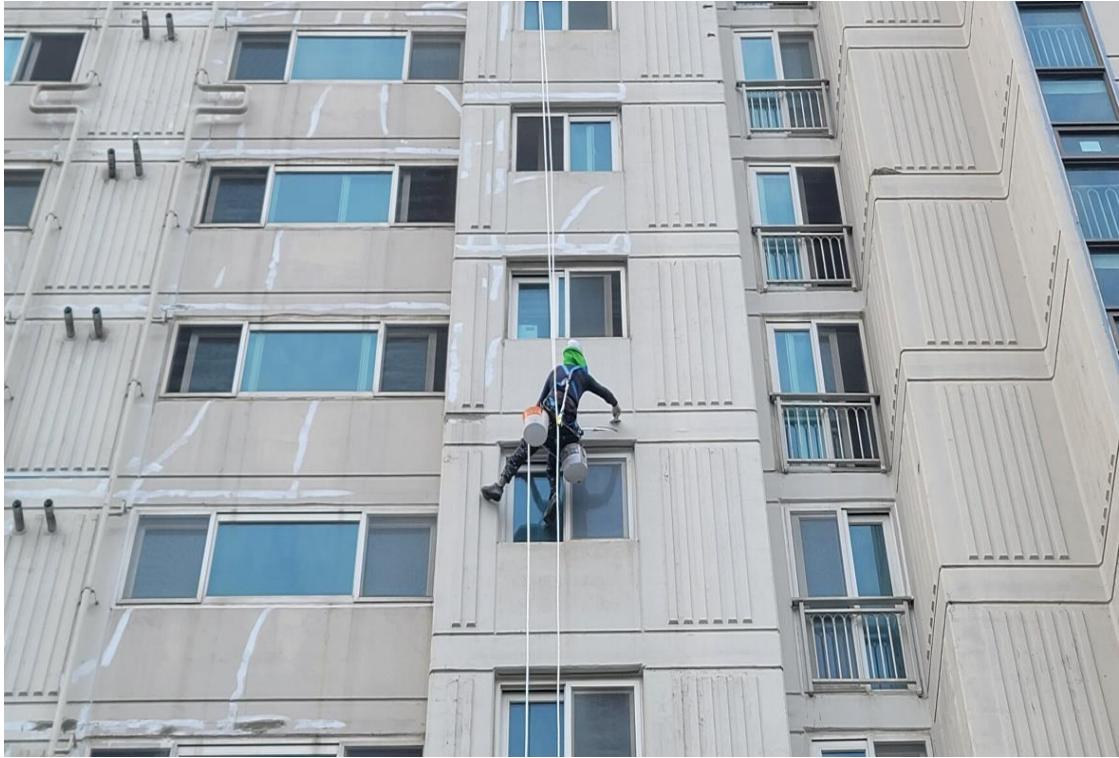
외벽 균열 보수 1차
