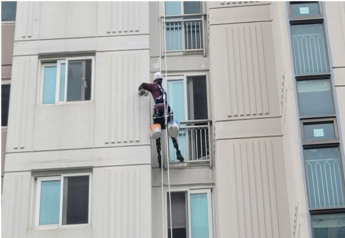
외벽 균열 보수 1차
