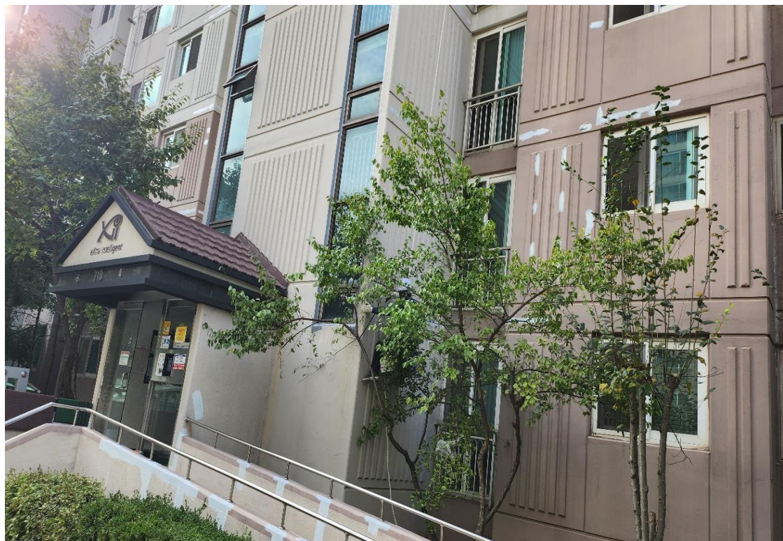
외벽 균열 보수 1차
