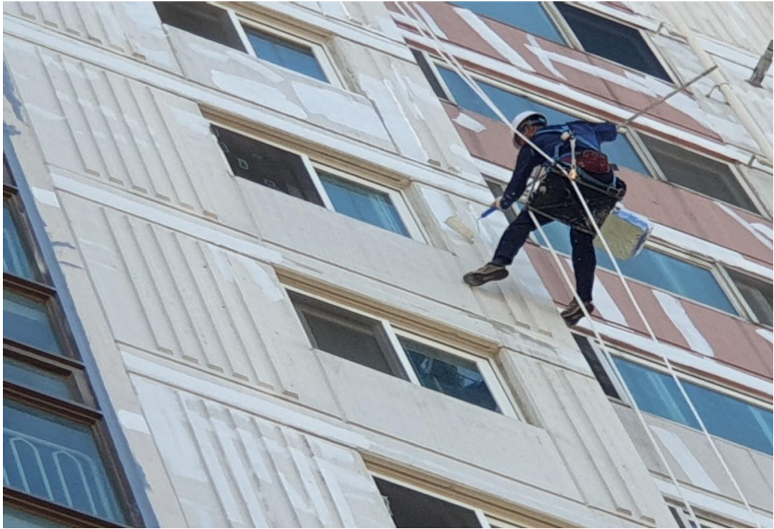
외벽 균열 보수 2차
