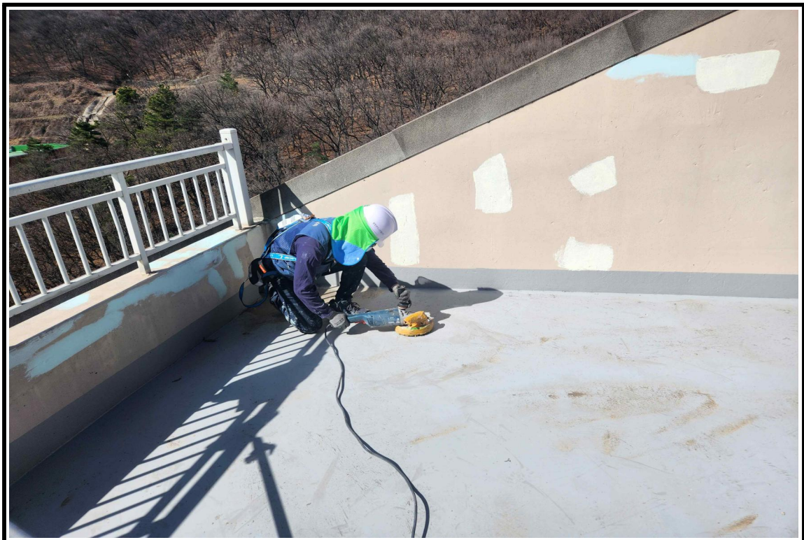
◎ 공사 중(옥상 배수로 방수공사)
