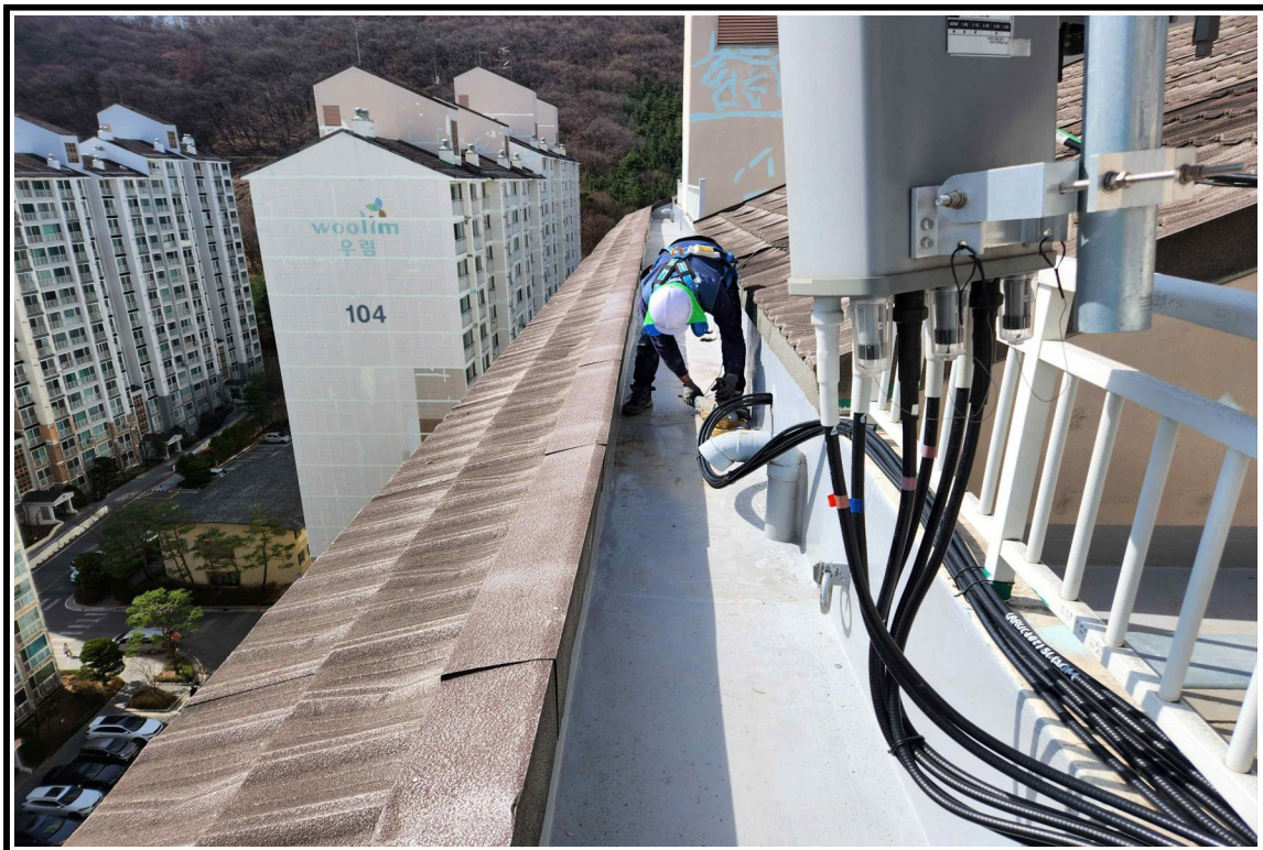
◎ 공사 중(옥상 배수로 방수공사)
