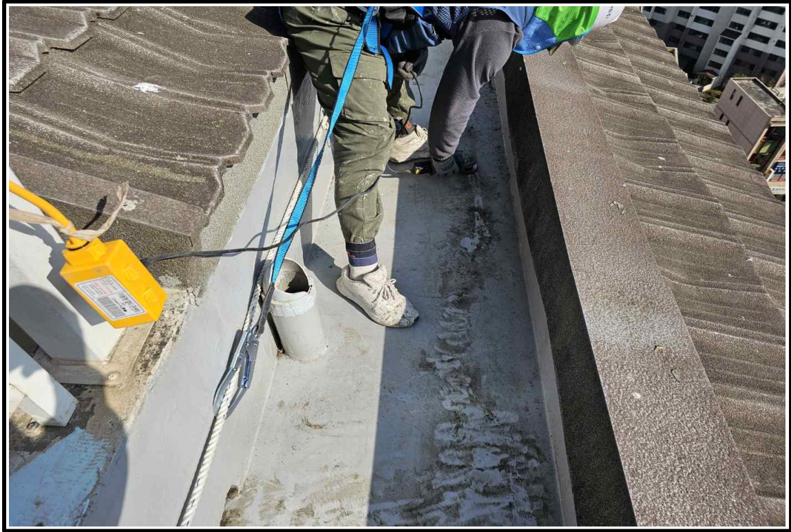
◎ 공사 중(옥상 배수로 방수공사)
