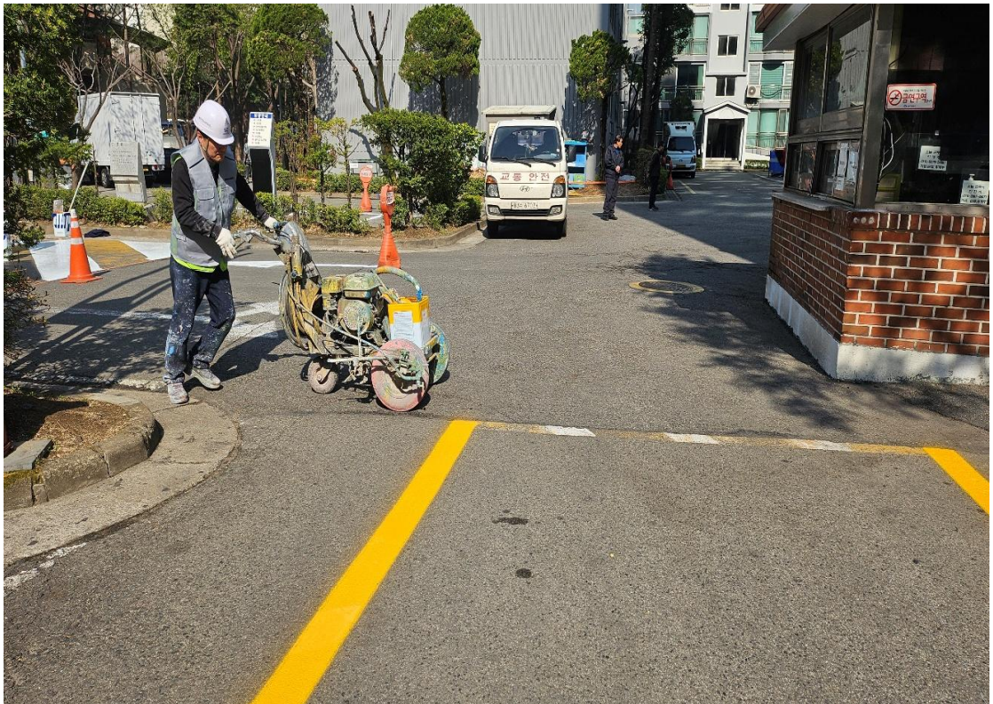
부대시설 도장 작업
