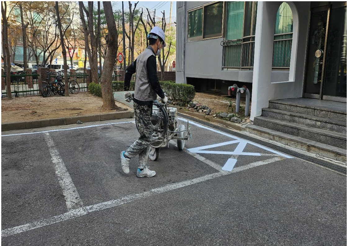
부대시설 도장 작업
