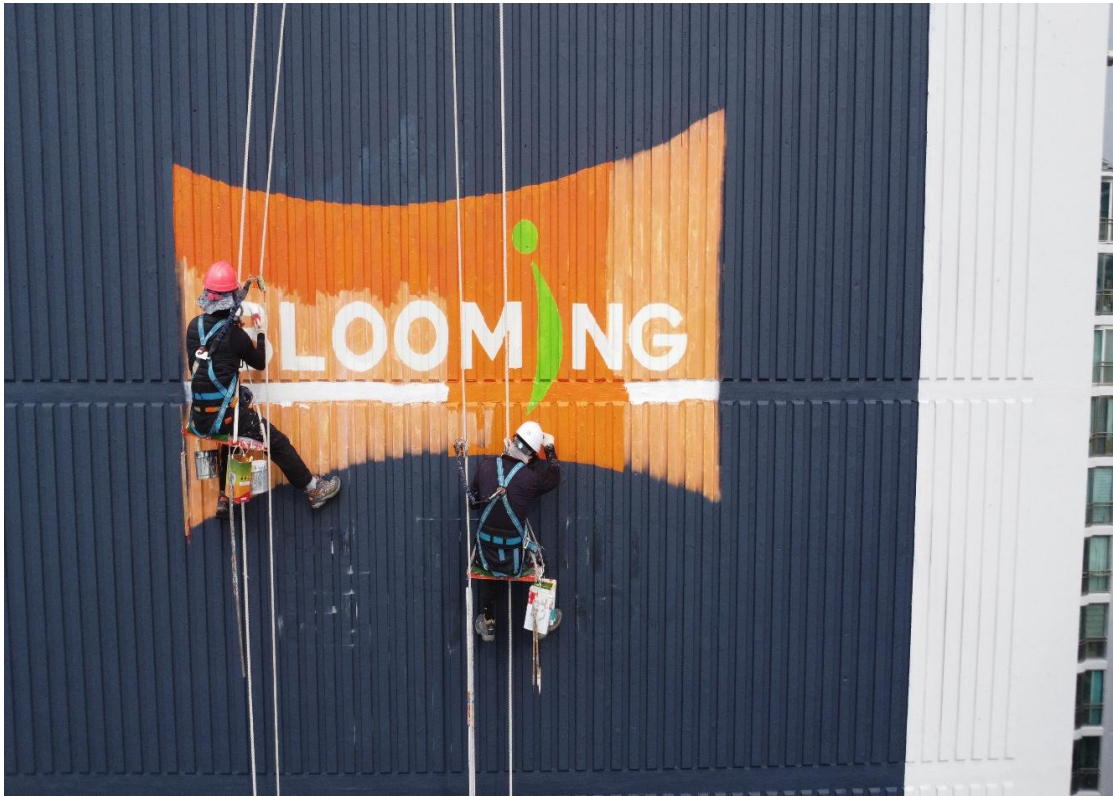
외벽 그래픽 작업
