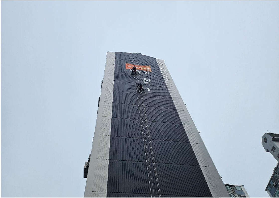
외벽 그래픽 작업
