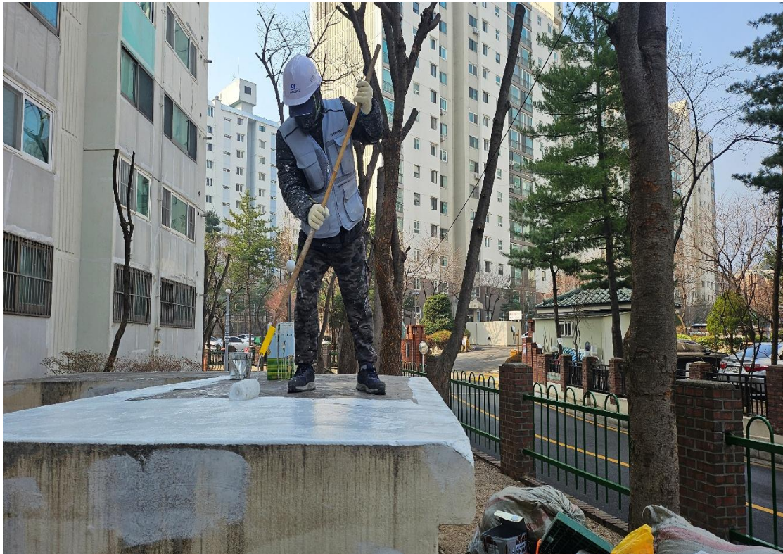
부대시설 도장 작업
