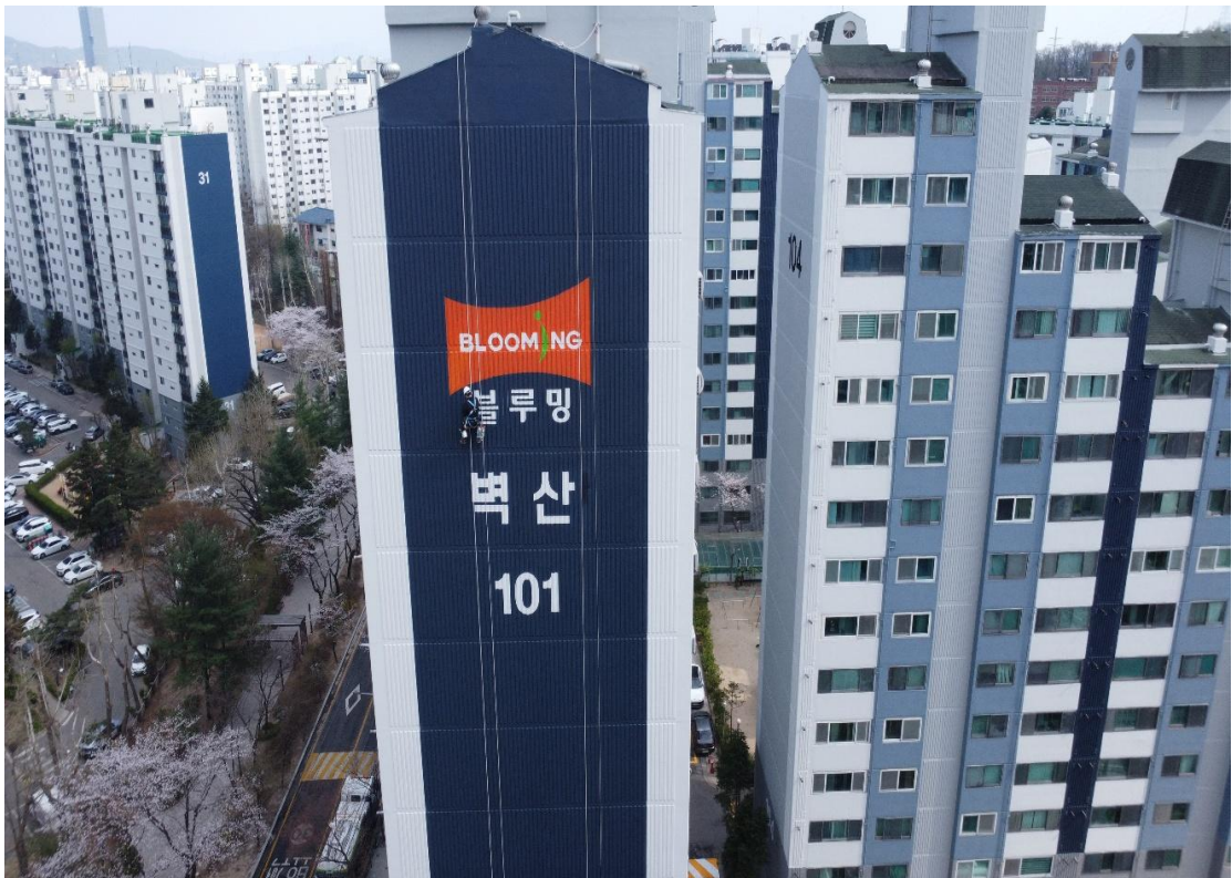
외벽 그래픽 작업
