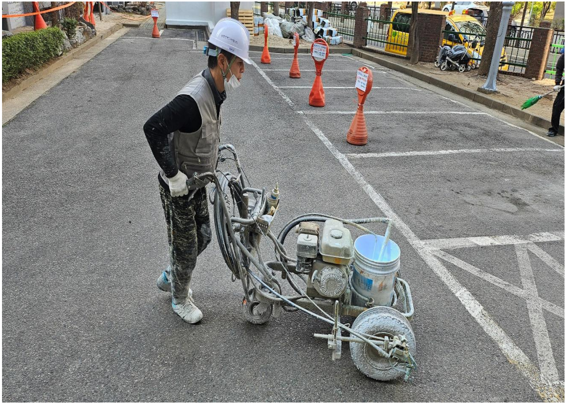
부대시설 도장 작업
