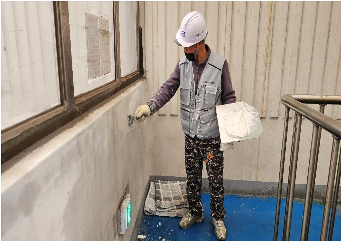
부대시설 도장 작업
