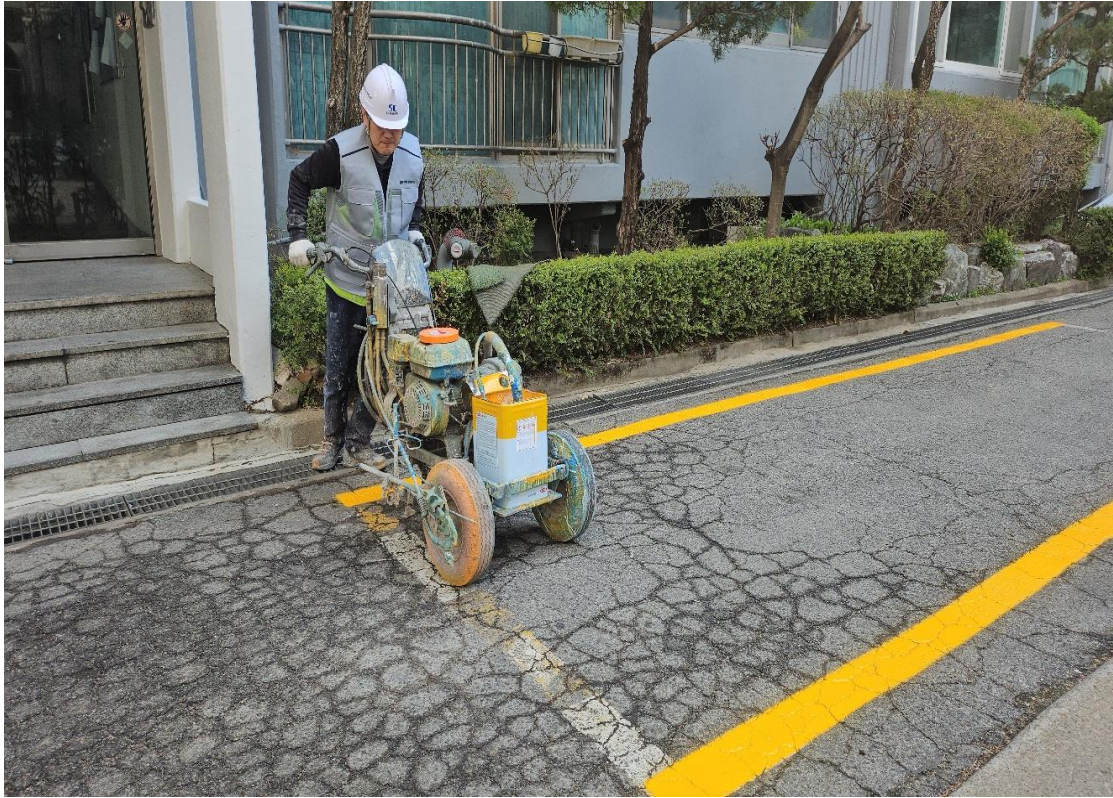
부대시설 도장 작업
