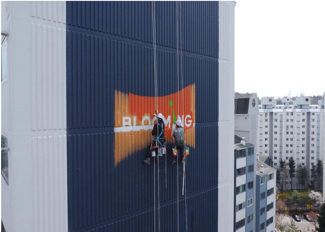
외벽 그래픽 작업
