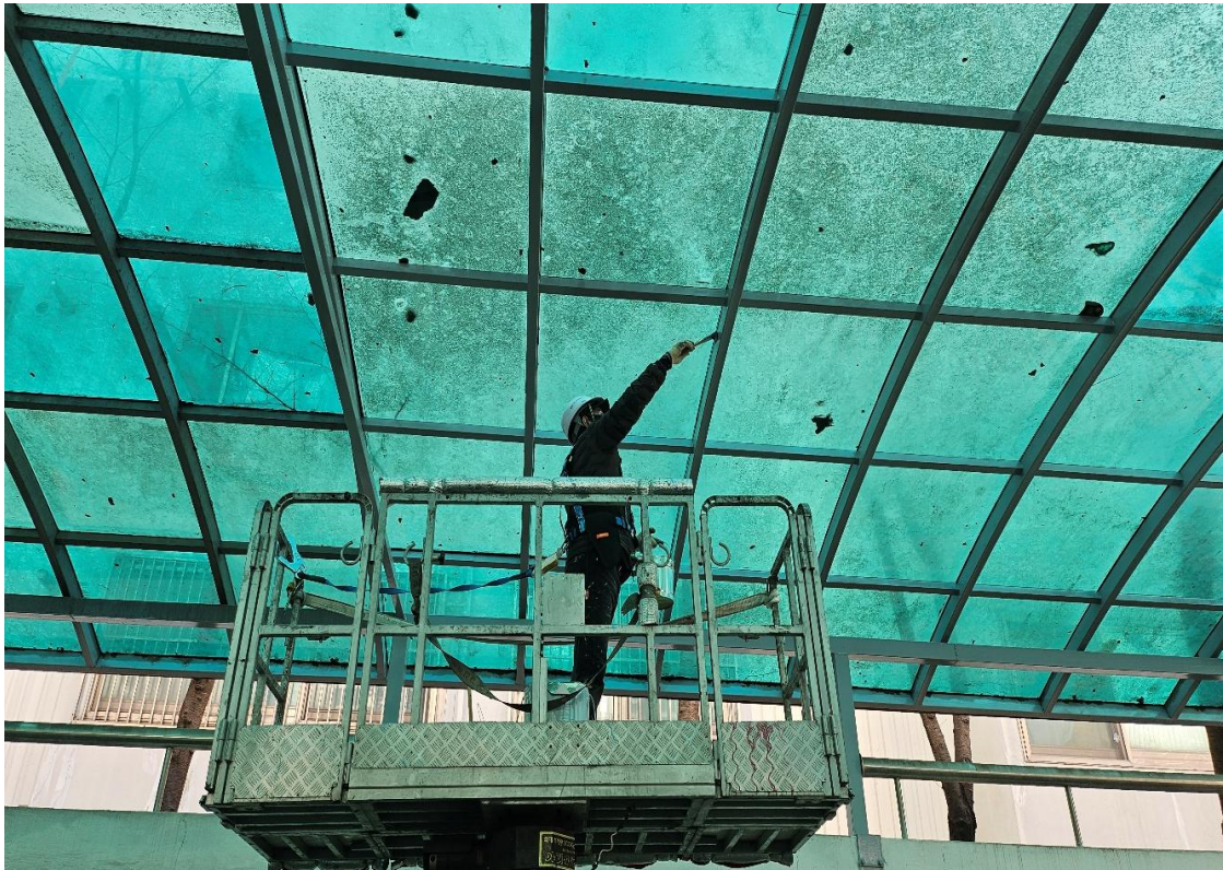
부대시설 도장 작업
