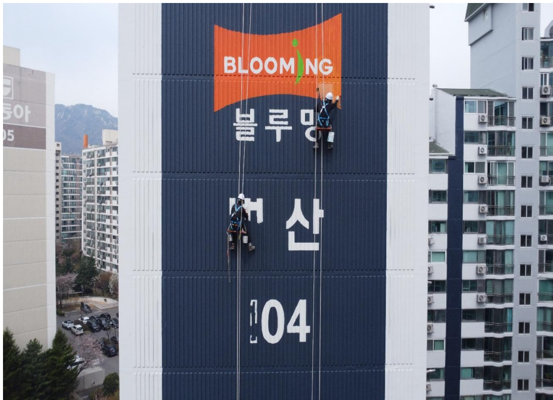
외벽 그래픽 작업
