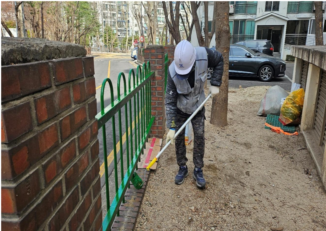
부대시설 도장 작업
