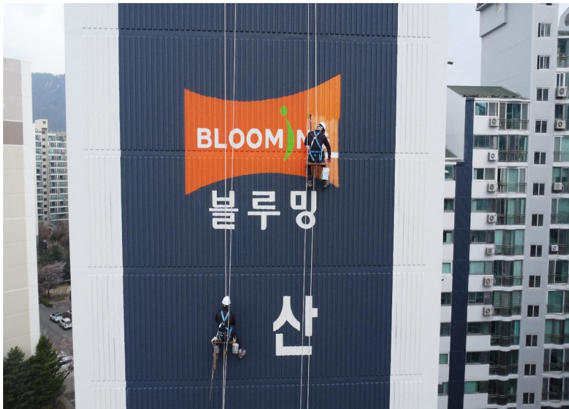
외벽 그래픽 작업
