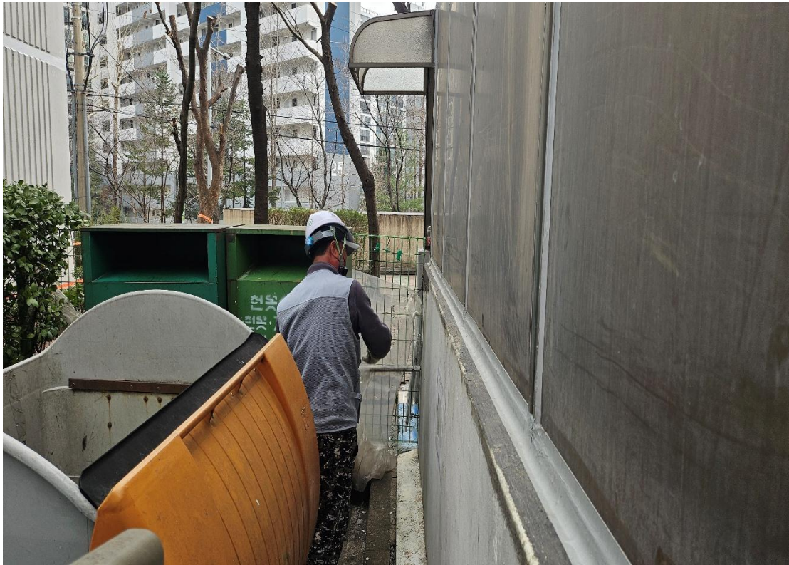
부대시설 도장 작업
