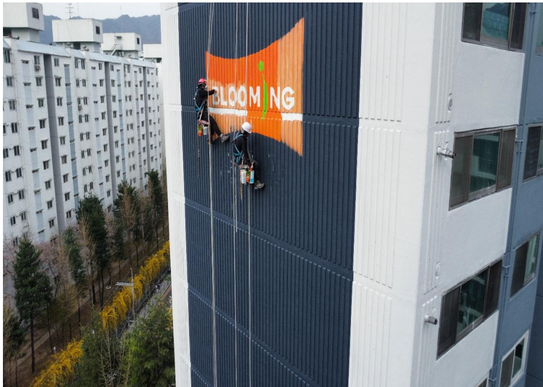
외벽 그래픽 작업
