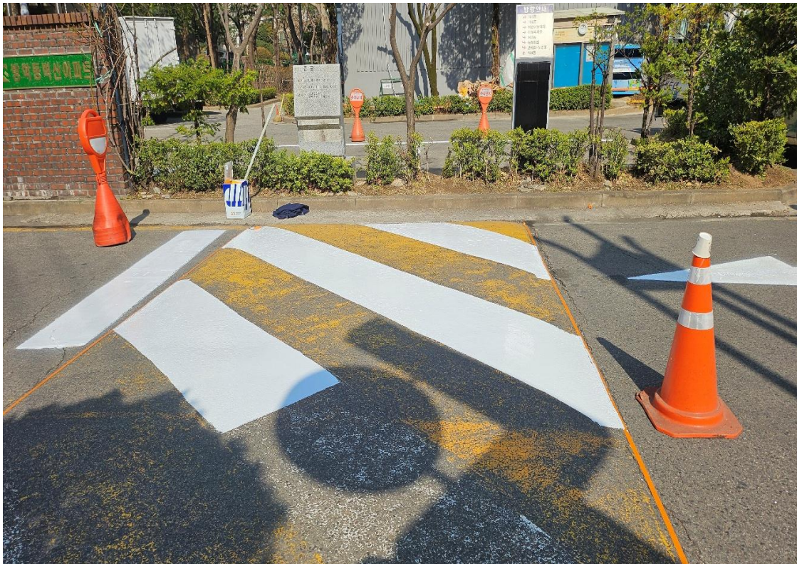
부대시설 도장 작업
