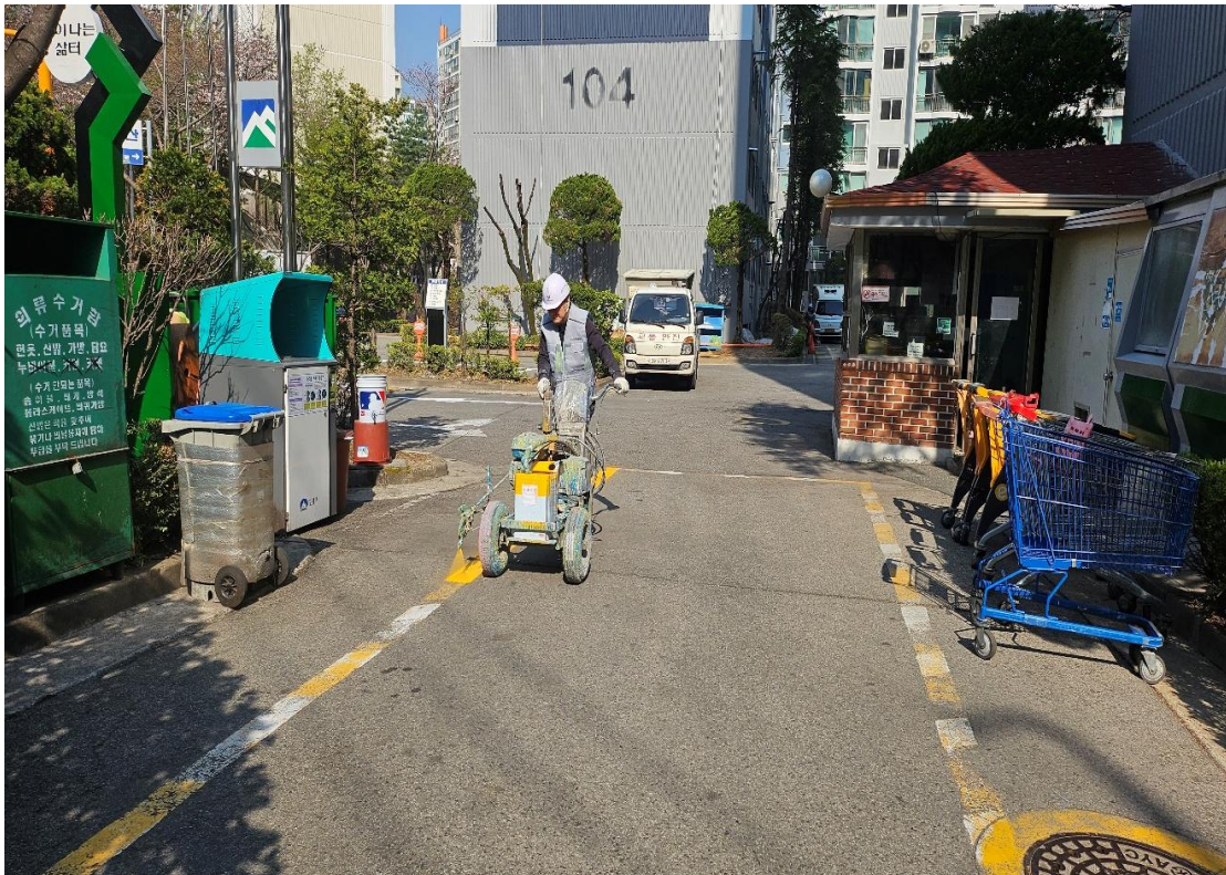
부대시설 도장 작업
