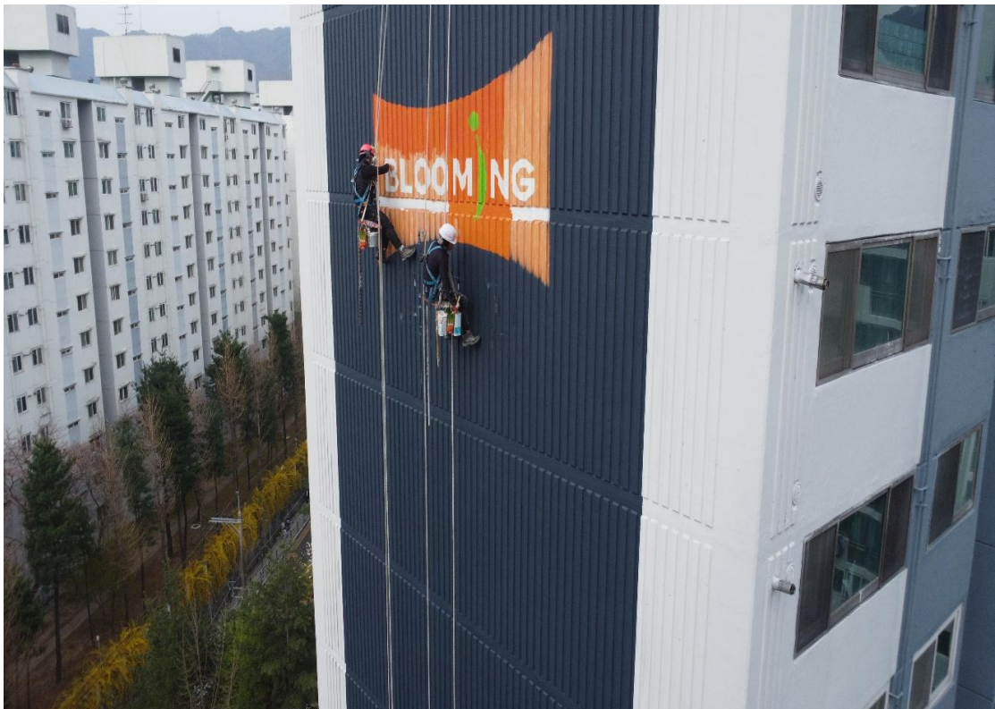
외벽 그래픽 작업
