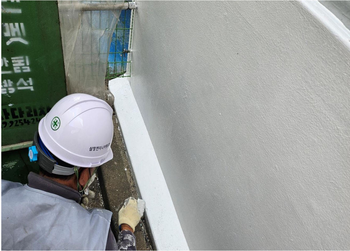
부대시설 도장 작업
