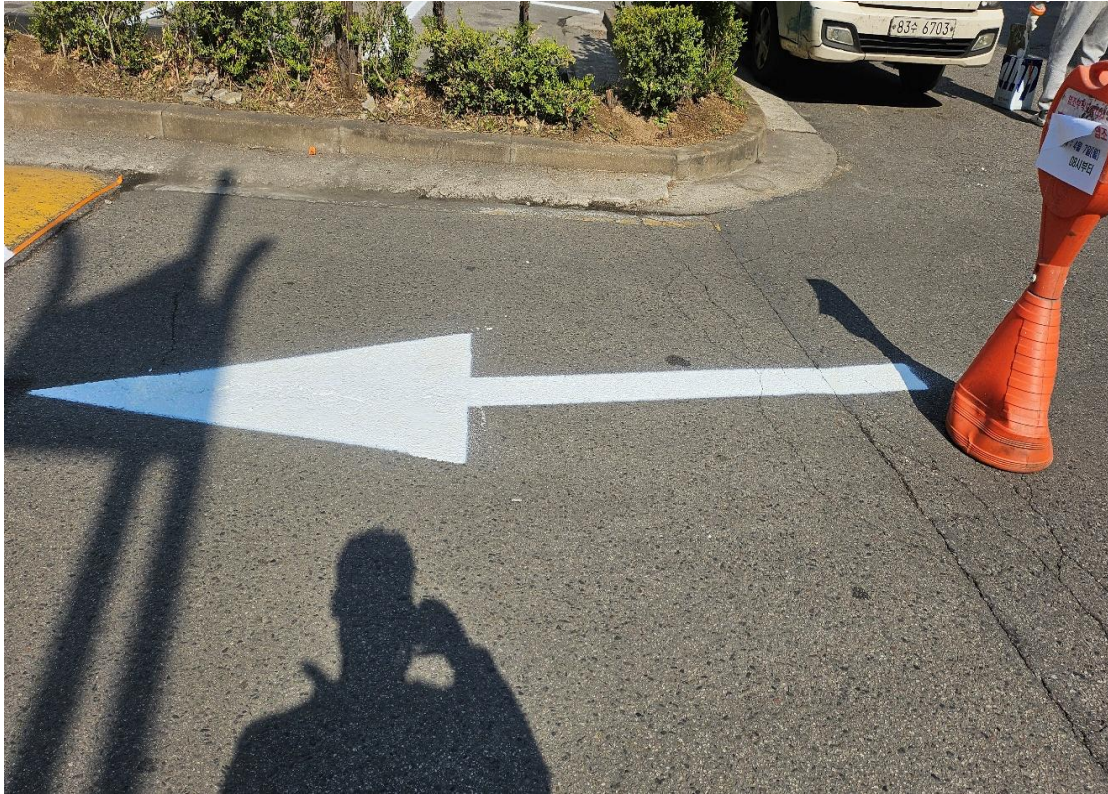
부대시설 도장 작업
