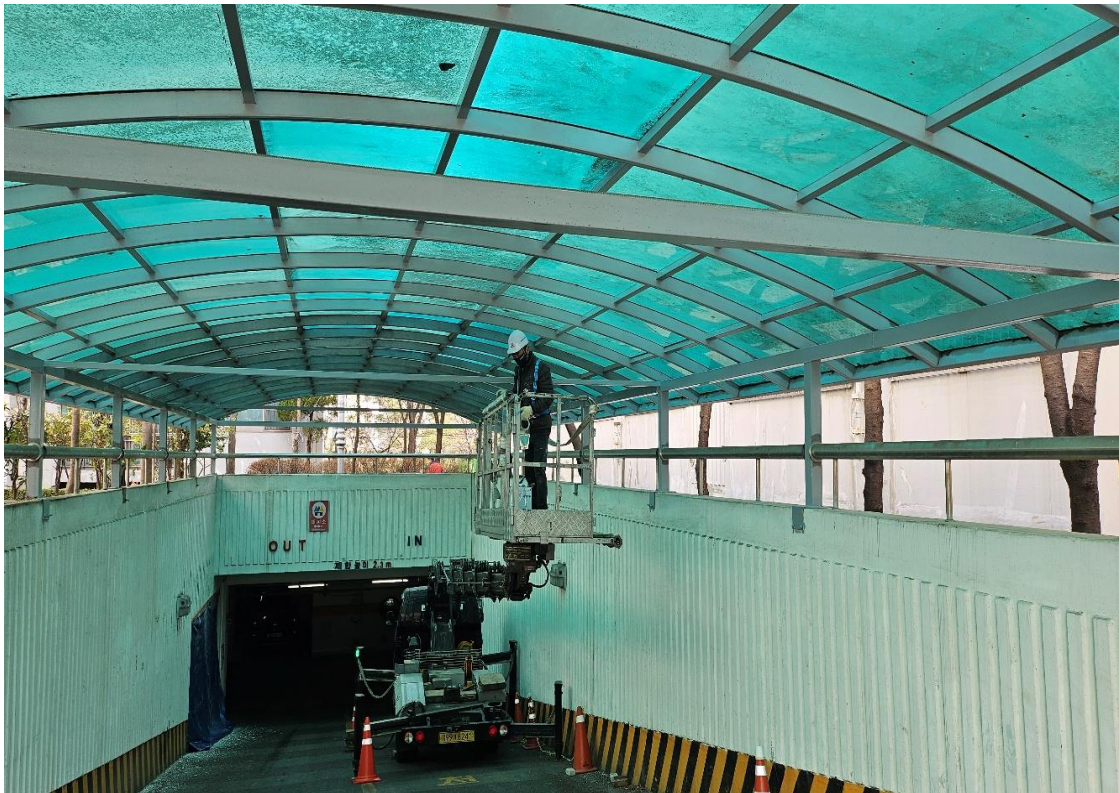
부대시설 도장 작업
