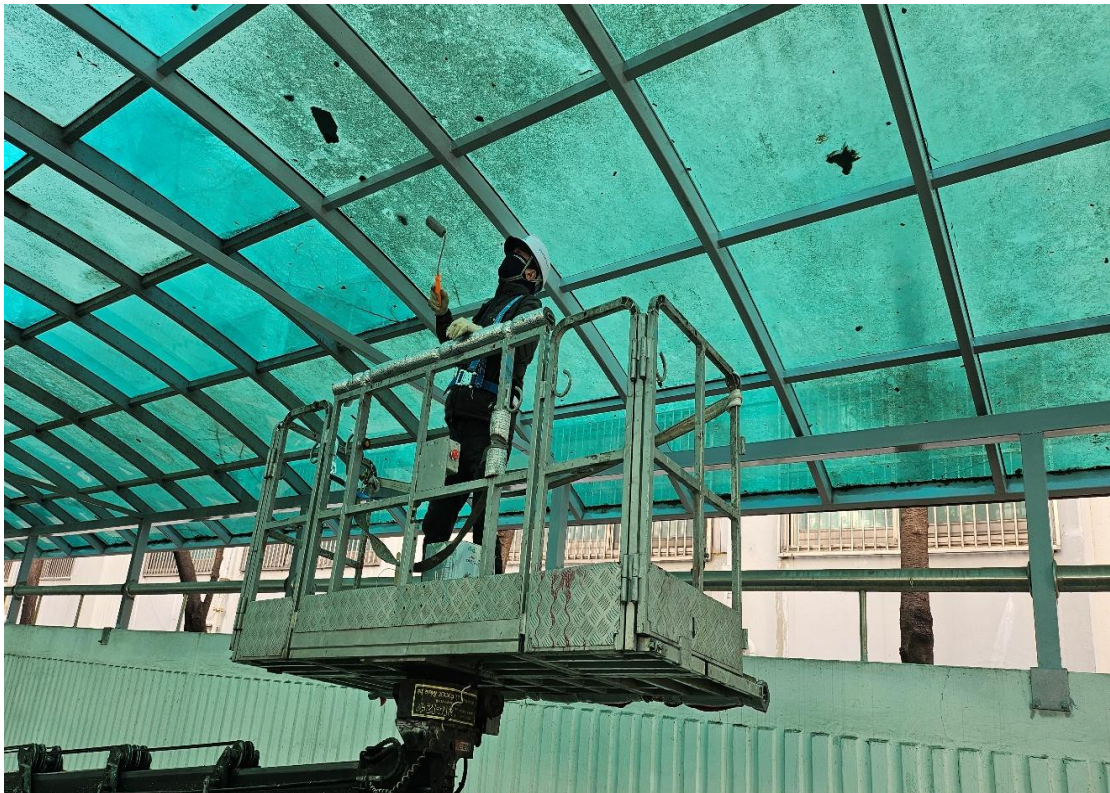
부대시설 도장 작업
