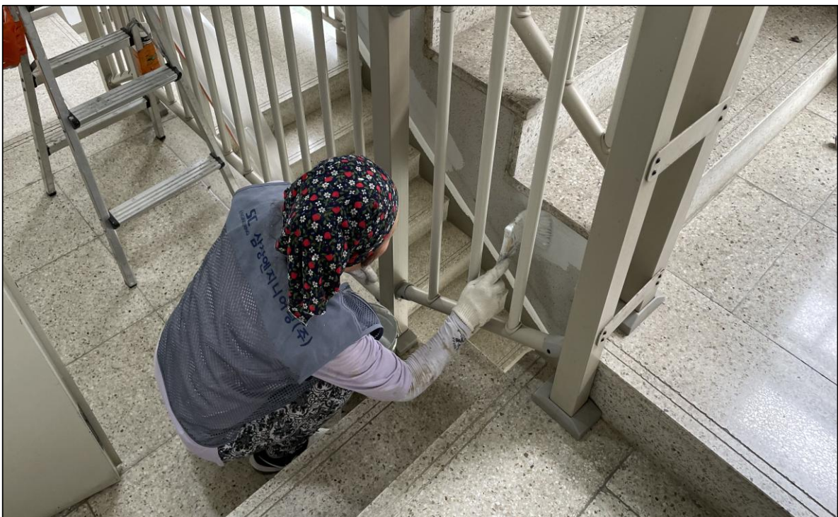
공용계단실 내부 수성페인트 도장
