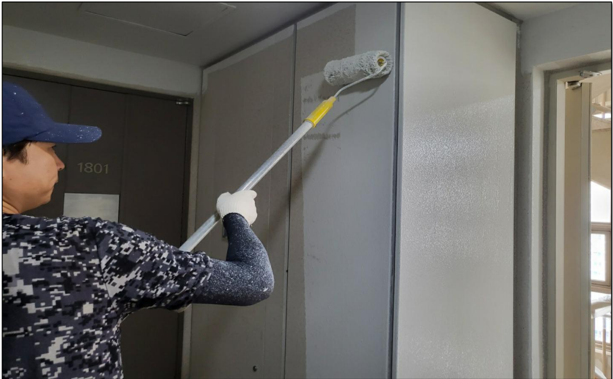
공용계단실 내부 수성페인트 도장
