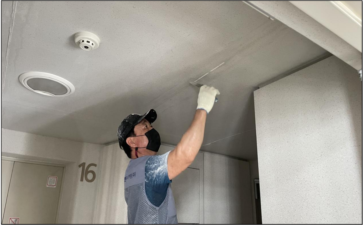
공용계단실 내부 계링 작업
