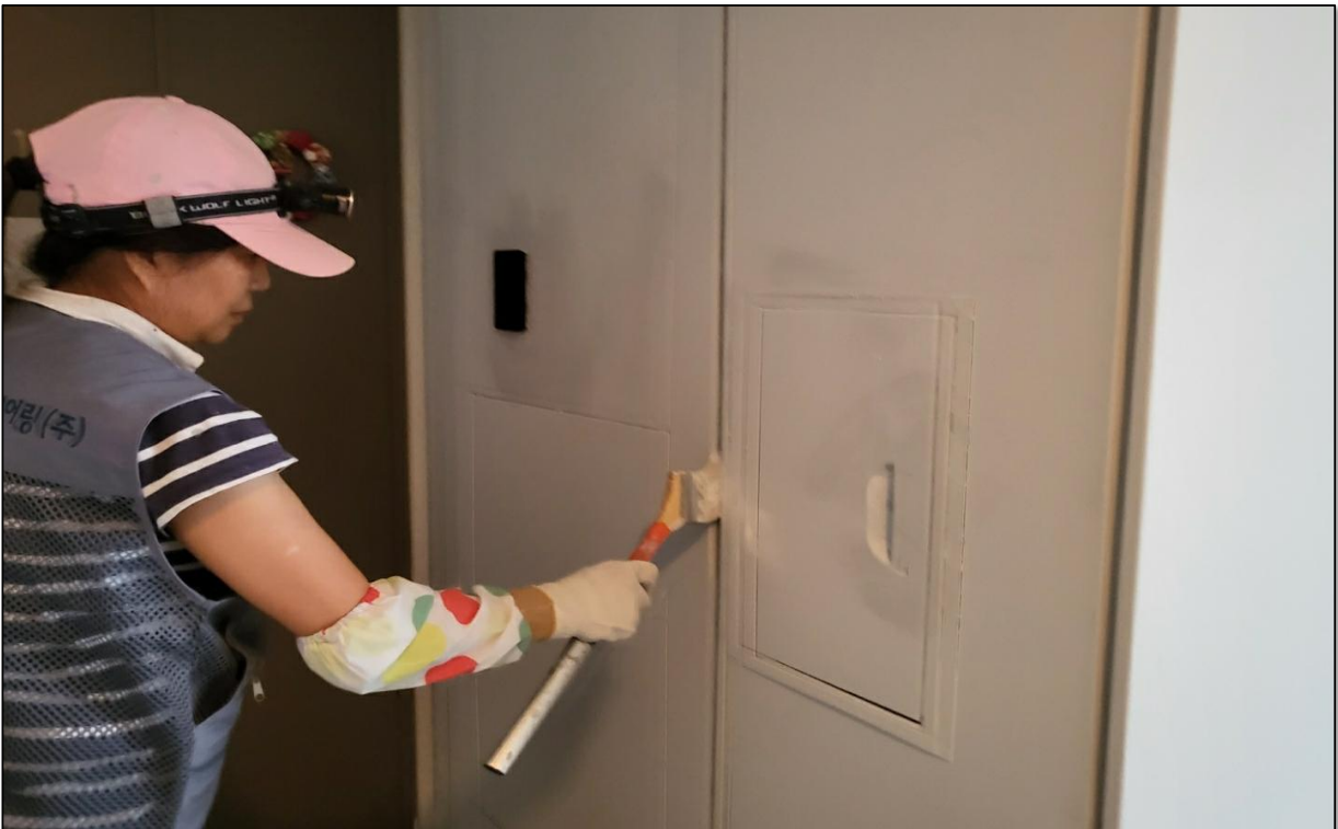
공용계단실 내부 수성페인트 도장
