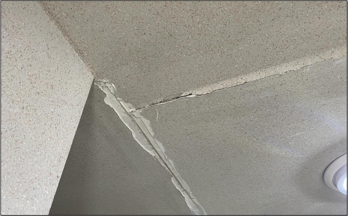
공용계단실 내부 계링 작업
