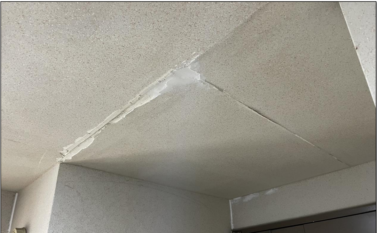
공용계단실 내부 계링 작업
