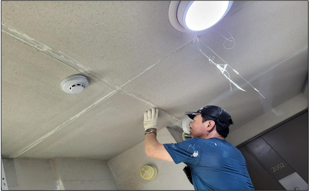
엘리베이터홀 천장 균열보수 전 망사테이프 시공
