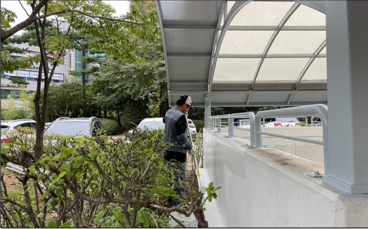
지하주차장 램프 도장
