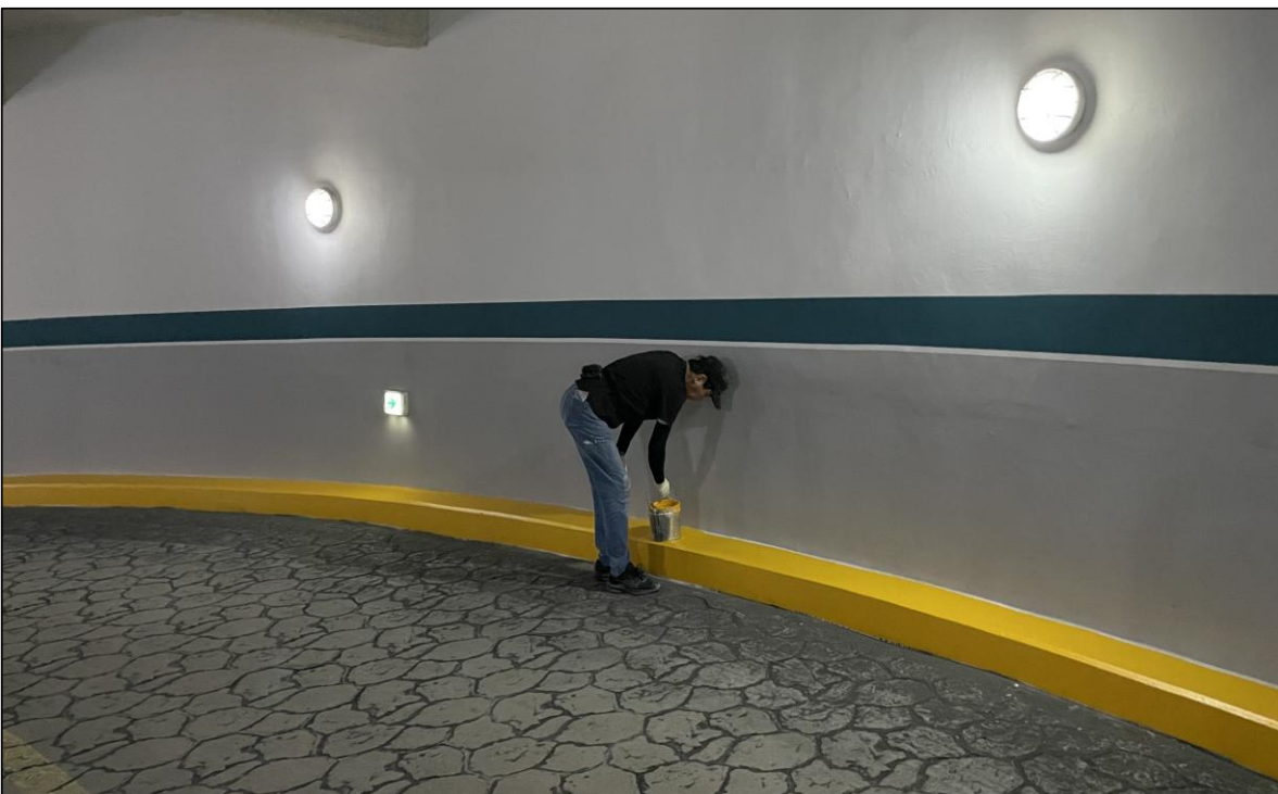
지하주차장 내부 수성페인트 도장
