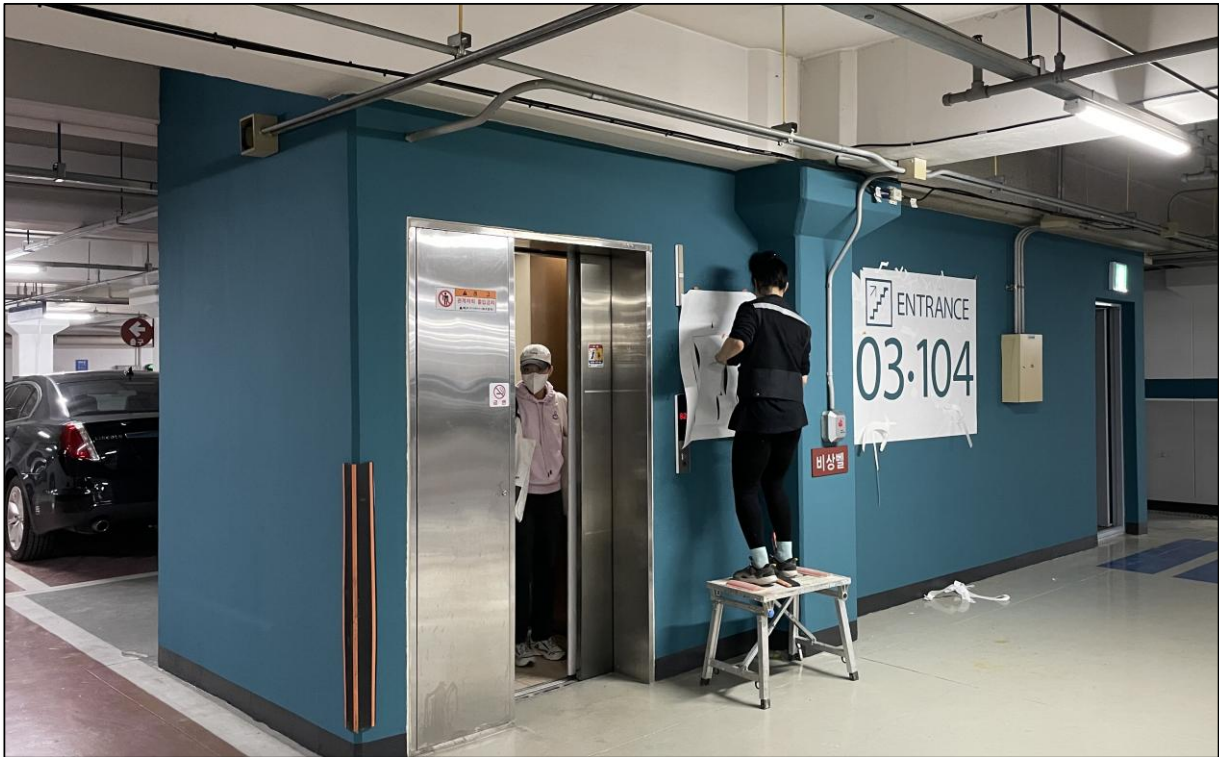
지하주차장 내부 그래픽 도장
