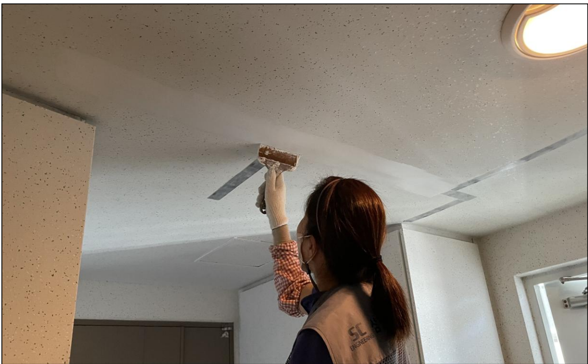
엘리베이터홀 천장 균열보수 전 망사테이프 시공
