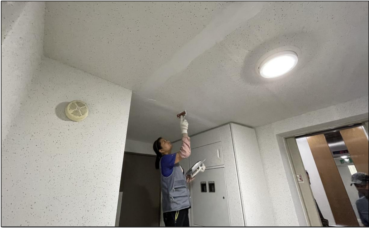
엘리베이터홀 천장 균열보수 전 망사테이프 시공
