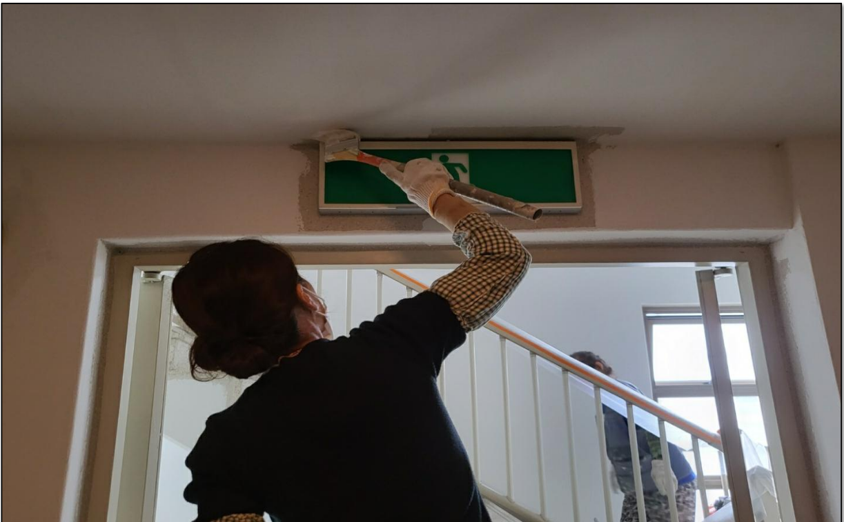
공용계단실 내부 수성페인트 도장
