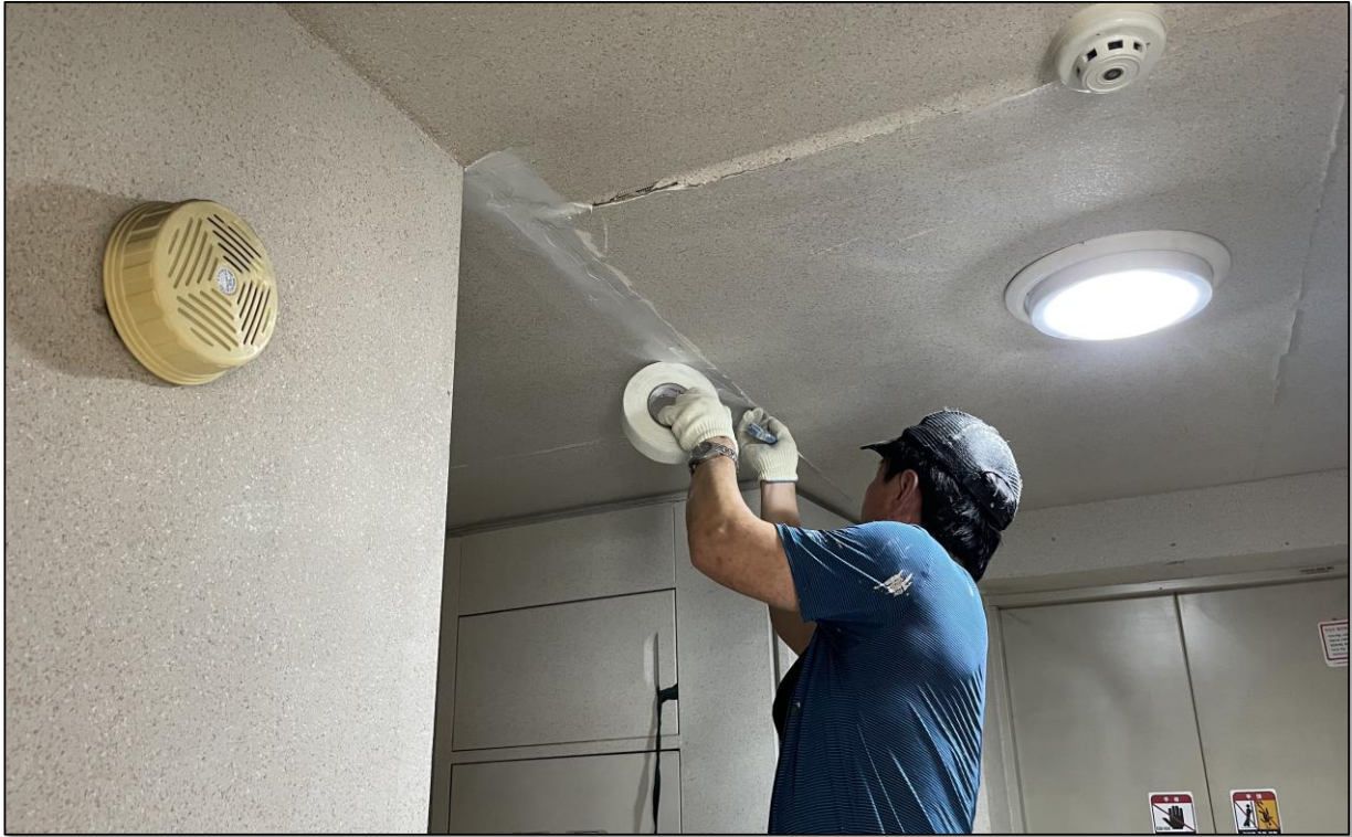
엘리베이터홀 천장 균열보수 전 망사테이프 시공
