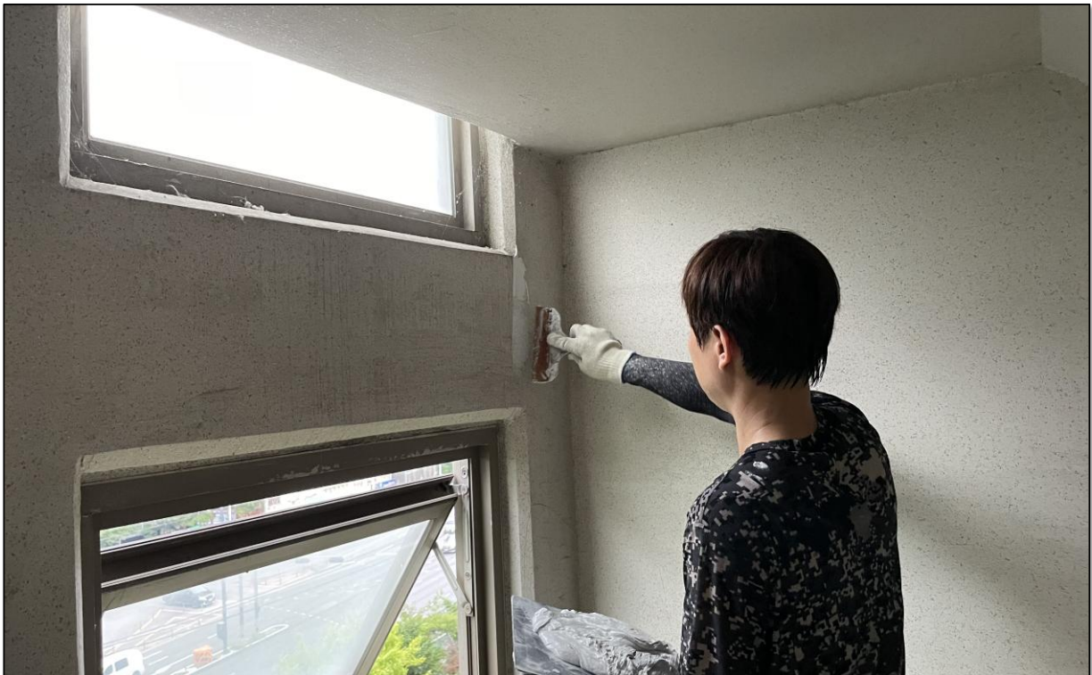
공용계단실 내부 균열보수
