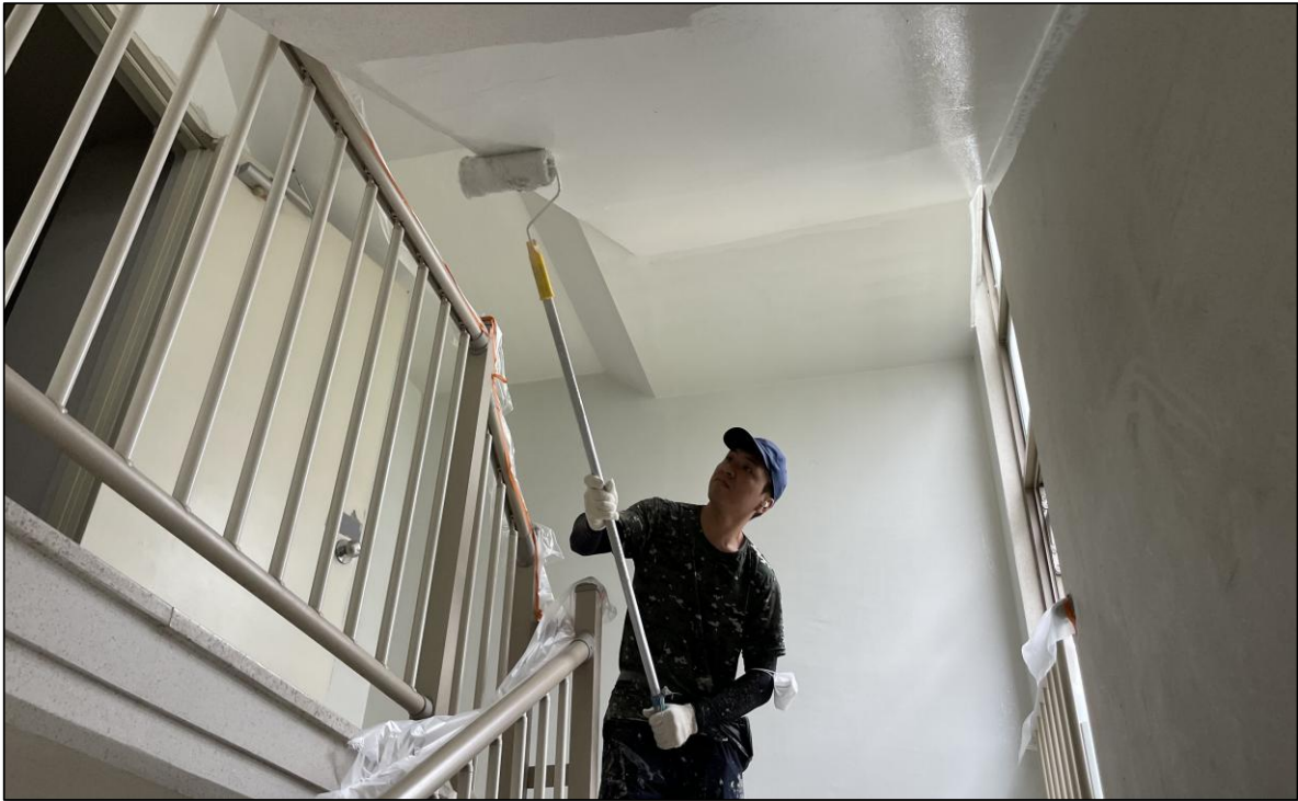
공용계단실 내부 수성페인트 도장
