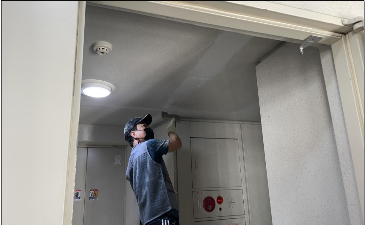
공용계단실 내부 균열보수
