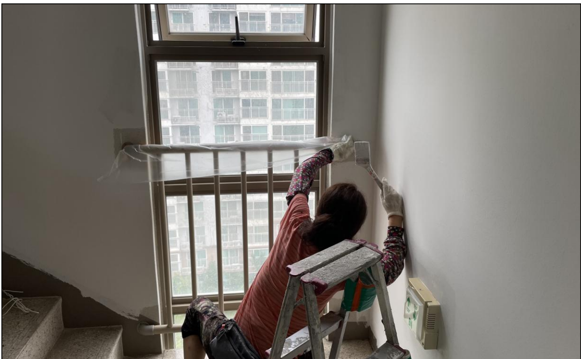
공용계단실 내부 수성페인트 도장
