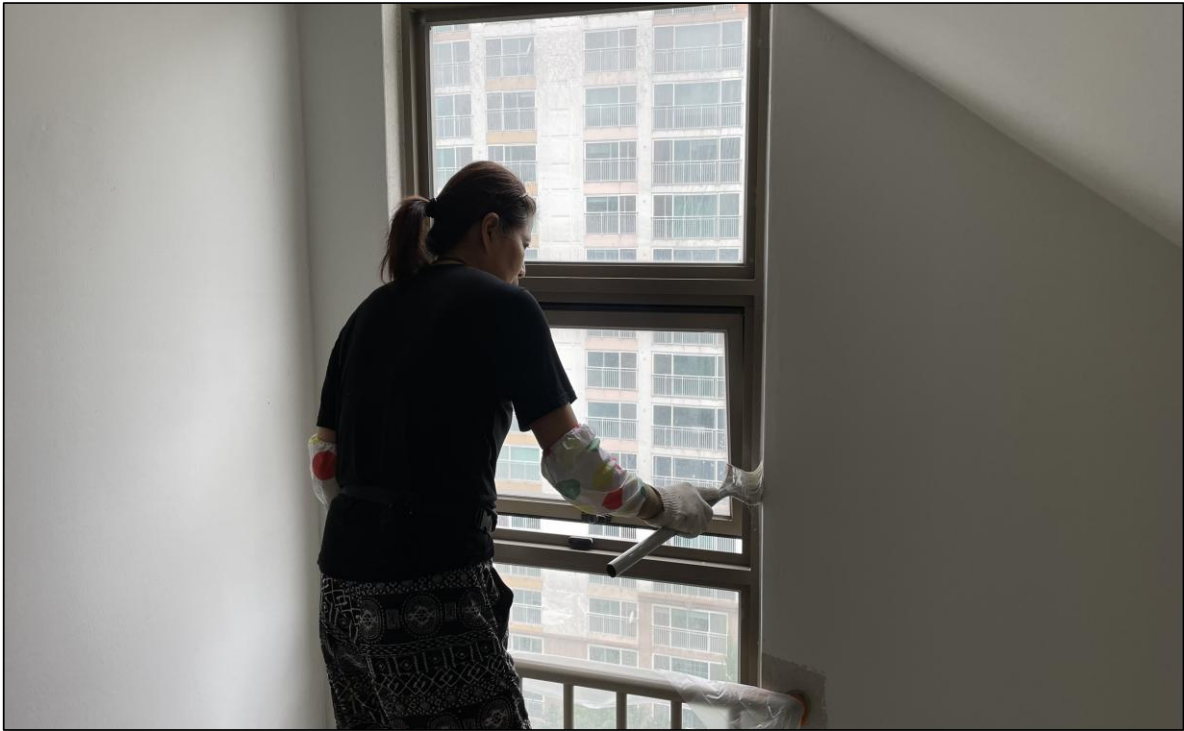
공용계단실 내부 수성페인트 도장
