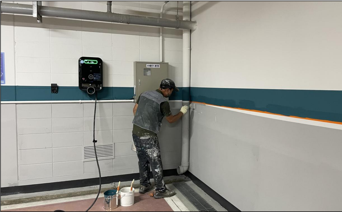
지하주차장 내부 수성페인트 도장
