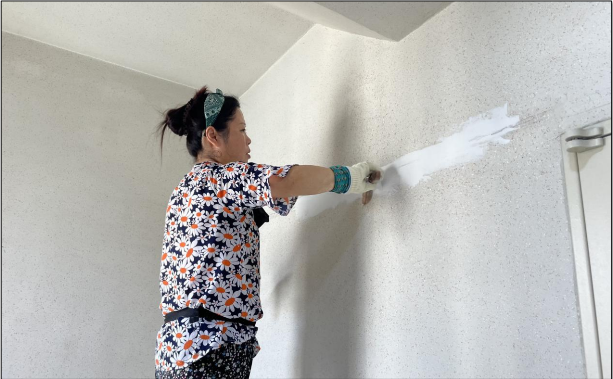
공용계단실 내부 균열보수
