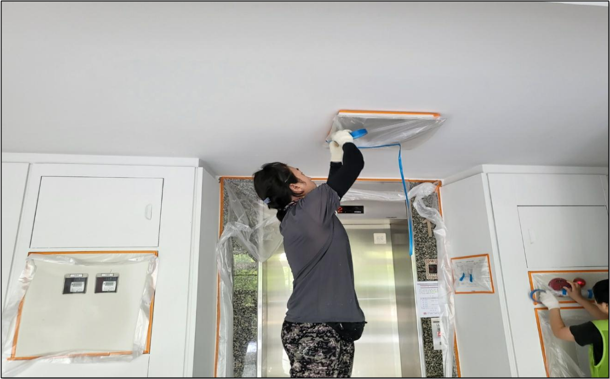
공용계단실 내부 무늬코트 뿔칠 전 보양작업
