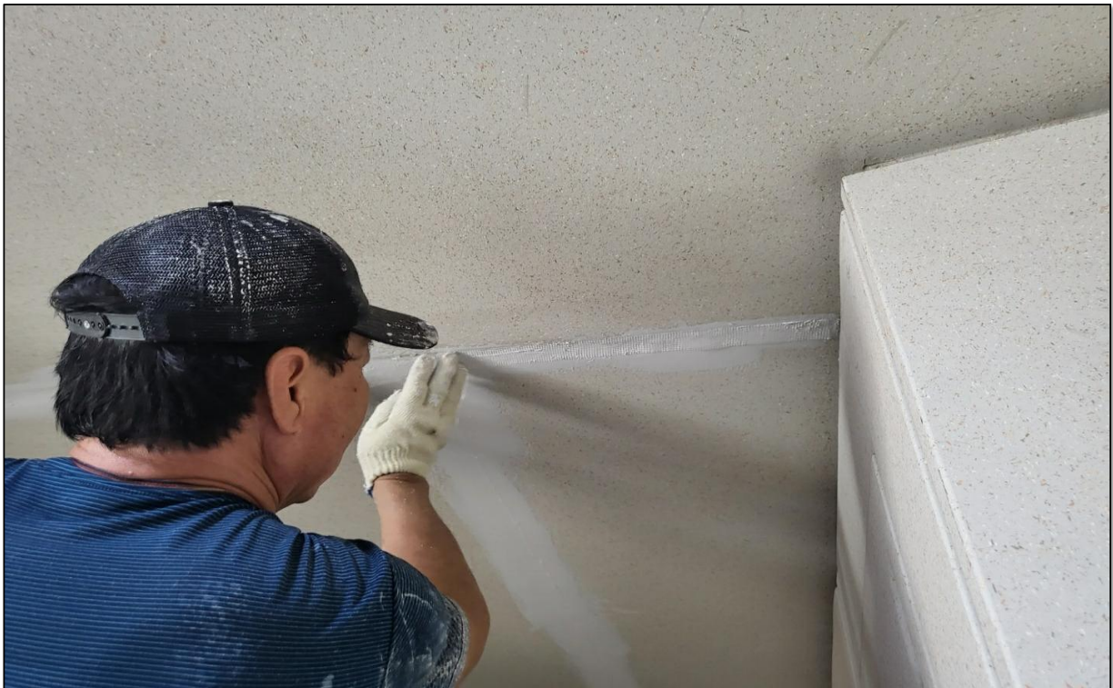
엘리베이터홀 천장 균열보수 전 망사테이프 시공
