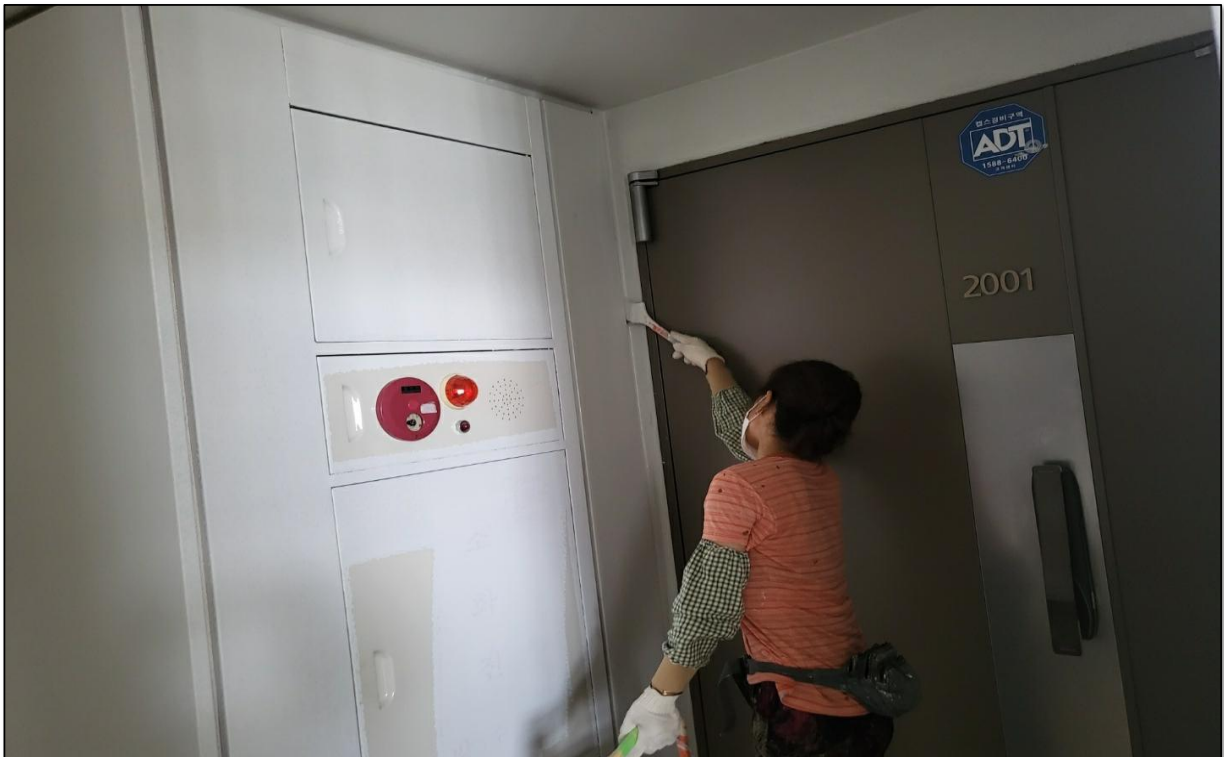
공용계단실 내부 수성페인트 도장
