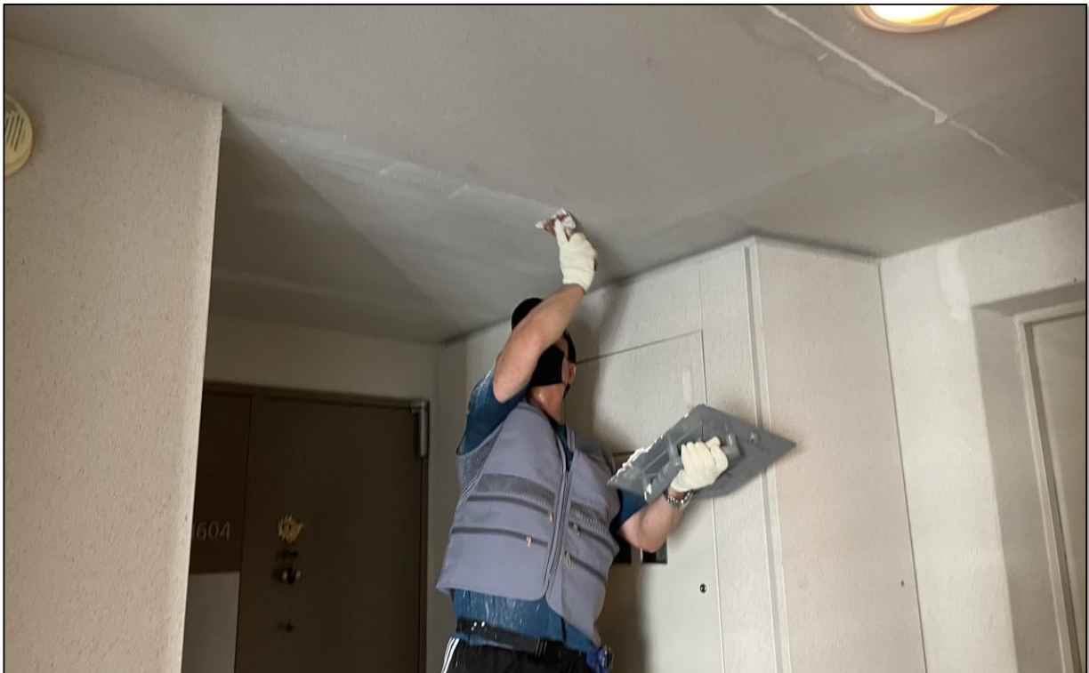
공용계단실 내부 균열보수
