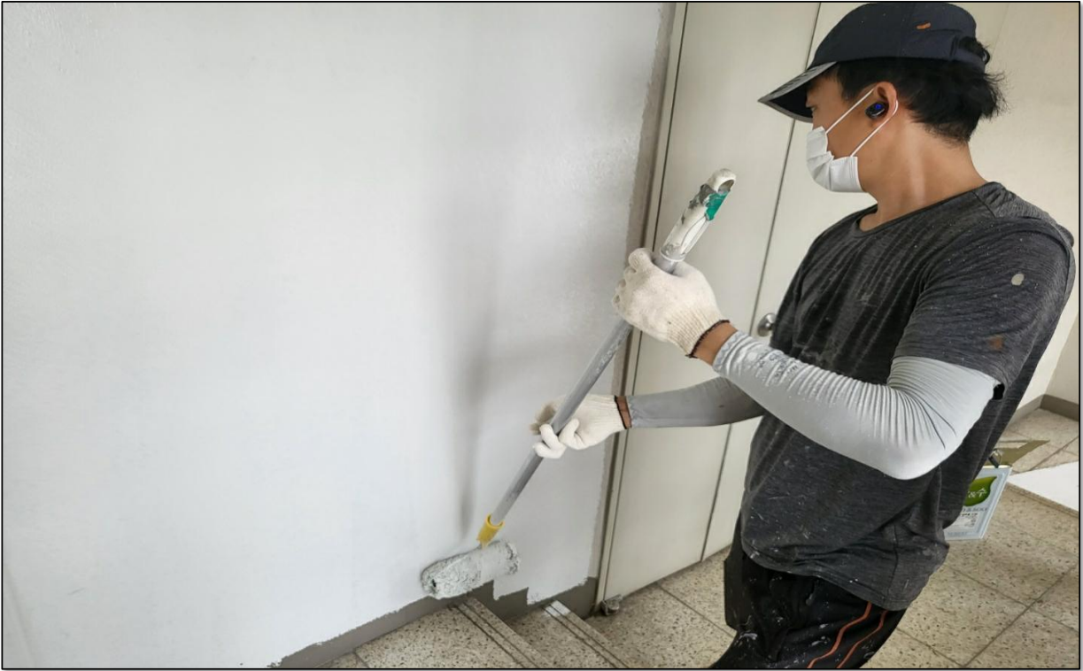
공용계단실 내부 수성페인트 도장
