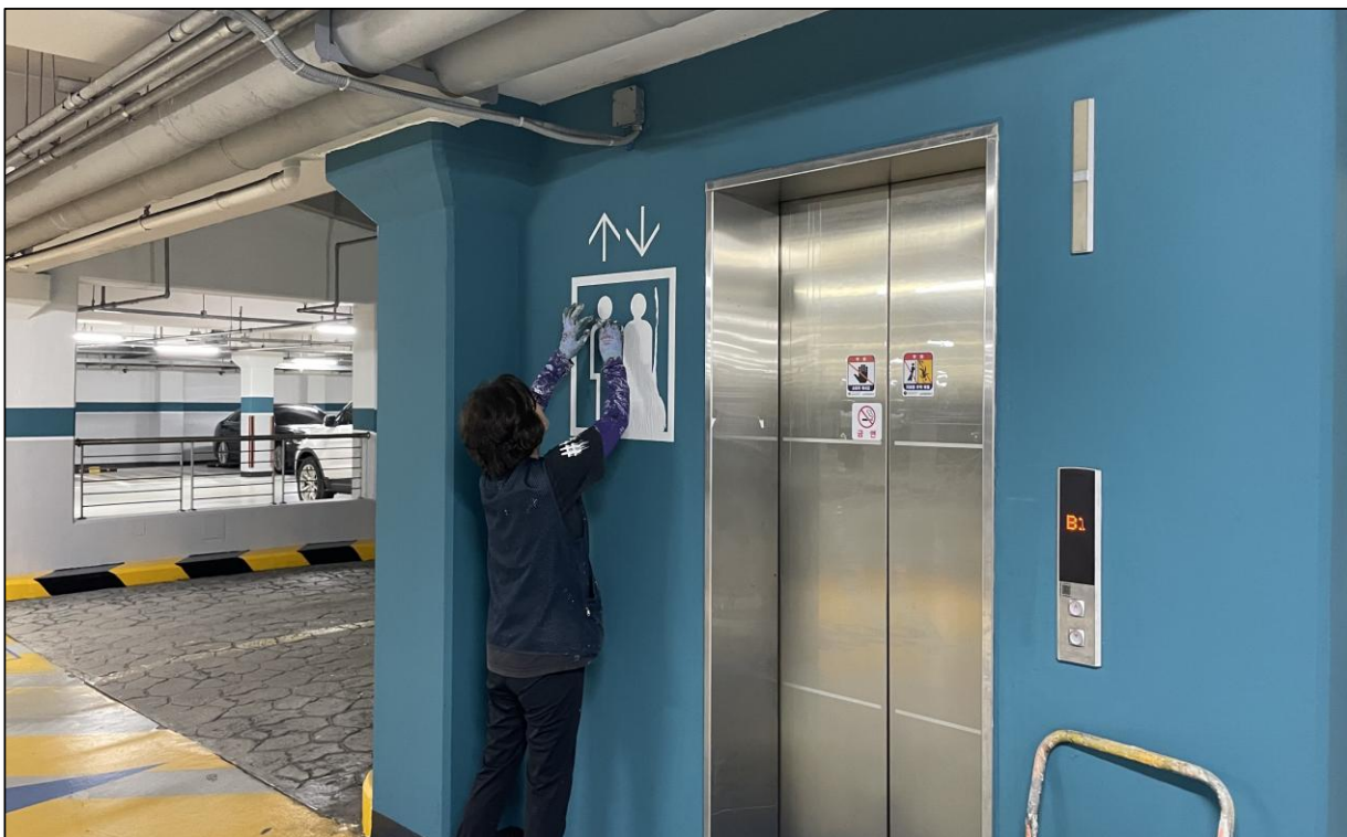
지하주차장 내부 그래픽 도장
