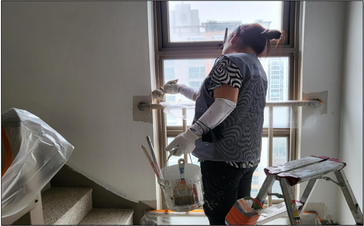
공용계단실 내부 수성페인트 도장
