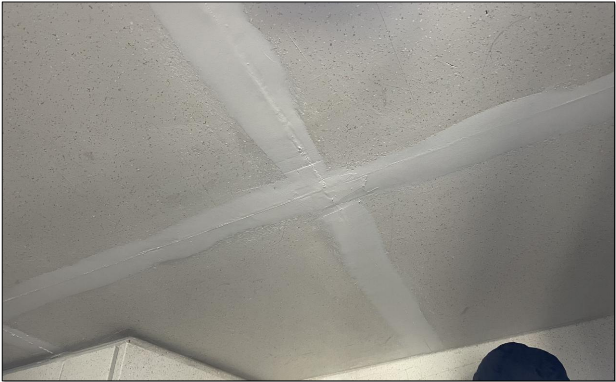
공용계단실 내부 균열보수
