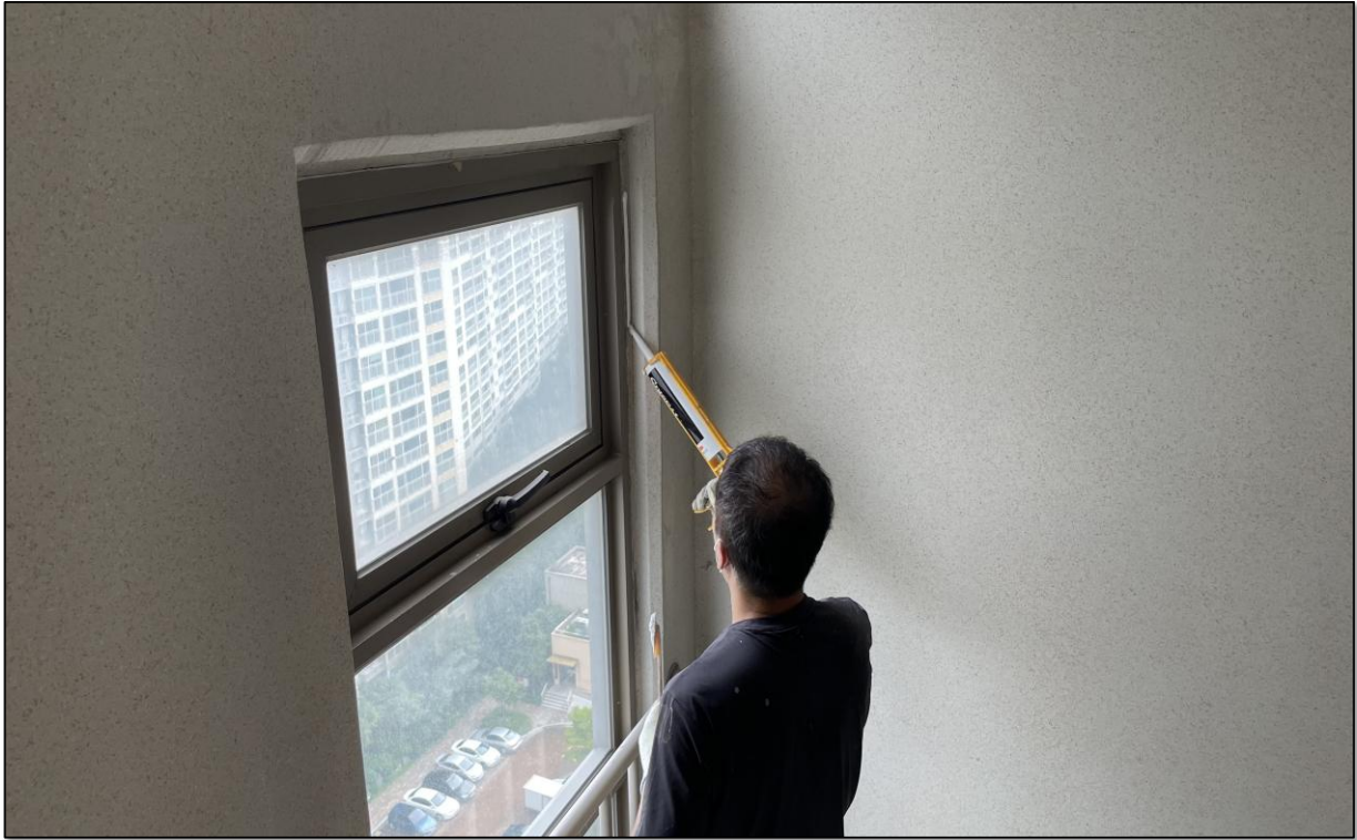
공용계단실 내부 균열보수
