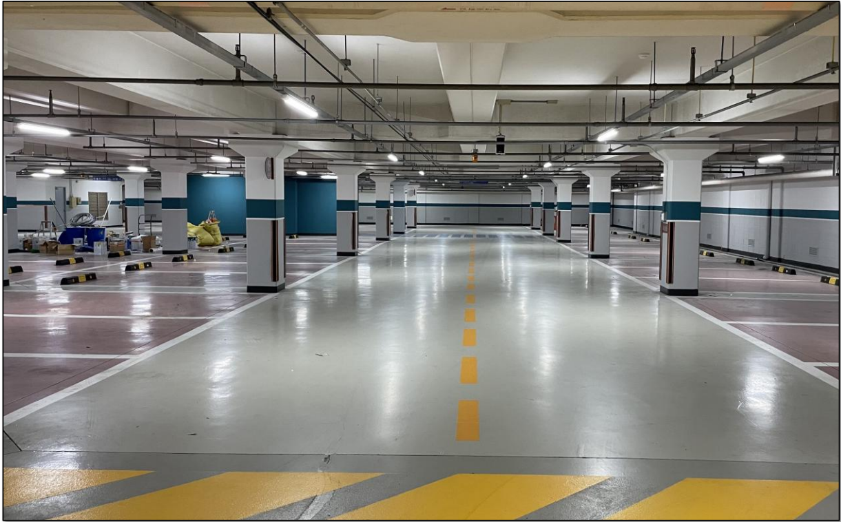
지하주차장 내부 수성페인트 도장
