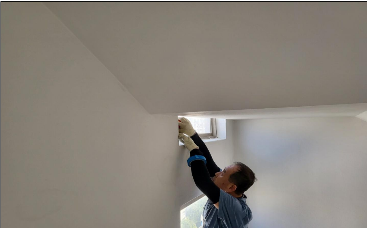
공용계단실 내부 무늬코트 뿔칠 전 보양작업
