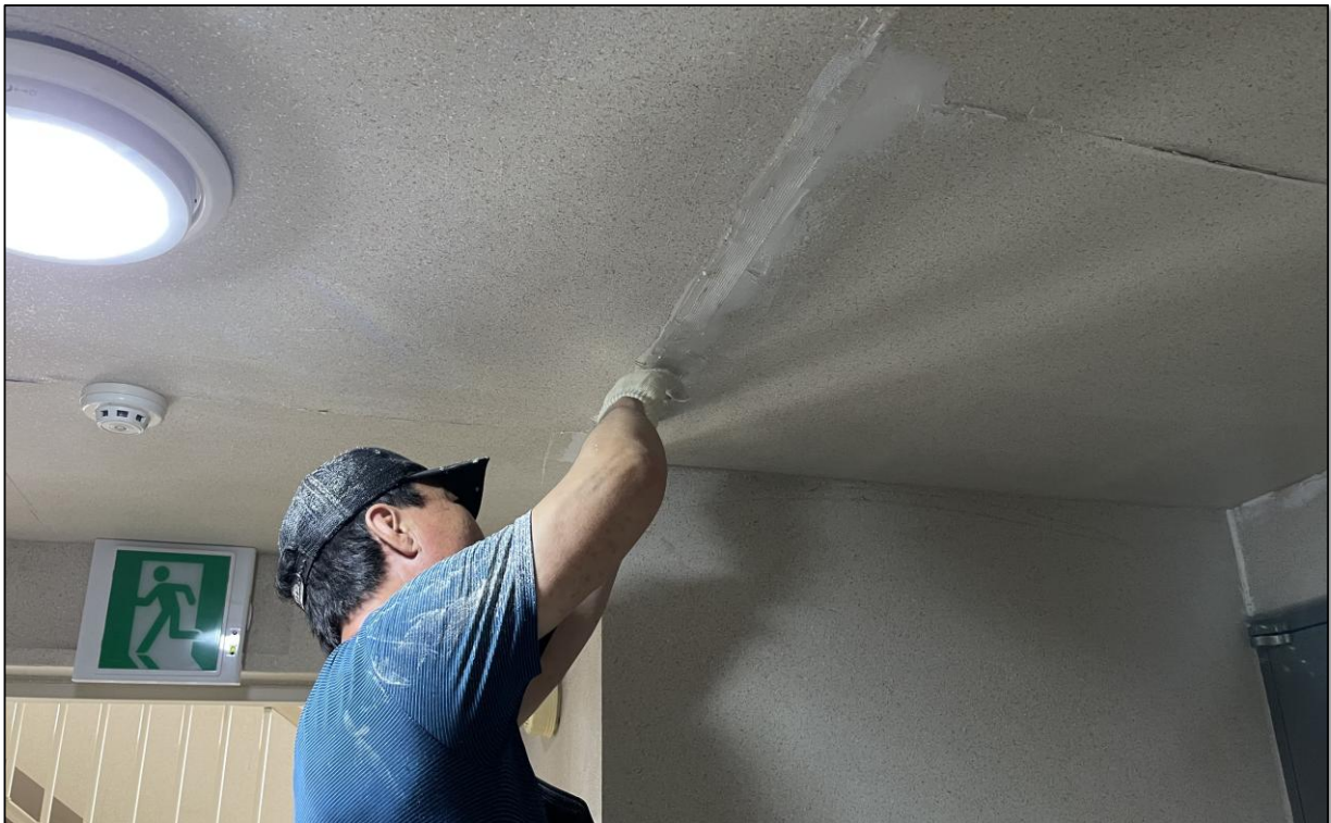
엘리베이터홀 천장 균열보수 전 망사테이프 시공
