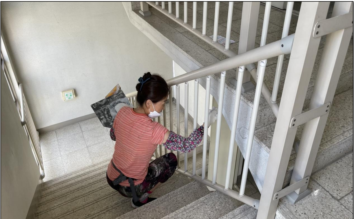
공용계단실 내부 균열보수
