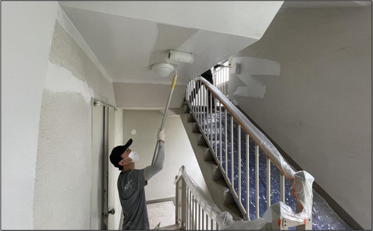
공용계단실 내부 수성페인트 도장
