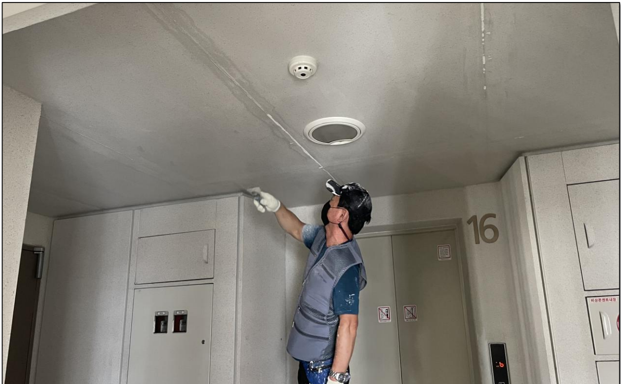
공용계단실 내부 계링 작업
