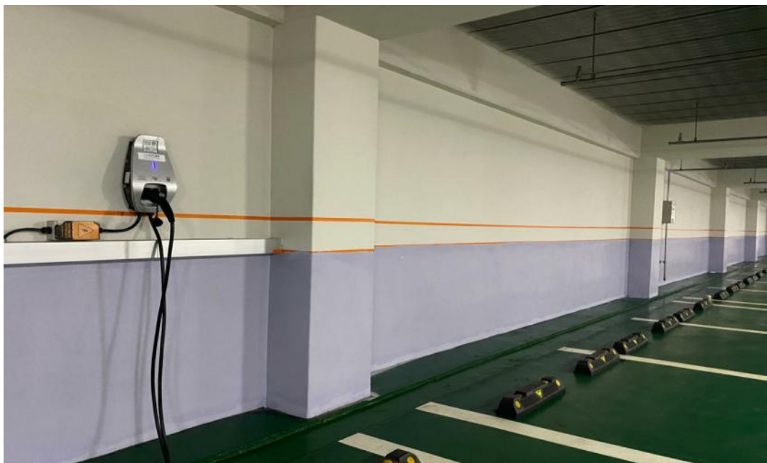
공사중 (지하주차장 수성페인트 작업)
