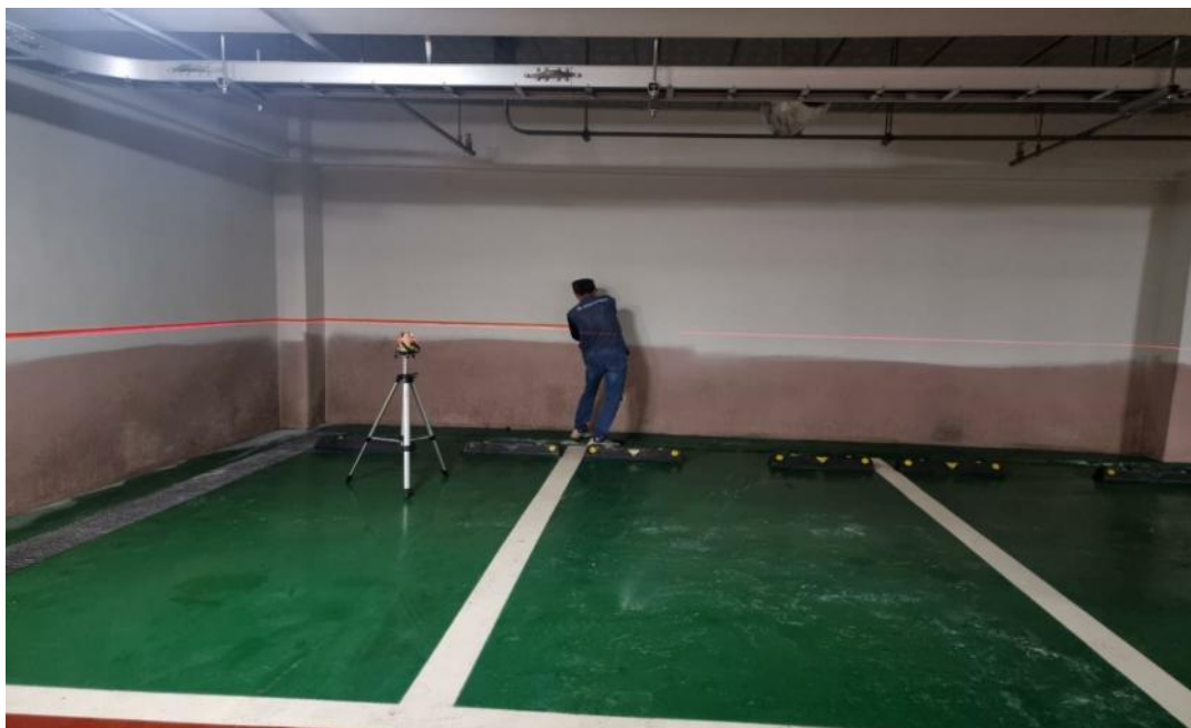
공사중 (지하주차장 테이프 작업)
