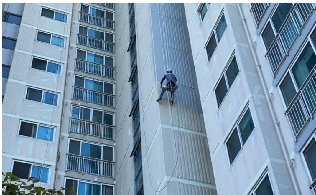
공사중 (수성페인트 작업)
