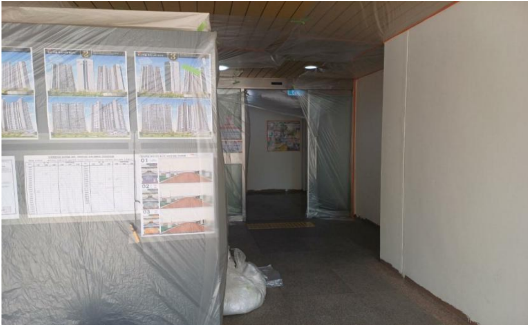
공사중 (뿔칠 전 보강작업)
