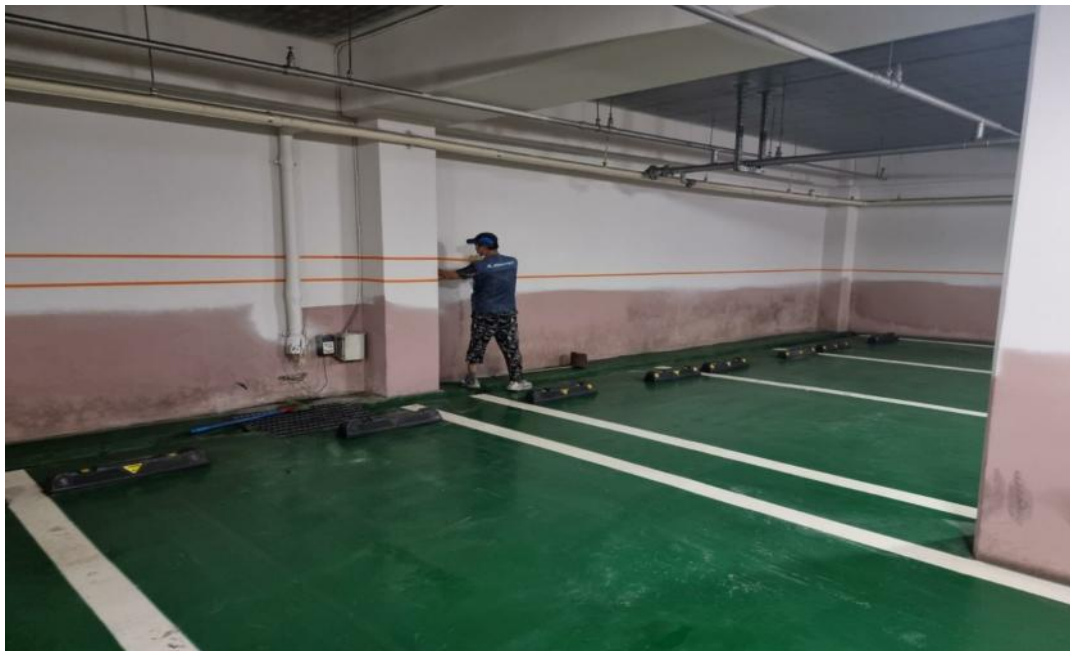
공사중 (지하주차장 테이프 작업)
