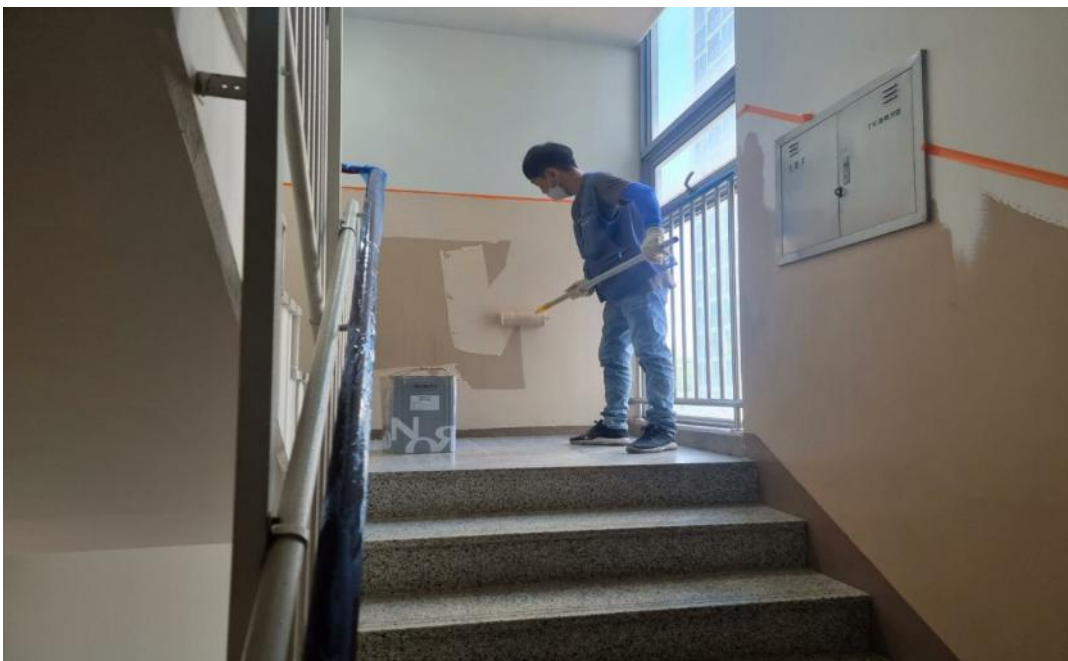
공사중 (수성페인트 작업)
