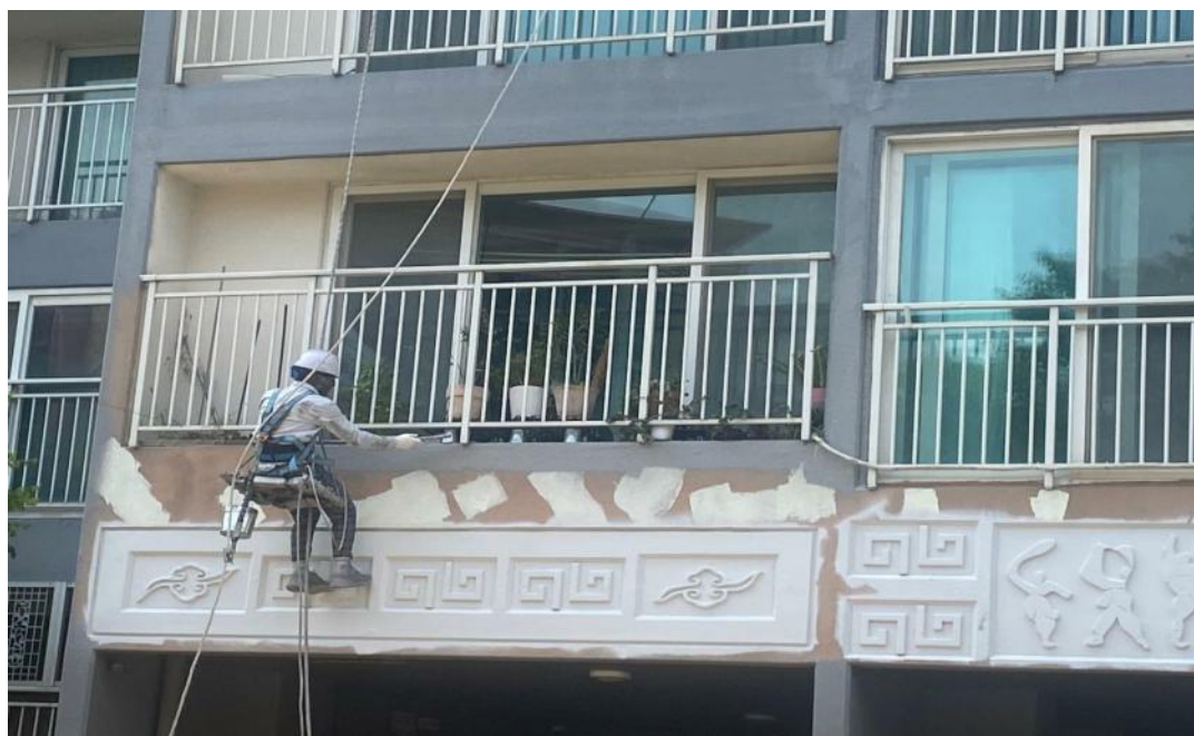
공사중 (수성페인트 작업)
