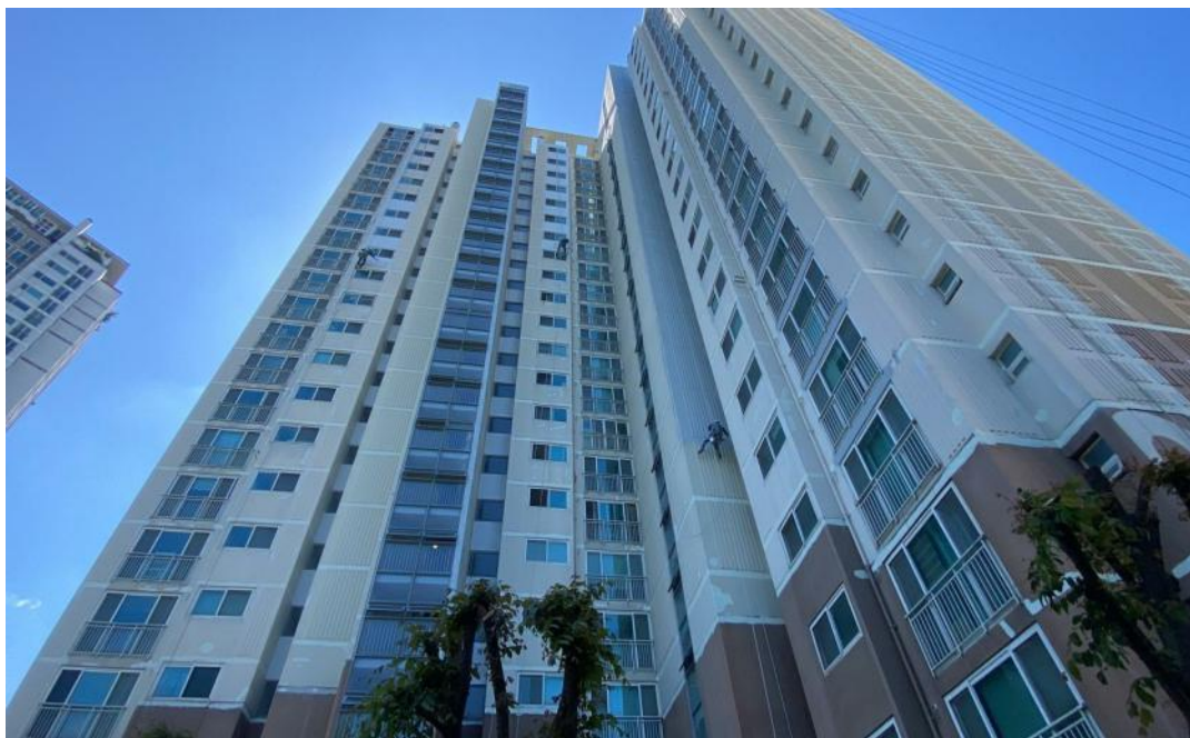
공사중 (수성페인트 작업)
