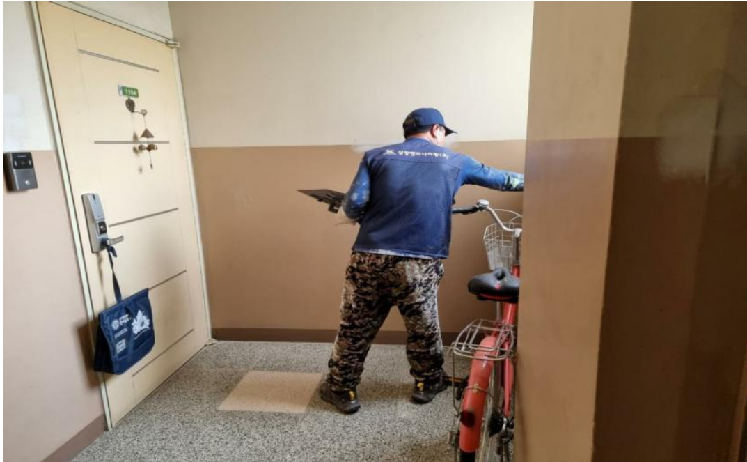
공사중 (내부 균열보수)
