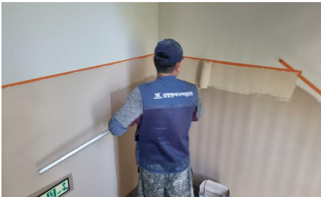
공사중 (수성페인트 작업)
