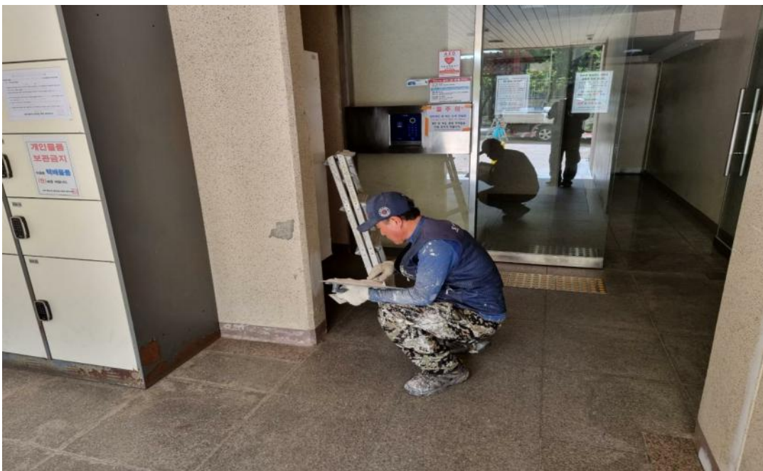
공사중 (내부 균열보수)
