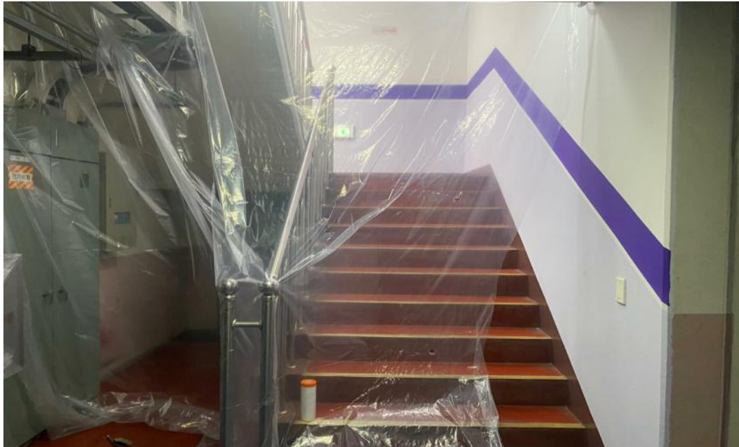
공사중 (지하주차장 보양 작업)
