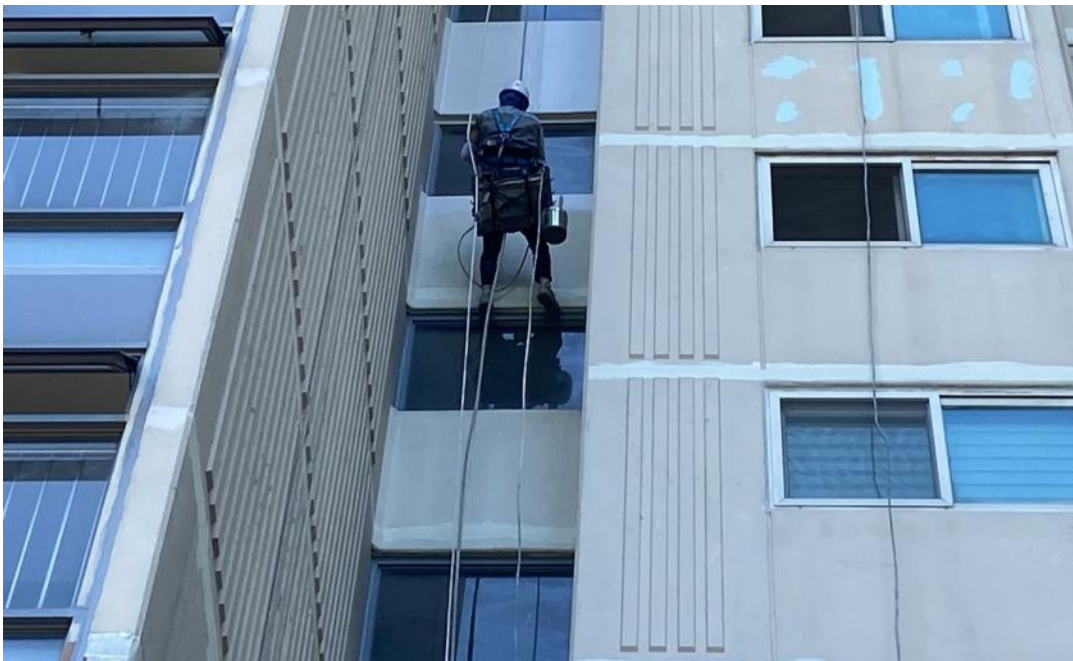
공사중 (수성페인트 작업)
