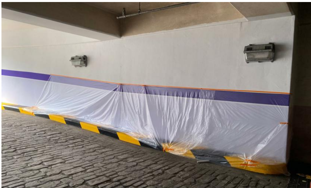
공사중 (지하주차장 보양 작업)
