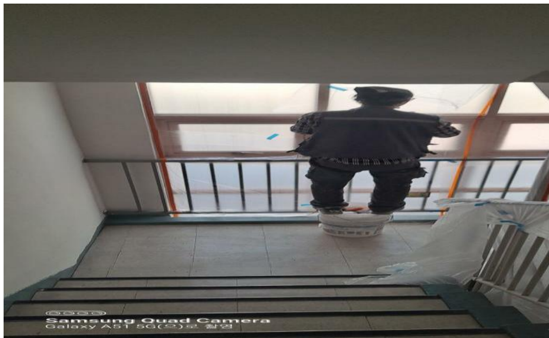
공사중 (뽐칠 전 보강작업)
