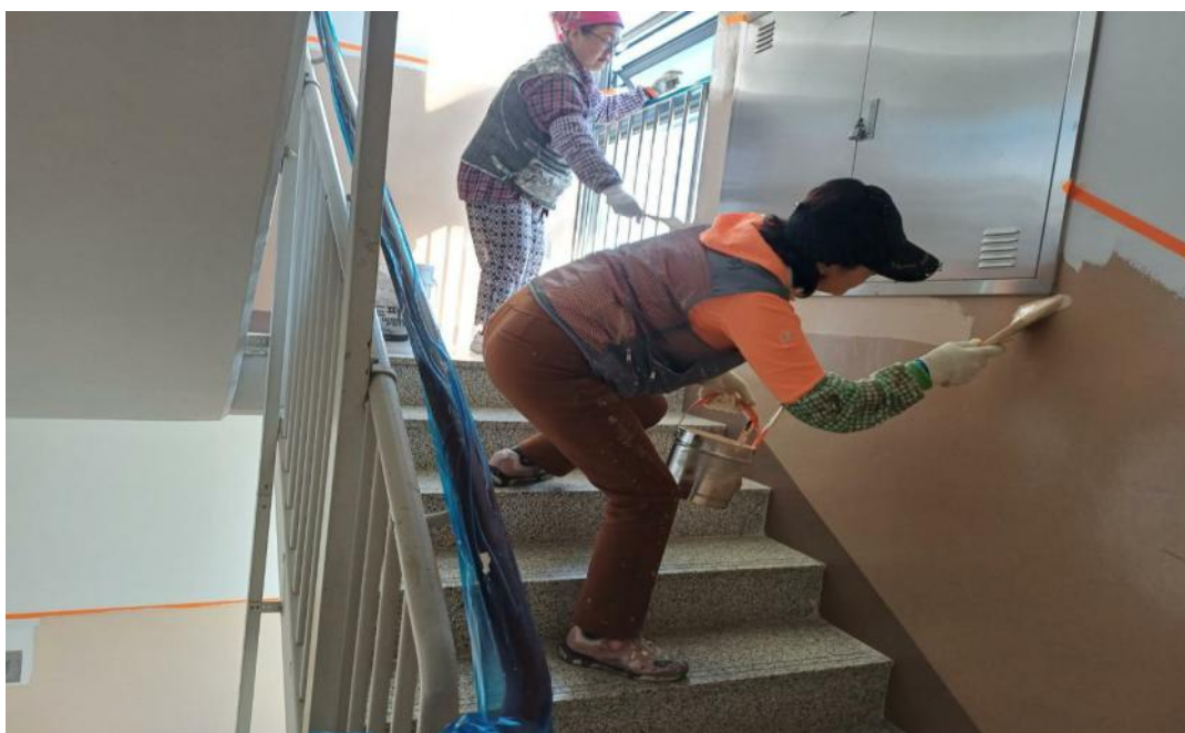
공사중 (수성페인트 작업)
