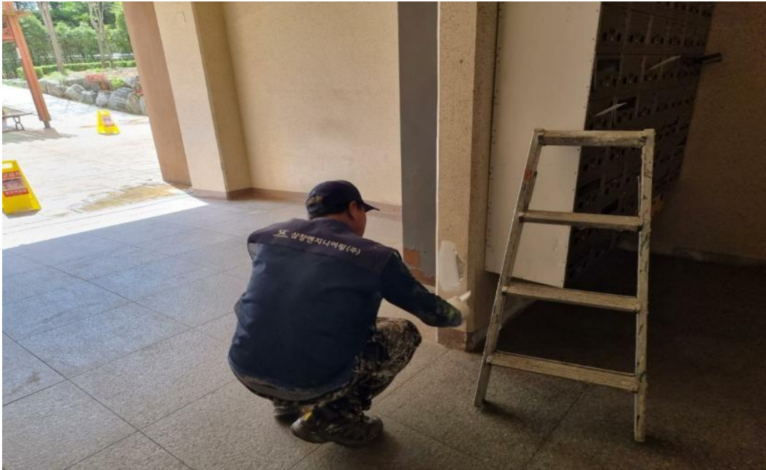
공사중 (내부 균열보수)
