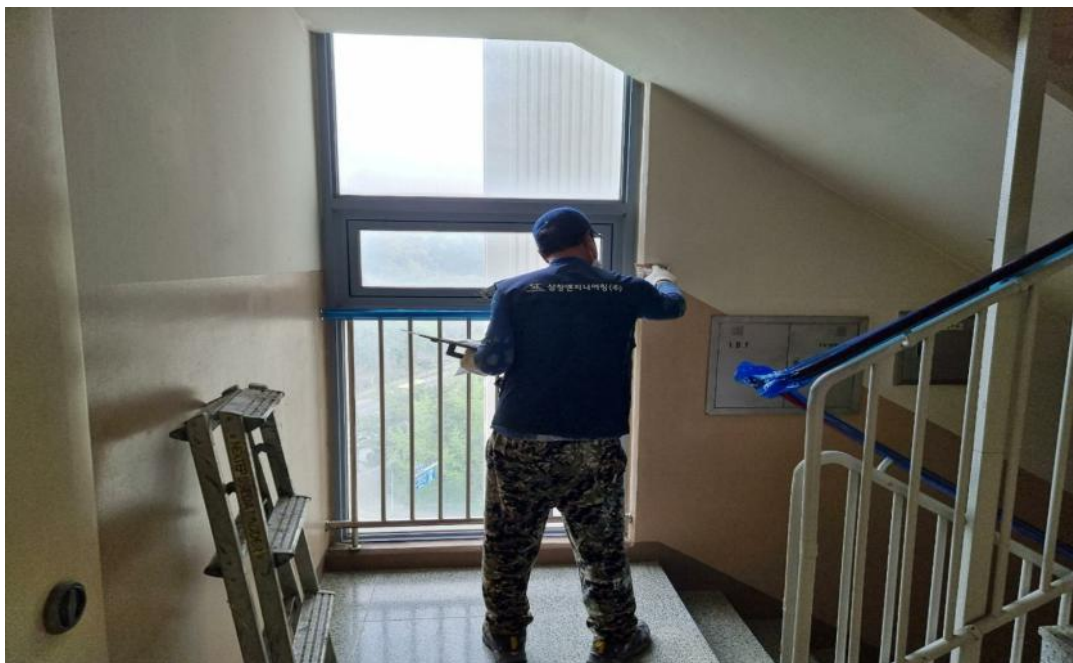
공사중 (내부 균열보수)
