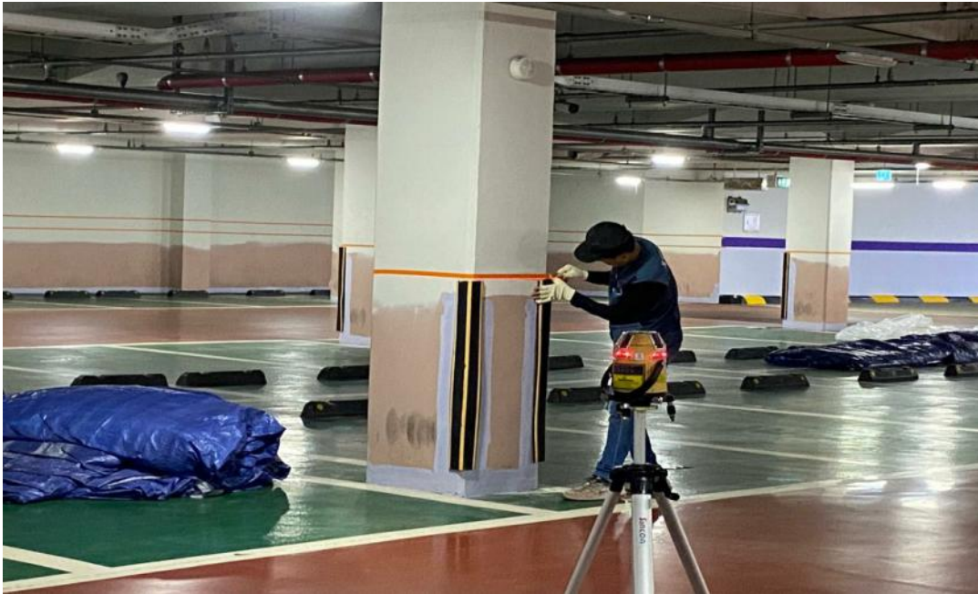
공사중 (지하주차장 테이프 작업)
