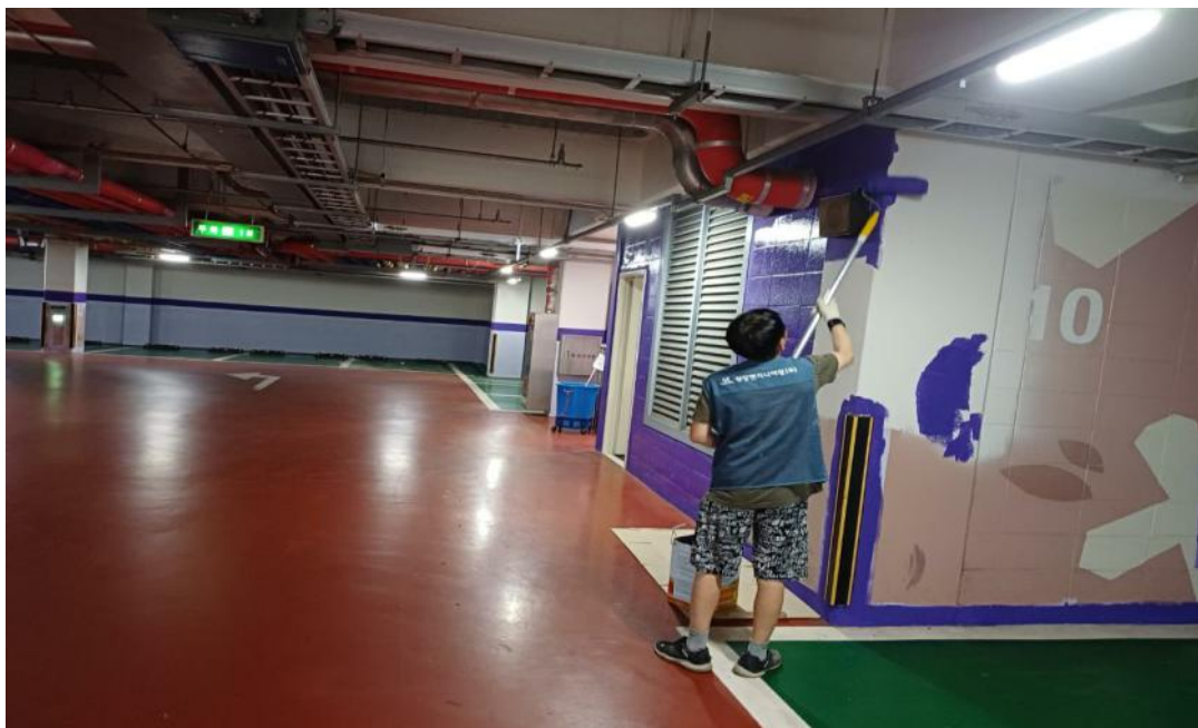
공사중 (지하주차장 수성페인트 작업)
