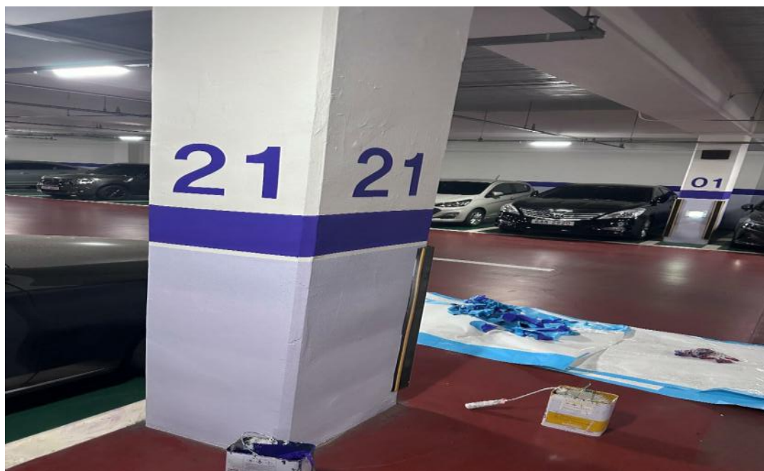
공사중 (지하주차장 그래픽 작업)
