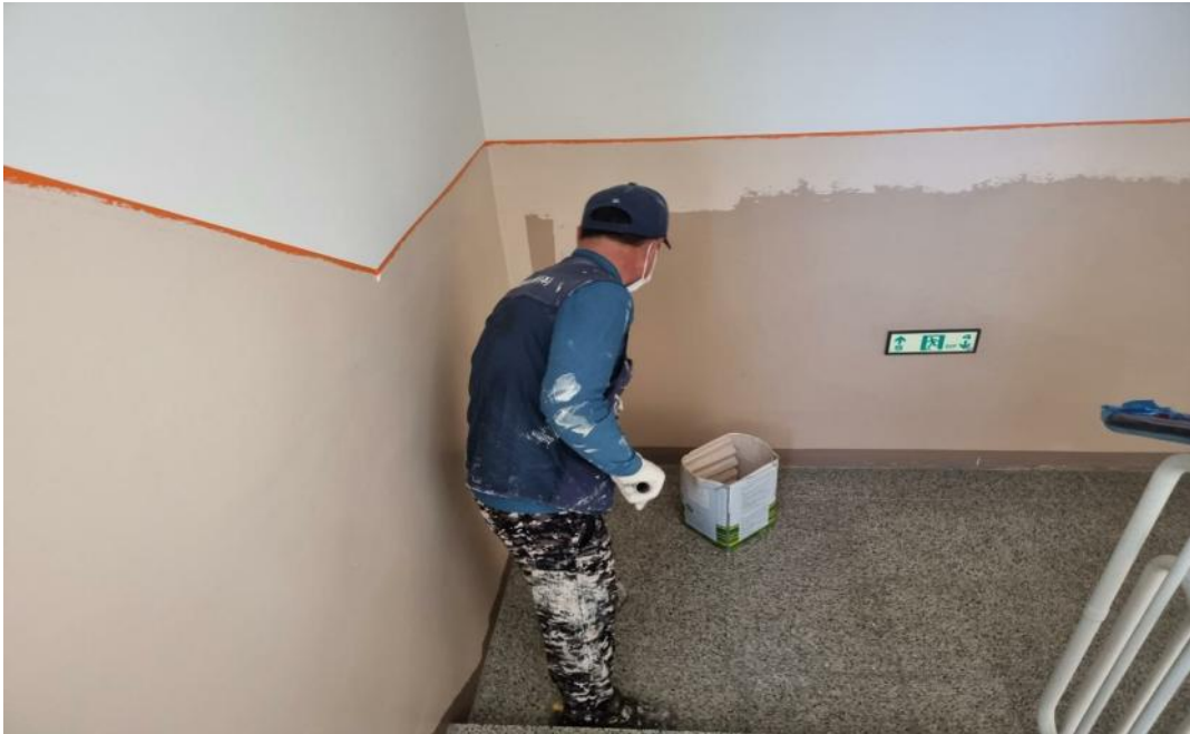
공사중 (수성페인트 작업)
