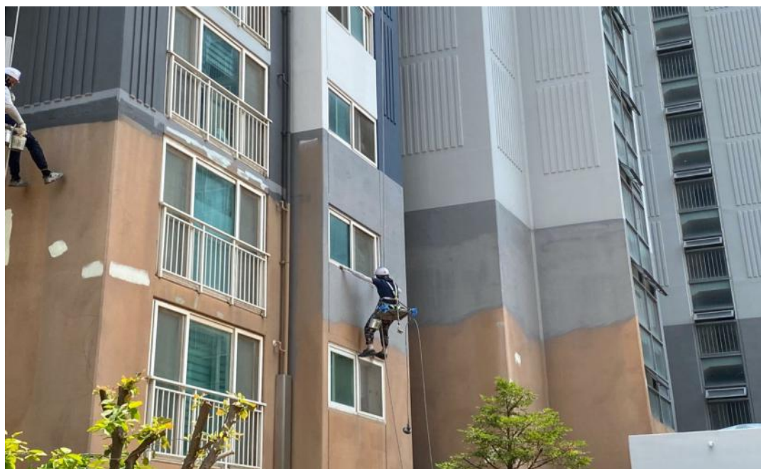
공사중 (수성페인트 작업)
