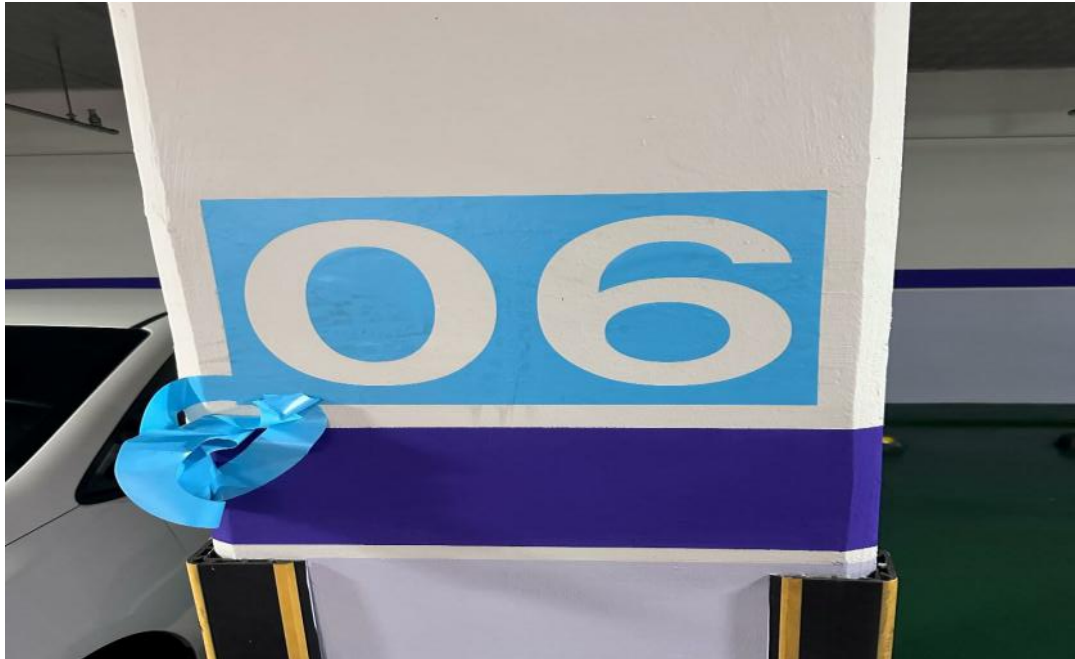
공사중 (지하주차장 그래픽 작업)
