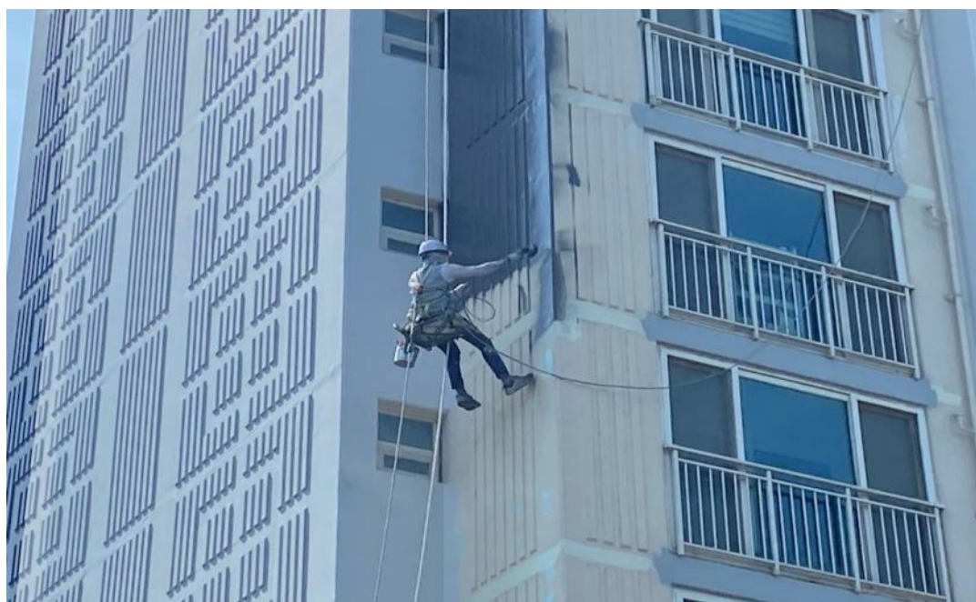
공사중 (수성페인트 작업)
