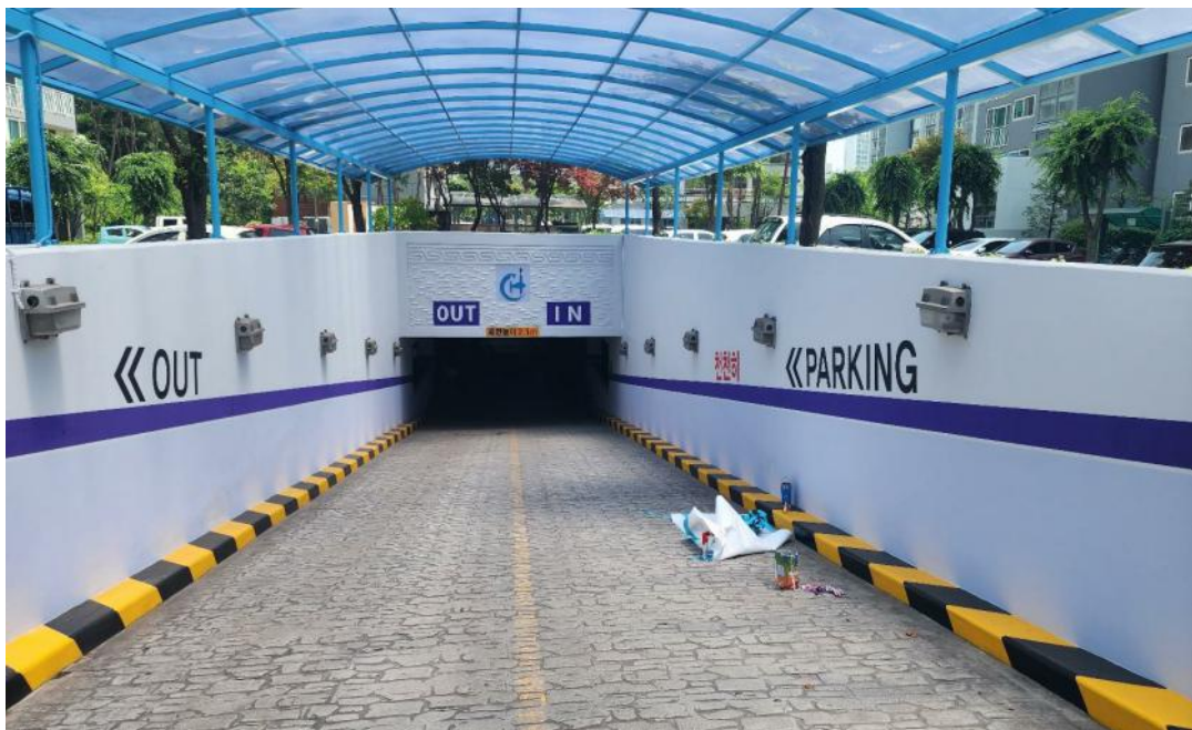
공사중 (지하주차장 그래픽 작업)
