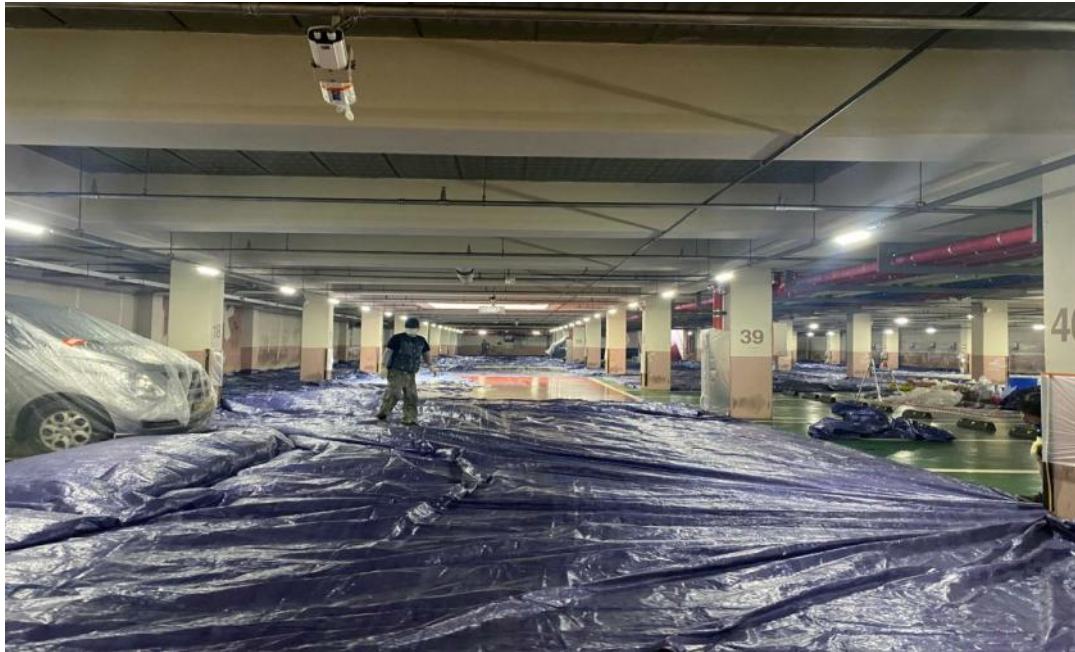
공사중 (지하주차장 보양 작업)
