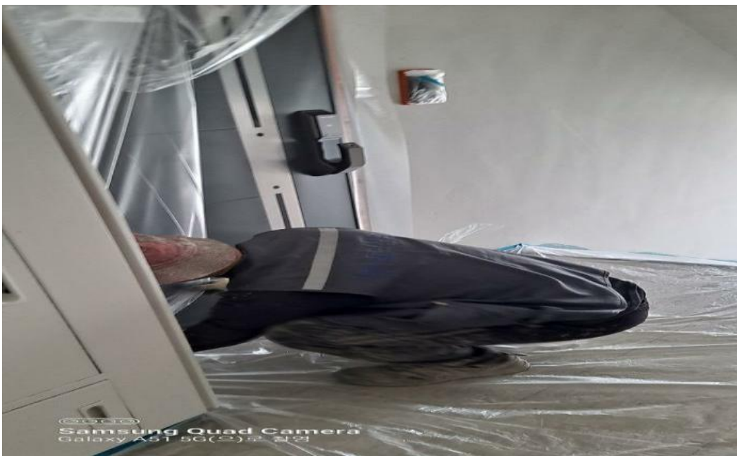
공사중 (뿔칠 전 보강작업)
