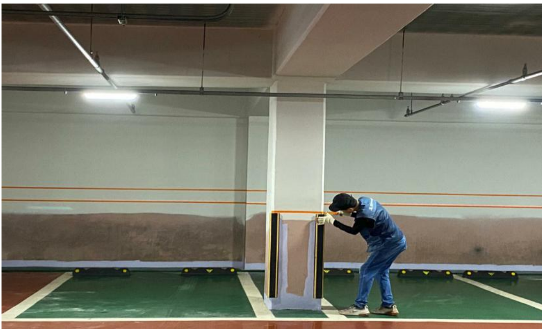
공사중 (지하주차장 테이프 작업)
