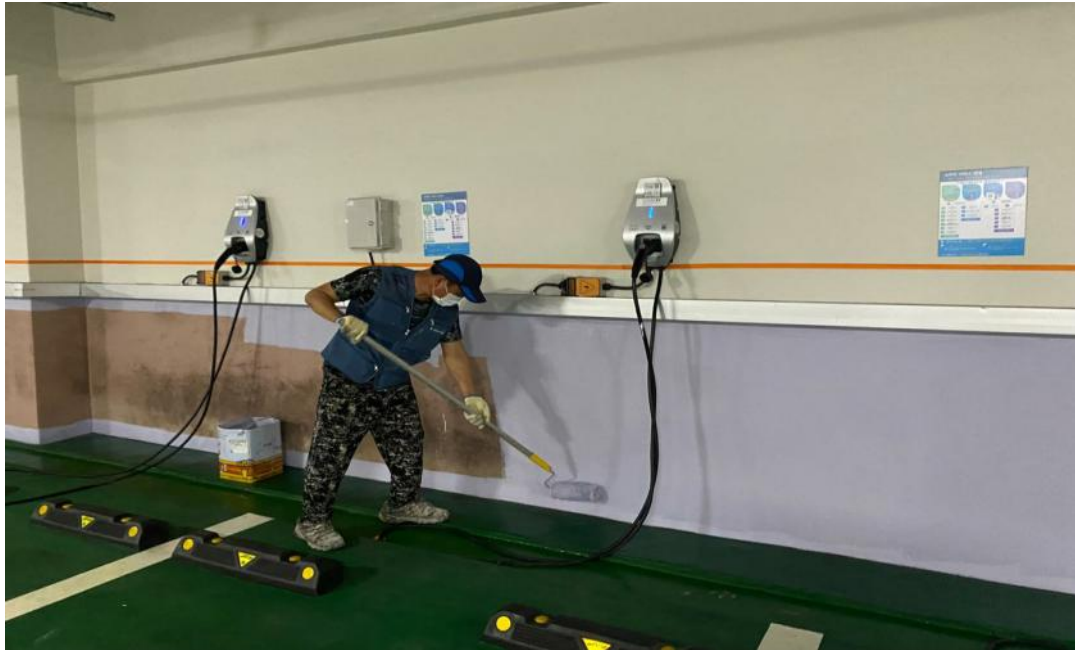
공사중 (지하주차장 수성페인트 작업)
