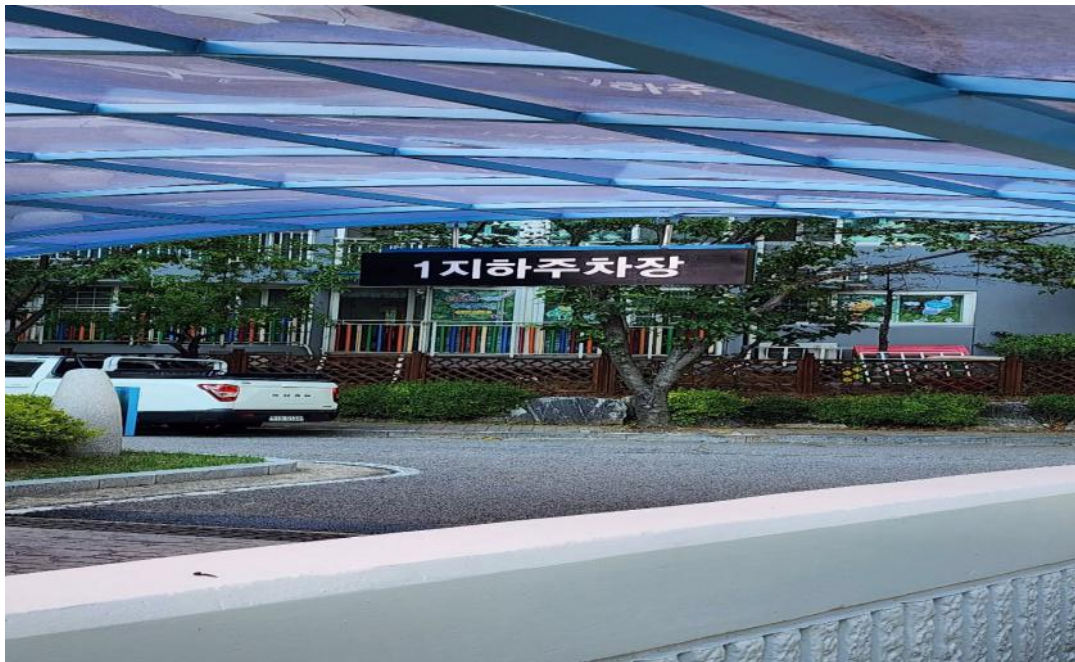
공사중 (지하주차장 그래픽 작업)
