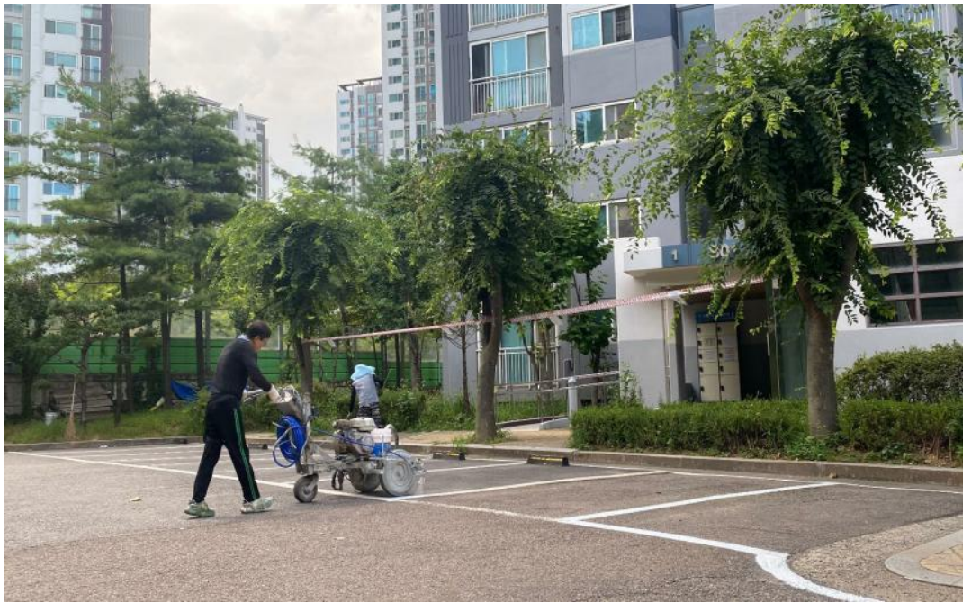
공사중 (지상주차선 작업)
