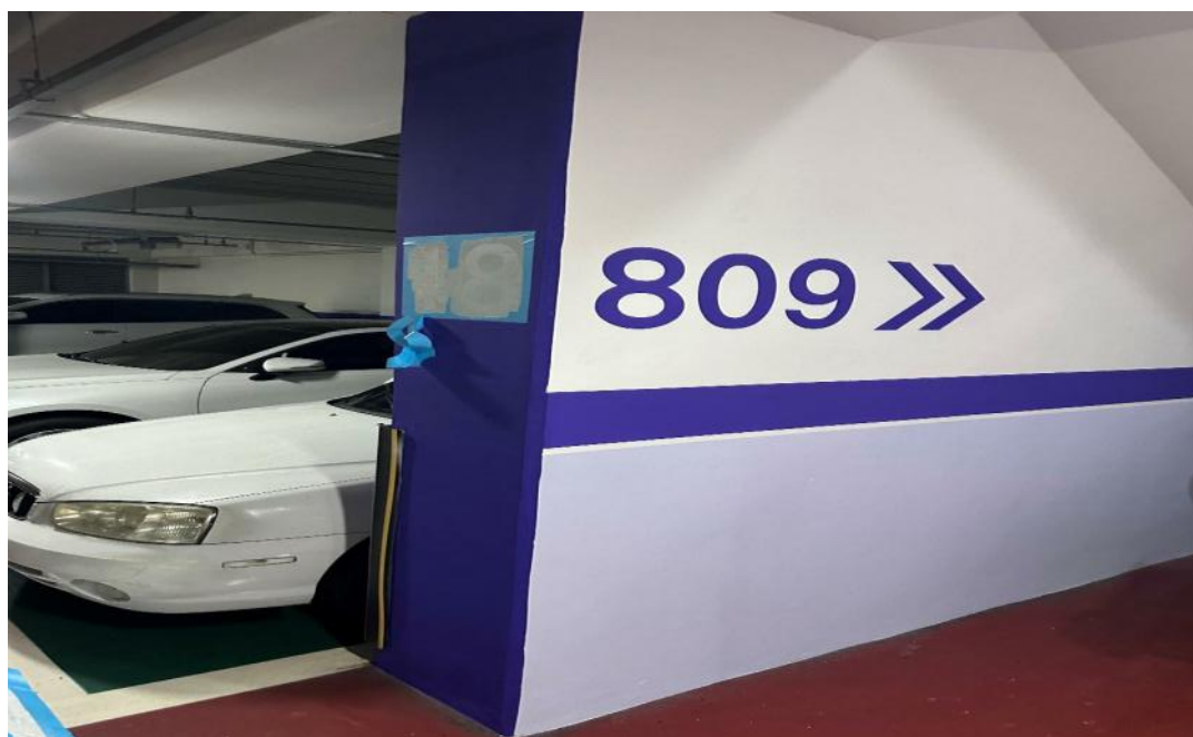
공사중 (지하주차장 그래픽 작업)
