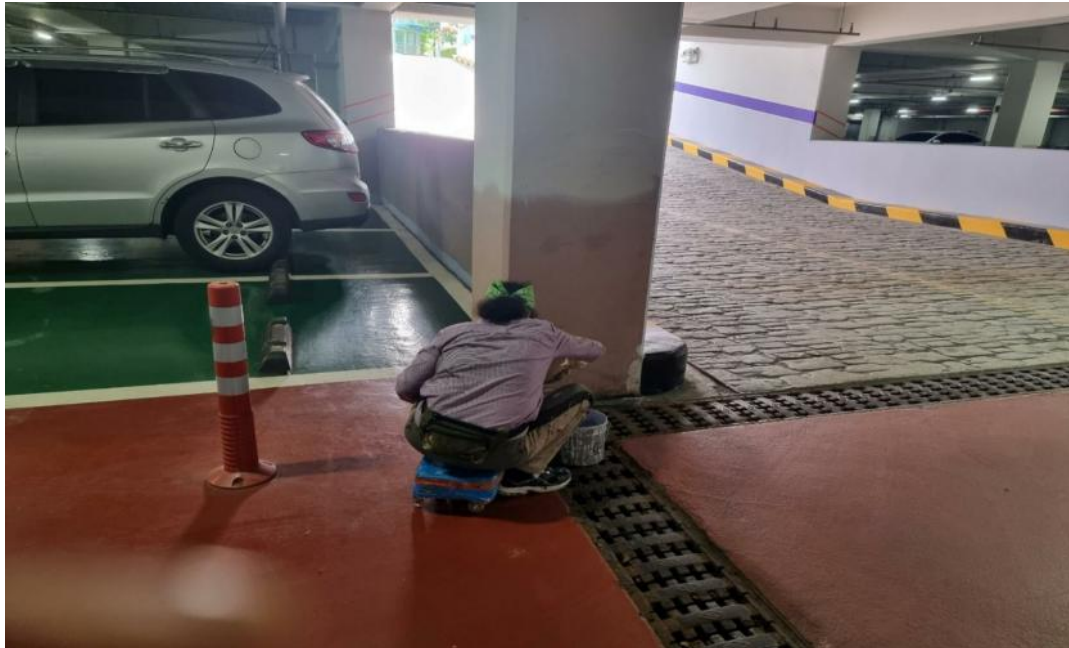
공사중 (지하주차장 수성페인트 작업)
