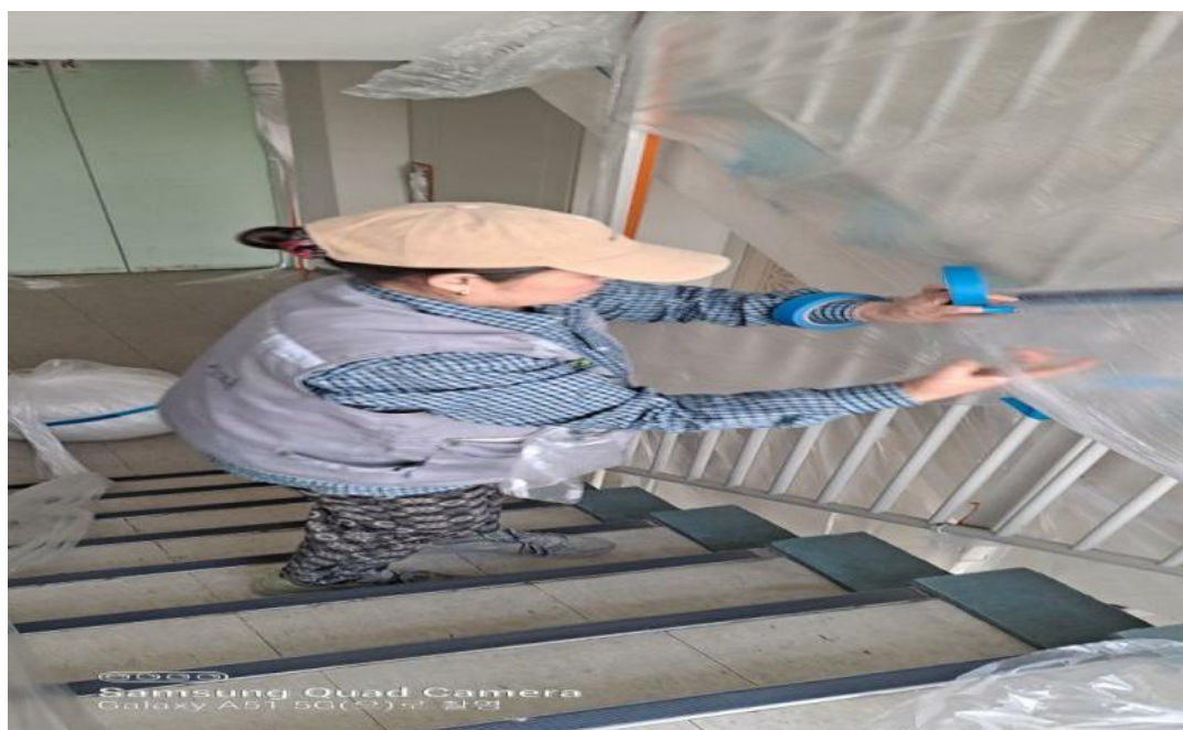
공사중 (뽐칠 전 보강작업)
