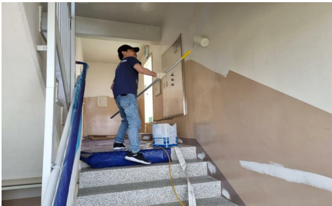
공사중 (수성페인트 작업)
