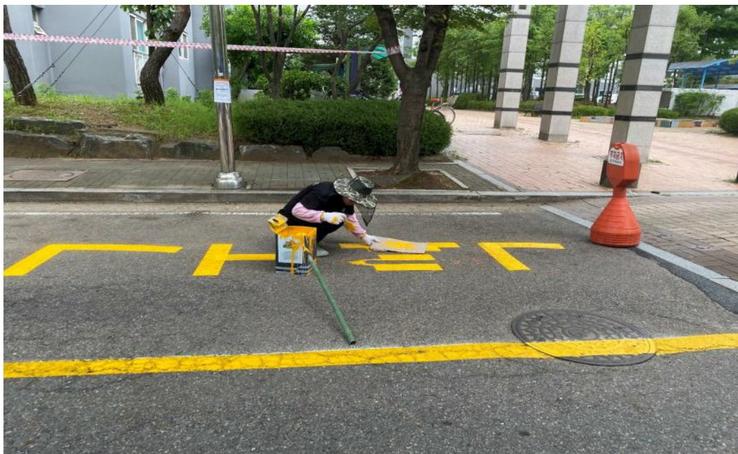
공사중 (지상주차선 작업)
