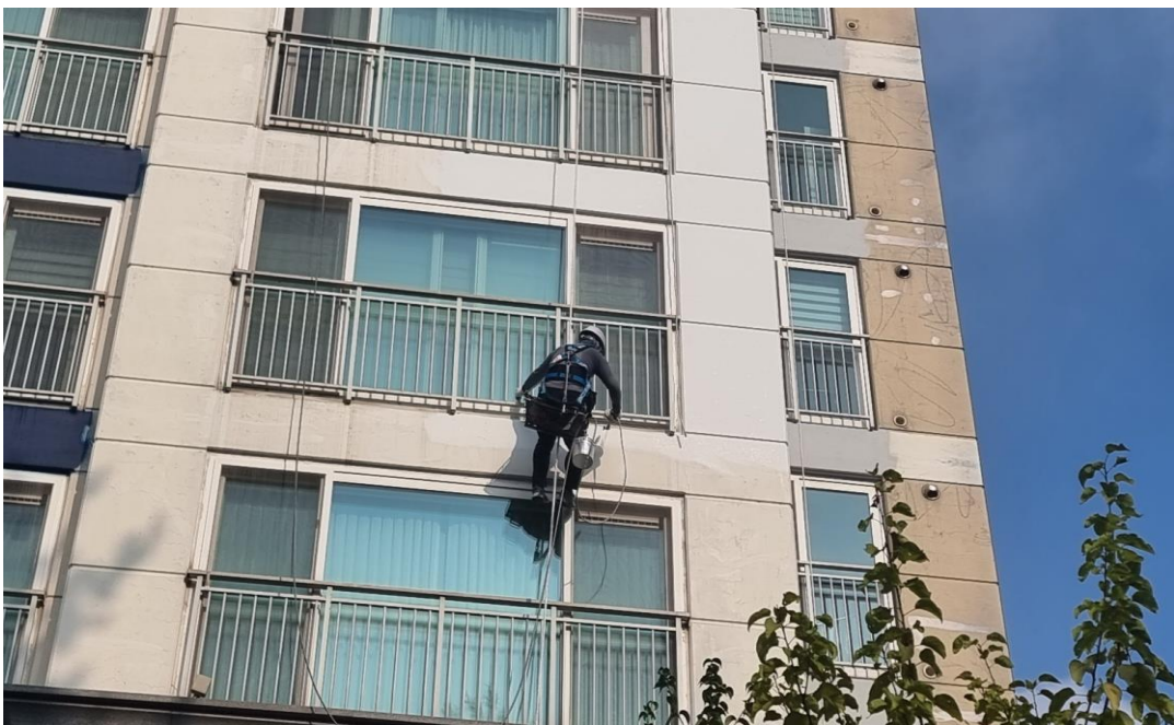
공사 중 : 외벽 페인트 도장
