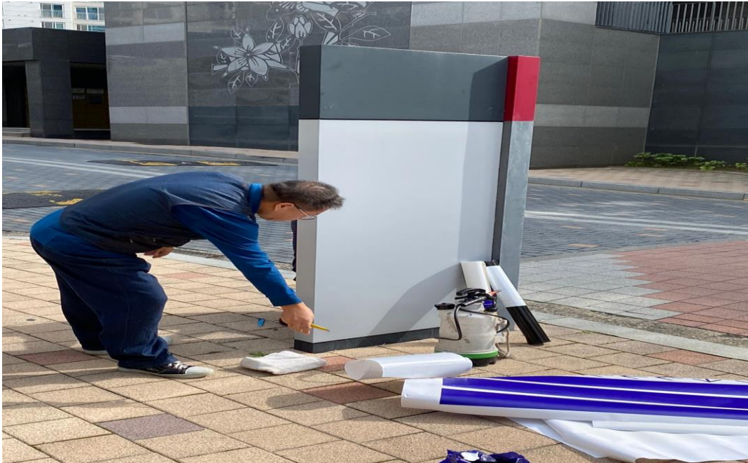
공사 중 : 간판 작업
