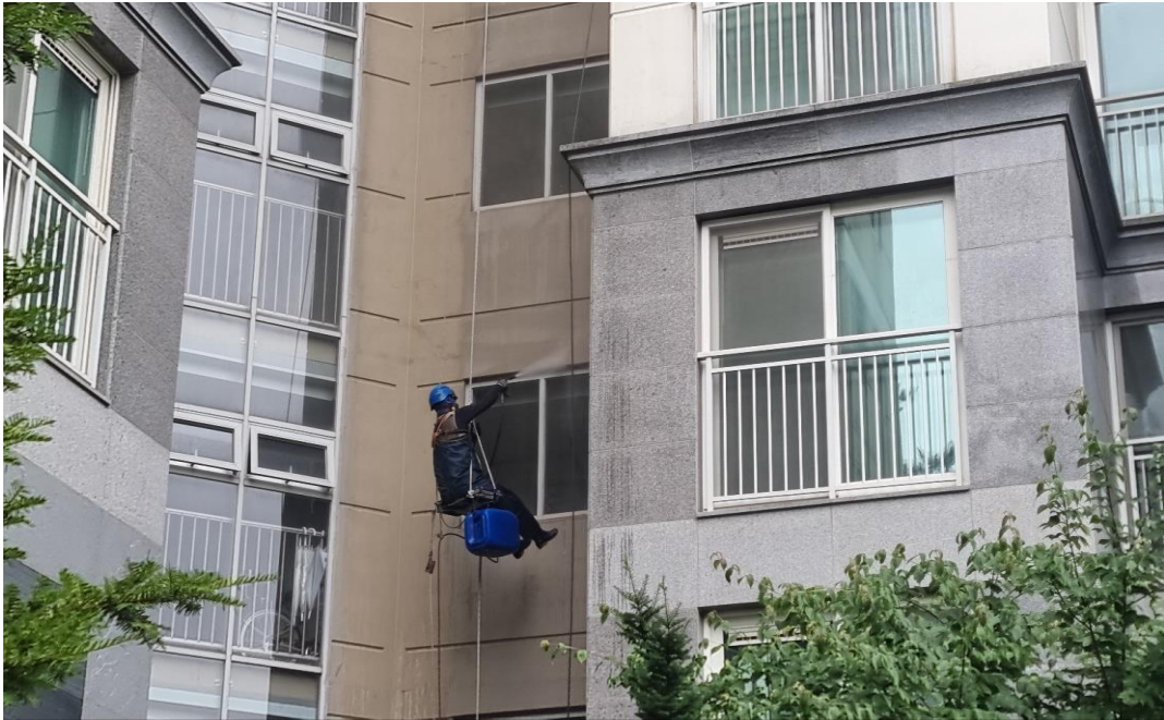
공사 중 : 외벽 고압세척
