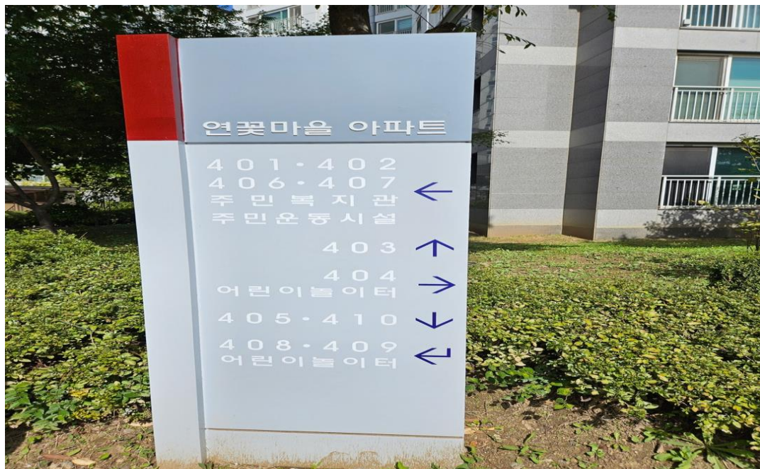
공사 중 : 간판 작업
