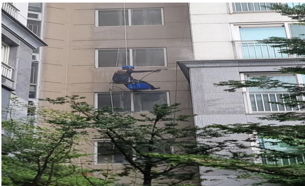
공사 중 : 외벽 고압세척
