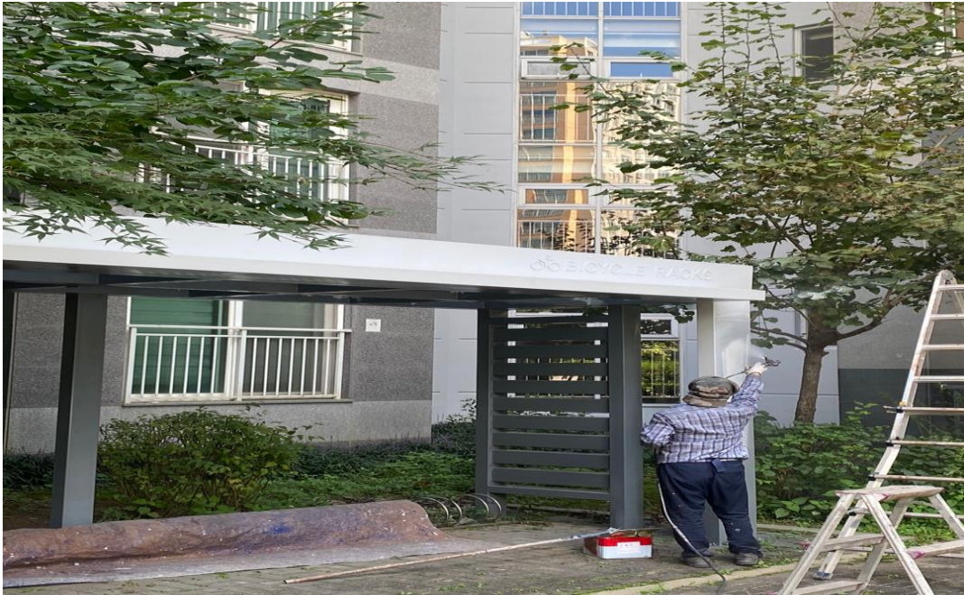
공사 중 : 부대시설 도장
