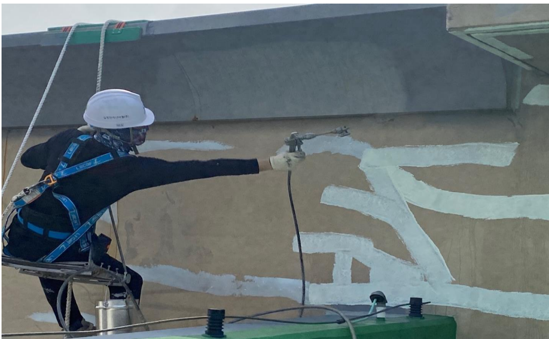
공사 중 : 외벽 페인트 도장
