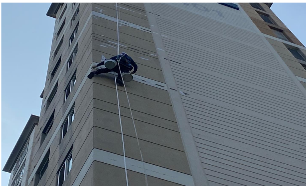
공사 중 : 외벽 균열보수
