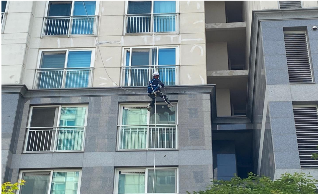
공사 중 : 외벽 바인다 작업
