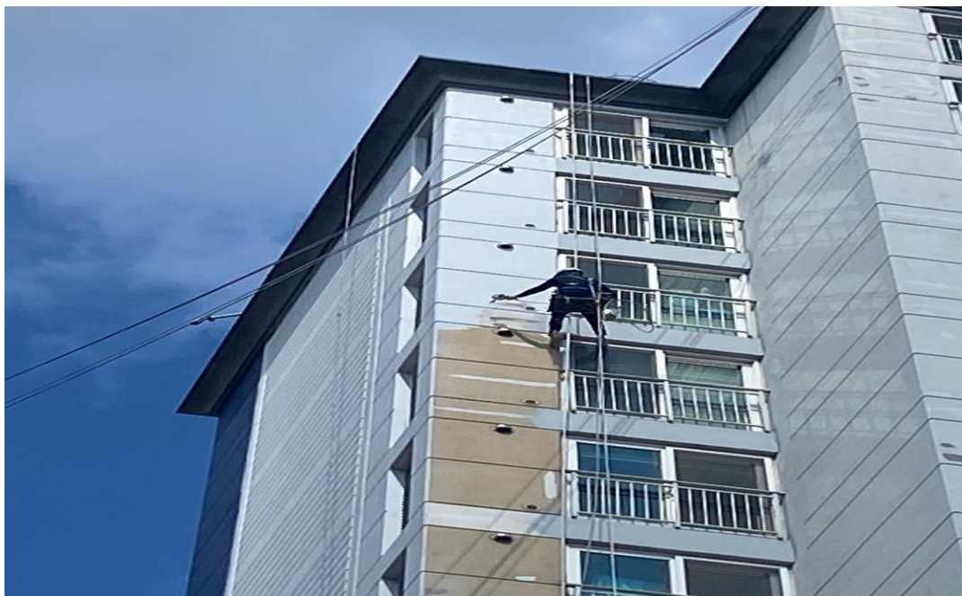
공사 중 : 외벽 페인트 도장
