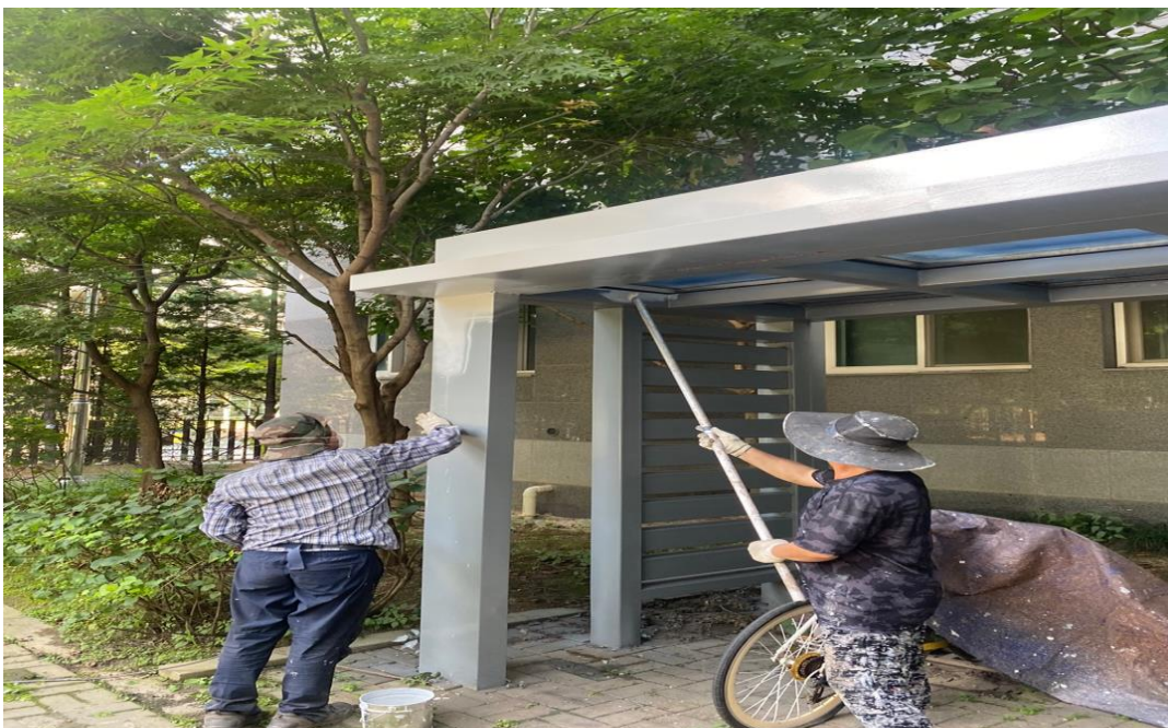
공사 중 : 부대시설 도장
