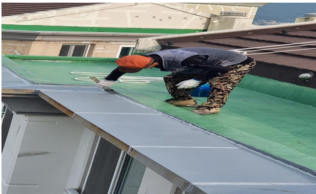
공사 중 : 코킹 작업
