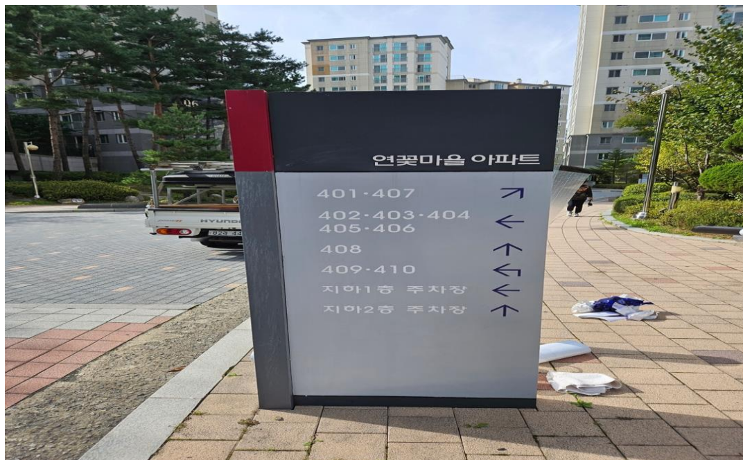
공사 중 : 간판 작업
