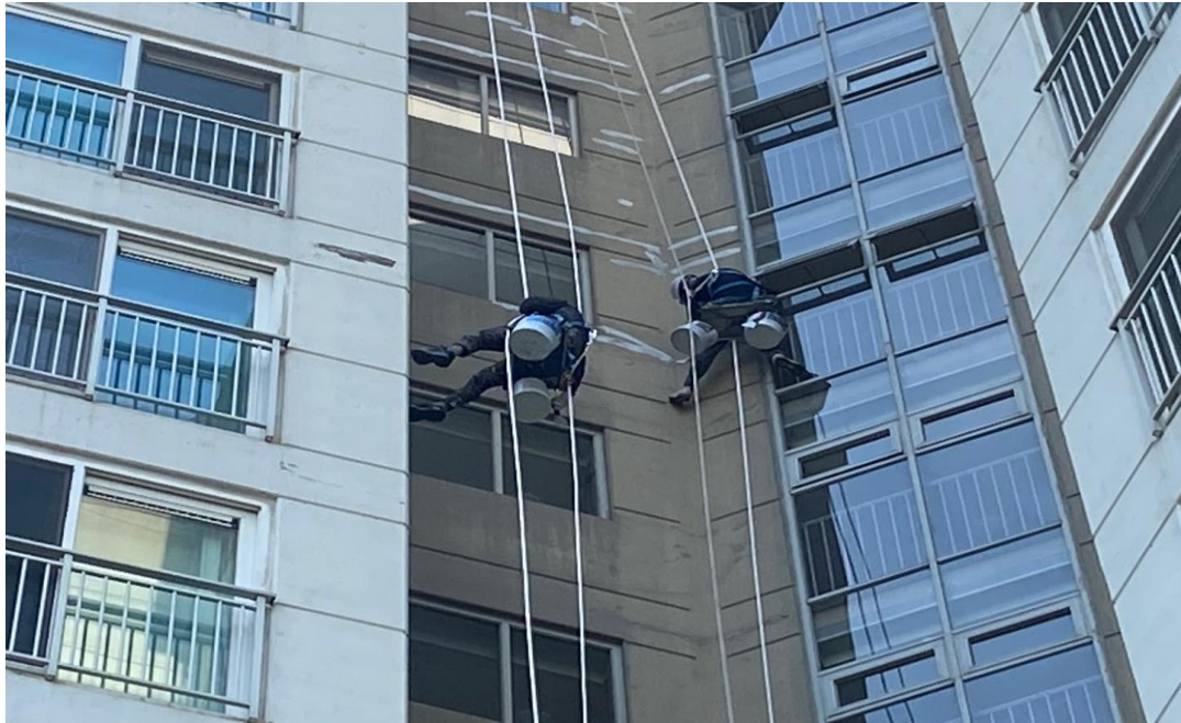
공사 중 : 외벽 균열보수
