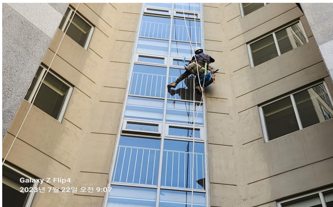
공사 중 : 코킹 작업
