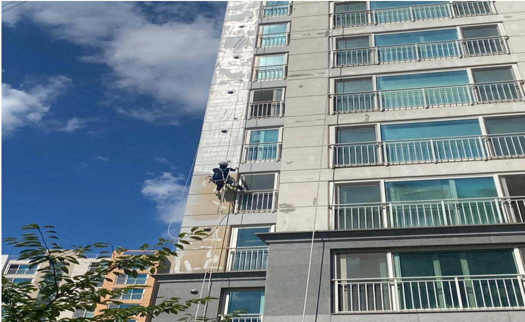
공사 중 : 외벽 페인트 도장
