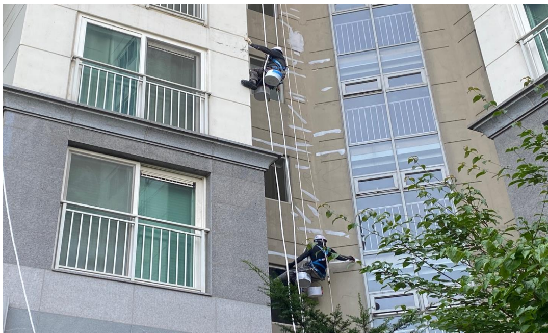
공사 중 : 외벽 균열보수
