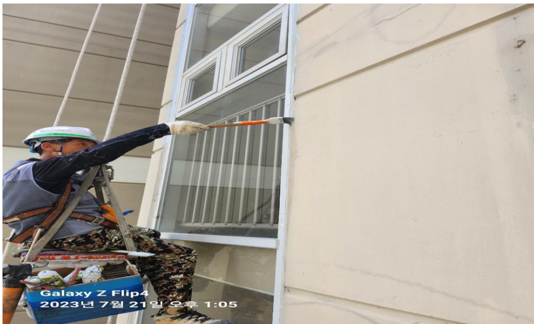
공사 중 : 코킹 작업
