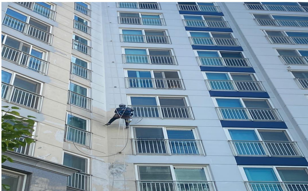
공사 중 : 외벽 페인트 도장
