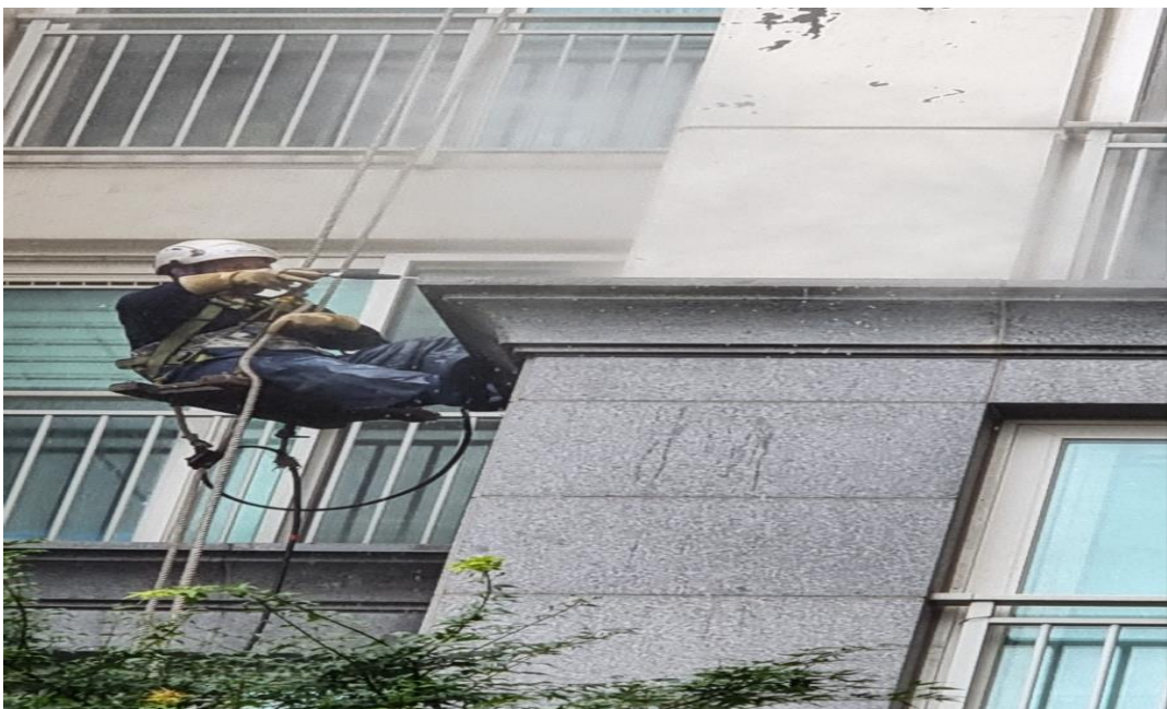
공사 중 : 외벽 고압세척
