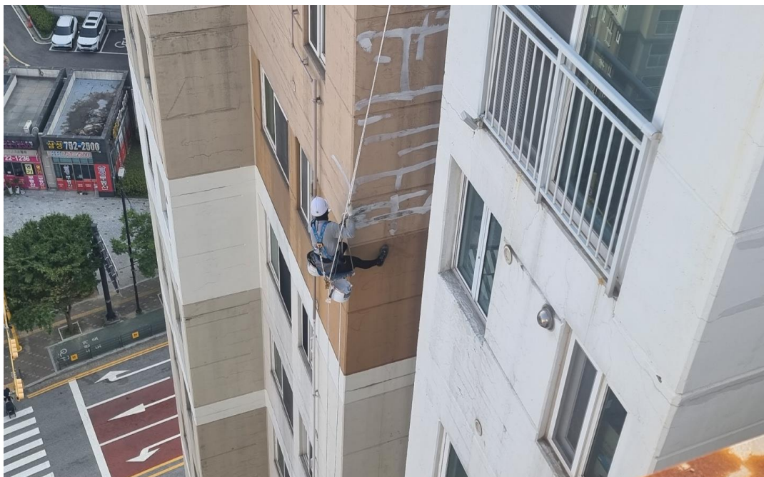
공사 중 : 외벽 균열보수
