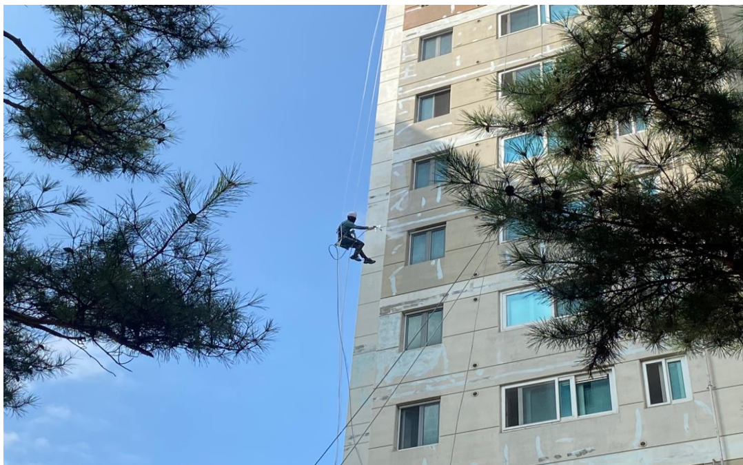
공사 중 : 외벽 바인다 작업
