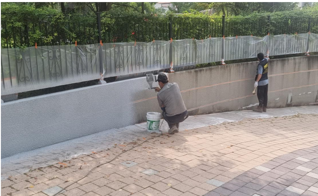
공사 중 : 스톤뿔칠작업
