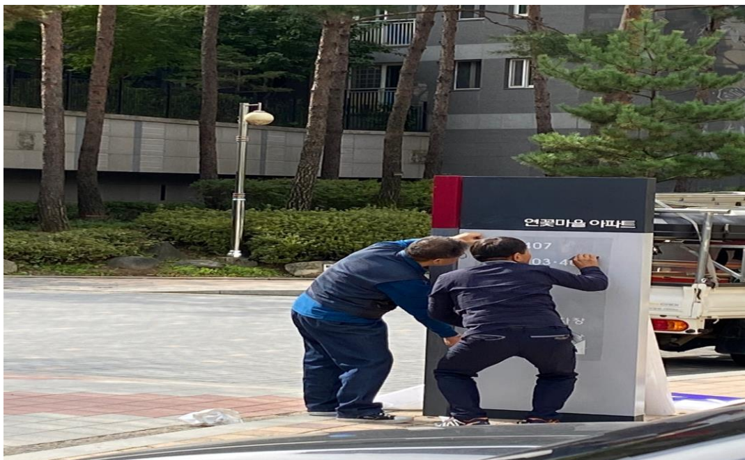
공사 중 : 간판 작업
