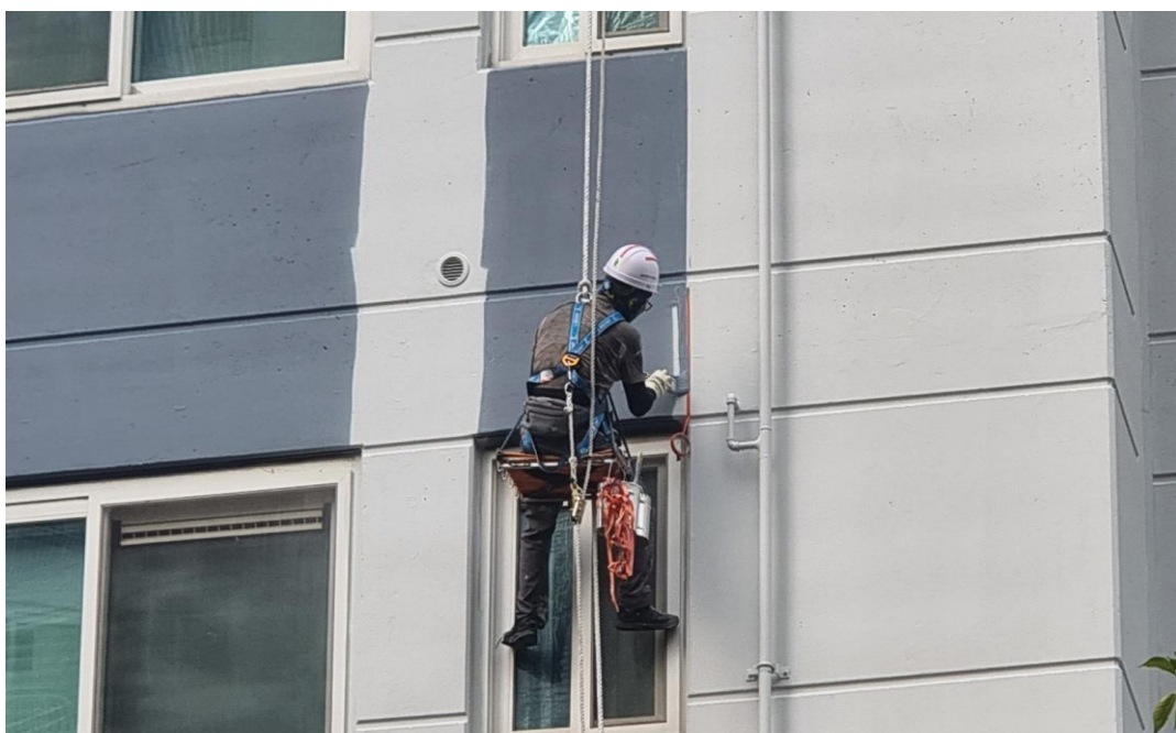
공사 중 : 외벽 페인트 도장
