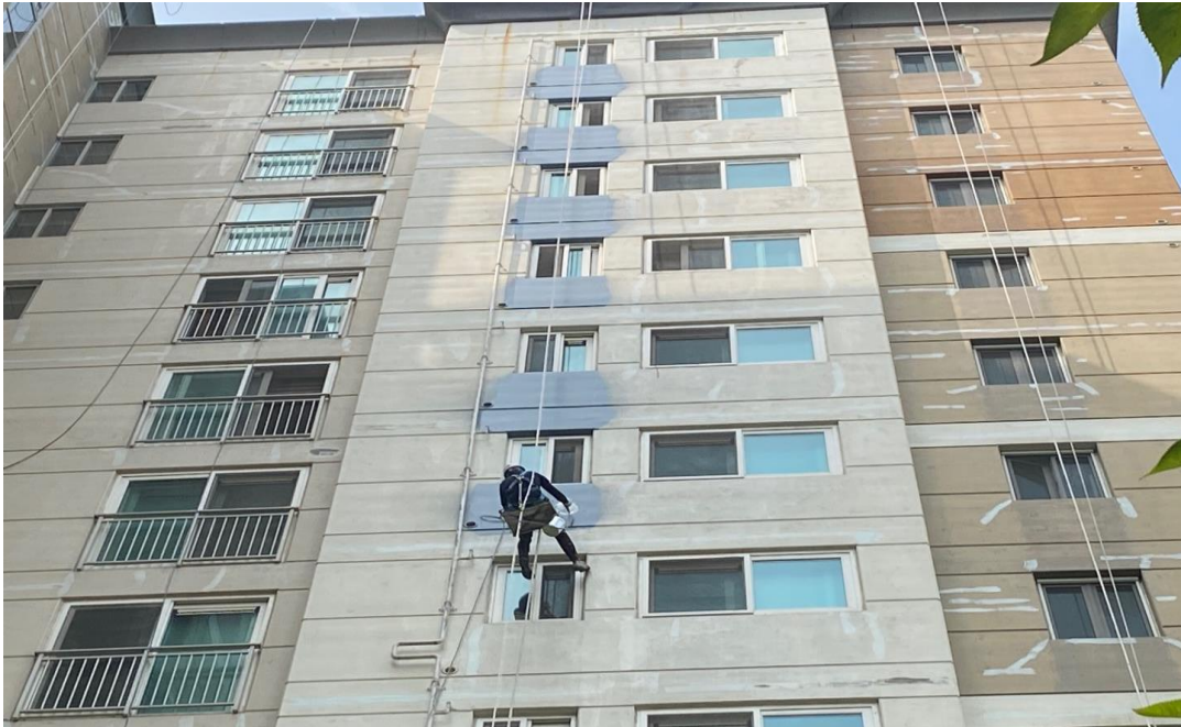
공사 중 : 외벽 페인트 도장
