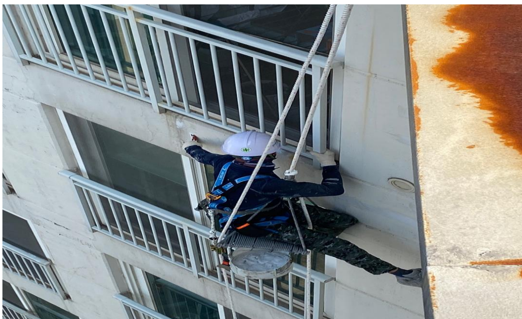
공사 중 : 외벽 균열보수
