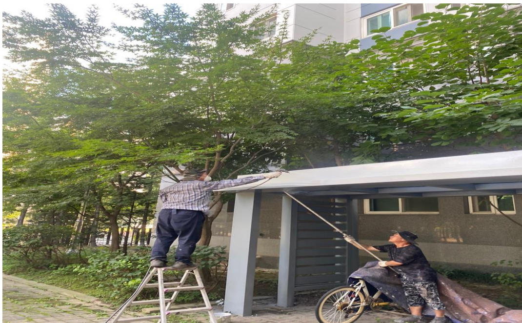
공사 중 : 부대시설 도장
