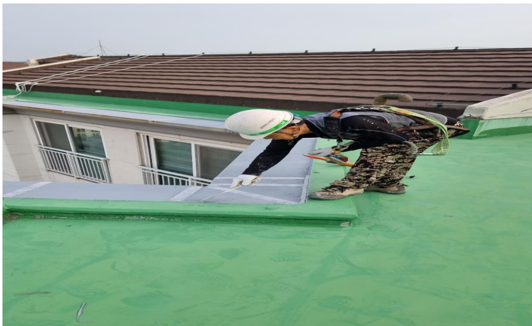
공사 중 : 코킹 작업
