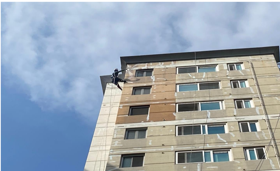
공사 중 : 외벽 바인다 작업
