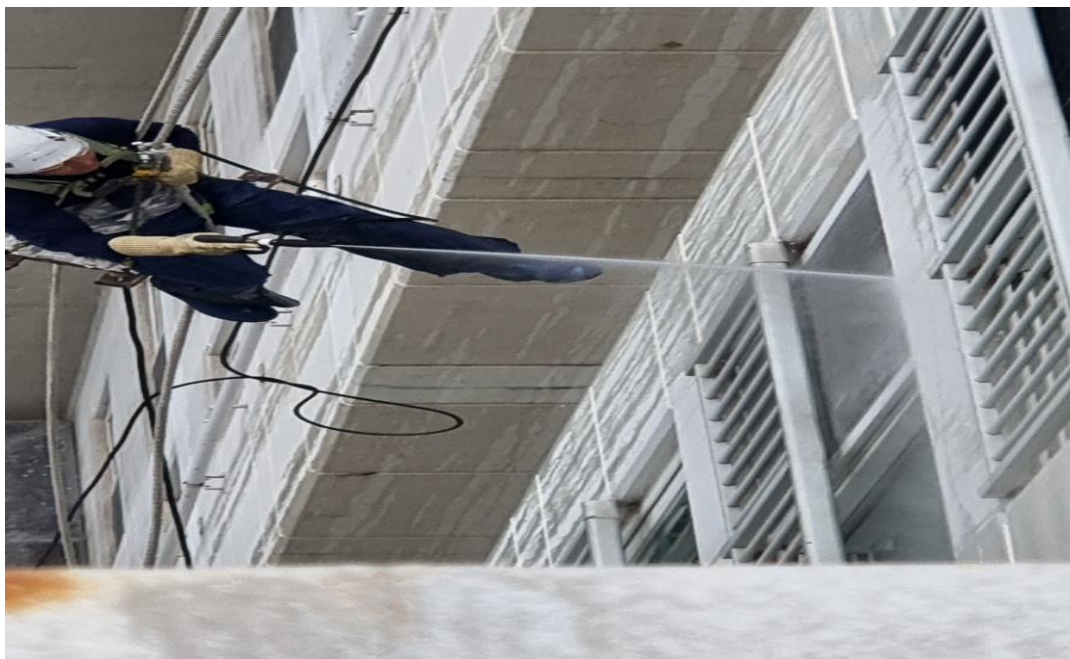
공사 중 : 외벽 고압세척
