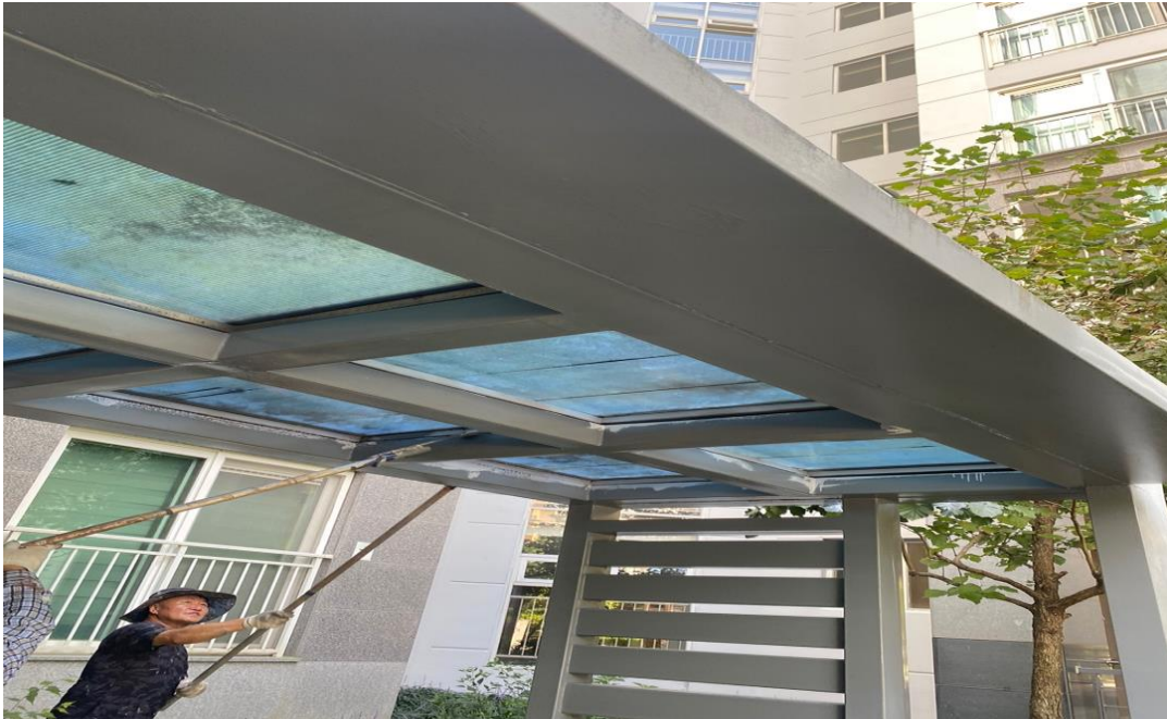
공사 중 : 부대시설 도장
