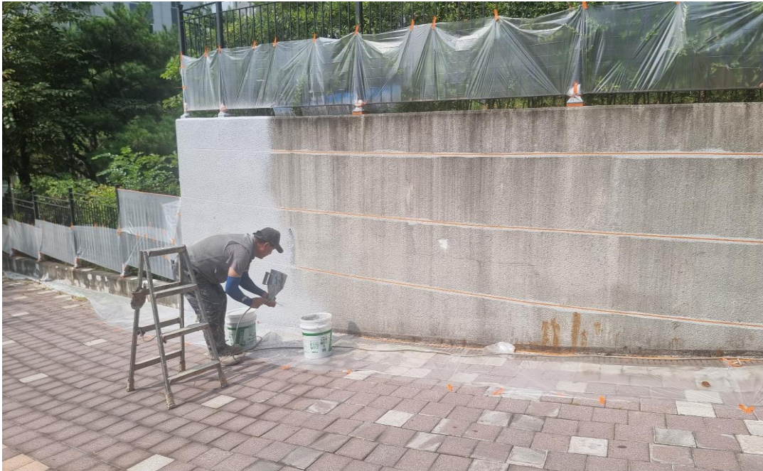
공사 중 : 스톤뿔칠작업
