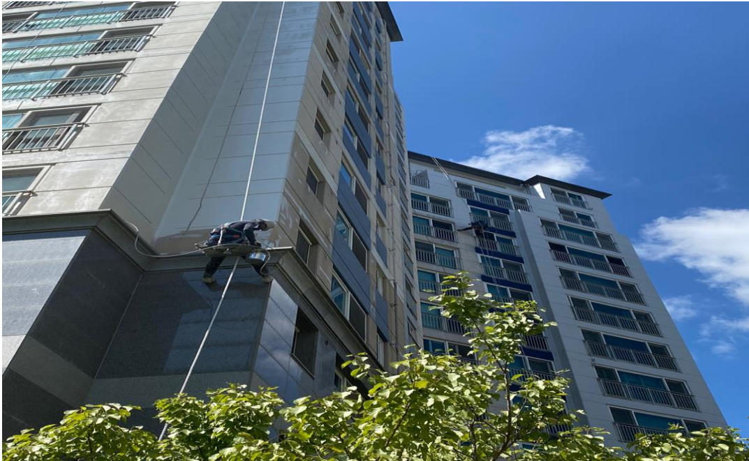
공사 중 : 외벽 페인트 도장
