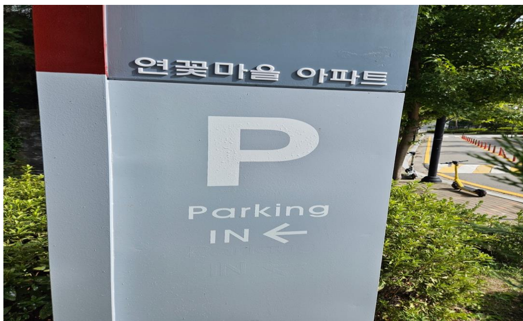
공사 중 : 간판 작업
