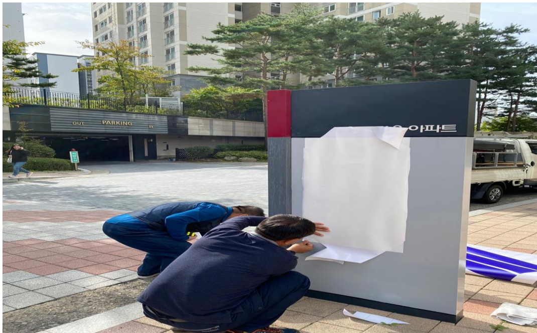
공사 중 : 간판 작업
