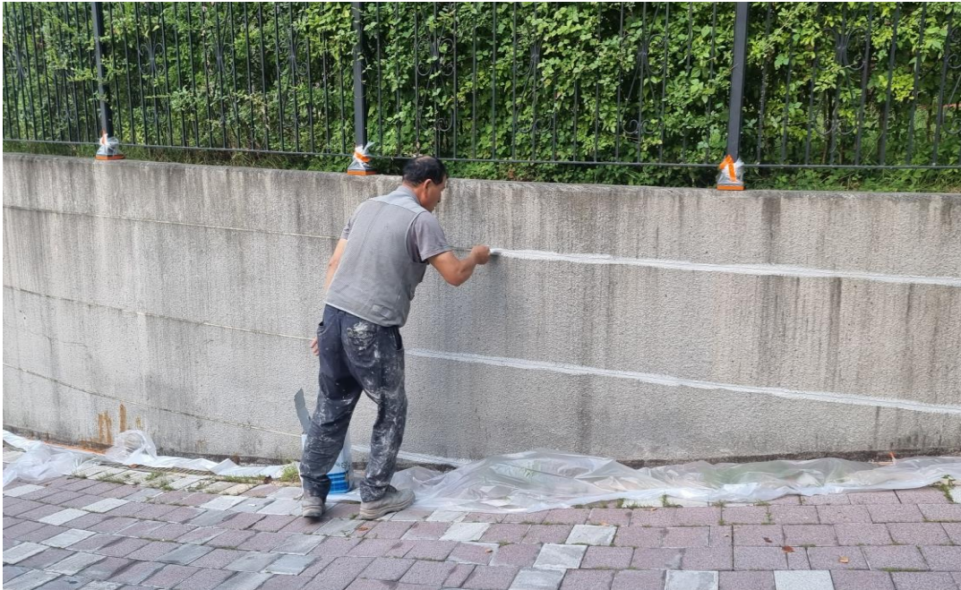
공사 중 : 스톤뿔칠작업
