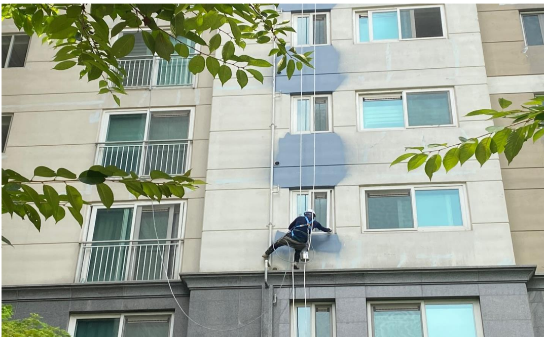
공사 중 : 외벽 페인트 도장
