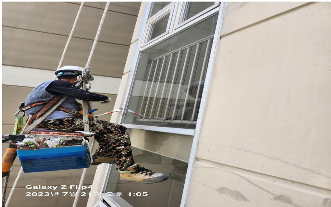
공사 중 : 코킹 작업
