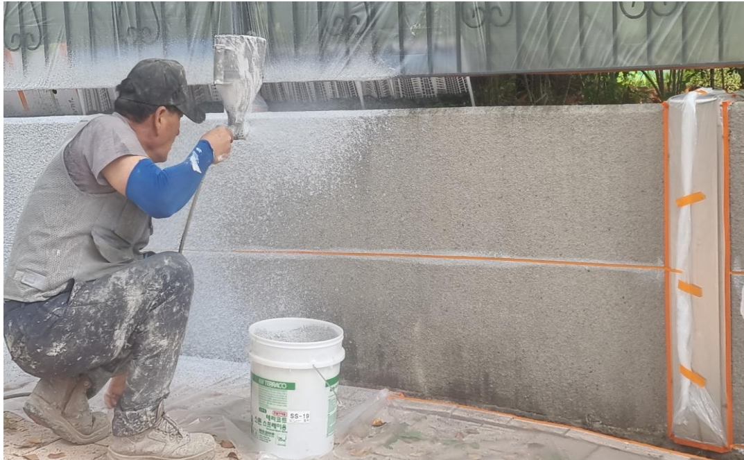
공사 중 : 스톤뿔칠작업
