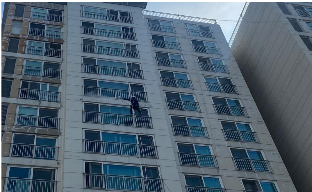
공사 중 : 외벽 바인다 작업
