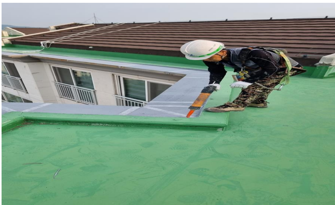
공사 중 : 코킹 작업
