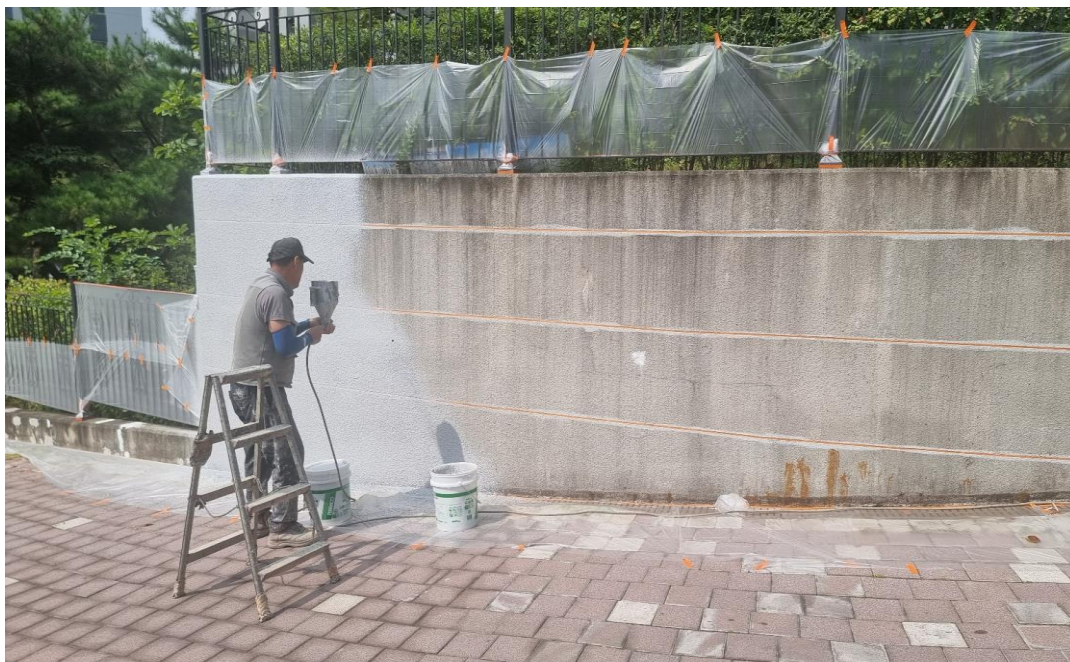
공사 중 : 스톤뿔칠작업
