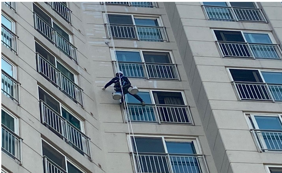
공사 중 : 외벽 균열보수
