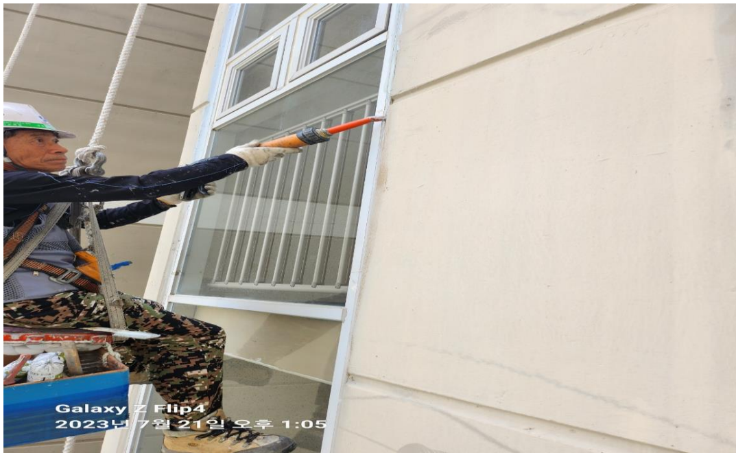
공사 중 : 코킹 작업
