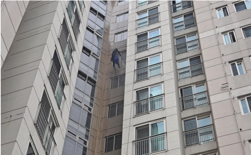
공사 중 : 외벽 고압세척
