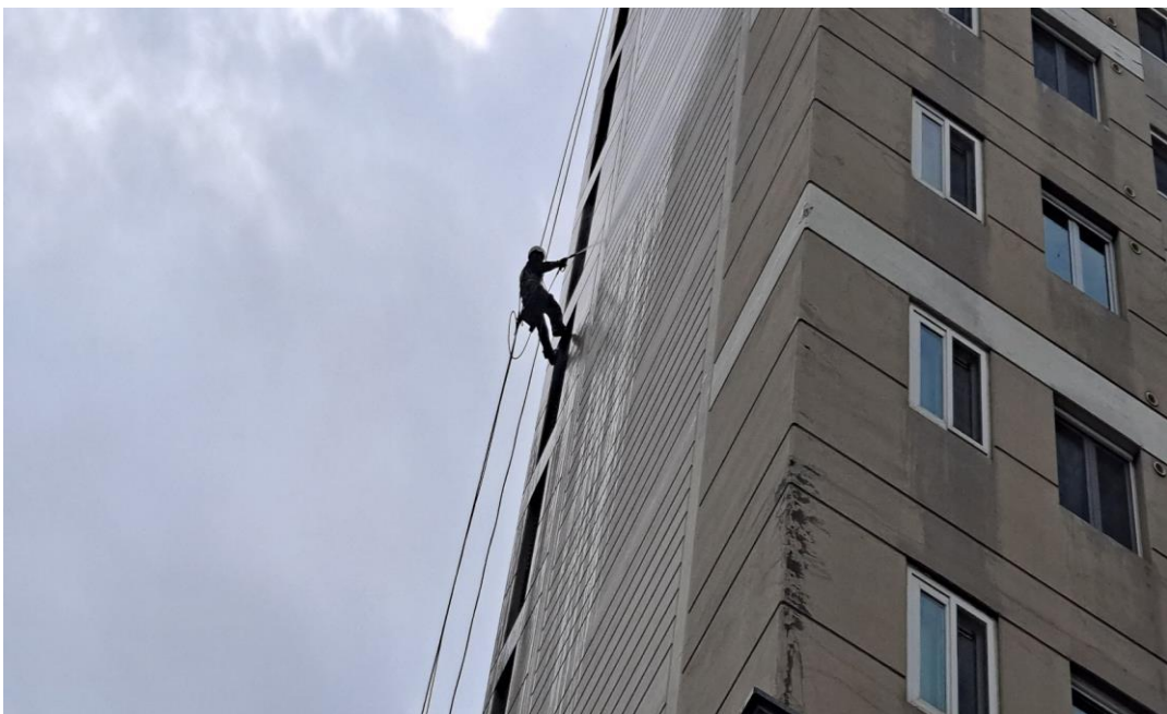
공사 중 : 외벽 고압세척
