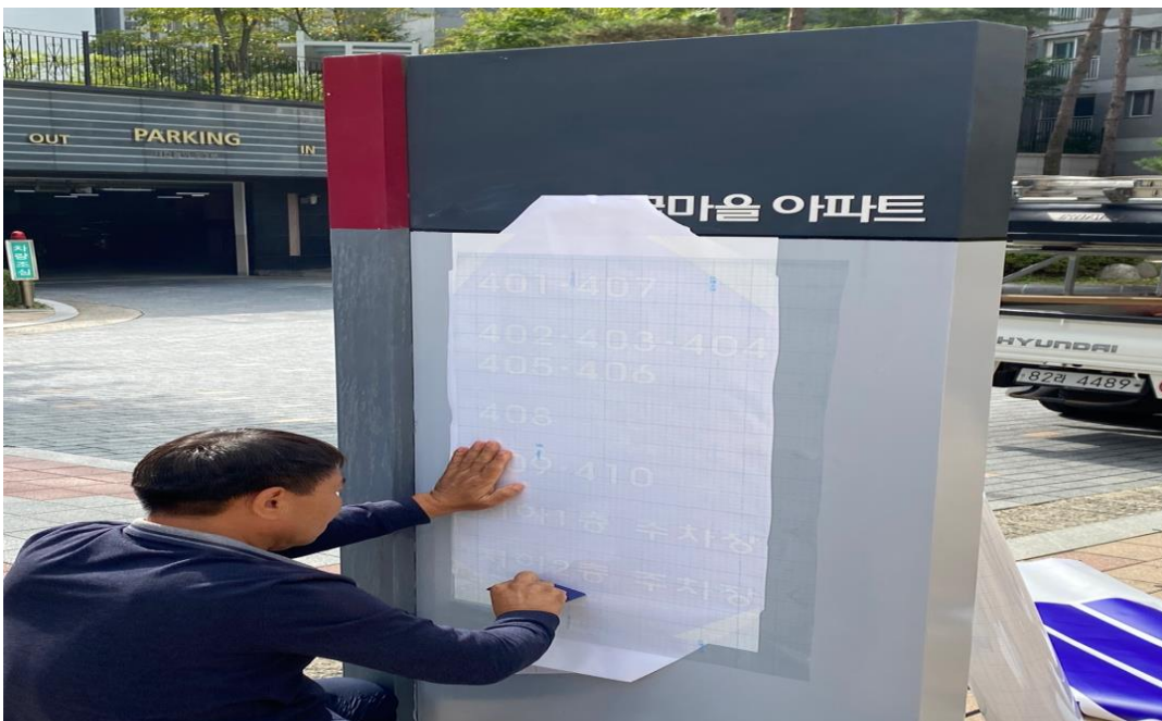
공사 중 : 간판 작업
