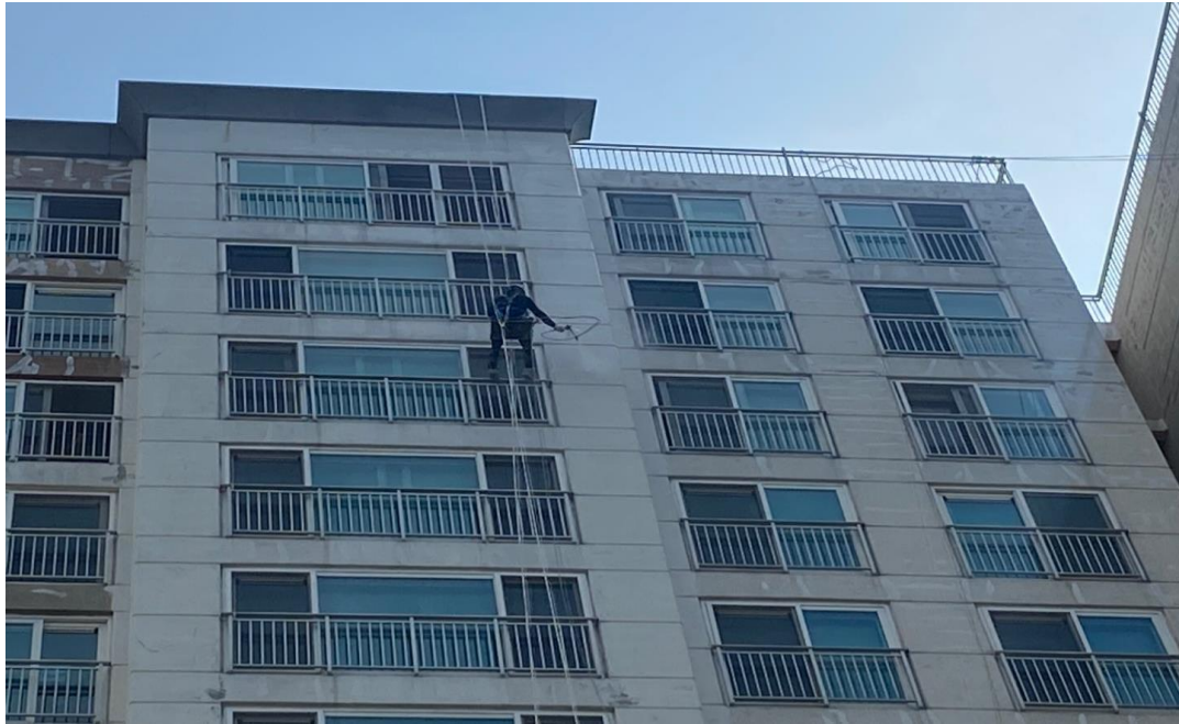
공사 중 : 외벽 바인다 작업
