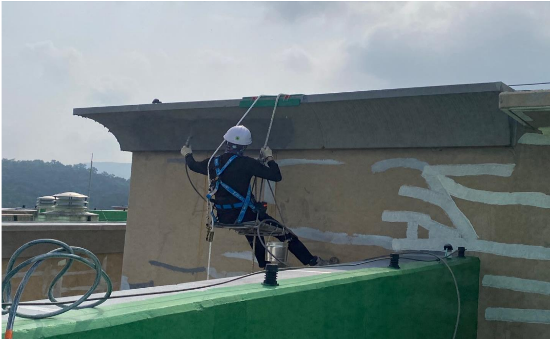
공사 중 : 외벽 페인트 도장
