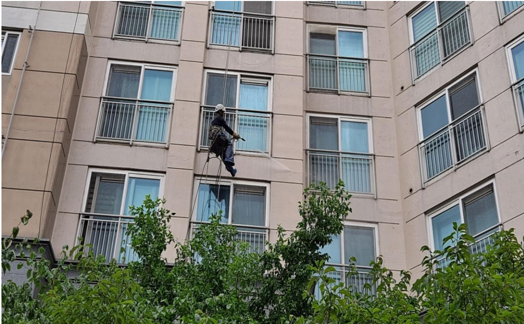
공사 중 : 외벽 고압세척
