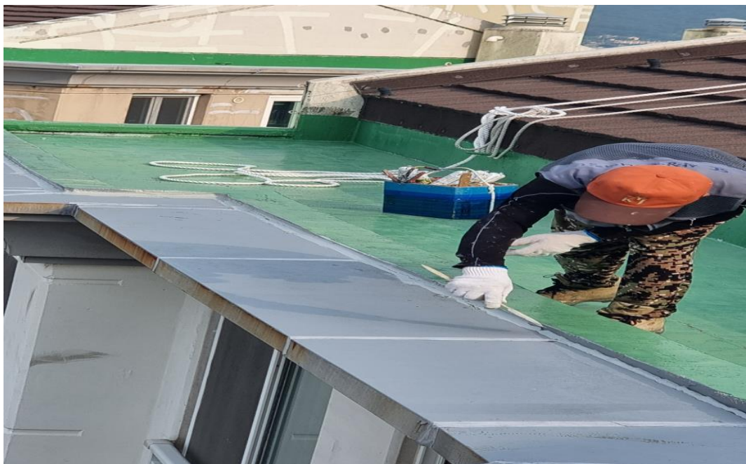
공사 중 : 코킹 작업
