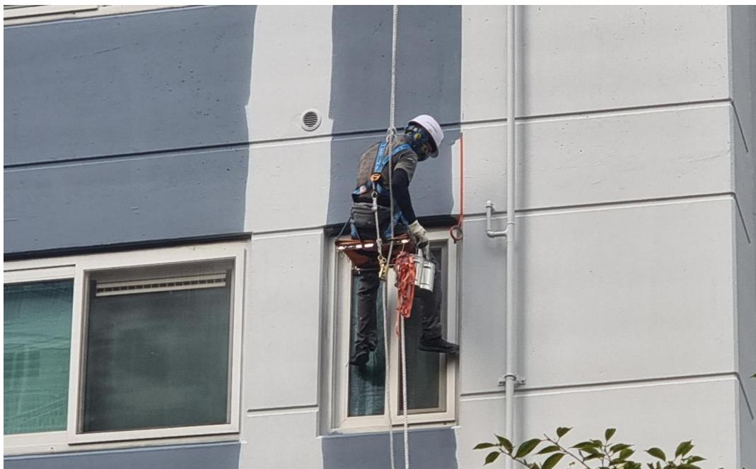
공사 중 : 외벽 페인트 도장
