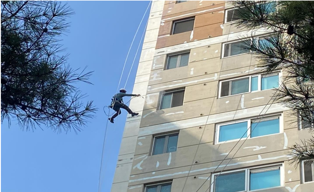
공사 중 : 외벽 바인다 작업
