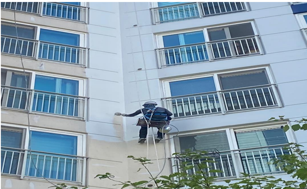
공사 중 : 외벽 페인트 도장
