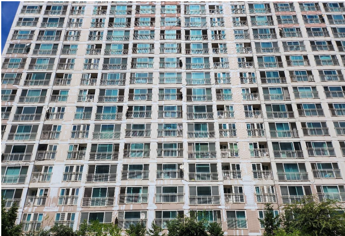
외벽 균열 보수 1차
