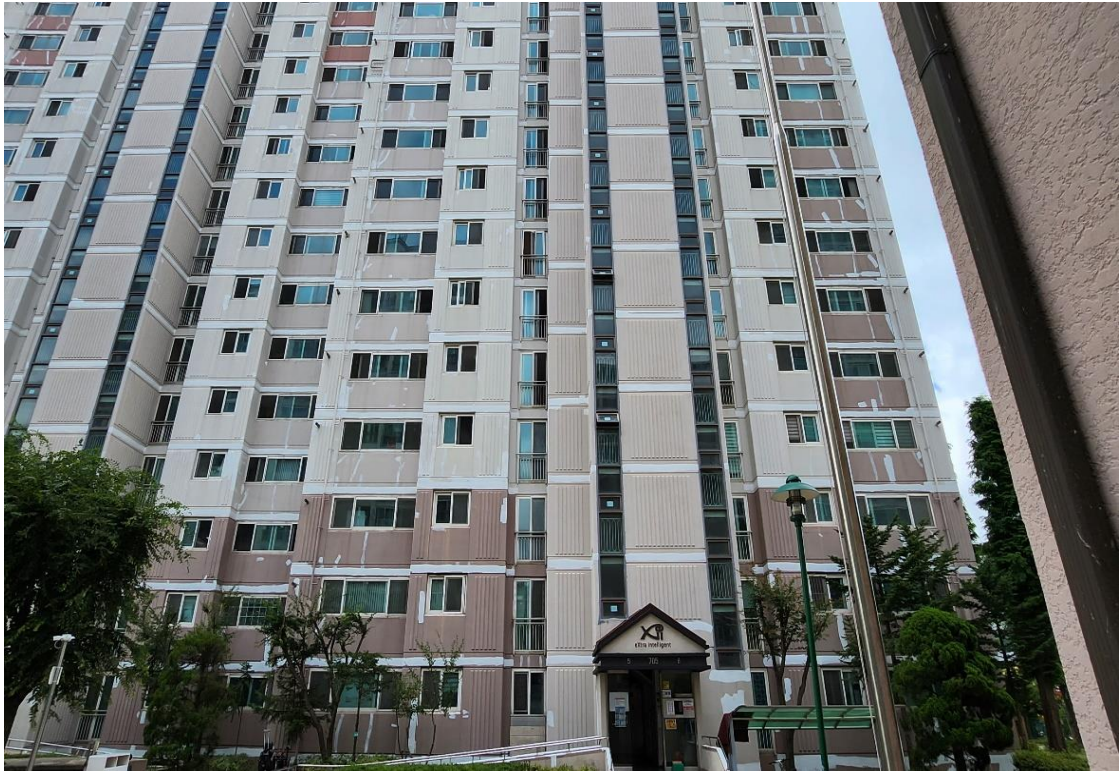
외벽 균열 보수 2차
