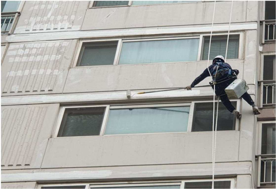
외벽 균열 보수 2차
