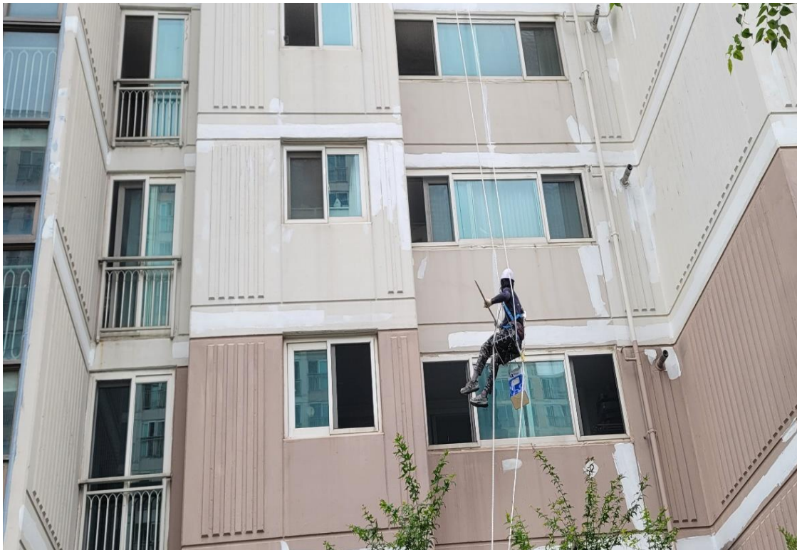
외벽 균열 보수 2차
