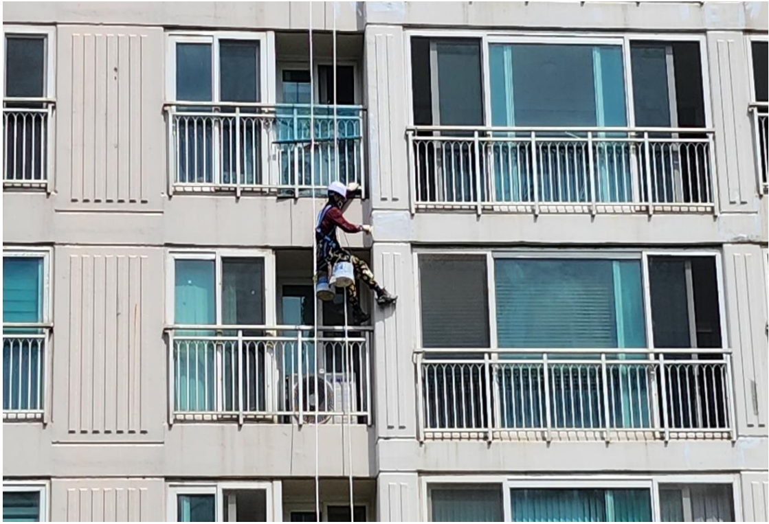
외벽 균열 보수 1차
