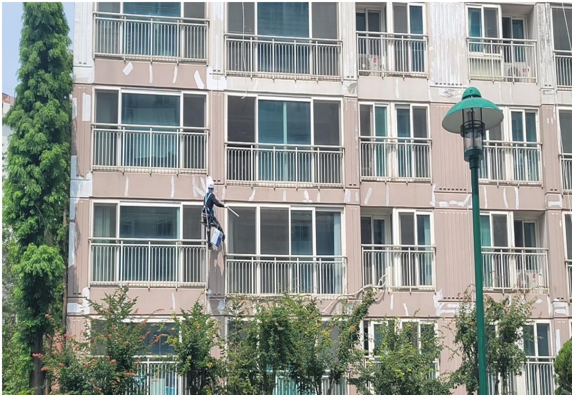
외벽 균열 보수 1차
