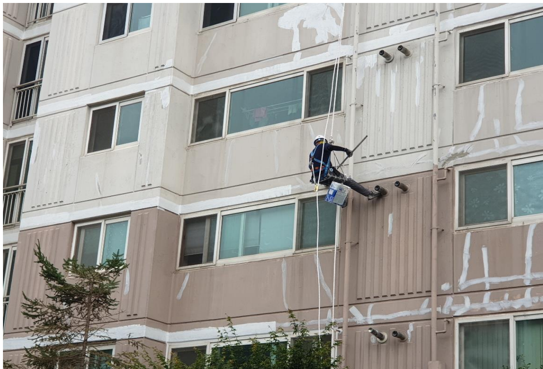
외벽 균열 보수 2차
