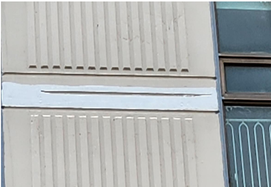
외벽 균열 보수 2차
