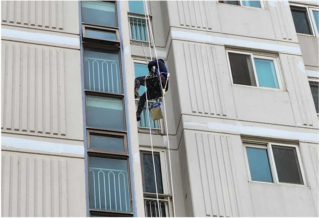
외벽 균열 보수 1차
