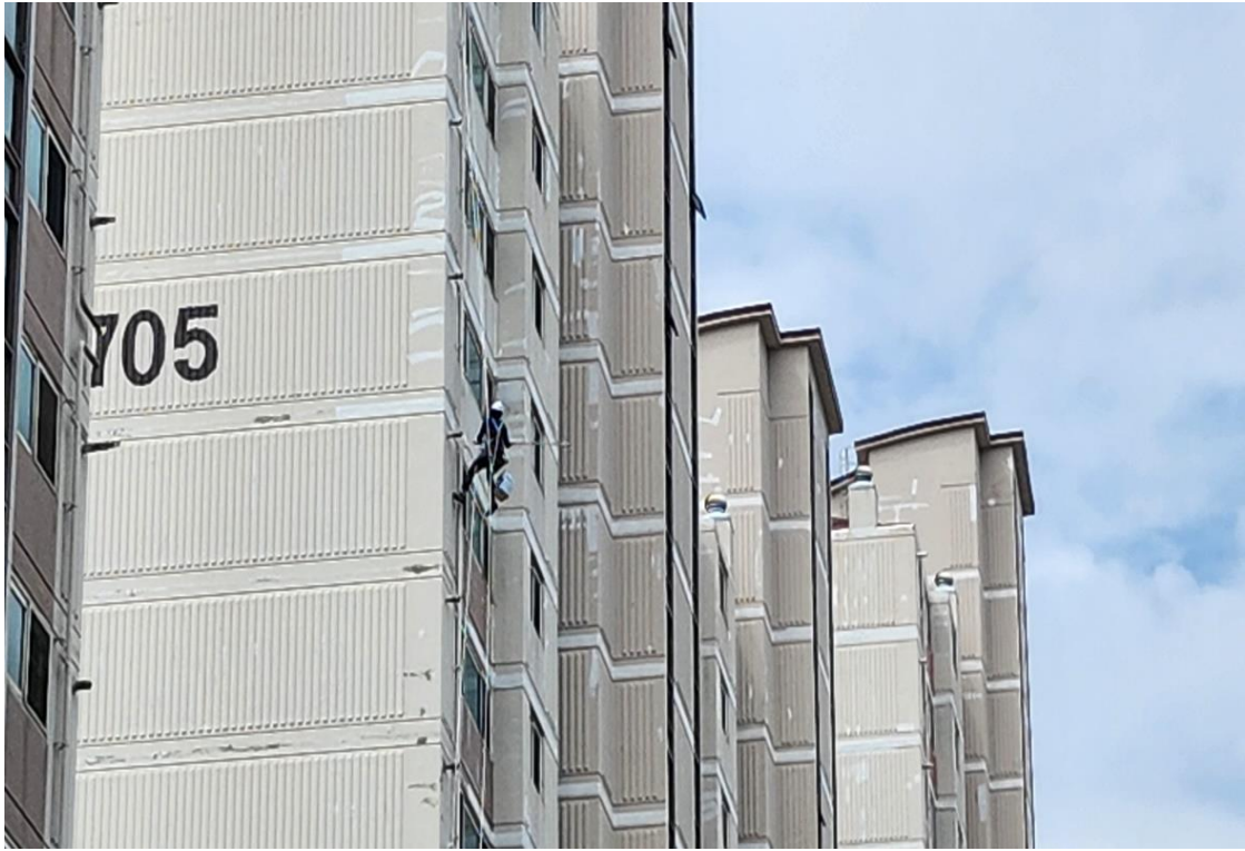
외벽 균열 보수 2차
