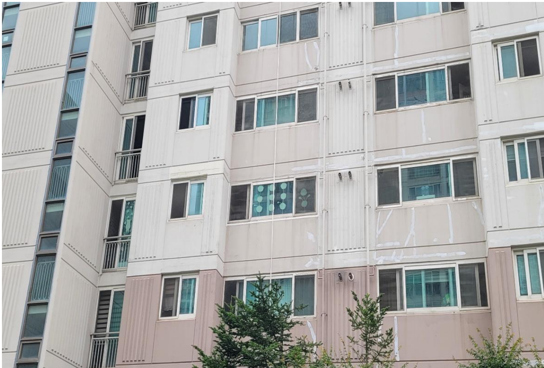
외벽 균열 보수 1차
