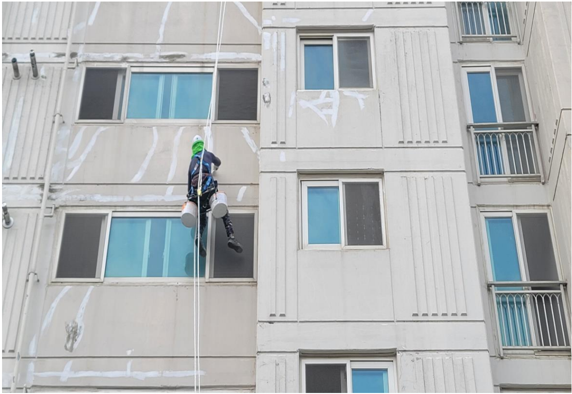
외벽 균열 보수 1차
