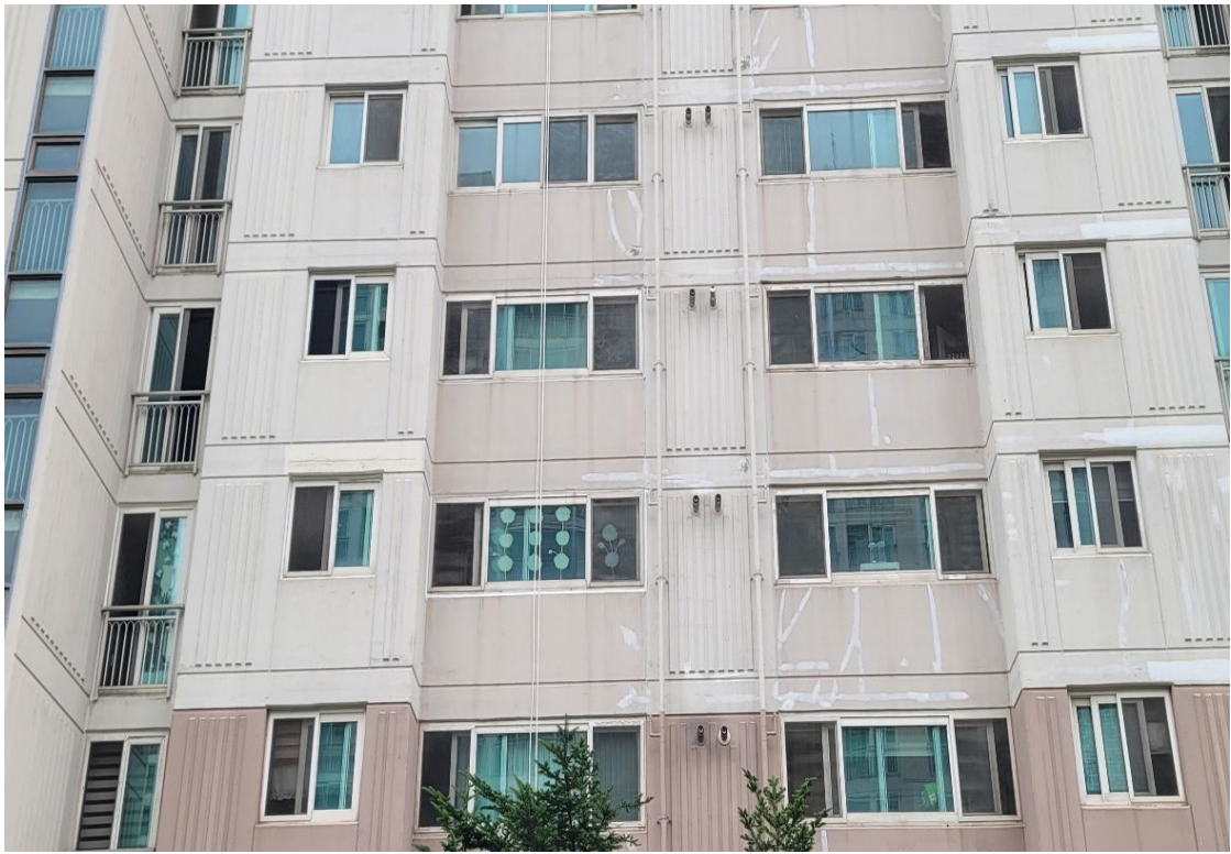
외벽 균열 보수 1차
