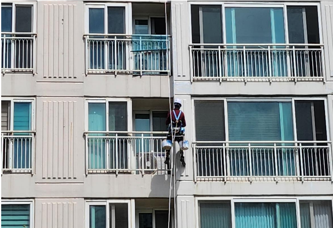
외벽 균열 보수 1차
