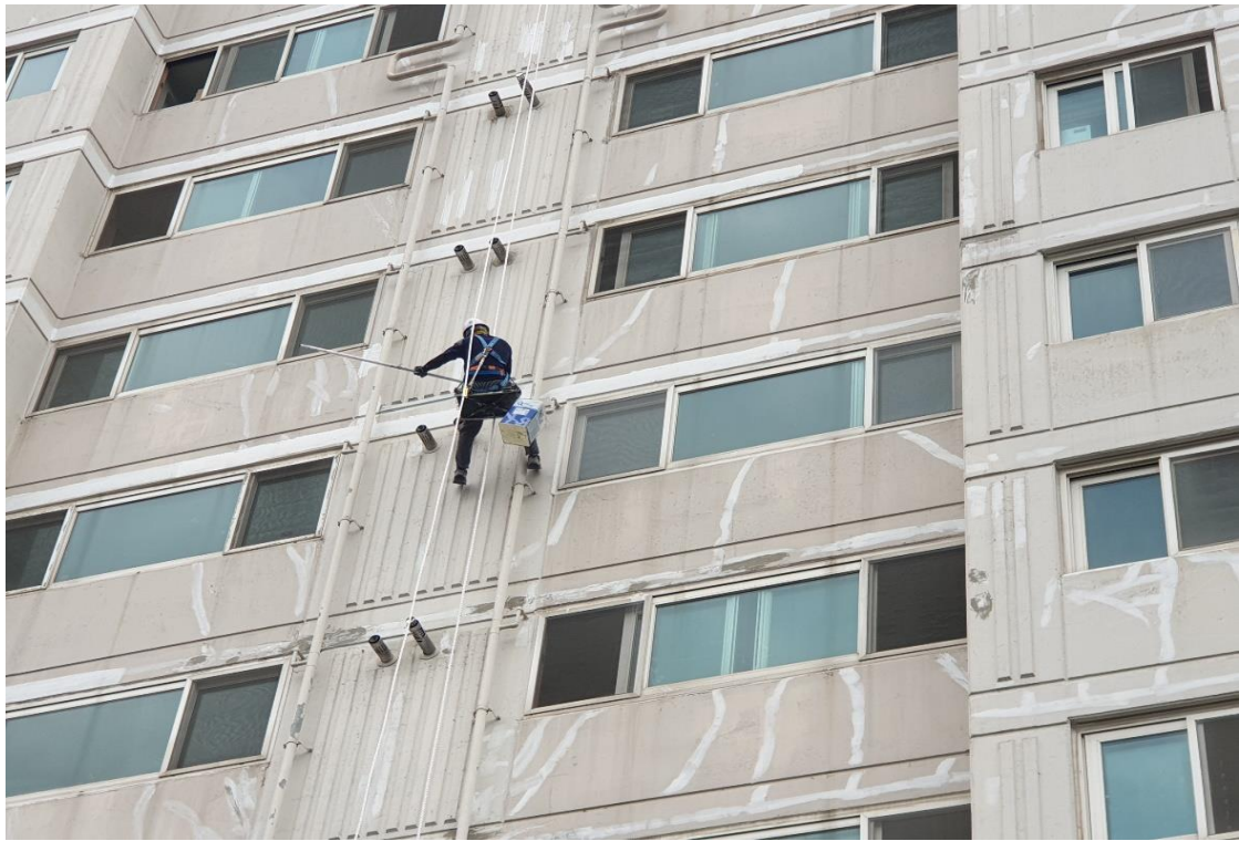
외벽 균열 보수 2차
