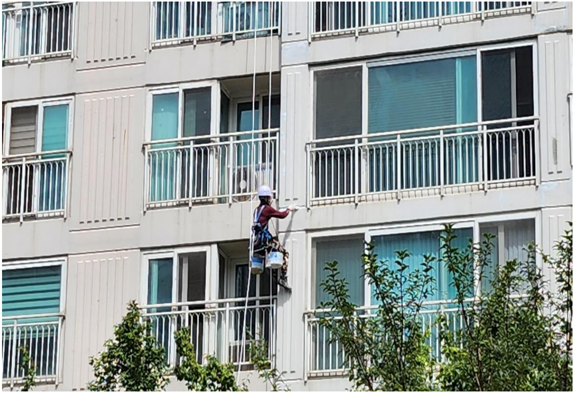
외벽 균열 보수 1차
