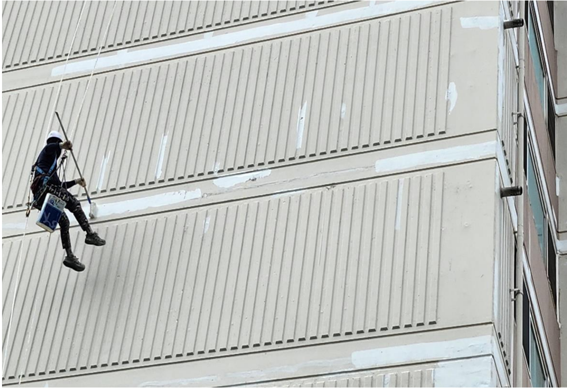
외벽 균열 보수 2차
