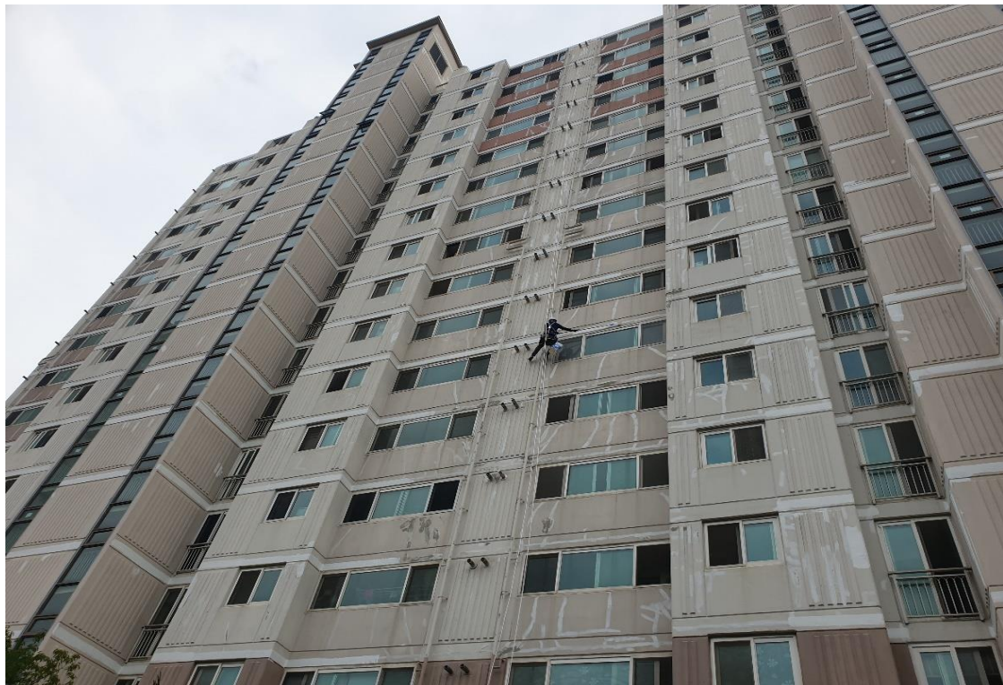
외벽 균열 보수 2차
