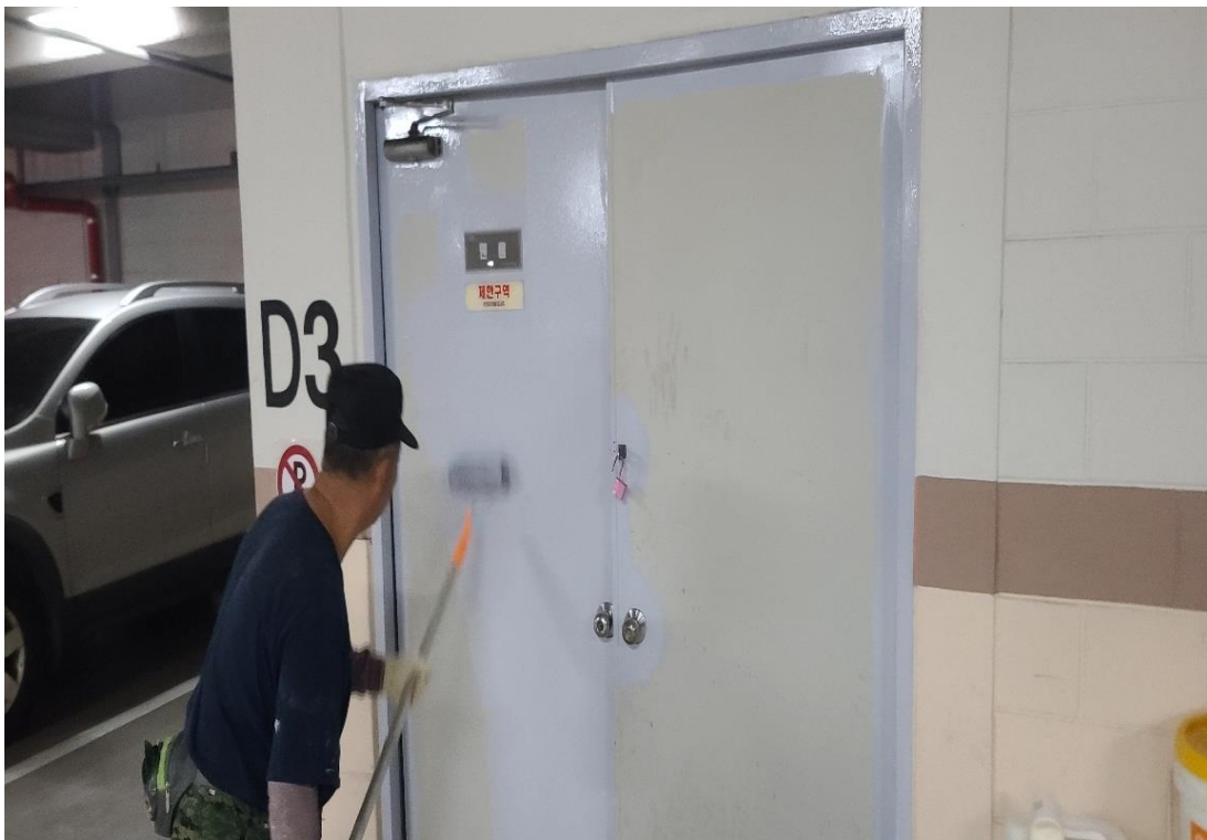
지하 주차장 도장
