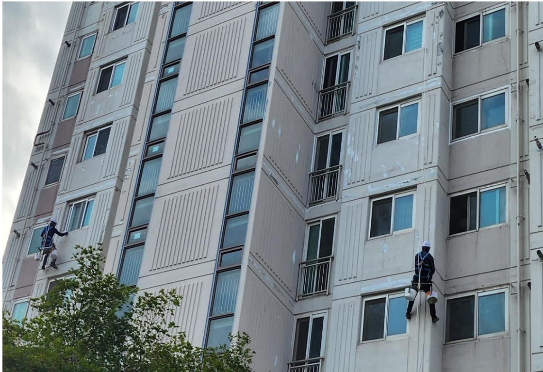
외벽 균열 보수 1차
