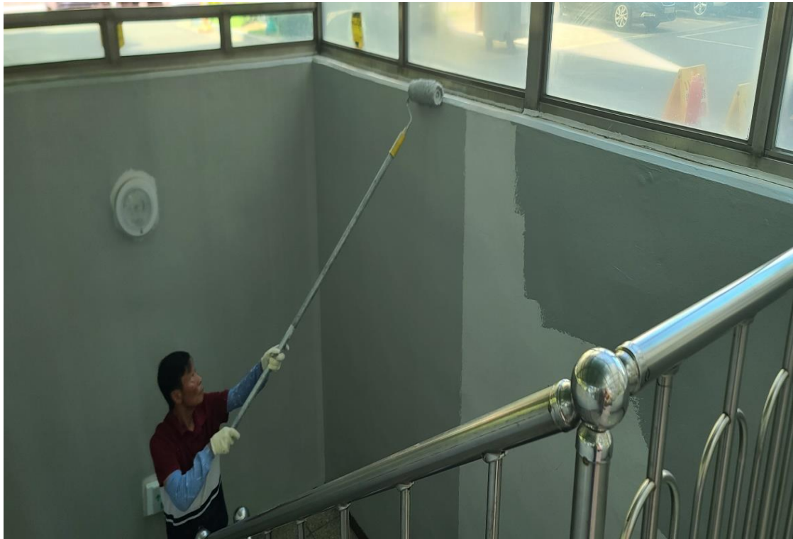
지하 주차장 도장
