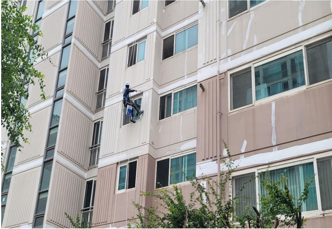
외벽 균열 보수 2차
