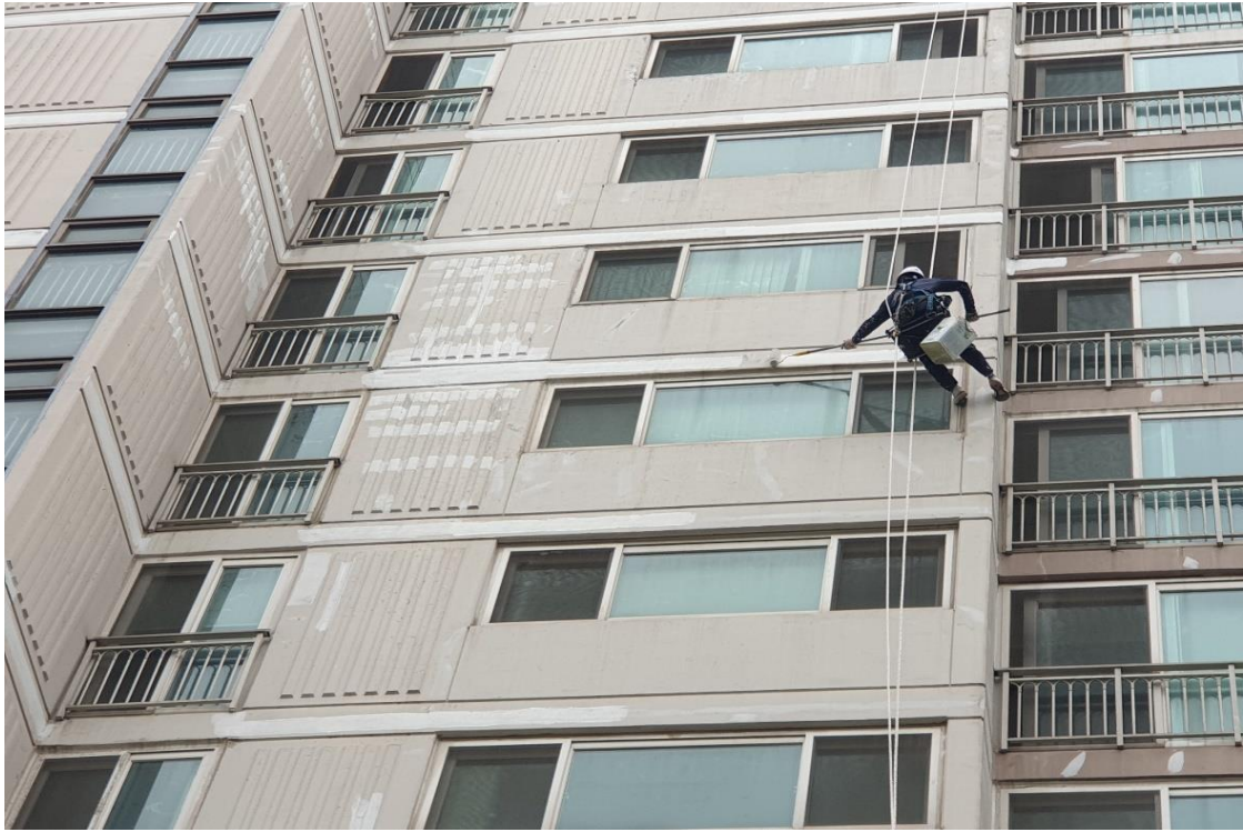
외벽 균열 보수 2차
