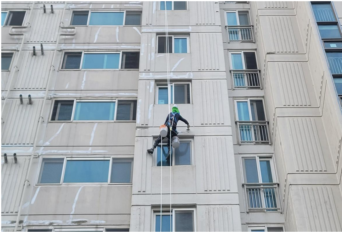
외벽 균열 보수 1차
