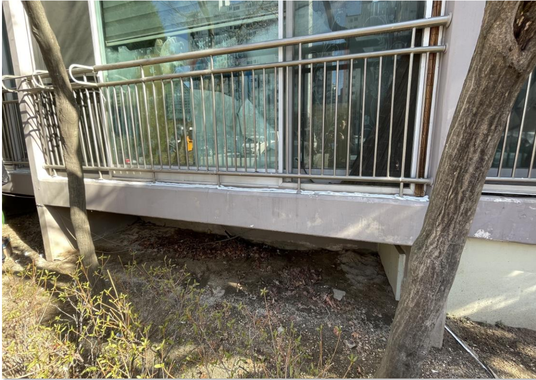
베란다 난간 턱 전체 코킹공사
