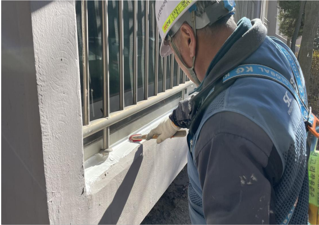
베란다 난간 턱 전체 코킹공사
