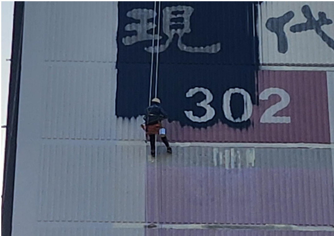
수성페인트 도장
