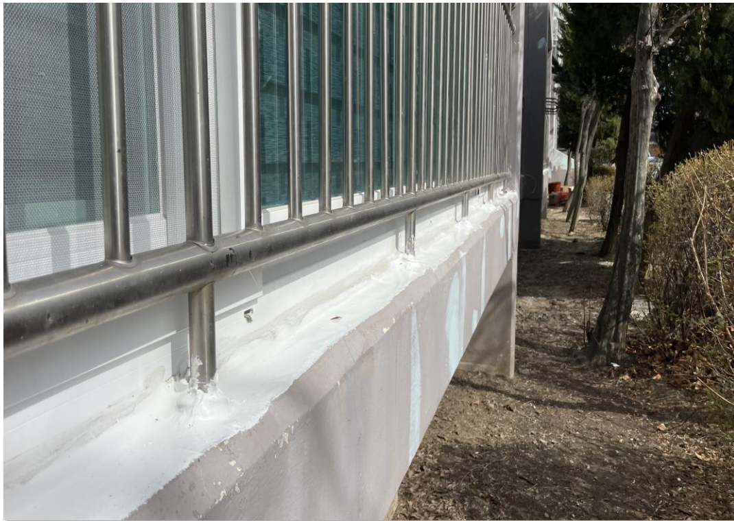
베란다 난간 턱 전체 코킹공사
