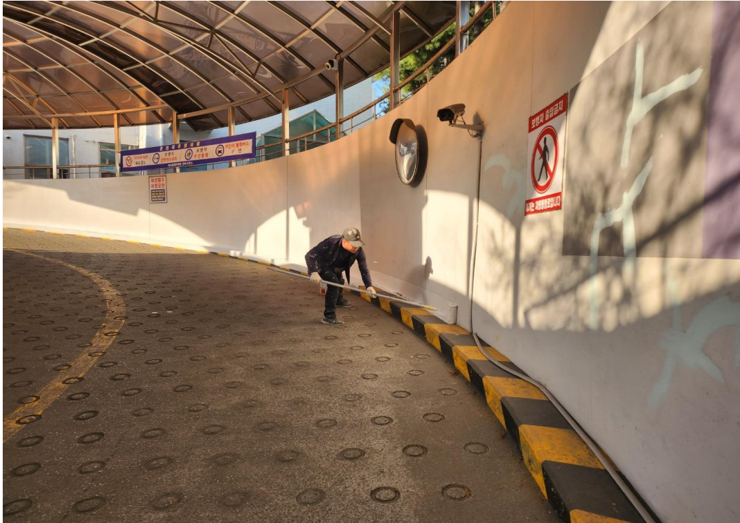
지하주차장 램프 내부 수성페인트 도장
