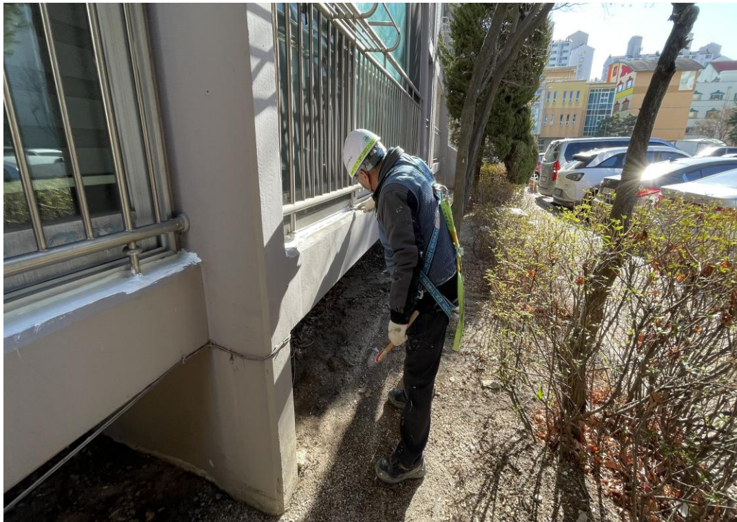
베란다 난간 턱 전체 코킹공사
