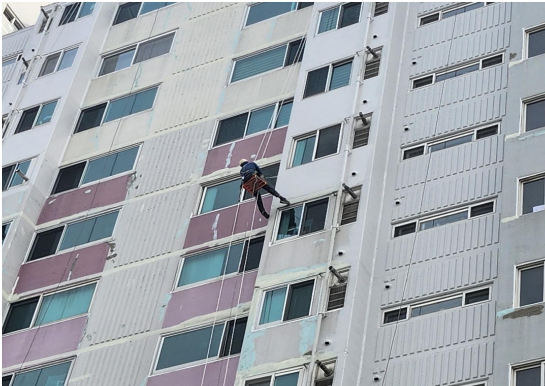
수성페인트 도장
