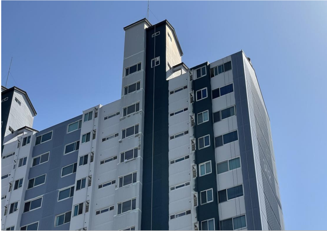
수성페인트 도장
