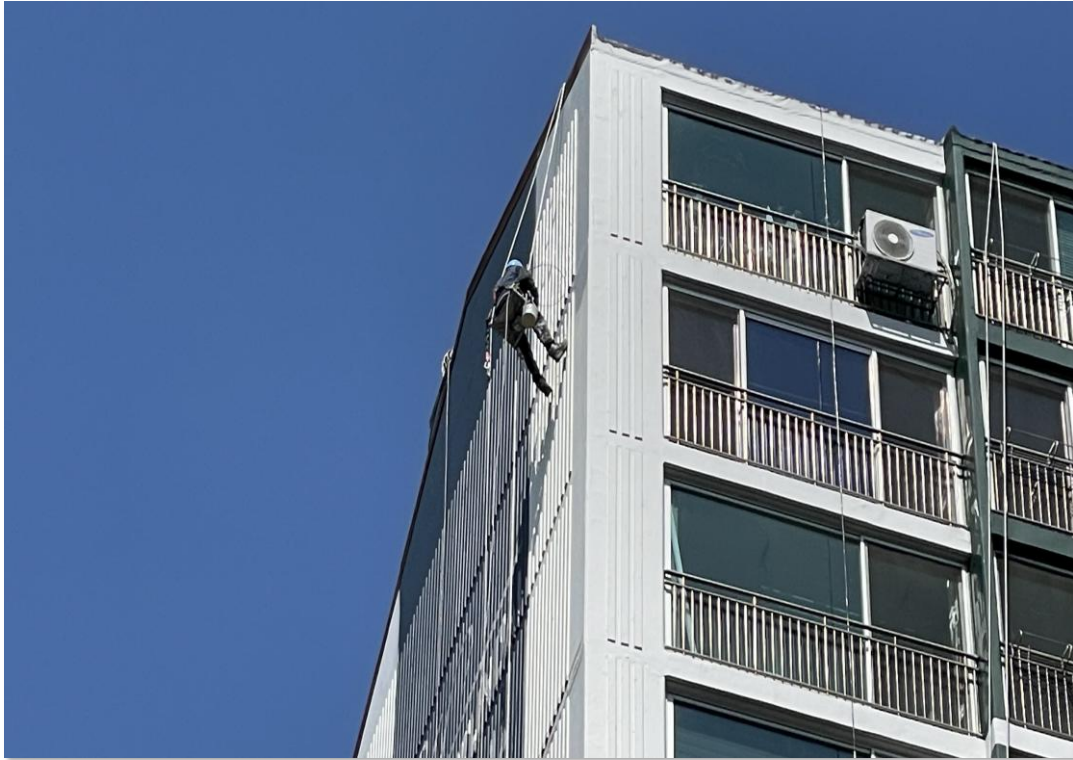
수성페인트 도장
