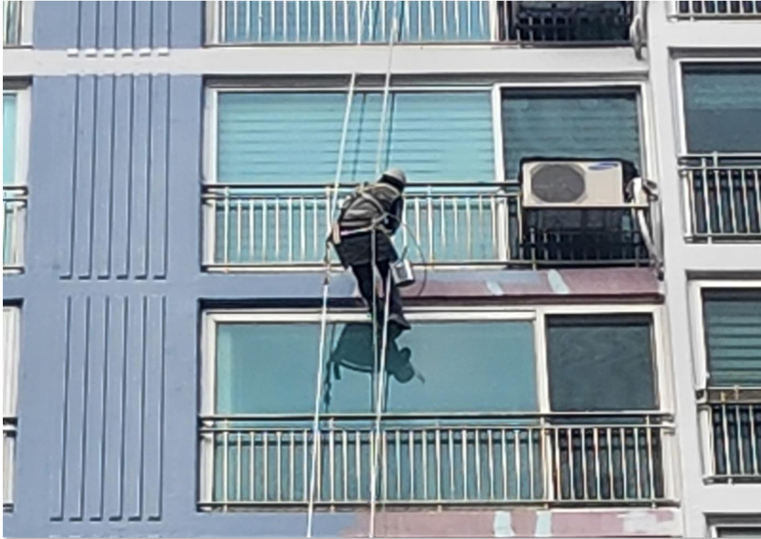
수성페인트 도장
