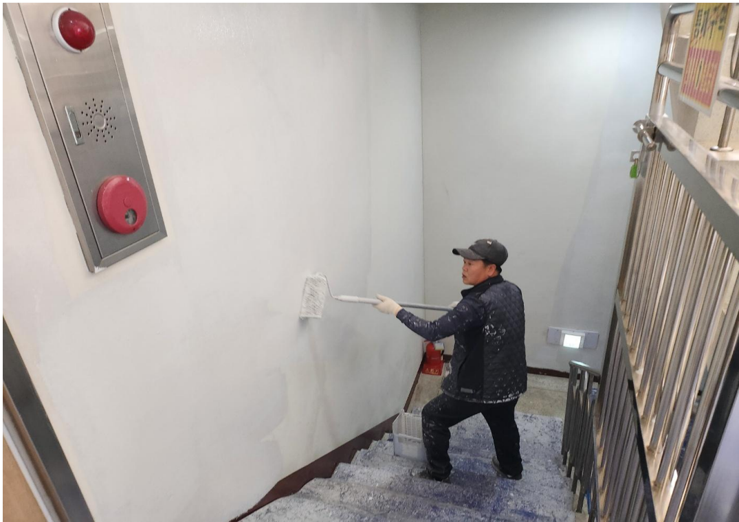
지하주차장 진입계단 내부 수성페인트 도장
