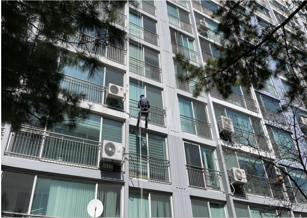
수성페인트 도장
