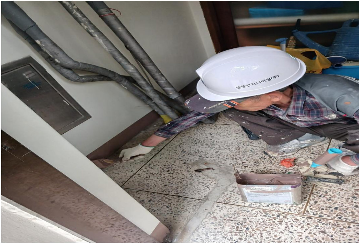
내부 균열 보수 및 부대시설 도장
