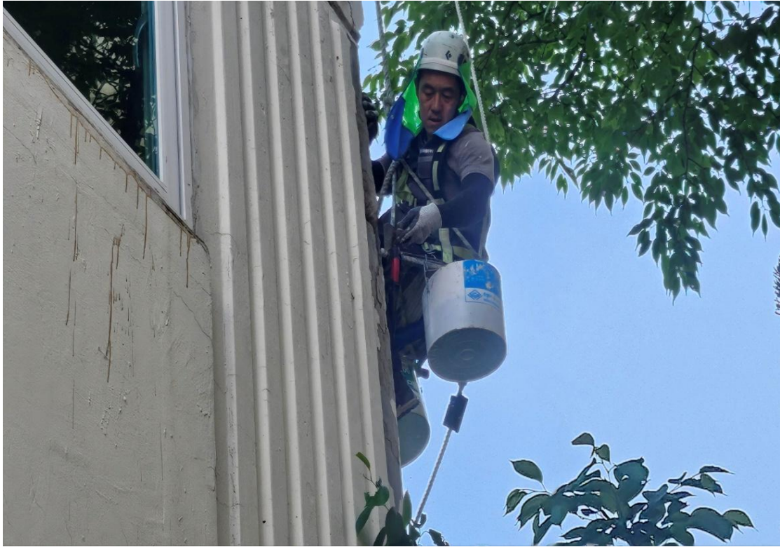
외부 균열보수 및 층간 조인트 보수
