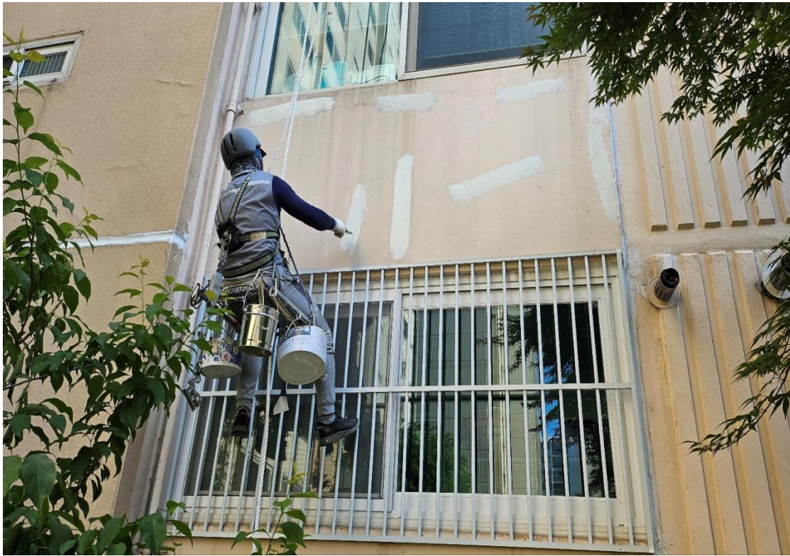
외부 균열보수 및 층간 조인트 보수
