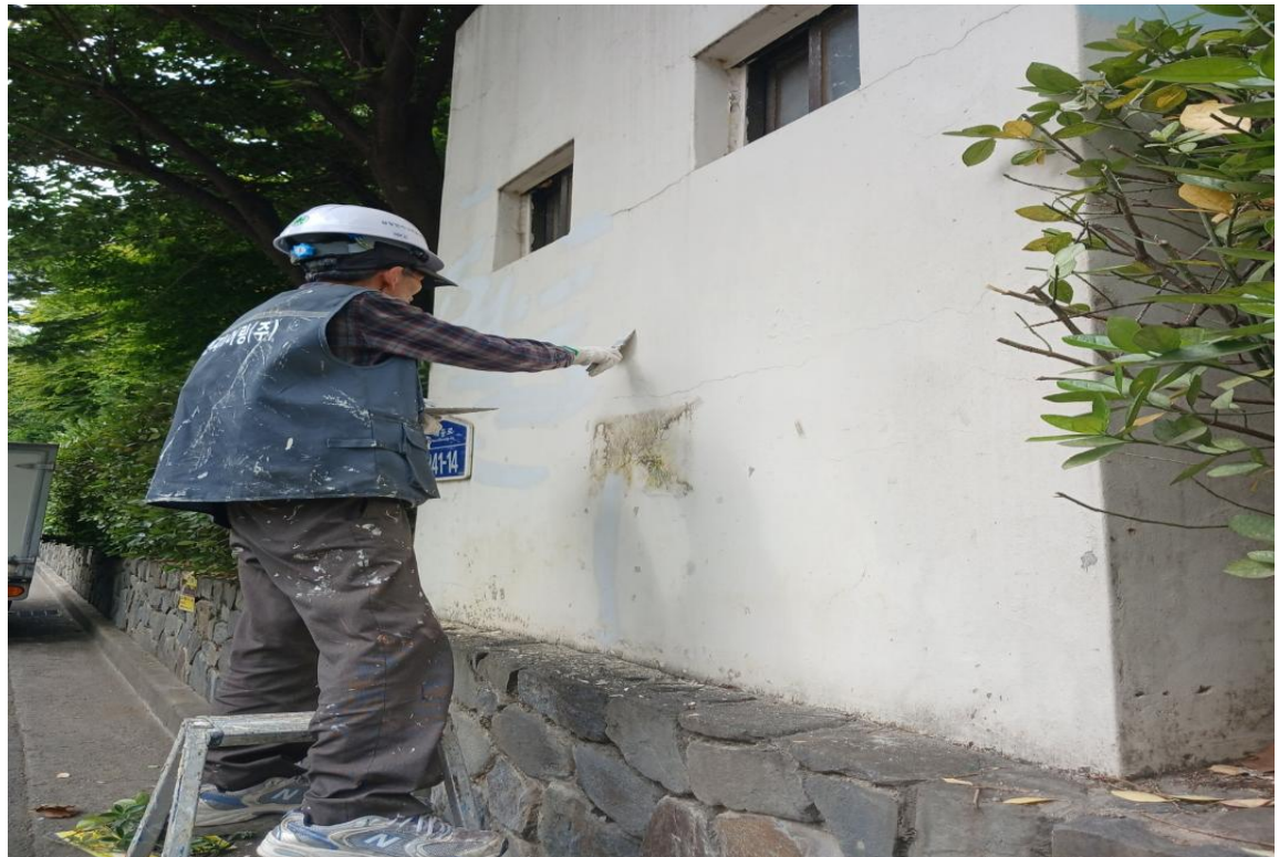
내부 균열 보수 및 부대시설 도장
