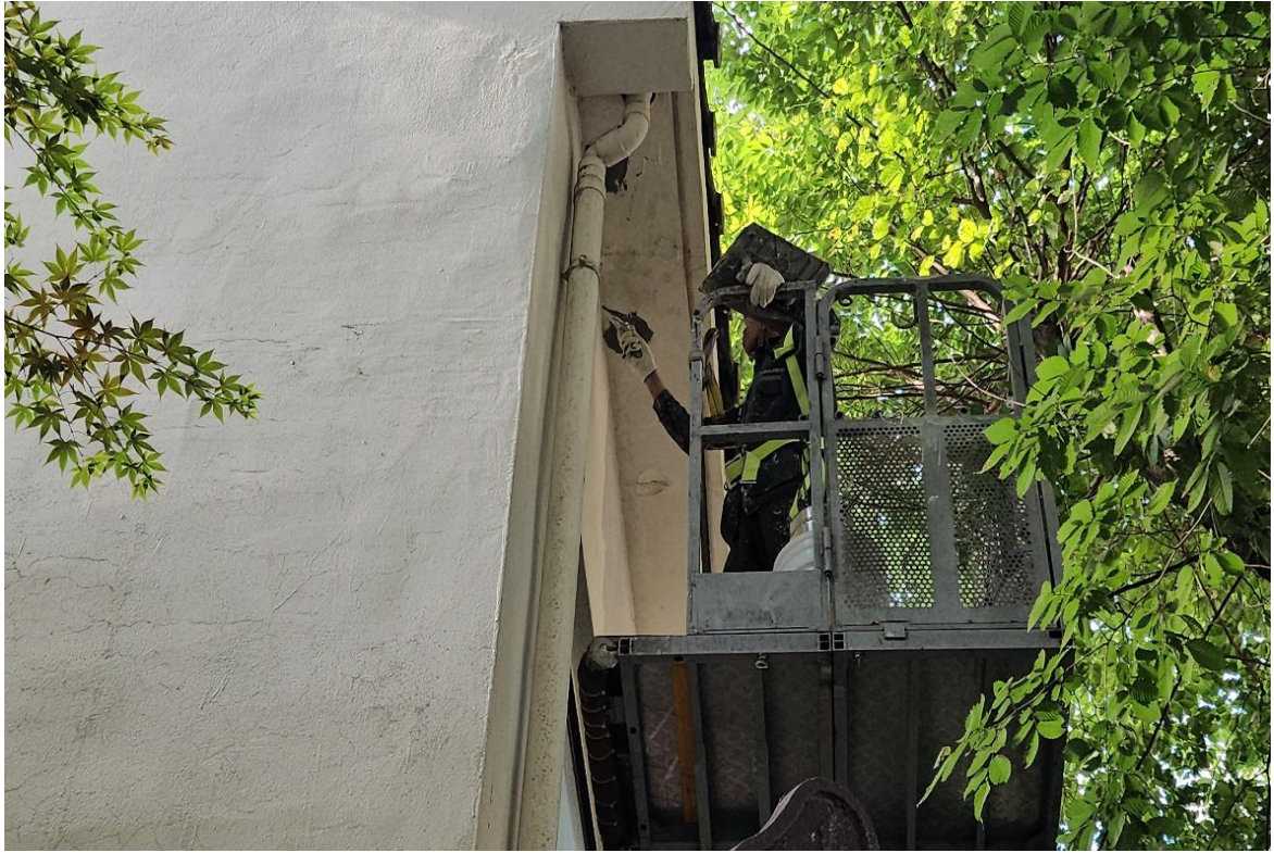
내부 균열 보수 및 부대시설 도장
