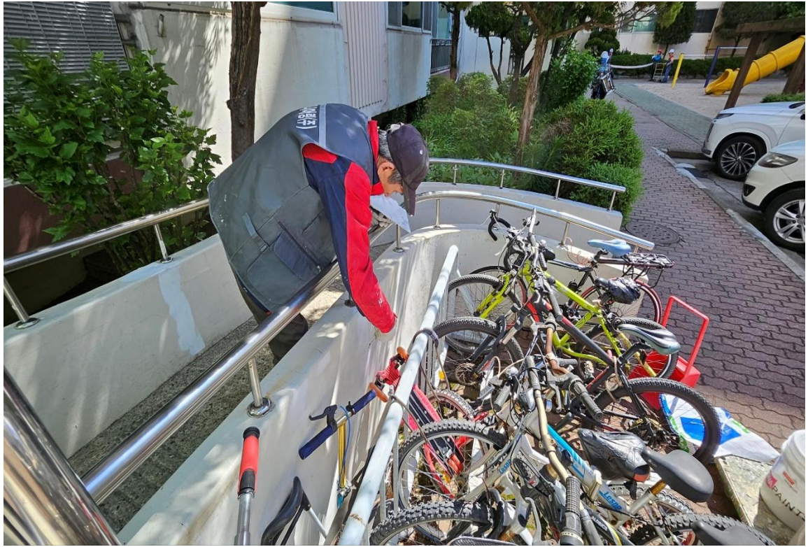
내부 균열 보수 및 부대시설 도장
