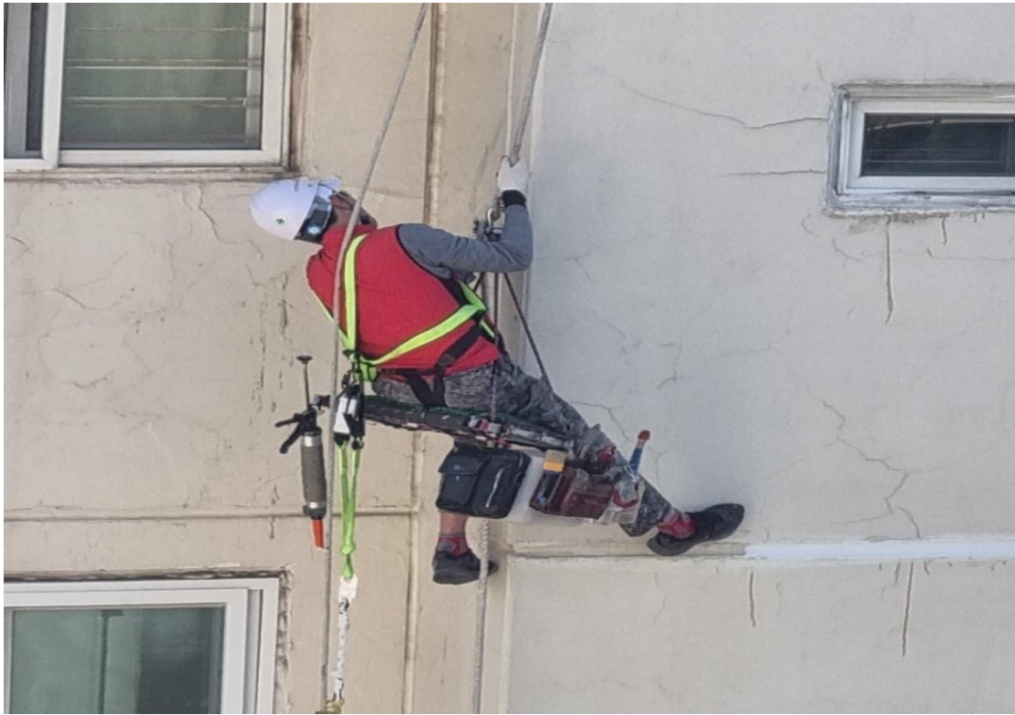
외벽 코킹 작업
