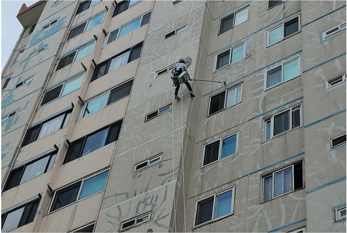
외부 균열보수 및 층간 조인트 보수
