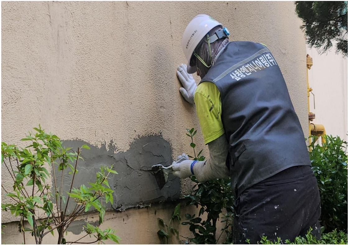
외부 균열보수 및 층간 조인트 보수
