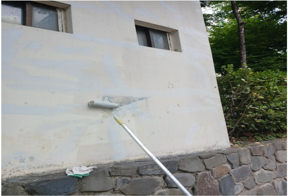
내부 균열 보수 및 부대시설 도장
