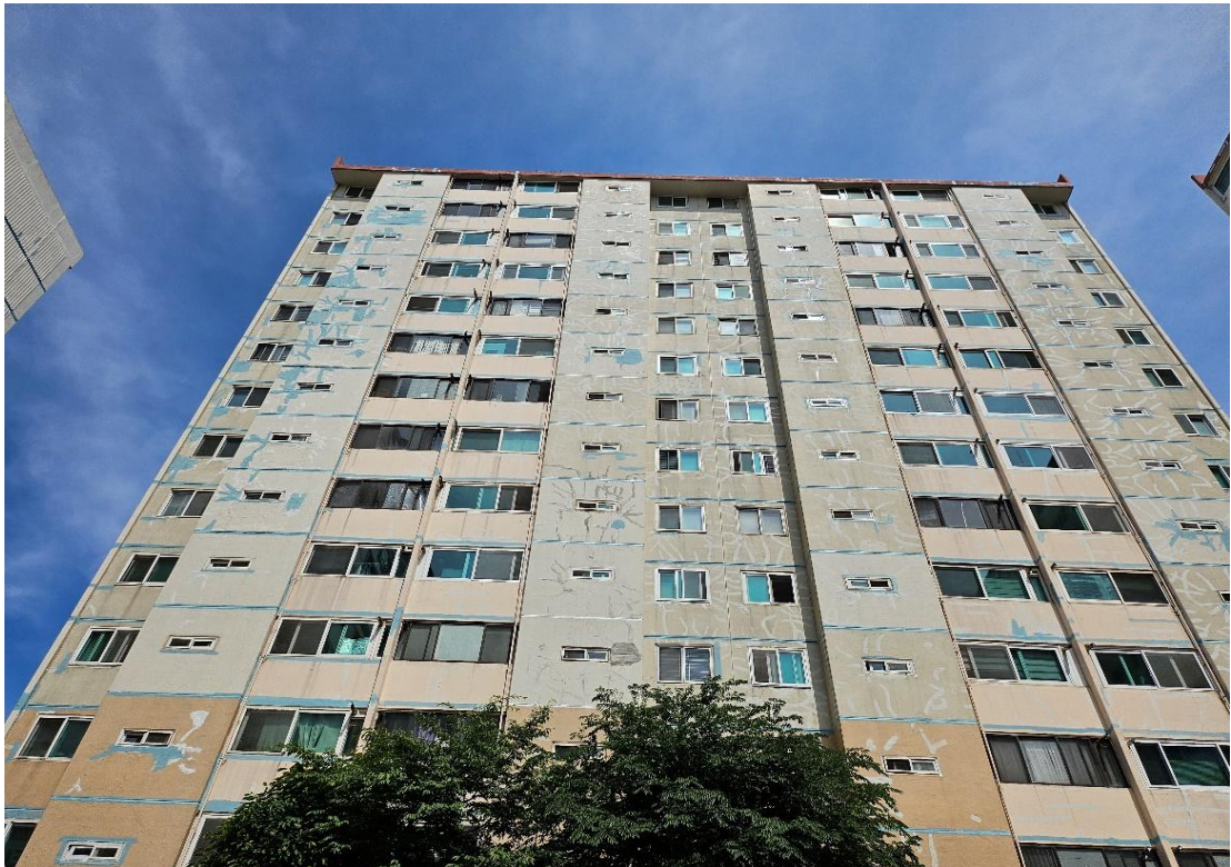
외부 균열보수 및 층간 조인트 보수
