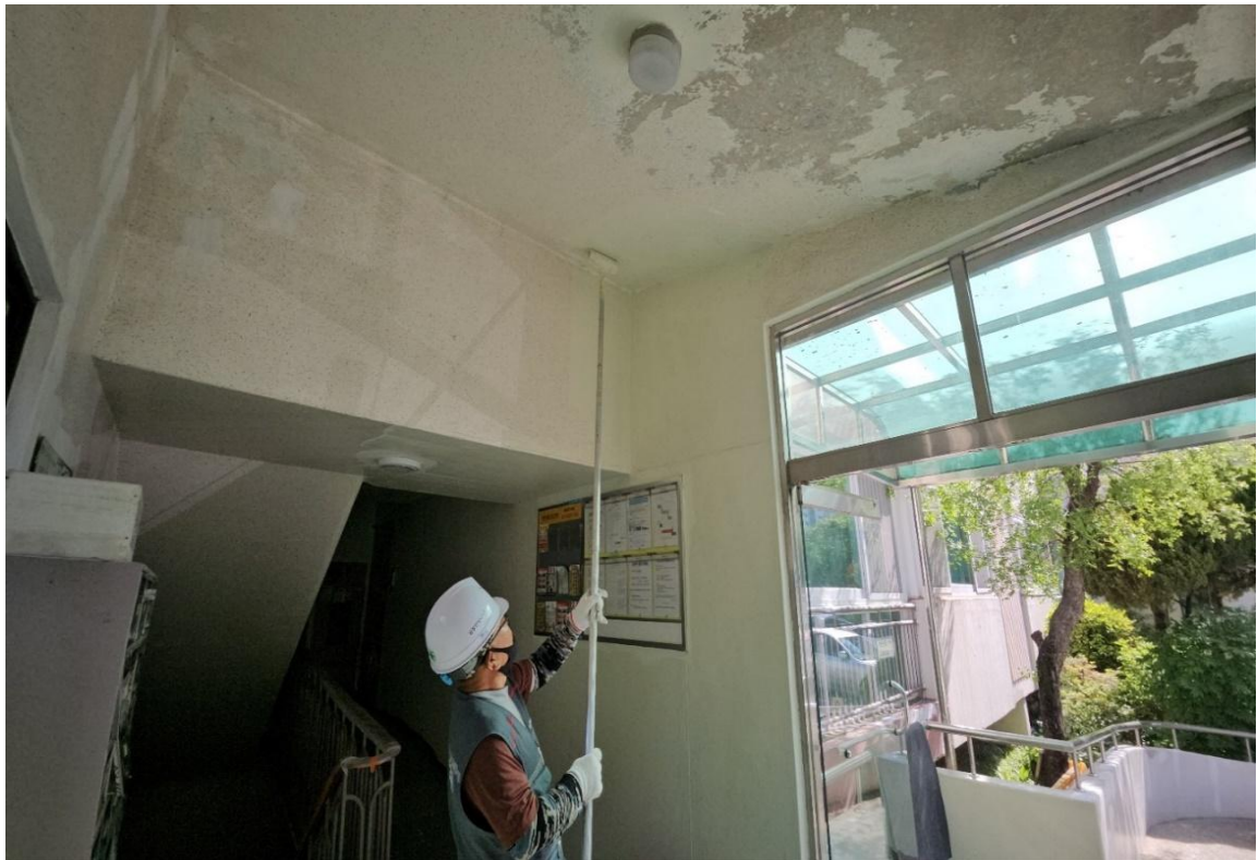
내부 균열 보수 및 부대시설 도장
