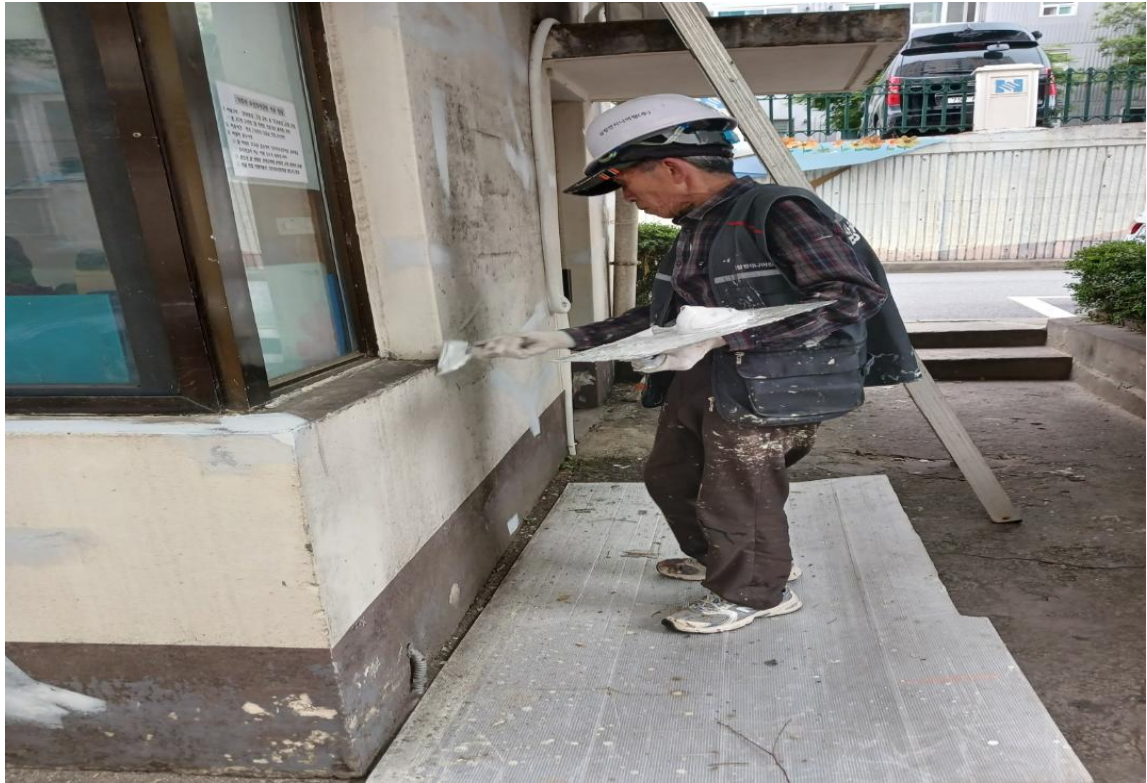
내부 균열 보수 및 부대시설 도장
