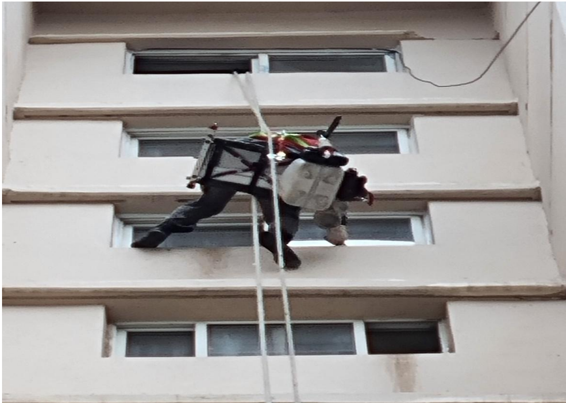
외벽 코킹 작업
