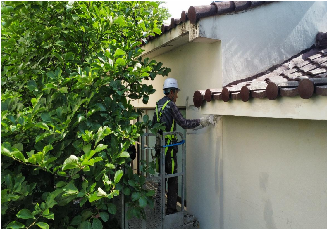
내부 균열 보수 및 부대시설 도장
