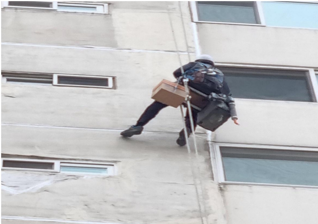
외벽 코킹 작업
