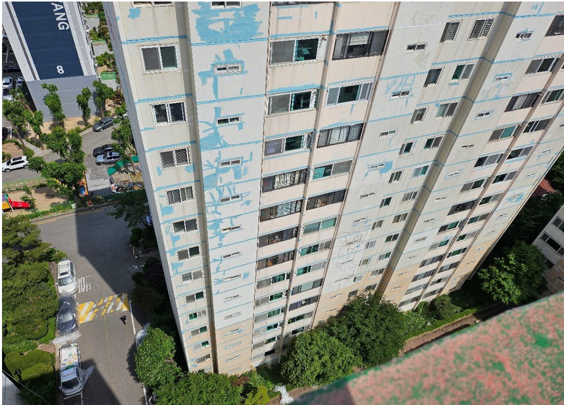
외부 균열보수 및 층간 조인트 보수
