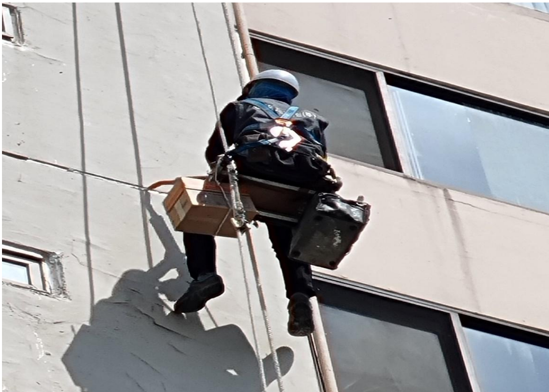
외벽 코킹 작업
