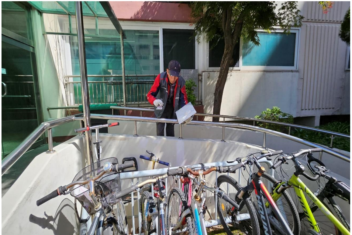
내부 균열 보수 및 부대시설 도장
