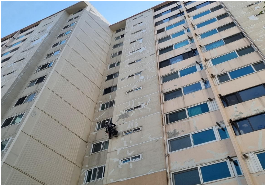
외벽 코킹 작업
