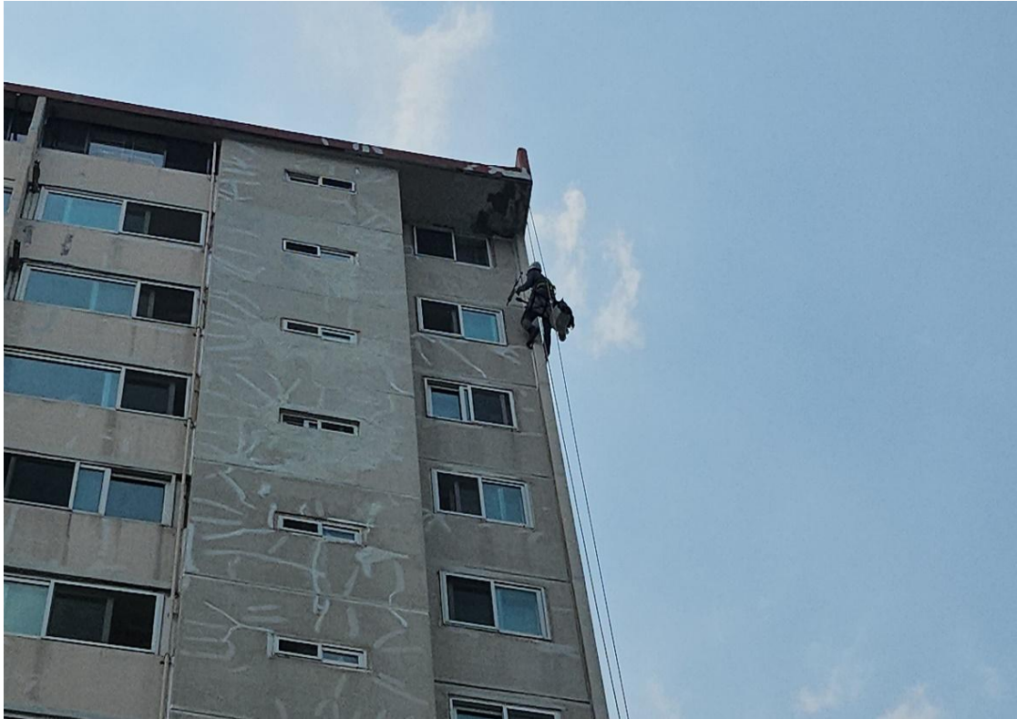
외벽 코킹 작업
