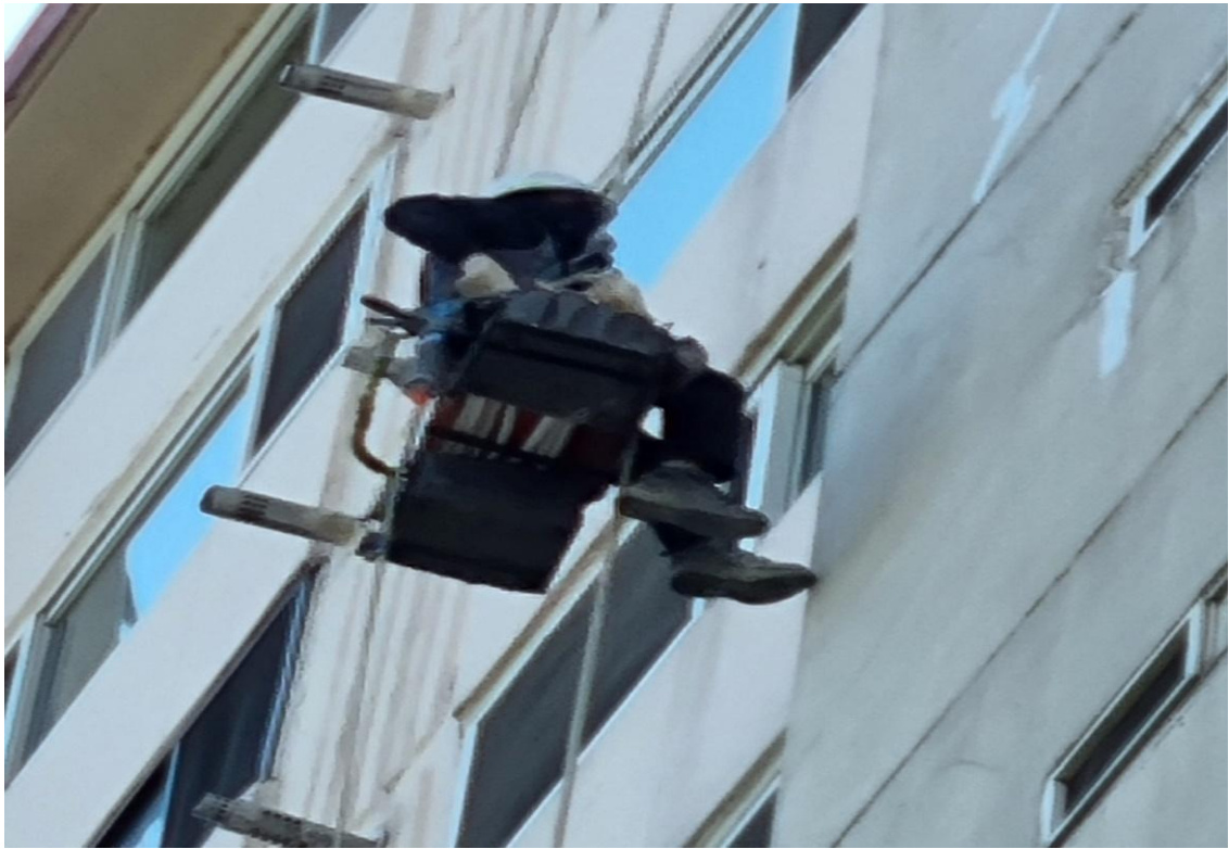
외벽 코킹 작업
