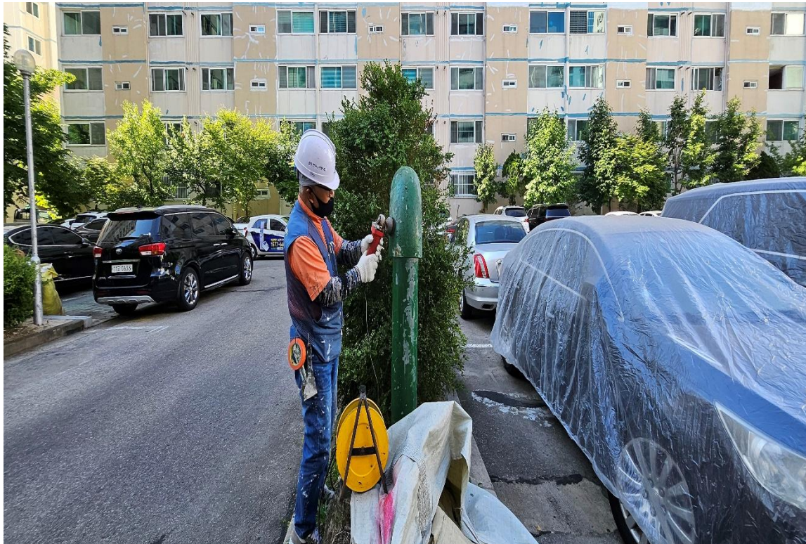
내부 균열 보수 및 부대시설 도장
