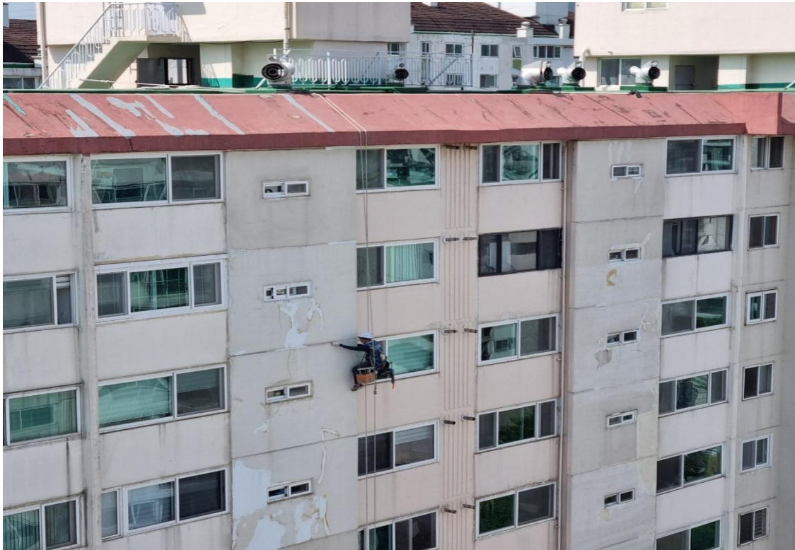
외벽 코킹 작업
