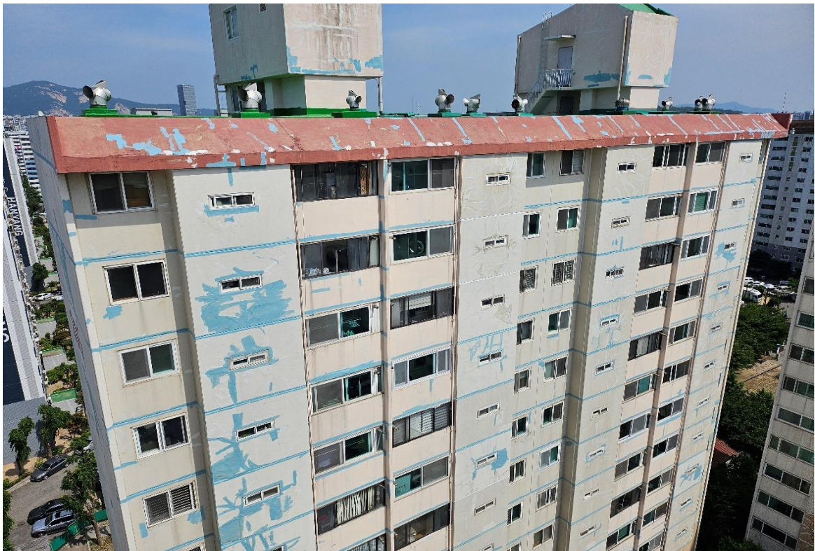
외부 균열보수 및 층간 조인트 보수
