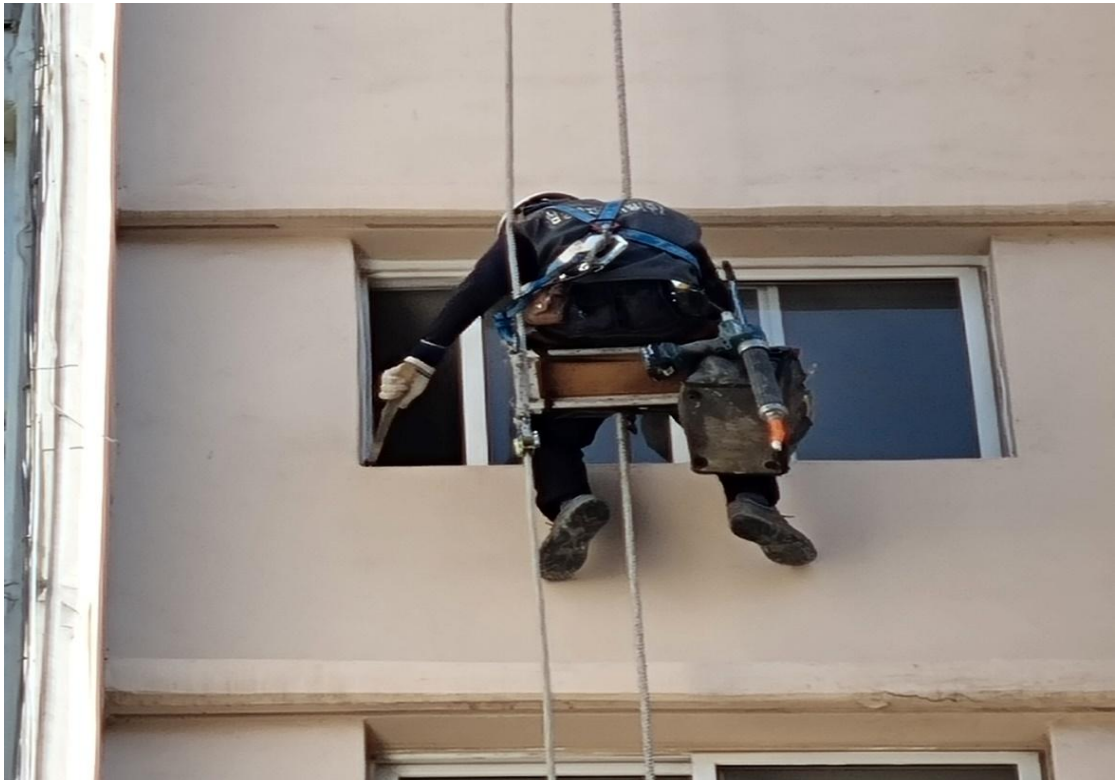
외벽 코킹 작업
