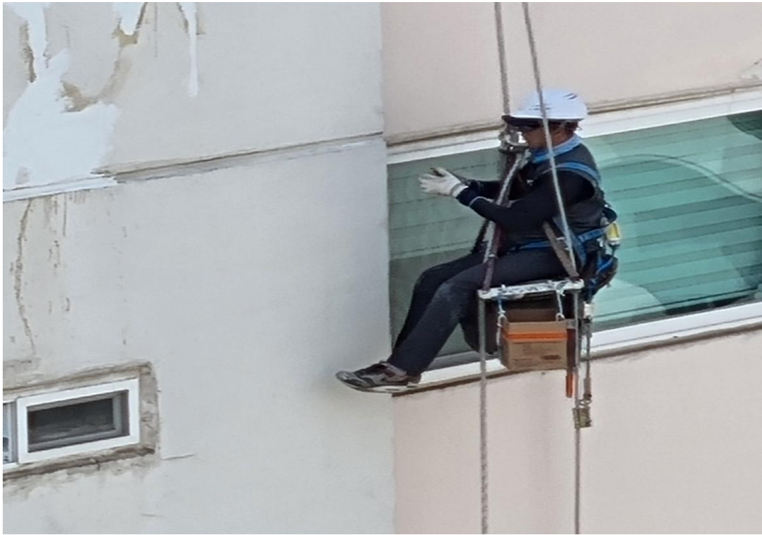
외벽 코킹 작업
