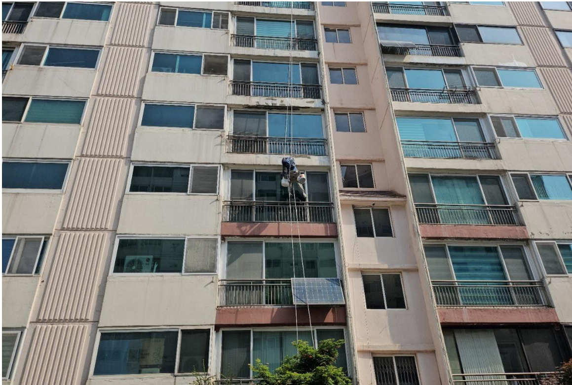
외부 균열보수 및 층간 조인트 보수
