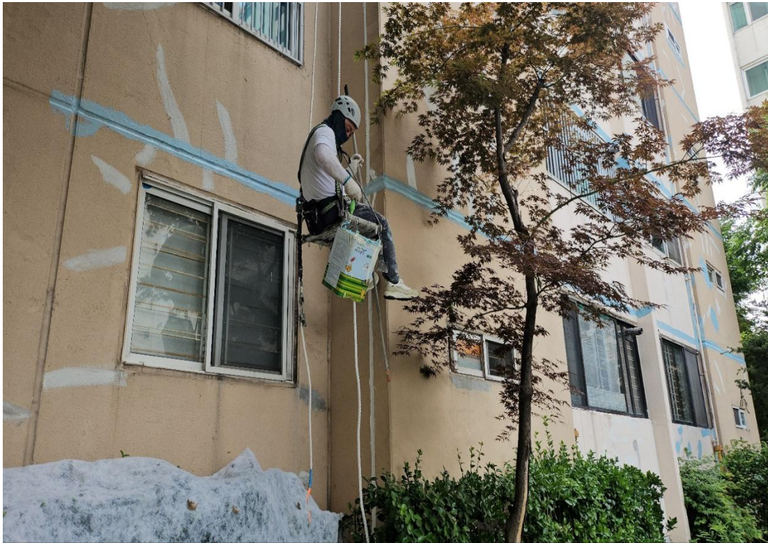
외부 균열보수 및 층간 조인트 보수
