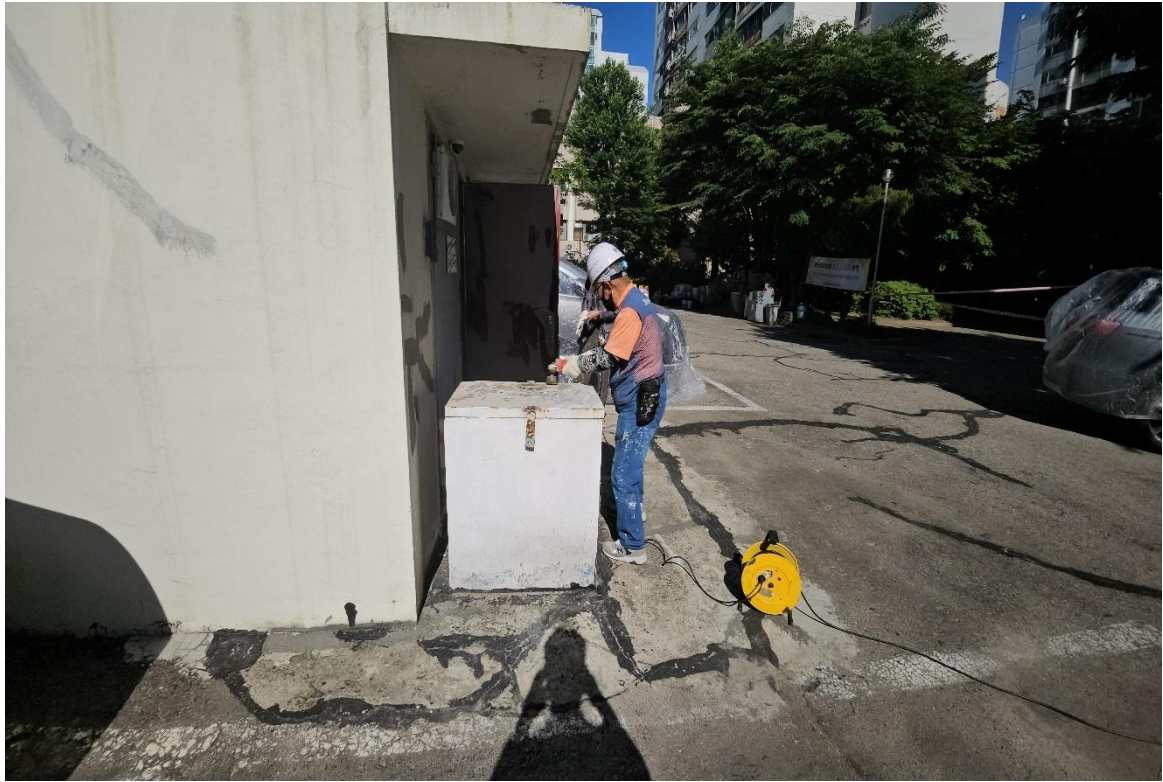
내부 균열 보수 및 부대시설 도장
