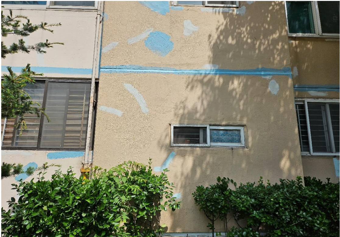
외부 균열보수 및 층간 조인트 보수
