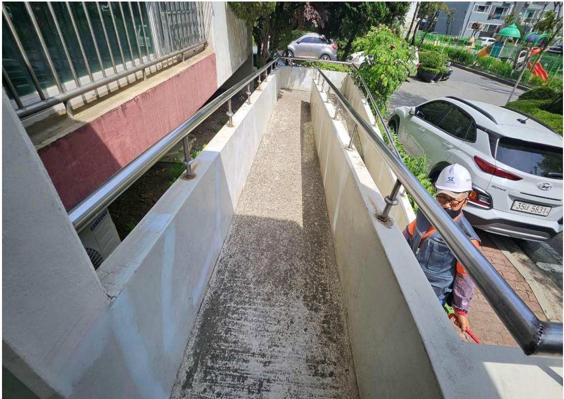
내부 균열 보수 및 부대시설 도장
