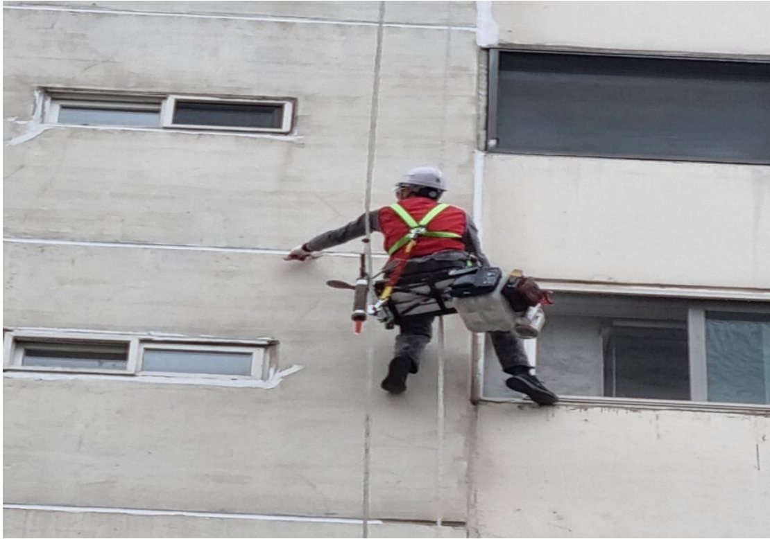
외벽 코킹 작업
