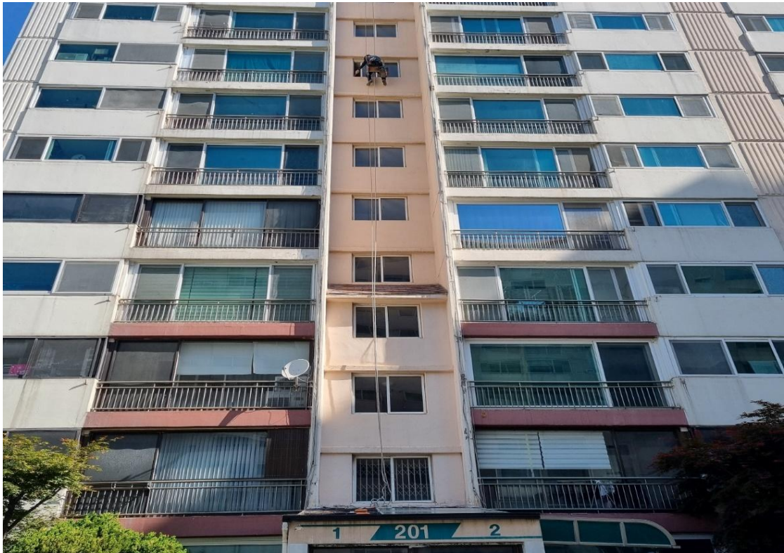
외벽 코킹 작업
