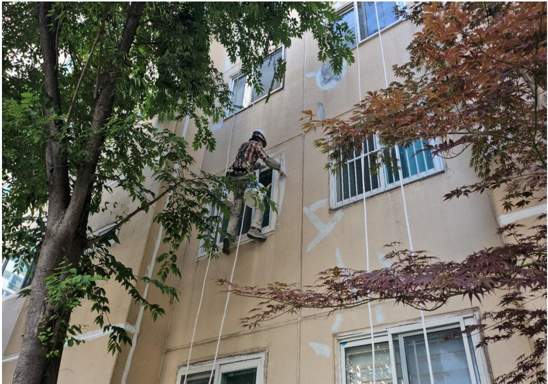
외부 균열보수 및 층간 조인트 보수
