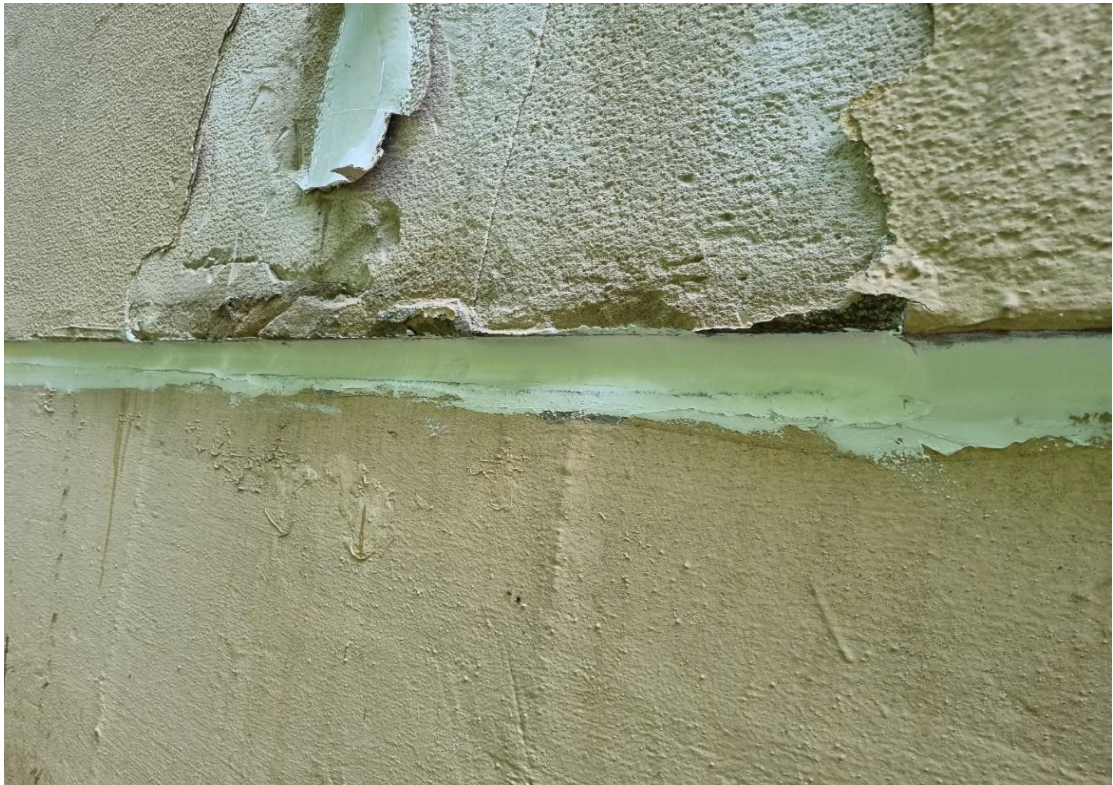
외벽 코킹 작업
