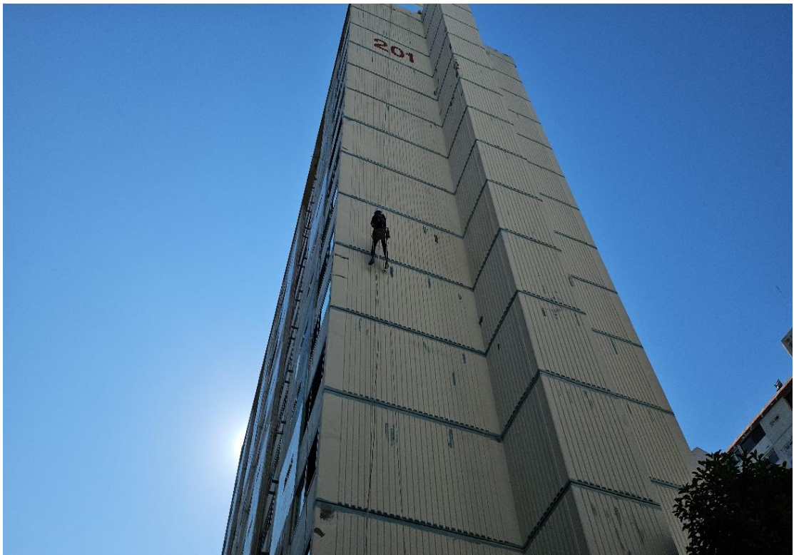
외부 균열보수 및 층간 조인트 보수
