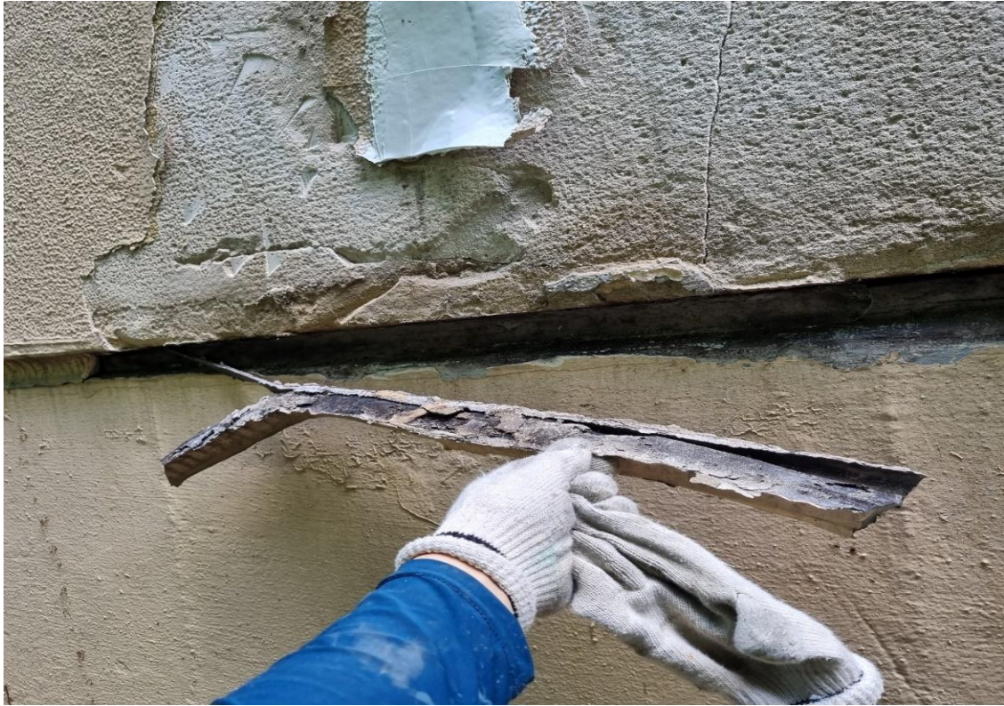
외벽 코킹 작업
