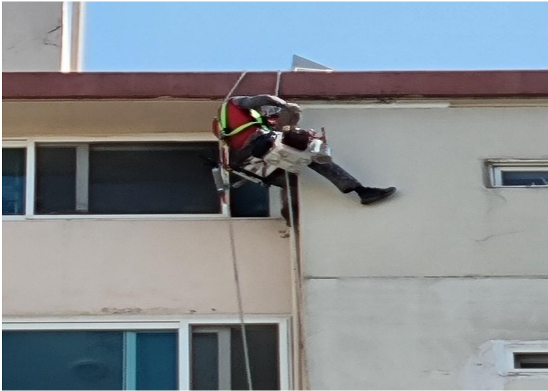
외벽 코킹 작업
