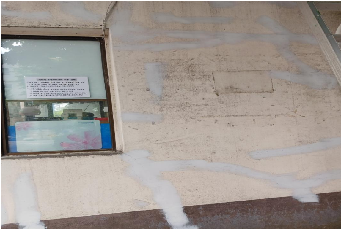
내부 균열 보수 및 부대시설 도장
