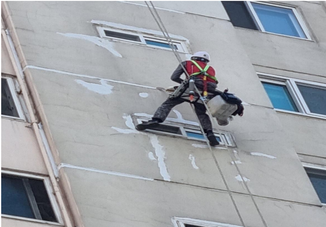
외벽 코킹 작업
