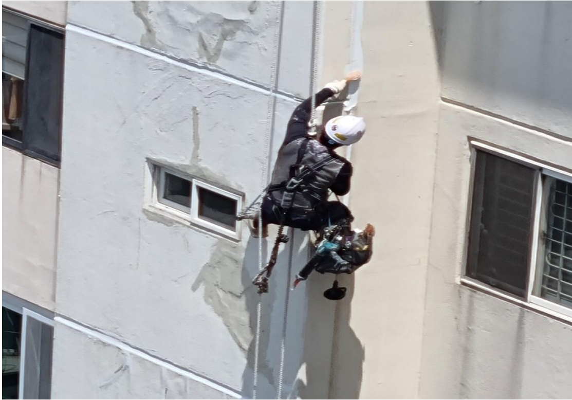
외벽 코킹 작업
