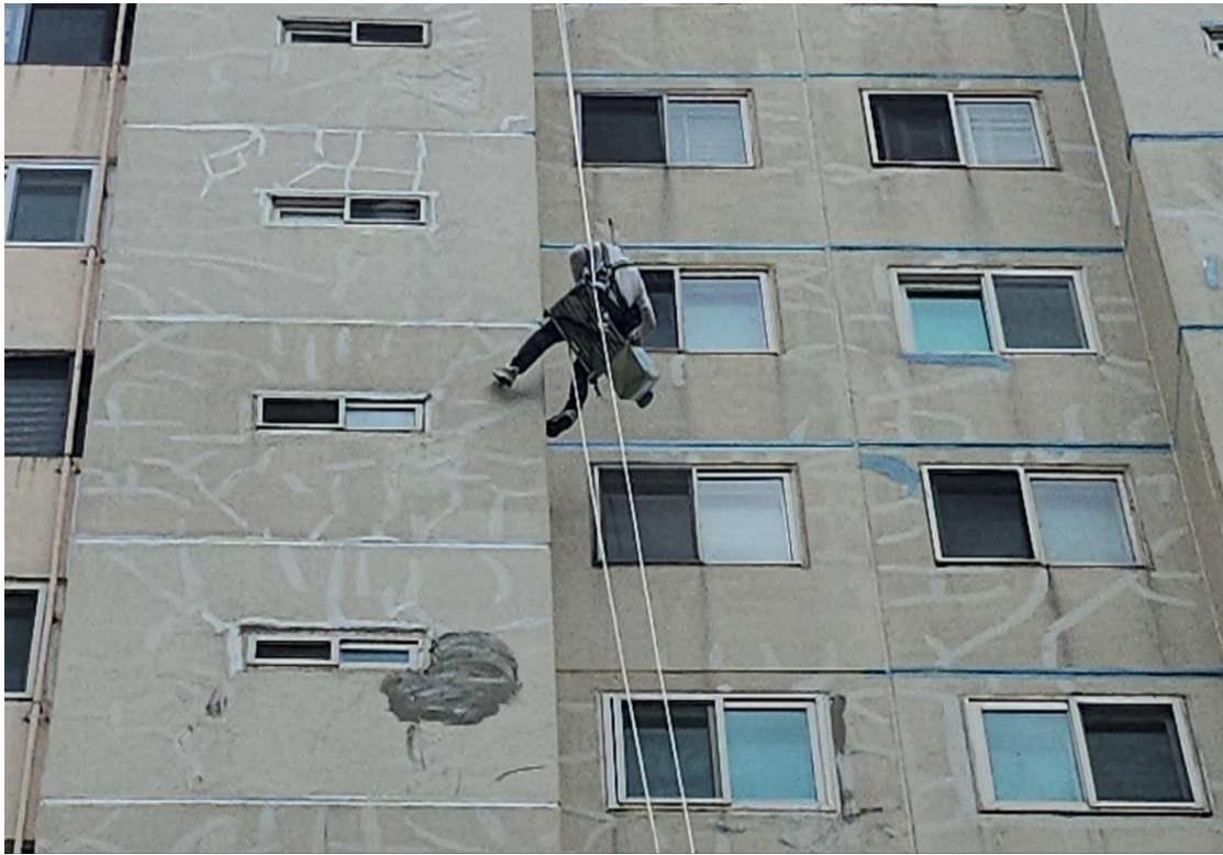
외부 균열보수 및 층간 조인트 보수
