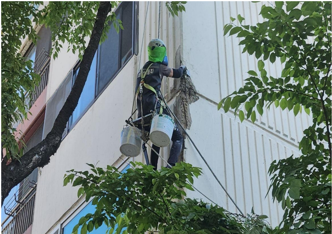
외부 균열보수 및 층간 조인트 보수
