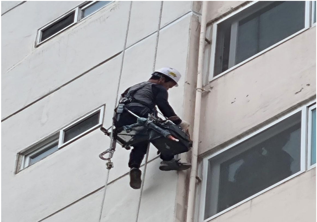
외벽 코킹 작업
