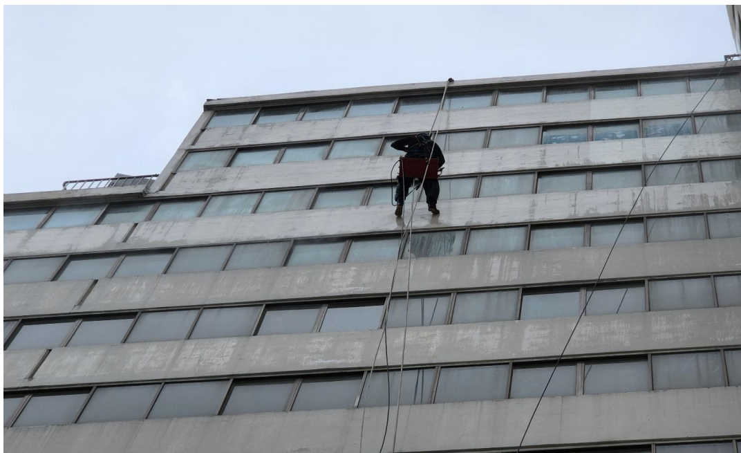
공사 중 : 외벽 고압세척
