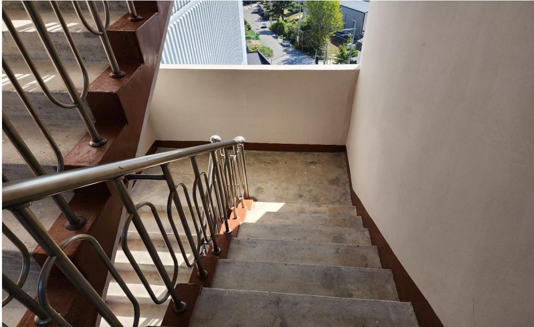
공사 후. : 내부도장 완료사진(비상계단실)
