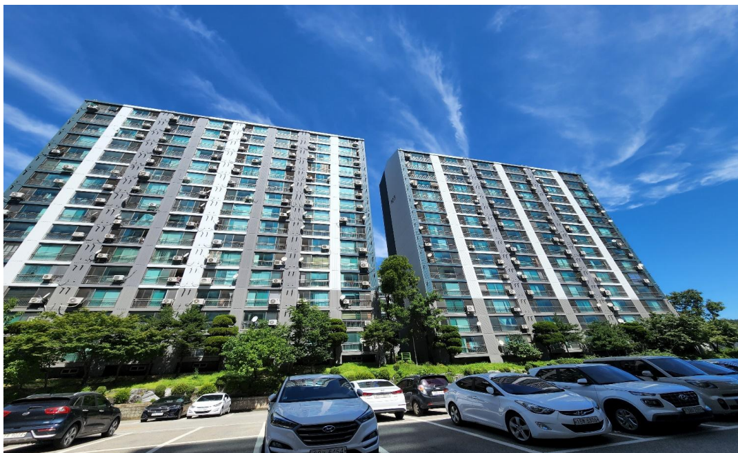
공사 후 : 외벽도장 완료 전경사진
