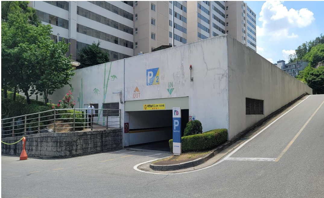
공사 전(주차장 외벽)
