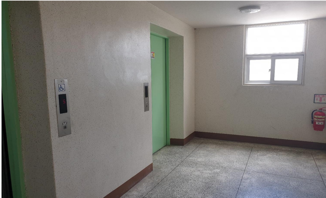
공사 전(내부 전경)
