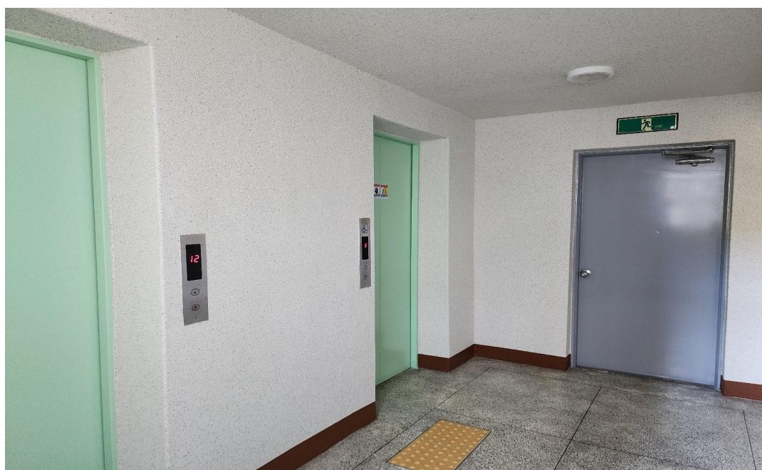
공사 후 : 내부도장 완료사진(계단실 및 E/V홀)
