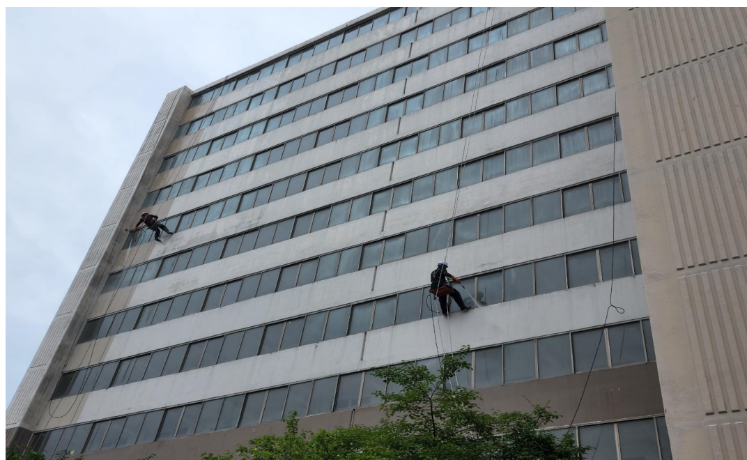
공사 중 : 외벽 고압세척
