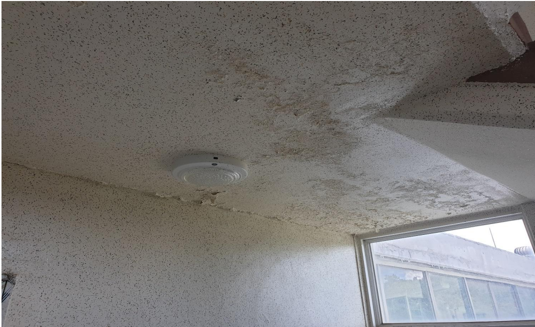
공사 전(내부 전경)
