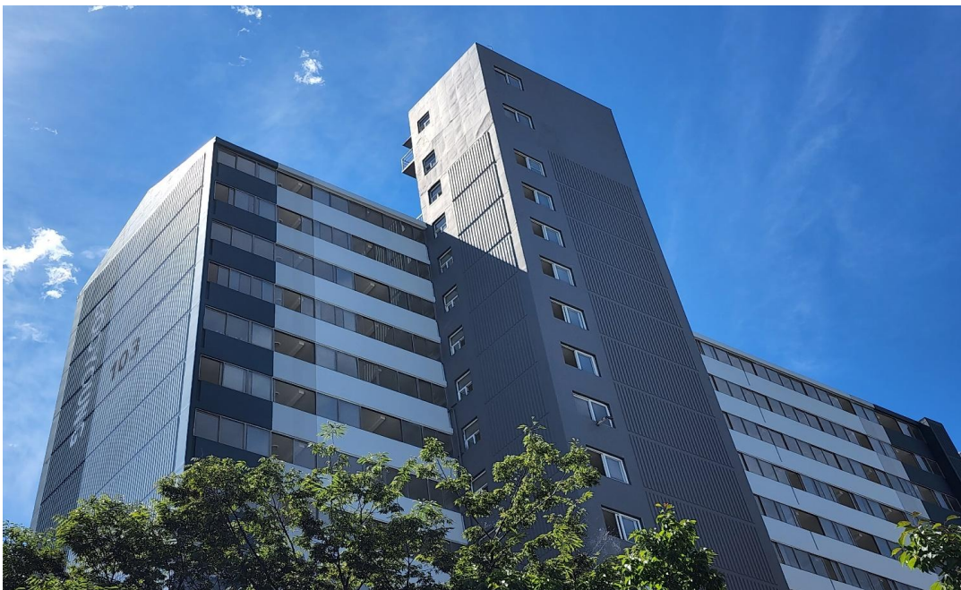
공사 후 : 외벽도장 완료 전경사진
