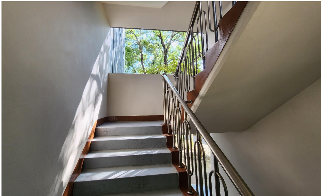
공사 후 : 내부도장 완료사진(비상계단실)
