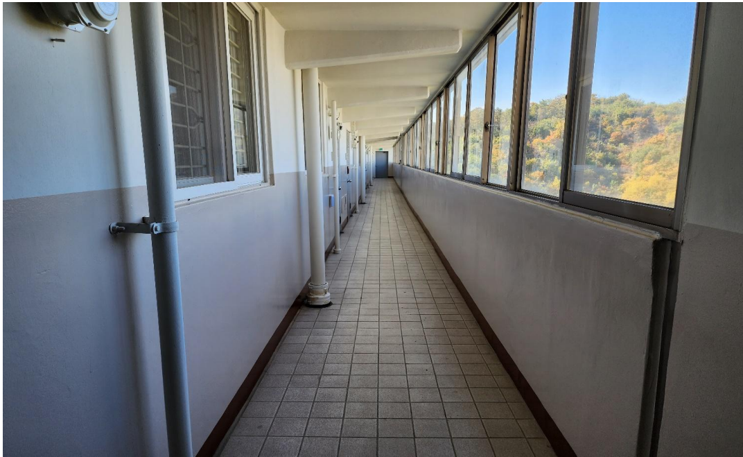
공사 후 : 내부도장 완료사진(복도)
