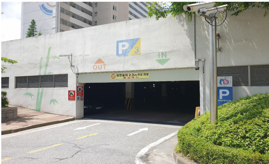
공사 전(주차장 외벽)
