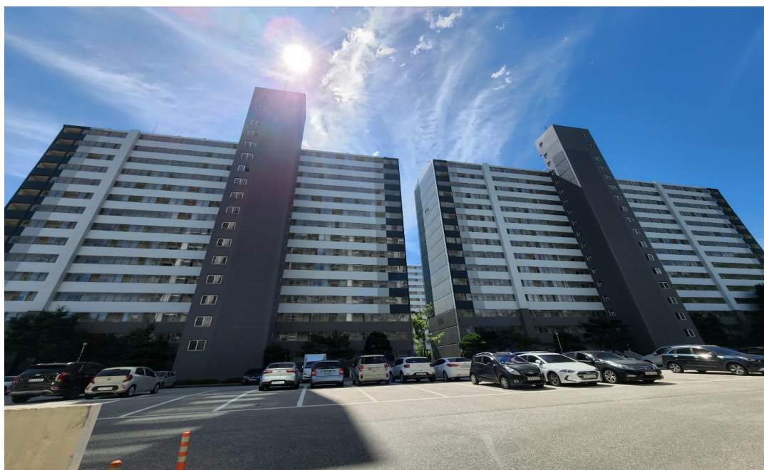
공사 후 : 외벽도장 완료 전경사진
