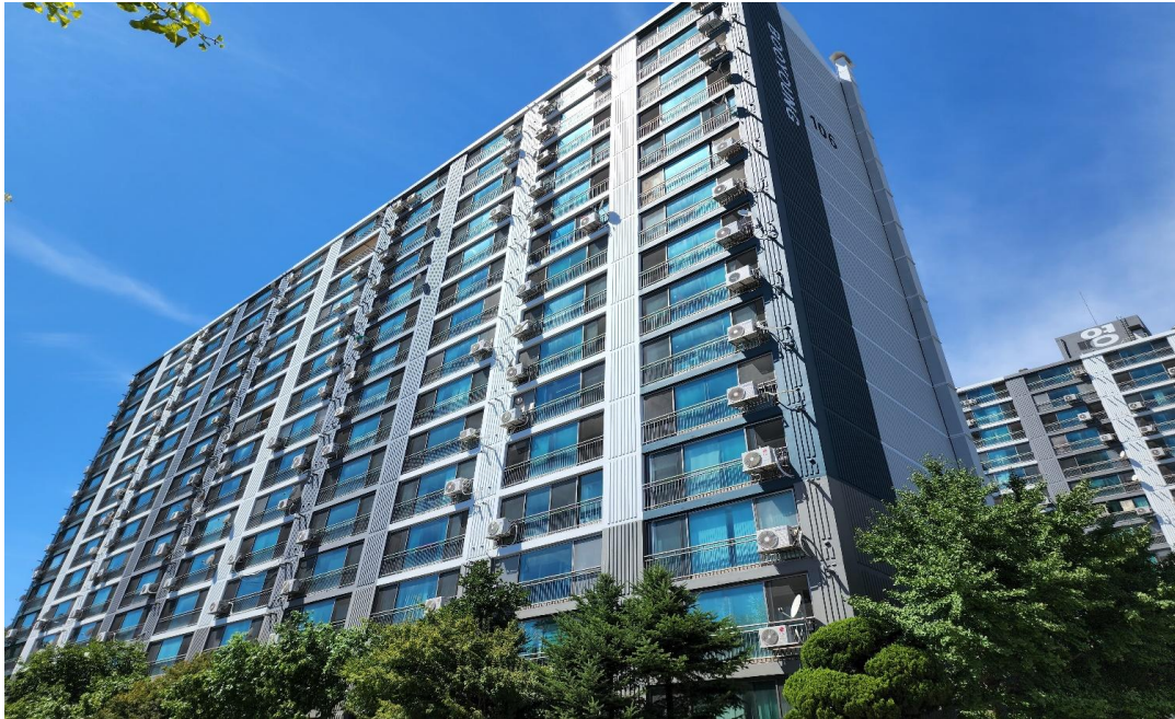
공사 후 : 외벽도장 완료 전경사진
