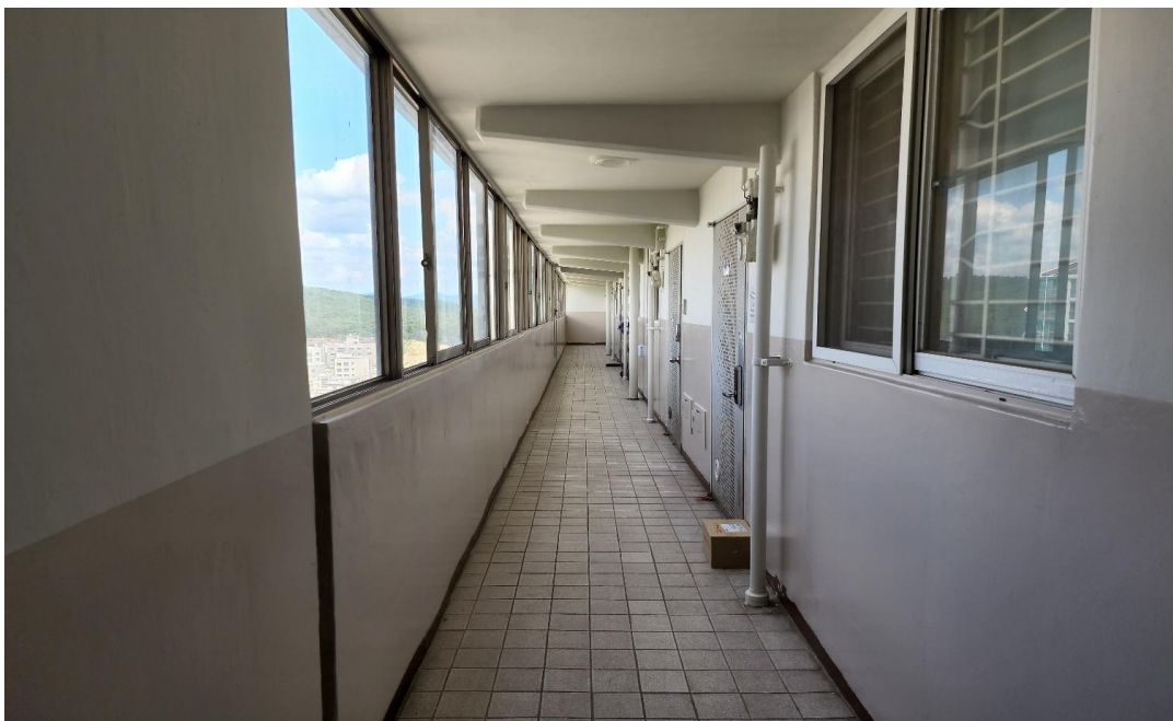
공사 후 : 내부도장 완료사진(복도)
