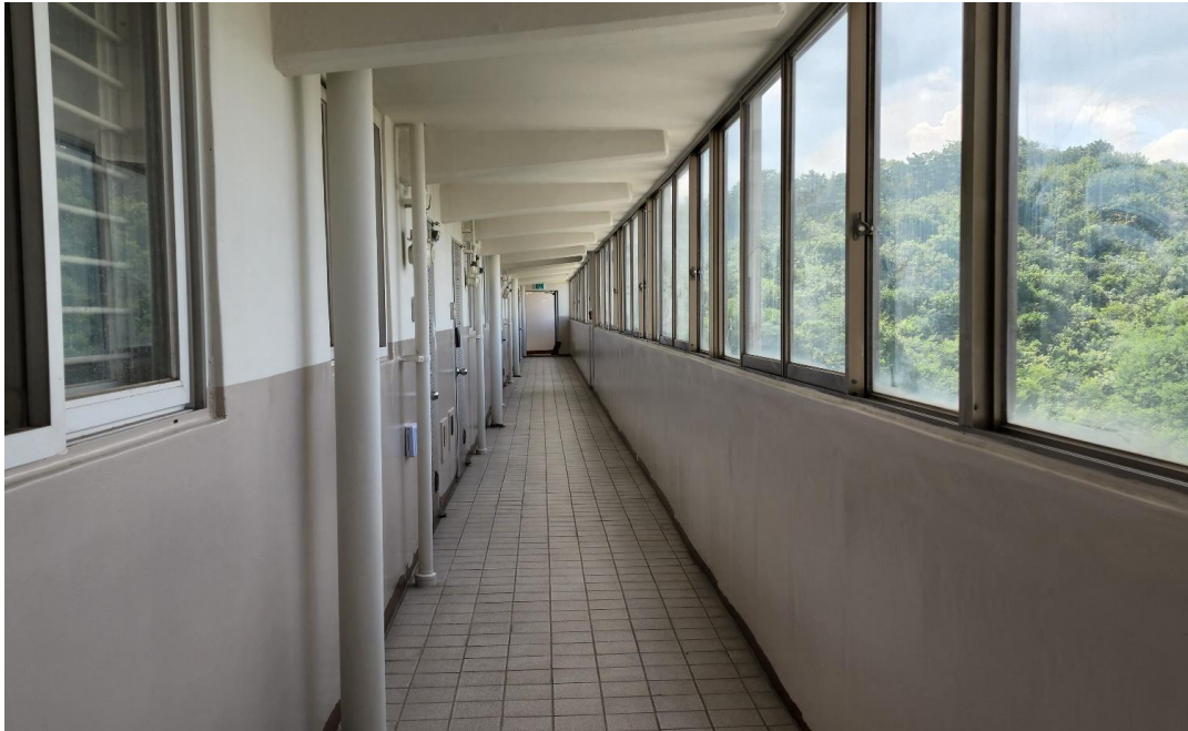
공사 후 : 내부도장 완료사진(복도)
