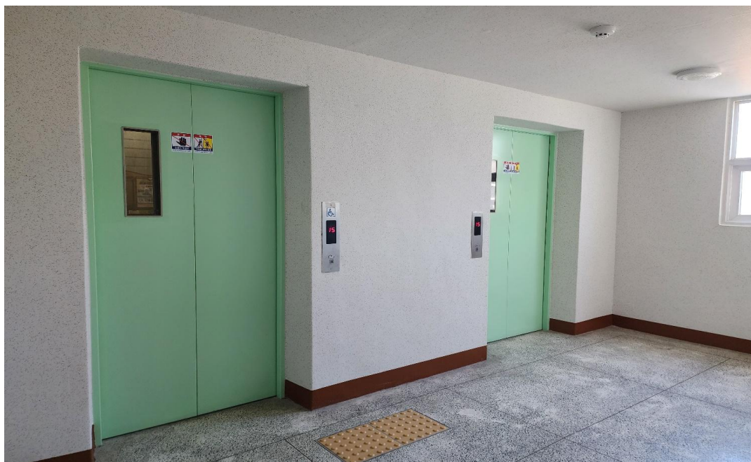
공사 후 : 내부도장 완료사진(계단실 및 E/V홀)
