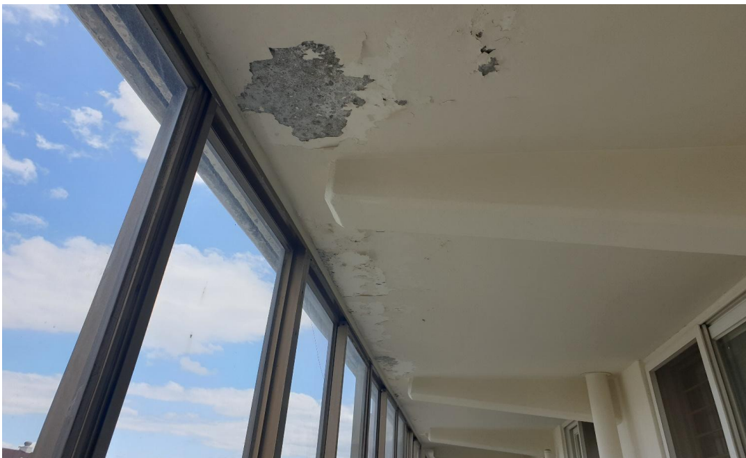
공사 전(내부 전경)
