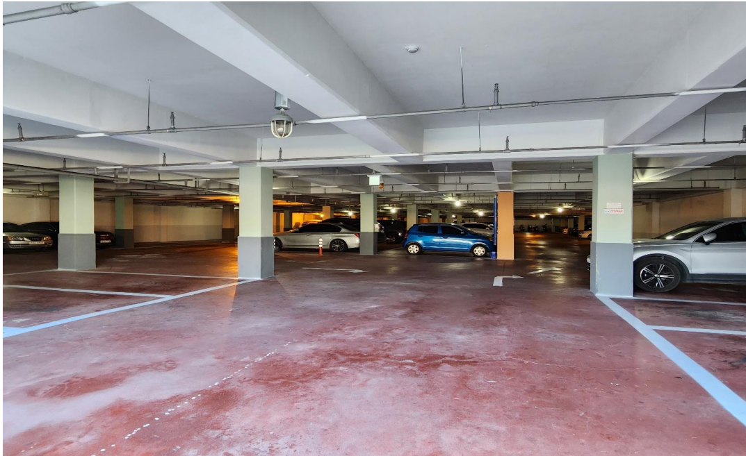
공사 후 : 지하주차장 완료사진
