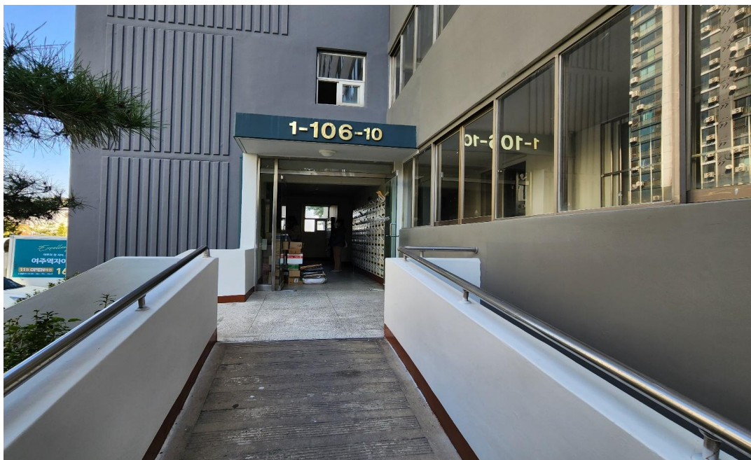
공사 후 : 각 동 아파트 출입구 스카시 및 단지안내도 교체 완료사진
