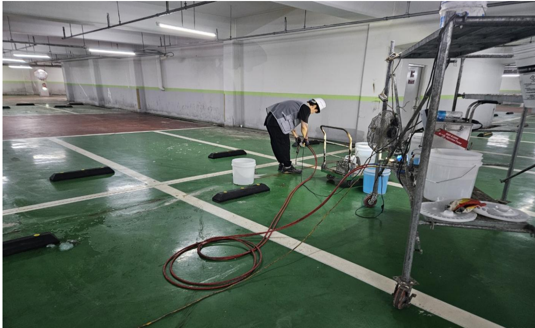
공사 중 (차수)
