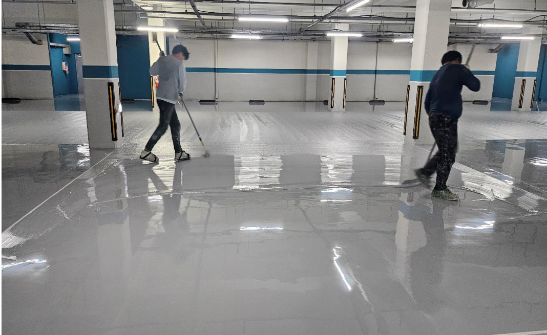
공사 중 (에폭시 엠보)
