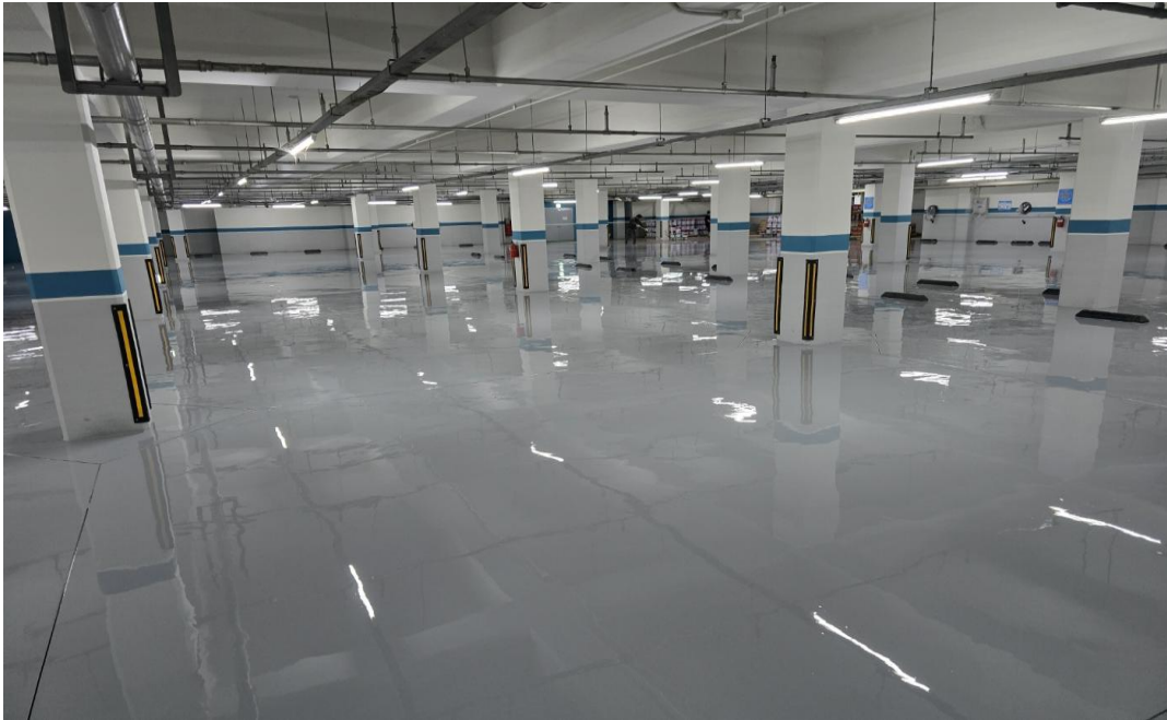
공사 중 (에폭시 라이닝)
