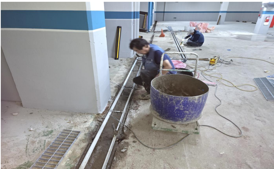
공사 중 (트렌치 교체)
