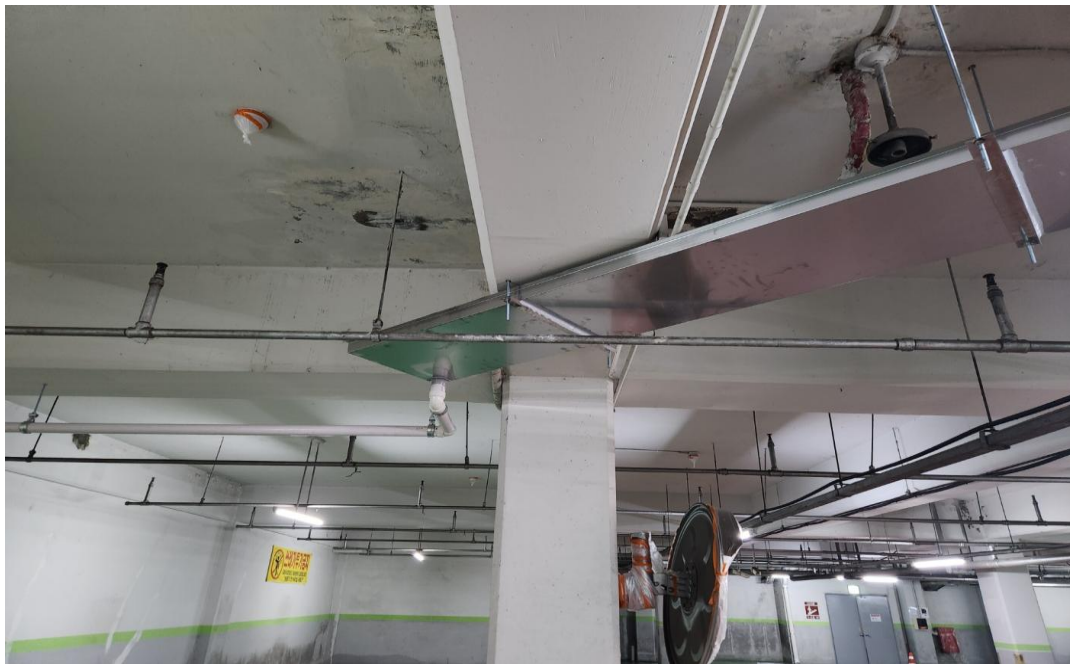
공사 중 (유도 배수)
