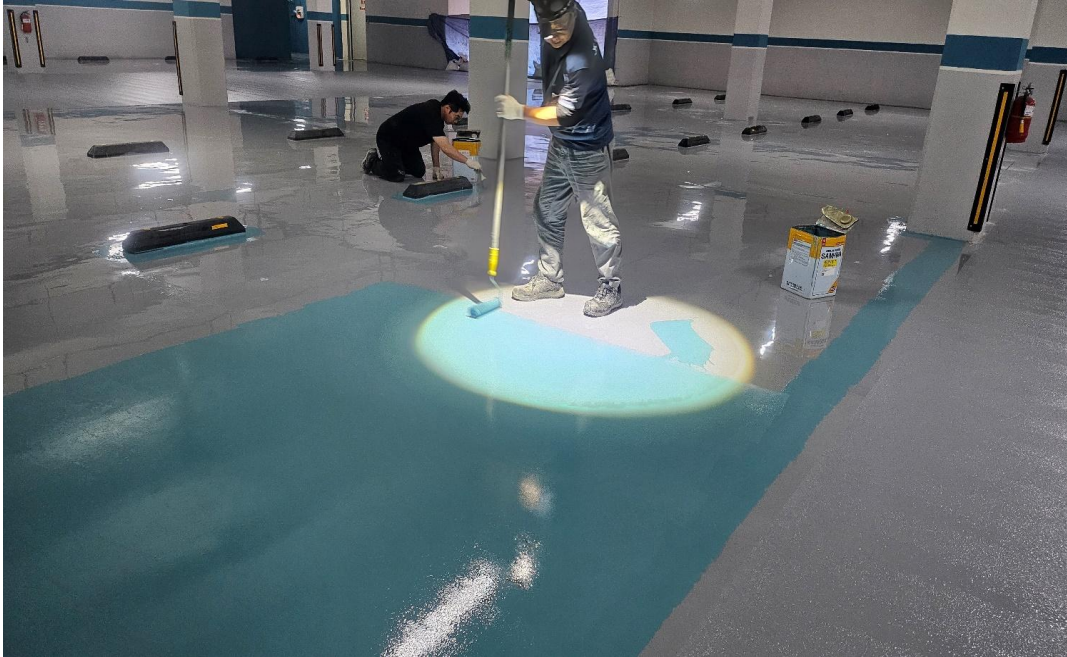
공사 중 (에폭시 상도)
