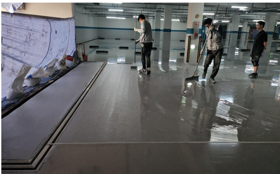
공사 중 (에폭시 엠보)
