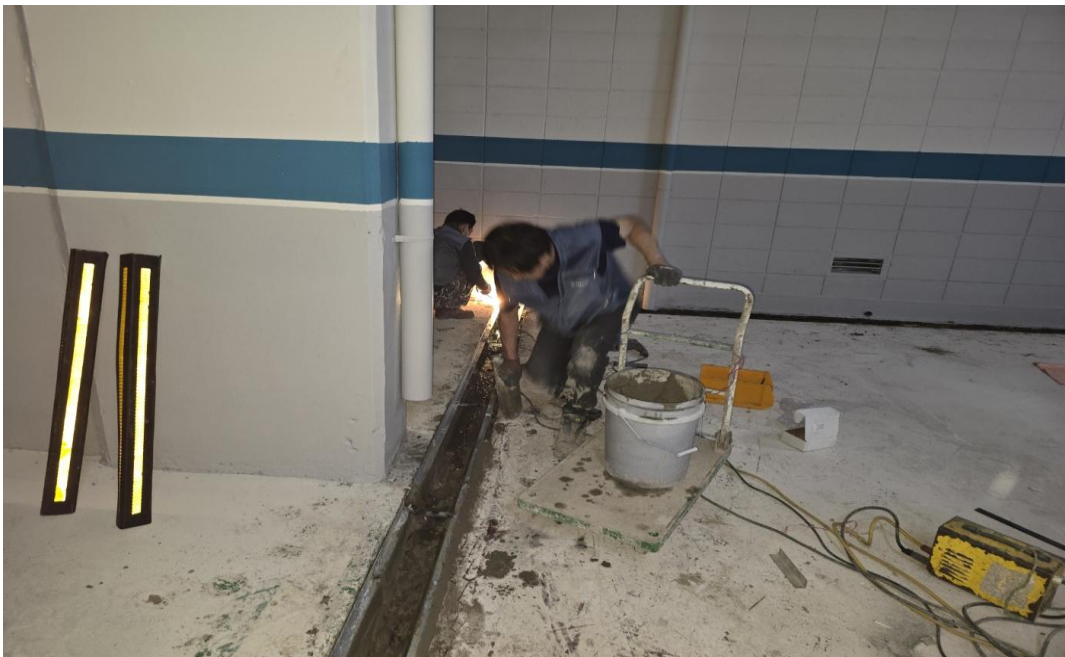
공사 중 (트렌치 교체)
