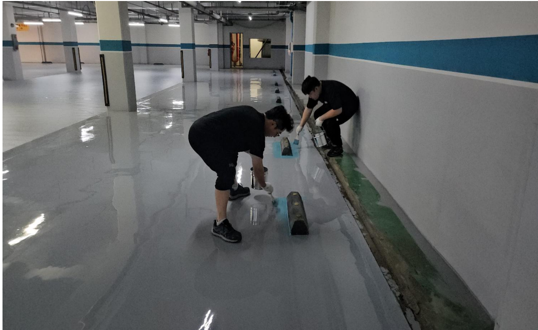
공사 중 (에폭시 상도)
