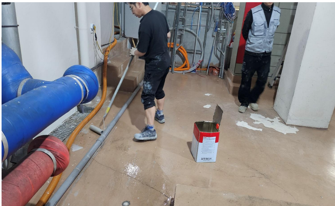
공사 중 (에폭시 프라이마 도포)
