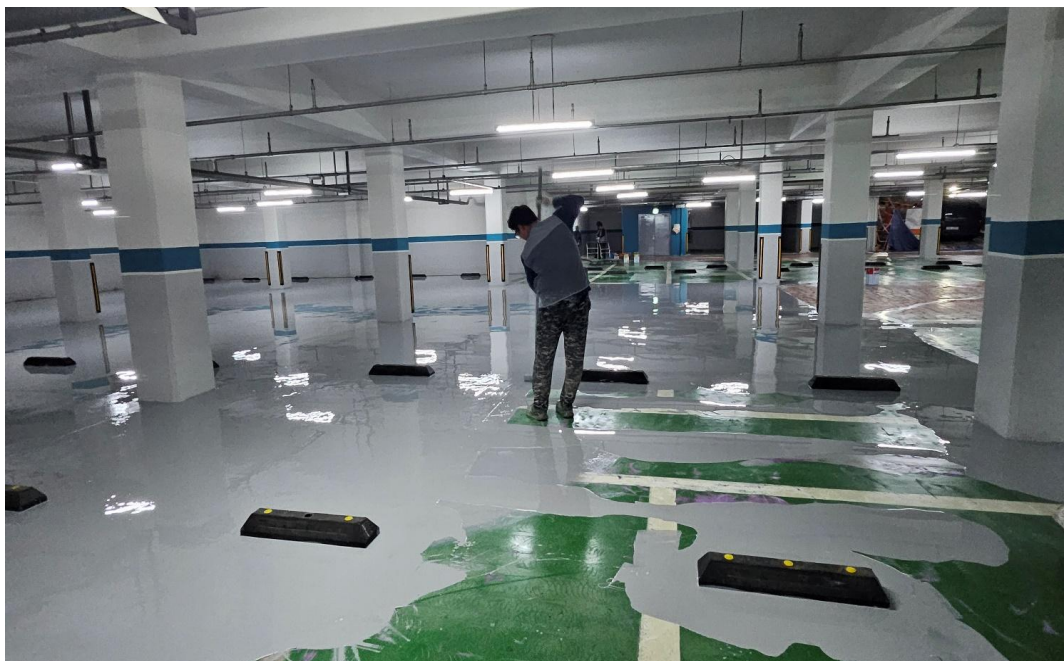
공사 중 (에폭시 라이닝)
