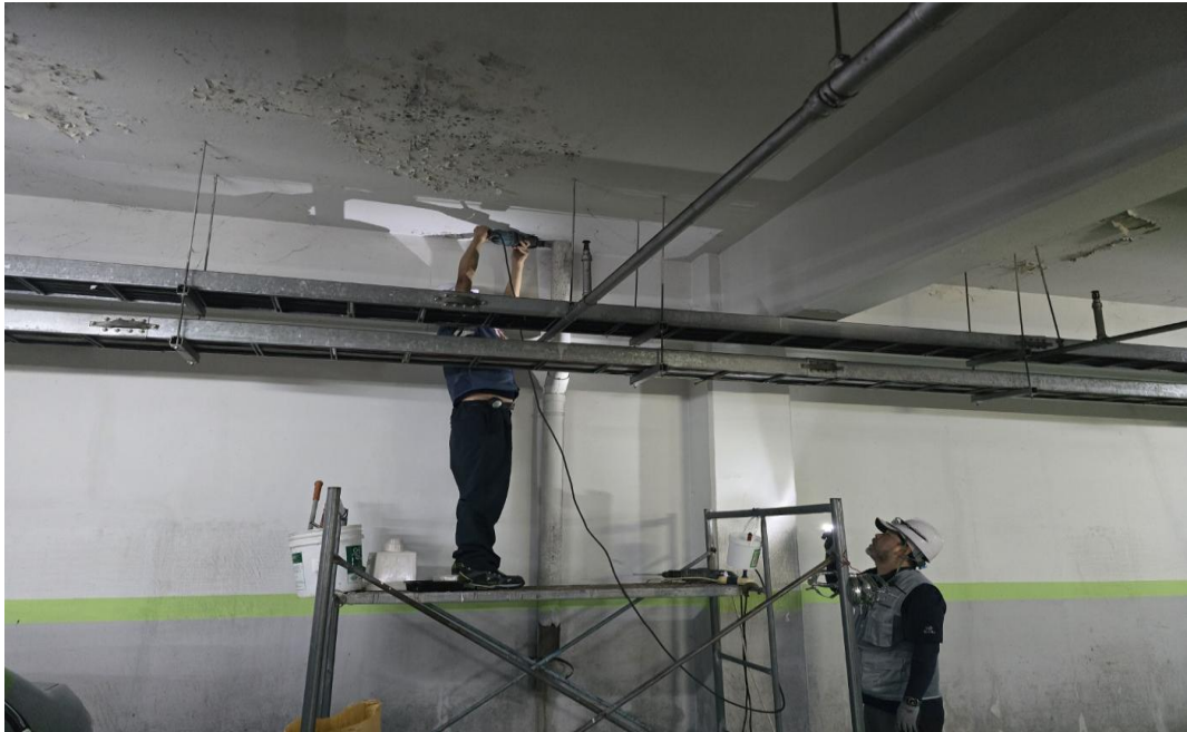
공사 중 (선흡통 교체)
