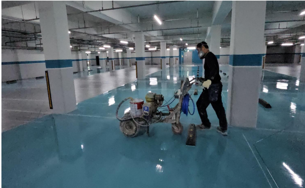
공사 중 (차선)
