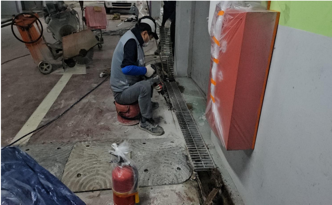
공사 중 (트렌치 교체)
