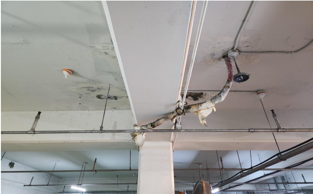
공사 중 (유도 배수)
