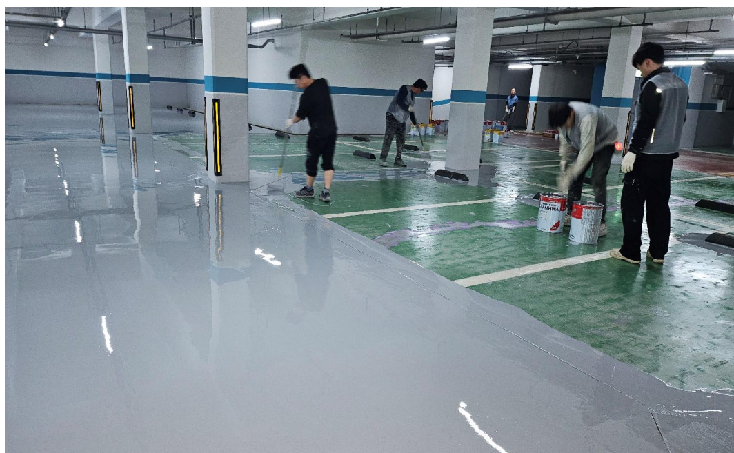
공사 중 (에폭시 라이닝)
