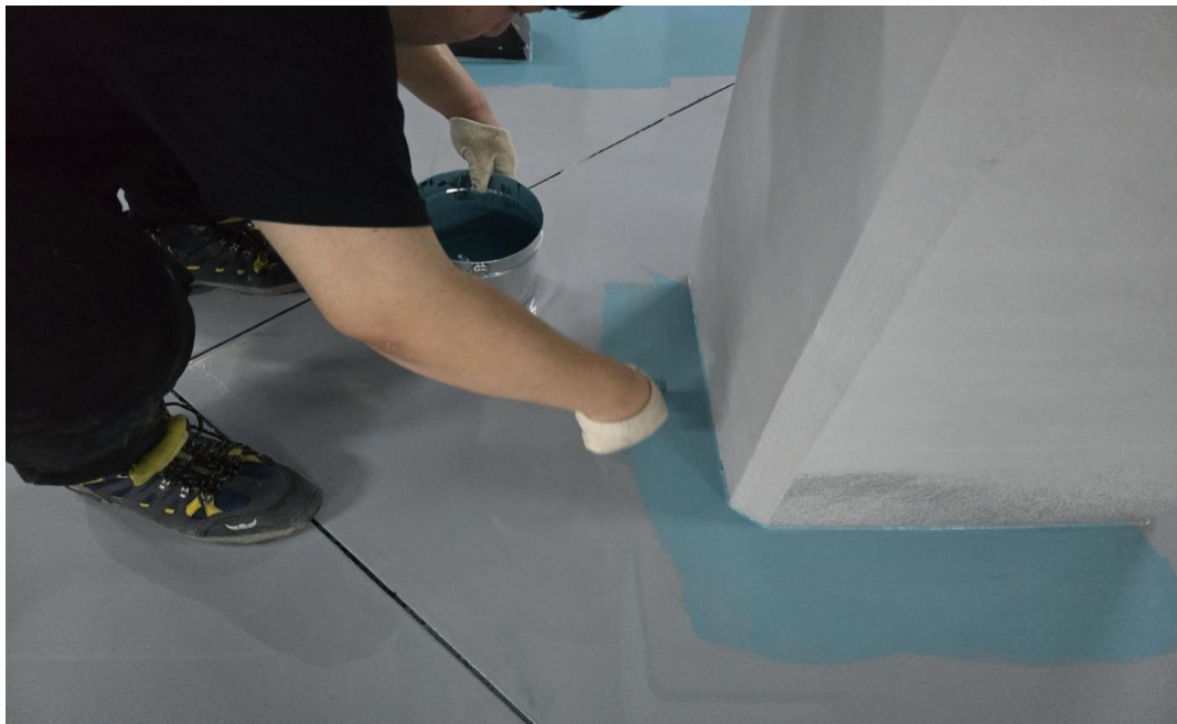
공사 중 (에폭시 상도)
