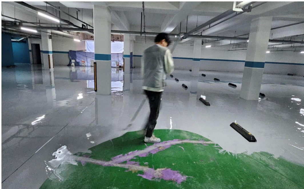
공사 중 (에폭시 라이닝)
