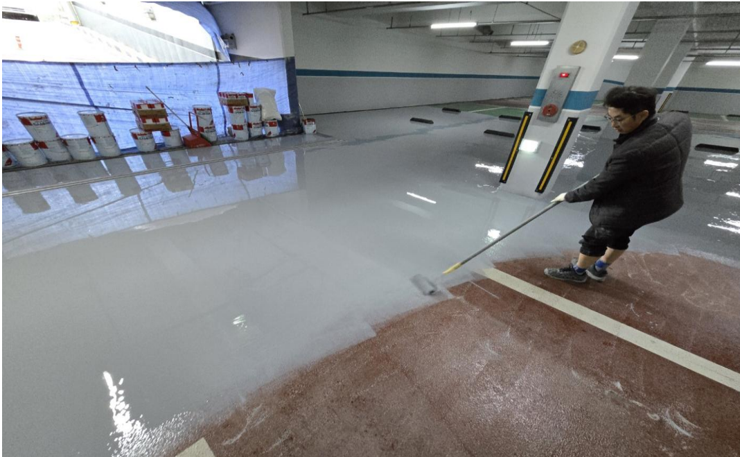
공사 중 (에폭시 라이닝)
