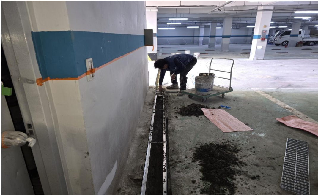
공사 중 (트렌치 교체)
