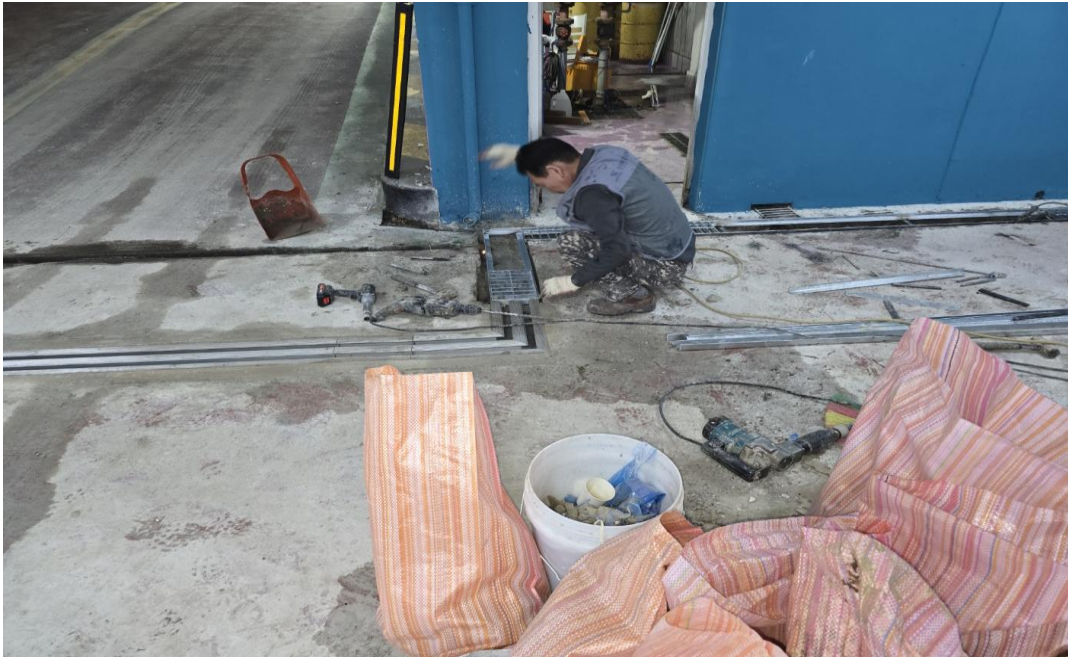
공사 중 (트렌치 교체)
