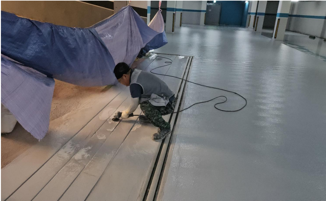
공사 중 (램프 앞 컷팅)
