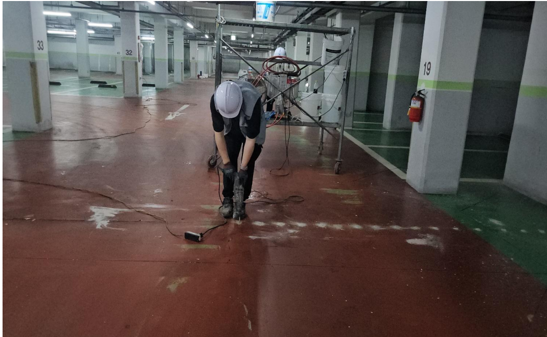
공사 중 (차수)
