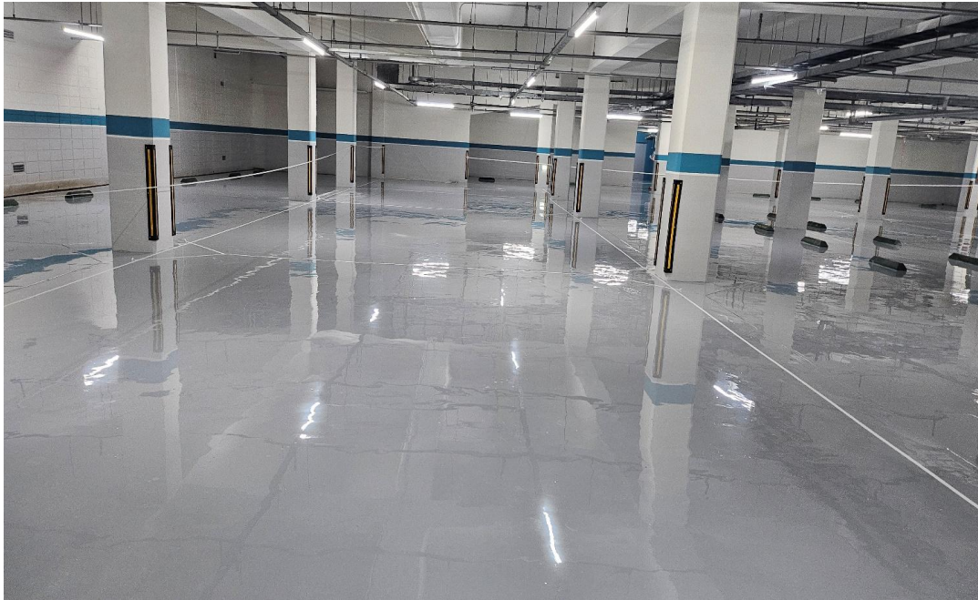
공사 중 (에폭시 라이닝)
