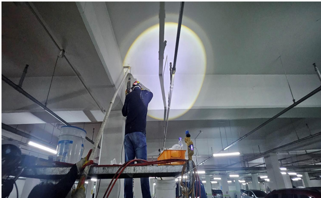
공사 중 (인젝션 주입)
