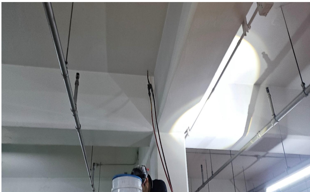
공사 중 (인젝션 주입)
