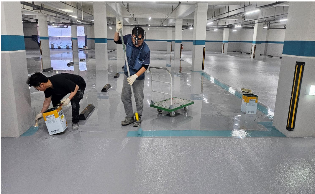
공사 중 (에폭시 상도)
