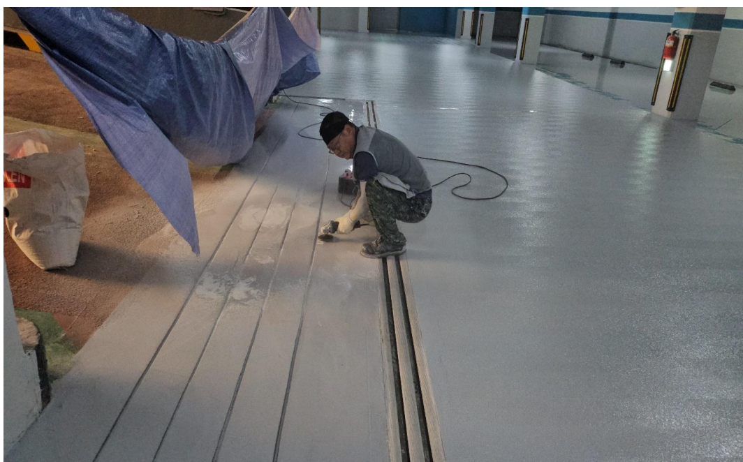
공사 중 (램프 앞 커팅)
