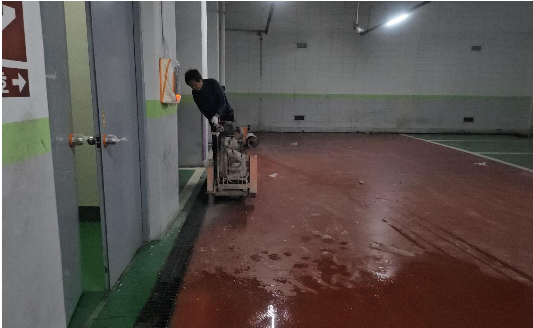
공사 중 (트렌치 교체)
