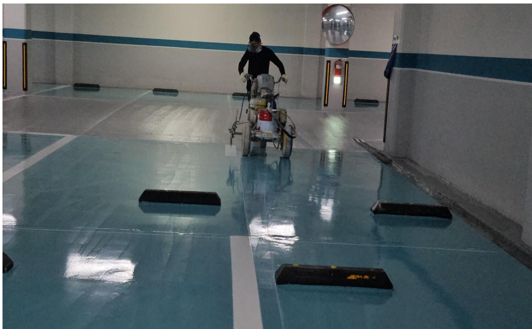
공사 중 (차선)
