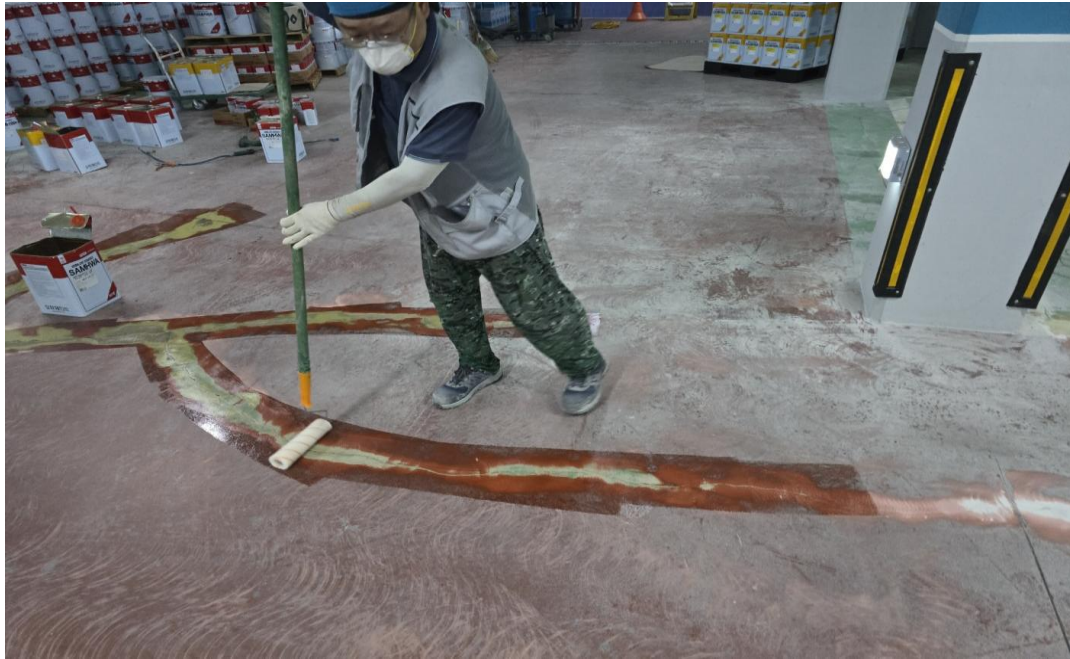
공사 중 (에폭시 프라이마 도포)
