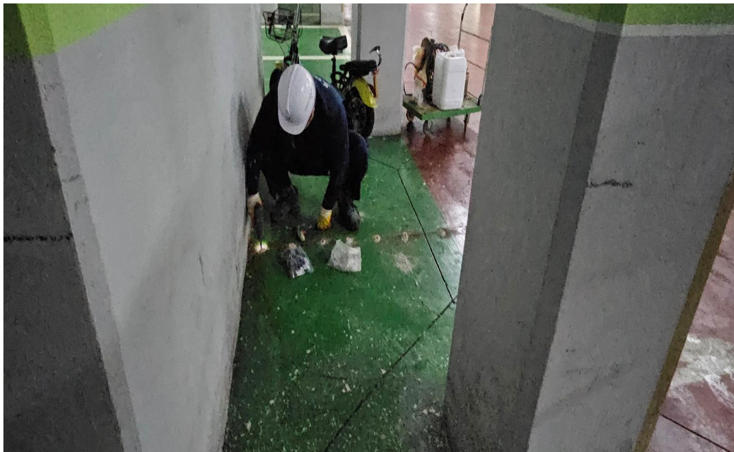
공사 중 (차수)
