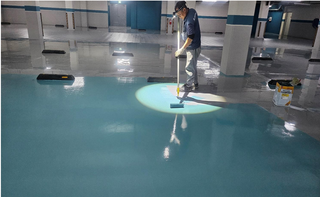
공사 중 (에폭시 상도)
