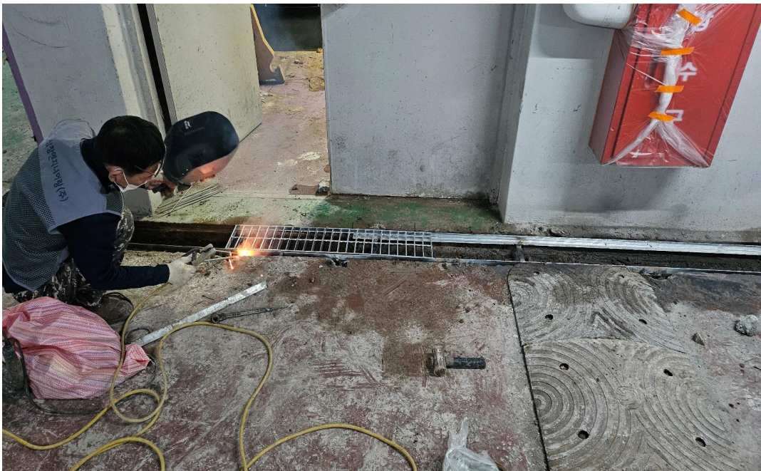
공사 중 (트렌치 교체)
