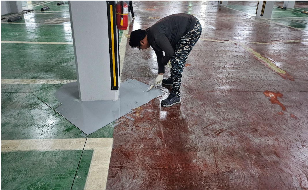
공사 중 (에폭시 라이닝)
