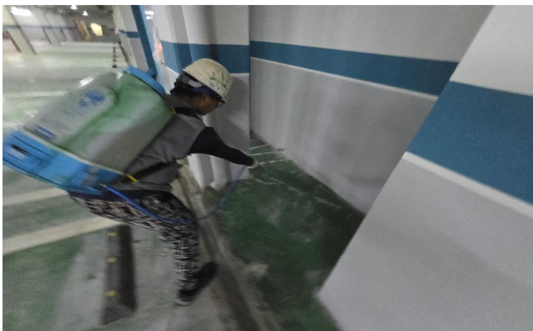
공사 중 (에폭시 프라이마 도포)
