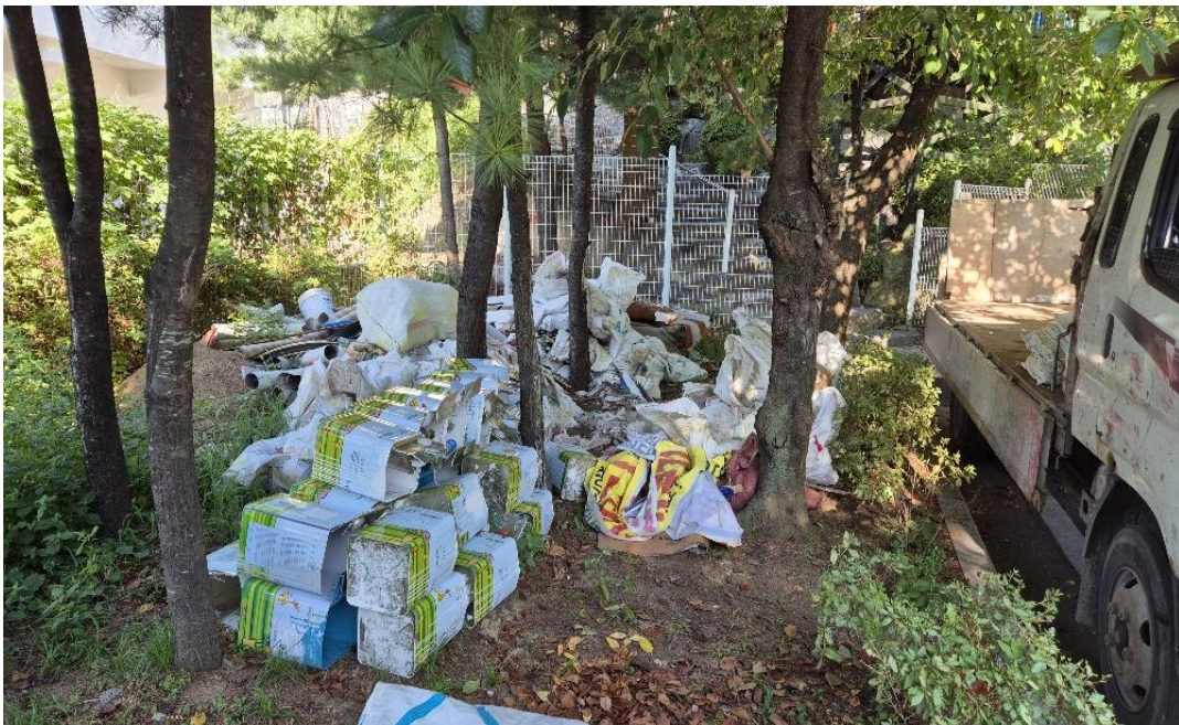
공사 중 (폐기물 처리)
