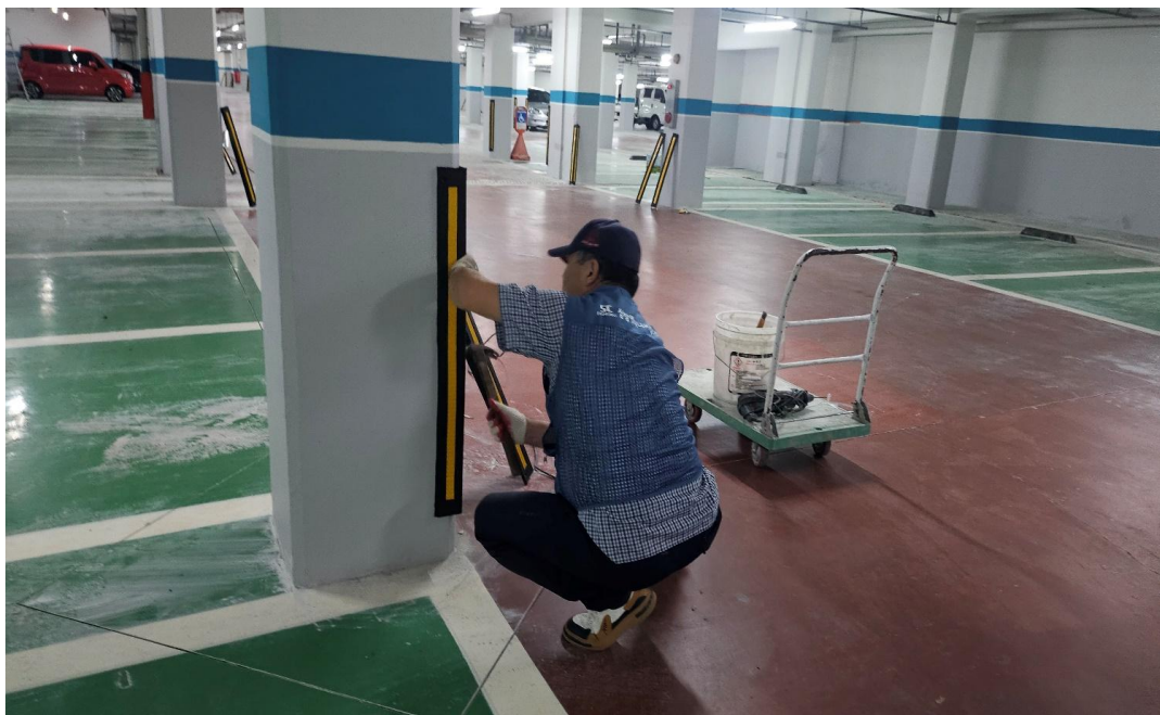
공사 중 (코너 비트 설치)
