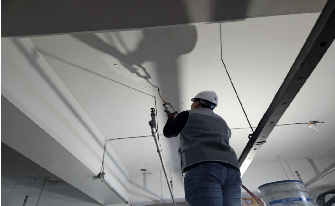
공사 중 (인젝션 주입)
