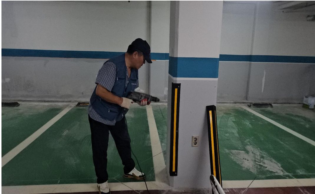
공사 중 (코너 비트 설치)
