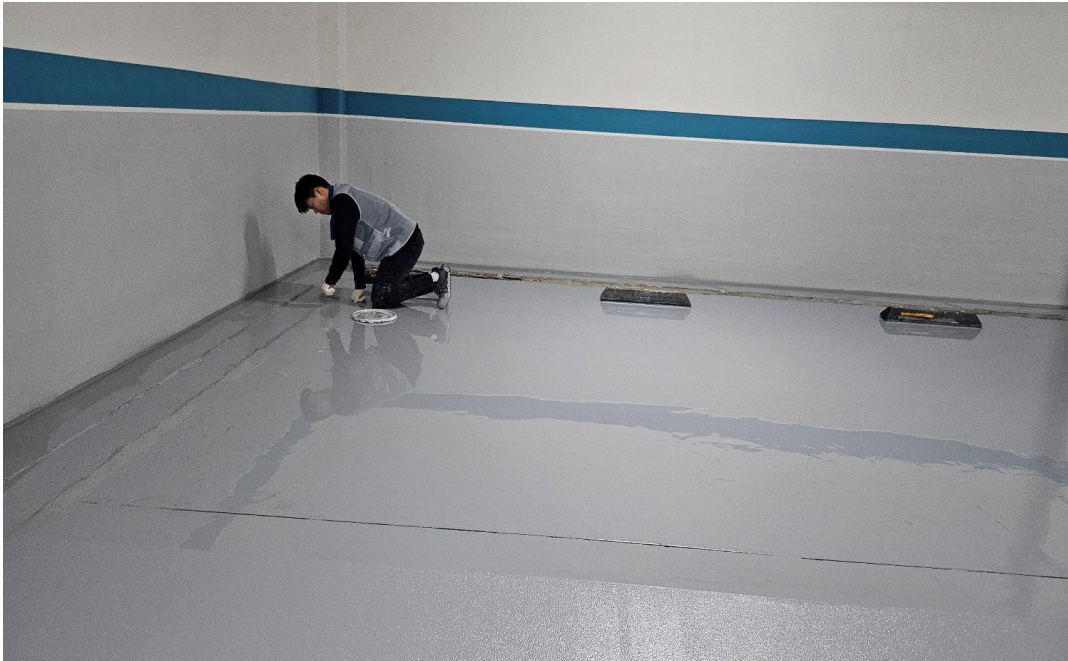
공사 중 (에폭시 퍼티)
