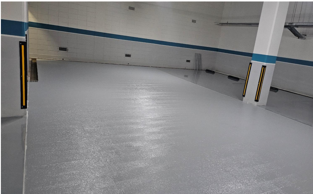
공사 중 (에폭시 엠보)
