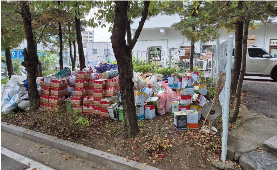
공사 중 (폐기물 처리)
