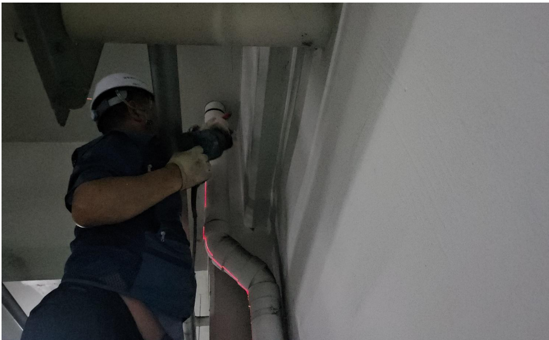
공사 중 (선흡통 교체)
