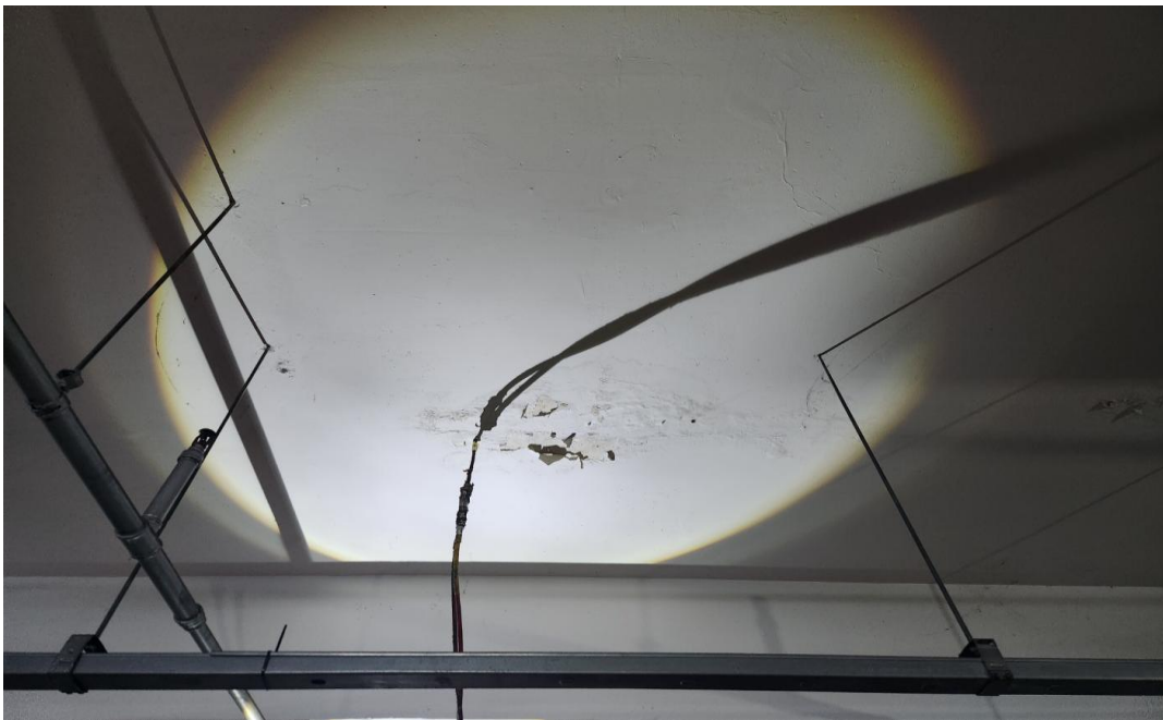
공사 중 (인젝션 주입)
