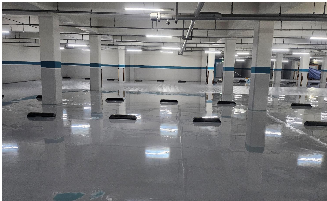
공사 중 (에폭시 라이닝)
