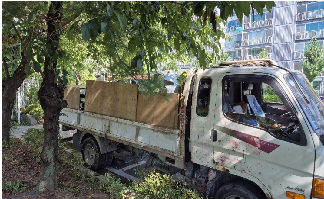
공사 중 (폐기물 처리)
