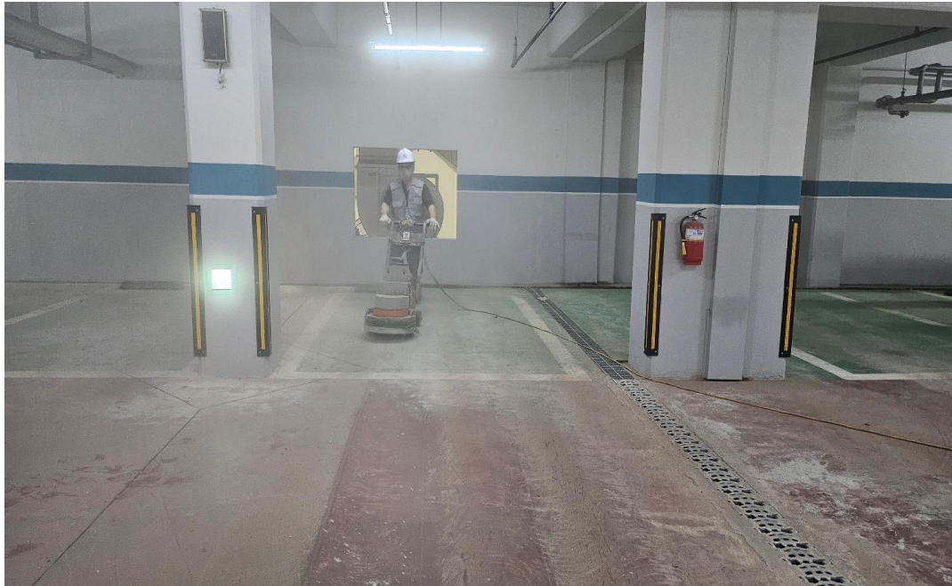
공사 중 (바탕면 정리)
