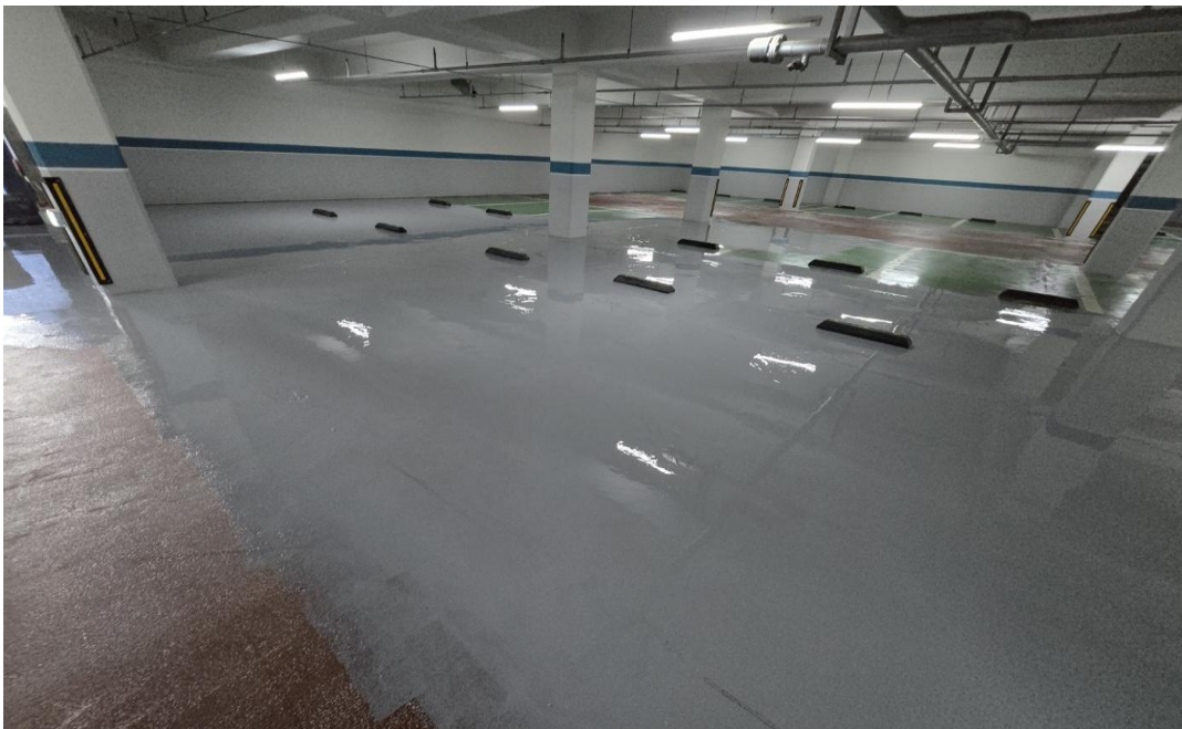
공사 중 (에폭시 라이닝)
