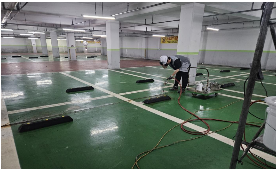
공사 중 (차수)
