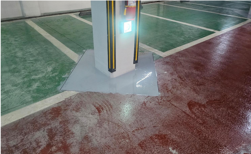
공사 중 (에폭시 라이닝)
