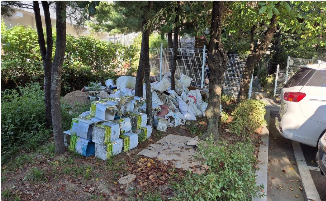
공사 중 (폐기물 처리)
