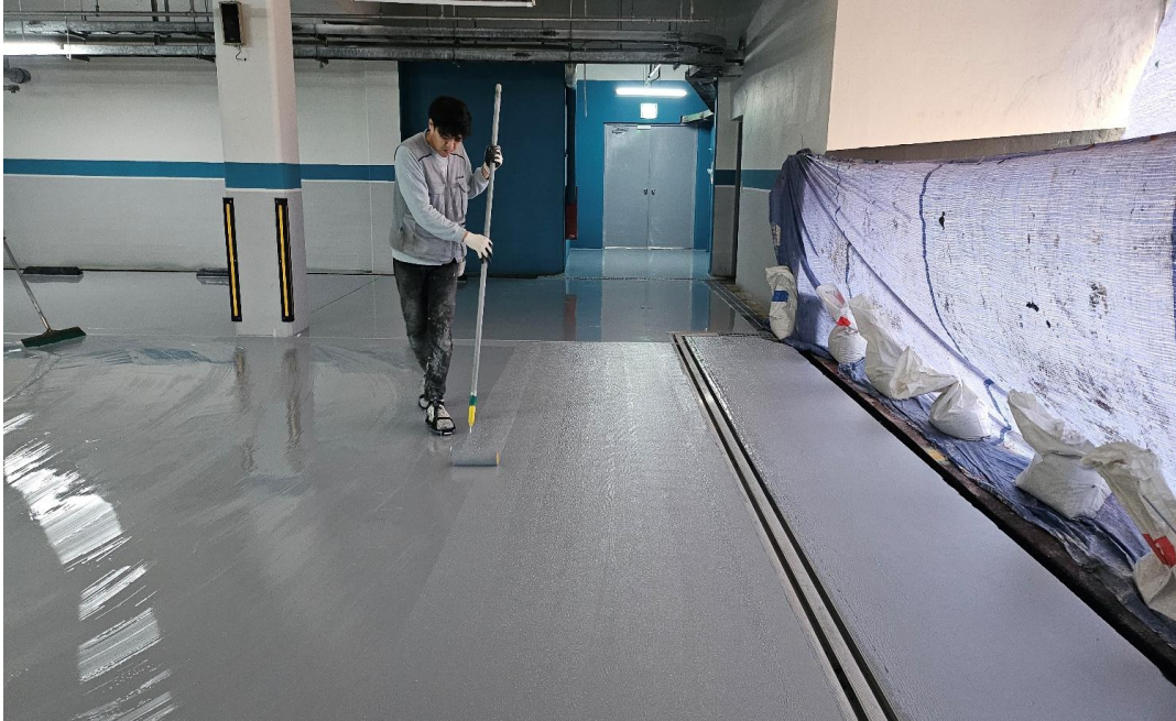
공사 중 (에폭시 엠보)
