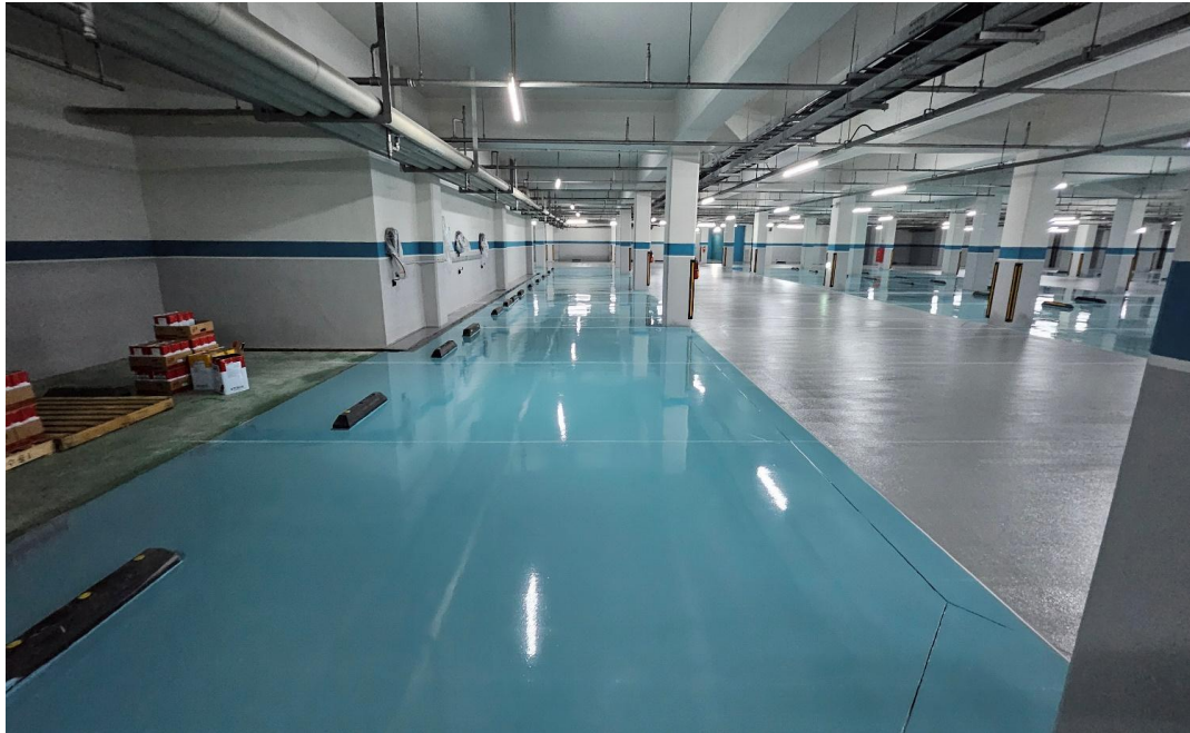
공사 중 (에폭시 상도)
