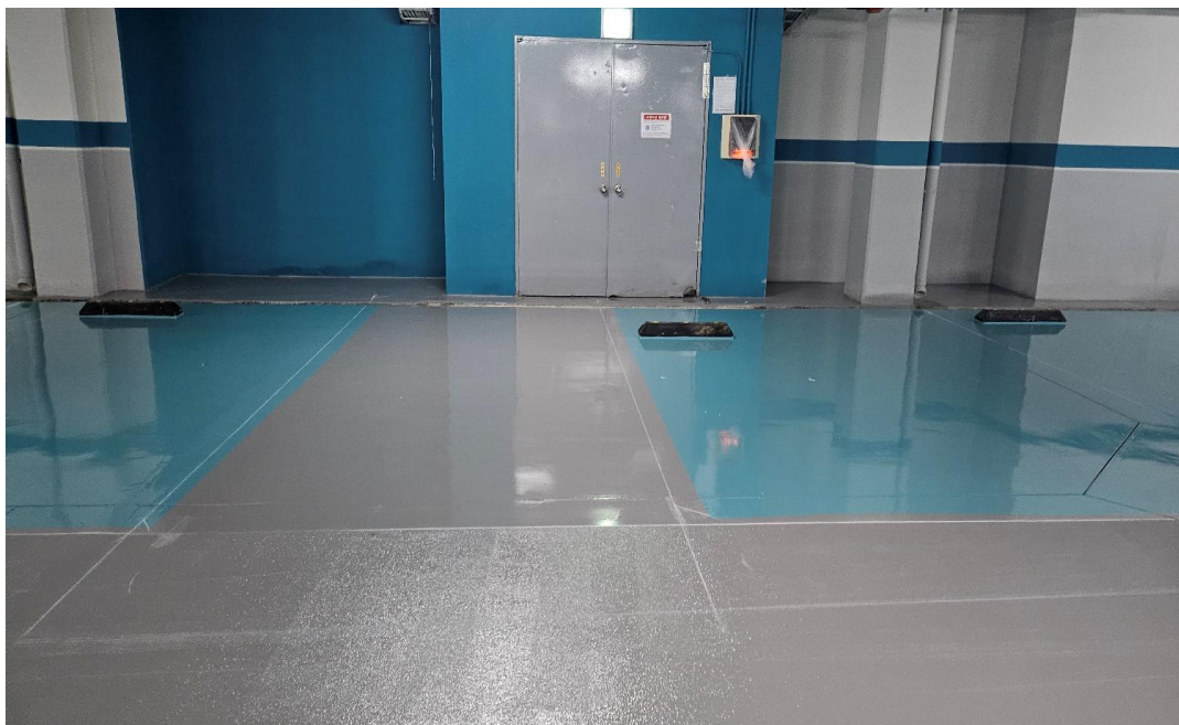
공사 중 (에폭시 상도)
