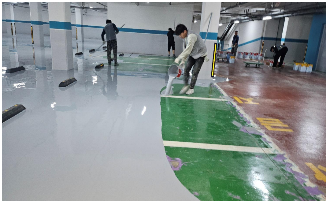
공사 중 (에폭시 라이닝)
