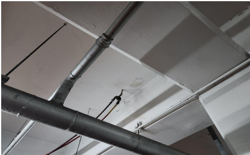
공사 중 (인젝션 주입)
