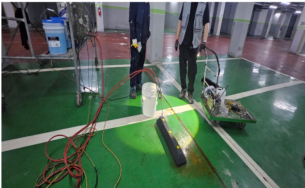
공사 중 (차수)
