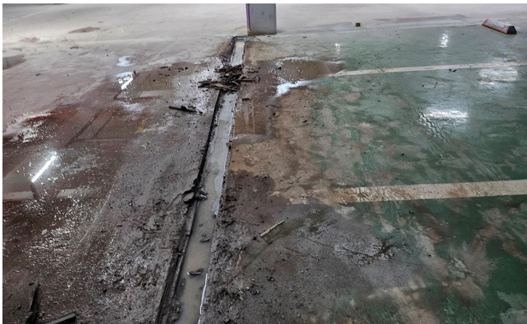
공사 중 (트렌치 교체)
