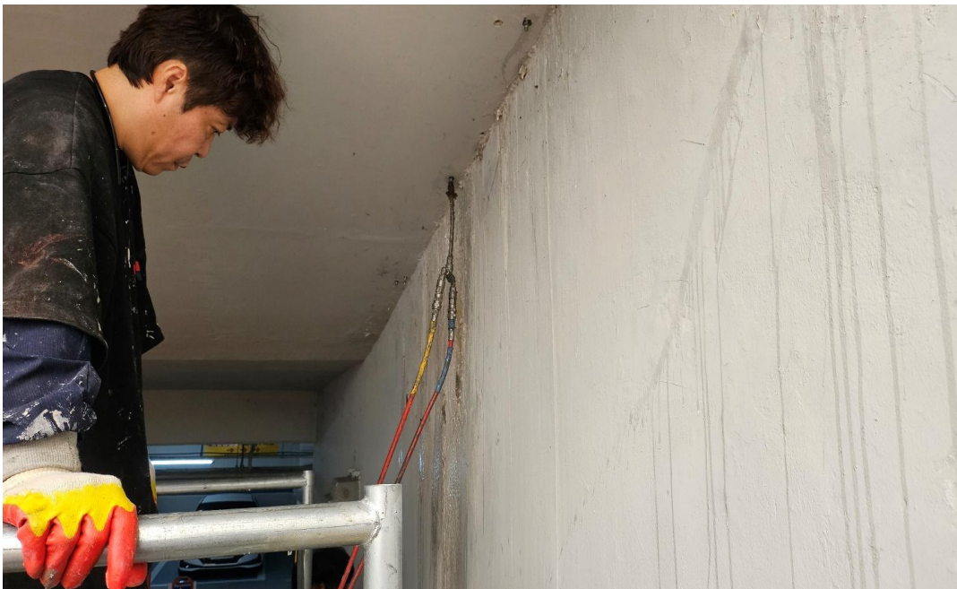
공사 중 (인젝션 주입)
