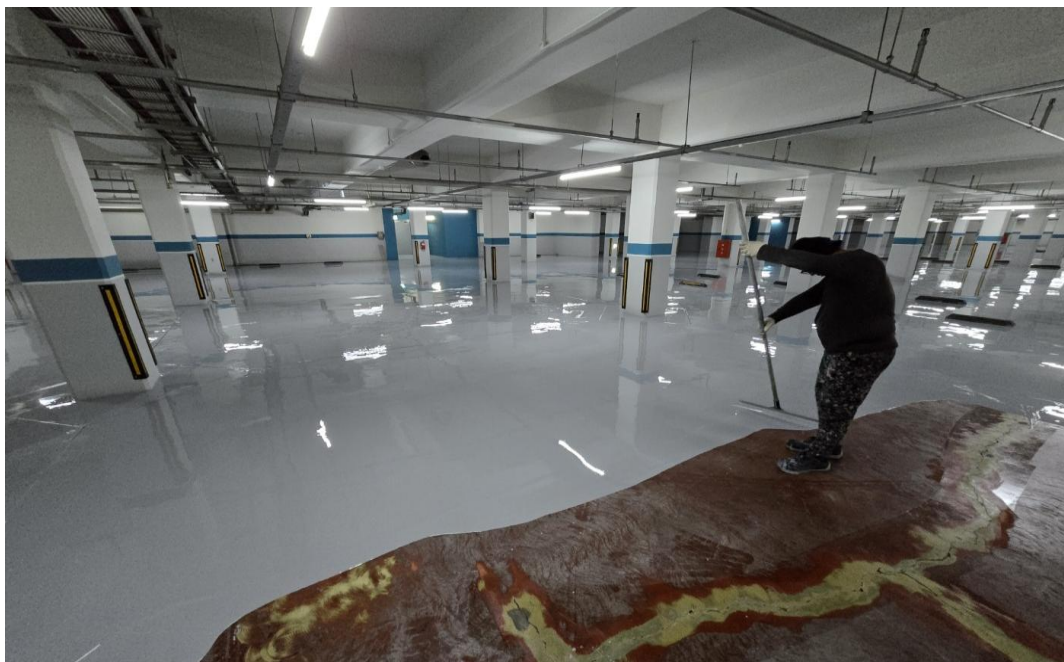
공사 중 (에폭시 라이닝)
