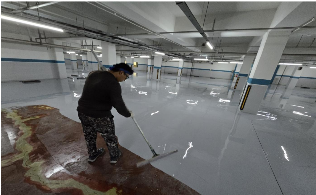
공사 중 (에폭시 라이닝)
