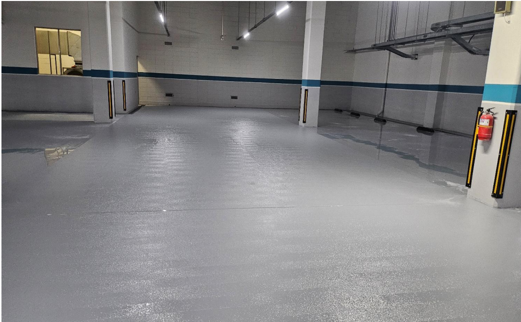
공사 중 (에폭시 엠보)
