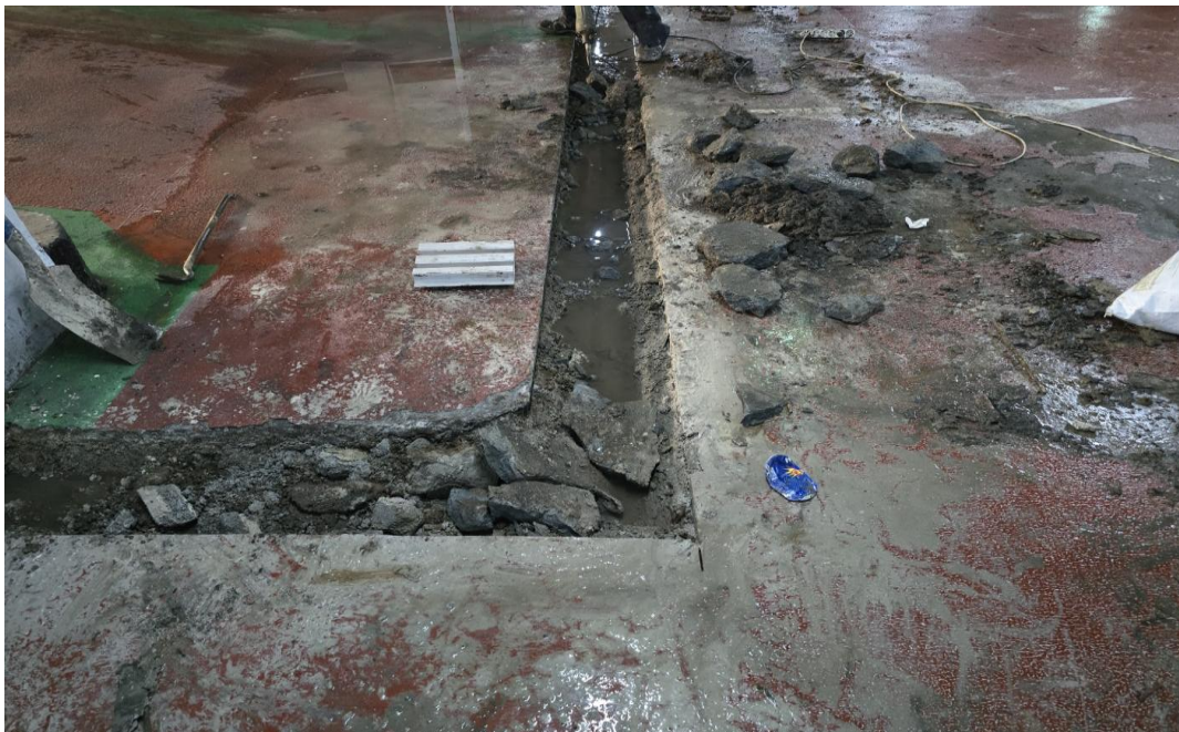
공사 중 (트렌치 교체)
