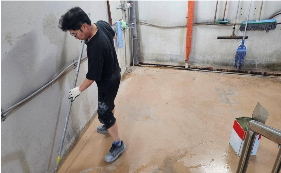
공사 중 (에폭시 프라이마 도포)
