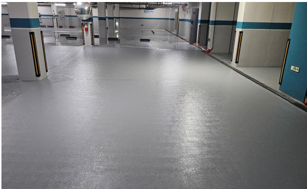
공사 중 (에폭시 엠보)
