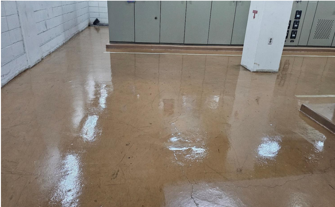
공사 중 (에폭시 프라이마 도포)
