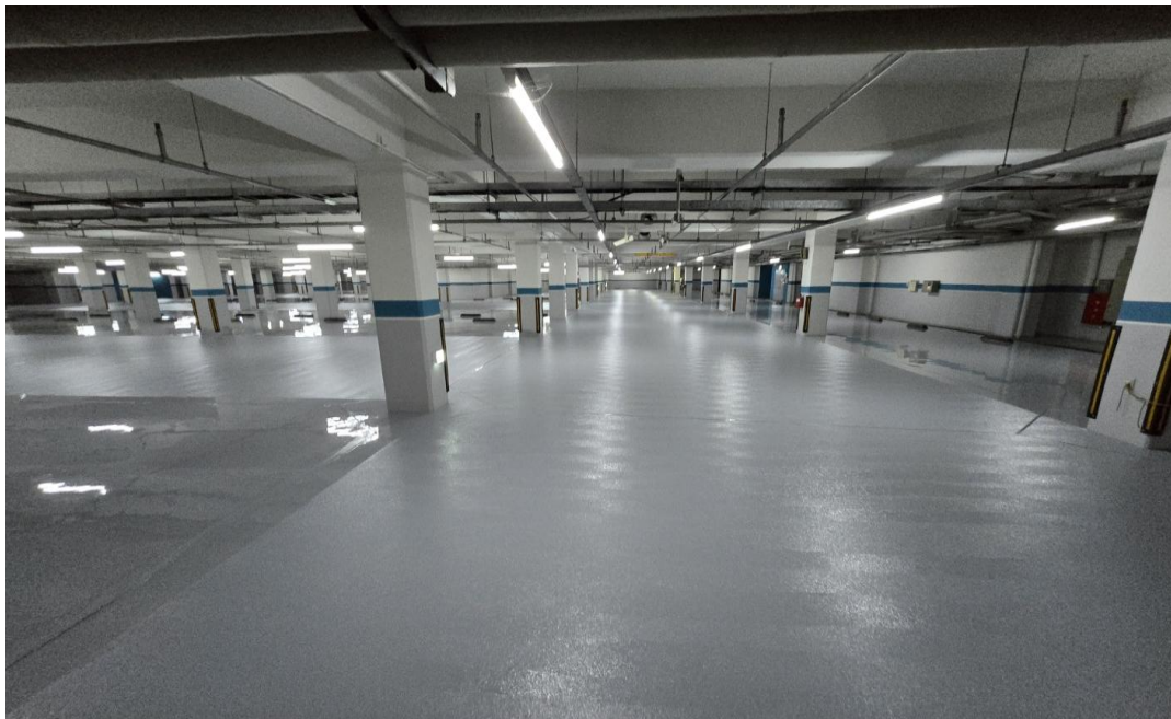
공사 중 (에폭시 엠보)
