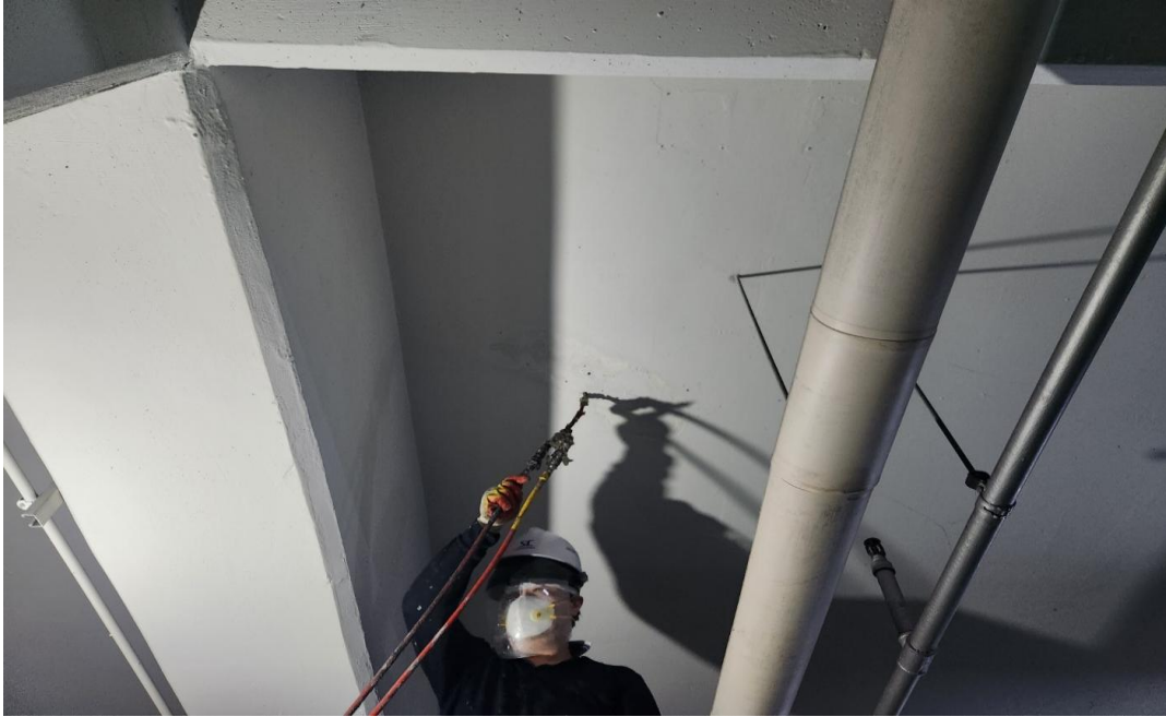
공사 중 (인젝션 주입)
