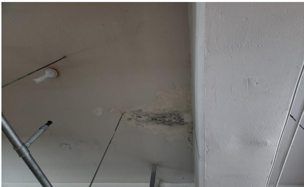
공사 중 (인젝션 주입)
