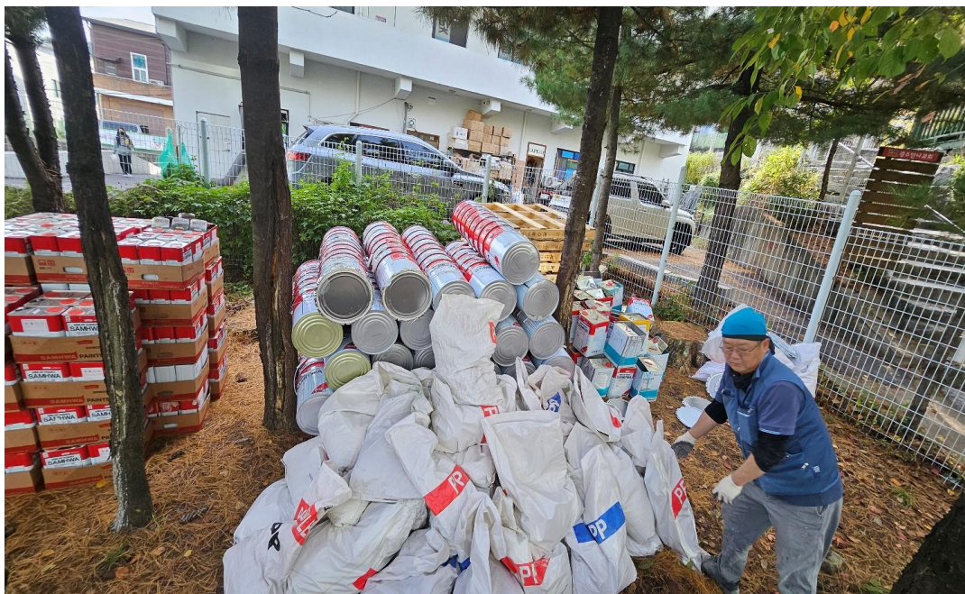
공사 중 (폐기물 처리)
