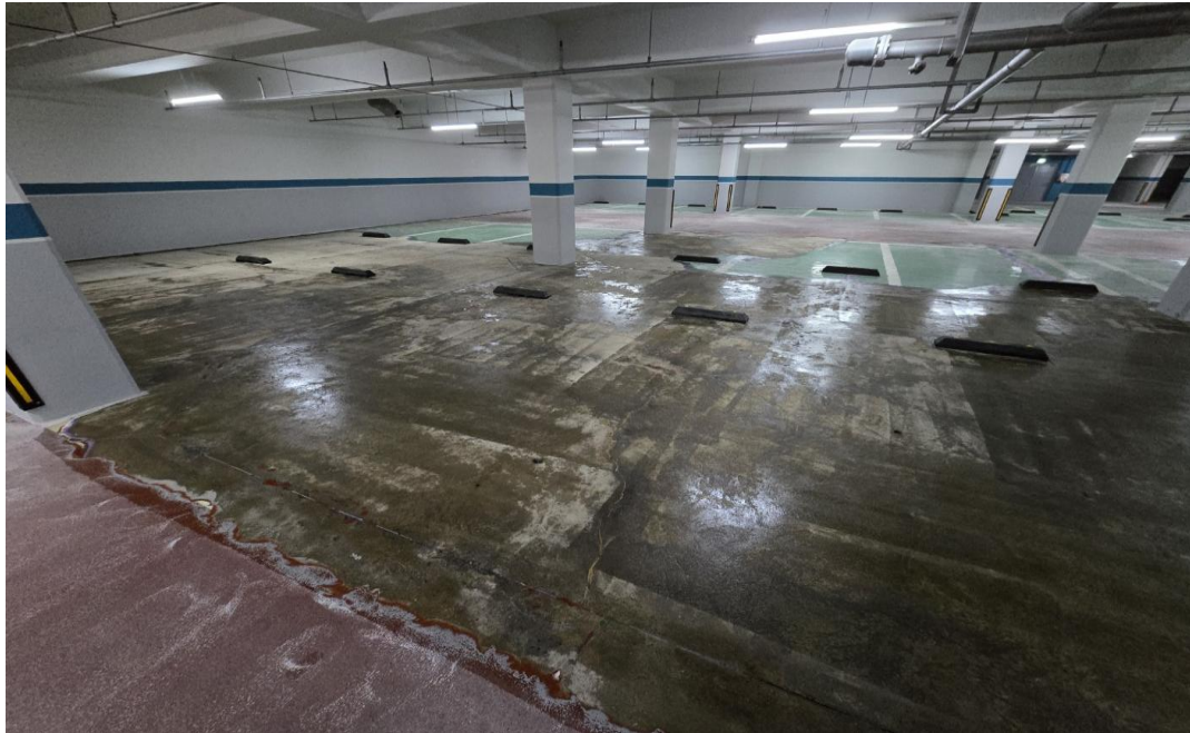
공사 중 (에폭시 프라이마 도포)
