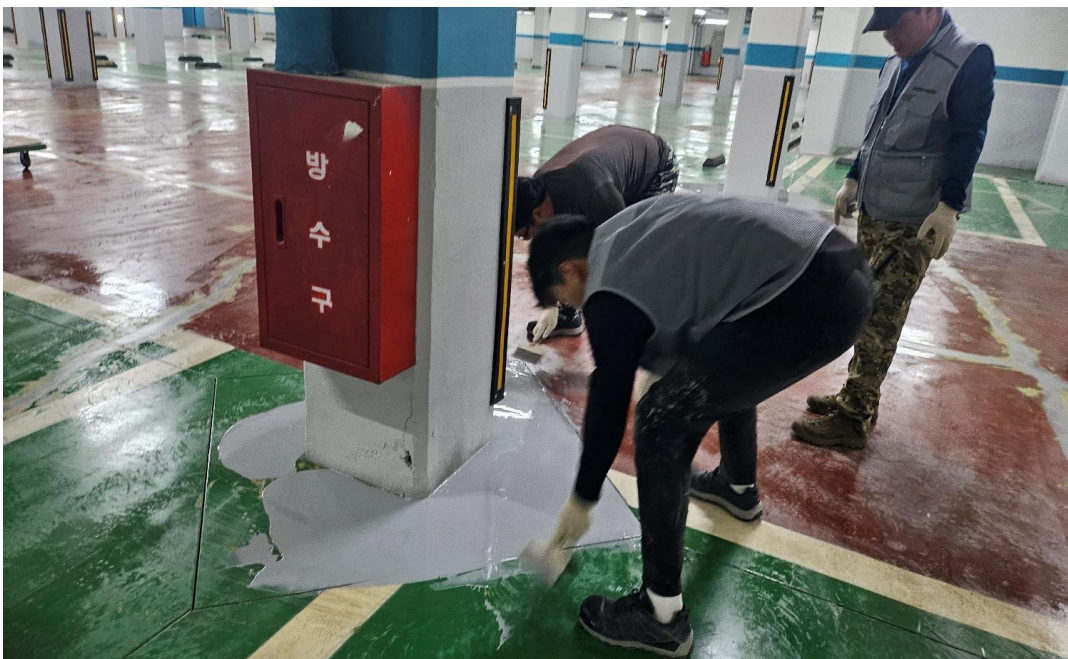
공사 중 (에폭시 라이닝)
