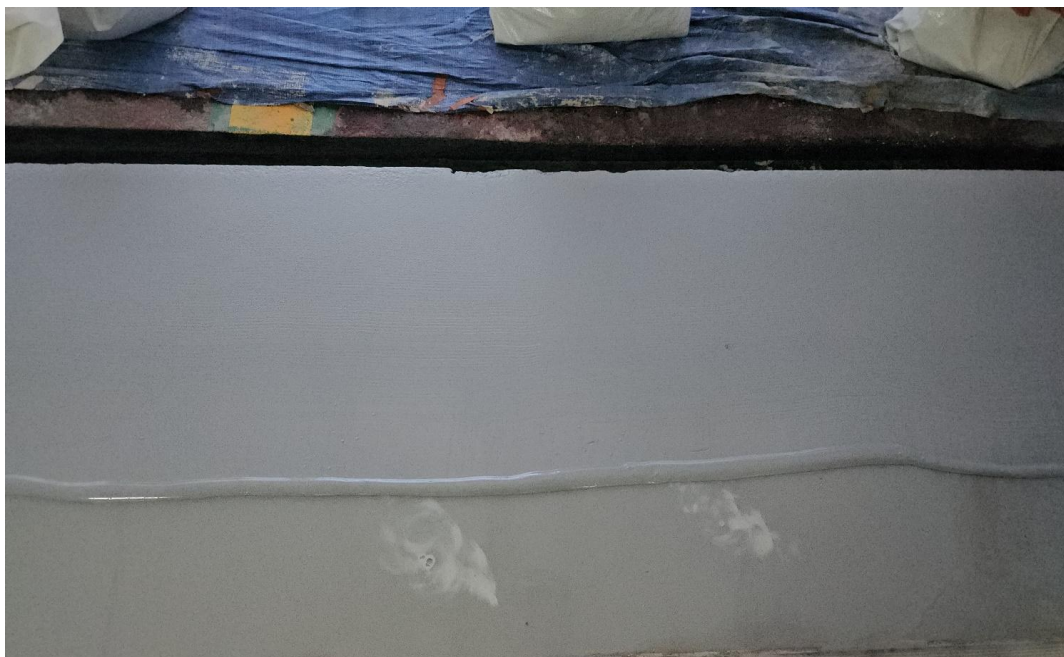
공사 중 (에폭시 엠보)
