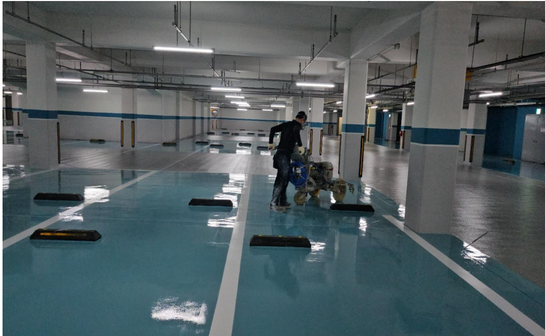
공사 중 (차선)
