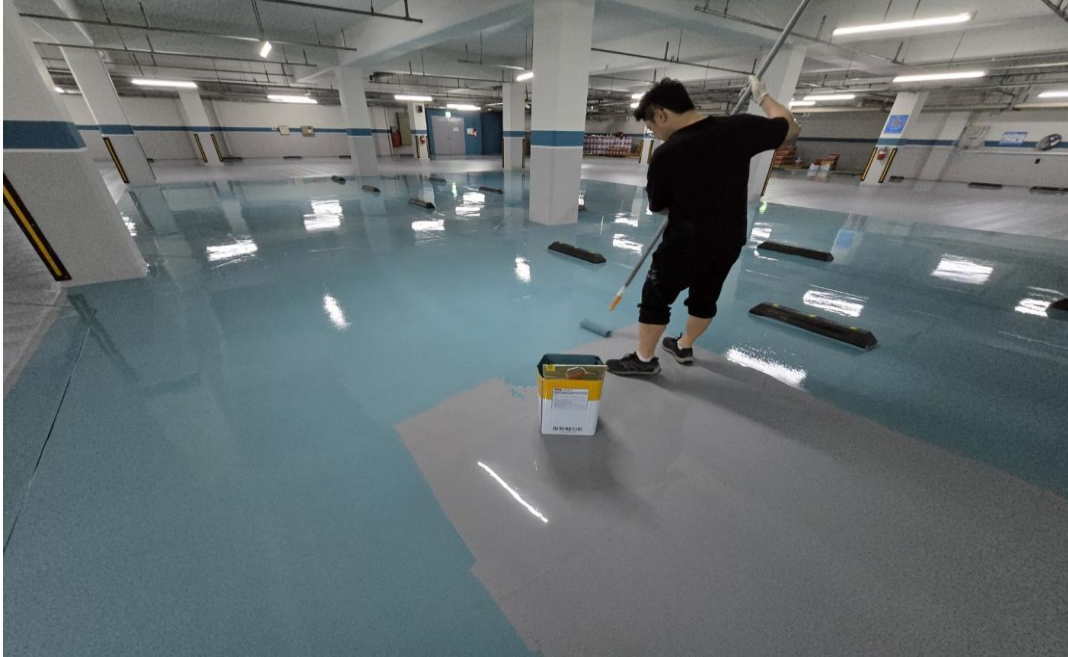
공사 중 (에폭시 상도)
