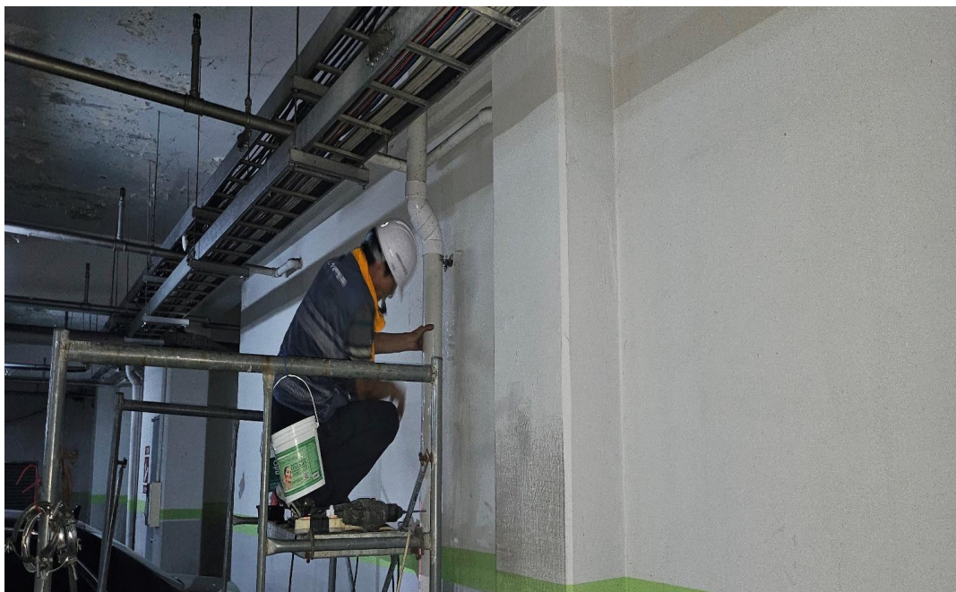
공사 중 (선흘통 교체)
