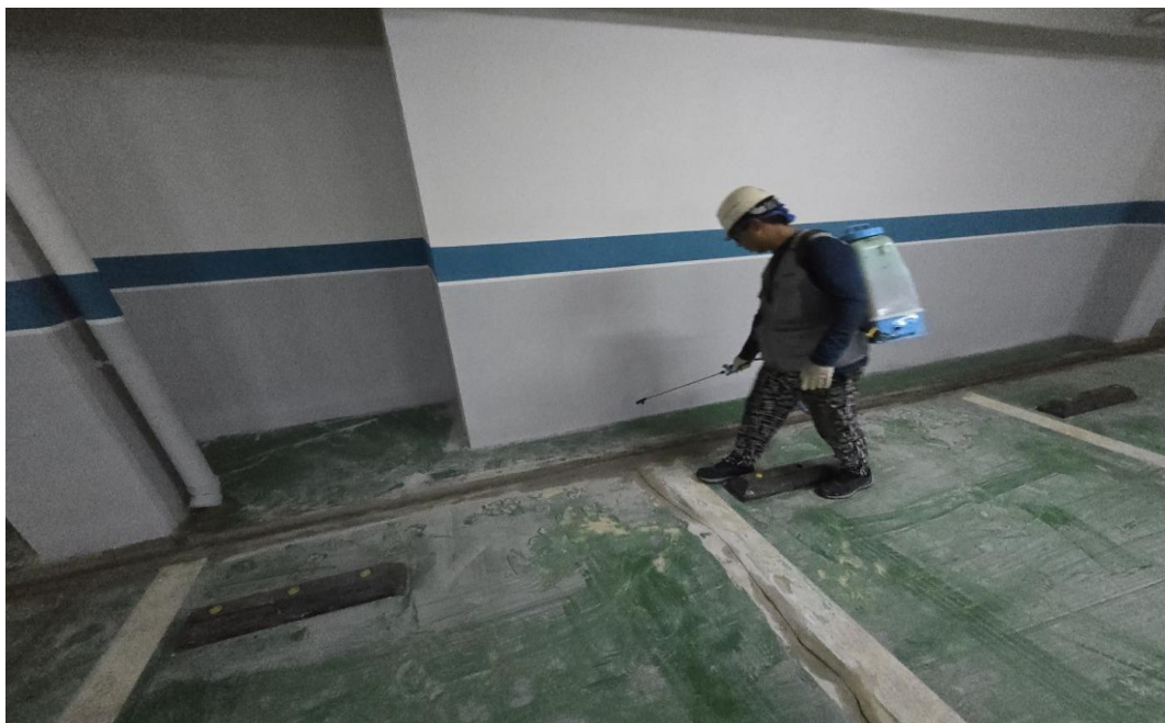
공사 중 (에폭시 프라이마 도포)
