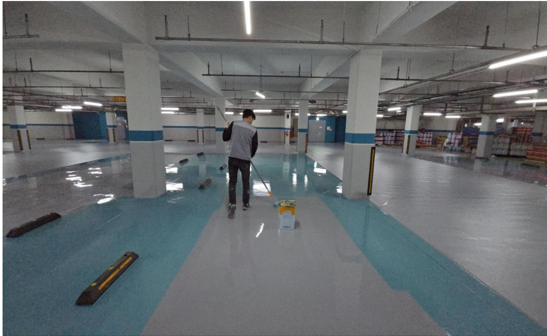
공사 중 (에폭시 상도)
