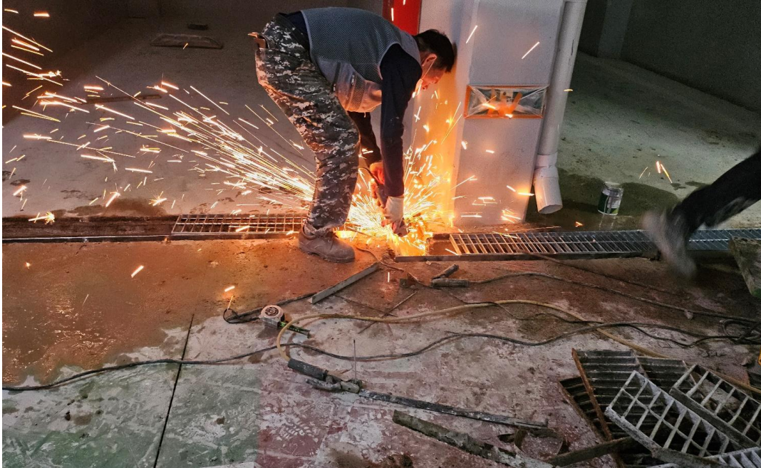
공사 중 (트렌치 교체)
