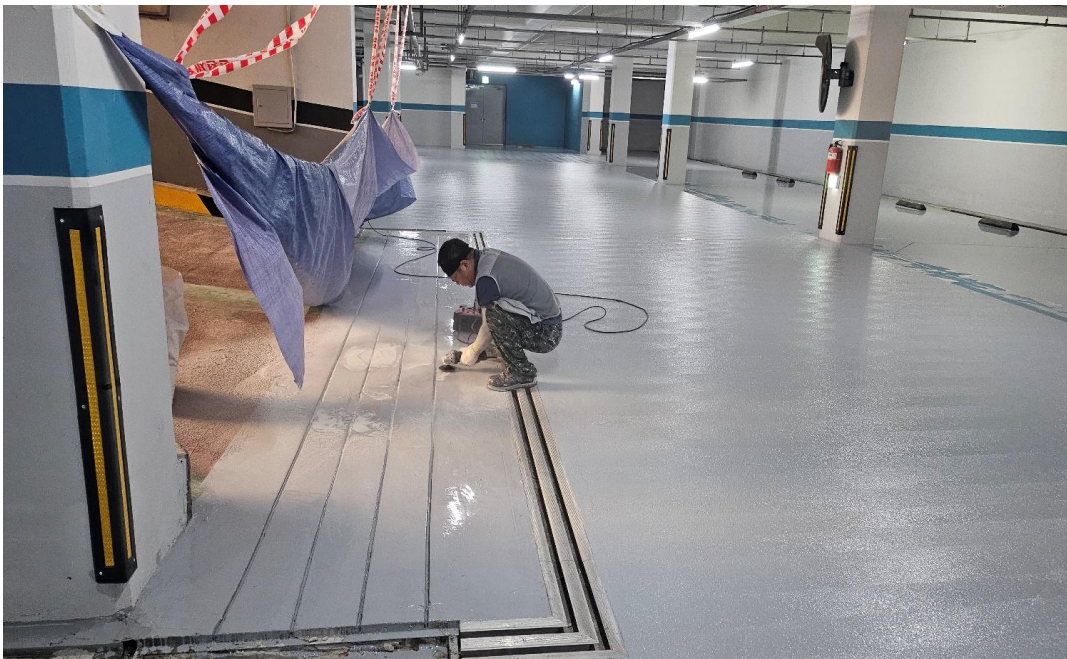
공사 중 (램프 앞 컷팅)
