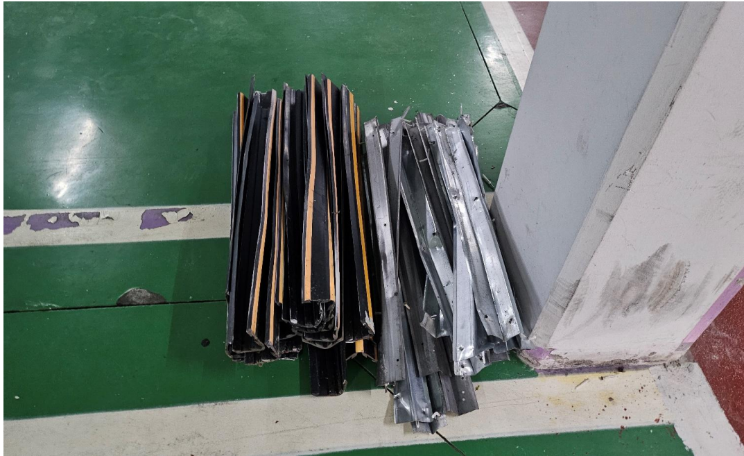
공사 중 (코너 비트 철거)
