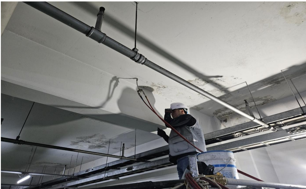
공사 중 (인젝션 주입)
