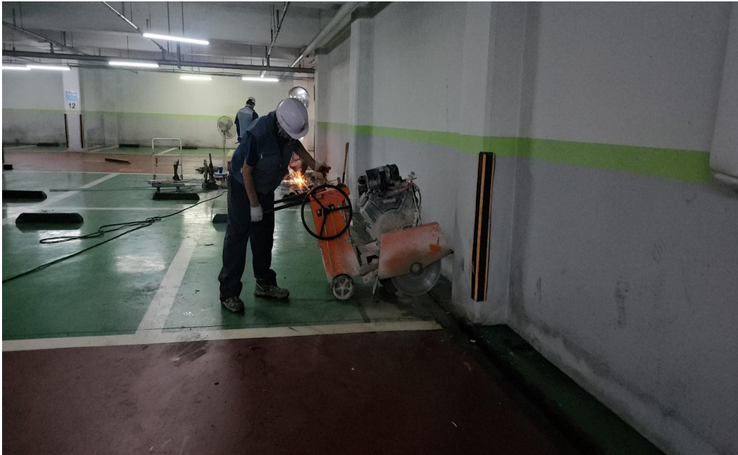
공사 중 (트렌치 교체)
