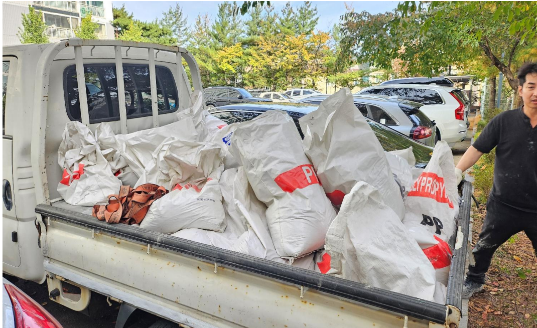
공사 중 (폐기물 처리)
