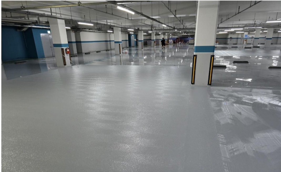
공사 중 (에폭시 엠보)
