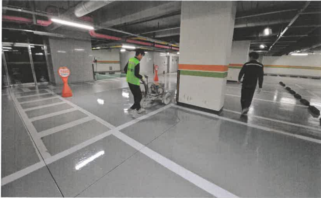
공사 중 : 차선 도장
