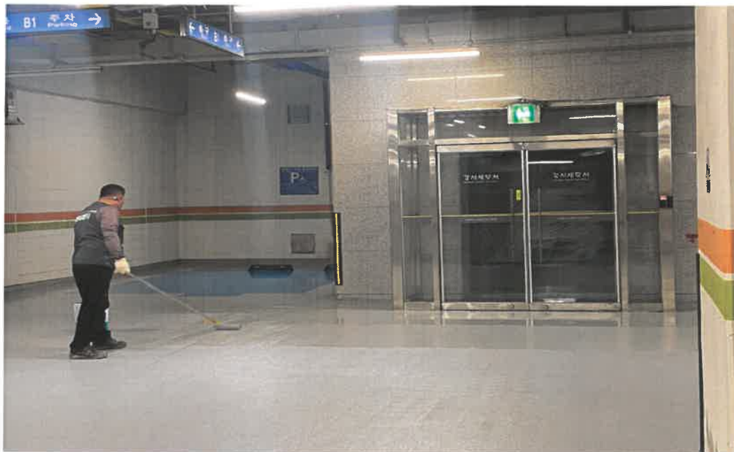
공사 중 : 엠보도포 후 코팅마감
