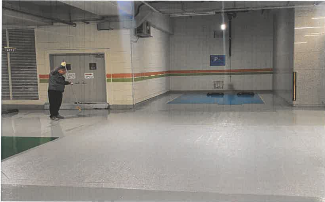
공사 중 : 엠보도포 후 코팅마감
