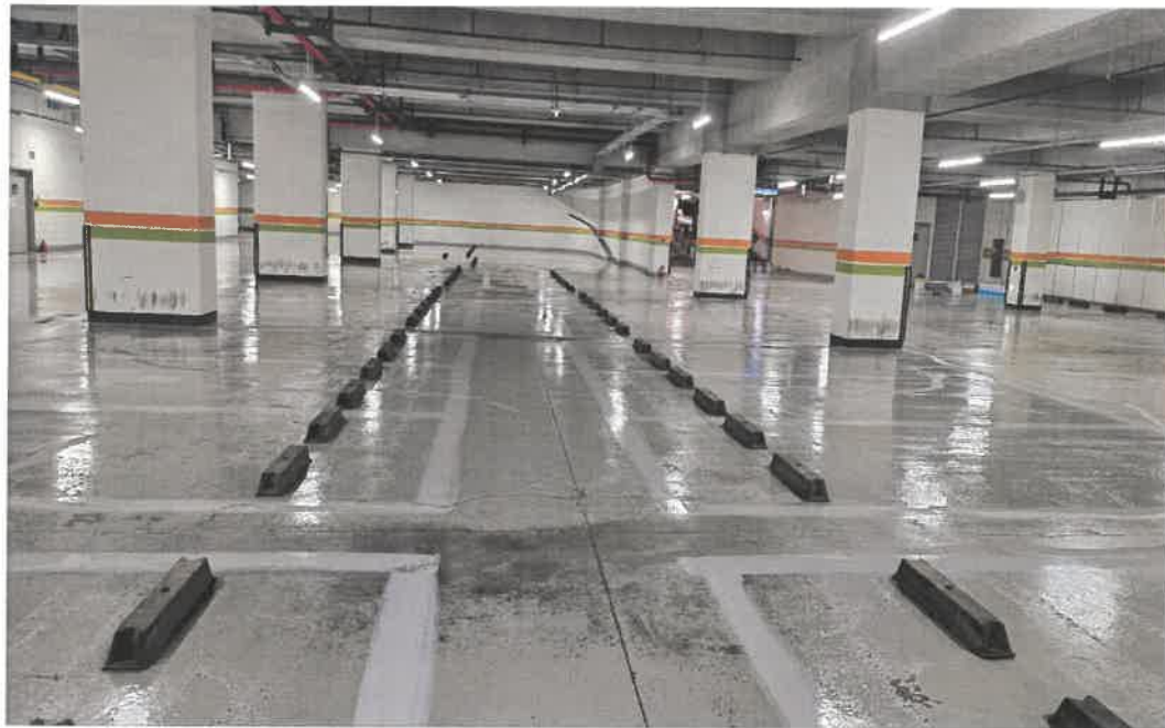
공사 중 : 에폭시 하도 도포
