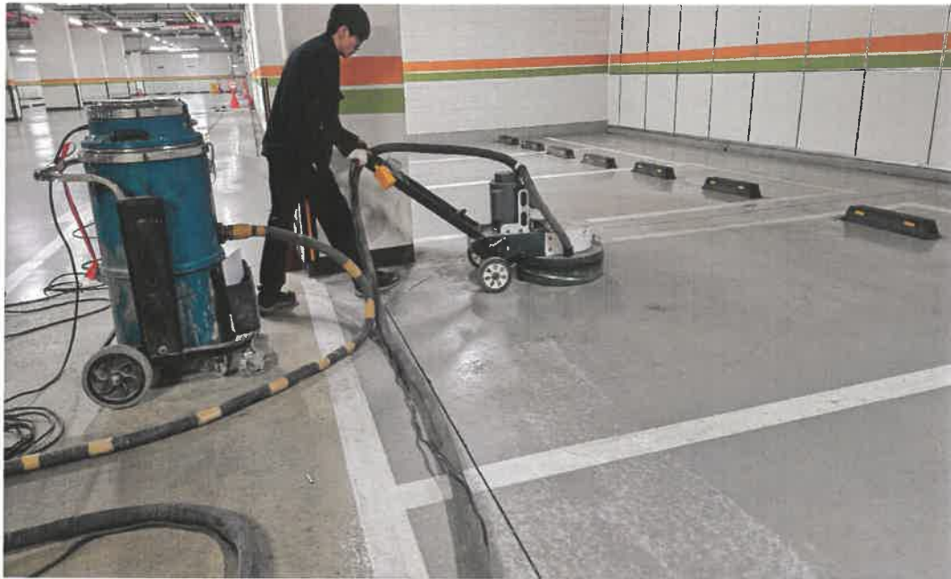
공사 중 : 바탕면 정리
