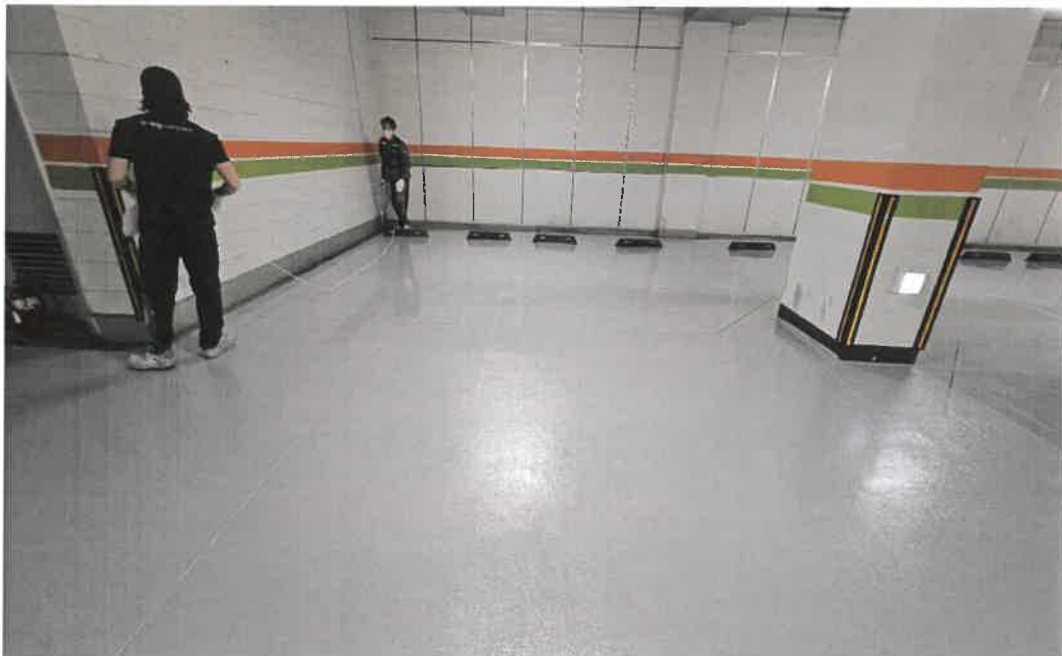
공사 중 : 차선 도장
