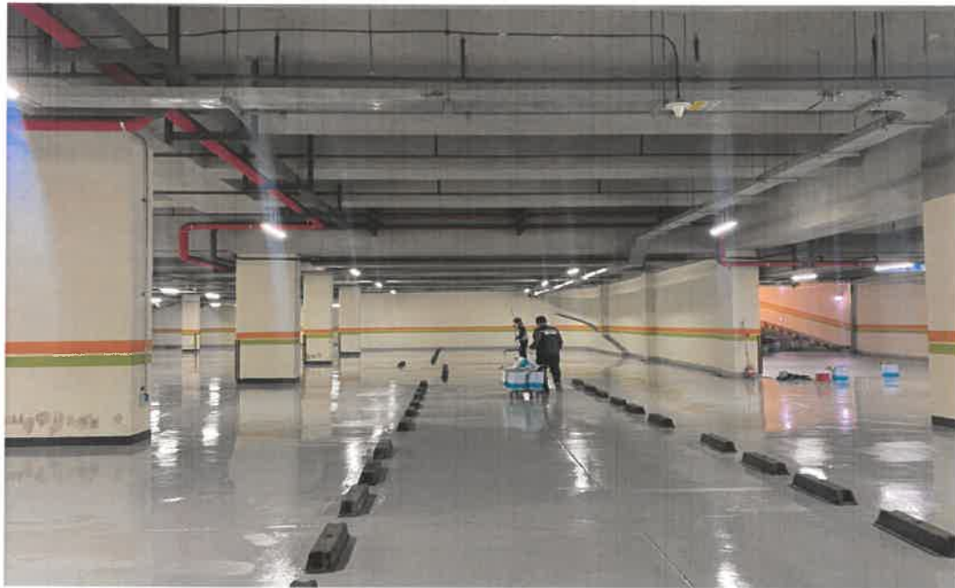
공사 중 : 에폭시 상도 2회도포
