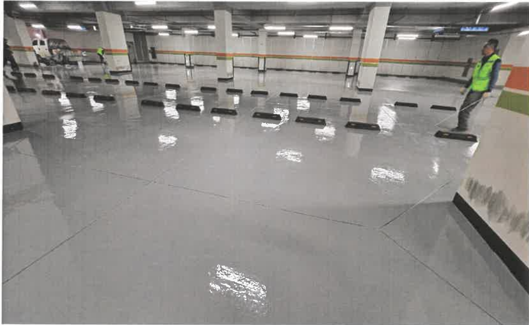
공사 중 : 차선 도장
