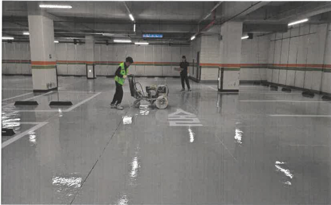
공사 중 : 차선 도장
