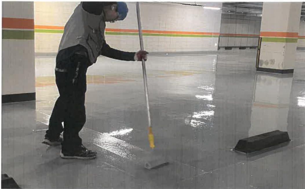
공사 중 : 엠보도포 후 코팅마감
