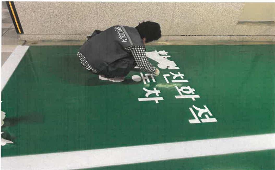
공사 중 : 그래픽 도장
