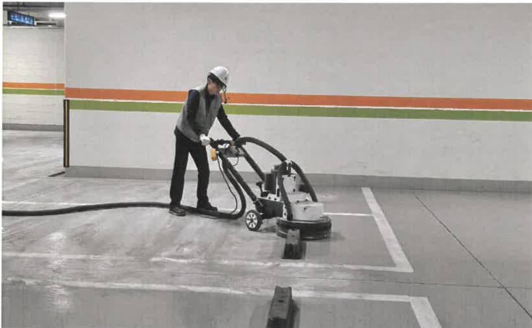
공사 중 : 바탕면 정리
