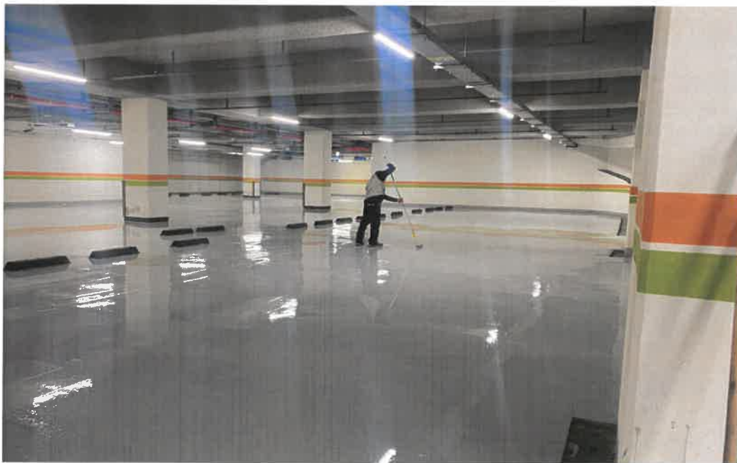
공사 중 : 에폭시 상도 2회도포
