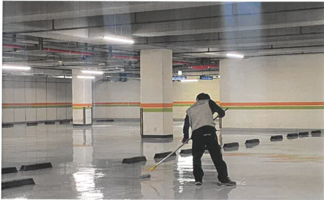
공사 중 : 에폭시 상도 2회도포
