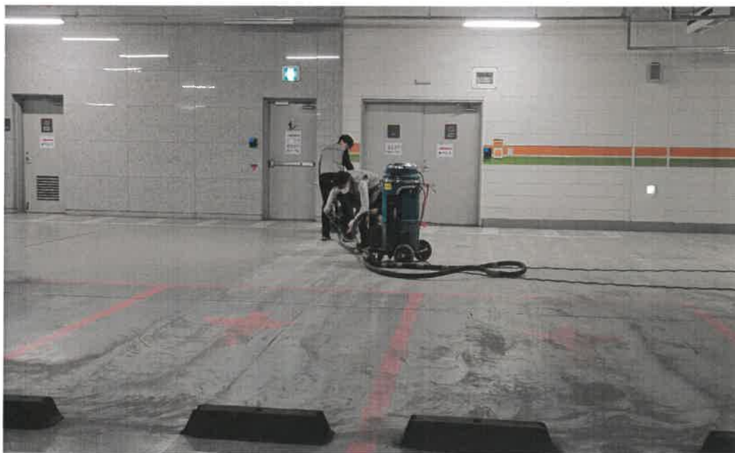
공사 중 : 바탕면 정리
