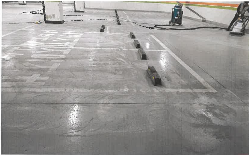
공사 중 : 바탕면 정리
