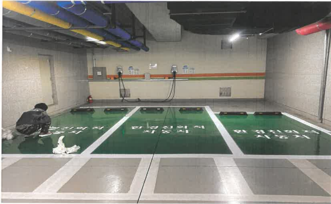
공사 중 : 그래픽 도장
