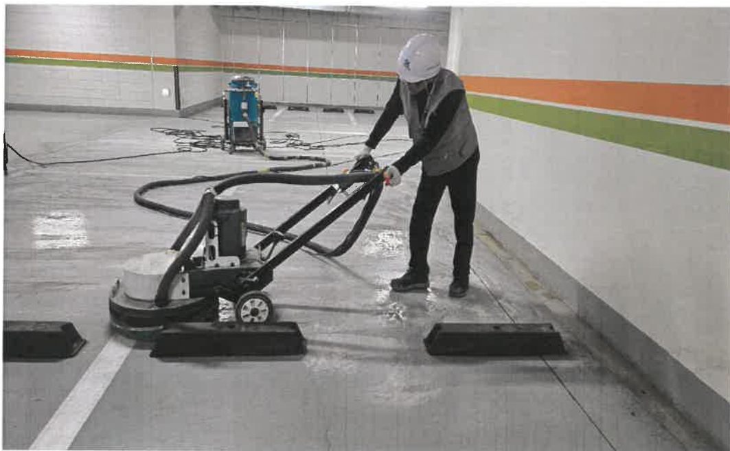
공사 중 : 바탕면 정리
