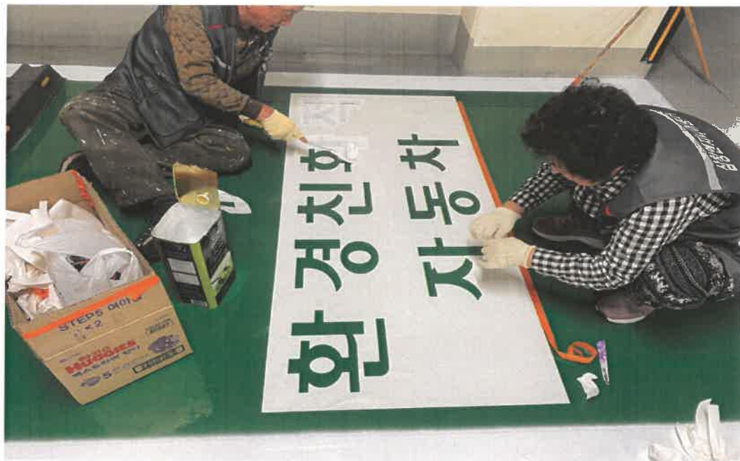
공사 중 : 그래픽 도장
