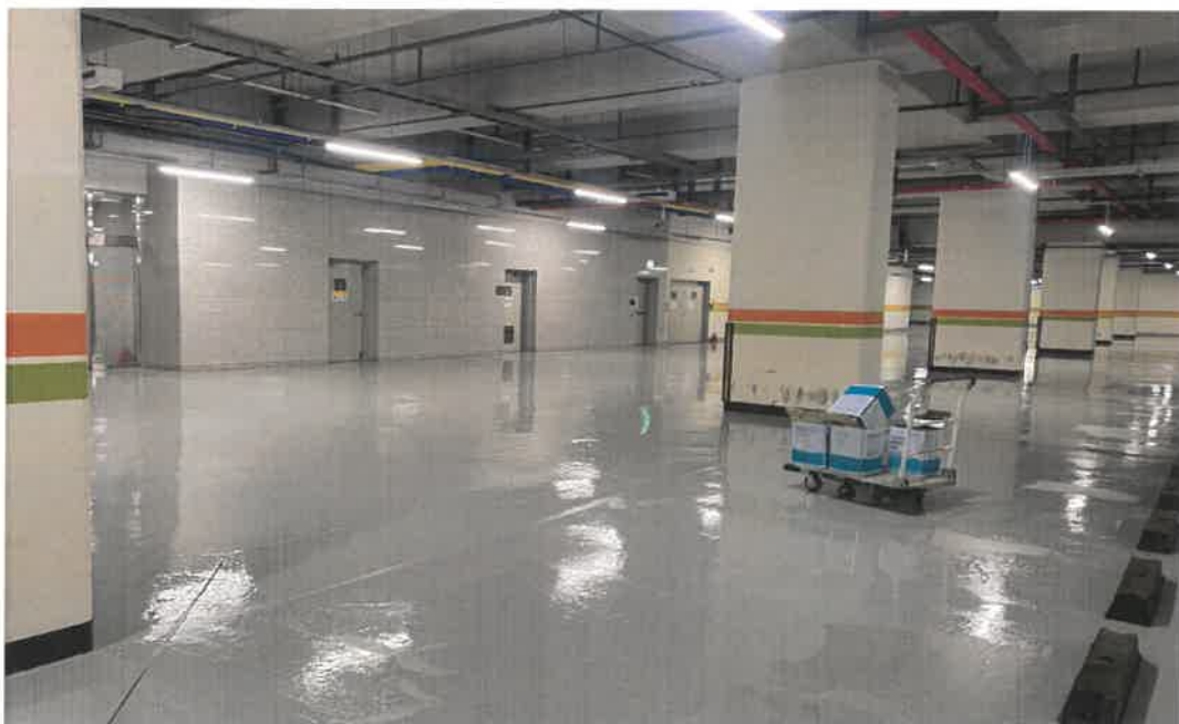
공사 중 : 에폭시 상도 2회도포
