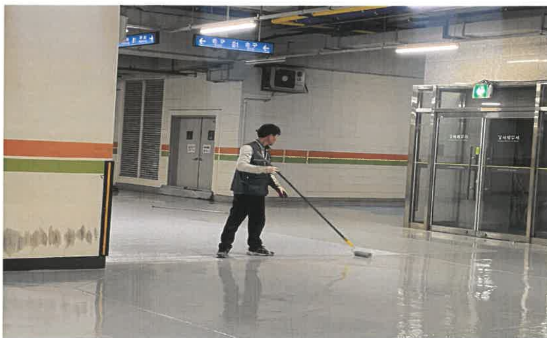
공사 중 : 엠보도포 후 코팅마감
