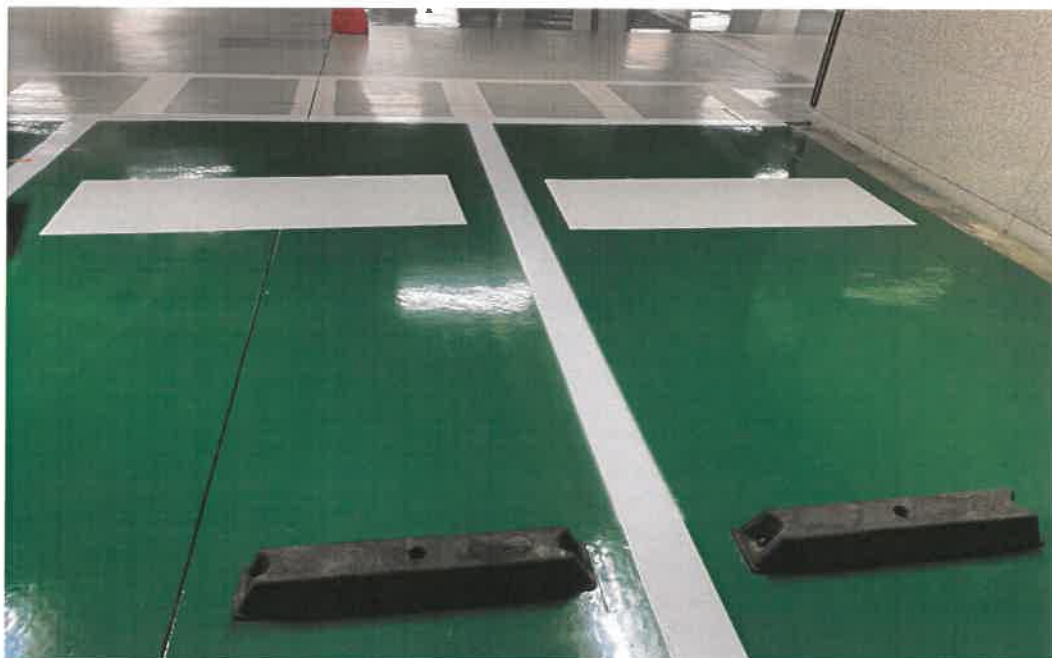
공사 중 : 그래픽 도장
