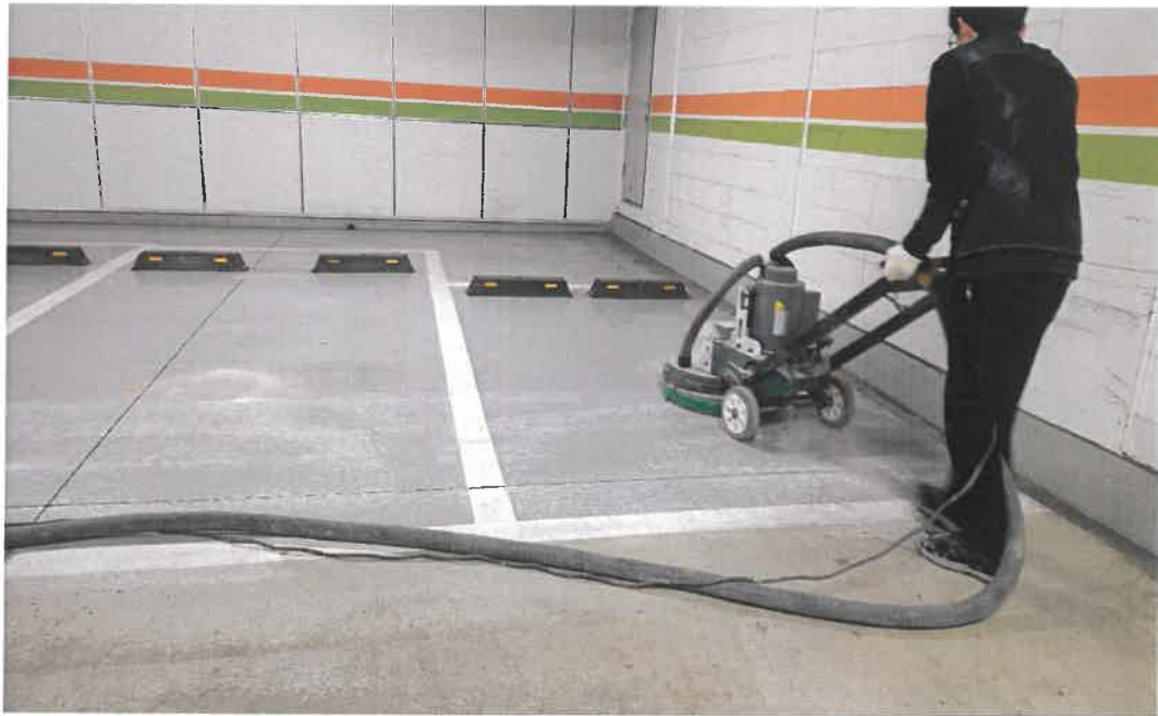
공사 중 : 바탕면 정리
