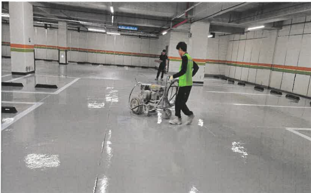
공사 중 : 차선 도장
