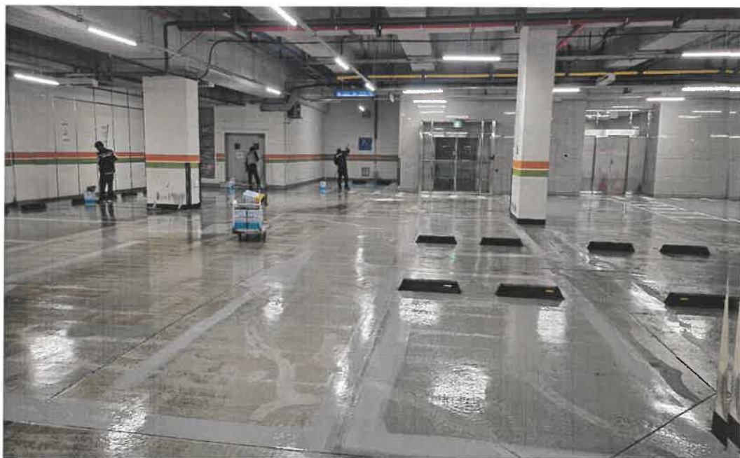
공사 중 : 에폭시 하도 도포
