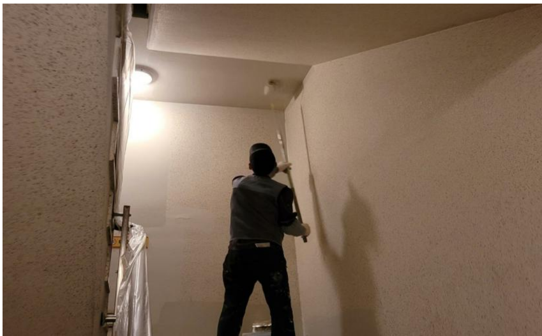
공사 중 (내부 수성페인트)
