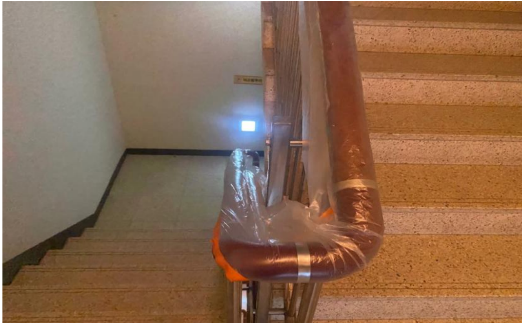
공사 중 (계단실 난간대 보양)
