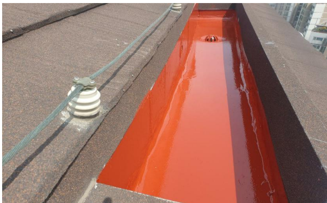
공사 중 (우레탄 상도 마감)
