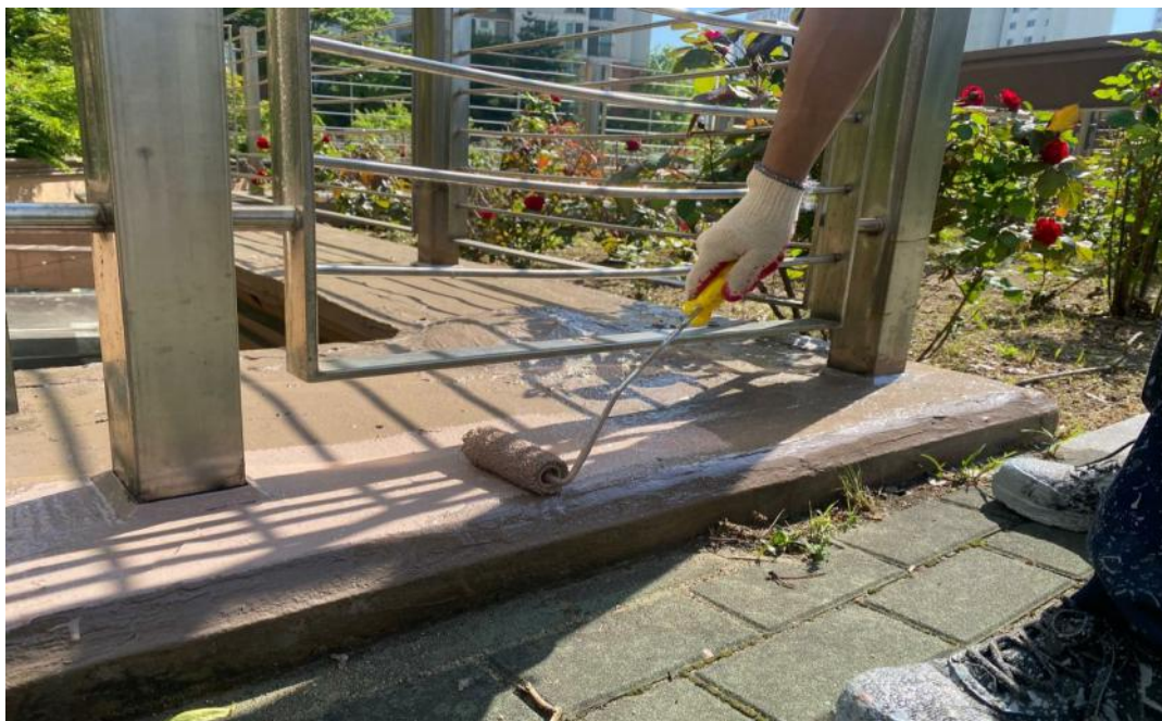
공사 중 (우레탄 상도 마감)
