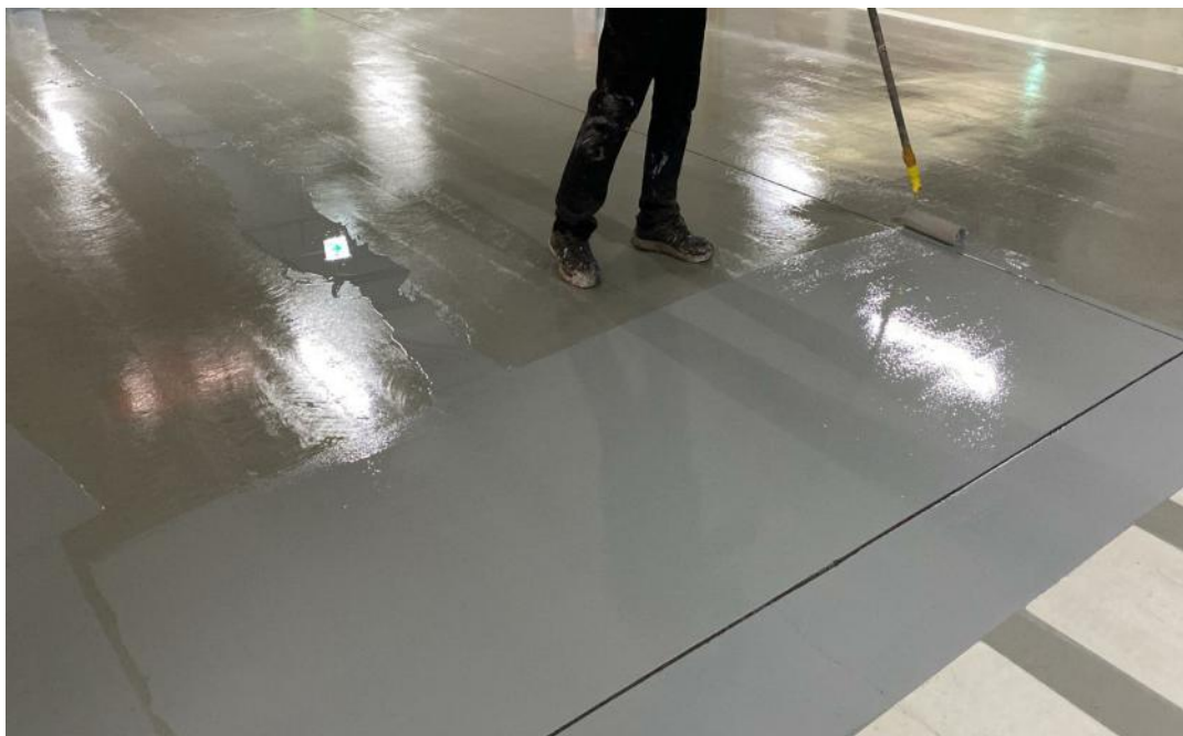
공사 중 (에폭시 상도 도포)
