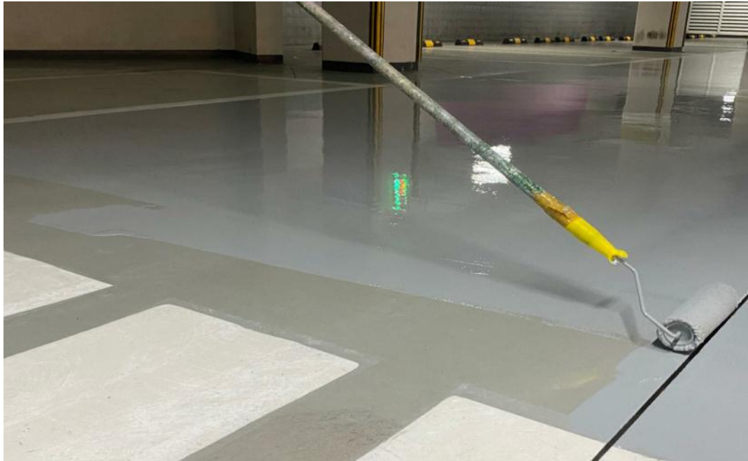
공사 중 (에폭시 상도 도포)
