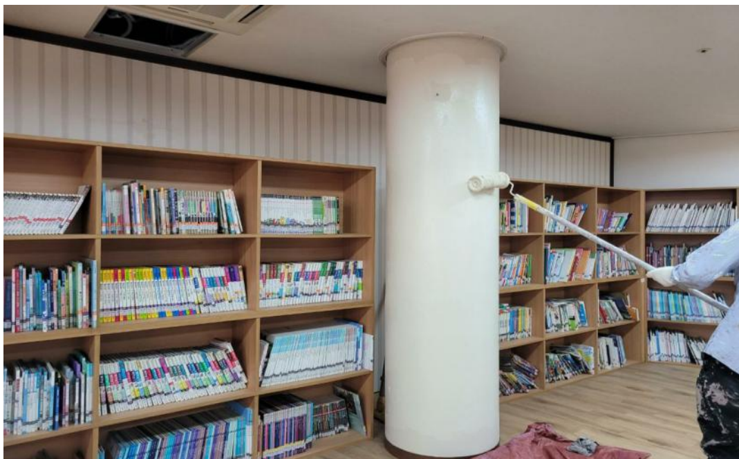
공사 중 (부대시설 도장)
