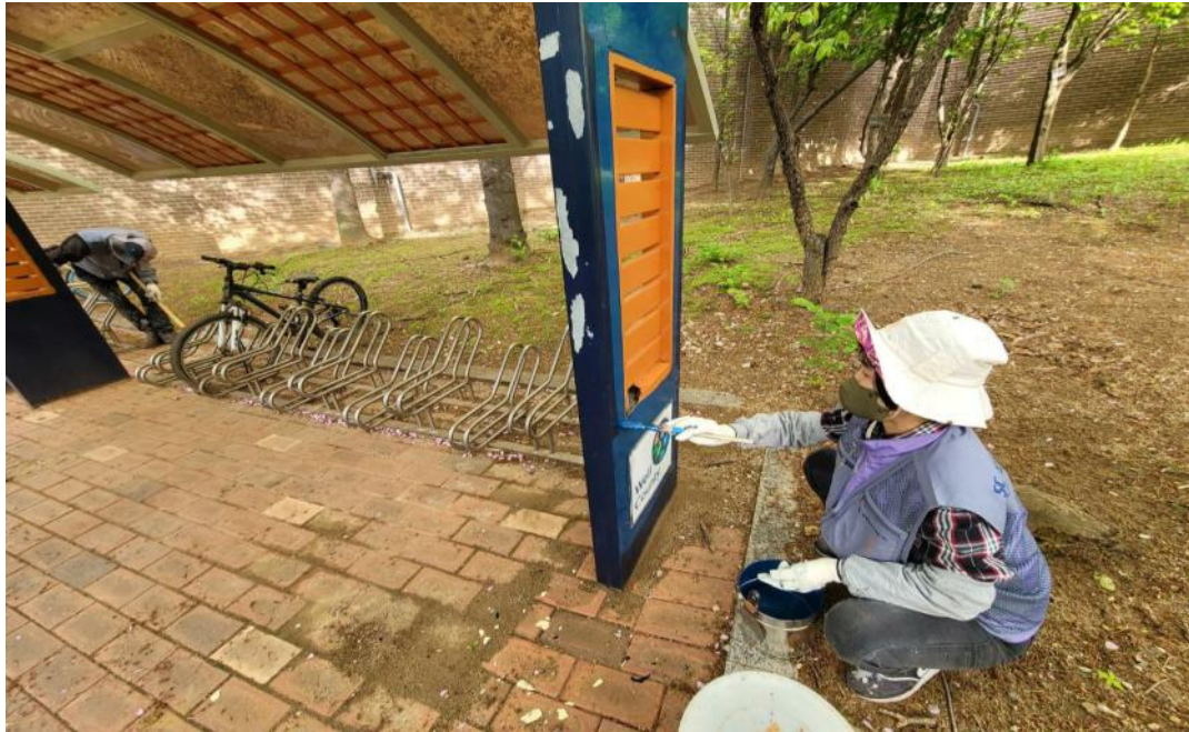
공사 중 (부대시설 도장)
