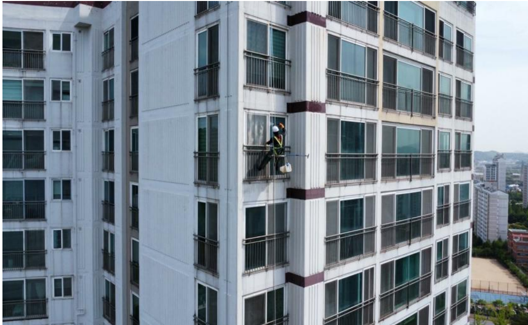
공사 중 (고압세척)
