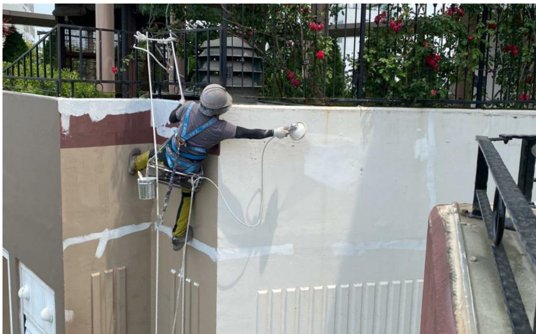
공사 중 (수성페인트 도장)
