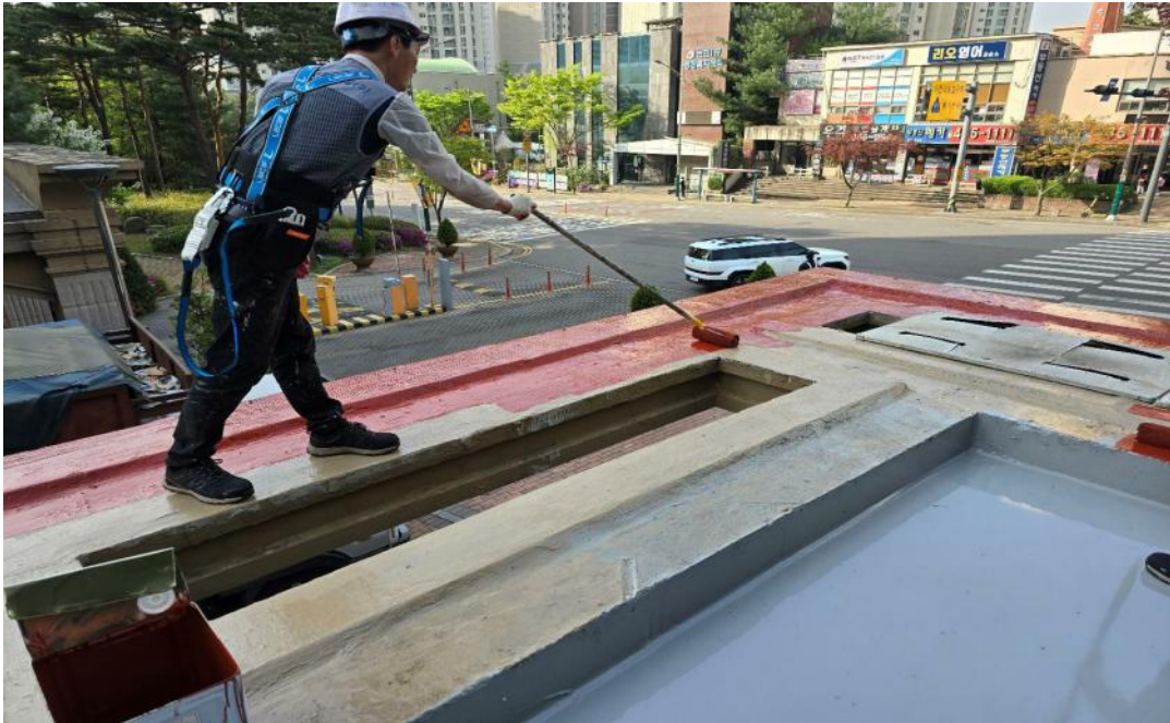
공사 중 (우레탄 상도 마감)
