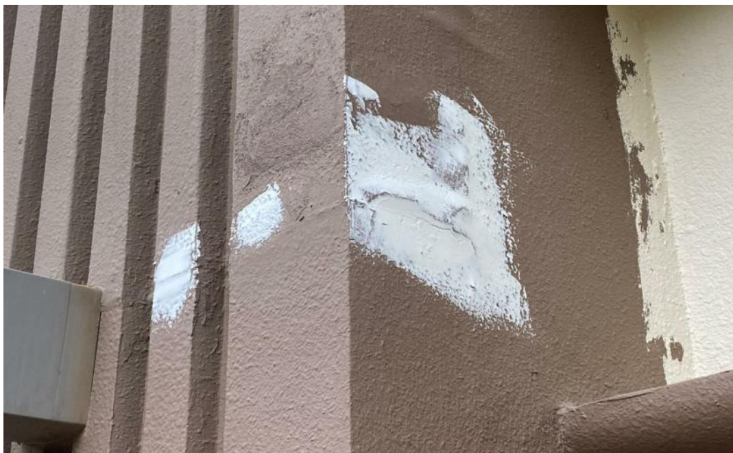
공사 중 (상가부위 균열보수)
