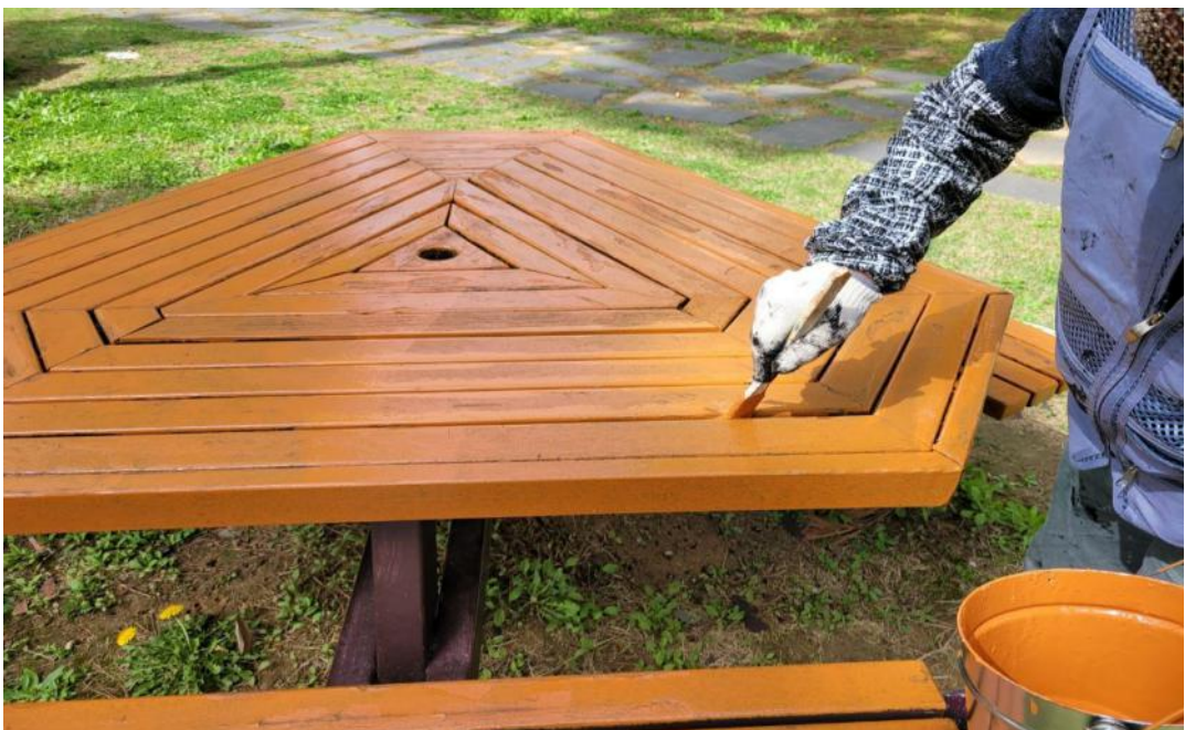
공사 중 (부대시설 도장)
