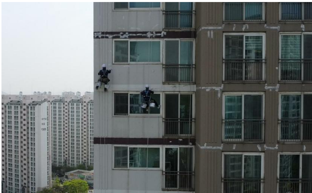
공사 중 (균열보수)
