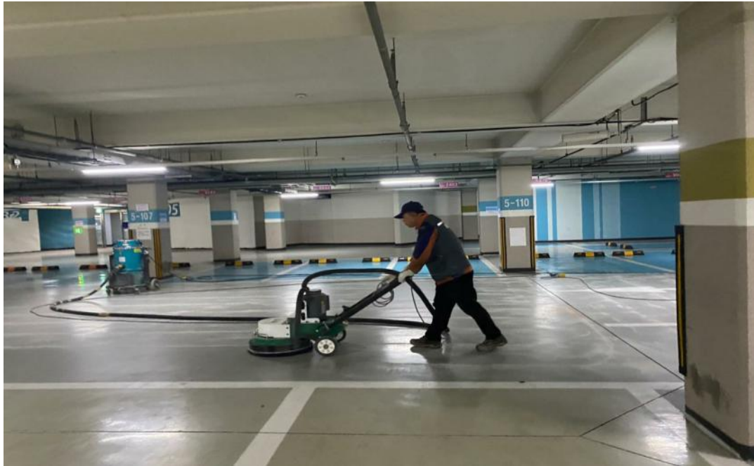
공사 중 (바탕면 정리)
