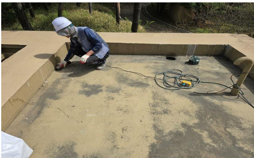
공사 중 (바탕면 정리)
