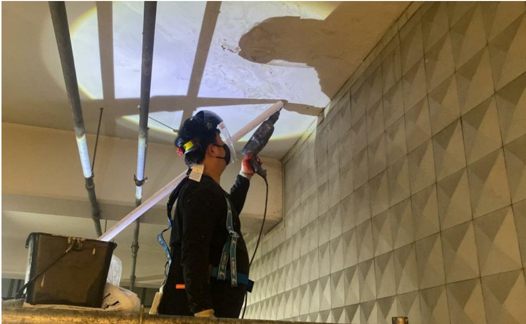
공사 중 (인젝션 주입)
