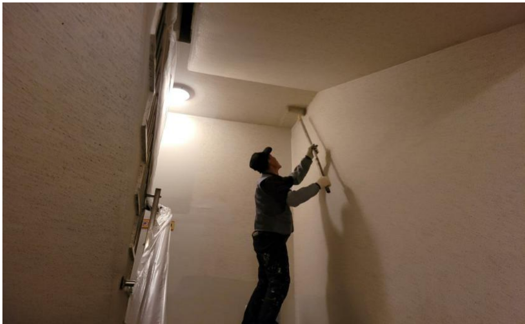
공사 중 (내부 수성페인트)
