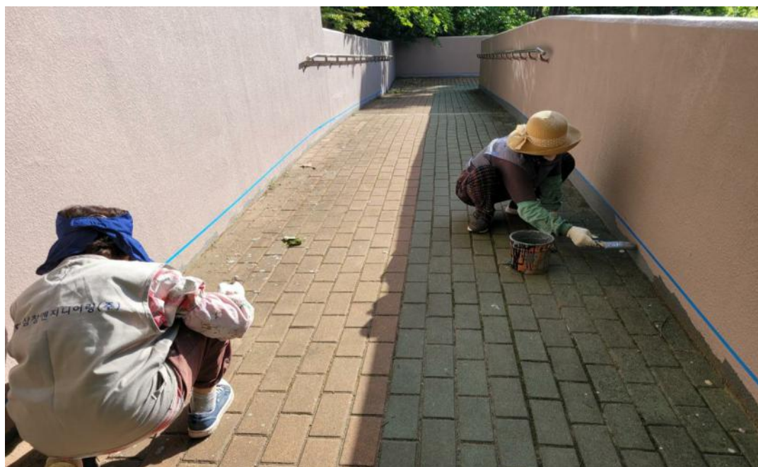
공사 중 (상가부위 걸레받이 페인트)
