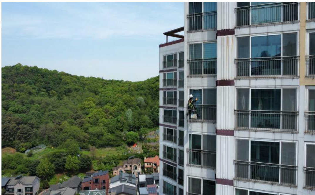
공사 중 (고압세척)
