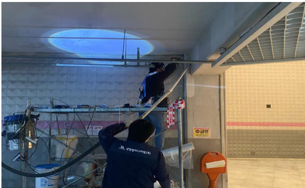
공사 중 (인젝션 주입)
