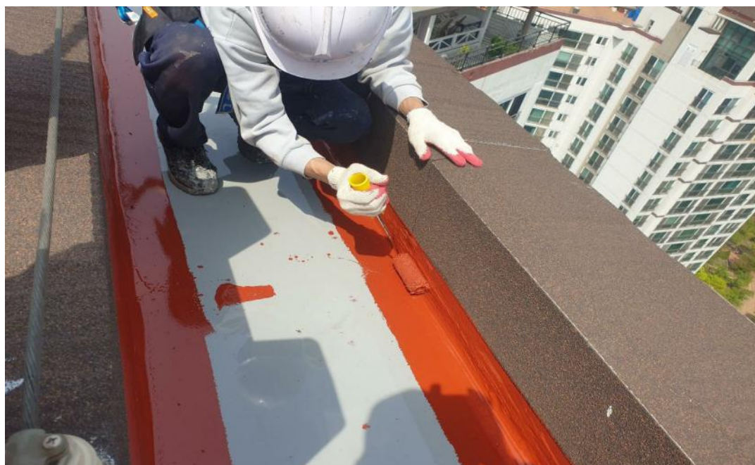
공사 중 (우레탄 상도 마감)
