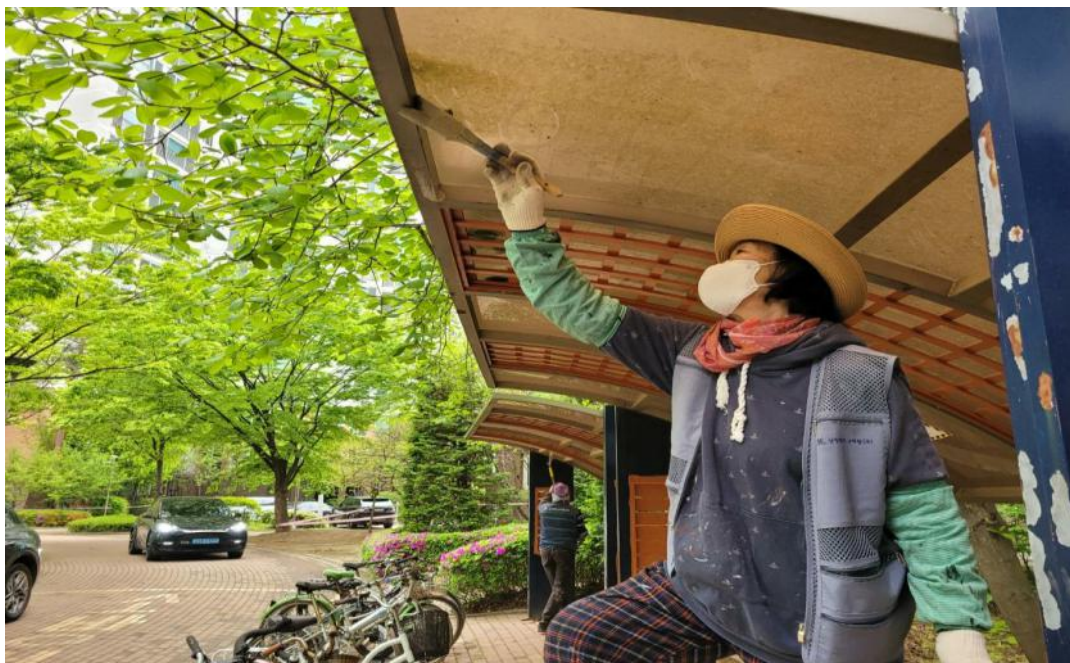
공사 중 (부대시설 도장)
