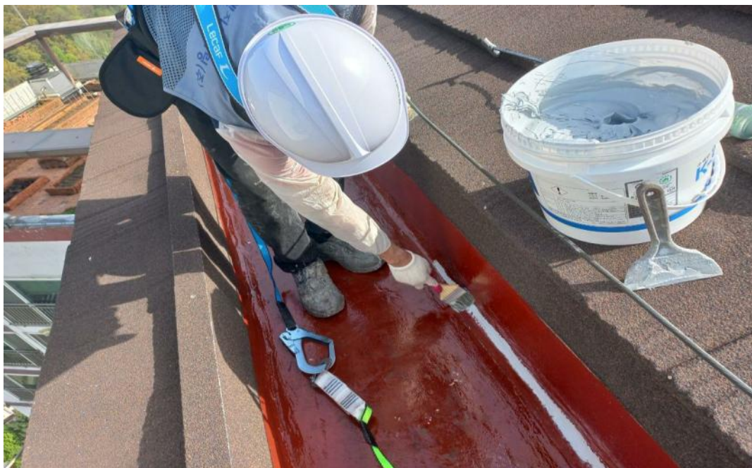
공사 중 (우레탄 하도 및 실란트)
