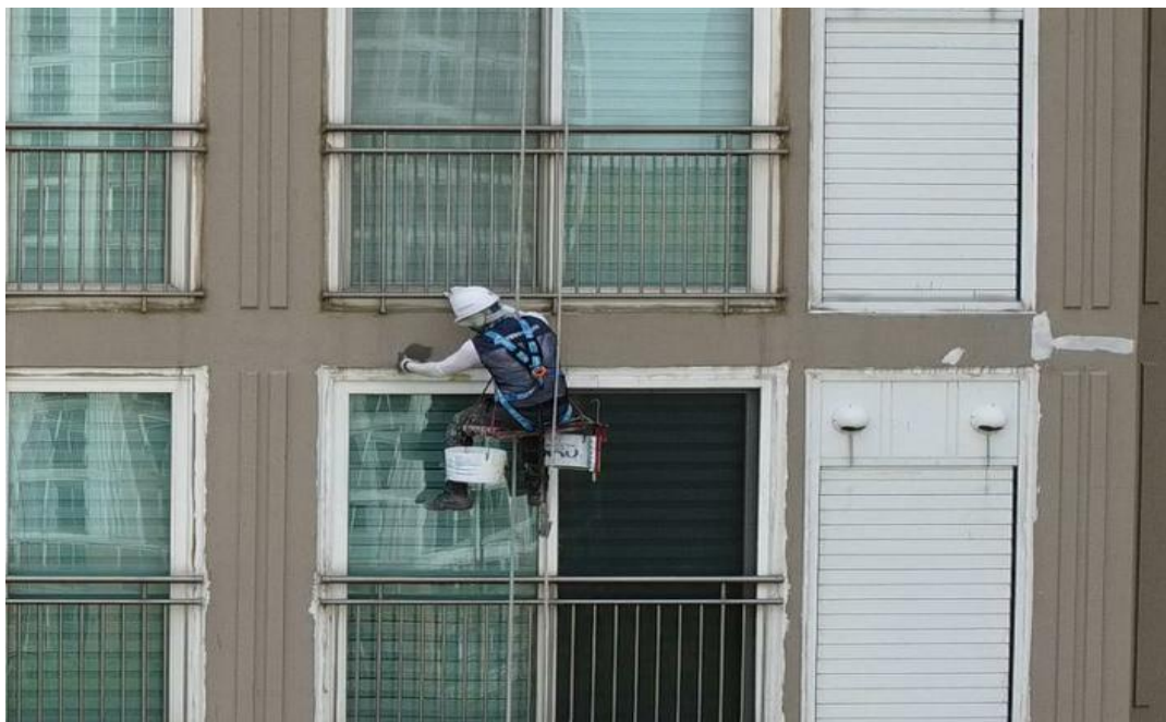
공사 중 (균열보수)
