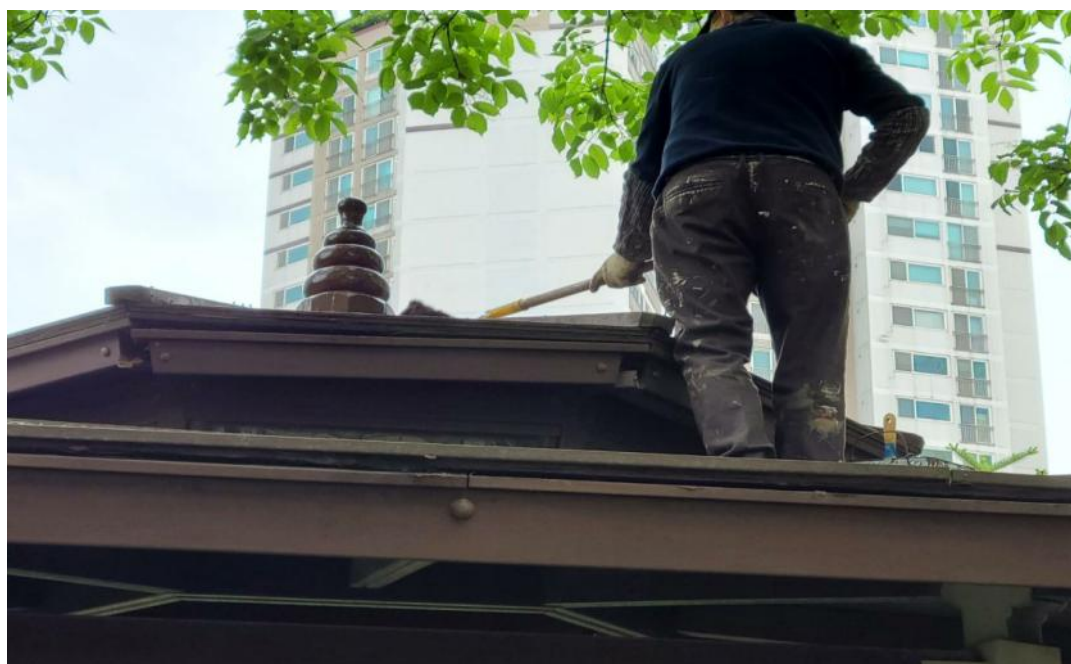
공사 중 (부대시설 도장)
