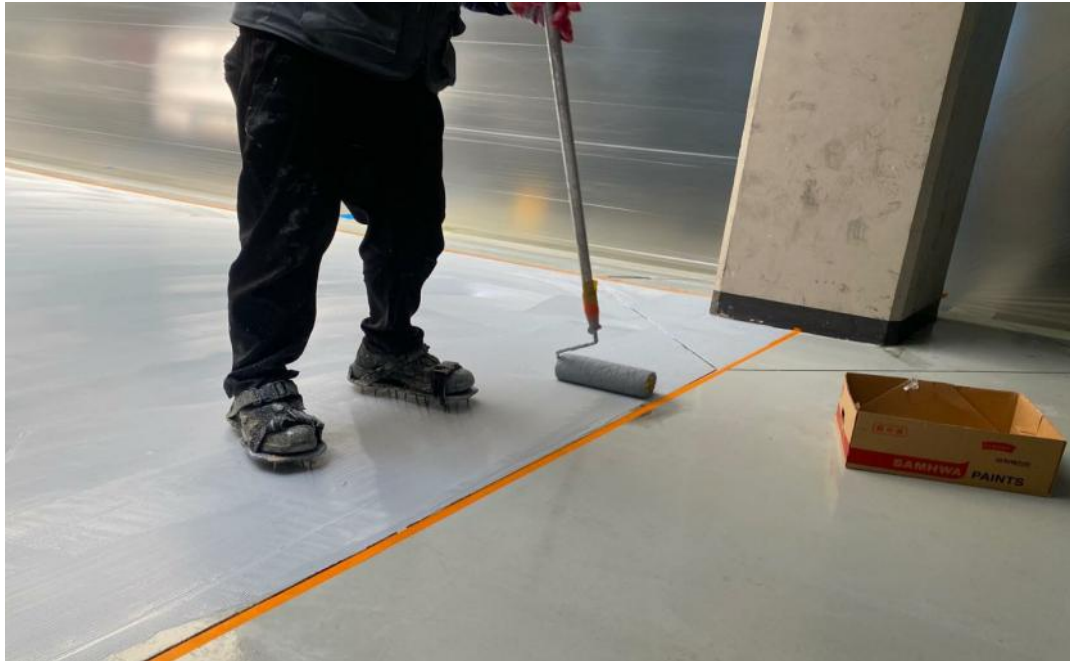
공사 중 (에폭시 엠보)
