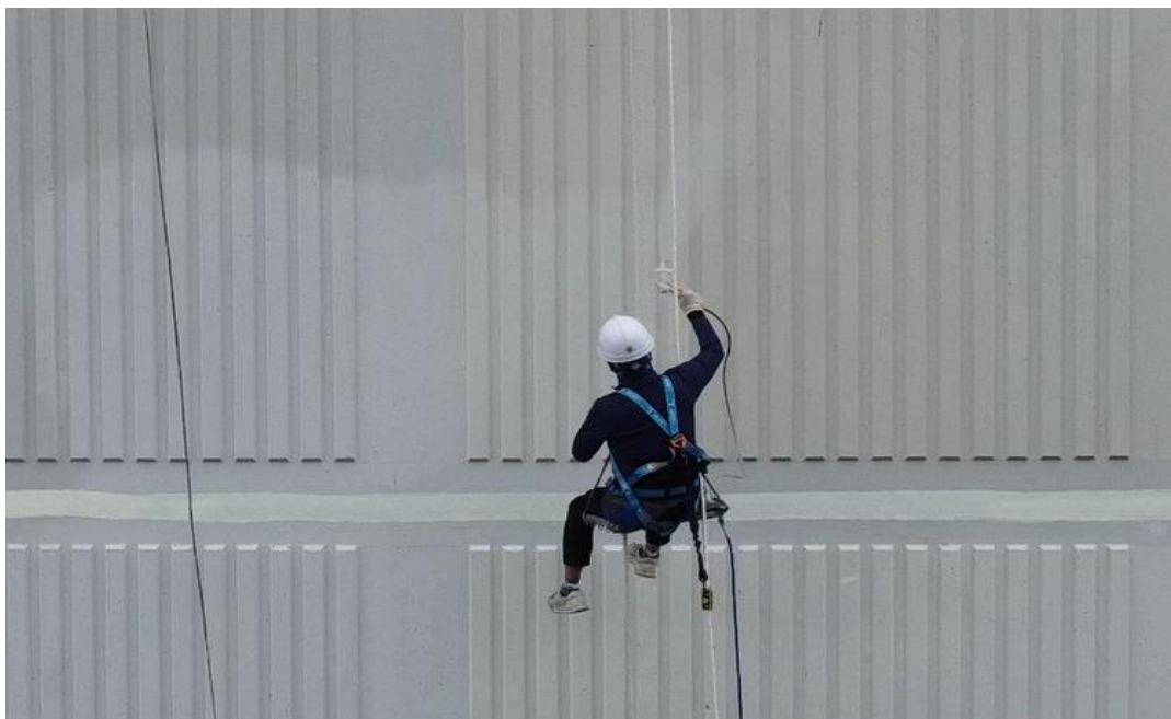
공사 중 (바인다 작업)
