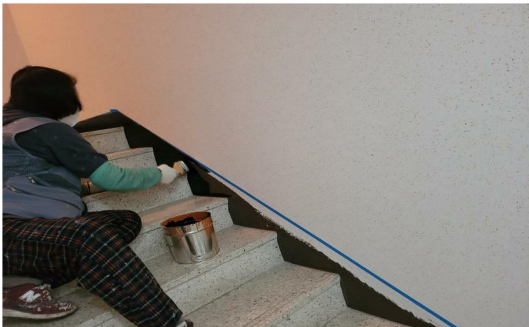
공사 중 (걸레받이 페인트)
