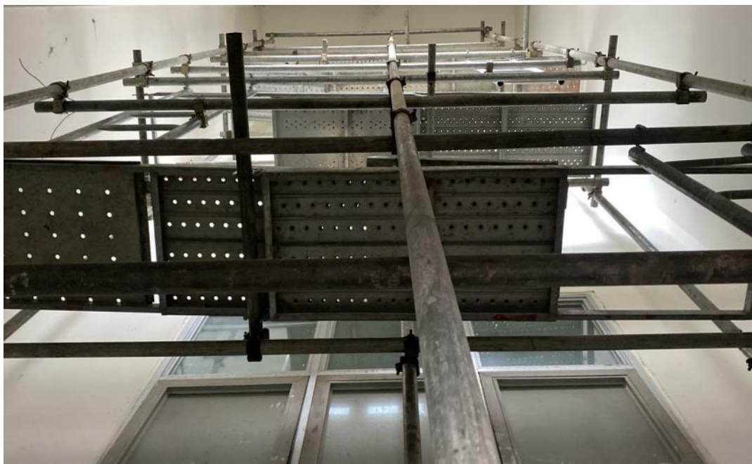
공사 중 (아시바 설치)
