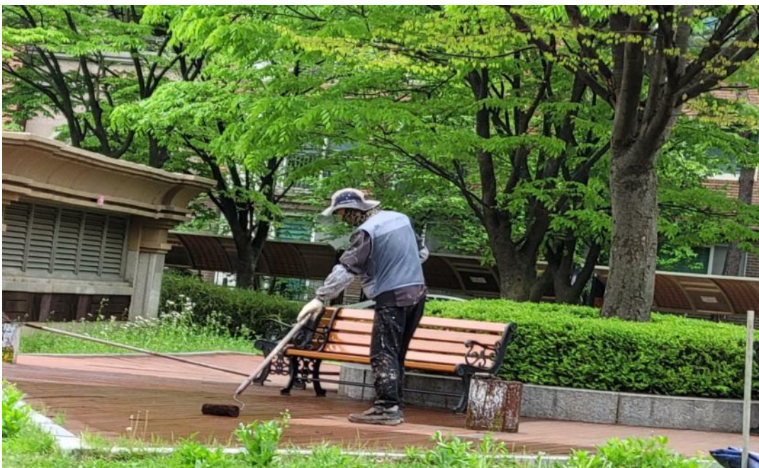
공사 중 (부대시설 도장)
