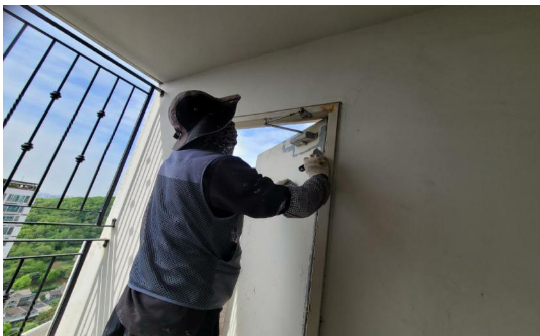
공사 중 (부대시설 도장)
