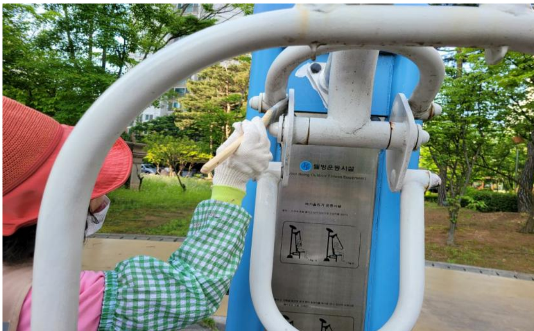
공사 중 (부대시설 도장)
