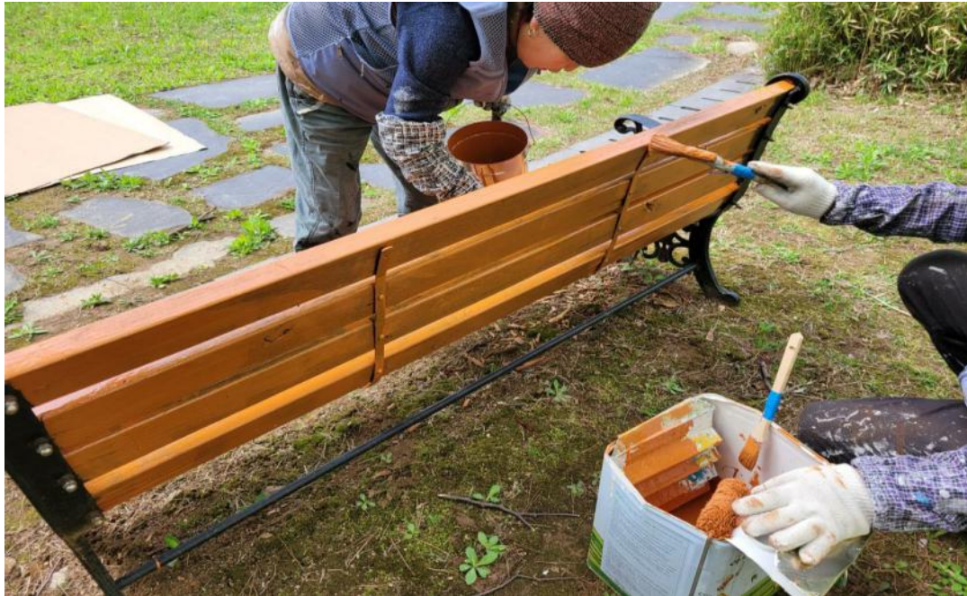
공사 중 (부대시설 도장)
