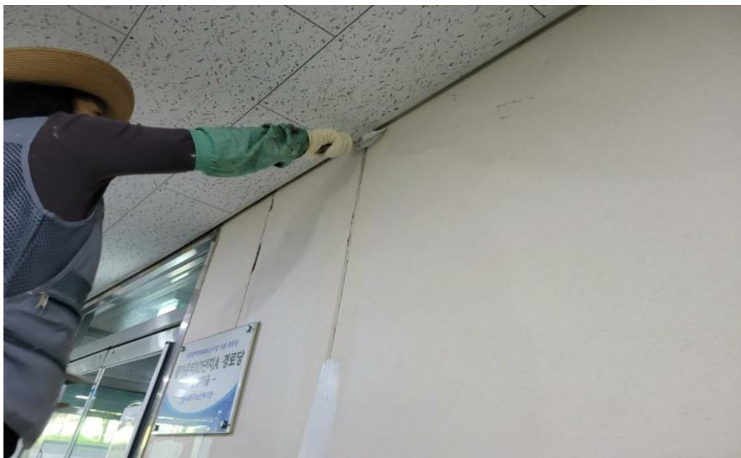
공사 중 (부대시설 도장)
