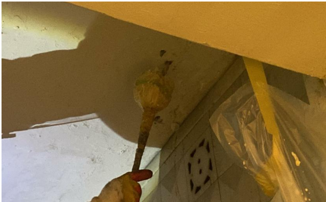
공사 중 (인젝션 주입)
