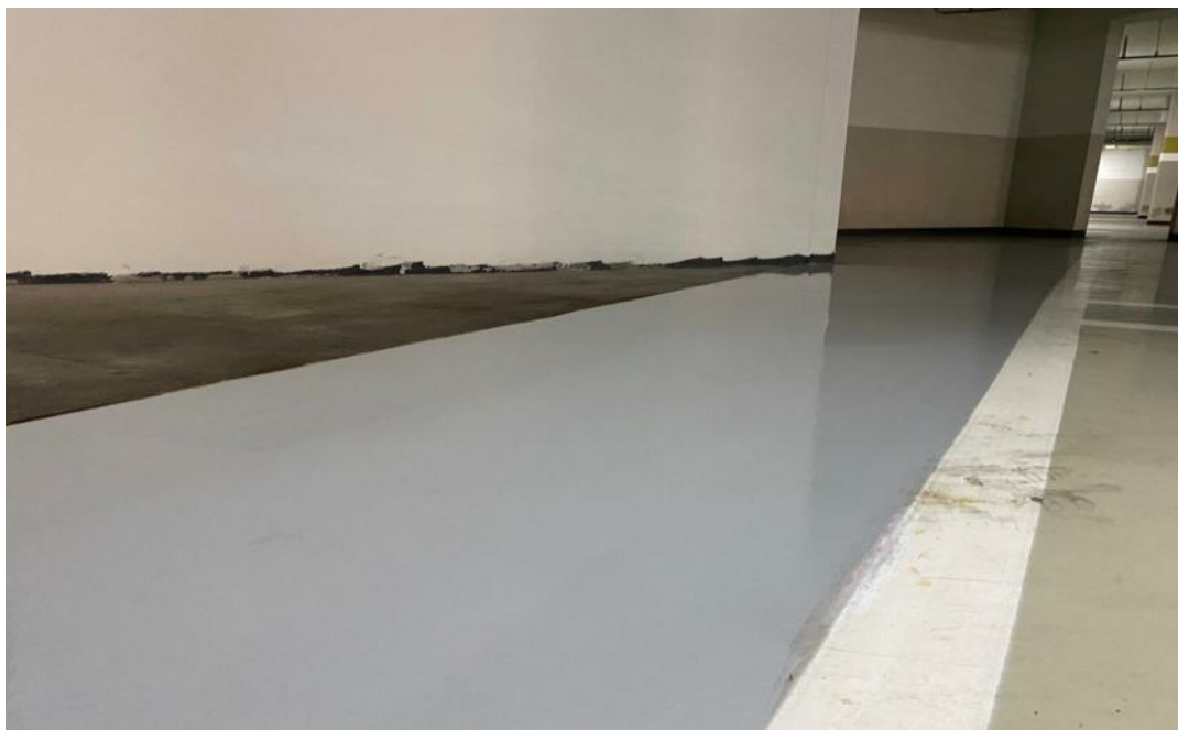
공사 중 (에폭시 상도 도포)
