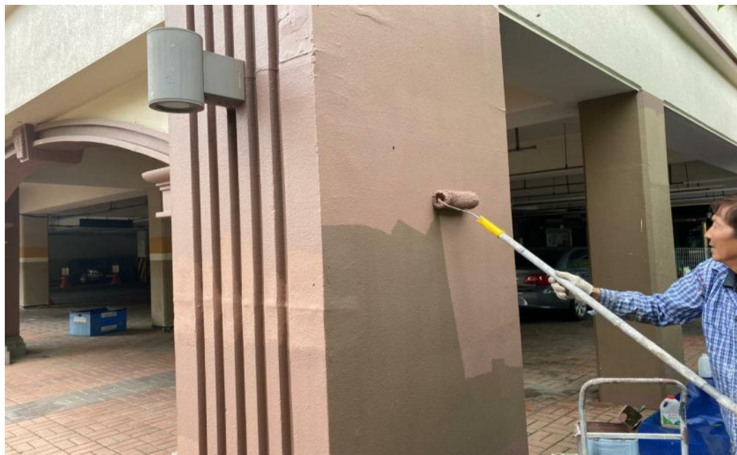
공사 중 (상가부위 수성페인트)
