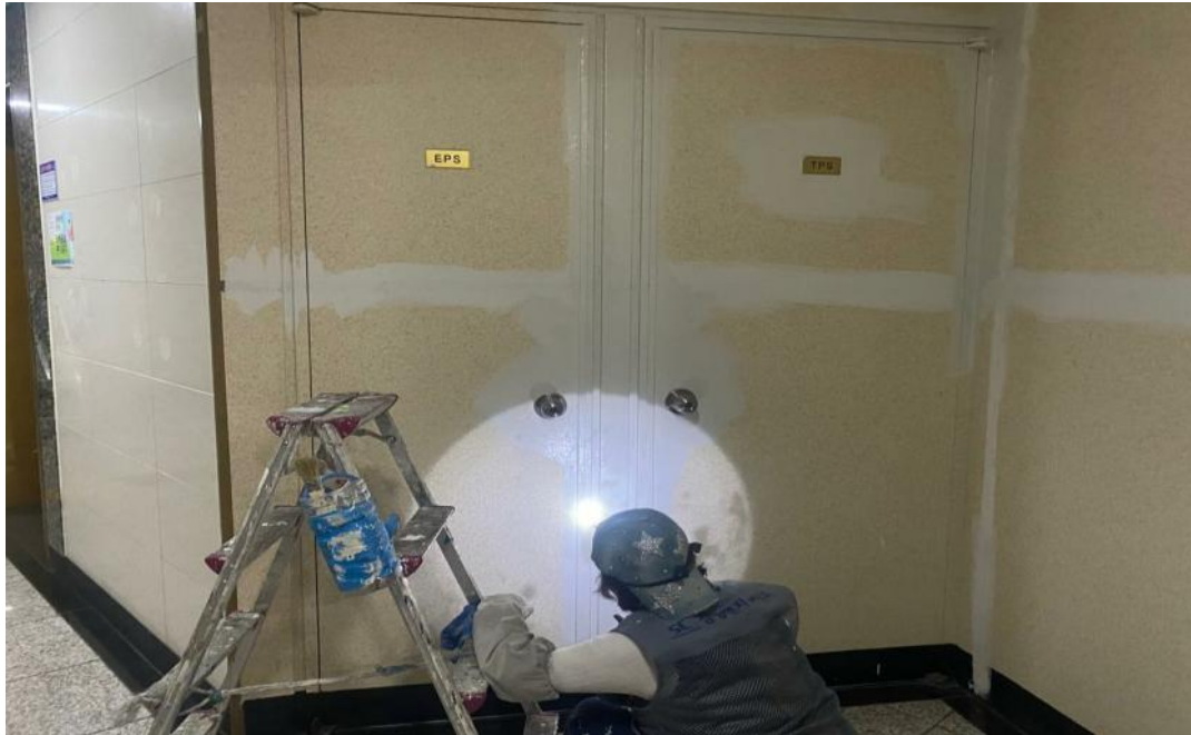
공사 중 (내부 균열보수)
