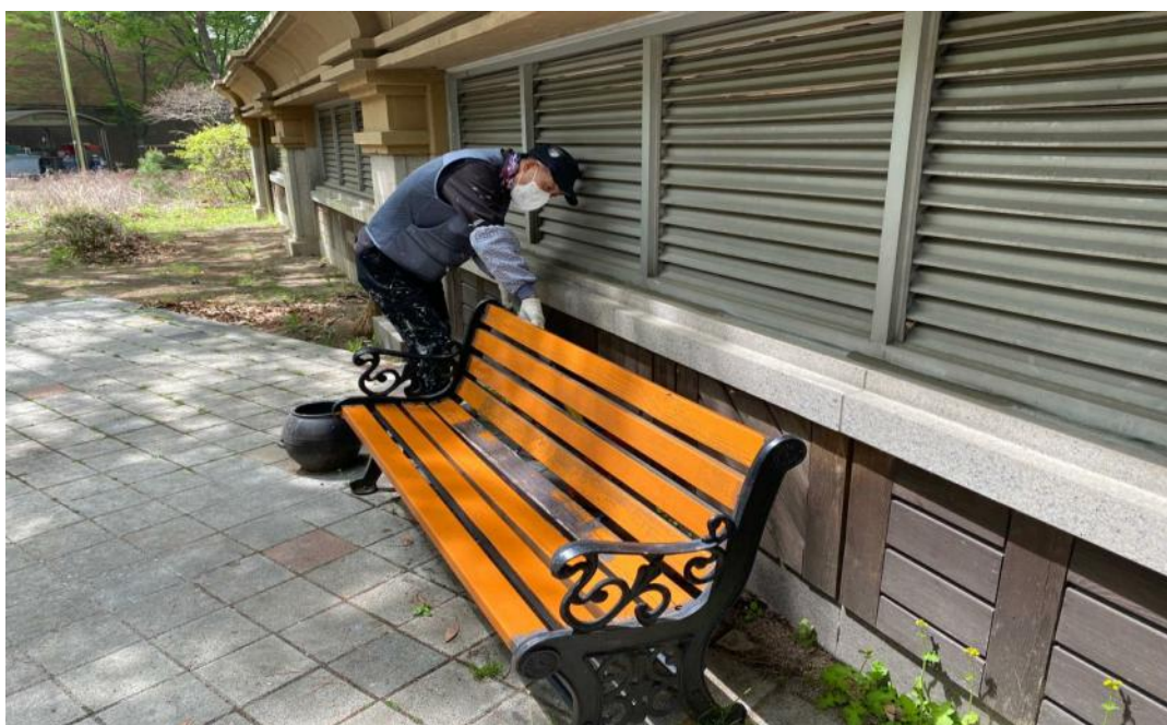
공사 중 (부대시설 도장)
