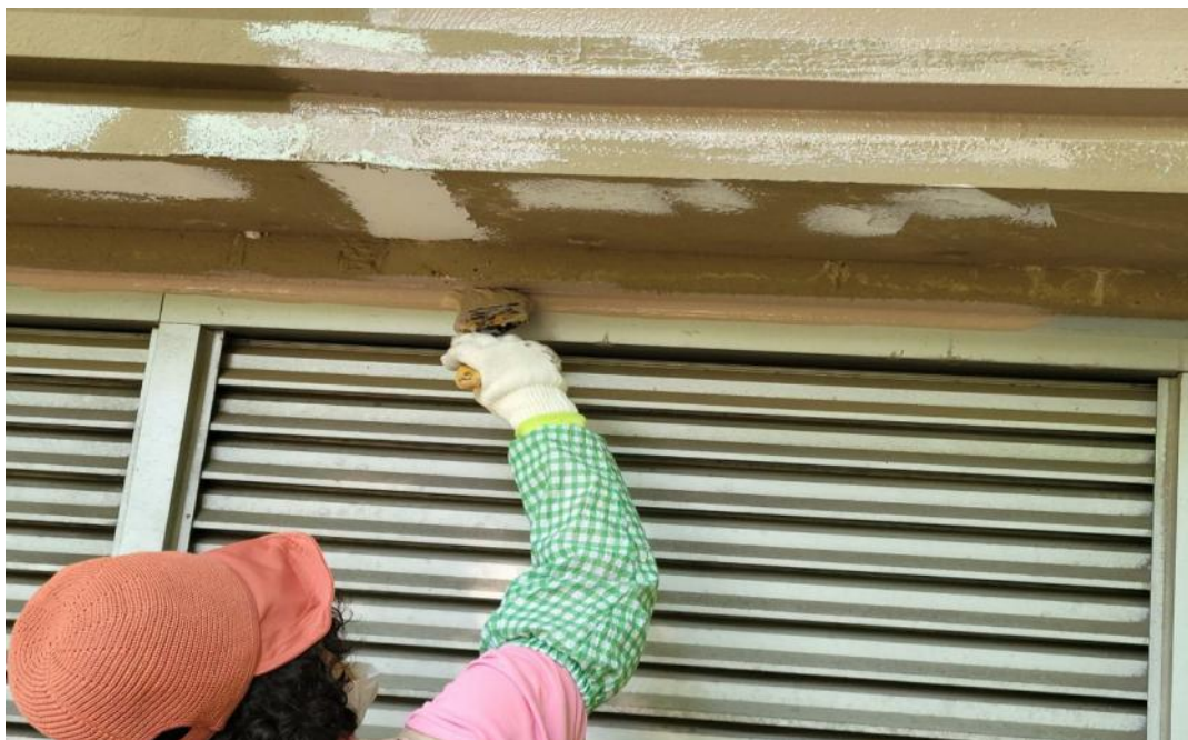
공사 중 (부대시설 도장)
