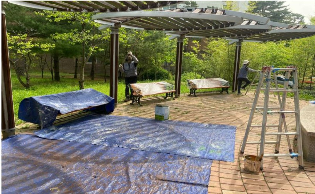
공사 중 (부대시설 도장)
