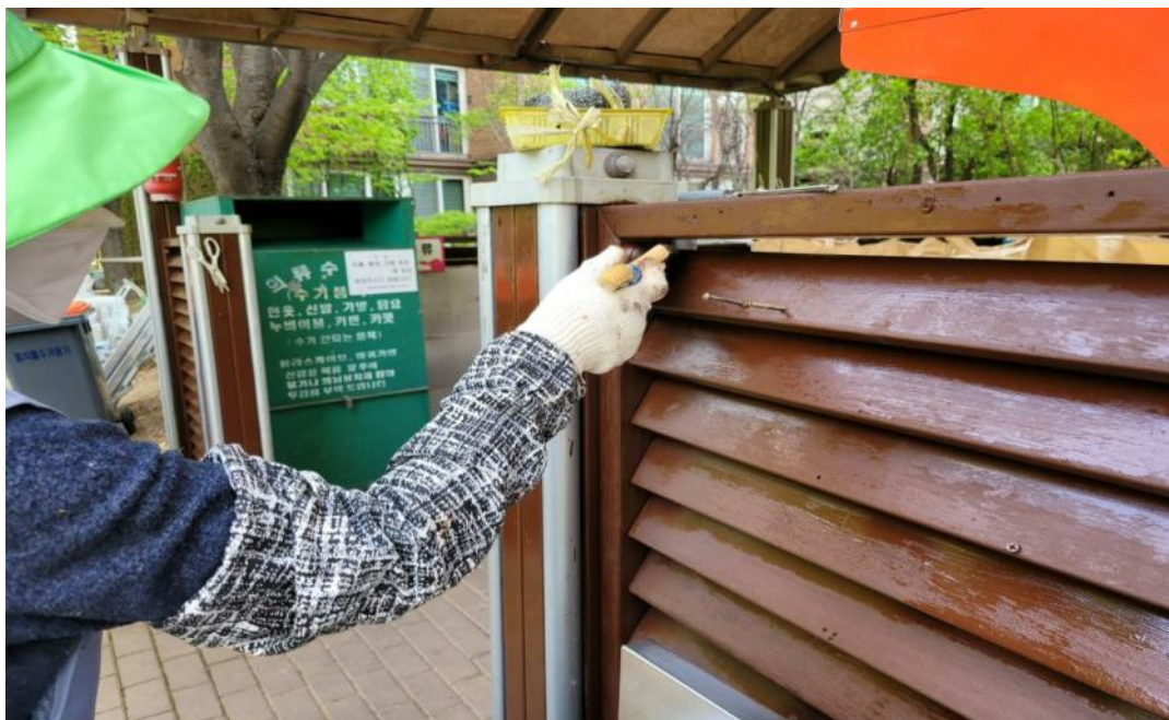
공사 중 (부대시설 도장)
