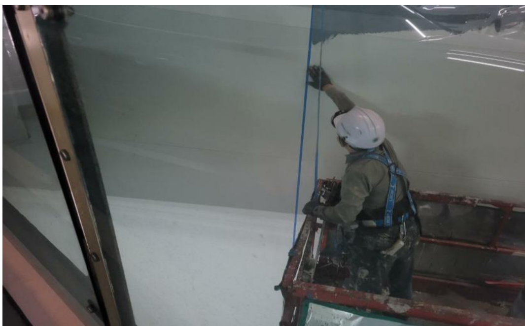
공사 중 (지하주차장 벽체 도장)
