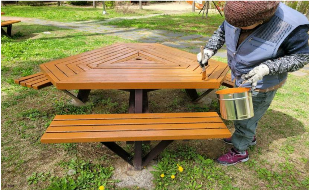
공사 중 (부대시설 도장)
