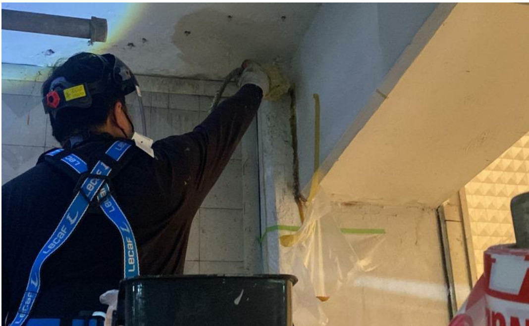
공사 중 (인젝션 주입)
