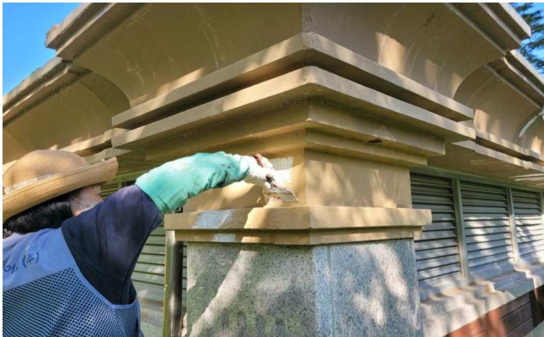
공사 중 (부대시설 도장)
