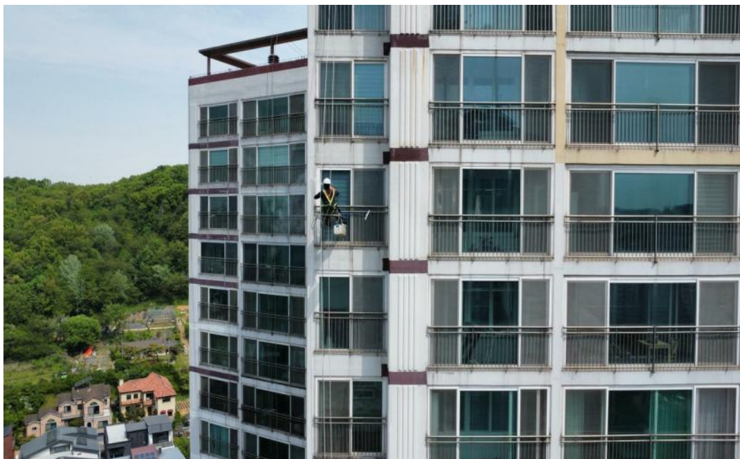
공사 중 (고압세척)
