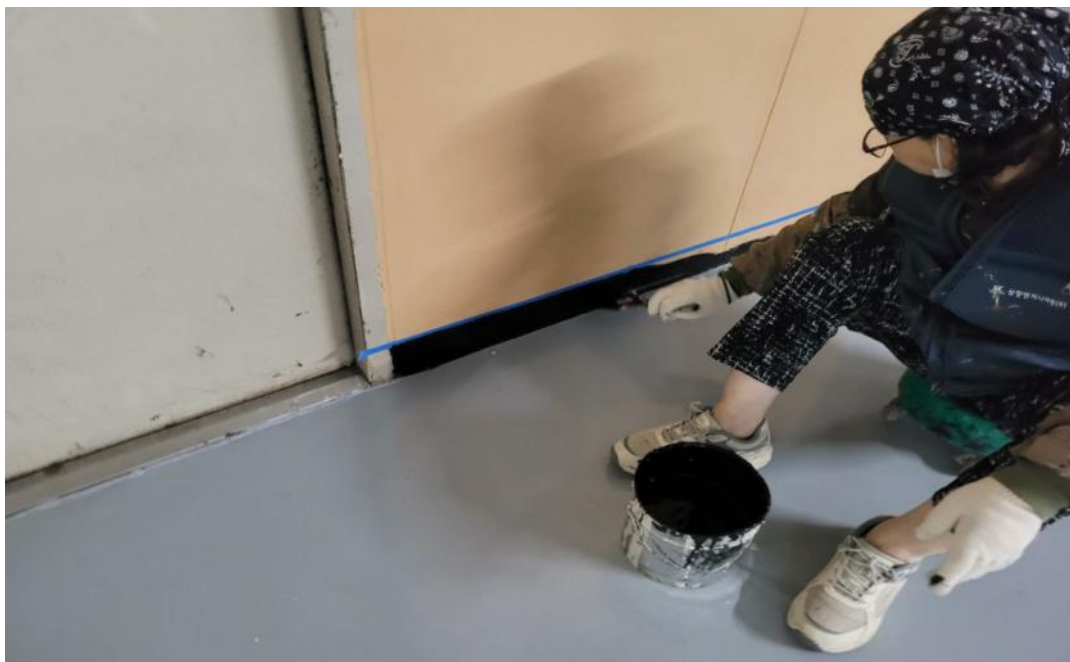
공사 중 (걸레받이 페인트)
