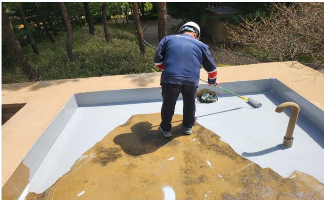
공사 중 (우레탄 중도 도포)
