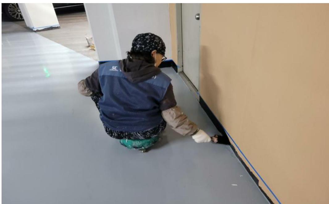
공사 중 (걸레받이 페인트)
