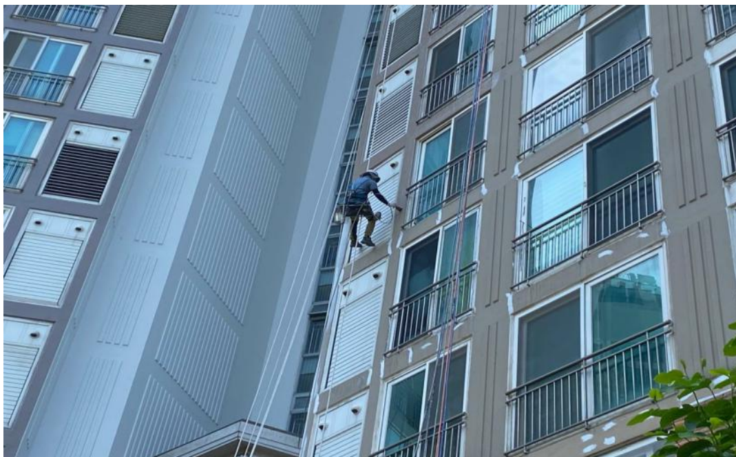
공사 중 (수성페인트 도장)
