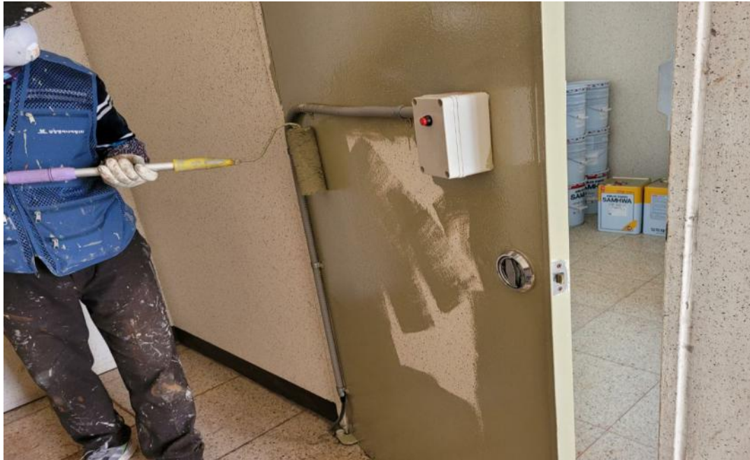
공사 중 (부대시설 도장)
