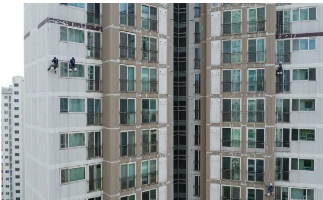
공사 중 (균열보수)
