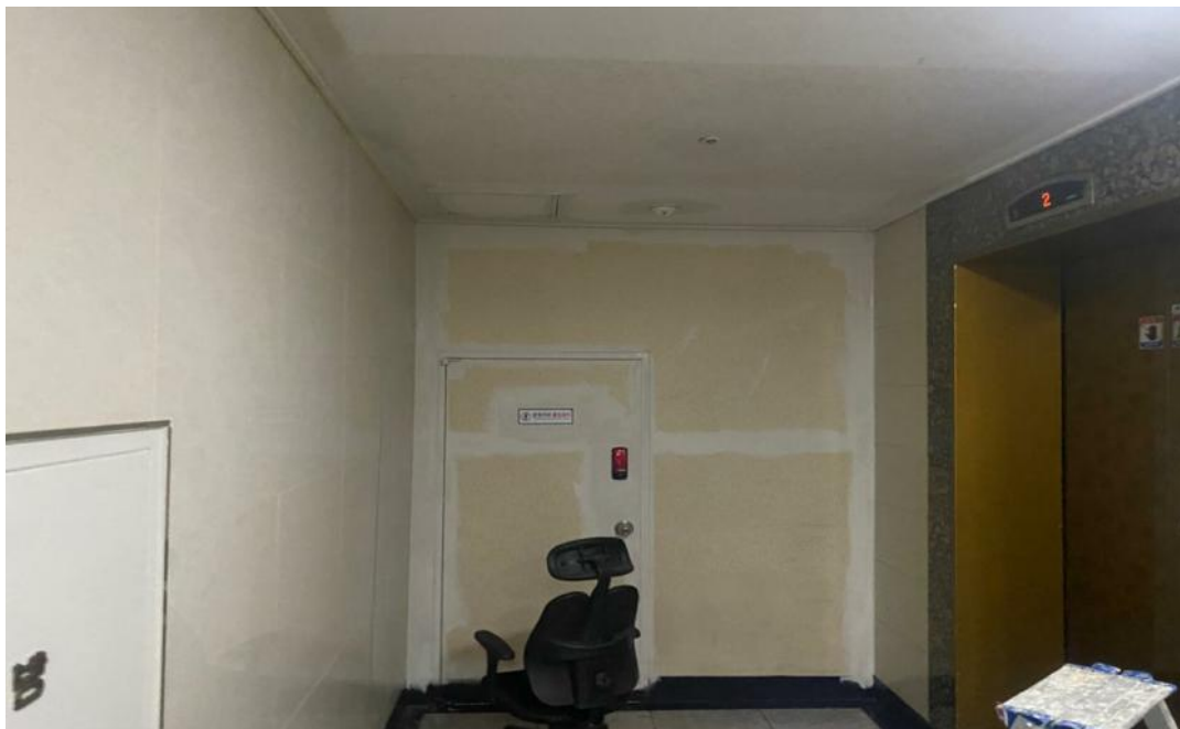
공사 중 (내부 균열보수)
