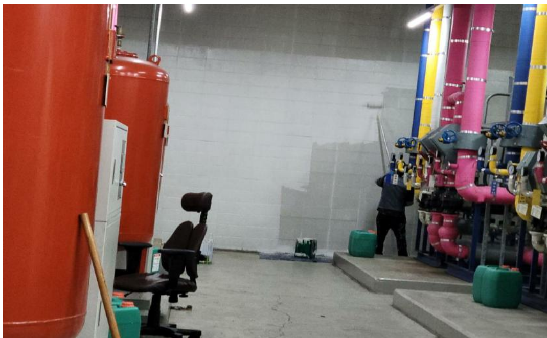
공사 중 (부대시설 도장)
