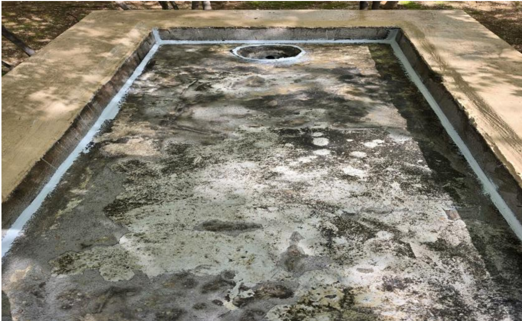
공사 중 (우레탄 하도 및 실란트)
