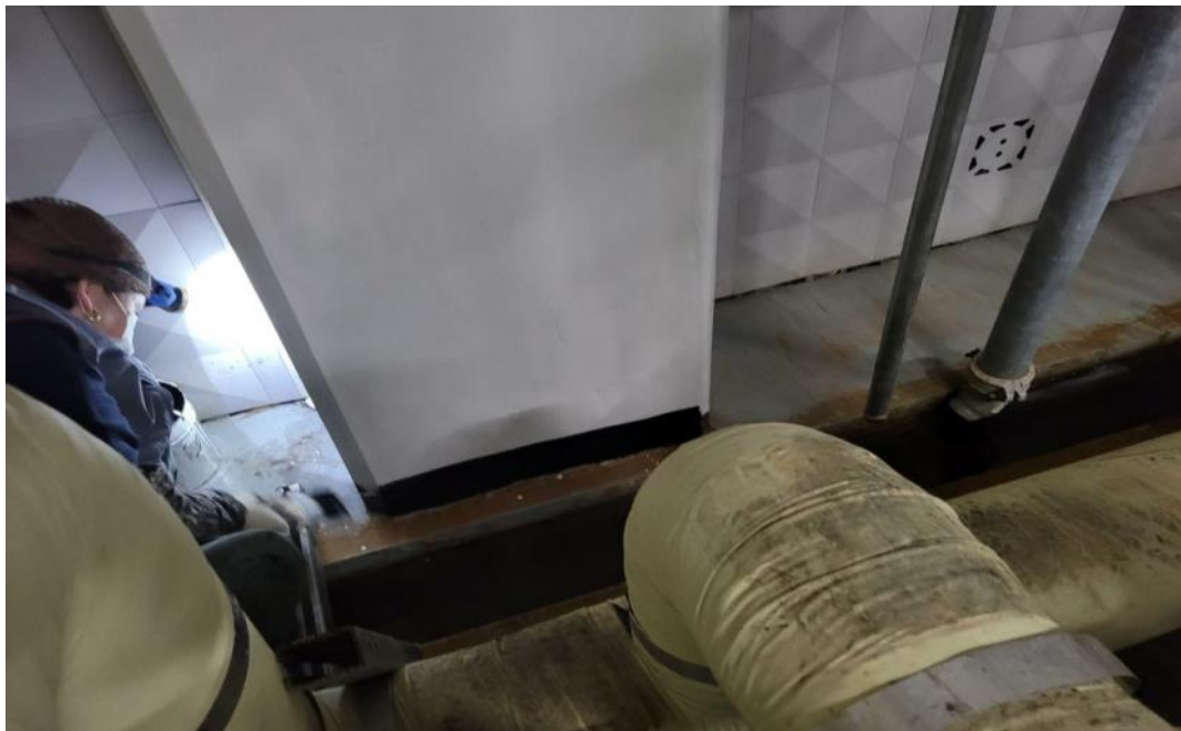
공사 중 (부대시설 도장)
