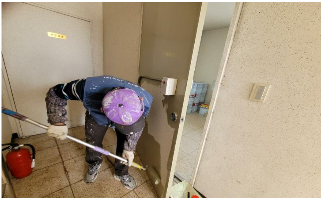
공사 중 (부대시설 도장)
