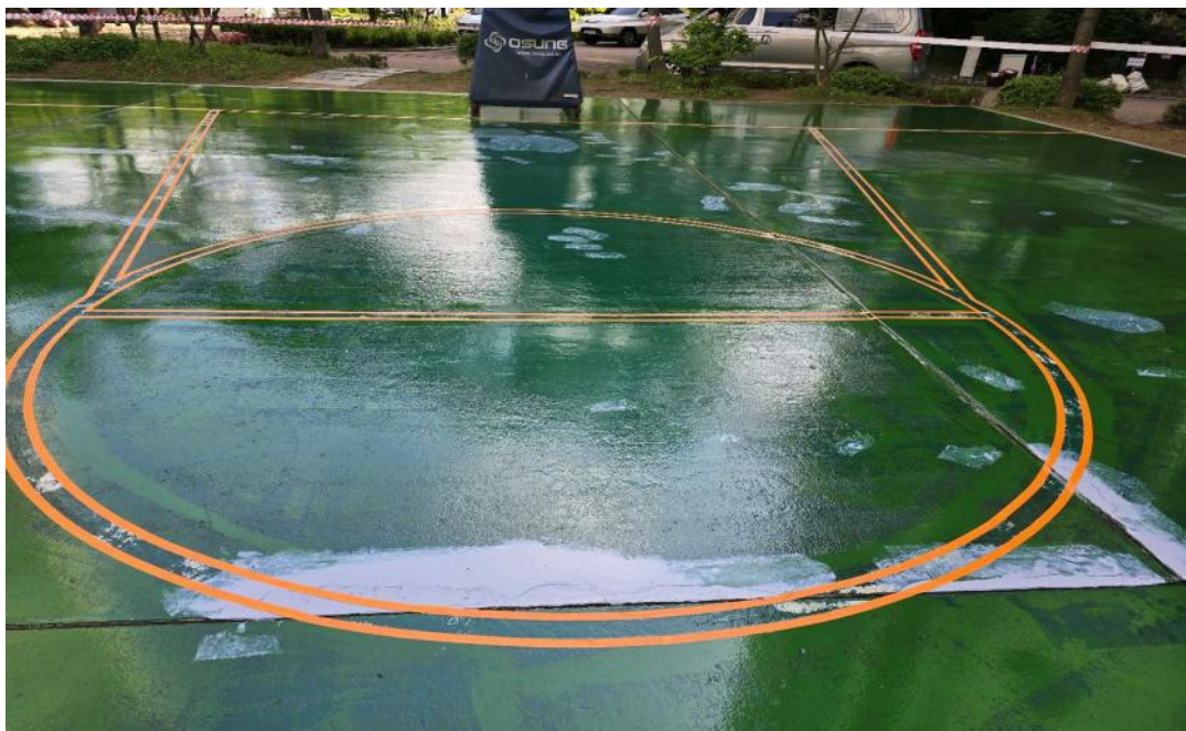
공사 중 (우레탄 하도 및 실란트)
