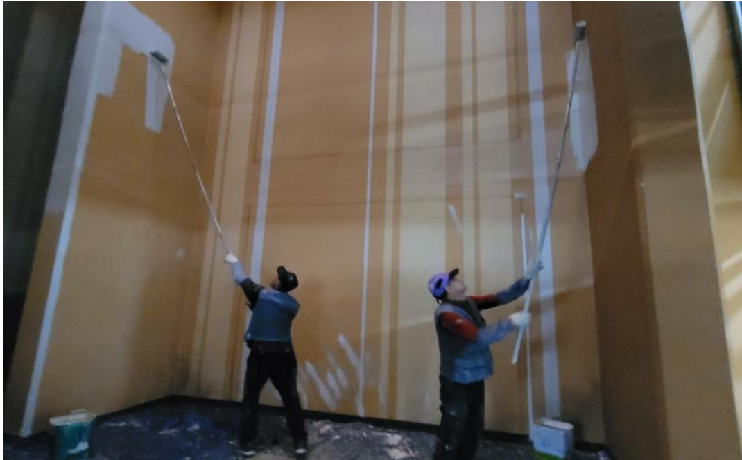
공사 중 (지하주차장 벽체 도장)
