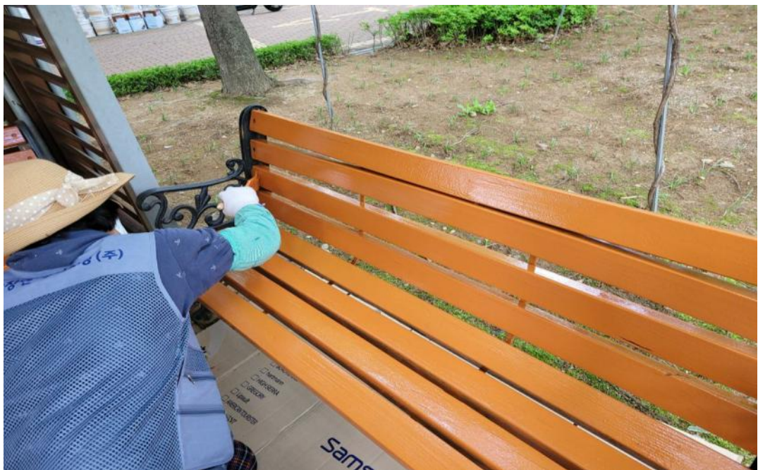
공사 중 (부대시설 도장)
