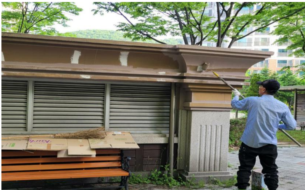
공사 중 (부대시설 도장)
