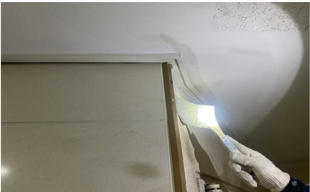
공사 중 (내부 균열보수)
