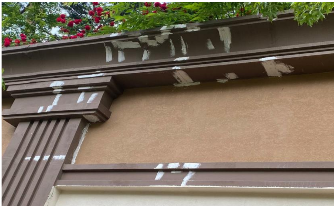
공사 중 (상가부위 균열보수)
