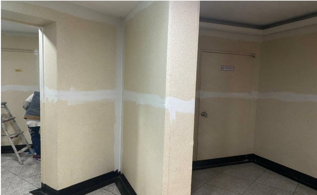
공사 중 (내부 균열보수)
