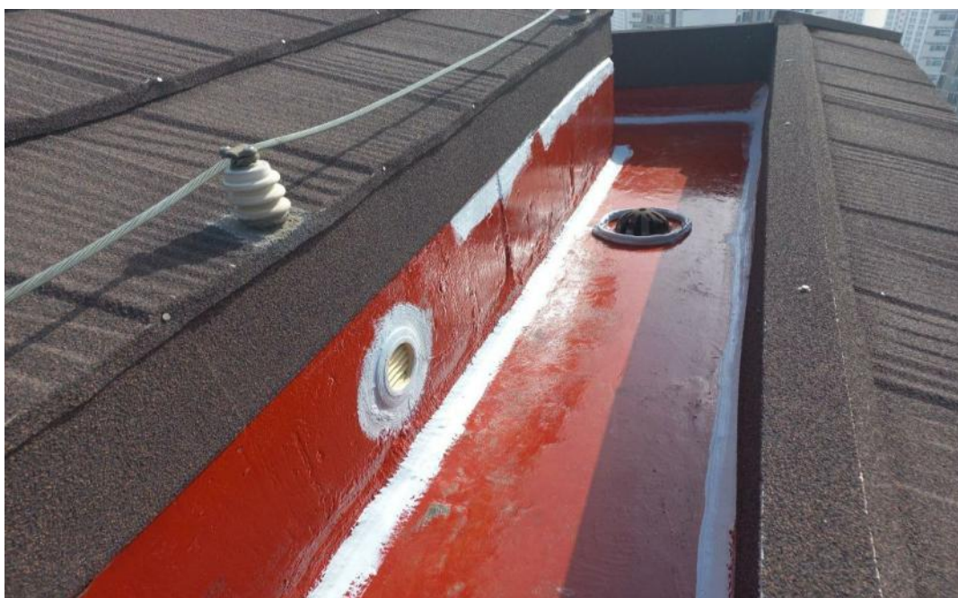
공사 중 (우레탄 하도 및 실란트)
