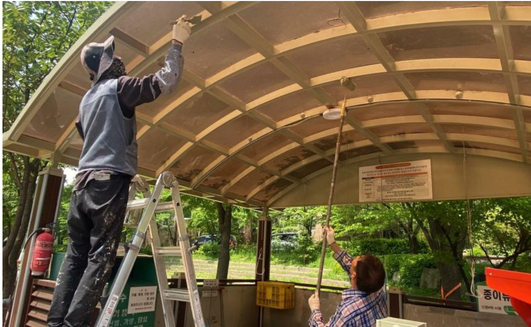
공사 중 (부대시설 도장)
