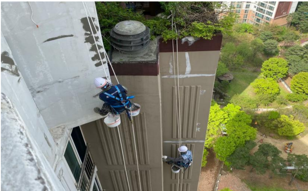
공사 중 (균열보수)
