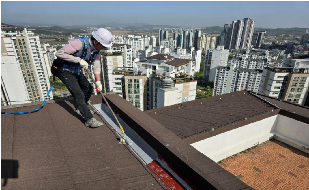
공사 중 (우레탄 중도 도포)
