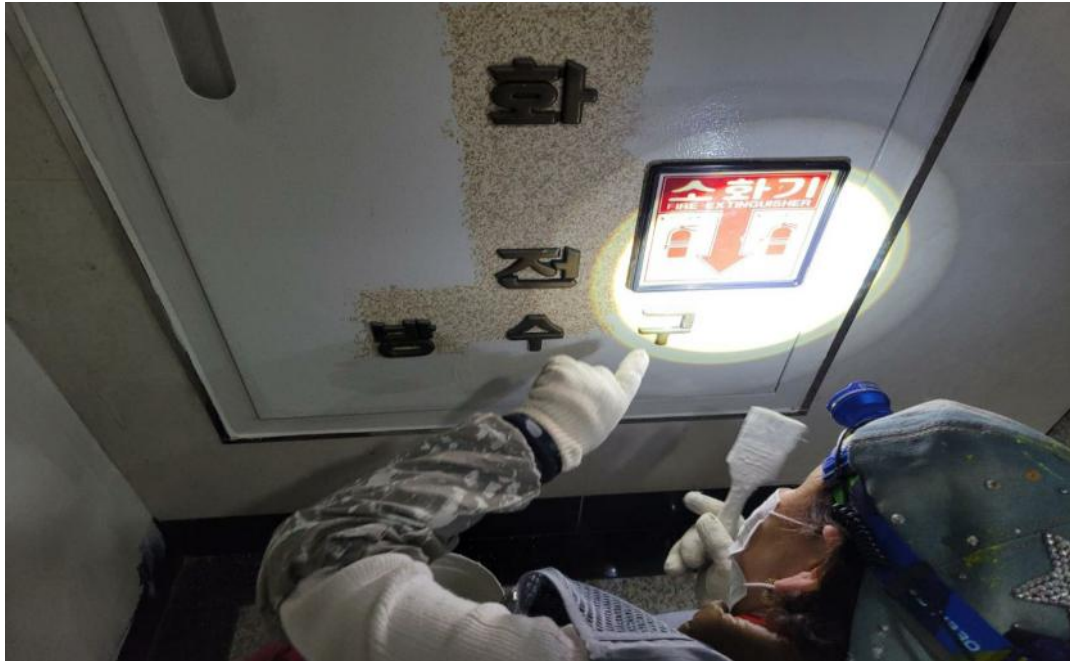
공사 중 (내부 수성페인트)
