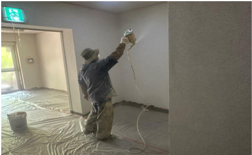
공사 중 (내부 무늬코트 뽐칠)
