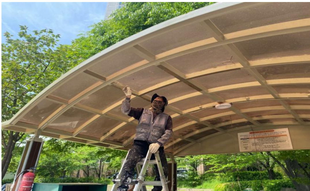
공사 중 (부대시설 도장)
