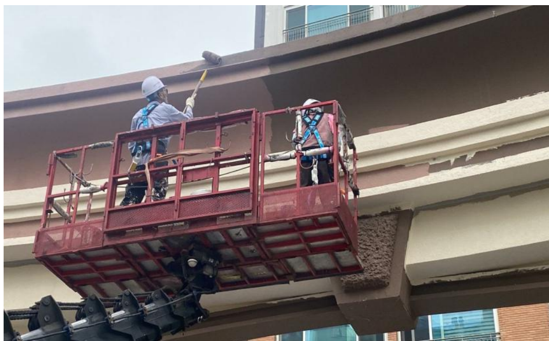
공사 중 (상가부위 수성페인트)
