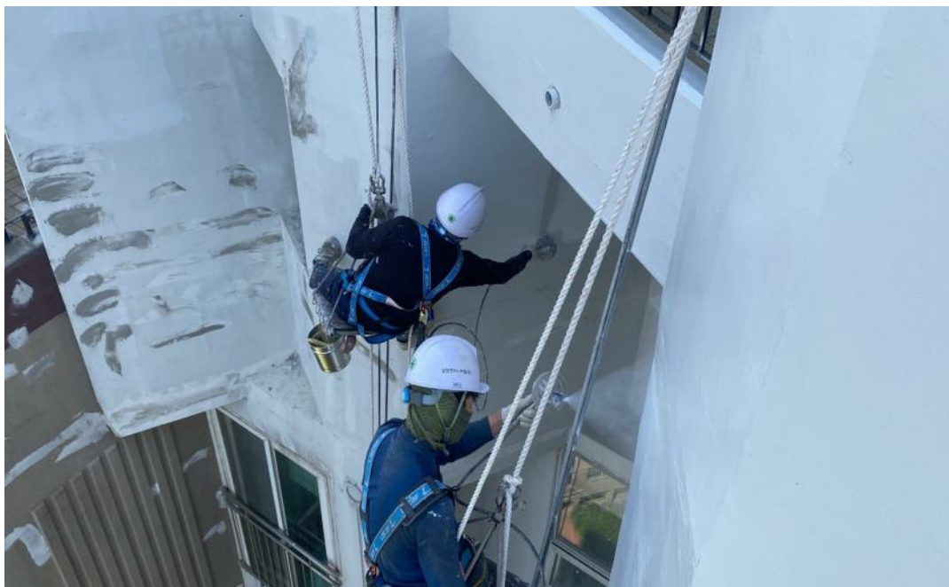
공사 중 (수성페인트 도장)
