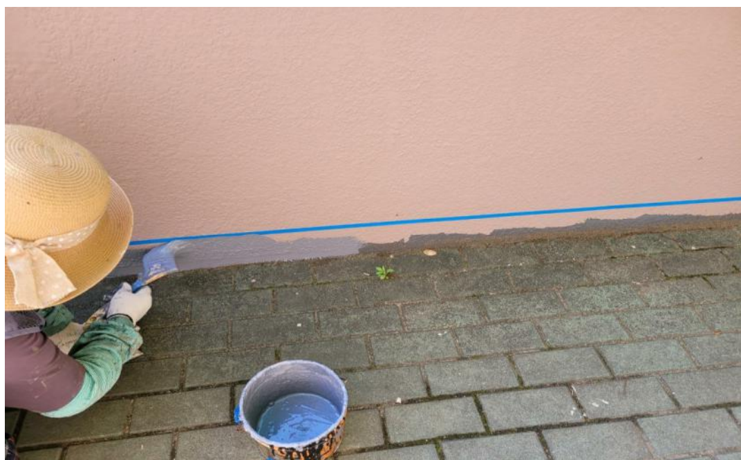
공사 중 (상가부위 걸레받이 페인트)
