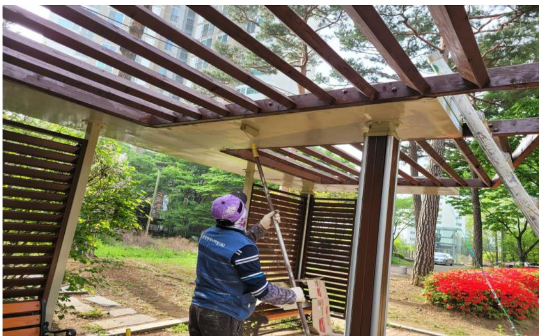
공사 중 (부대시설 도장)
