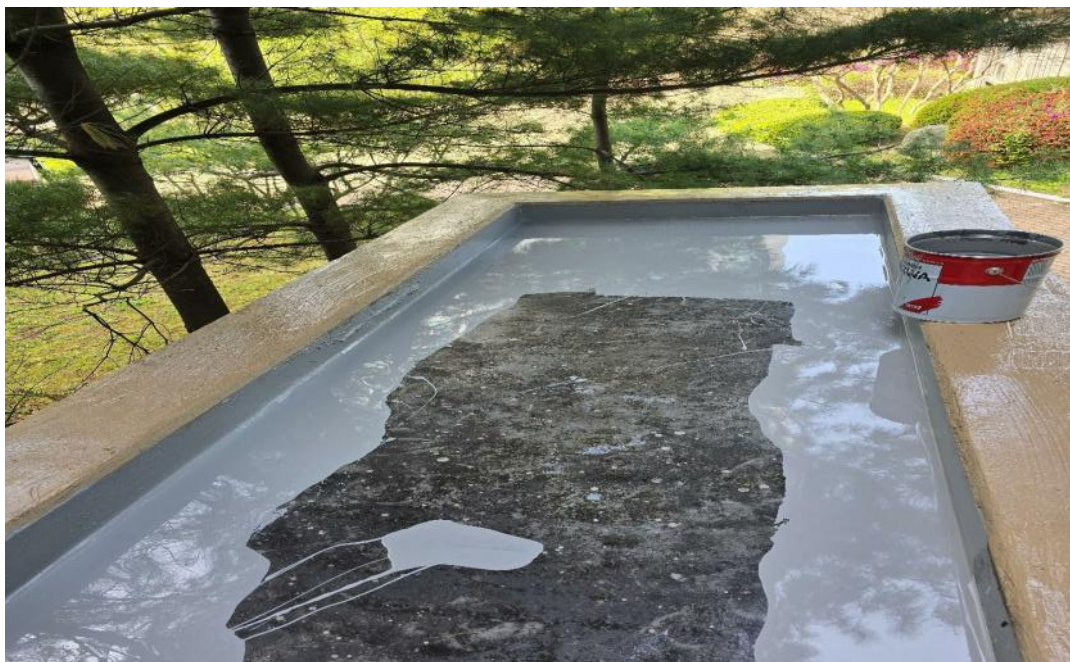
공사 중 (우레탄 중도 도포)
