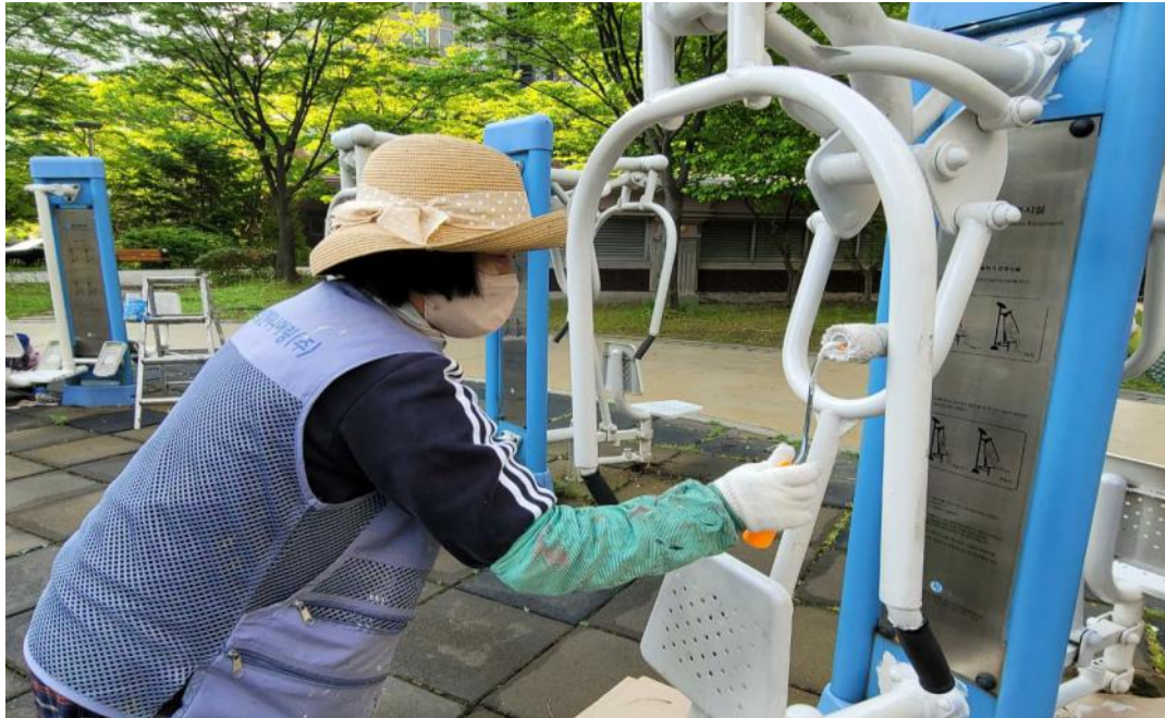
공사 중 (부대시설 도장)
