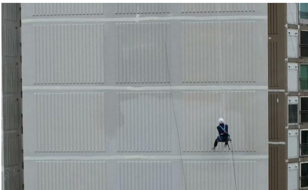
공사 중 (바인다 작업)
