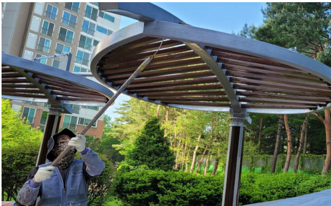
공사 중 (부대시설 도장)
