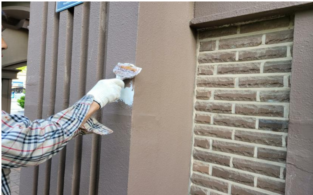
공사 중 (상가부위 균열보수)
