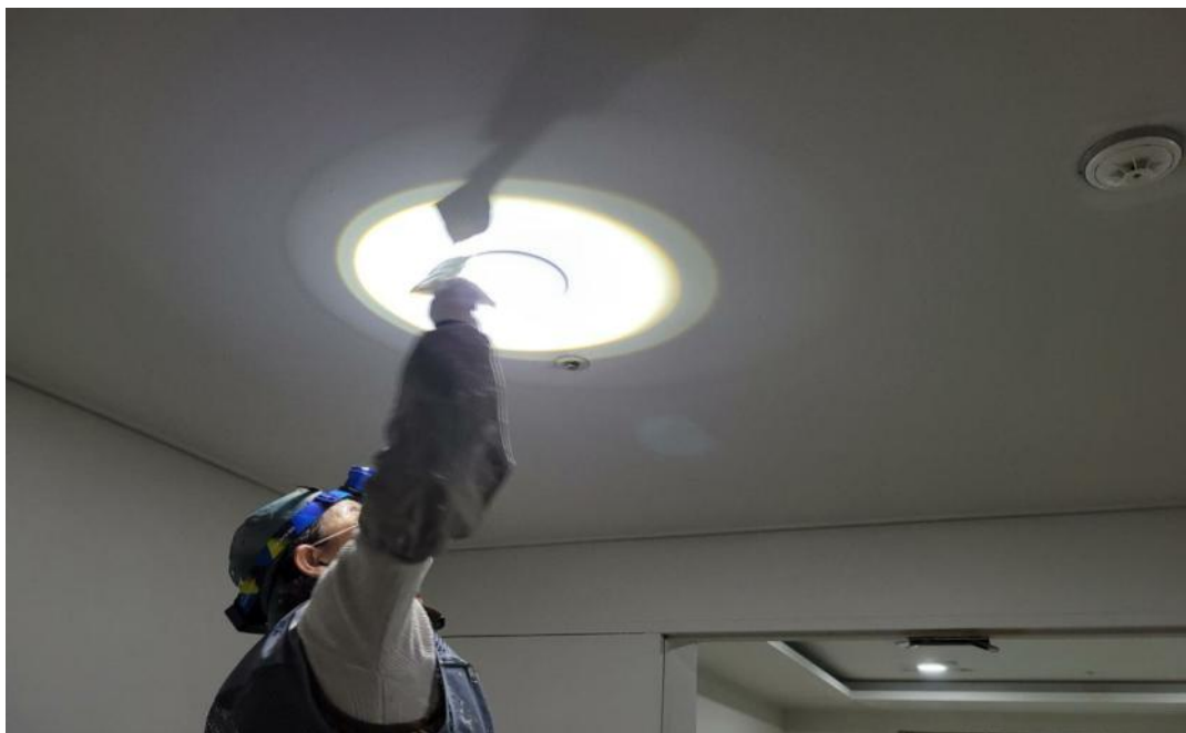
공사 중 (내부 수성페인트)
