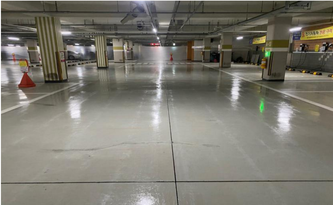
공사 중 (에폭시 프라이마 도포)
