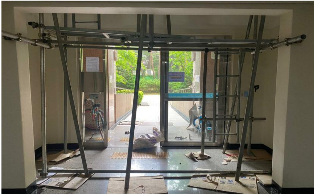
공사 중 (아시바 설치)
