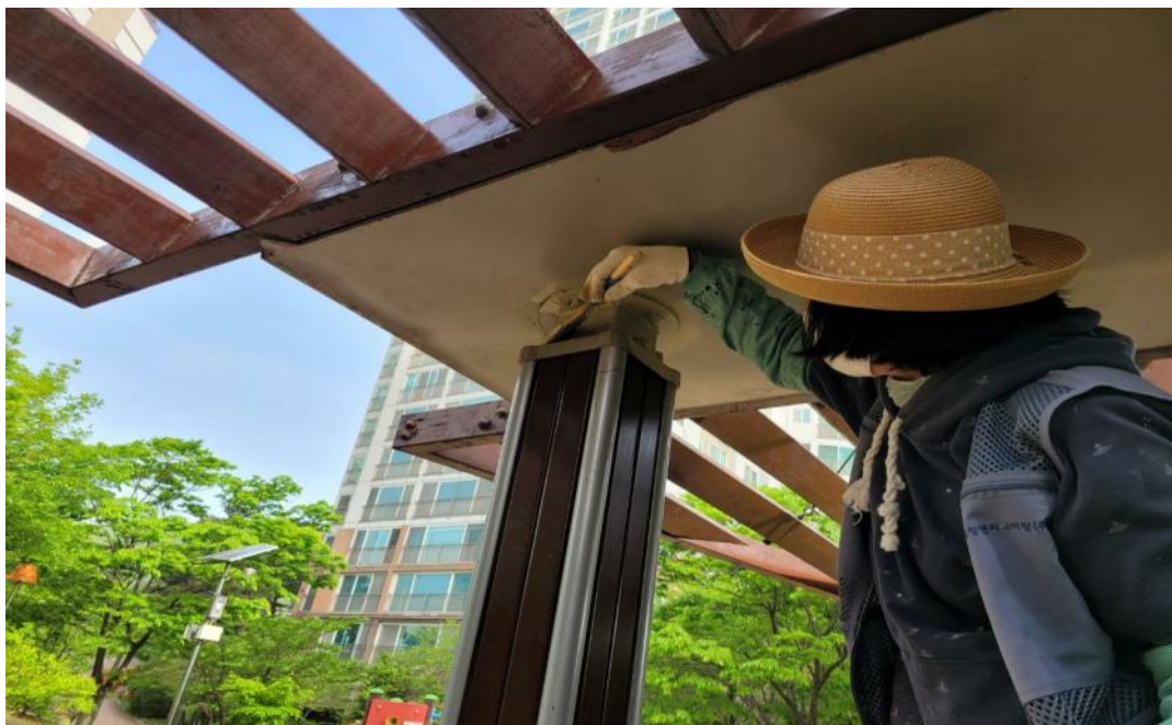
공사 중 (부대시설 도장)
