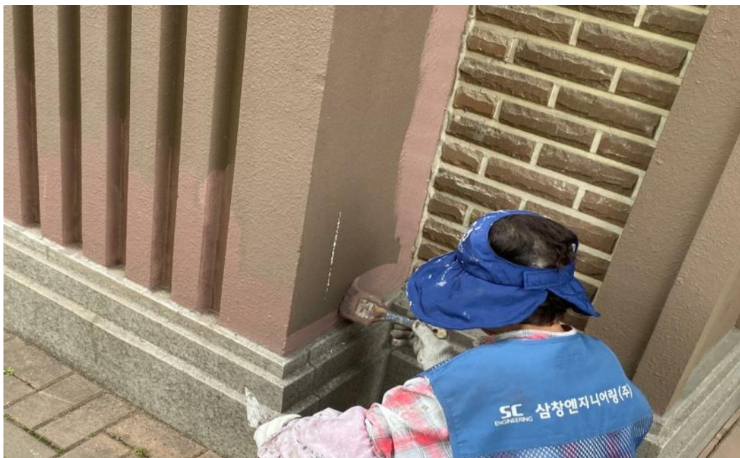
공사 중 (상가부위 수성페인트)
