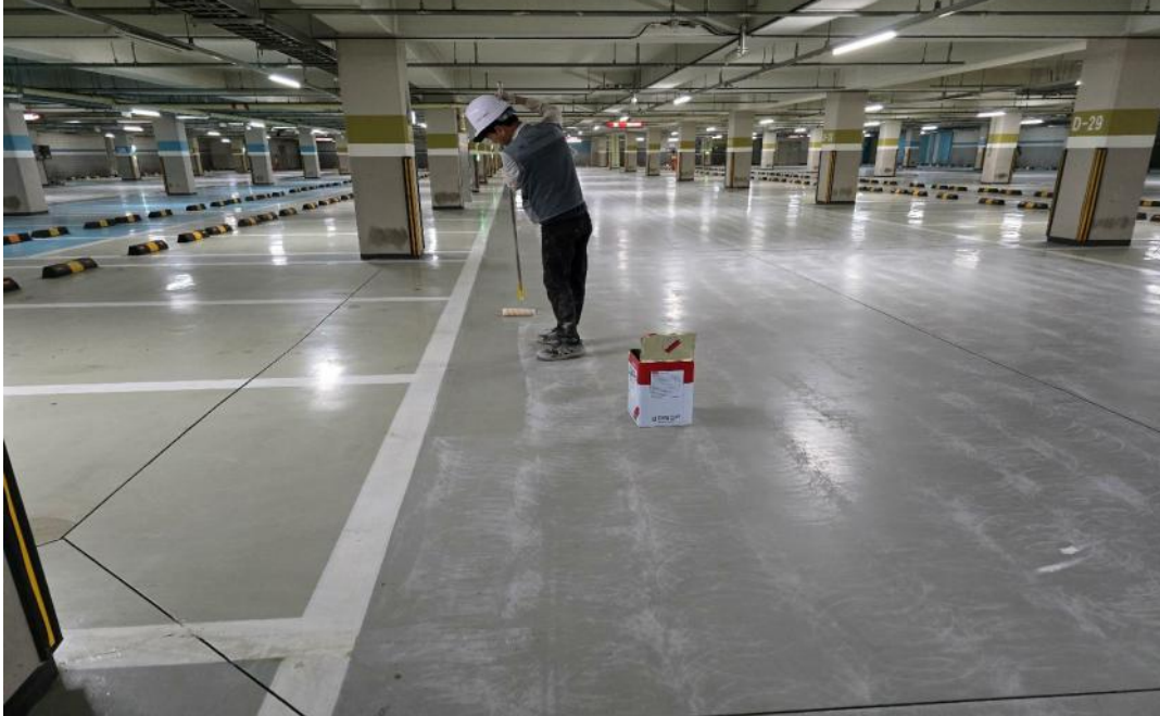
공사 중 (에폭시 프라이마 도포)
