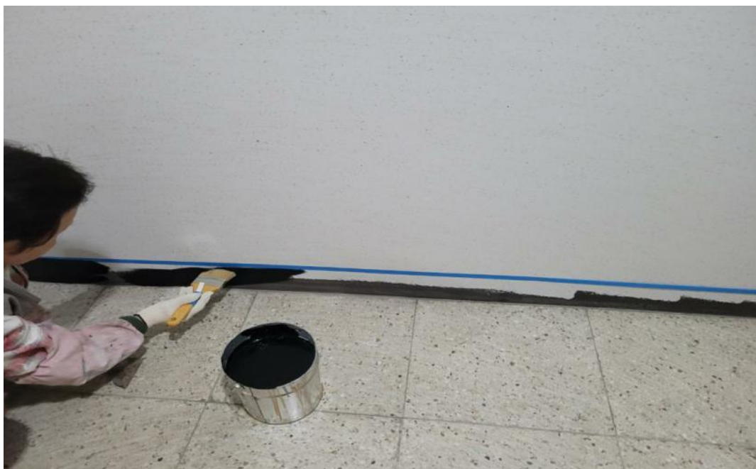
공사 중 (걸레받이 페인트)
