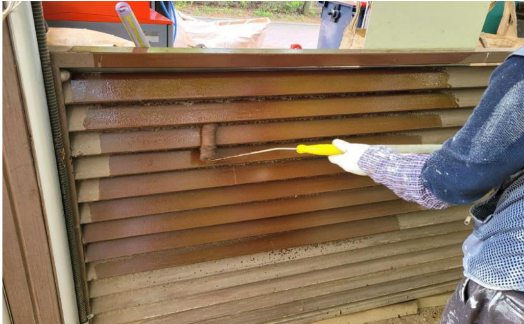
공사 중 (부대시설 도장)
