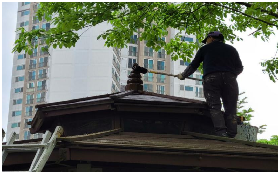
공사 중 (부대시설 도장)
