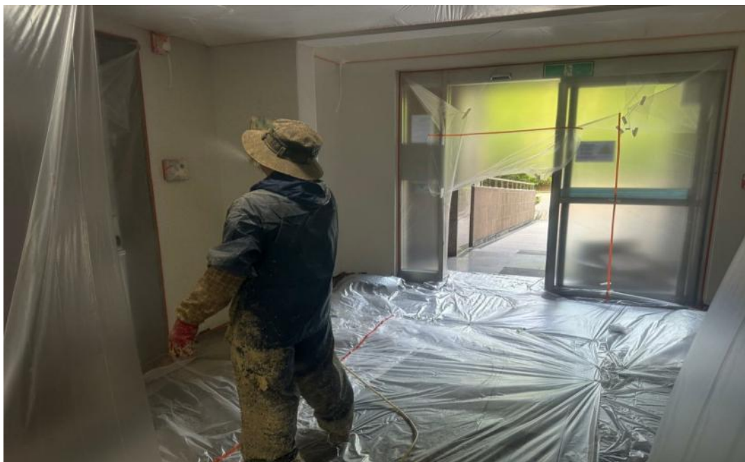
공사 중 (내부 무늬코트 뿜칠)
