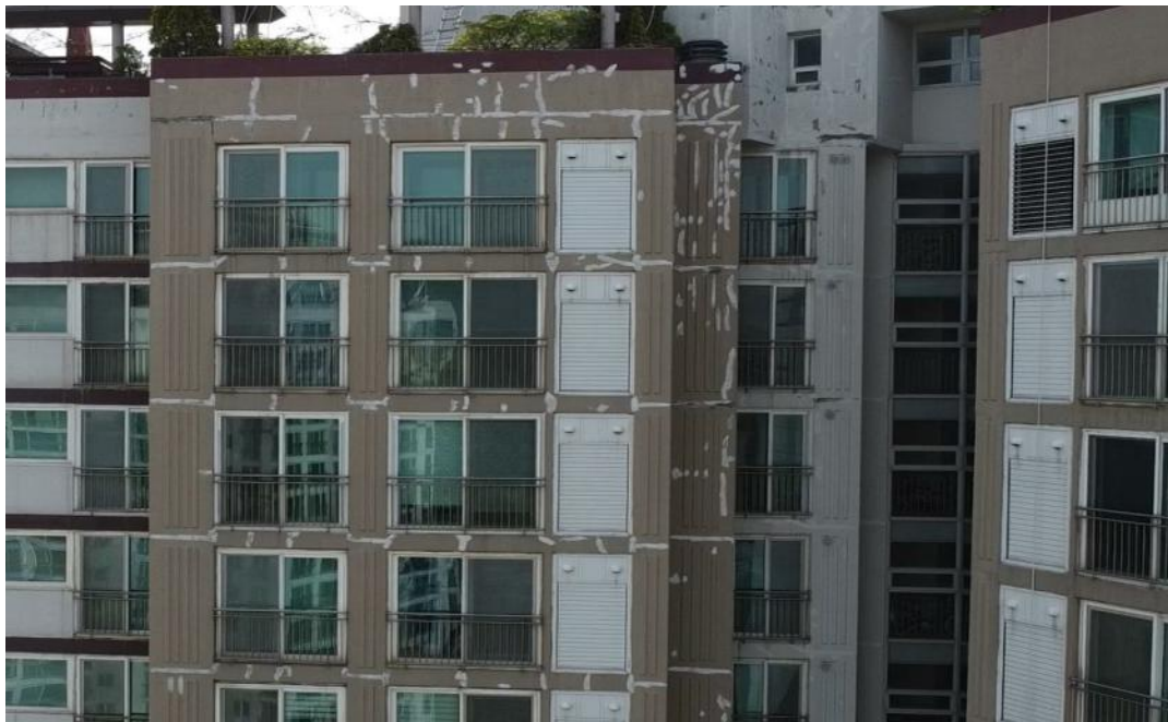
공사 중 (균열보수)
