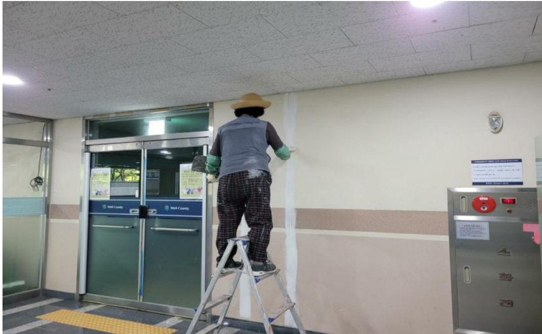
공사 중 (부대시설 도장)
