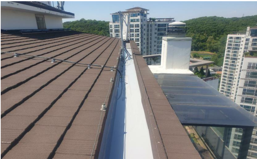
공사 중 (우레탄 중도 도포)
