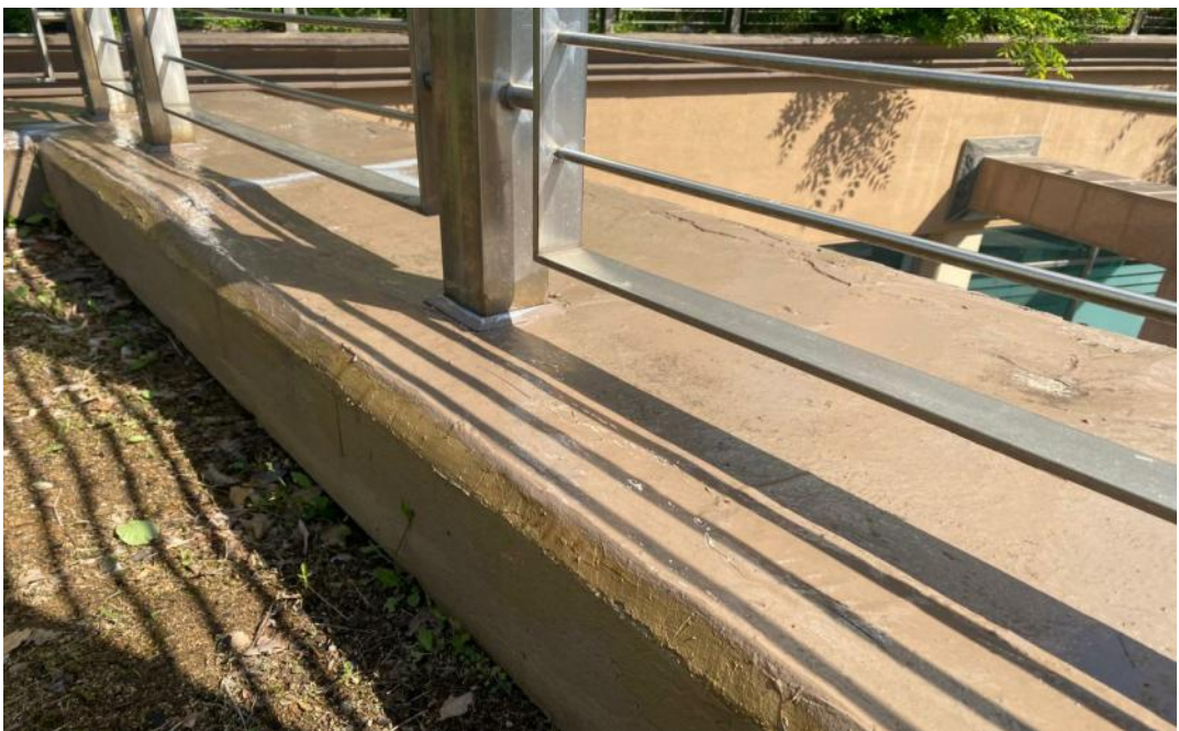
공사 중 (우레탄 하도 및 실란트)
