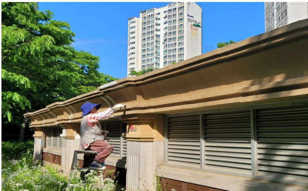
공사 중 (부대시설 도장)
