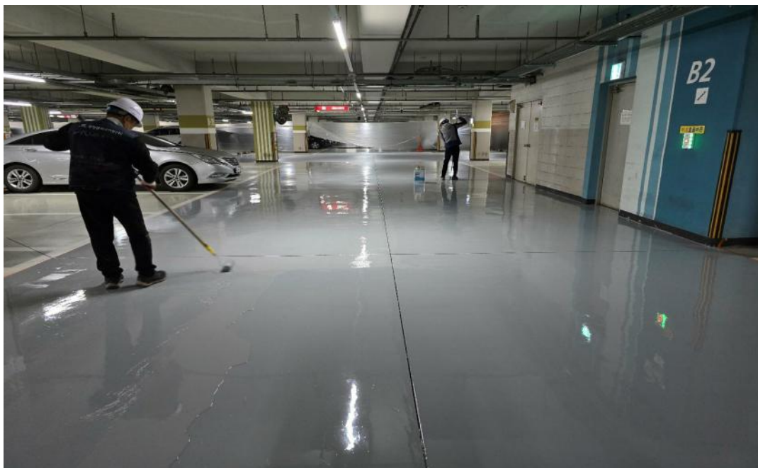
공사 중 (에폭시 상도 도포)
