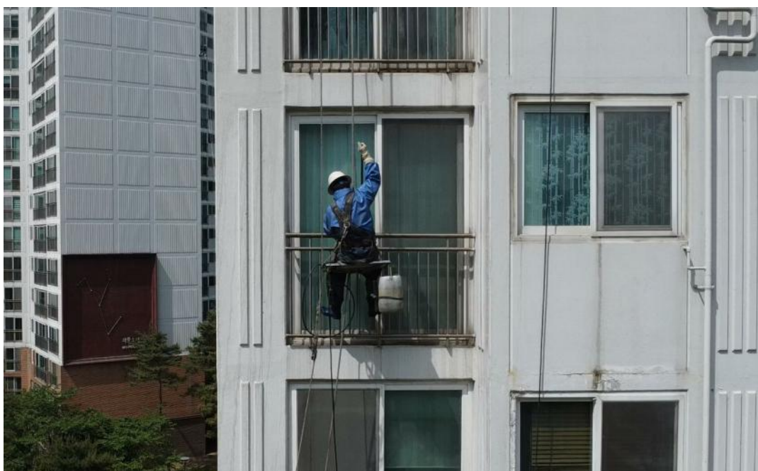
공사 중 (고압세척)
