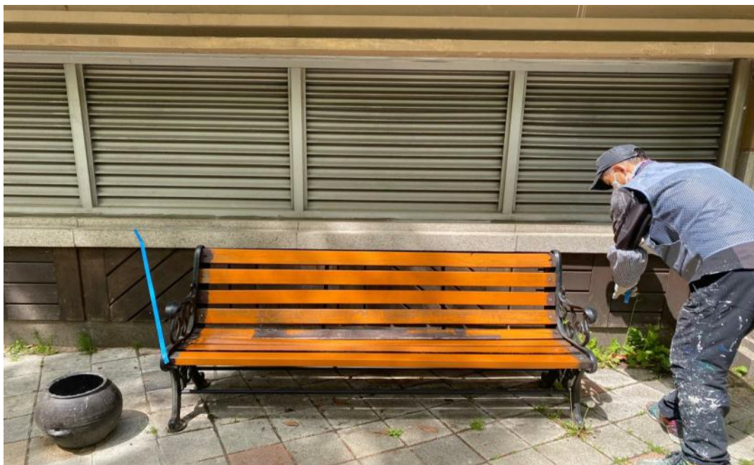
공사 중 (부대시설 도장)
