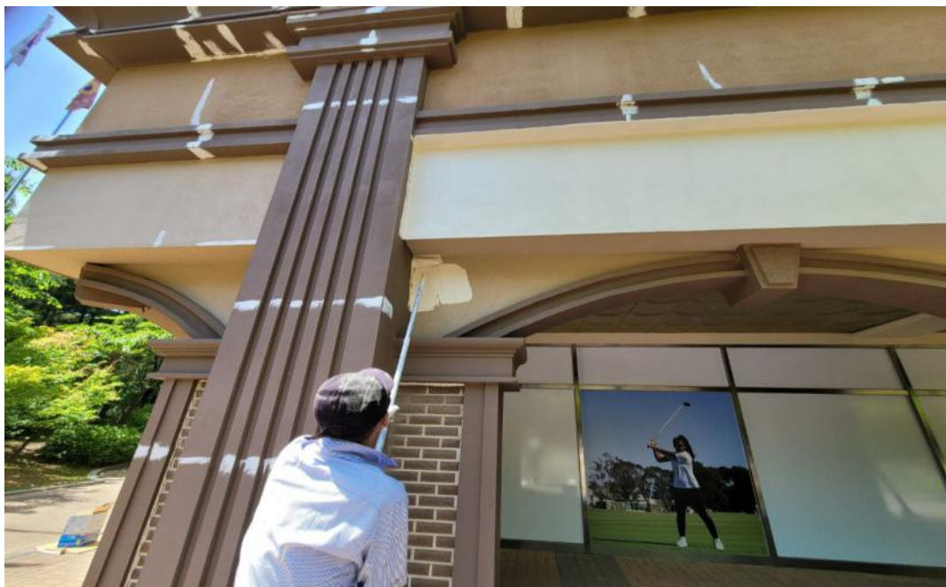
공사 중 (상가부위 수성페인트)
