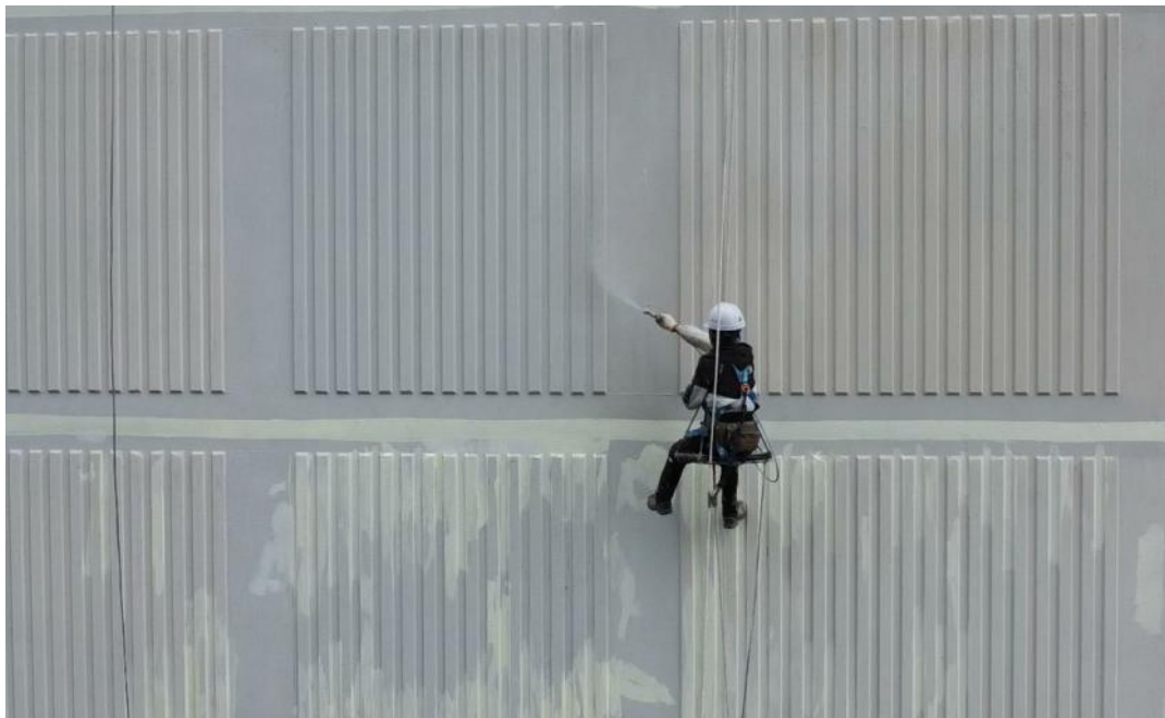
공사 중 (바인다 작업)
