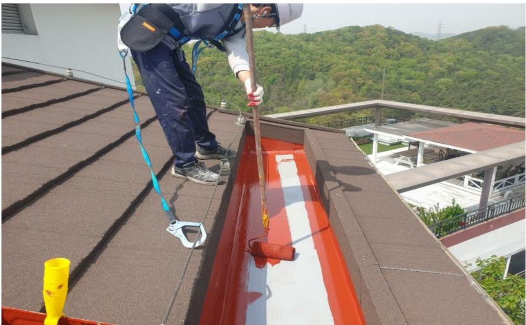
공사 중 (우레탄 상도 마감)
