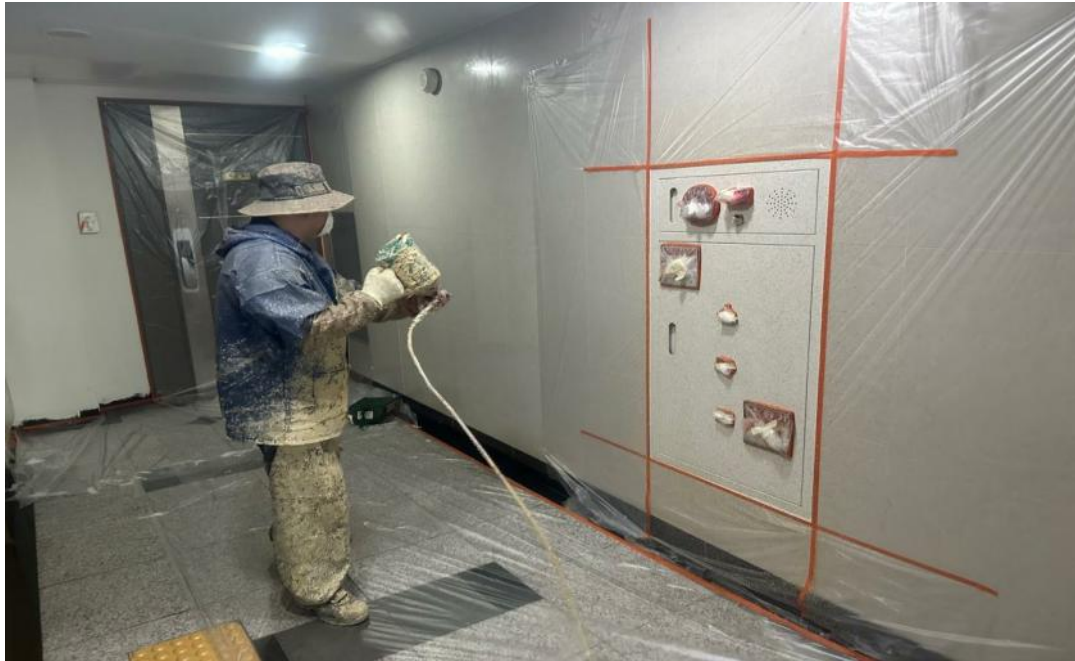
공사 중 (내부 무늬코트 뽐칠)
