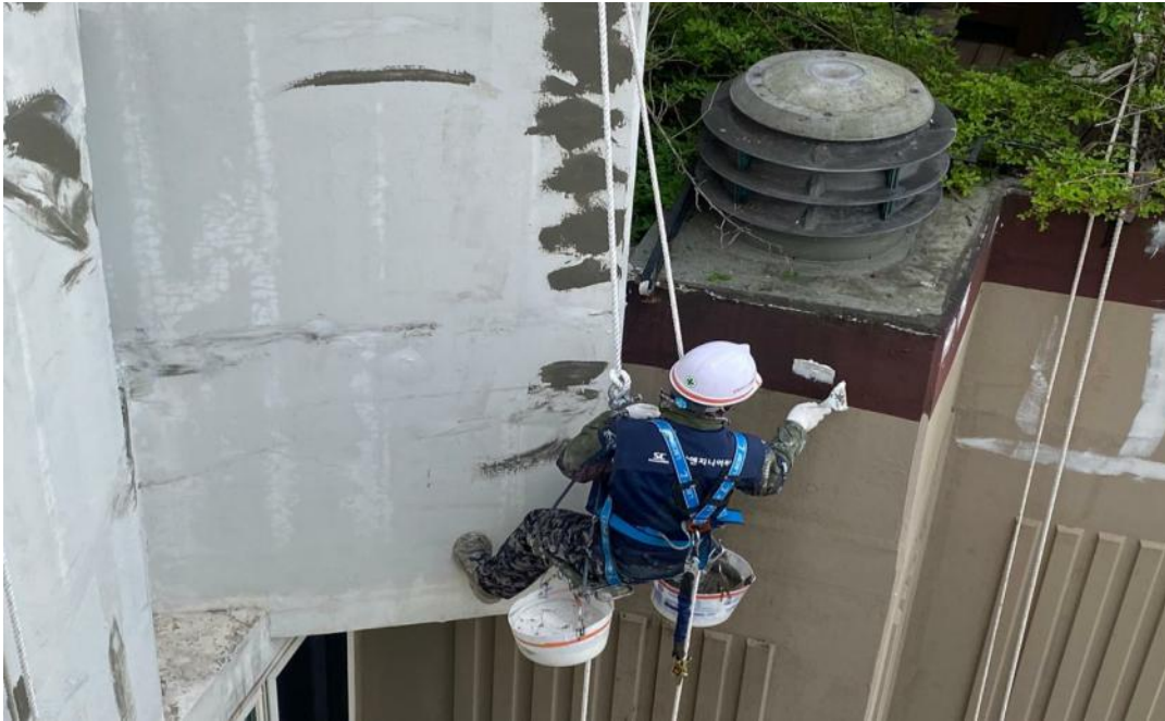
공사 중 (균열보수)
