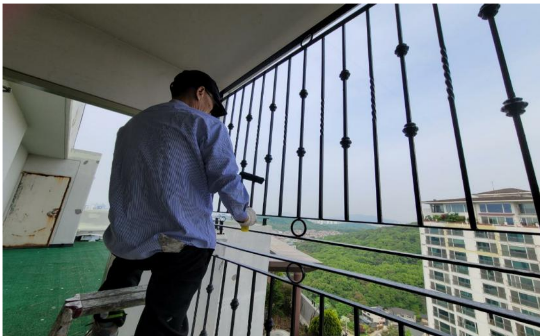
공사 중 (부대시설 도장)
