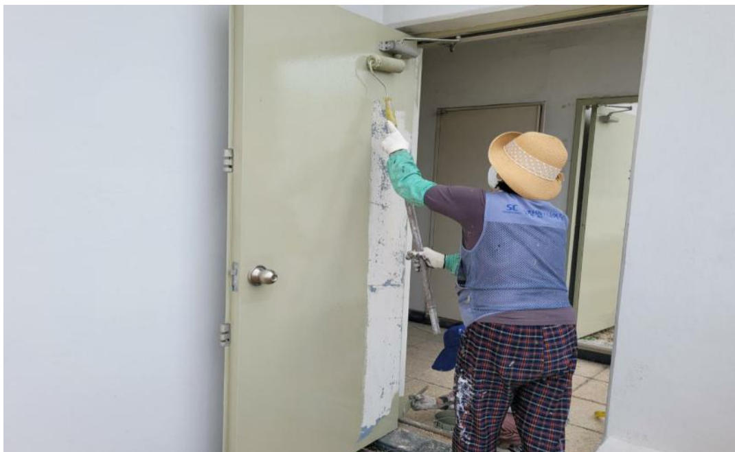
공사 중 (부대시설 도장)
