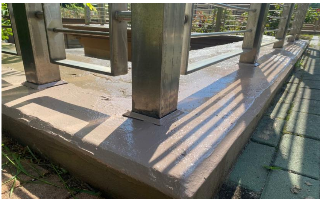
공사 중 (우레탄 상도 마감)
