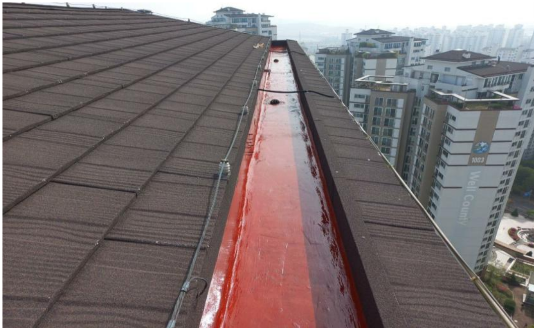
공사 중 (우레탄 하도 및 실란트)
