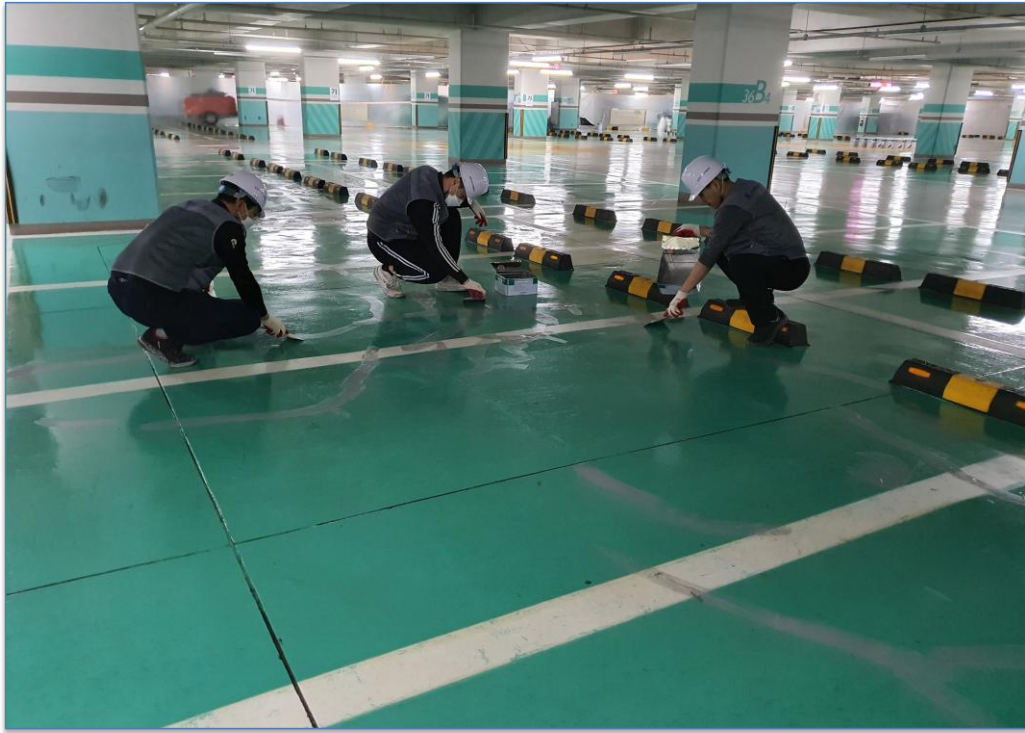
바닥 균열보수 작업
