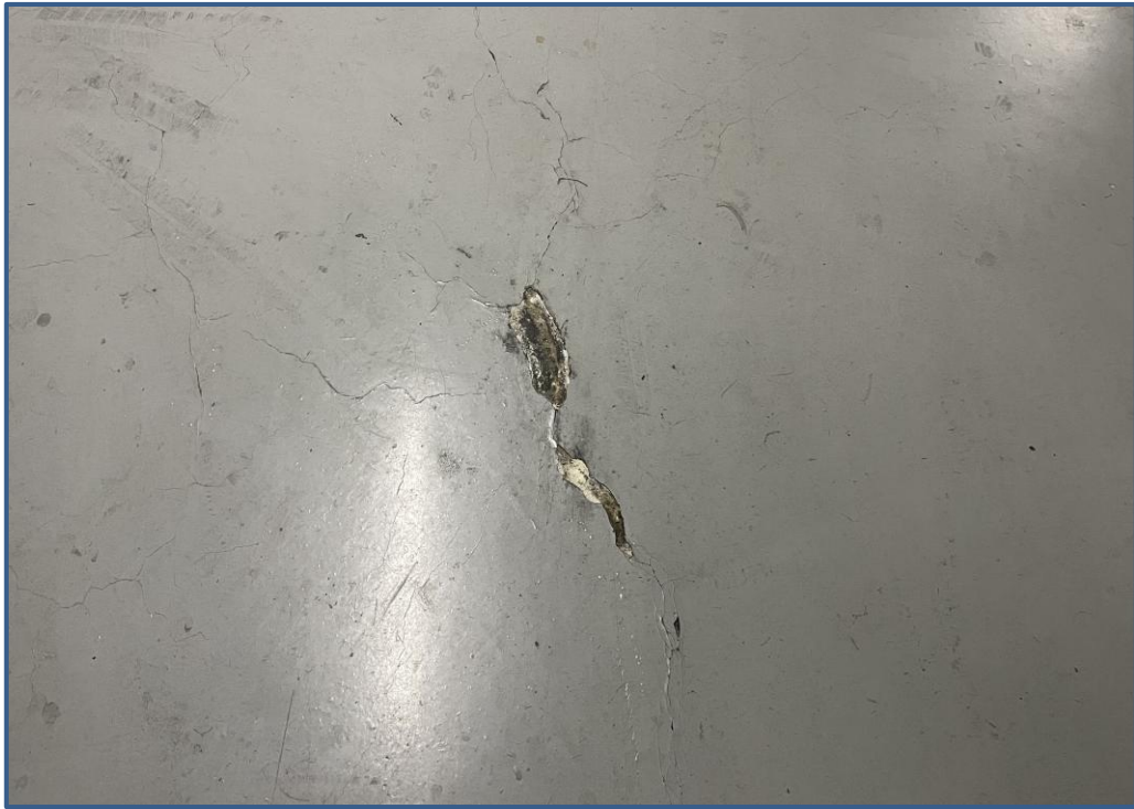
공사 전 지하주차장 전경
