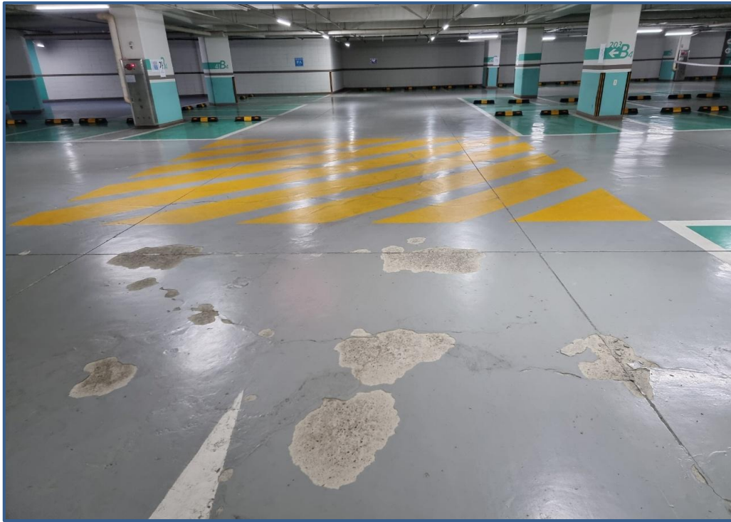
공사 전 지하주차장 전경
