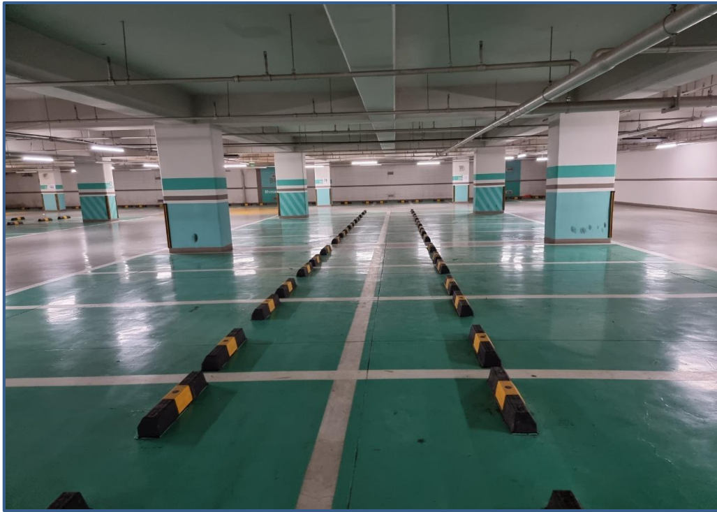
공사 전 지하주차장 전경
