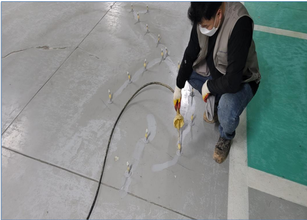
바닥 T-PORT 공법 시공
