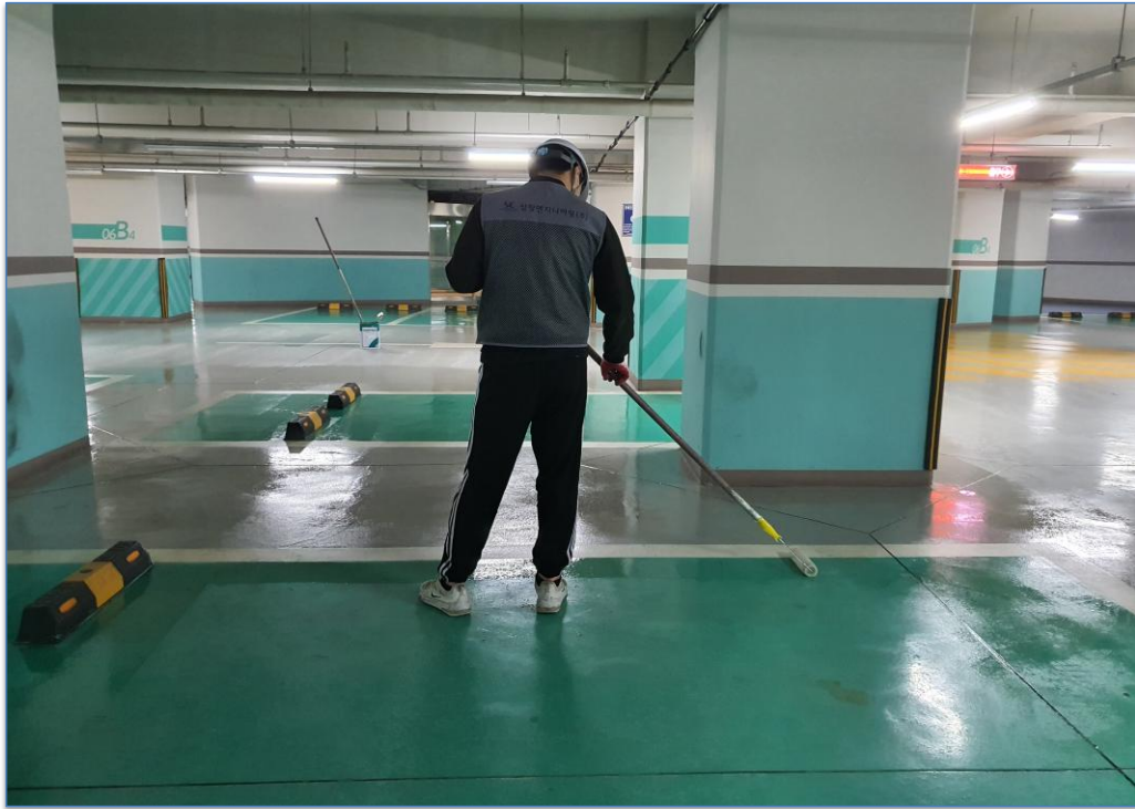
바닥 프라이머 도포 작업
