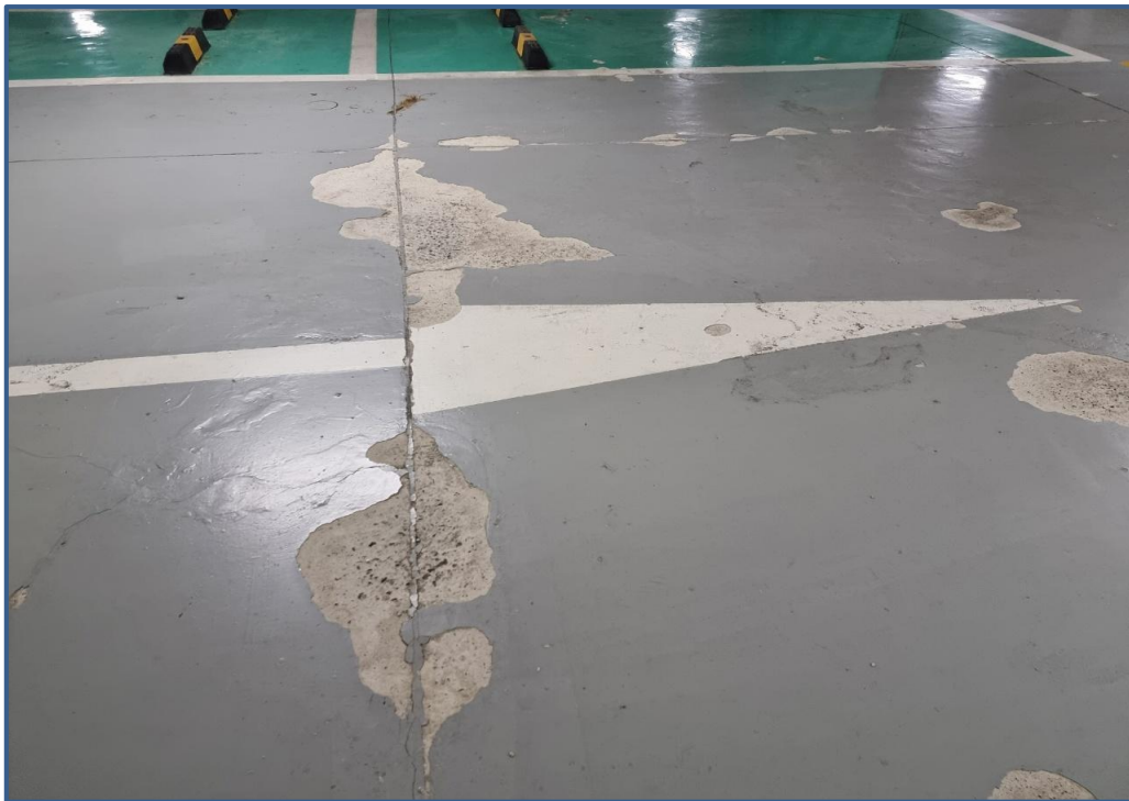
공사 전 지하주차장 전경
