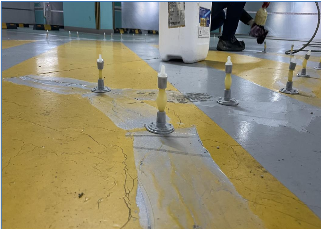
바닥 T-PORT 공법 시공-약액주입
