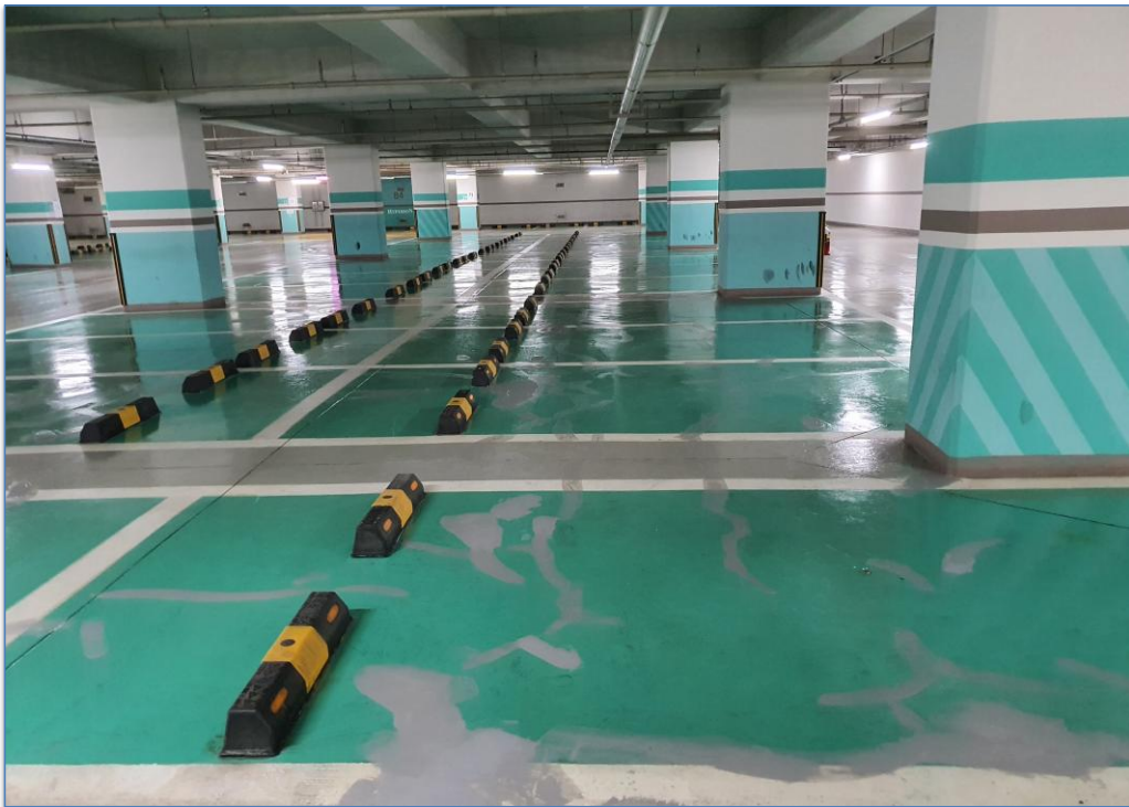
바닥 균열보수 작업
