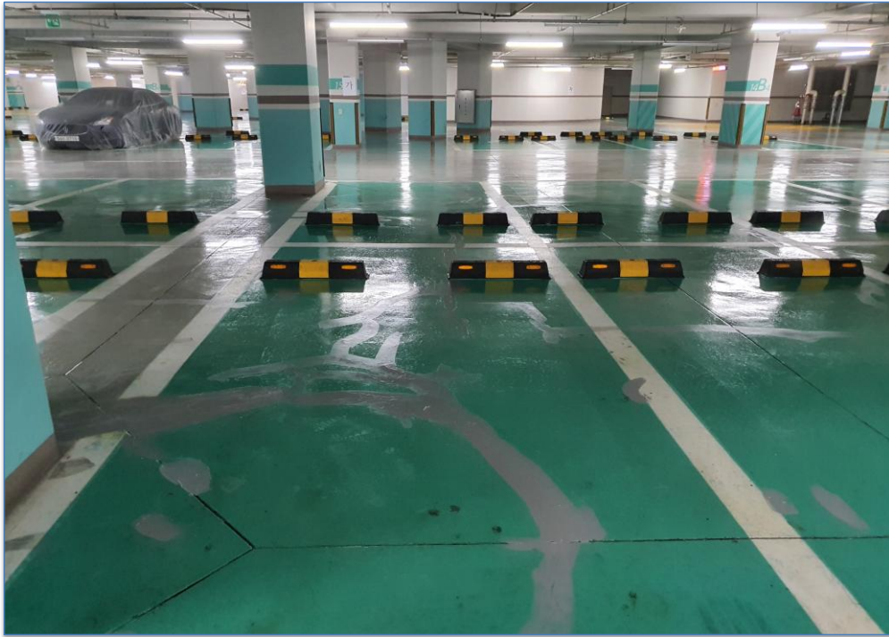
바닥 균열보수 작업
