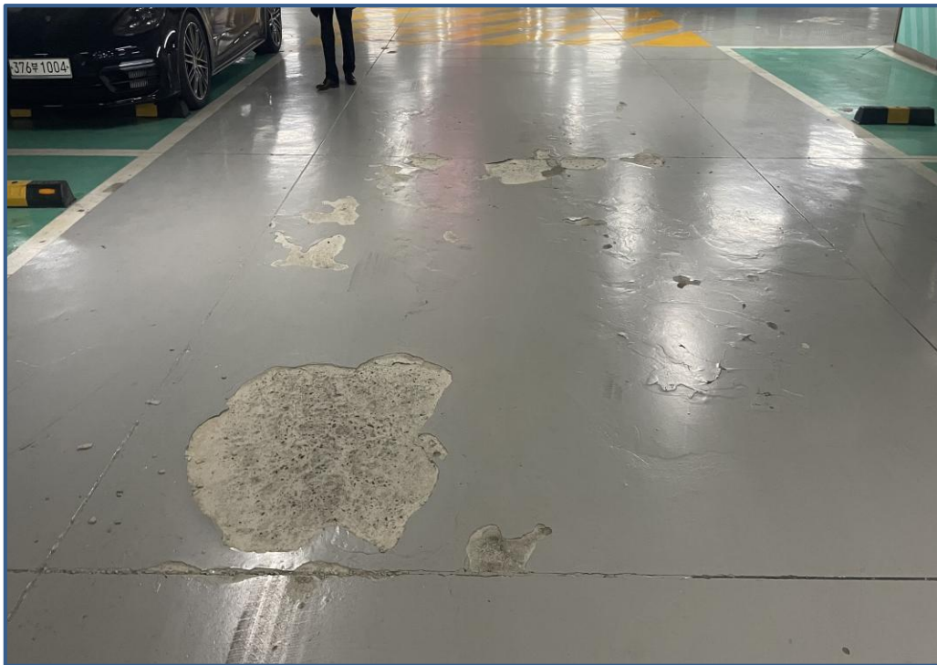
공사 전 지하주차장 전경
