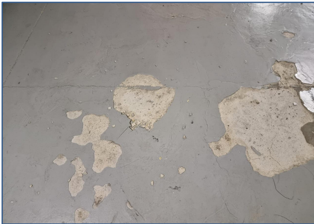
공사 전 지하주차장 전경
