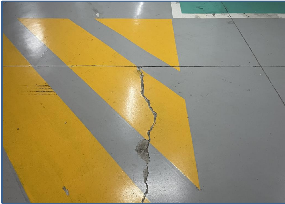
공사 전 지하주차장 전경
