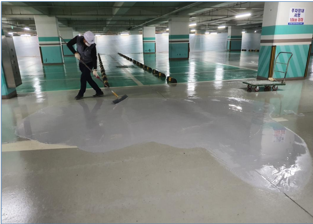
바닥 단면복구 작업
