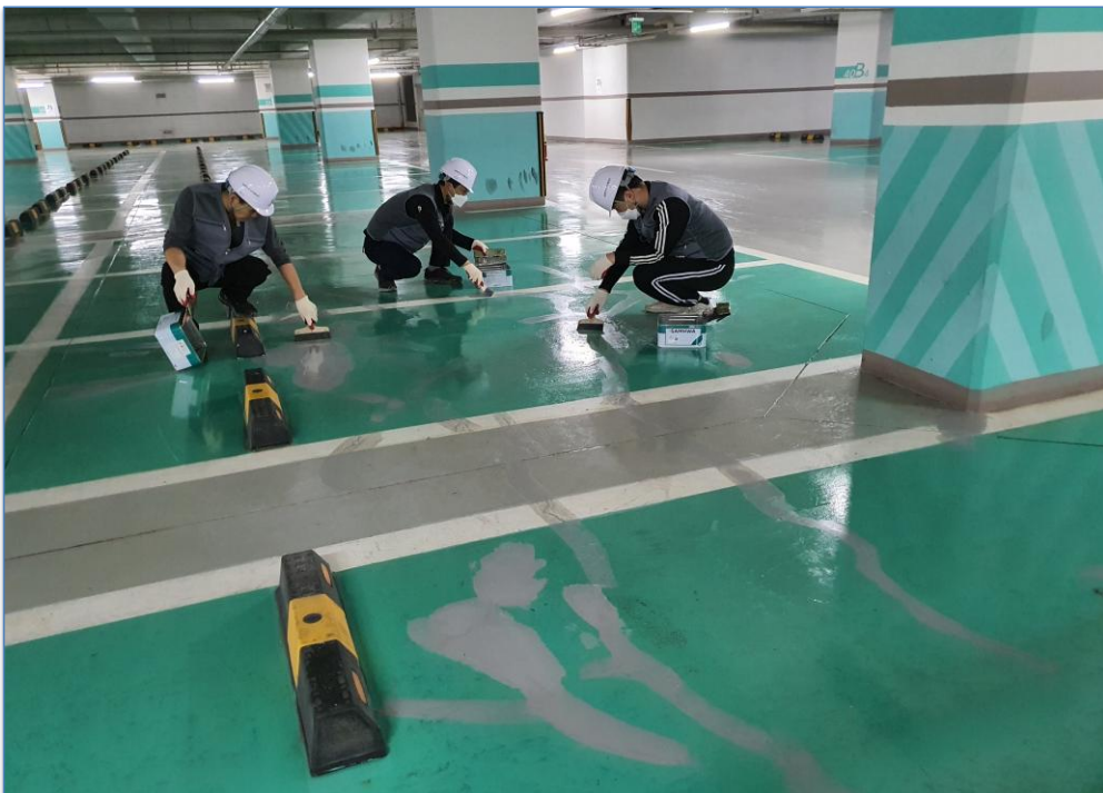
바닥 균열보수 작업
