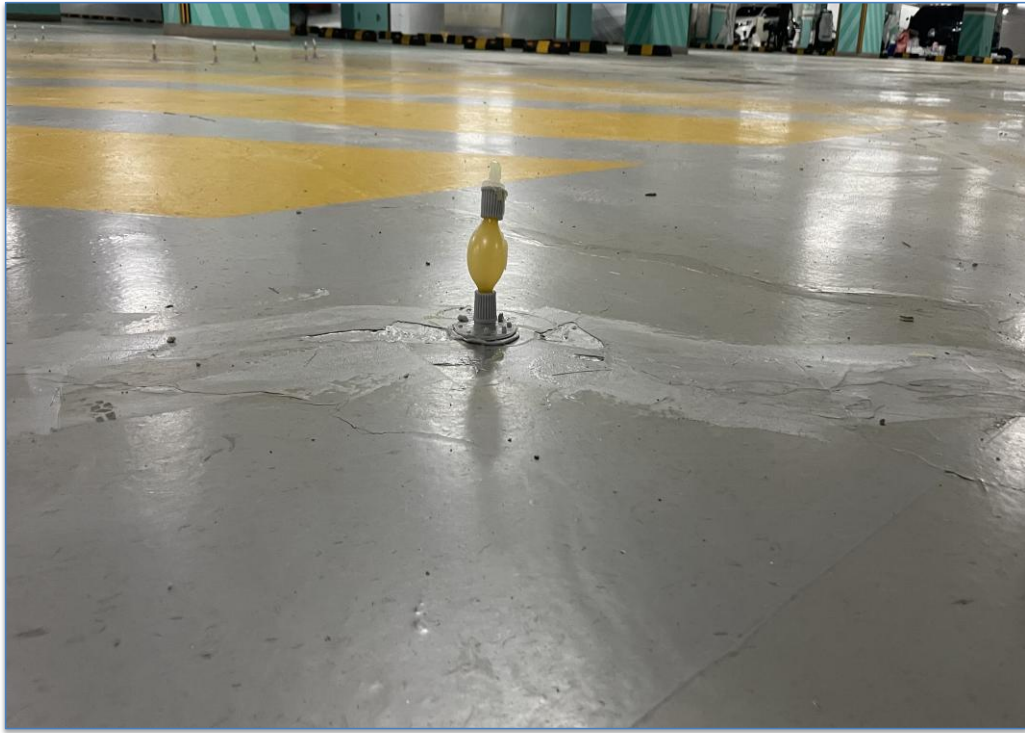
바닥 T-PORT 공법 시공-약액주입
