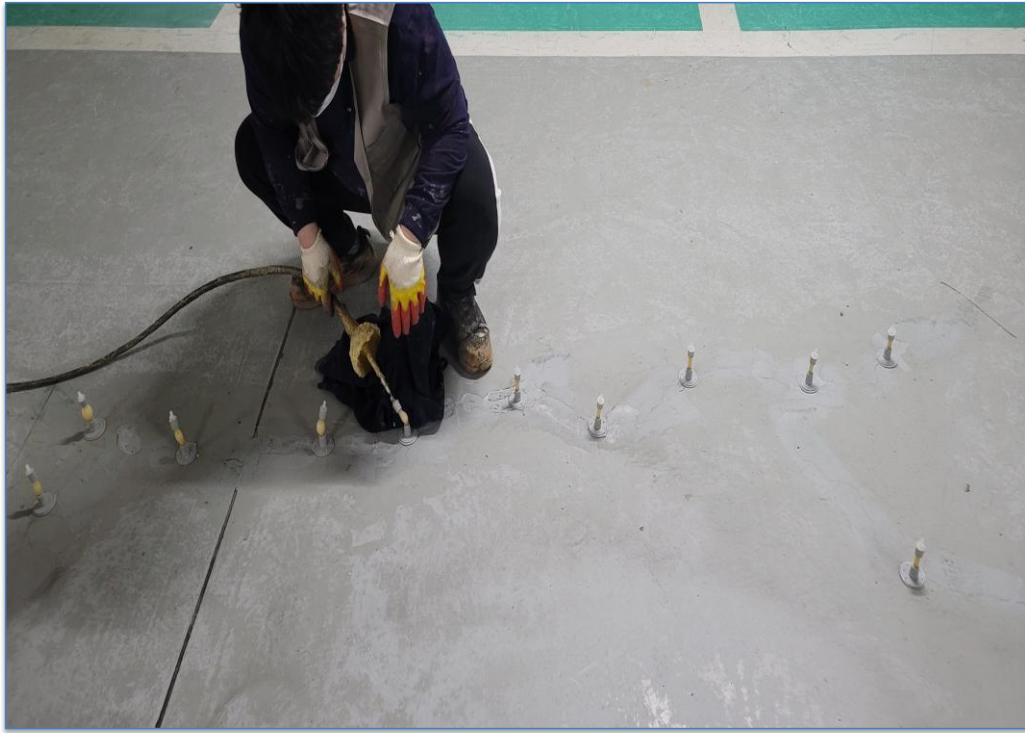
바닥 T-PORT 공법 시공
