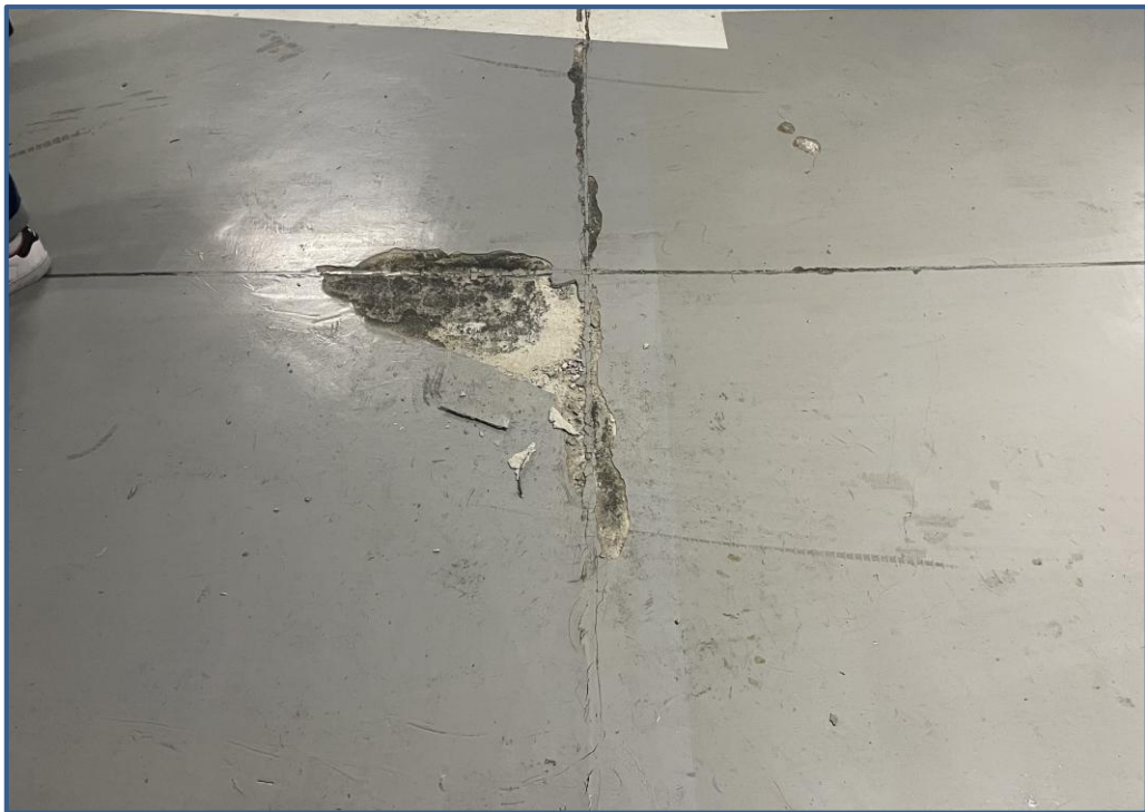
공사 전 지하주차장 전경
