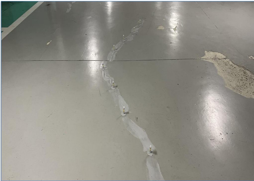
바닥 T-PORT 공법 시공
