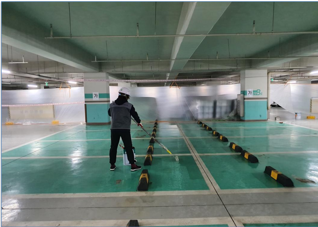
바닥 프라이머 도포 작업
