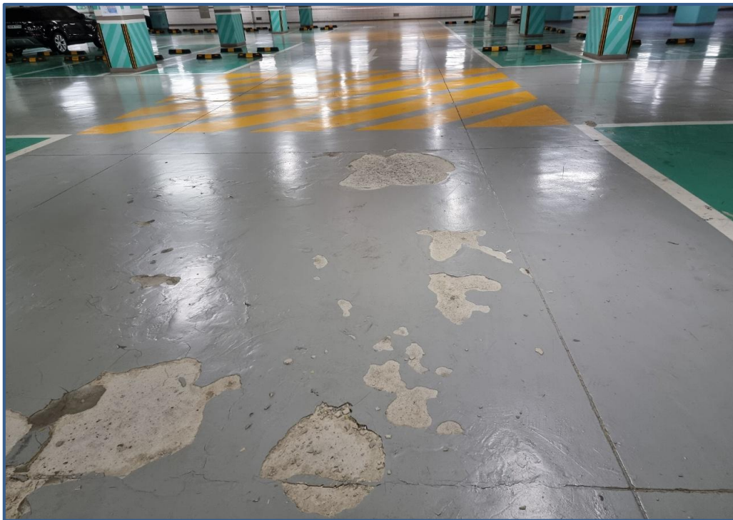
공사 전 지하주차장 전경
