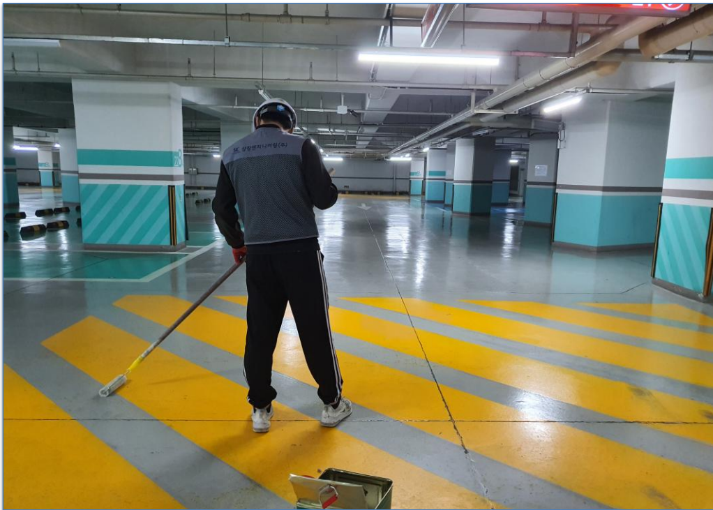
바닥 프라이머 도포 작업
