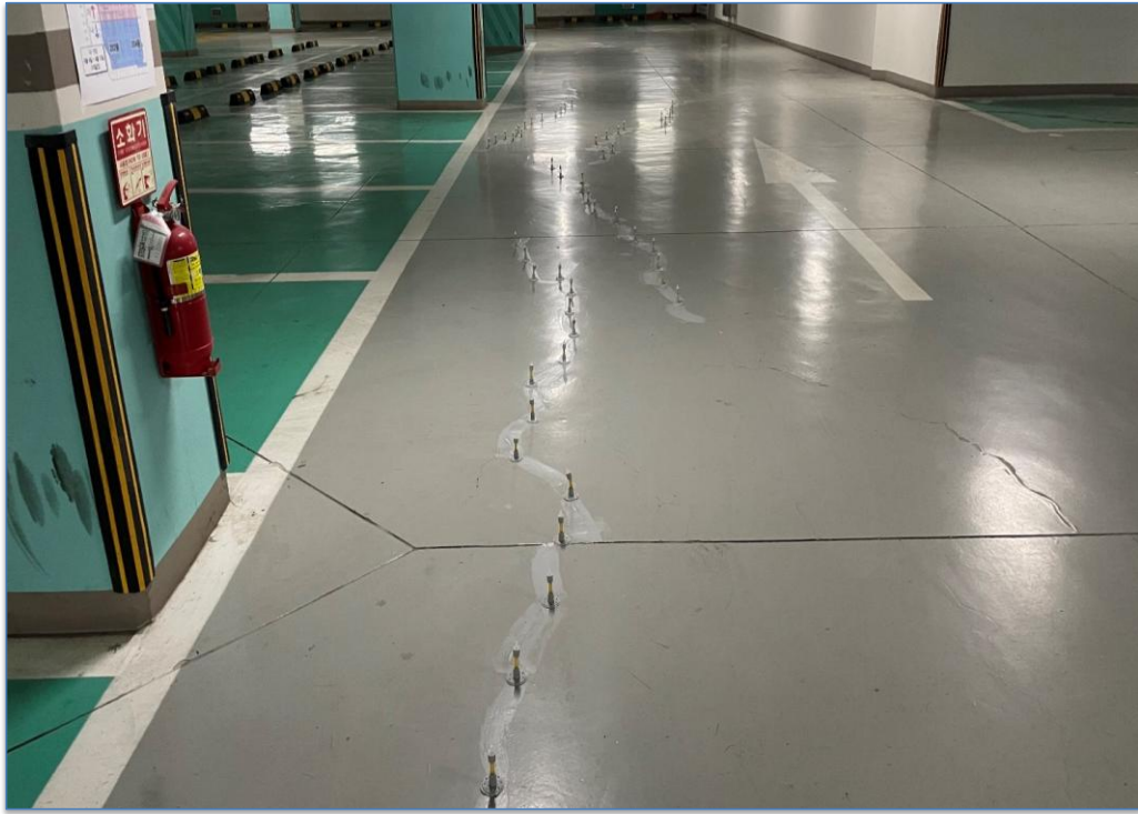
바닥 T-PORT 공법 시공
