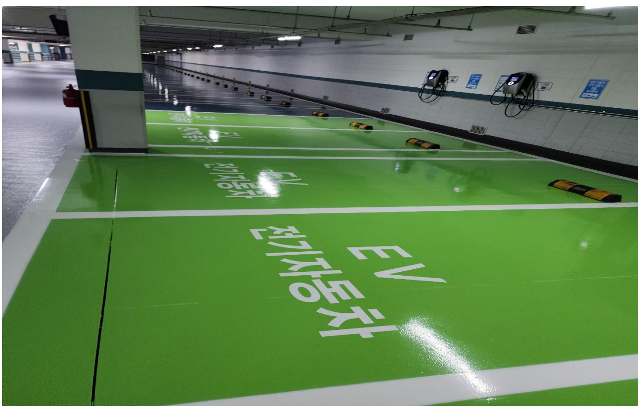
공사 중 (그래픽 도장)
