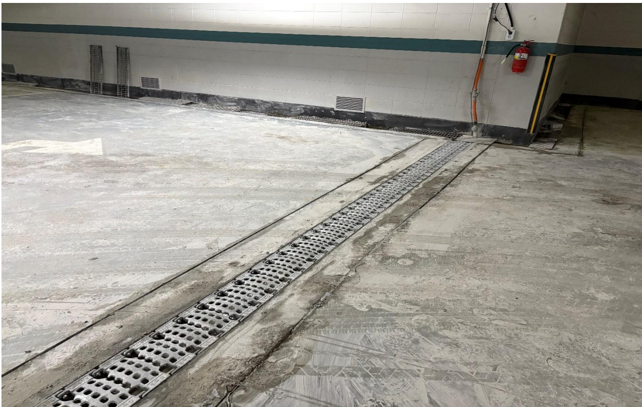
공사 중 (차수 공법)
