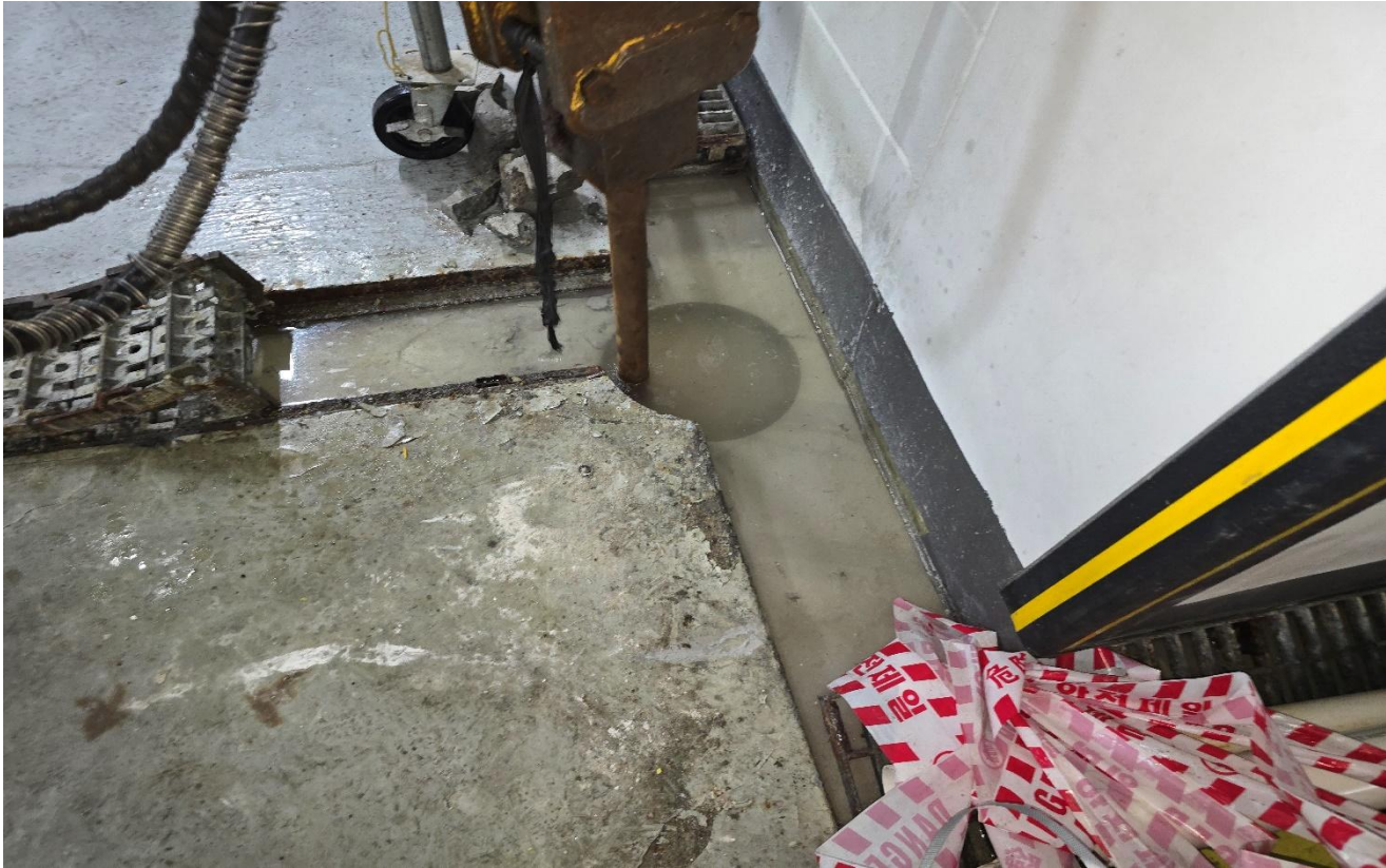
공사 중 (집수정 설치)
