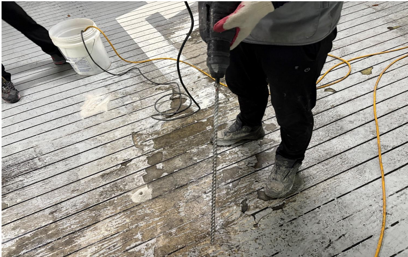
공사 중 (배면 그라우팅)
