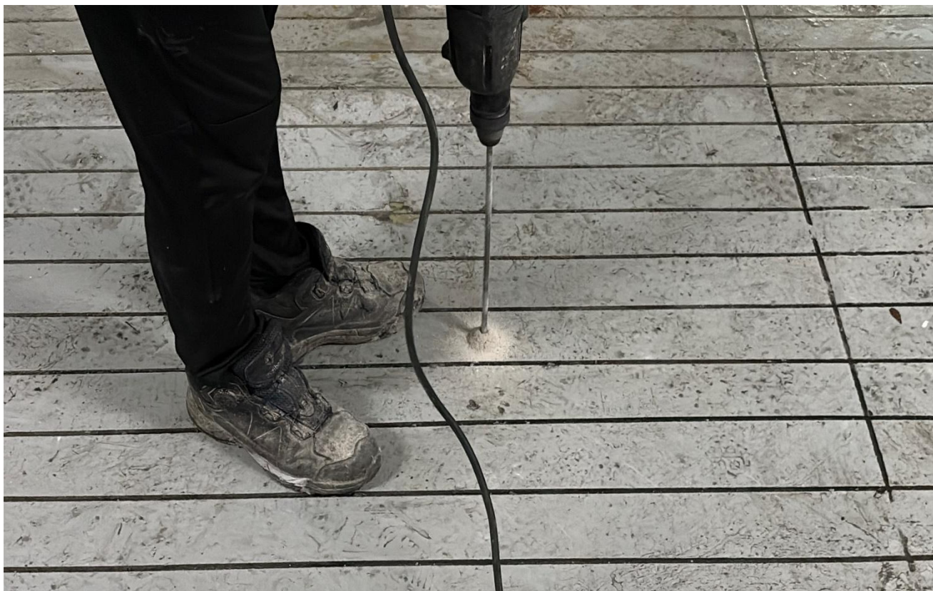
공사 중 (배면 그라우팅)
