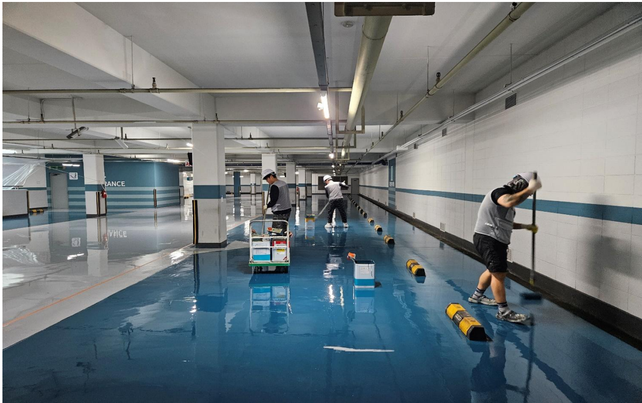
공사 중 (불연 에폭시 상도 코팅)
