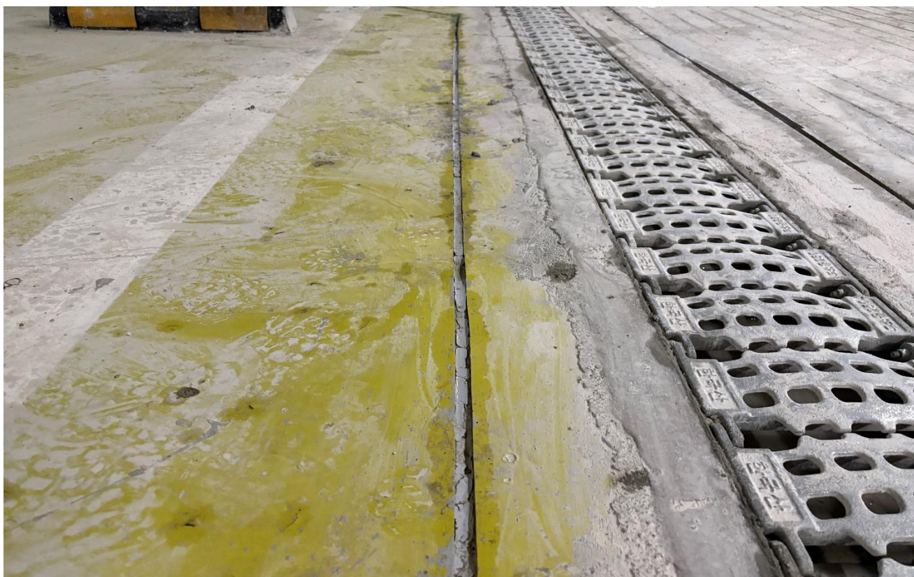
공사 중 (차수 공법)
