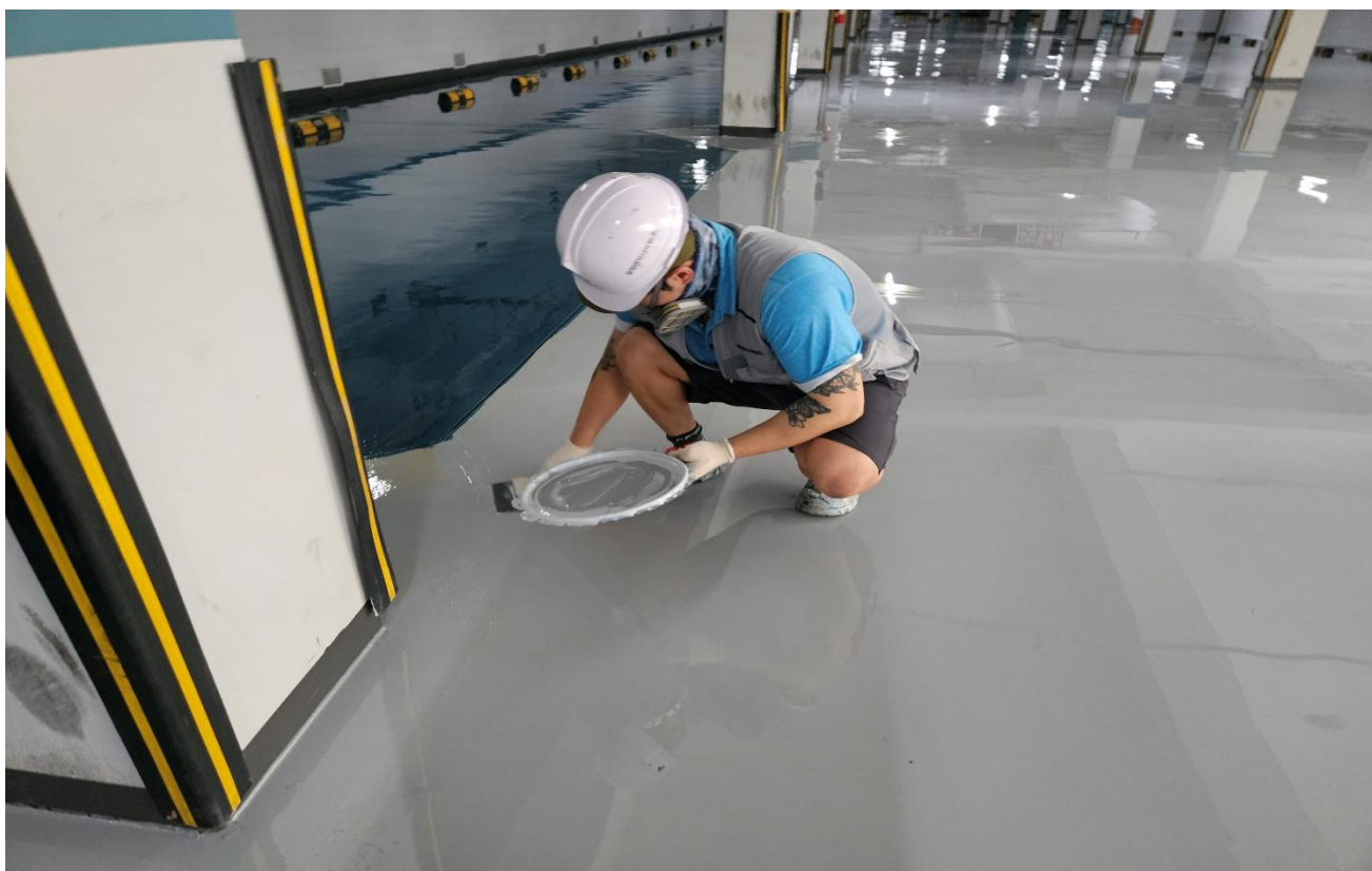
공사 중 (바닥 균열보수)
