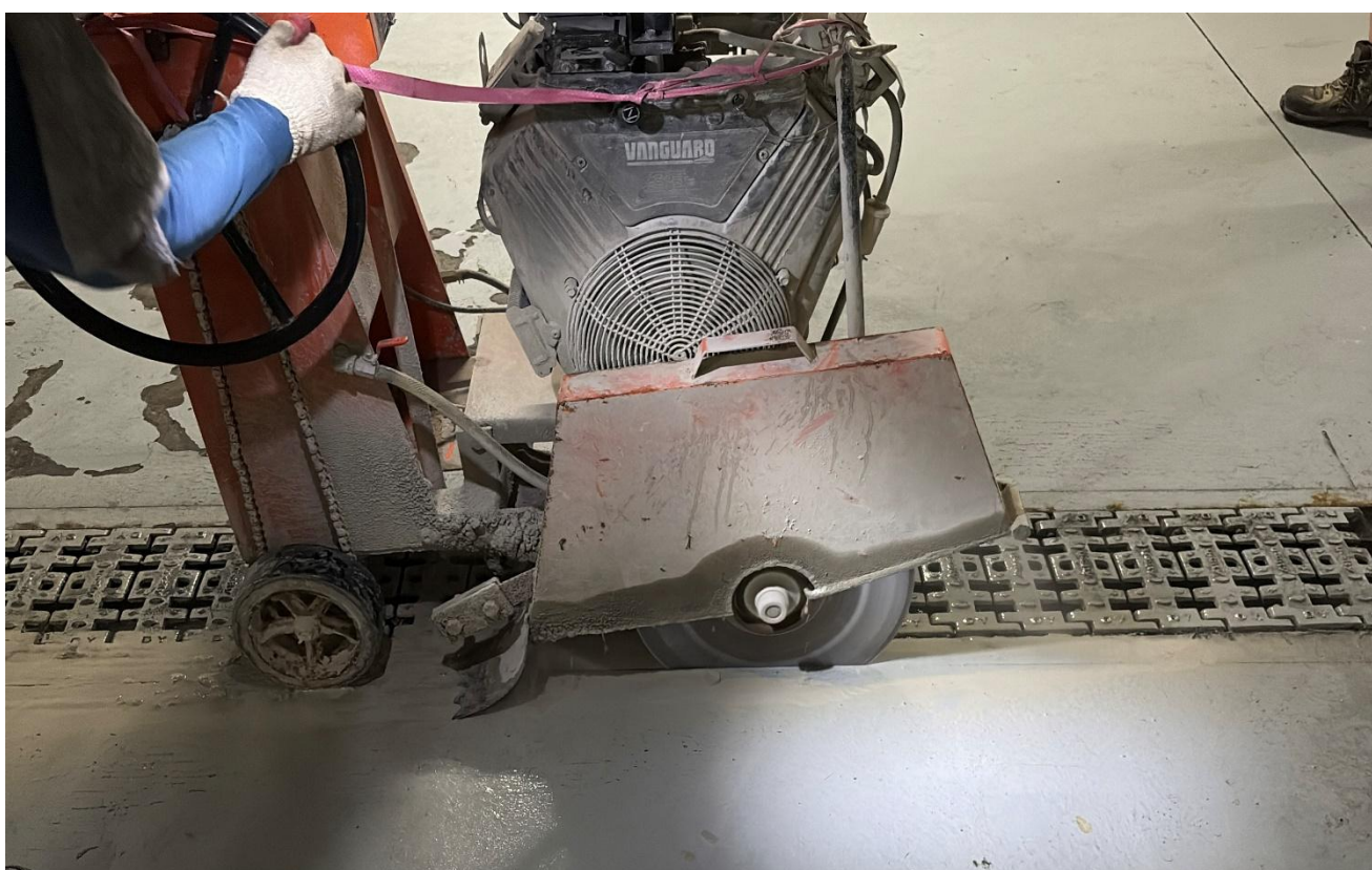
공사 중 (차수 공법)
