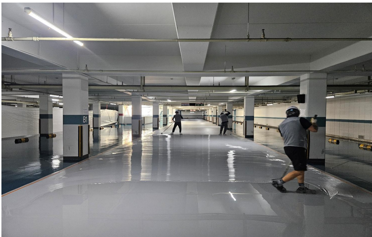
공사 중 (에폭시 엠보 도포)
