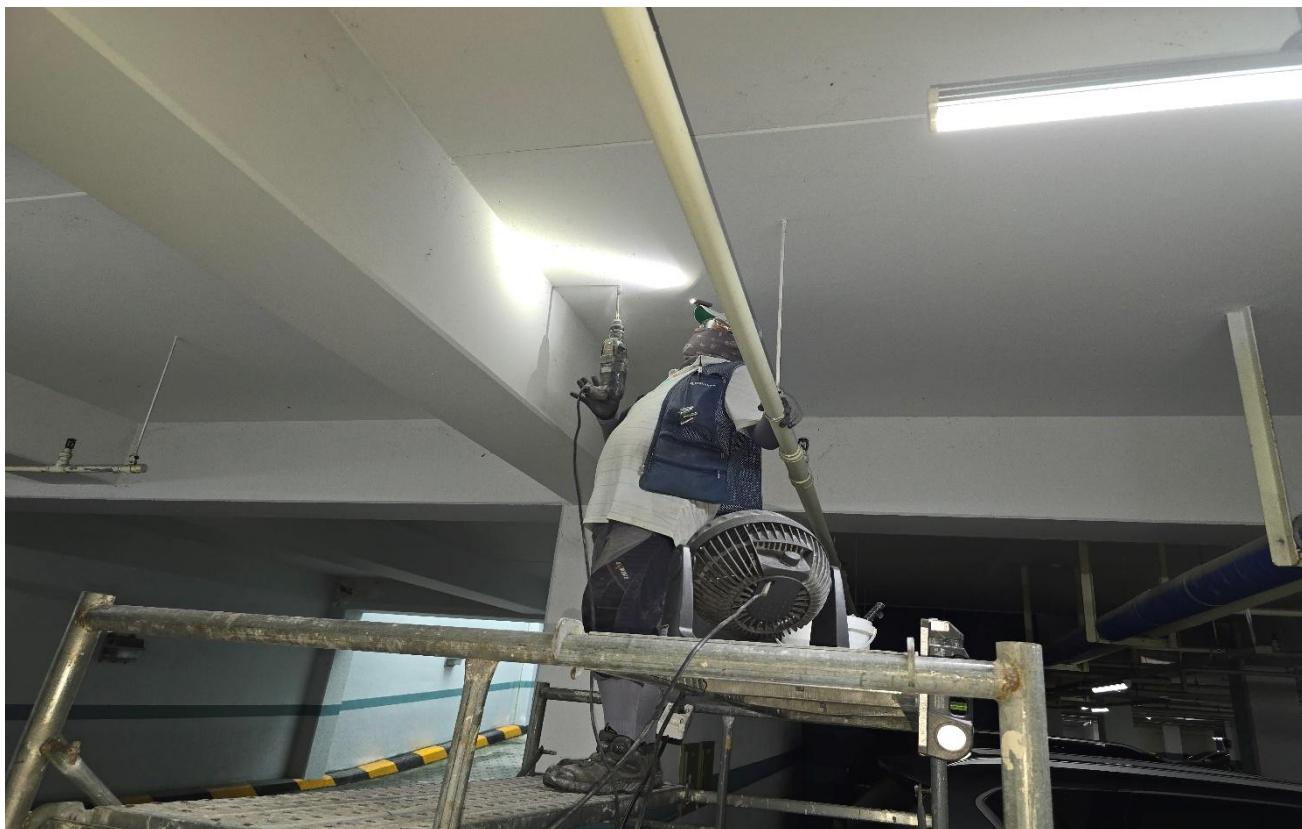
공사 중 (집수정 설치)
