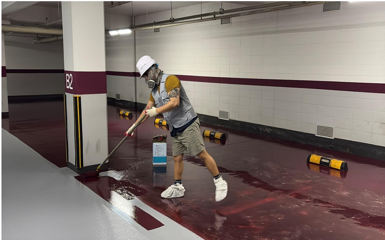
공사 중 (불연 에폭시 상도 코팅)
