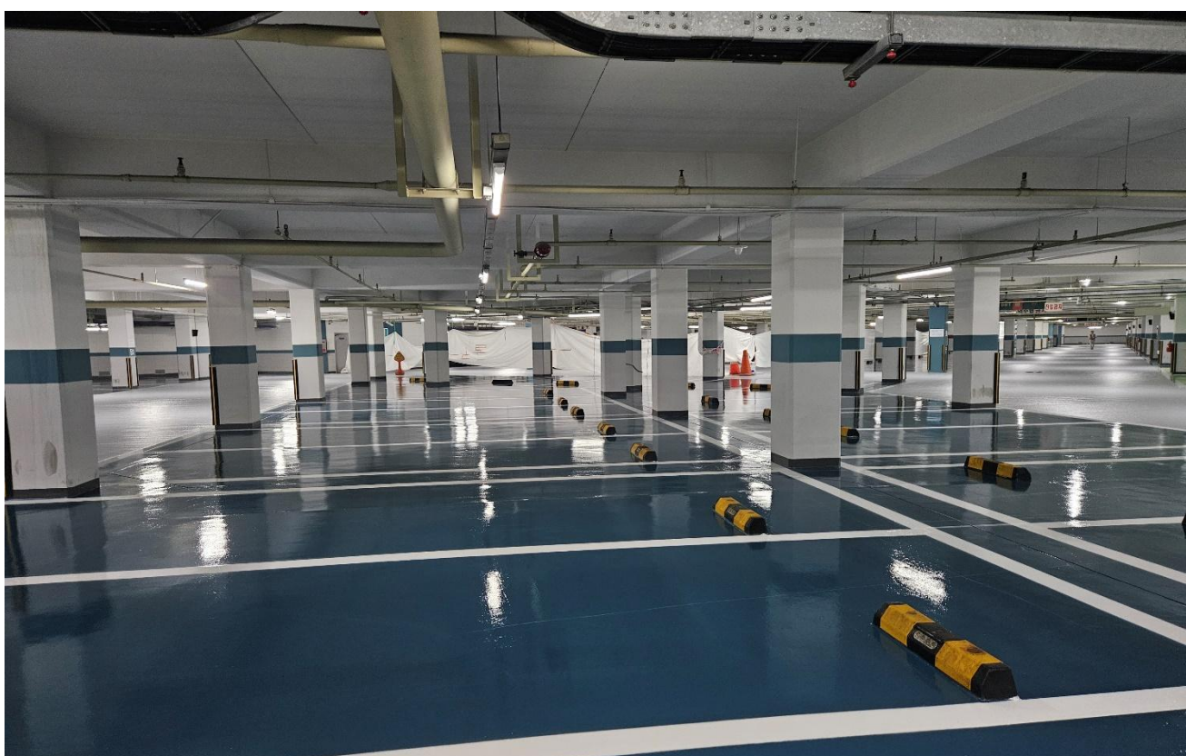
공사 중 (차선 도장)
