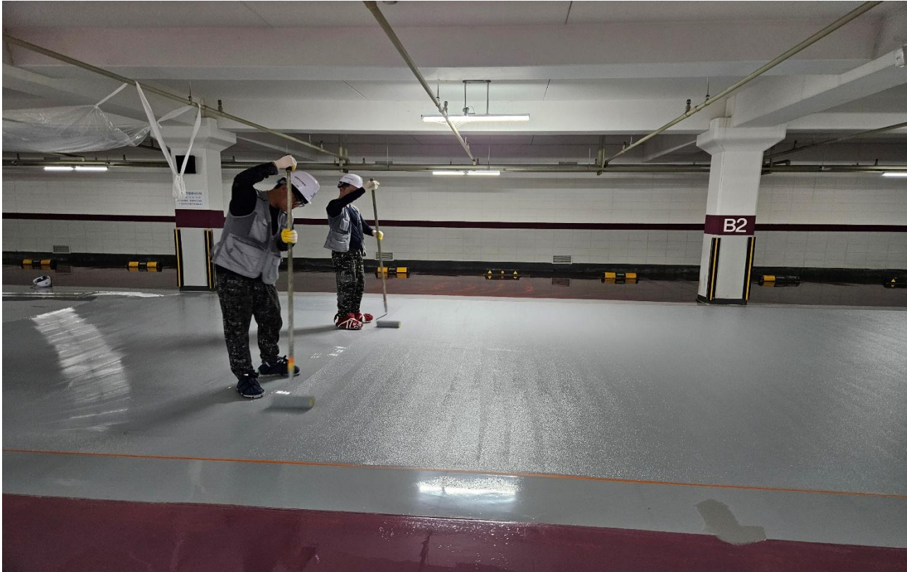
공사 중 (에폭시 엠보 도포)
