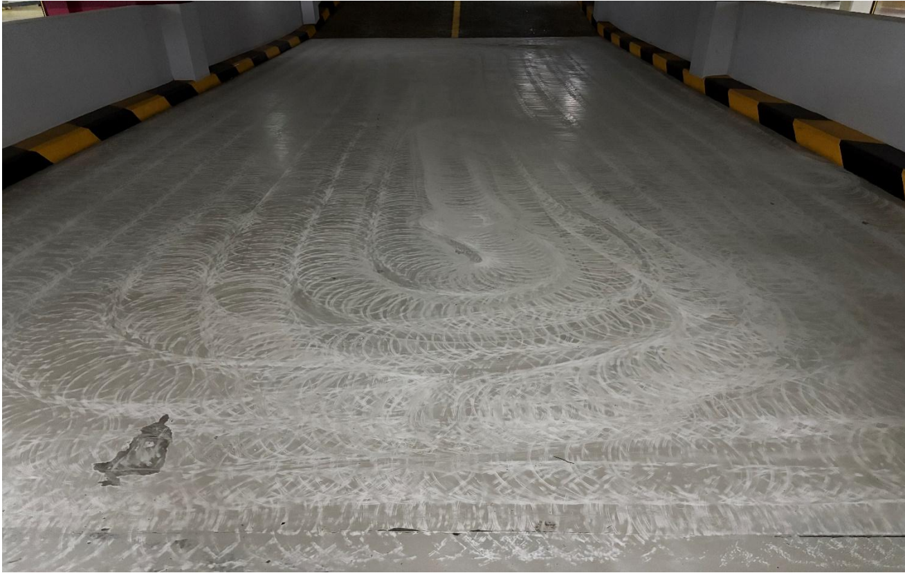
공사 중 (바탕면 정리)
