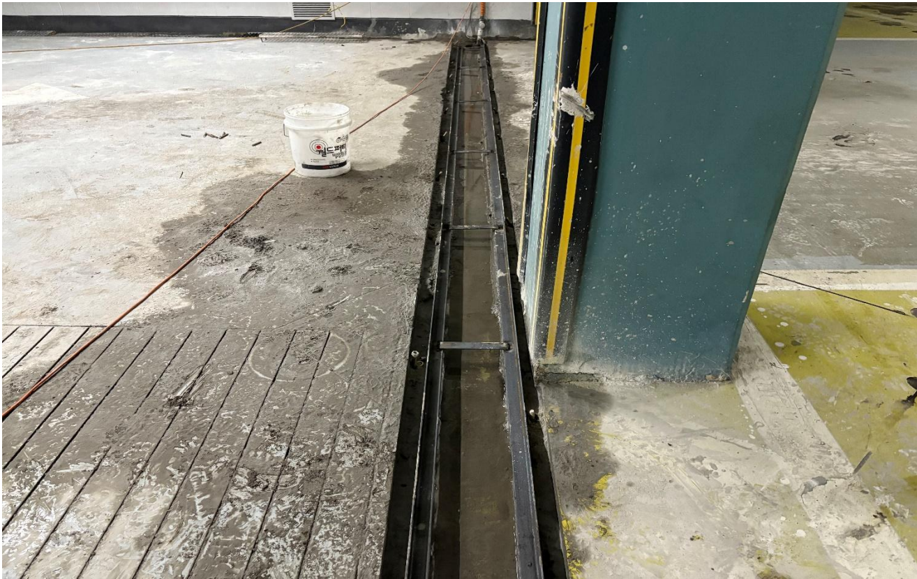
공사 중 (무소음 트렌치)
