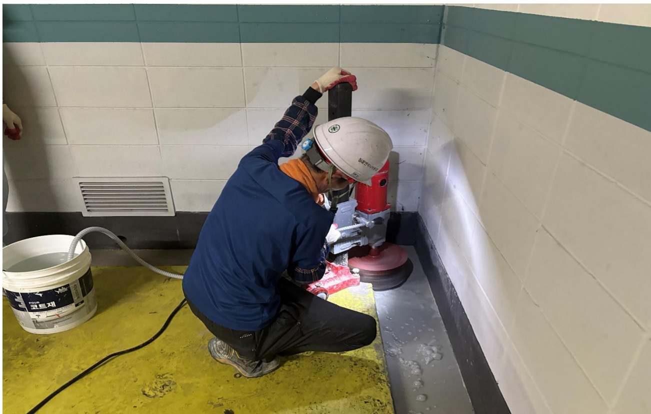
공사 중 (집수정 설치)
