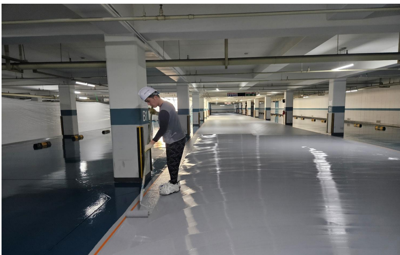
공사 중 (에폭시 엠보 도포)
