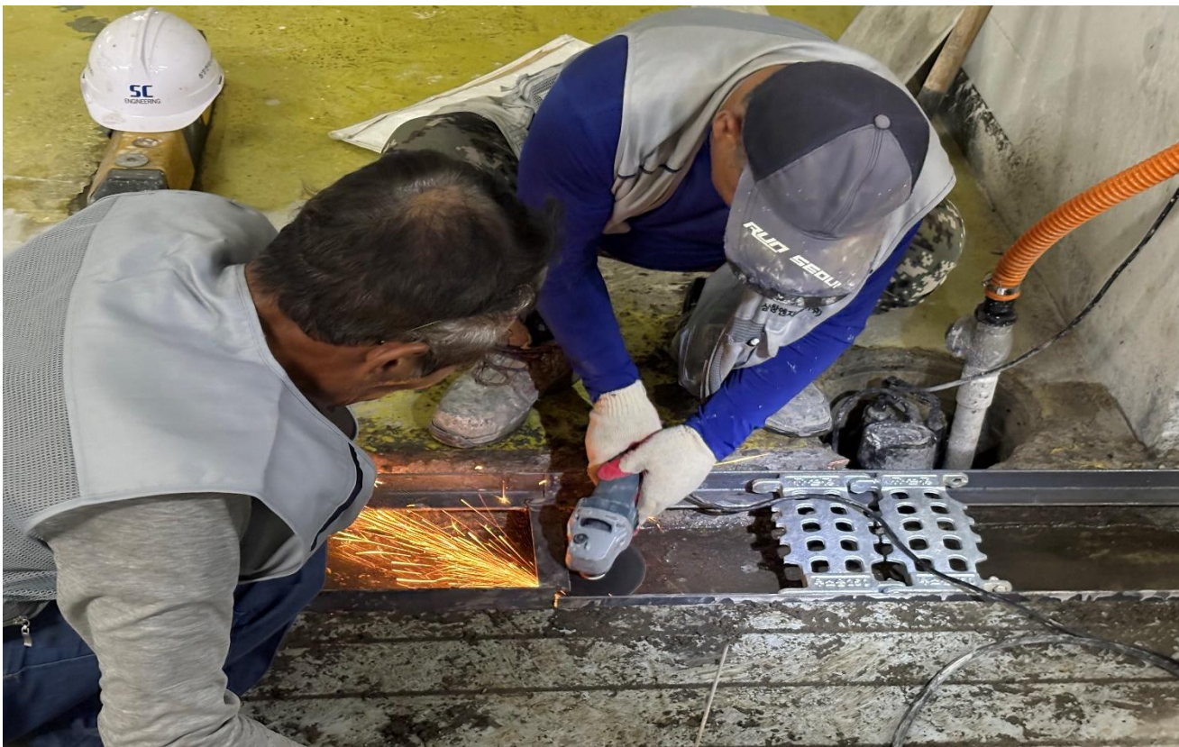
공사 중 (무소음 트렌치)
