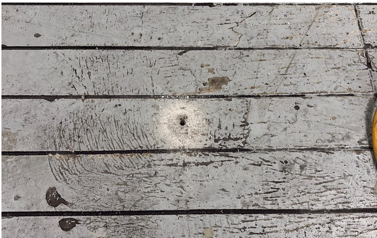
공사 중 (배면 그라우팅)
