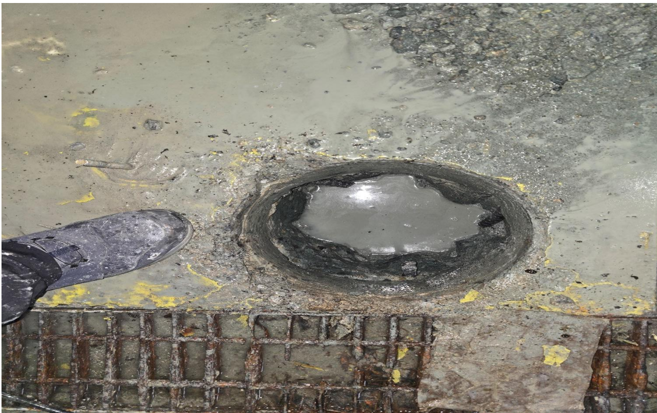
공사 중 (집수정 설치)
