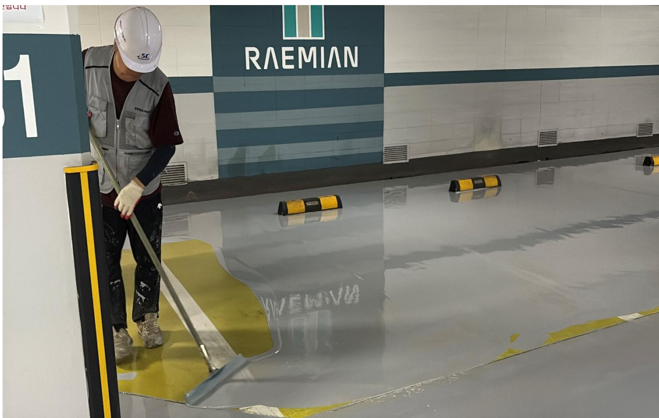
공사 중 (에폭시 중도 도포)
