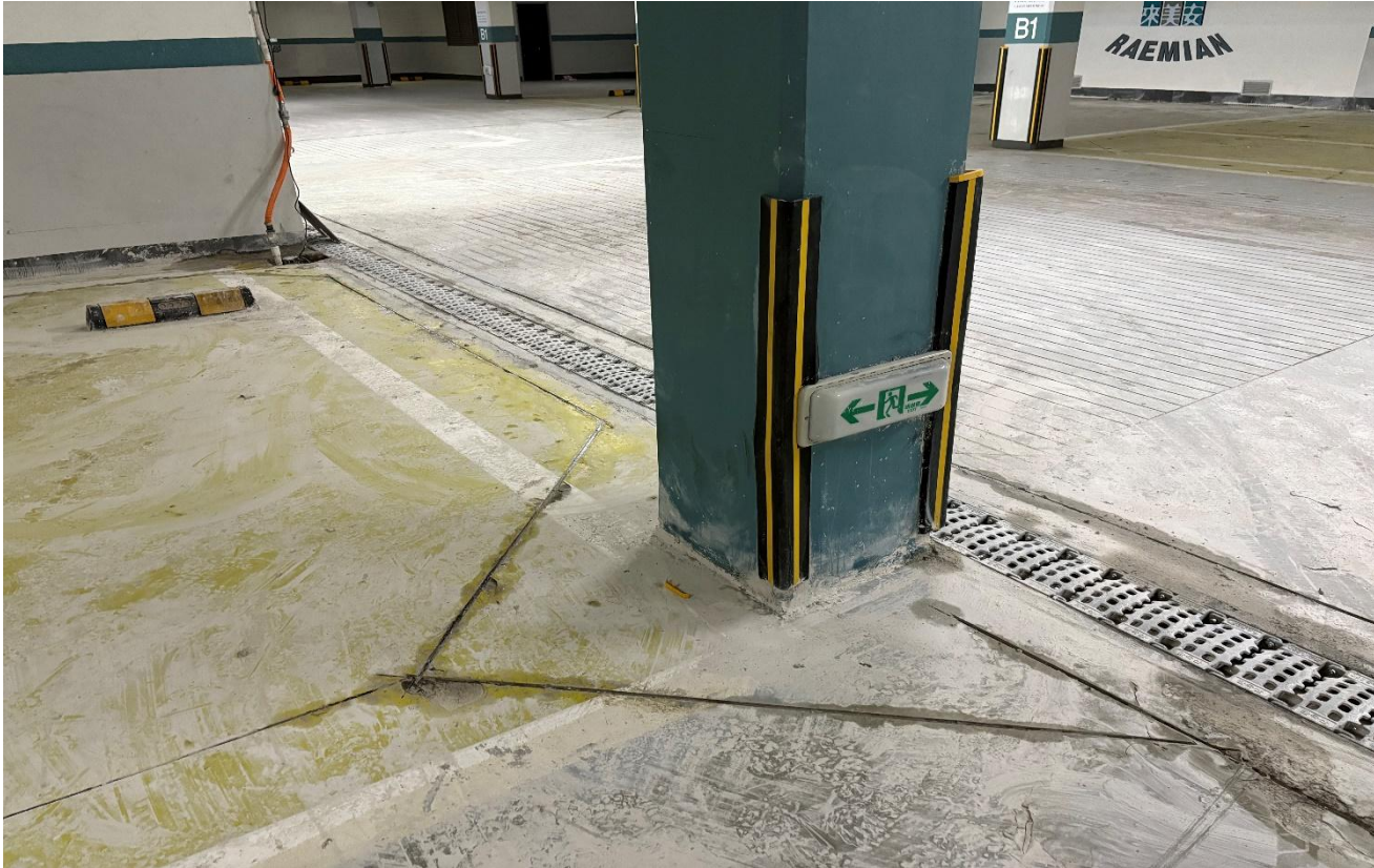
공사 중 (차수 공법)
