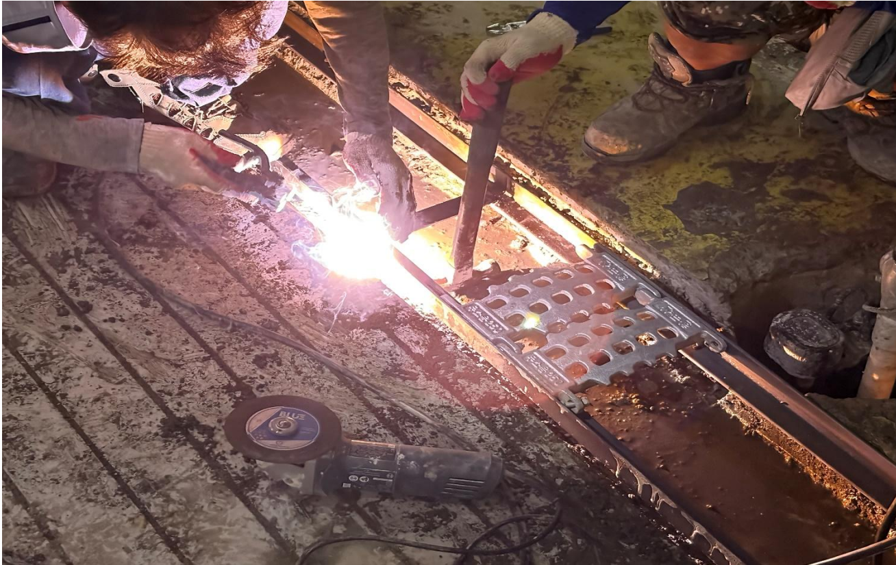
공사 중 (무소음 트렌치)
