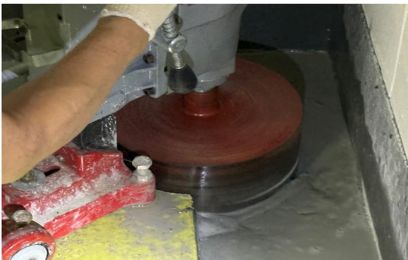
공사 중 (집수정 설치)
