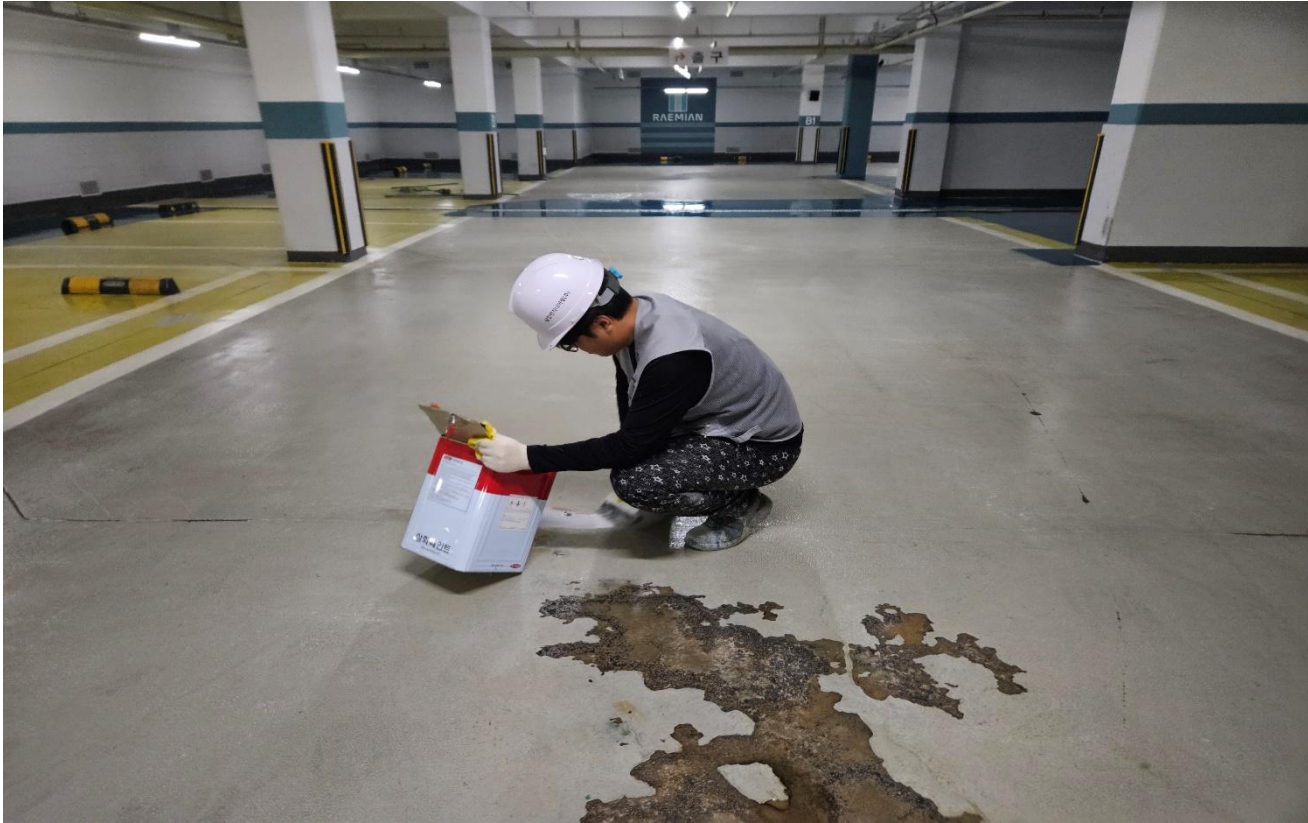
공사 중 (바닥 균열보수)
