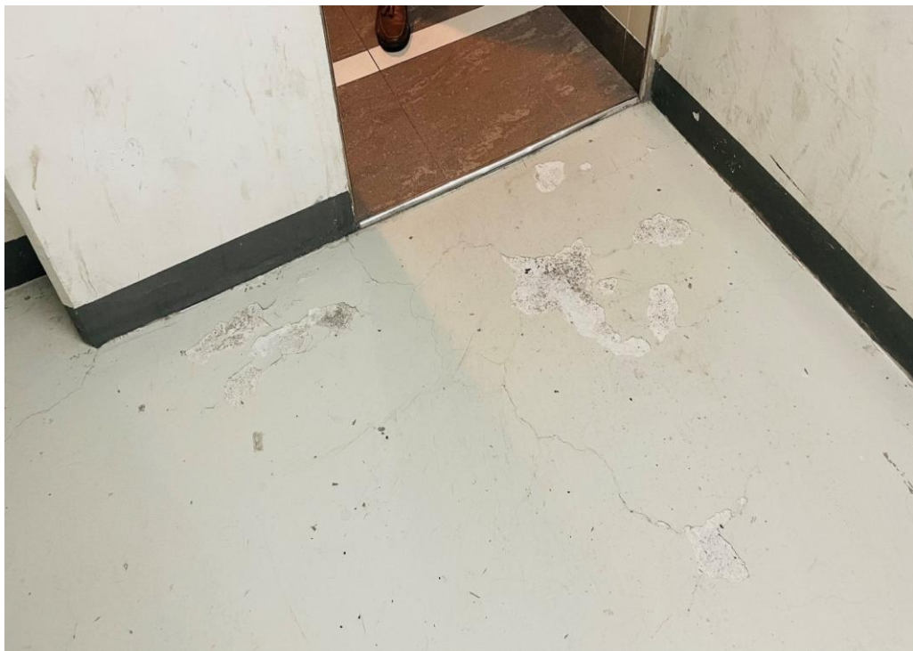
공사 전 지하주차장 전경
