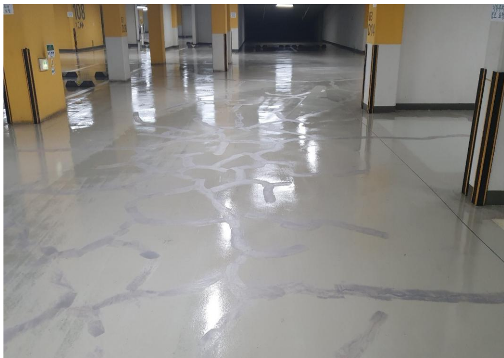
에폭시 퍼티 시공-균열보수
