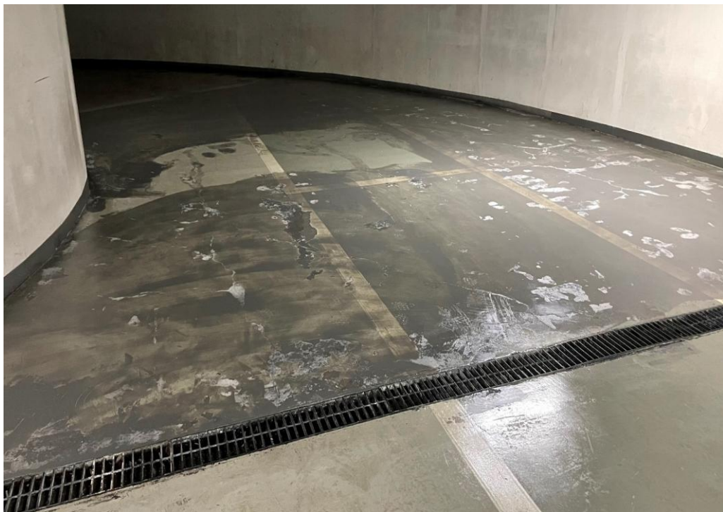
에폭시 퍼티 시공-균열보수
