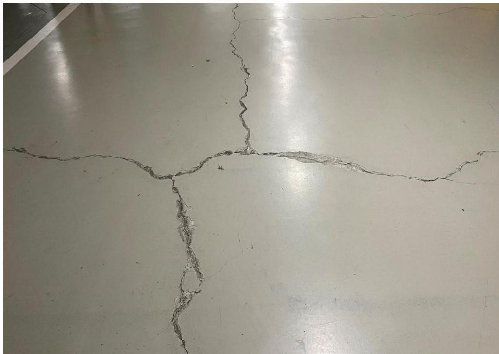
공사 전 지하주차장 전경
