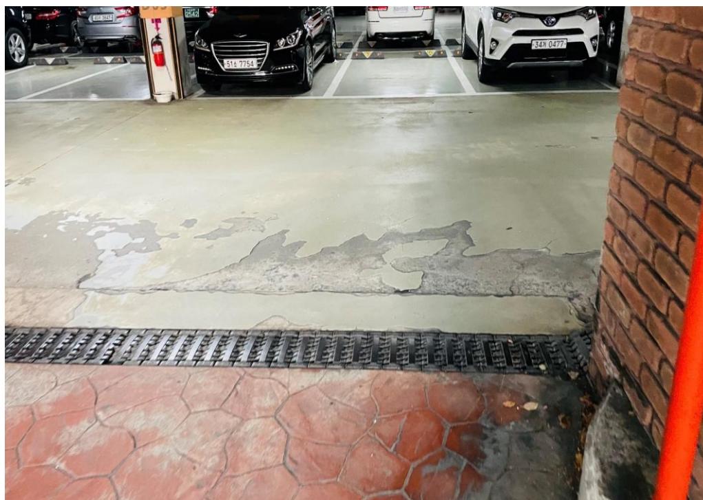
공사 전 지하주차장 전경
