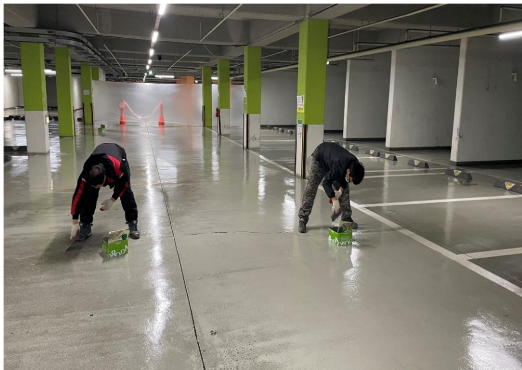
에폭시 퍼티 시공-균열보수
