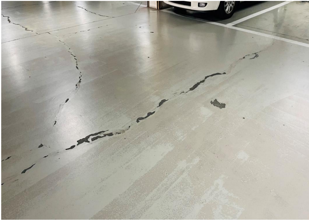
공사 전 지하주차장 전경
