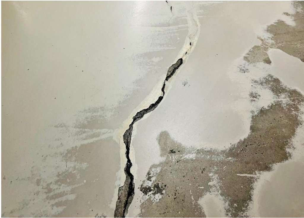
공사 전 지하주차장 전경
