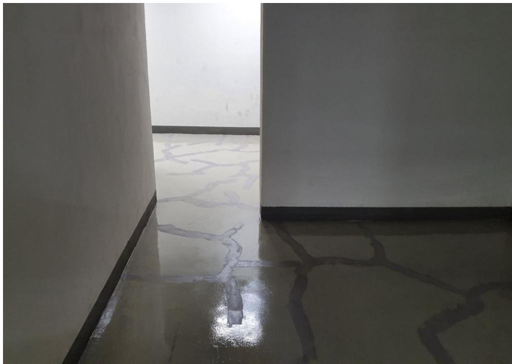
에폭시 퍼티 시공-균열보수
