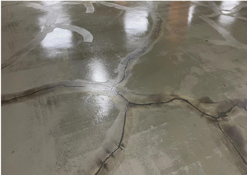
에폭시 퍼티 시공-균열보수
