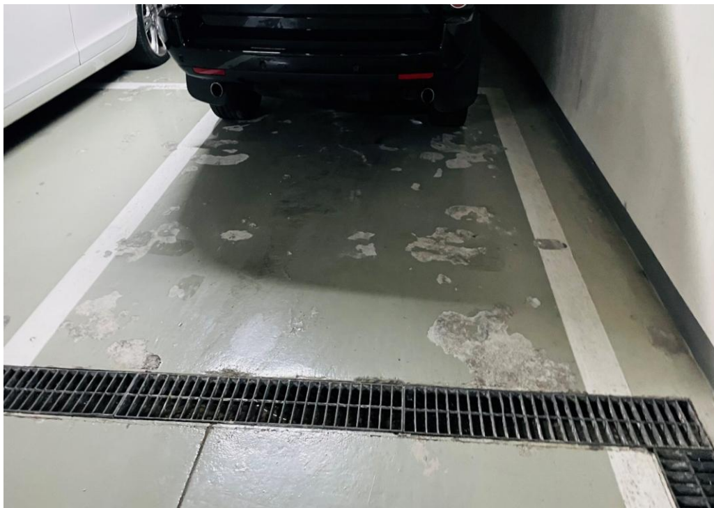
공사 전 지하주차장 전경
