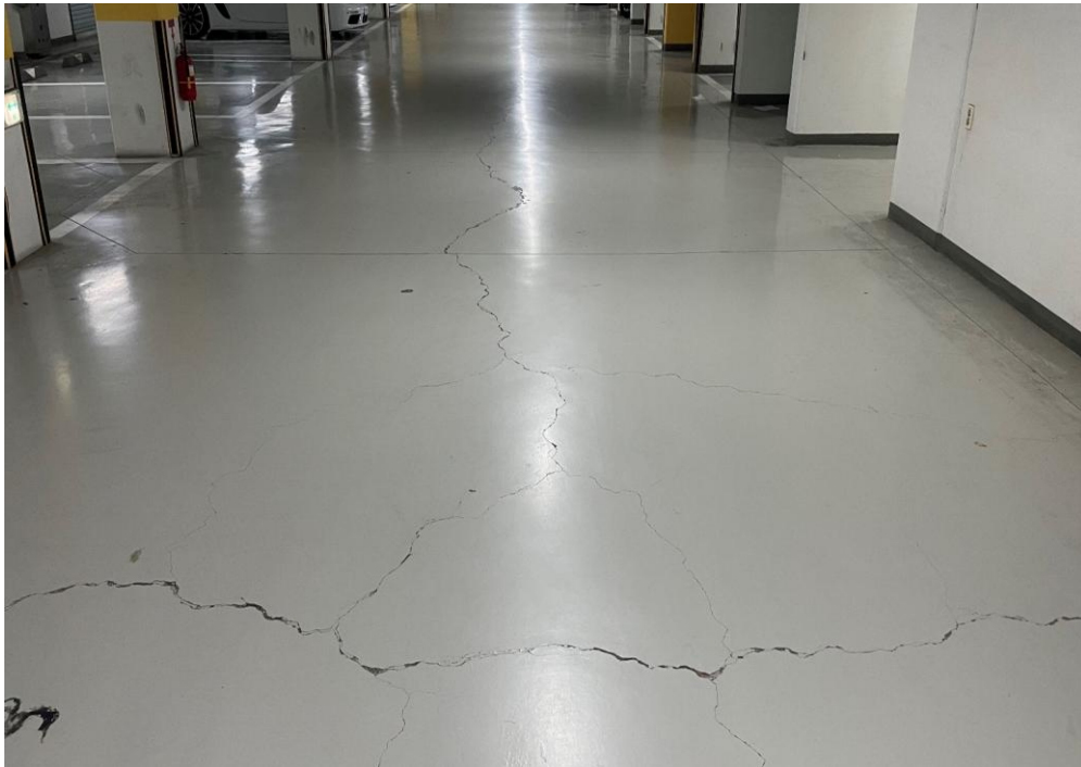
공사 전 지하주차장 전경
