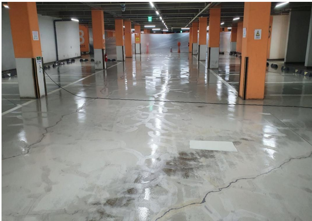
에폭시 퍼티 시공-균열보수
