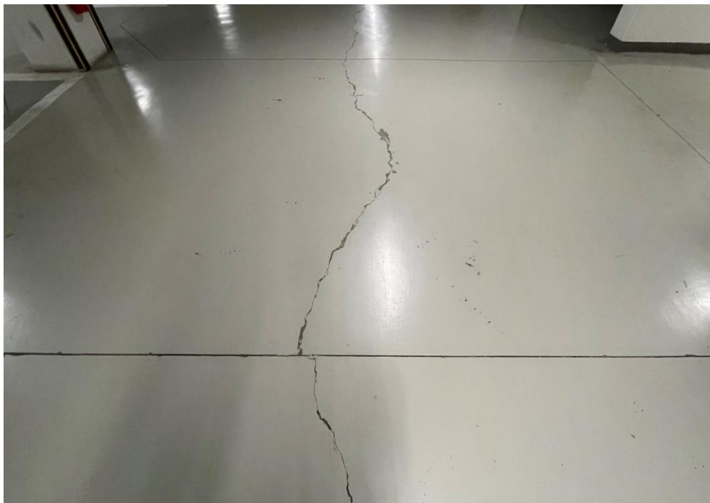
공사 전 지하주차장 전경
