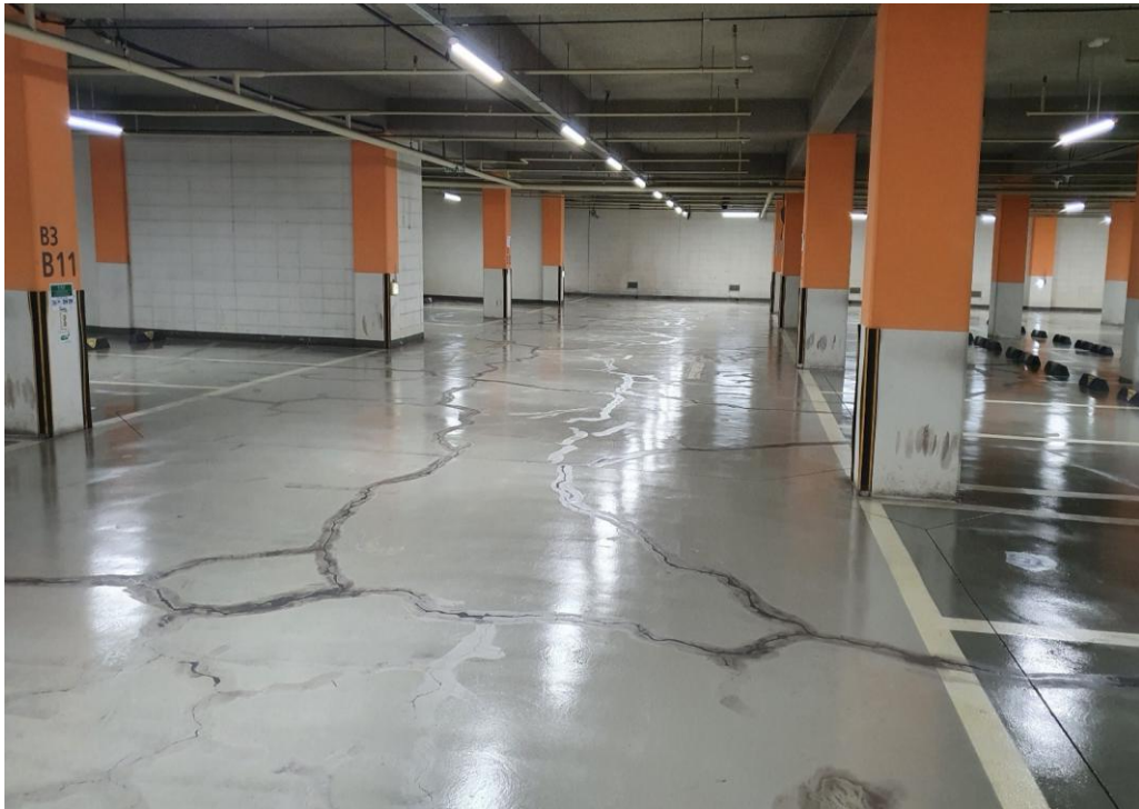
에폭시 퍼티 시공-균열보수
