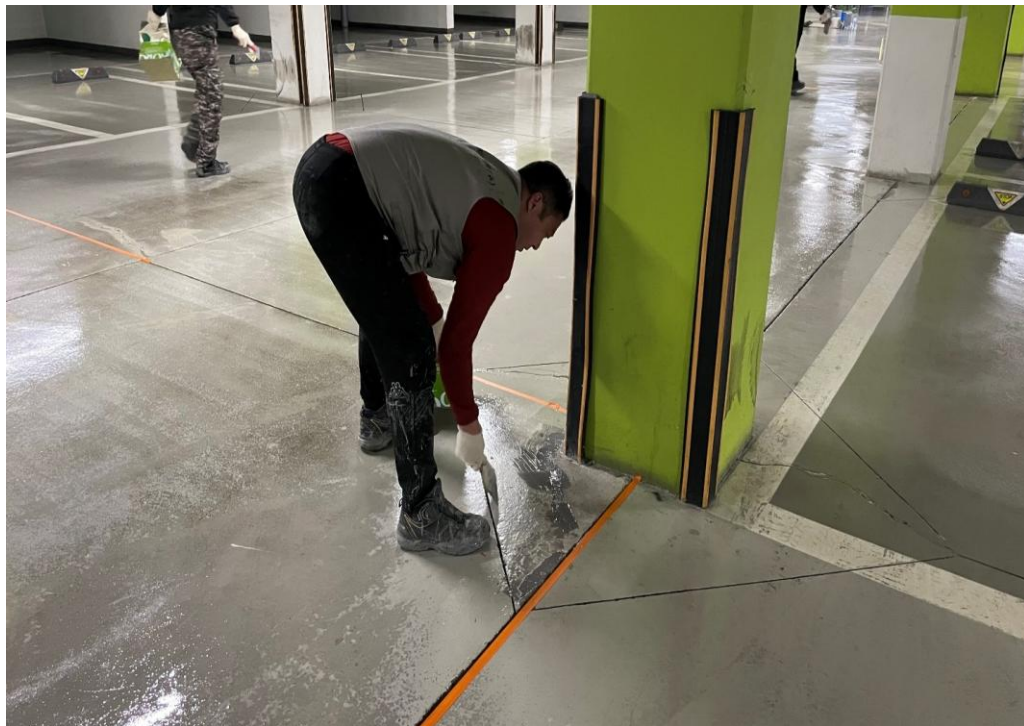
에폭시 퍼티 시공-균열보수
