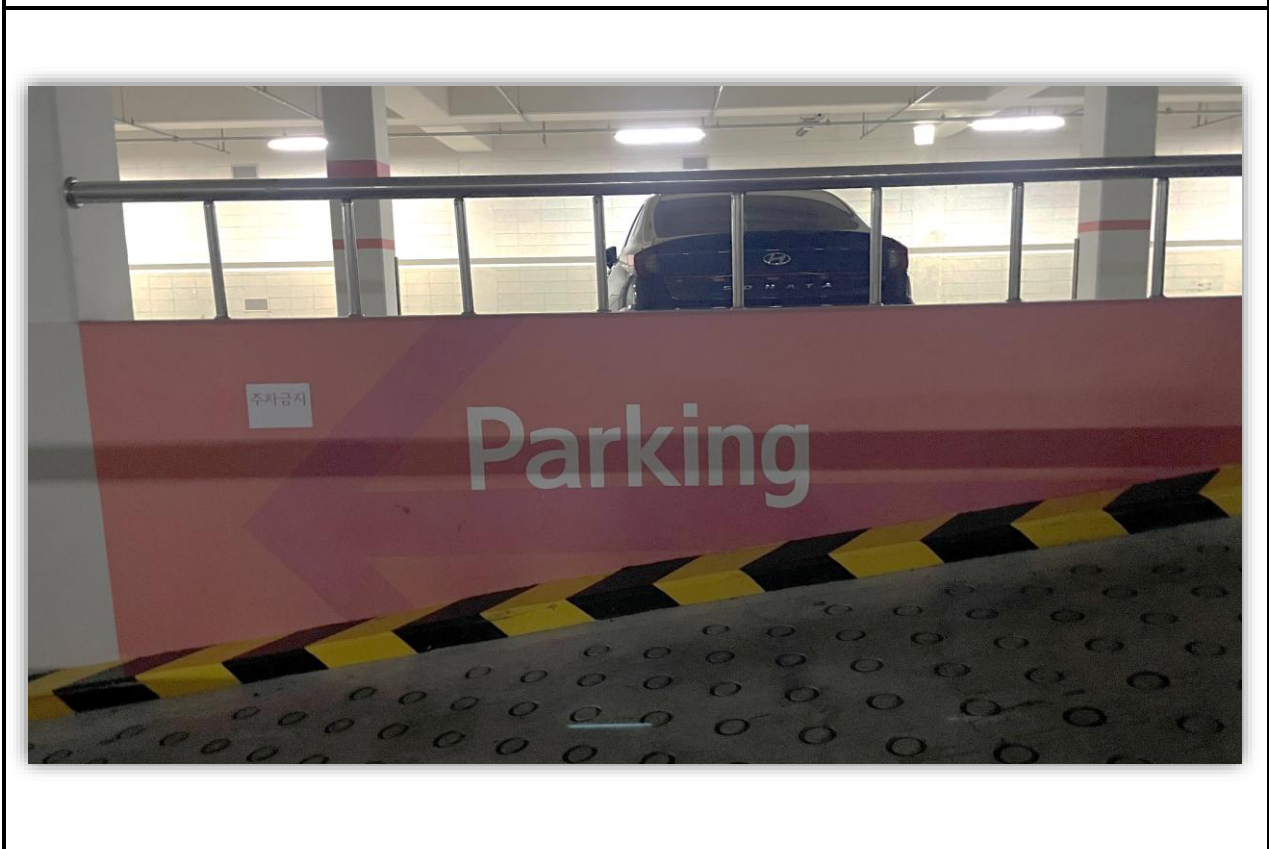
공사 전 지하주차장 전경
