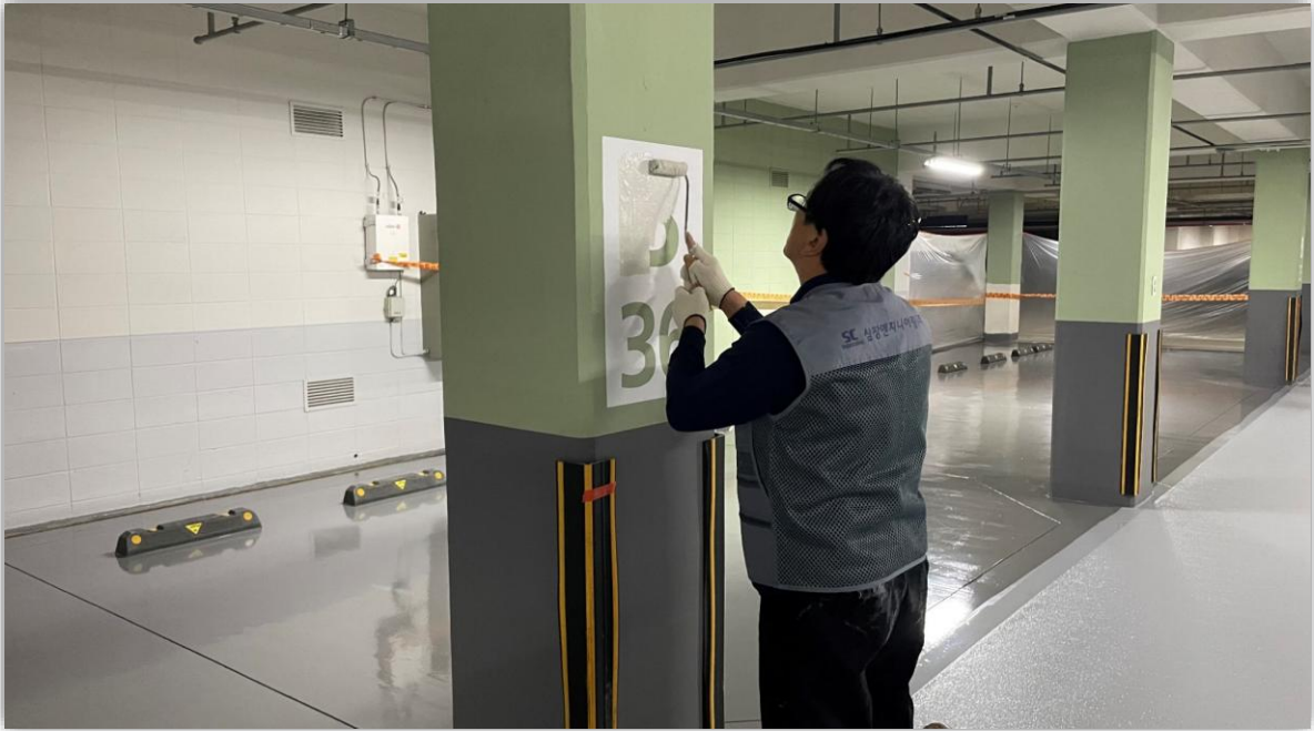
지하주차장 내부 그래픽 도장
