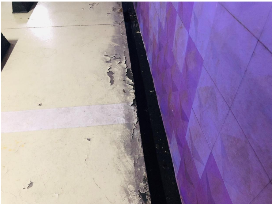
공사 전 지하주차장 전경
