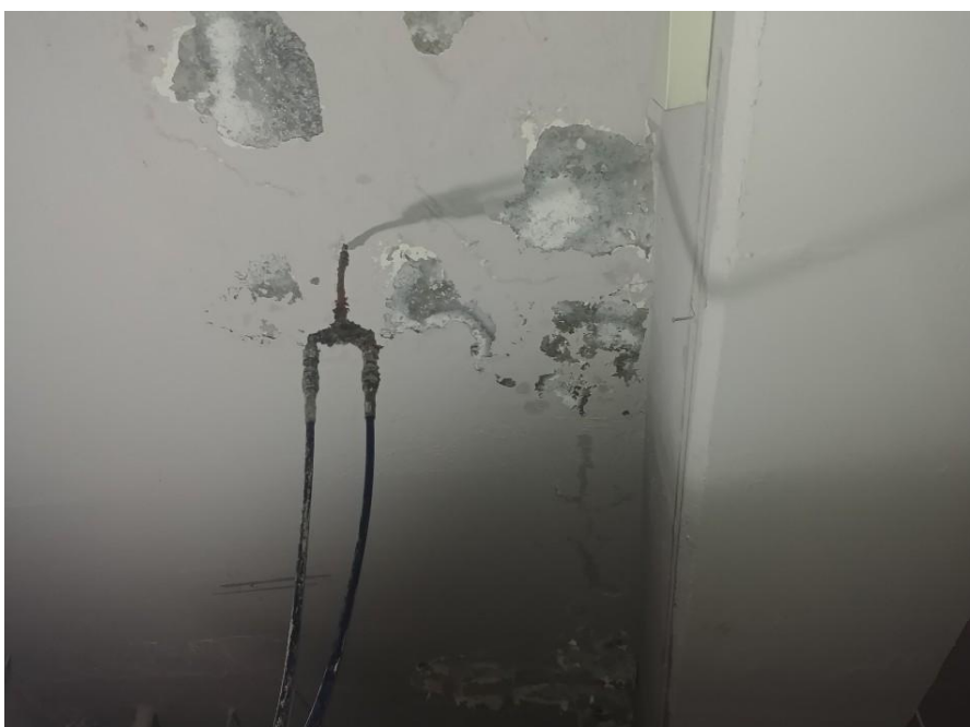
지하주차장 천장 누수보수-아크릴 주입
