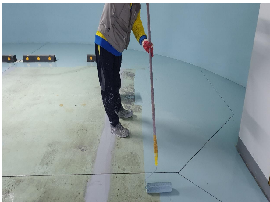
지하주차장 바닥 에폭시 도장-주차면 에폭시 상도 1차코팅
