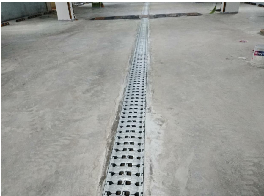
무소음트렌치 설치-트렌치 설치
