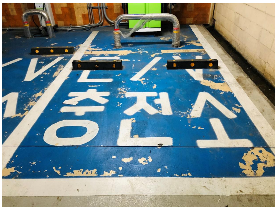
공사 전 지하주차장 전경
