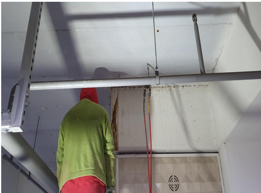
지하주차장 천장 누수보수-아크릴 주입
