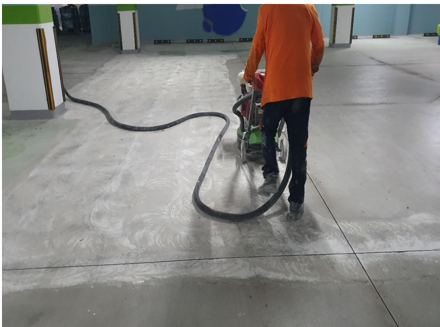
지하주차장 바닥 에폭시 도장-바탕면 정리 및 스크래치 작업
