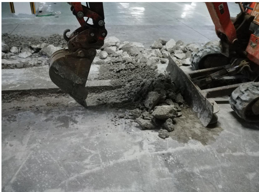
무소음트랜치 설치-바닥 파쇄
