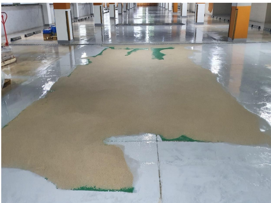
지하주차장 바닥 에폭시 도장-에폭시 레진몰탈 시공
