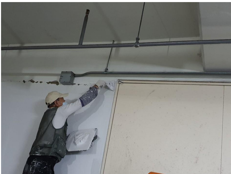
지하주차장 내부 도장-바탕면 정리 및 퍼티작업
