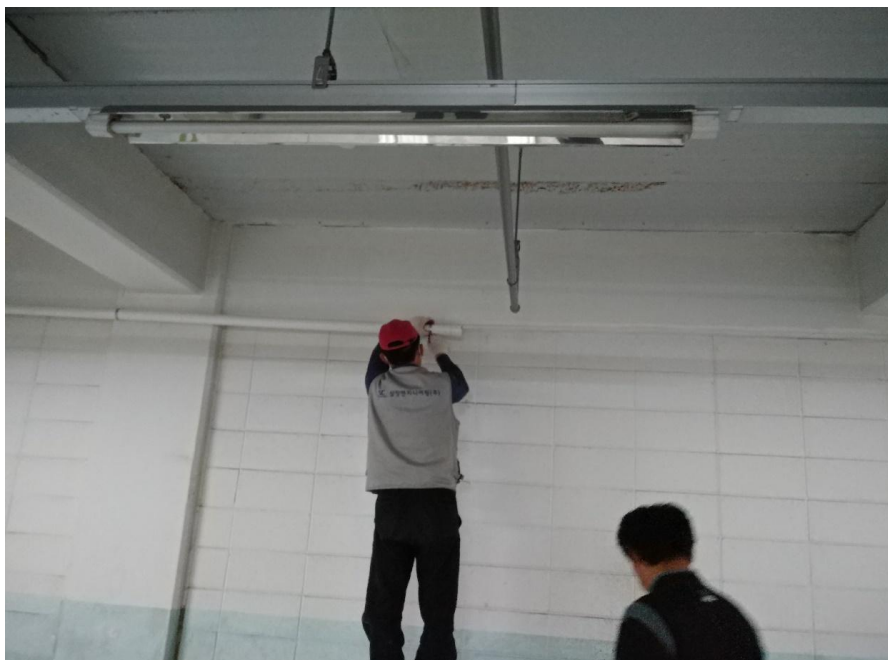
집수정 설치-유도배관 설치
