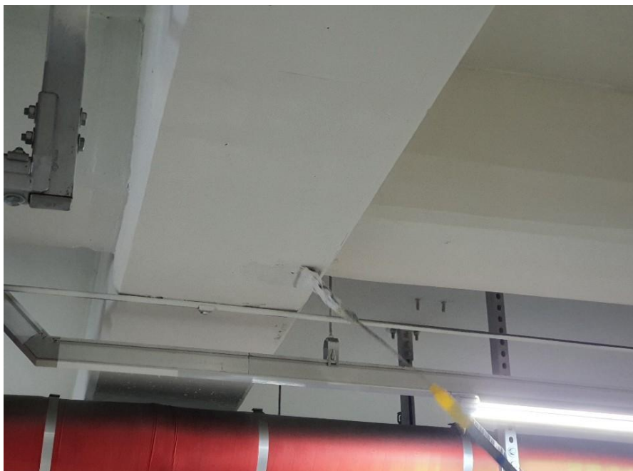
지하주차장 내부 도장-바탕면 정리 및 퍼티작업
