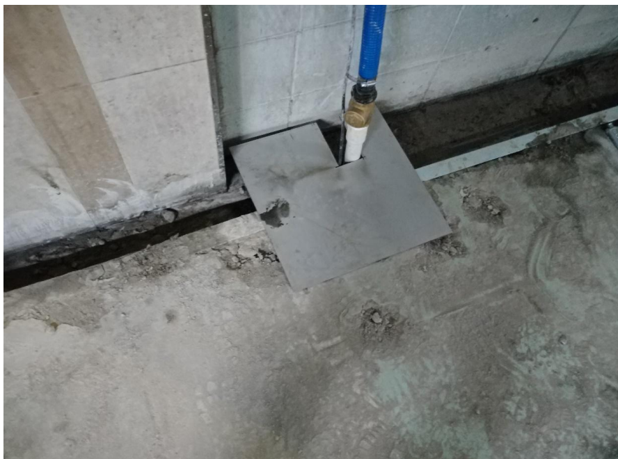
집수정 설치-배수펌프 설치
