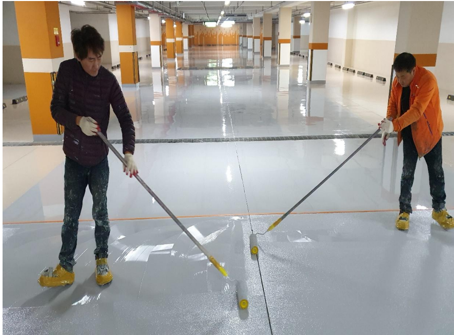
지하주차장 바닥 에폭시 도장-코너부위 에폭시 엠보 시공
