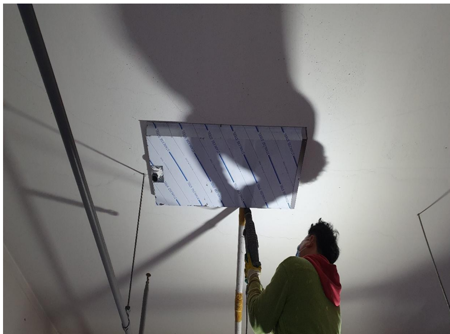
지하주차장 천장 누수보수-유도판 부착
