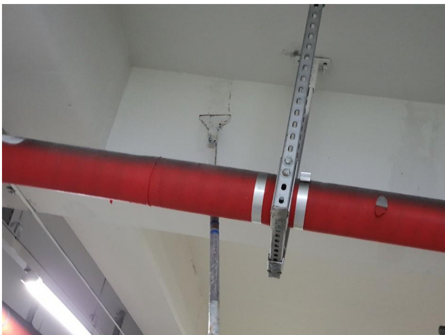
지하주차장 내부 도장-바탕면 정리 및 퍼티작업
