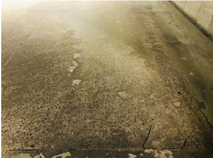
공사 전 지하주차장 전경
