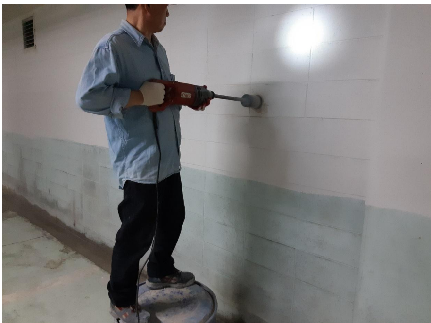
집수정 설치-유도배관 설치
