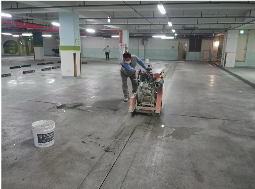
무소음트랜치 설치-바닥 커팅
