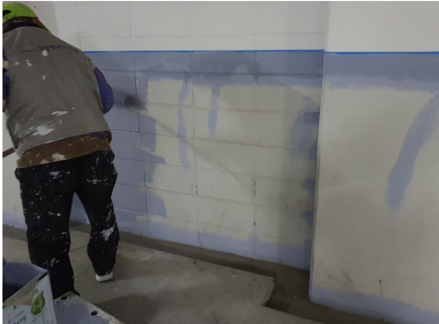
지하주차장 내부 도장-수성페인트 도장
