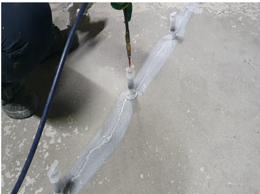
지하주차장 바닥 에폭시 도장-주행로 대균열 주입식 균열보수
