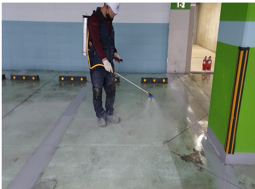
지하주차장 바닥 에폭시 도장-에폭시 프라이머 도포
