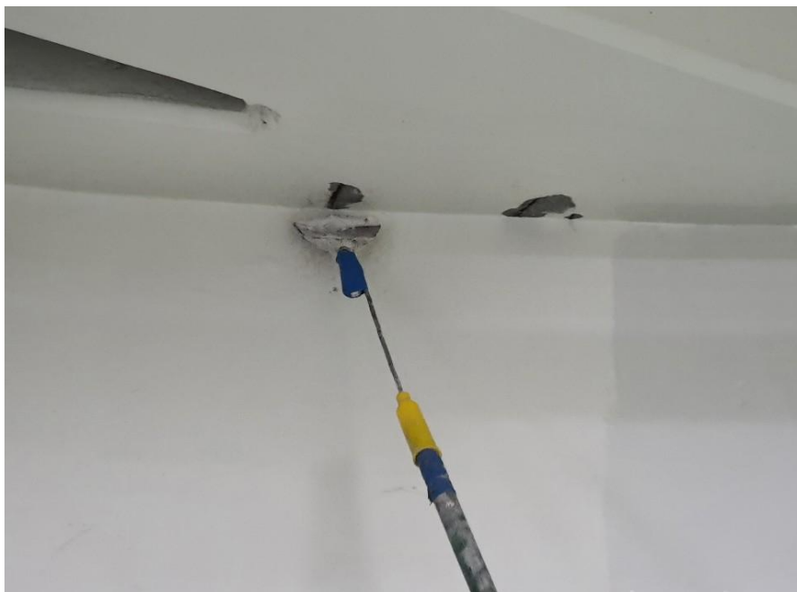
지하주차장 내부 도장-바탕면 정리 및 퍼티작업
