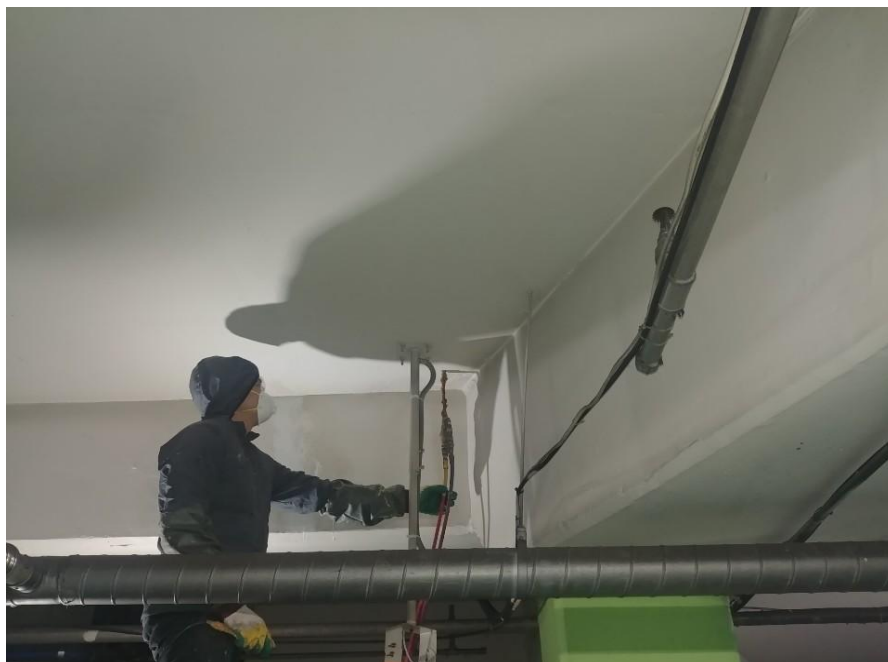
지하주차장 천장 누수보수-아크릴 주입
