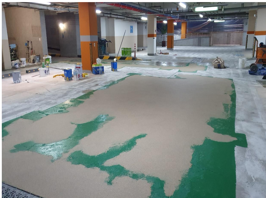
지하주차장 바닥 에폭시 도장-에폭시 레진몰탈 시공
