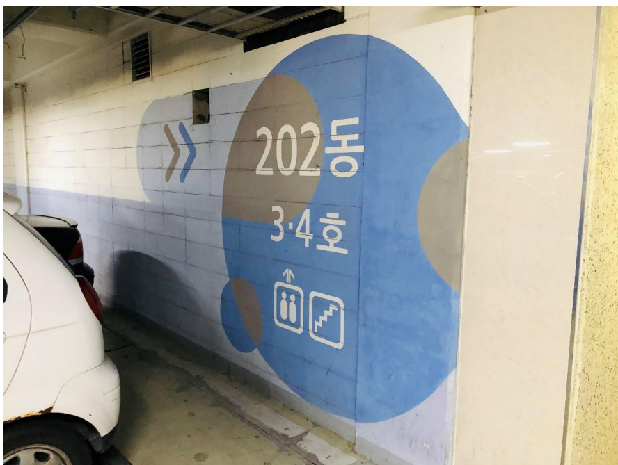
공사 전 지하주차장 전경
