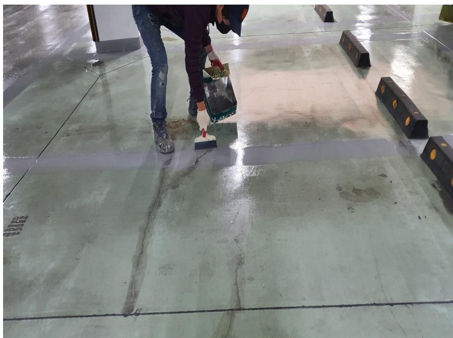
지하주차장 바닥 에폭시 도장-에폭시 퍼티 균열보수
