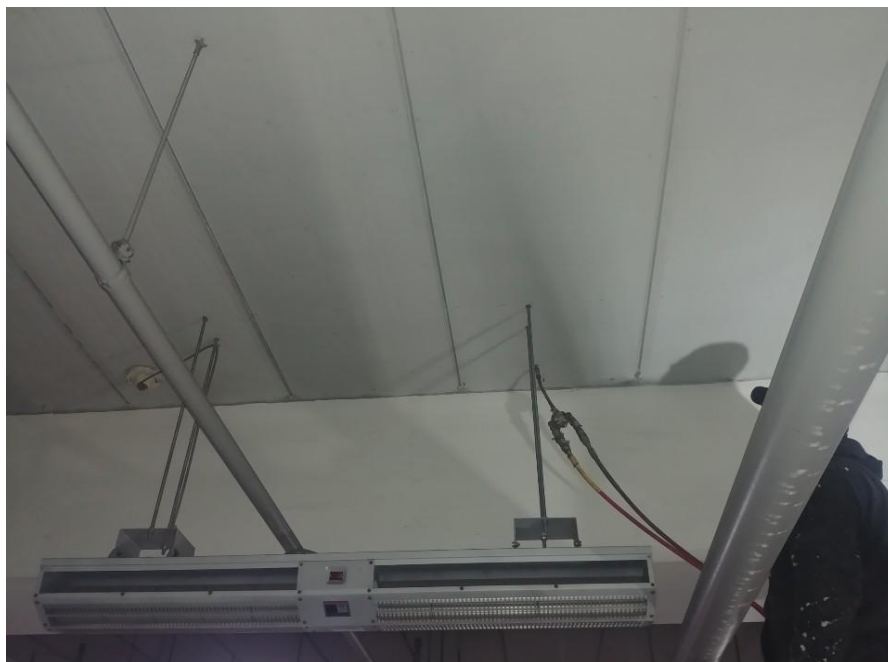
지하주차장 천장 누수보수-아크릴 주입
