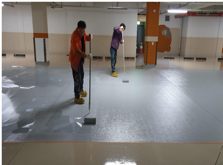
지하주차장 바닥 에폭시 도장-코너부위 에폭시 엠보 시공
