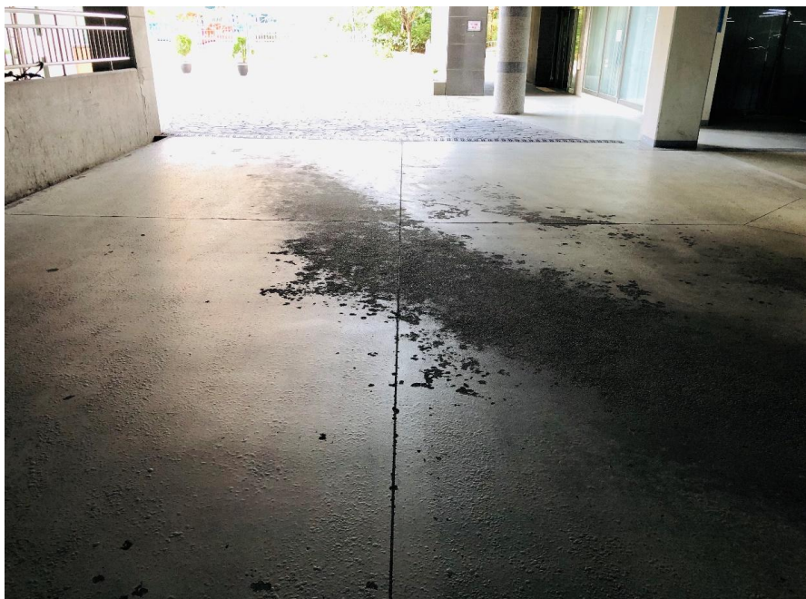
공사 전 지하주차장 전경
