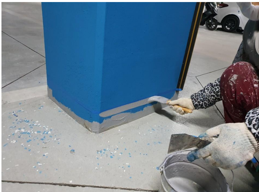
지하주차장 내부 도장-결레받이 도장
