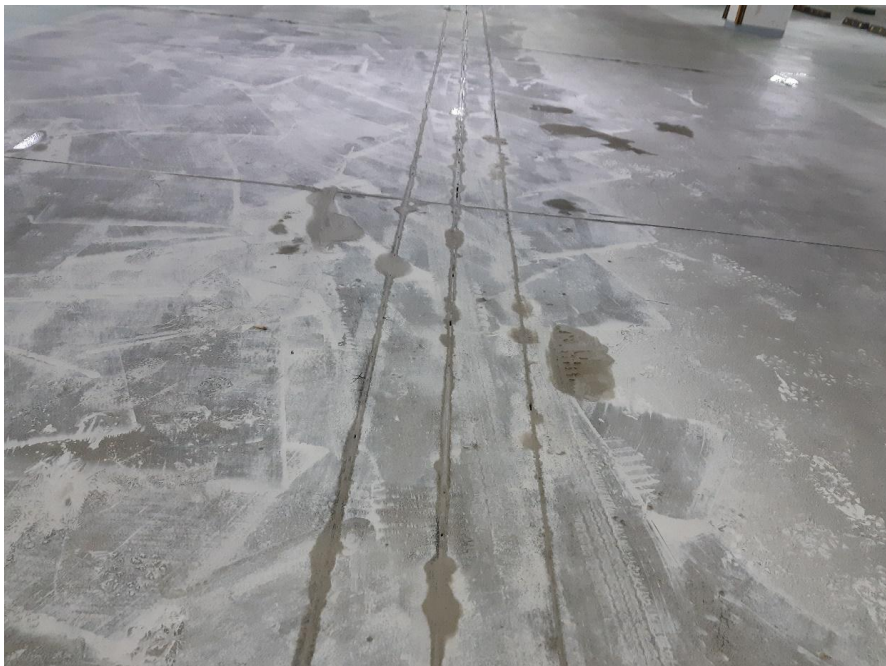
무소음트랜치 설치-바닥 커팅
