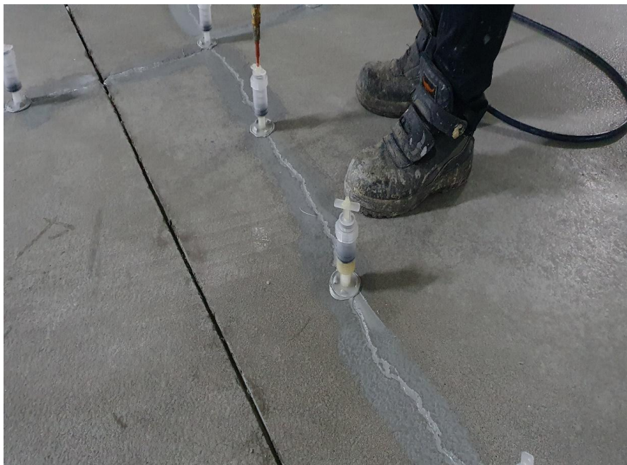
지하주차장 바닥 에폭시 도장-주행로 대균열 주입식 균열보수
