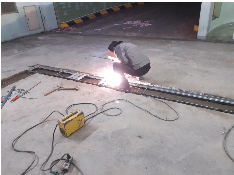
무소음트랜치 설치-앵글 용접
