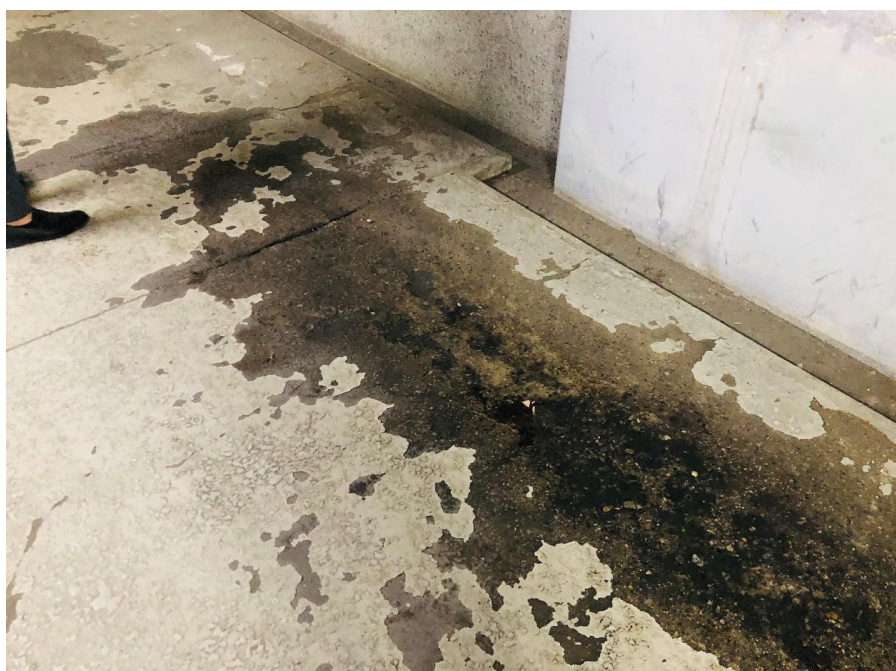
공사 전 지하주차장 전경
