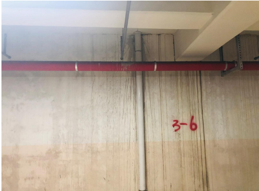
공사 전 지하주차장 전경
