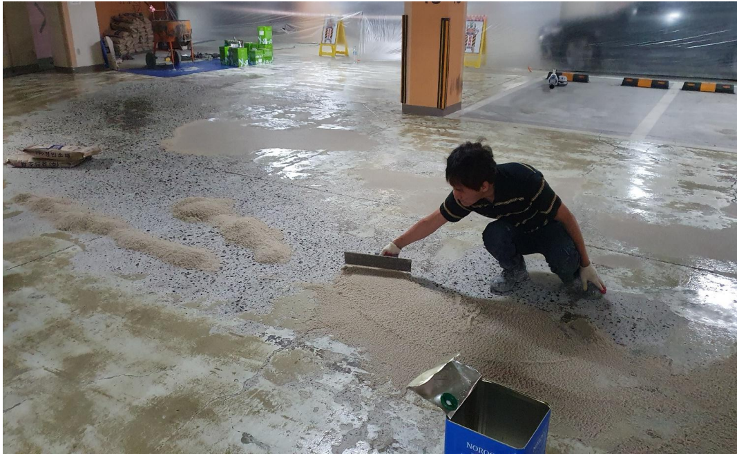
바닥 파인부분 에폭시 레진몰탈 함침 작업
