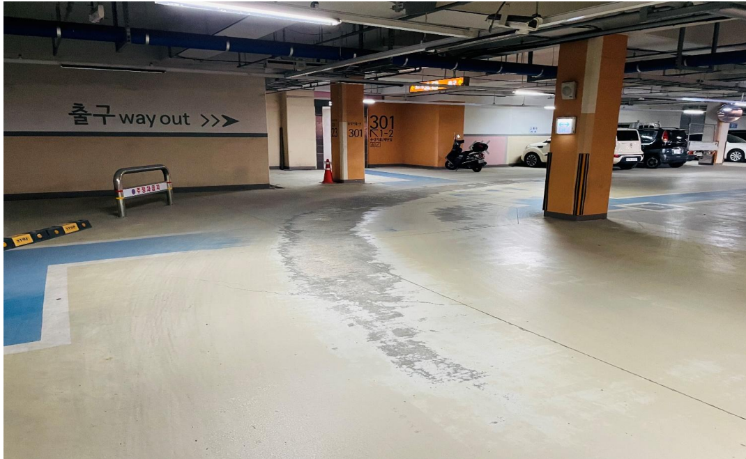
공사 전 지하주차장 전경
