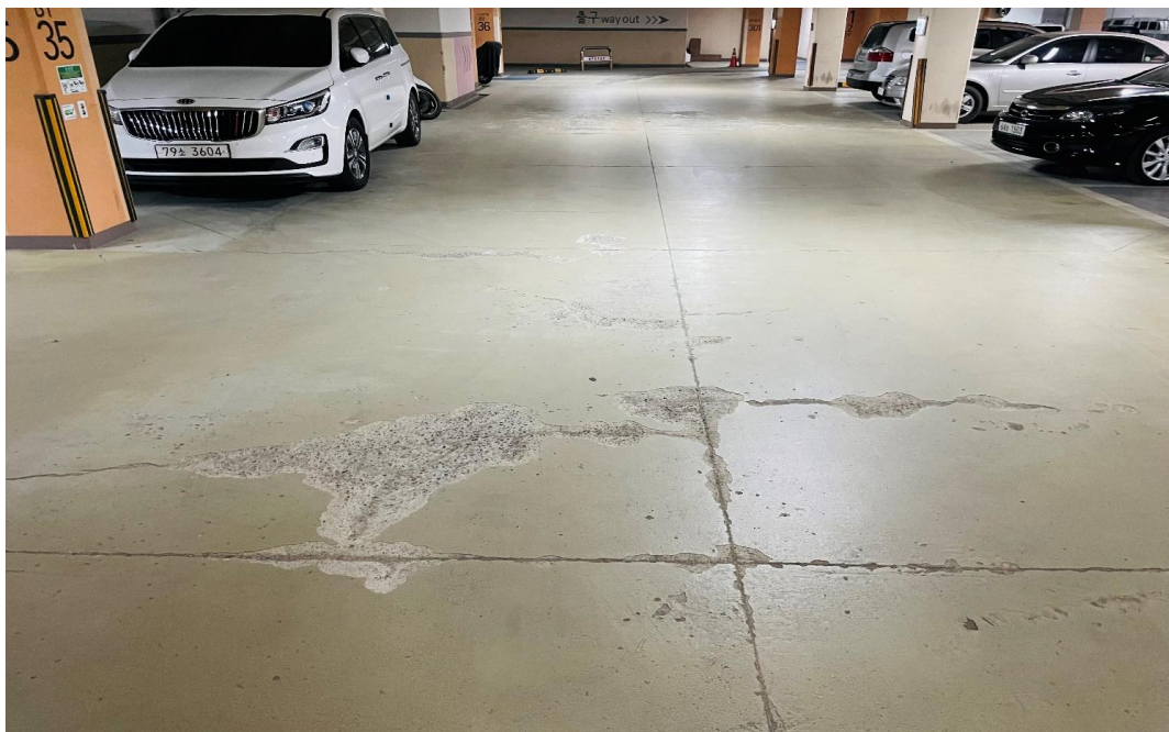
공사 전 지하주차장 전경
