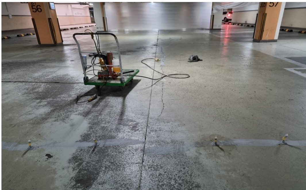
대균열 고점도 주입제 주입중(T-port 공법)
