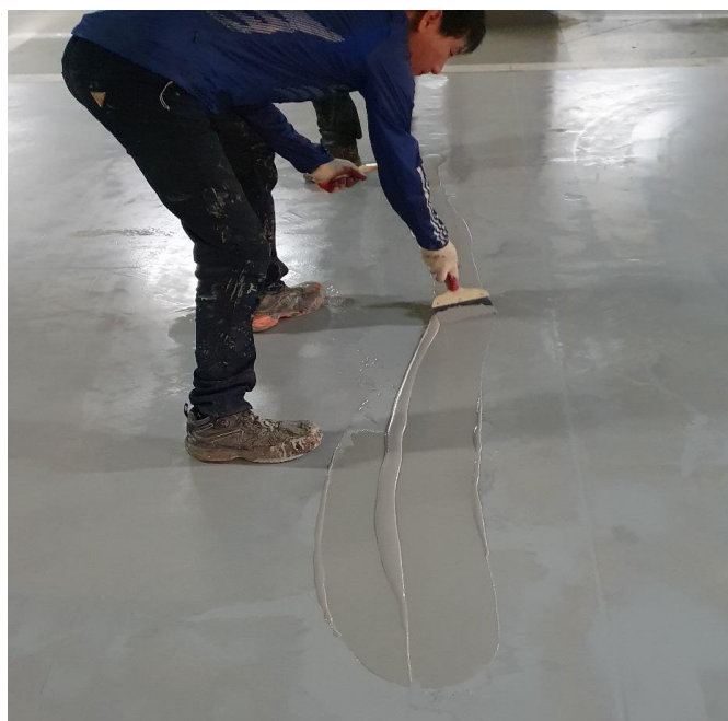
에폭시 라이닝 1차 도포 후 중간 면처리 작업
