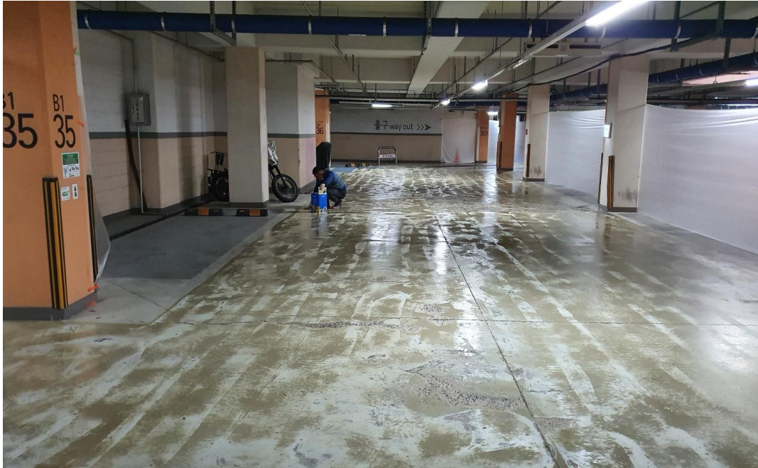
프라이머 도포 및 에폭시 퍼티 작업
