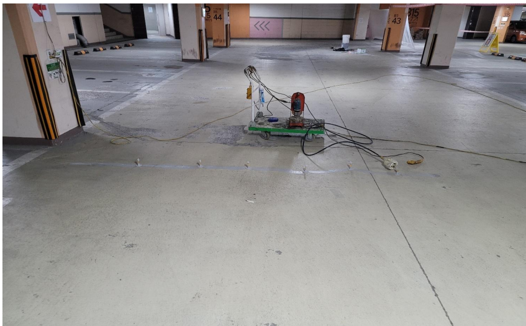
대균열 고점도 주입제 주입중(T-port 공법)
