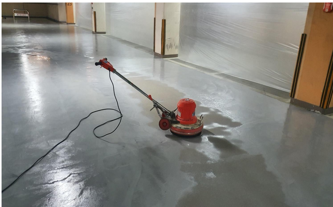
에폭시 라이닝 1차 도포 후 중간 면처리 작업
