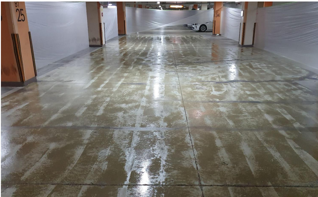
프라이머 도포 및 에폭시 퍼티 작업
