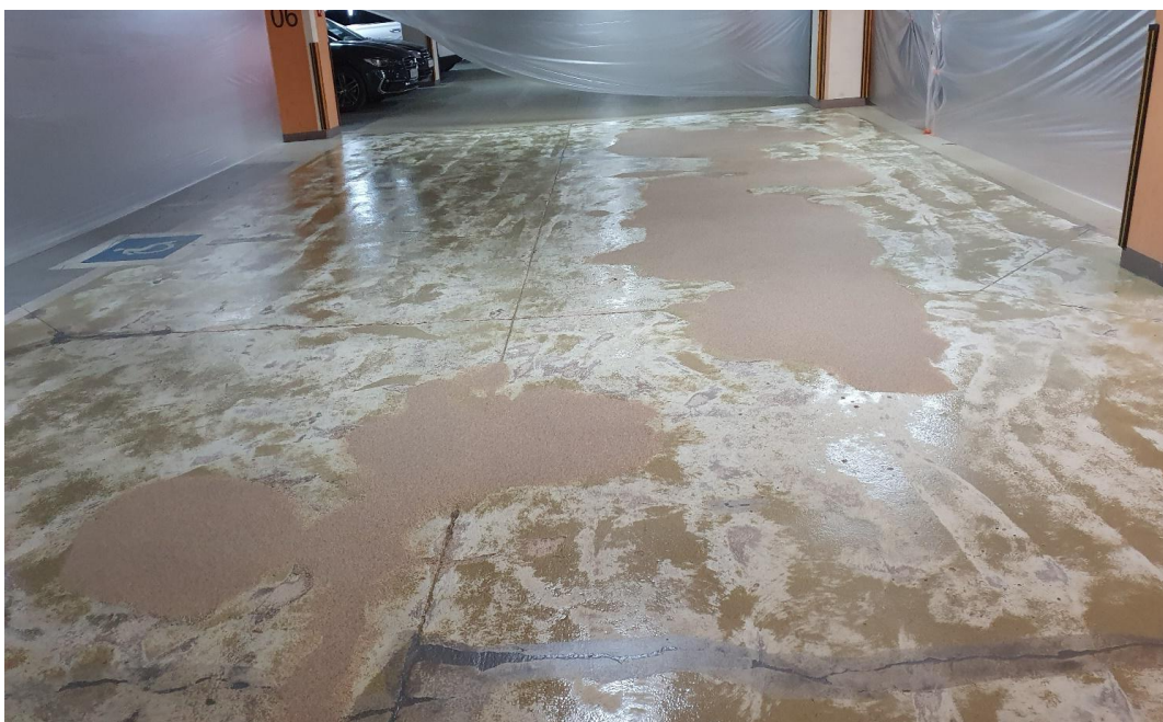
바닥 파인부분 에폭시 레진몰탈 함침 작업
