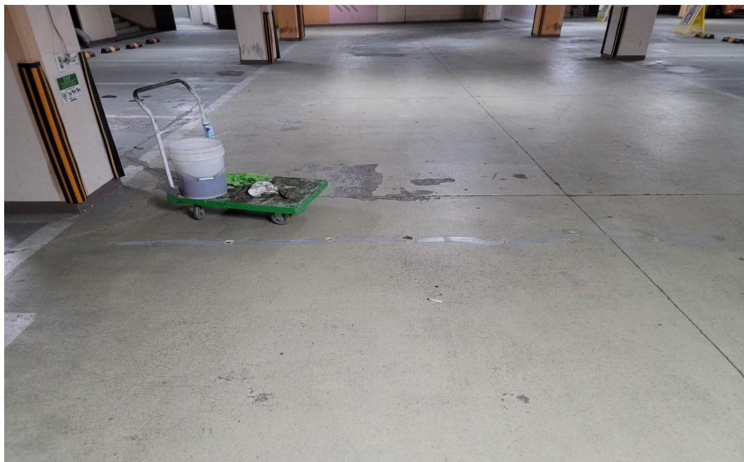
대균열 고점도 주입제 주입중(T-port 공법)
