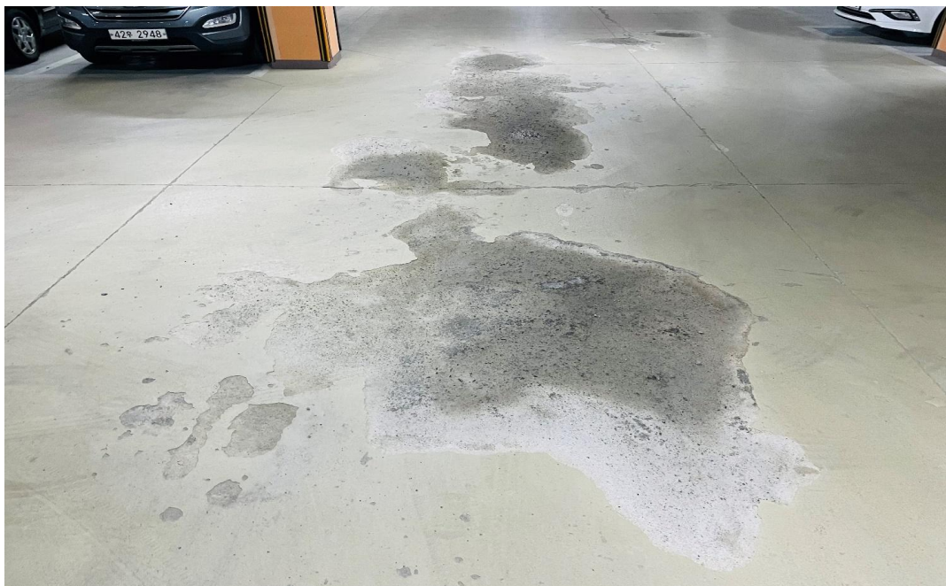
공사 전 지하주차장 전경
