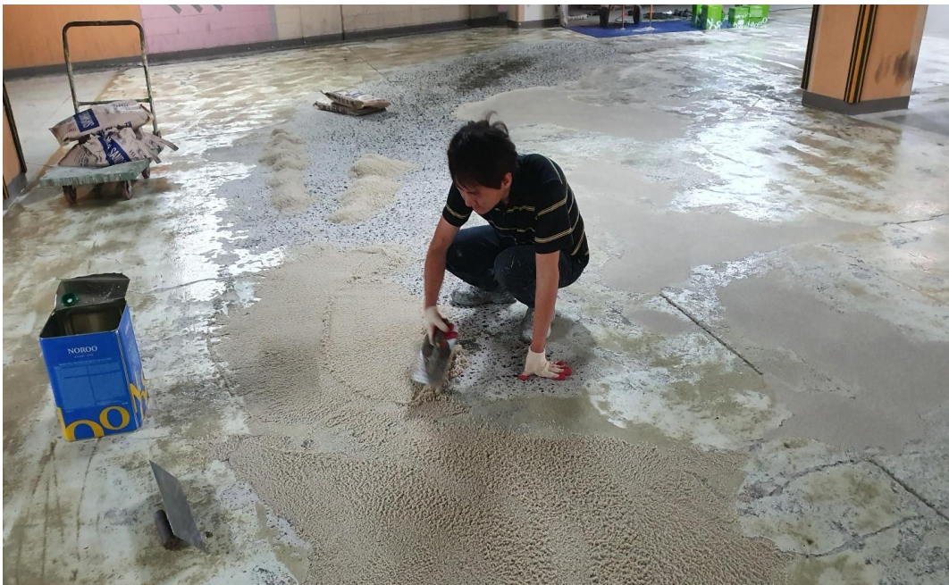
바닥 파인부분 에폭시 레진몰탈 함침 작업
