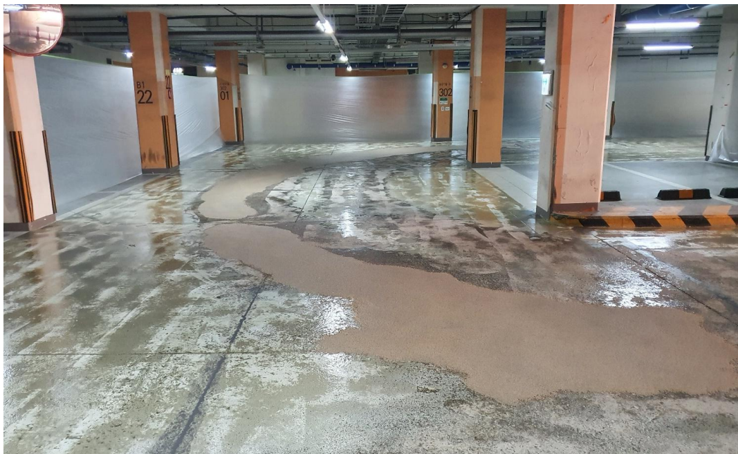
바닥 파인부분 에폭시 레진몰탈 함침 작업
