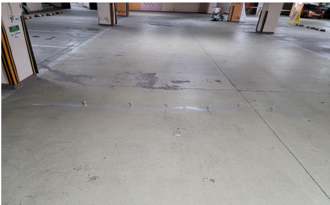
대균열 고점도 주입제 주입중(T-port 공법)
