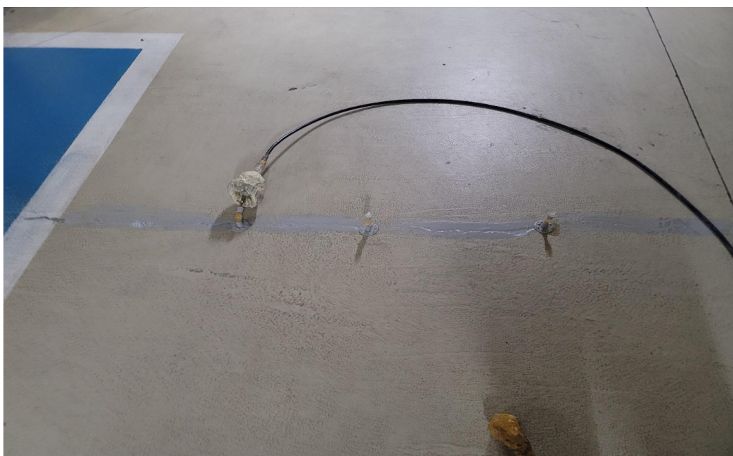
대균열 고점도 주입제 주입중(T-port 공법)
