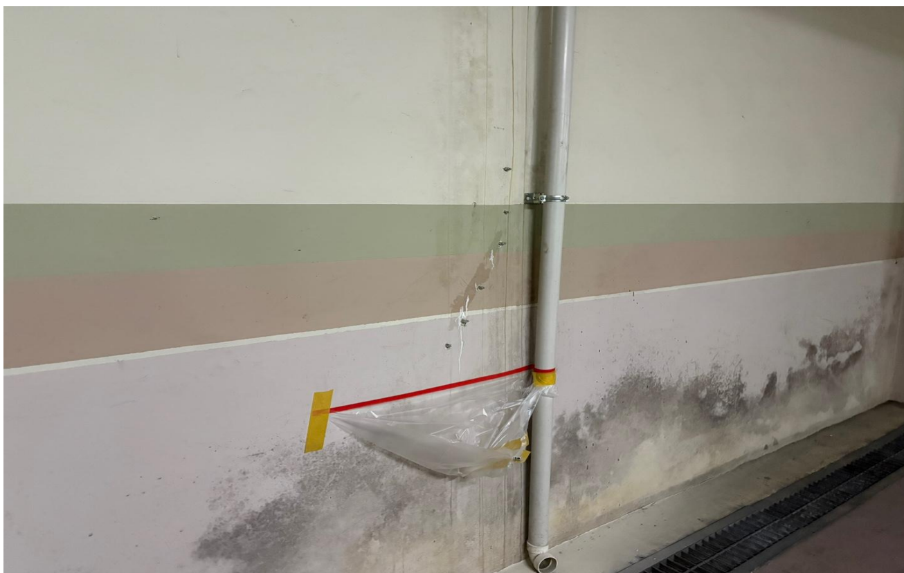
공사 중 : 인젝션 주입
