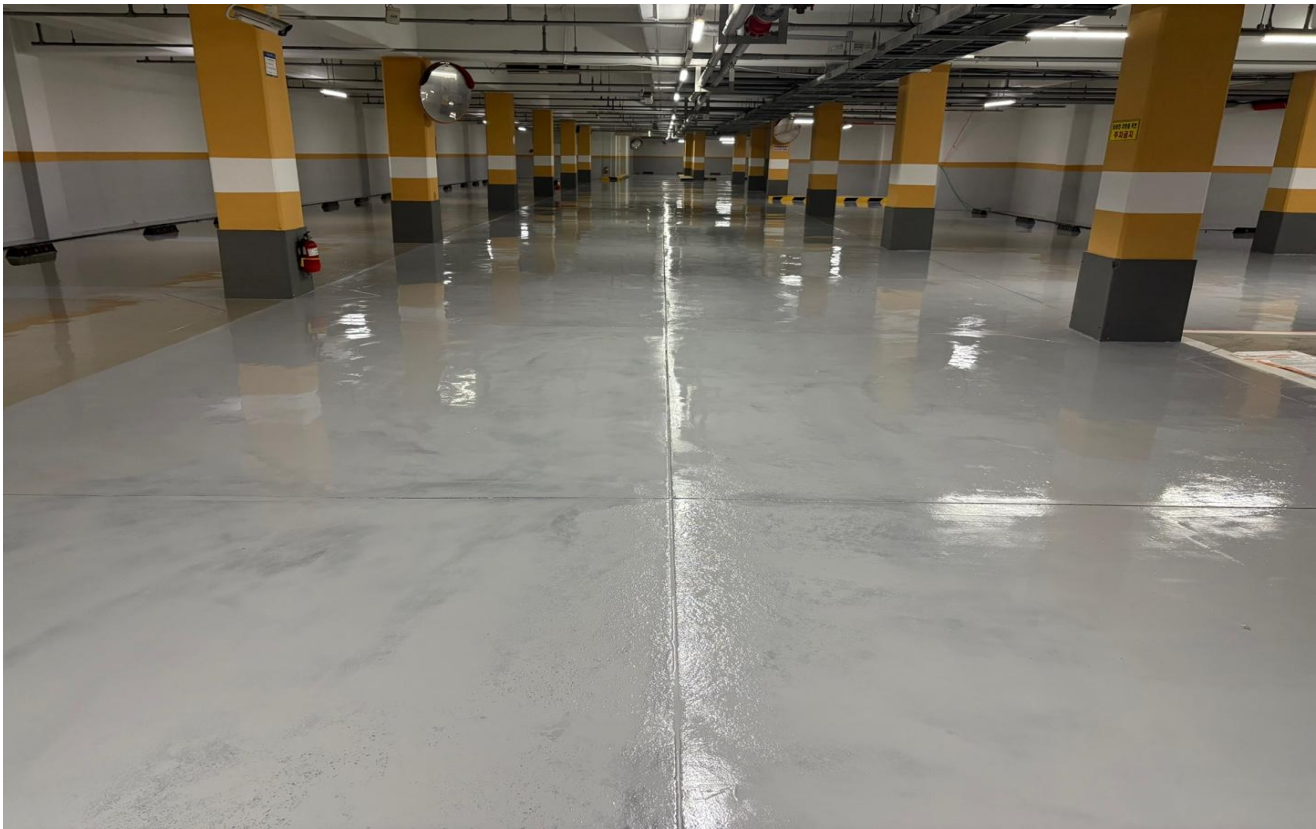
공사 중 : 에폭시 중도 1차 도포
