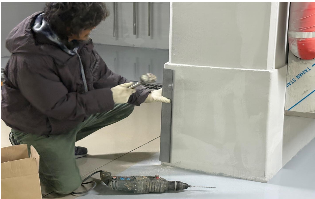
공사 중 : 시설물 설치
