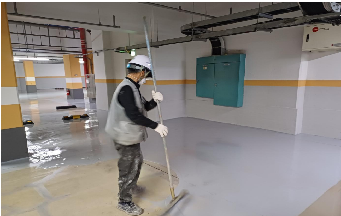
공사 중 : 에폭시 중도 1차 도포
