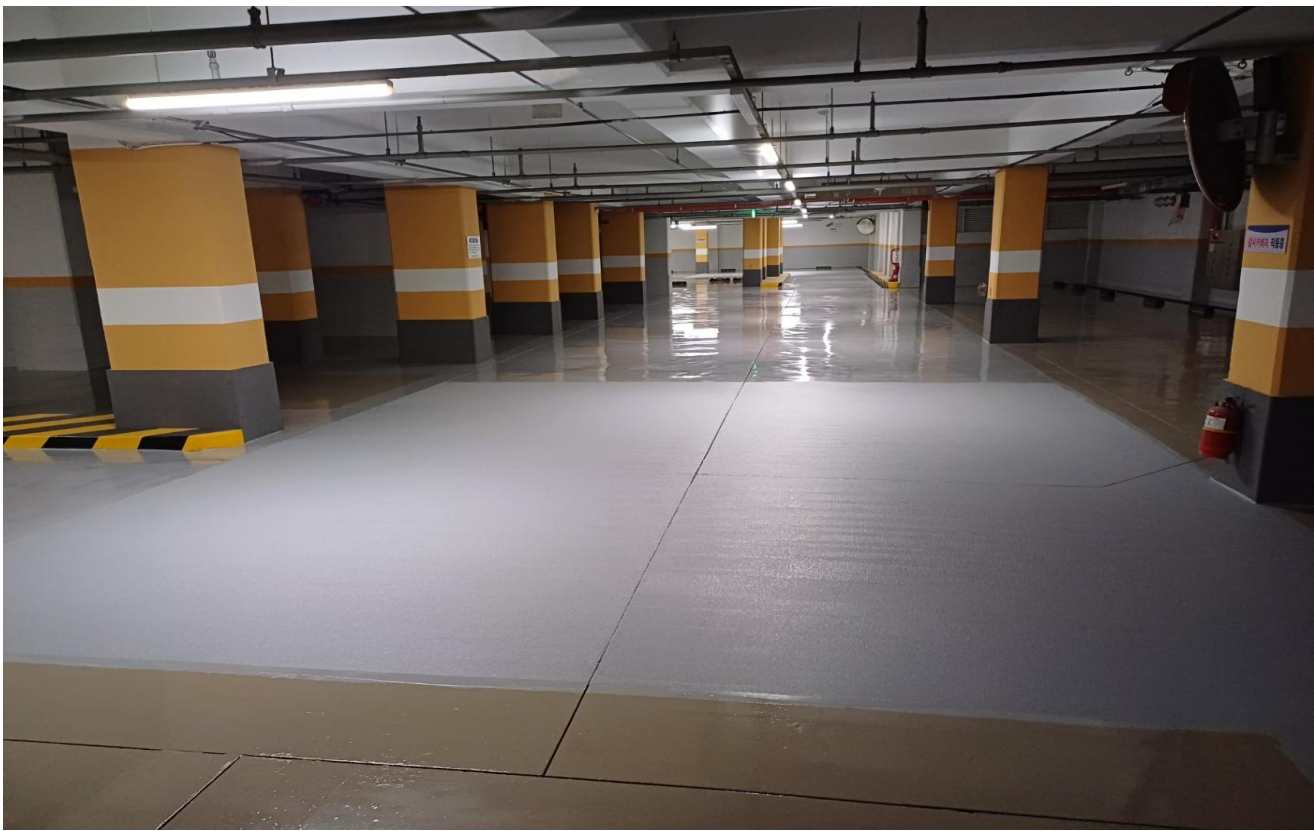
공사 중 : 에폭시 엠보 도포
