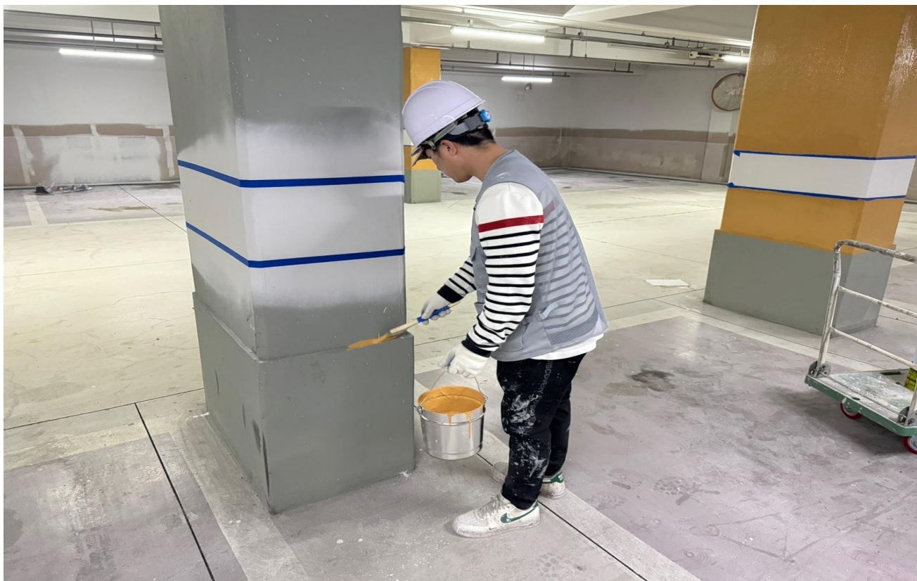
공사 중 : 지하 내부도장
