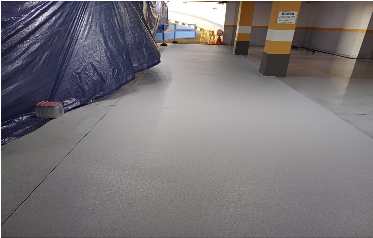
공사 중 : 에폭시 엠보 도포
