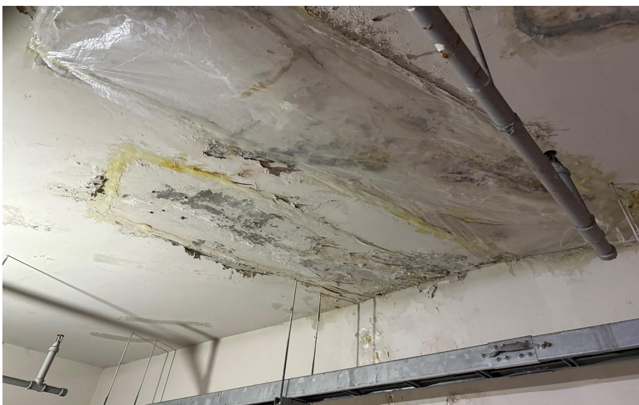
공사 중 : 인젝션 주입
