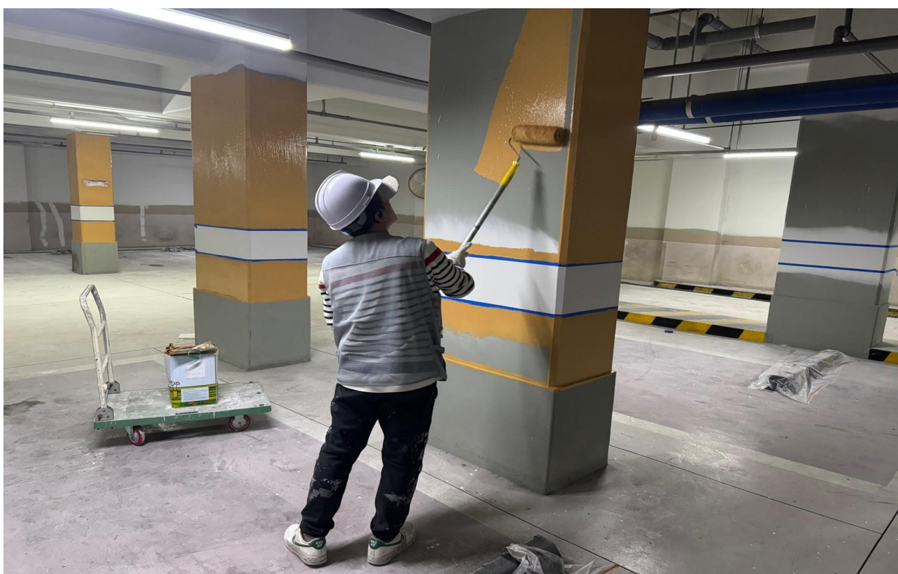
공사 중 : 지하 내부도장
