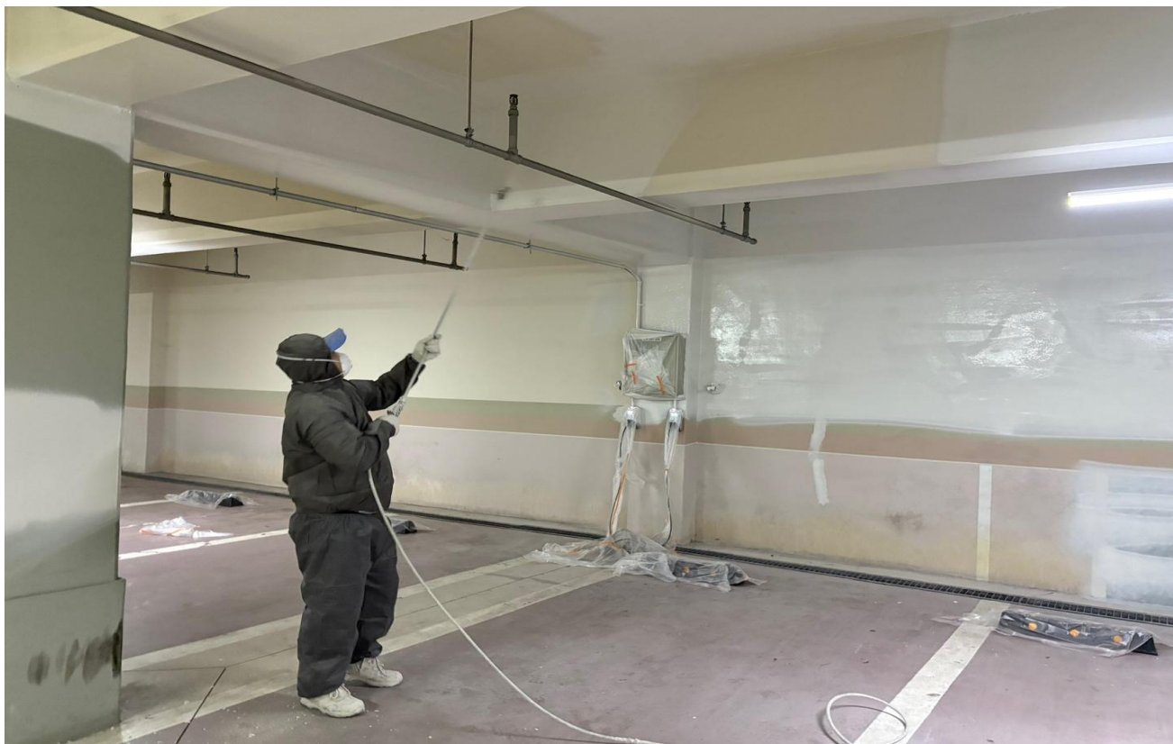
공사 중 : 지하 내부도장
