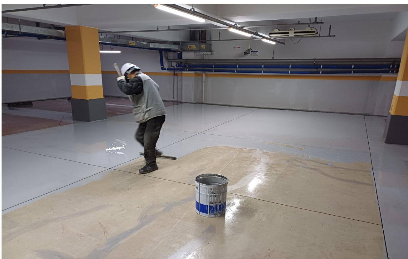
공사 중 : 에폭시 중도 1차 도포
