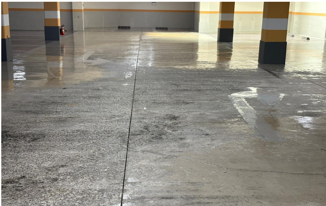
공사 중 : 에폭시 프라이마 도포
