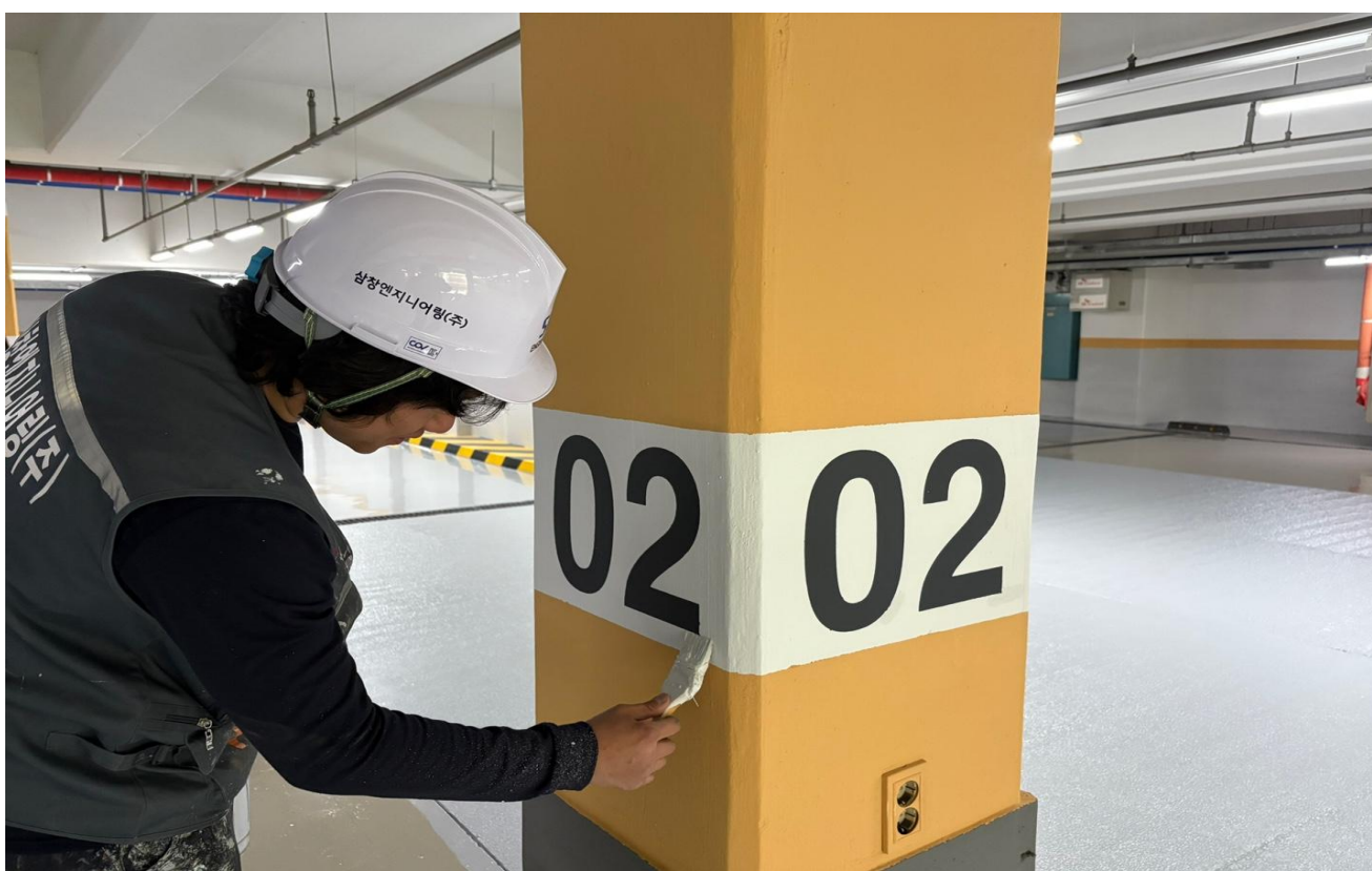
공사 중 : 내부 그래픽 도장
