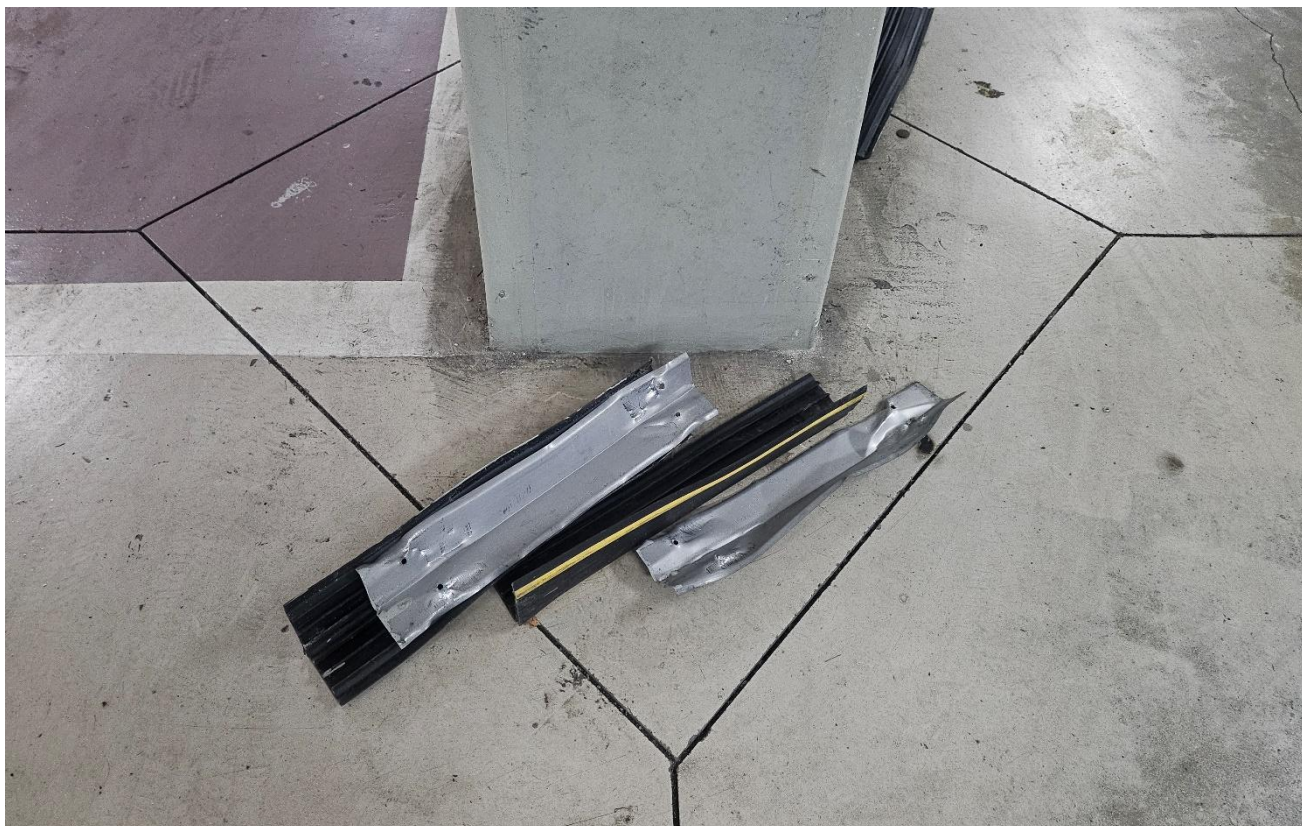
공사 중 : 시설물 철거
