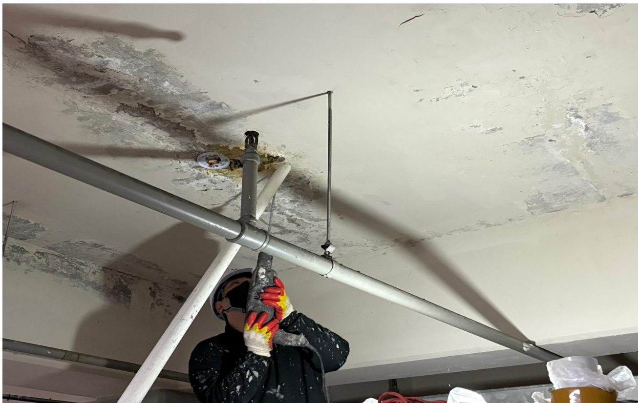
공사 중 : 인젝션 주입
