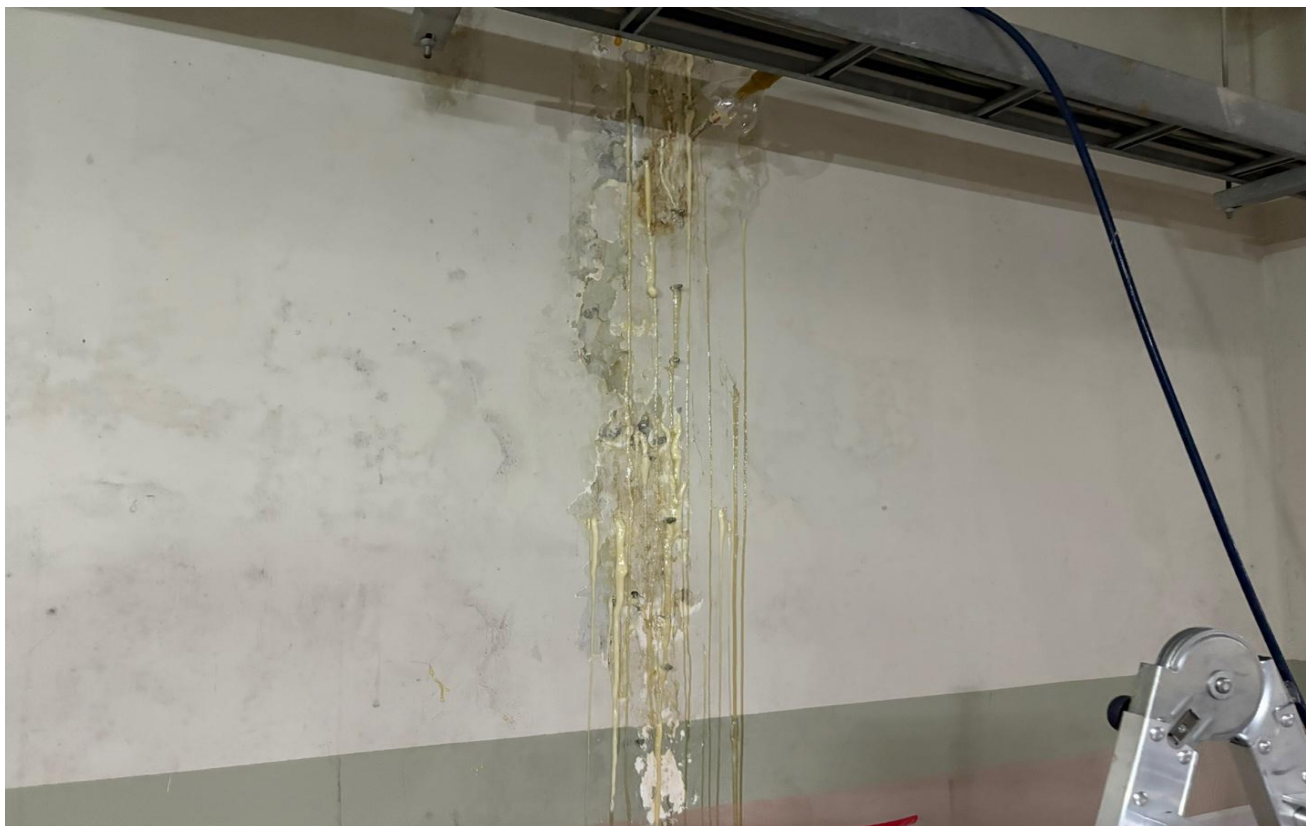
공사 중 : 인젝션 주입
