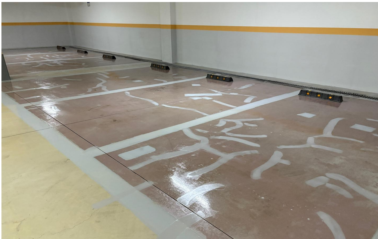
공사 중 : 바닥면 균열보수
