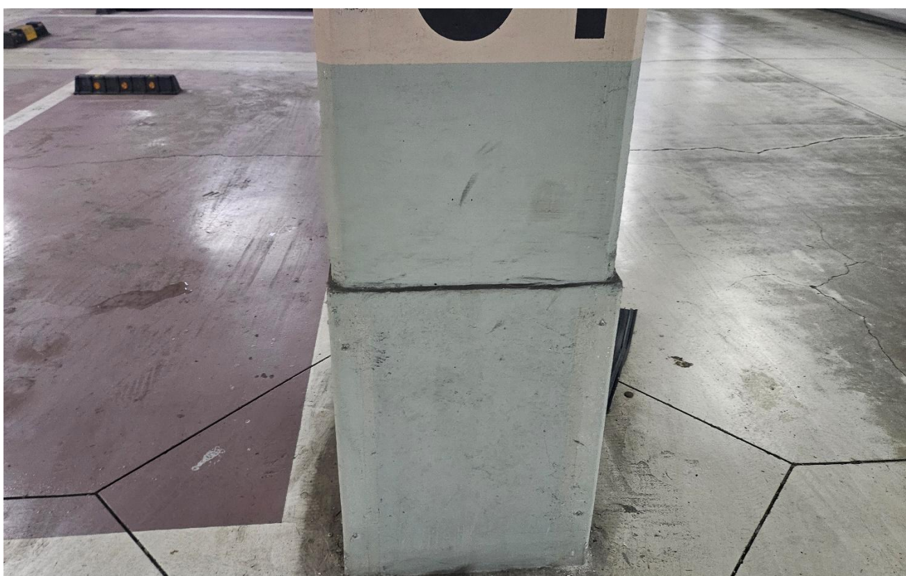
공사 중 : 시설물 철거
