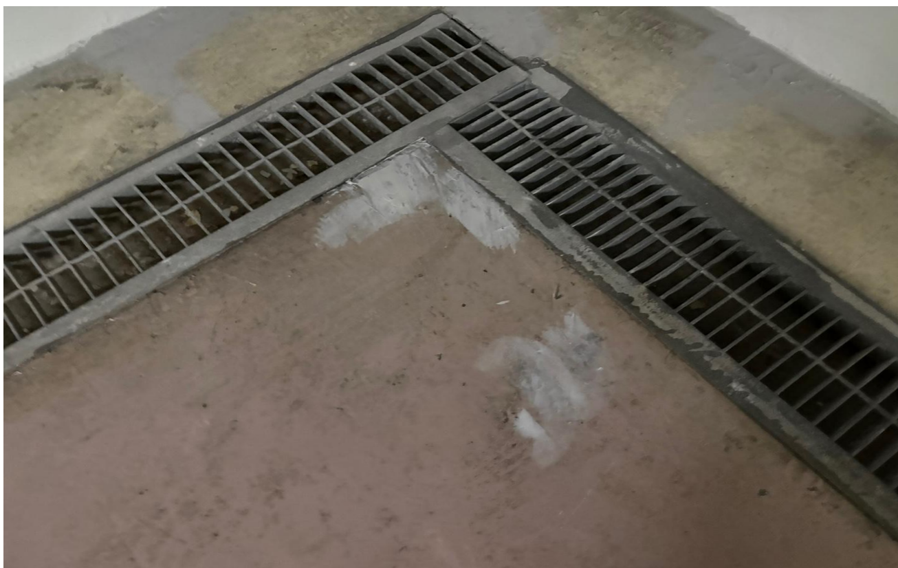
공사 중 : 바닥면 균열보수
